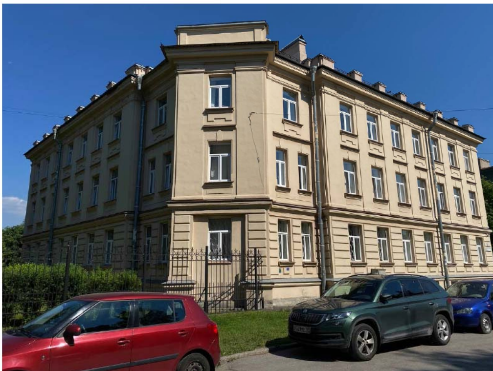
Фото №1. Общий вид здания с северо-запада, главный фасад.
