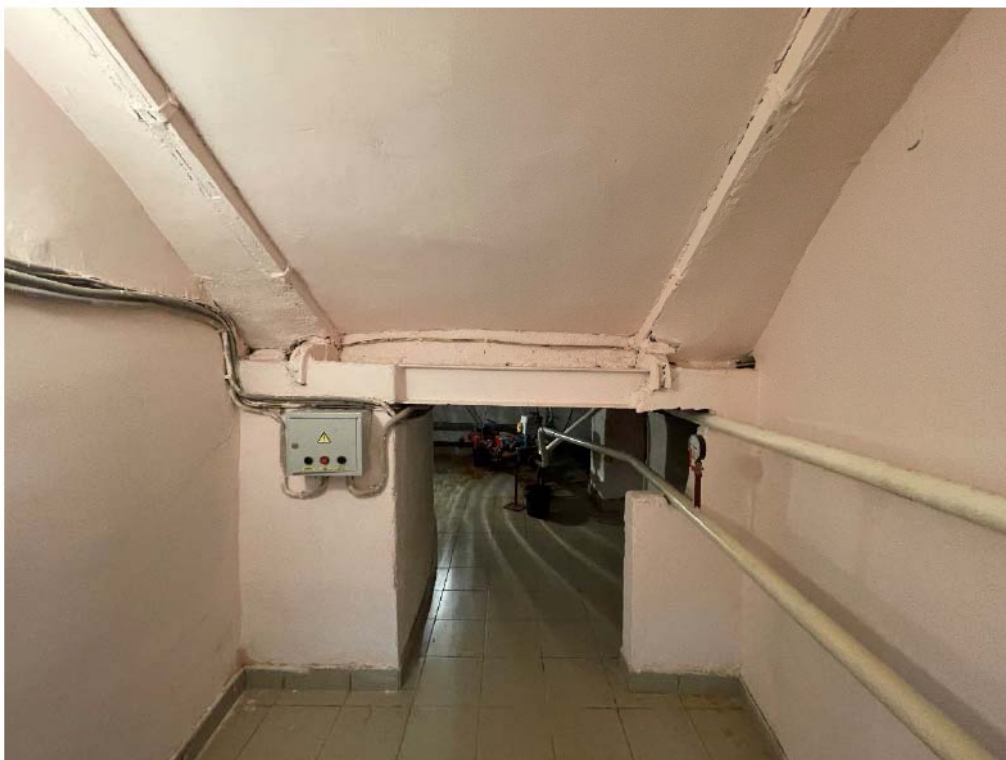
Фото №31. Подвал, помещение под парадной лестницей, лестничная площадка ж/б по металлическим балкам.
