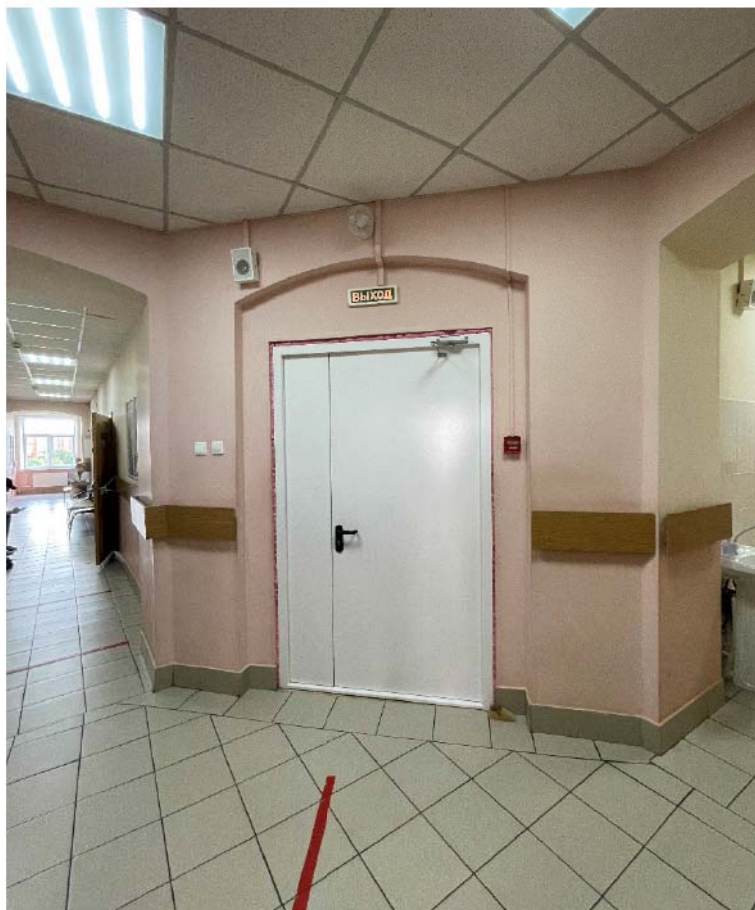
Фото №23. Выход на парадную лестницу 3 этажа, защищенный арочный проем.
