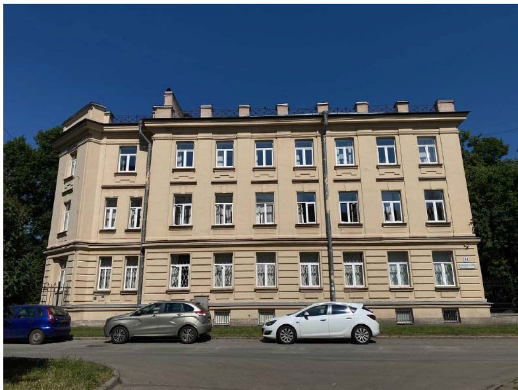
Фото №3. Западный фасад здания.
