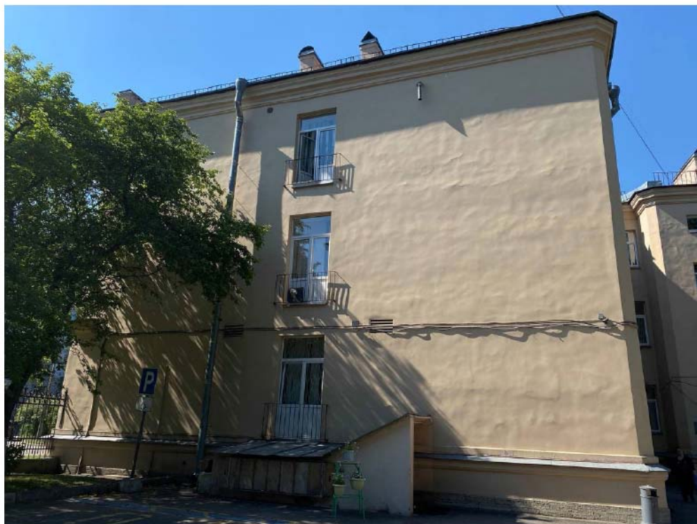
Фото №4. Южный фасад здания, вид со двора.
