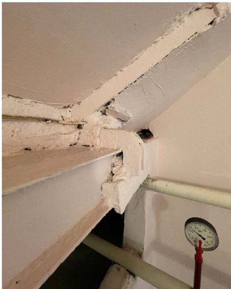
Фото №34. Подвал, лестничная площадка ж/б по металлическим балкам.
