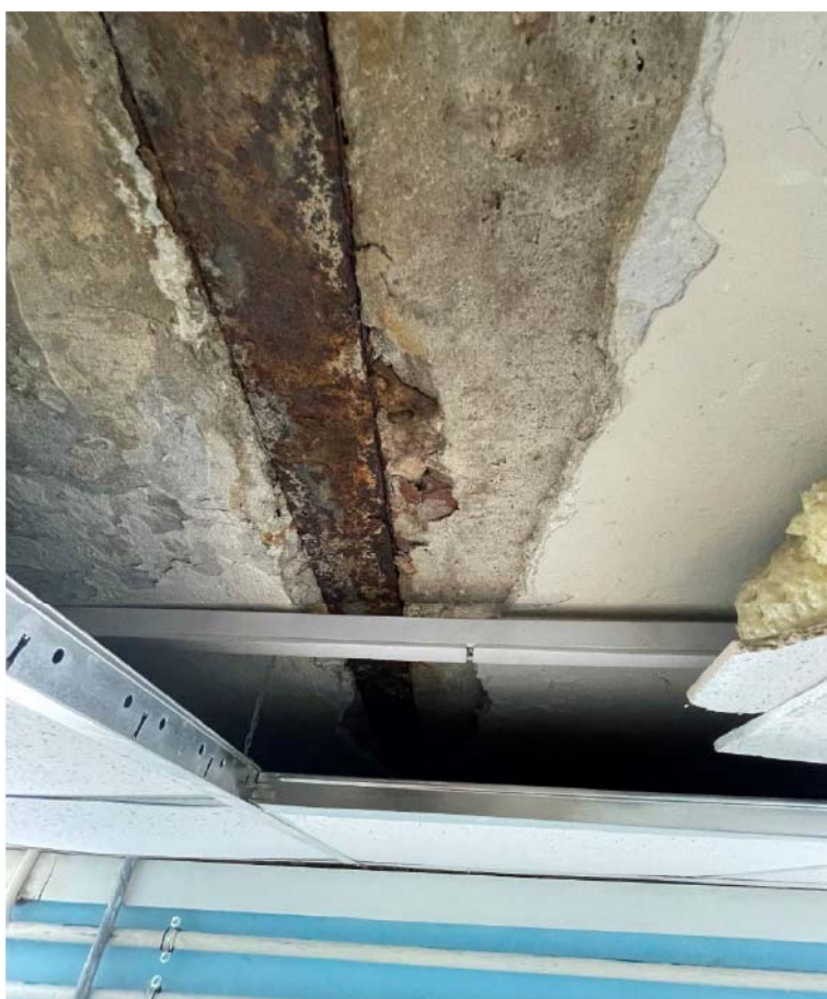
Фото №36. Плоское ж/б междуэтажное перекрытие по металлическим балкам.
