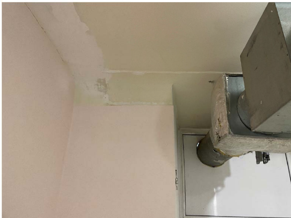
Фото №39. плоским перекрытием и потолочной тягой.
