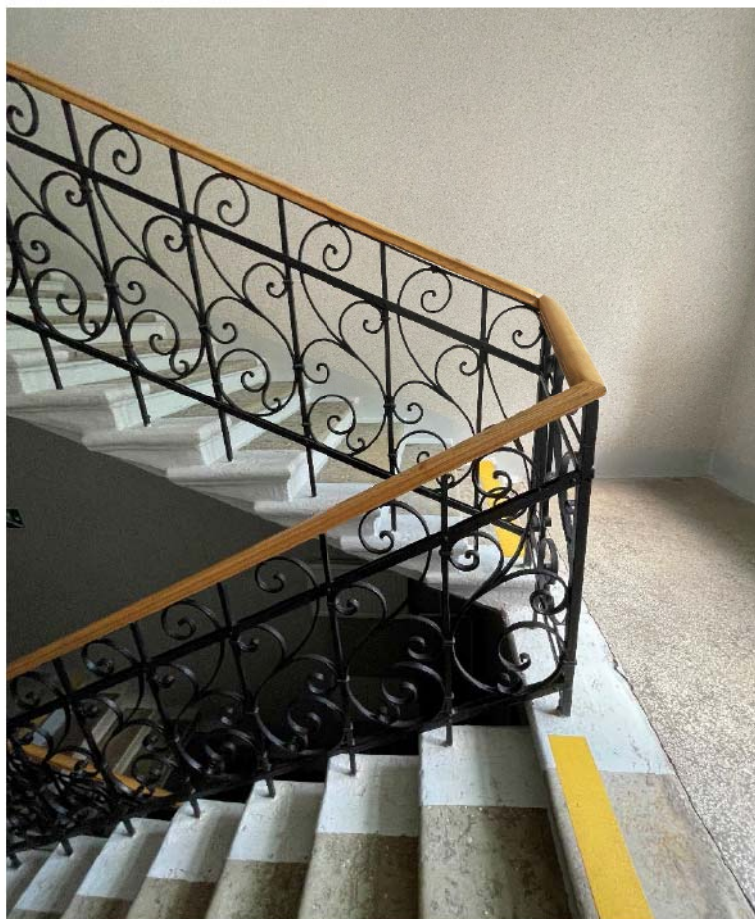
Фото №17. Металлическое ограждение парадной лестницы.
