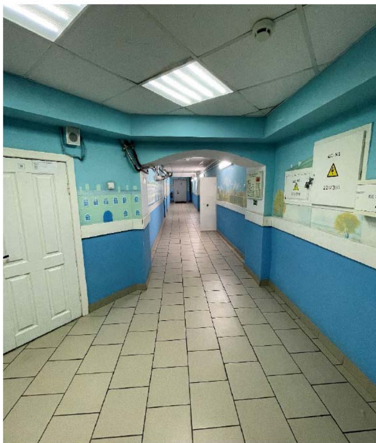
Фото №30. Отделка коридоров подвального этажа.
