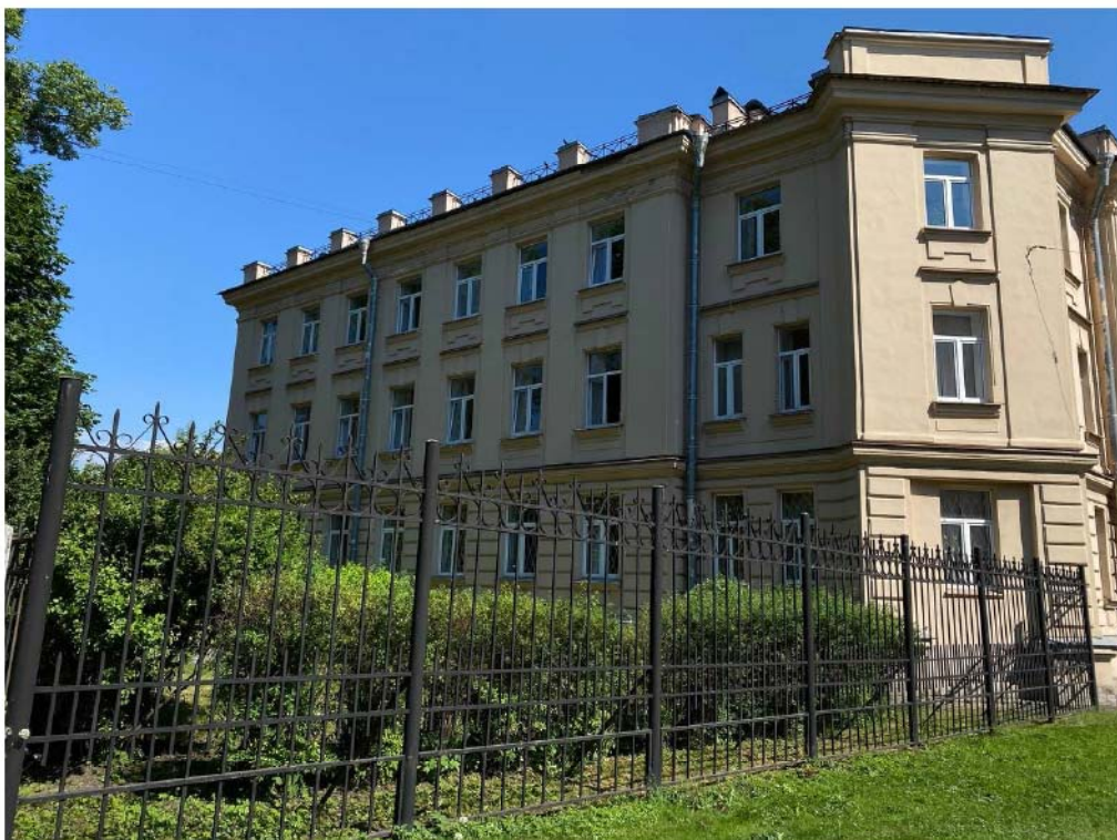
Фото №2. Северо-западный фасад здания.
