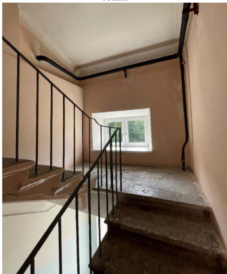
Фото №26. Служебная известняковая лестница, междуэтажная площадка 2 и 3 этажа, оконный проем.
