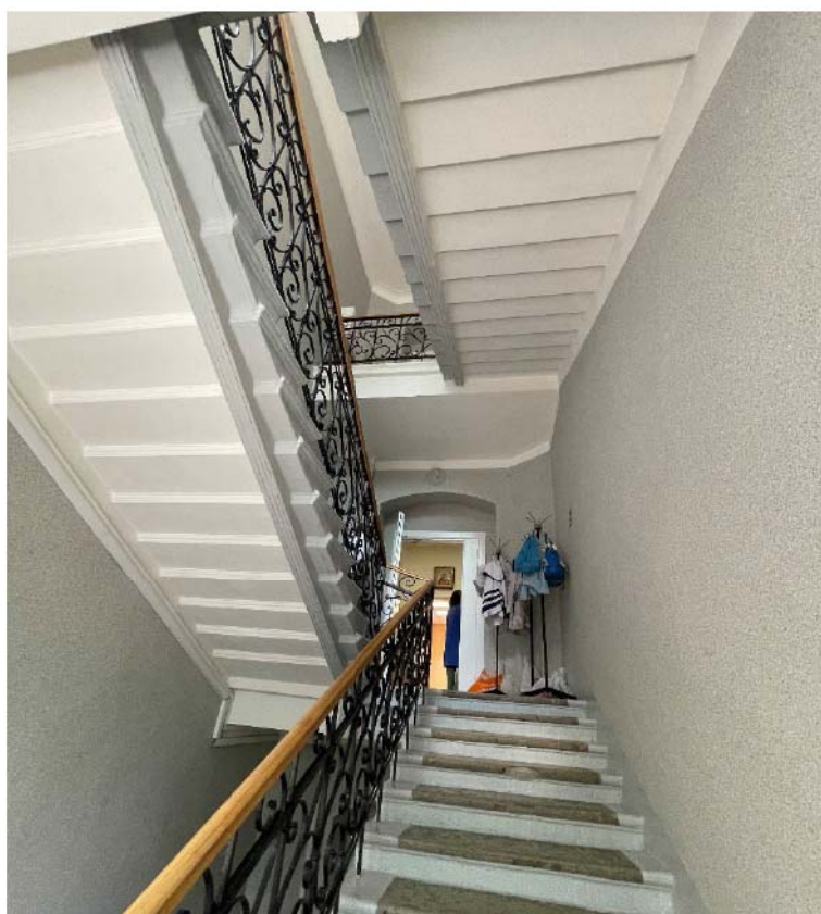
Фото №18. Лестничные марши 2 и 3 этажей, вид с междуэтажной площадки 1 и 2 этажа.
