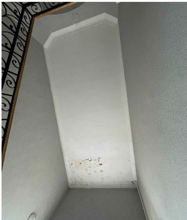
Фото №19. Потолок над парадной лестницей на уровне 3 этажа, вид с лестничного марша.
