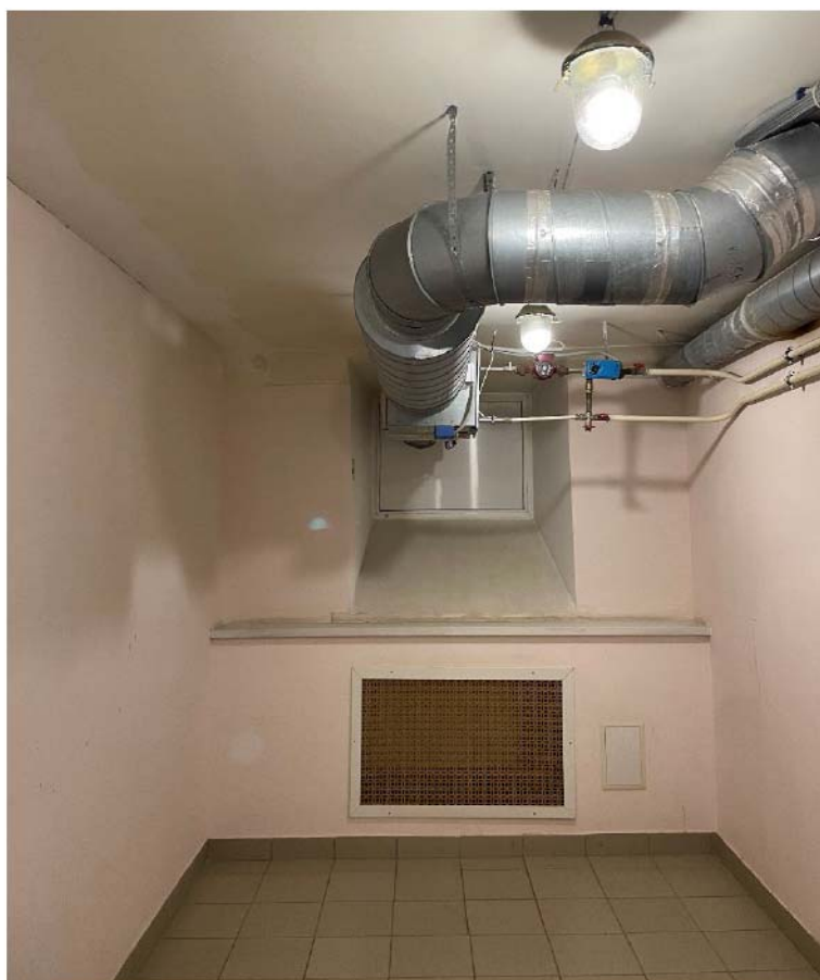
Фото №38. Помещение венткамеры с плоским перекрытием и потолочной тягой.
