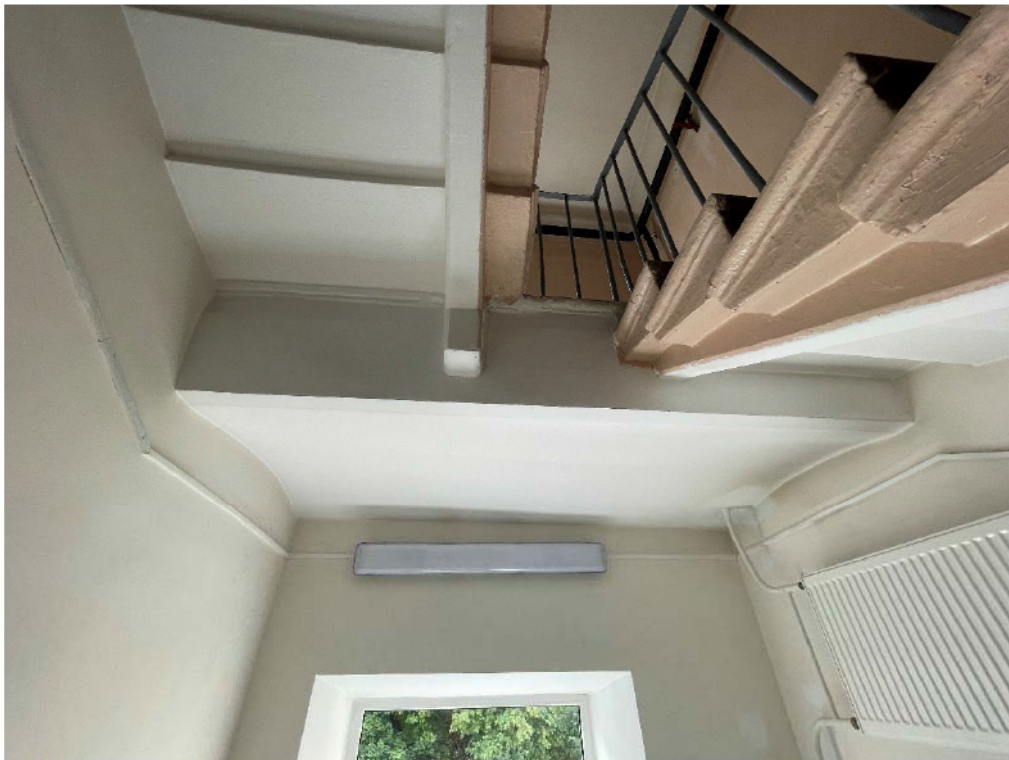
Фото №28. Служебная известняковая лестница, примыкание лестничных маршей к междуэтажной площадке 2 и 3 этажа.
