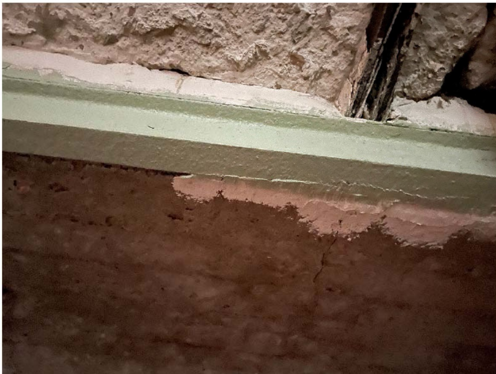
Фото №41. Сводчатое перекрытие лестничной площадки служебной лестницы.
