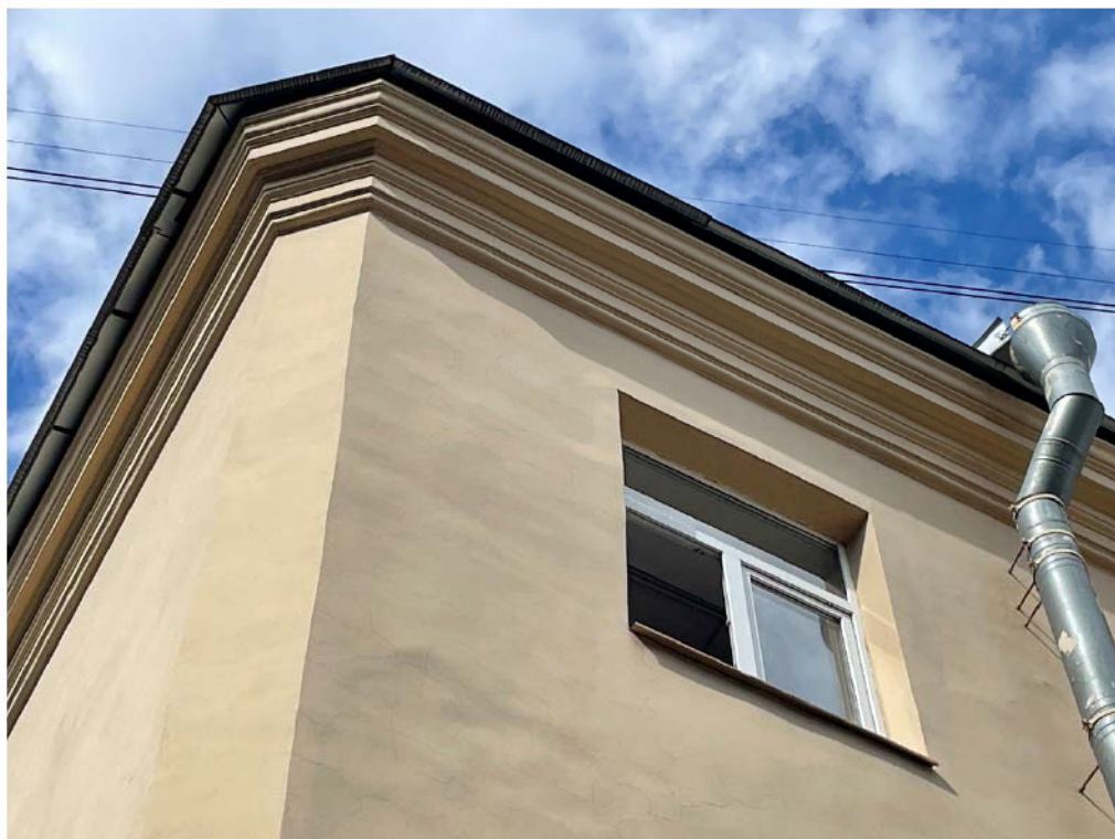
Фото №7. Венчающий профилированный карниз.
