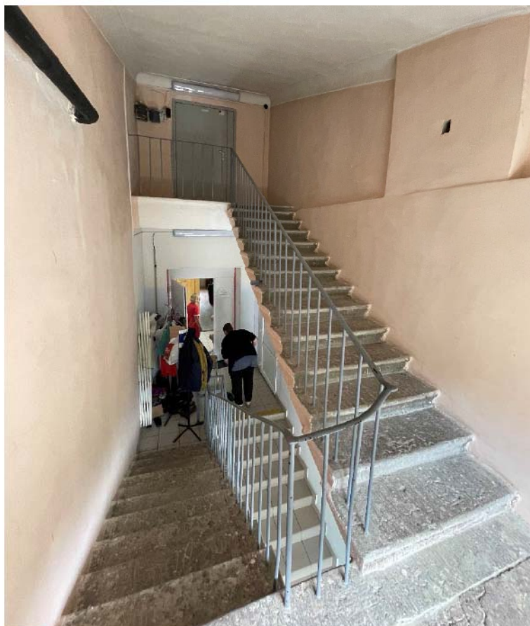
Фото №25. Служебная известняковая лестница, вид с междуэтажной площадки 2 и 3 этажа.
