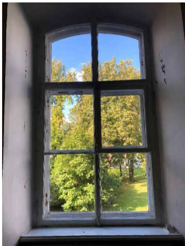
Фото 8. Заполнение оконного проема в аудитории.
