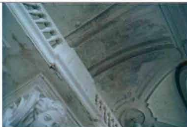
25. (Фрагмент интерьера северо-западного корпуса)
