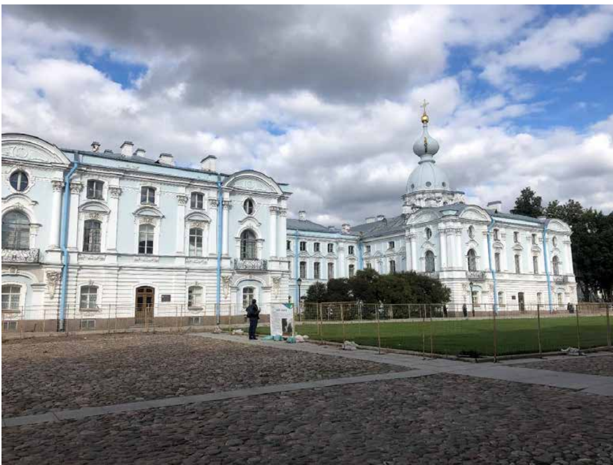
Фото 2. Вид на северные корпуса (первое каре), подъезд № 9.
