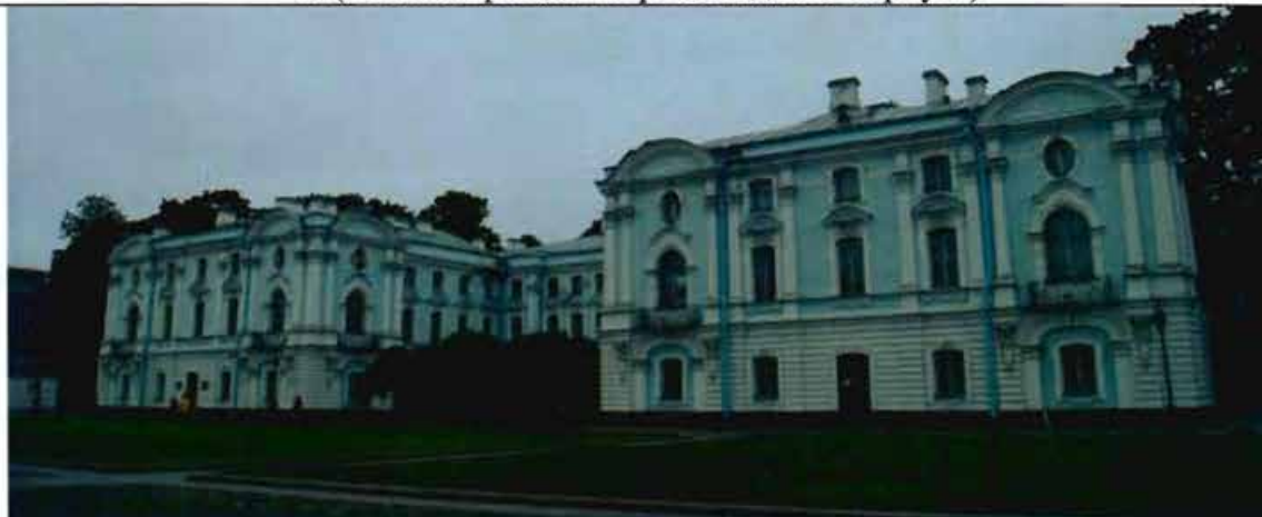
2. (Северный фасад юго-западного корпуса)
