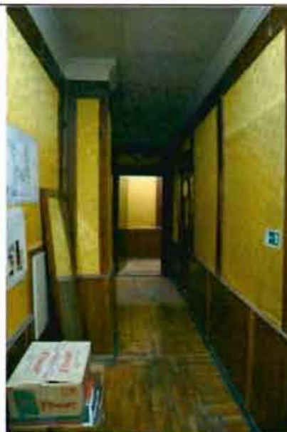
28. (Фрагмент интерьера северо-западного корпуса)
