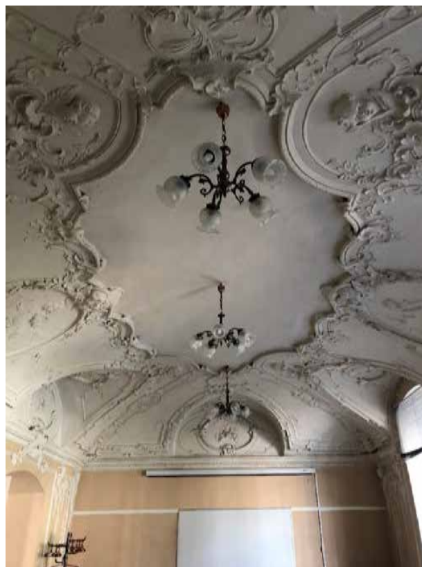
Фото 6. Вид на потолок аудитории с востока на запад.
