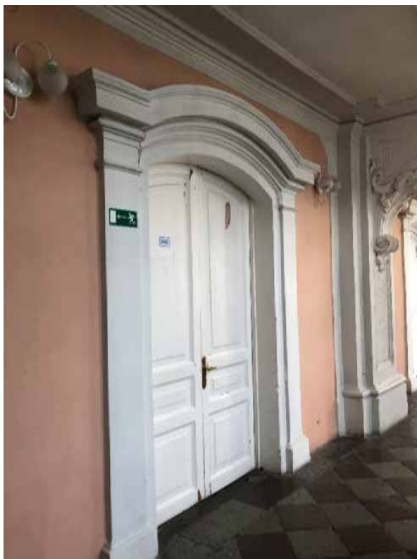
Фото 1. Вид на вход в аудиторию с коридора.
