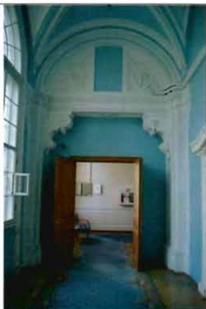
10. (Фрагмент интерьера юго-западного корпуса)
