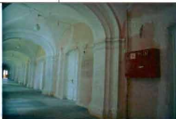
30. (Фрагмент интерьера северо-западного корпуса)
