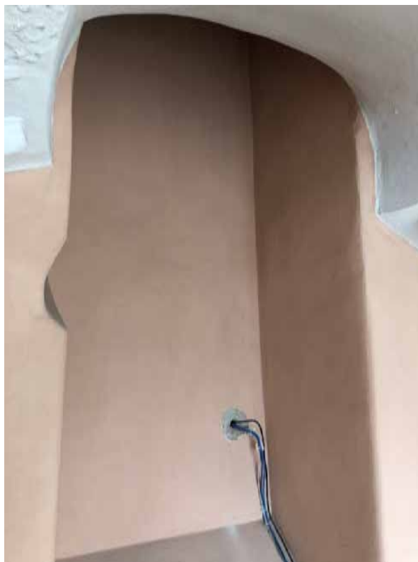
Фото 7. Ниша в уровне балкона восточной части коридора.
