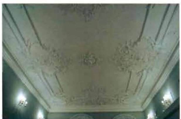
16. (Фрагмент интерьера восточного корпуса)
