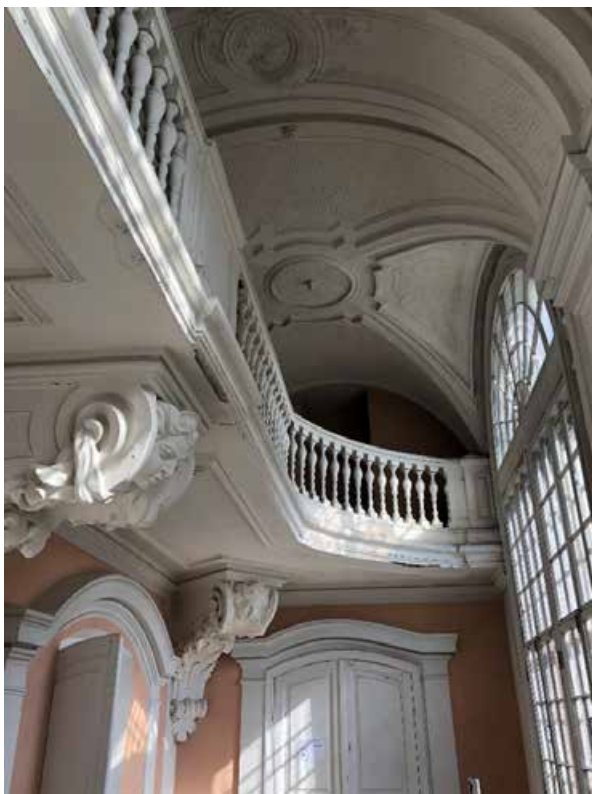
Фото 4. Вид на цилиндрический свод с распалубками в коридоре, в восточной части.
