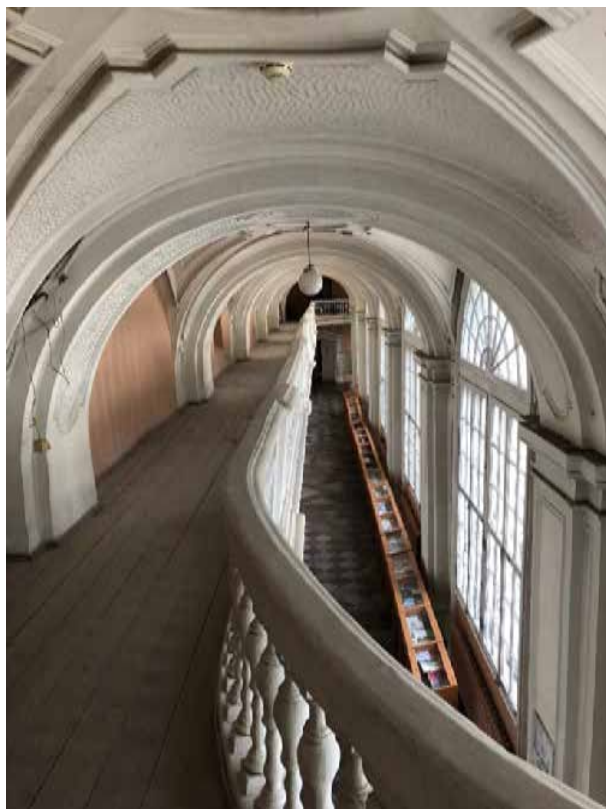
Фото 11. Вид на балкон в южной части коридора.
