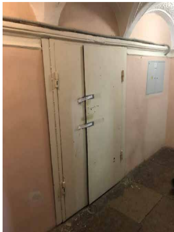
Фото 12. Вход на балкон в коридоре с лестничной клетки.
