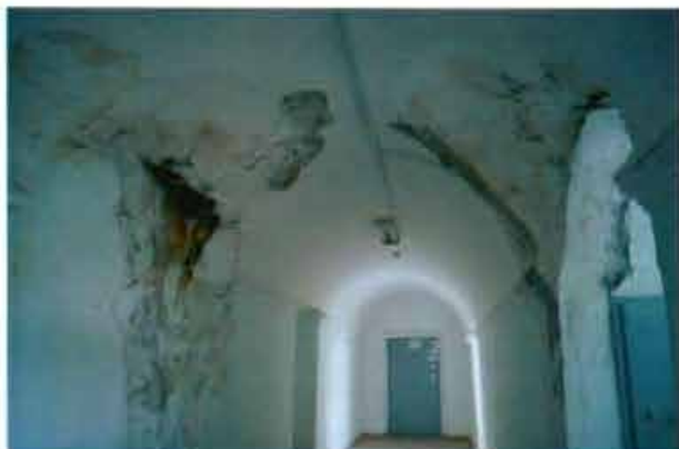
17. (Фрагмент интерьера северного корпуса)
