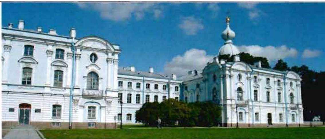
1. (Южный фасад северо-западного корпуса)
