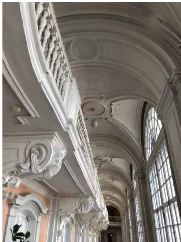
Фото 9. Вид на цилиндрический свод с распалубками в коридоре, в южной части.
