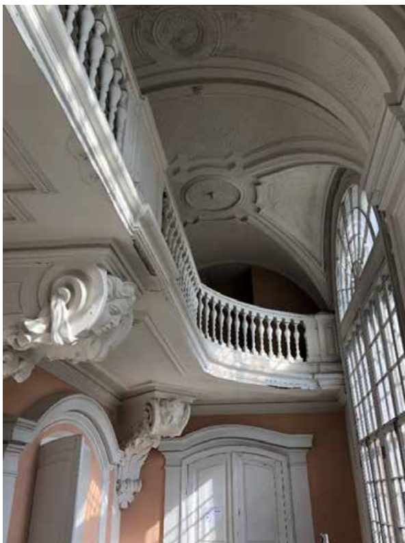
Фото 12. Вид на цилиндрический свод с распалубками в коридоре, в восточной части.
