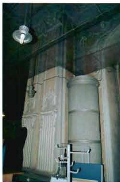
21. (Фрагмент интерьера северного корпуса)
