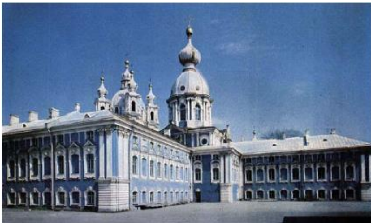
Илл. 19. А. Кедринский и др. “Восстановление памятников архитектуры Ленинграда”, Ленинград, "Стройиздат", 1987. Издание второе, дополненное. Первое вышло в 1983. Лютеранская церковь Святой Марии (дворовый фасад).
