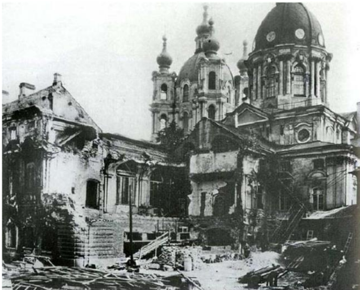
Илл. 16. 1946 г. А.Кедринский, М.Колотов, Б.Ометов, А.Раскин "Восстановление памятников архитектуры Ленинграда" Л., Стройиздат, 1989. Направление съемки: северо-восток Лютеранская церковь Святой Марии (дворовый фасад).
