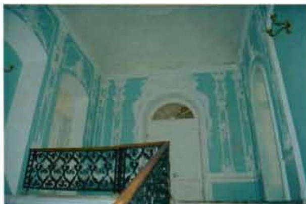
23. (Фрагмент интерьера северного корпуса)
