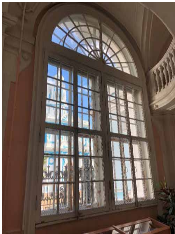
Фото 2. Вид на заполнение оконного проема в южной части коридора.
