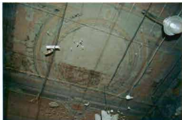
22. (Фрагмент интерьера северного корпуса)
