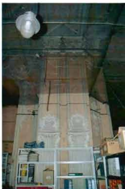
20. (Фрагмент интерьера северного корпуса)
