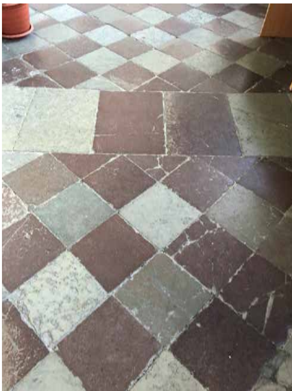
Фото 8. Покрытие пола из известняковых плит.
