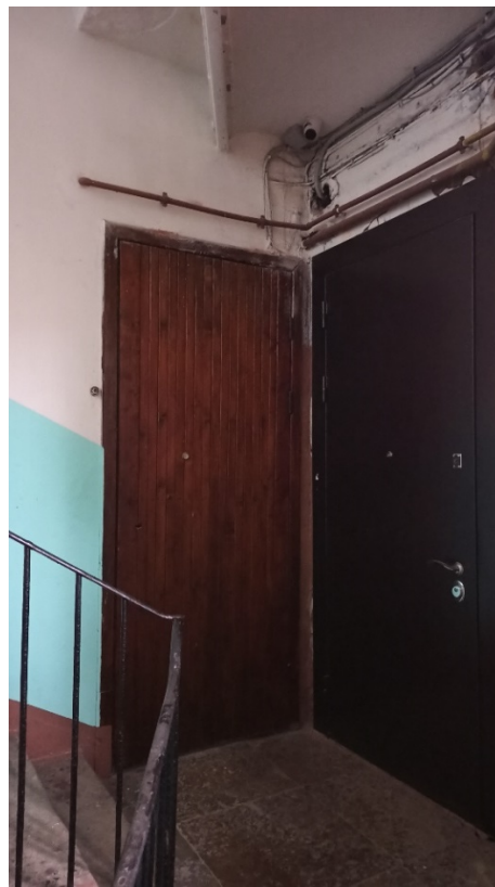
Фото 4. Интерьер парадной выявленного объекта культурного наследия «Дом и фабрика шелковых изделий А.И. Ниссена, входное дверное заполнение с ЛК2
