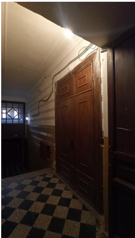
Фото 3. Интерьер парадной выявленного объекта культурного наследия «Дом и фабрика шелковых изделий А.И. Ниссена, входное дверное заполнение с ЛК1
