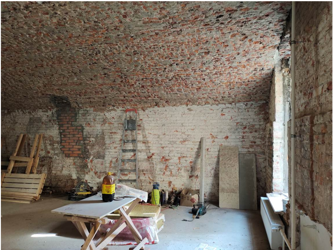
13. Выявленный ОКН «Дом Тампера» (г. Санкт-Петербург, Якубовича ул., д. 22). Помещение кв.№8.
