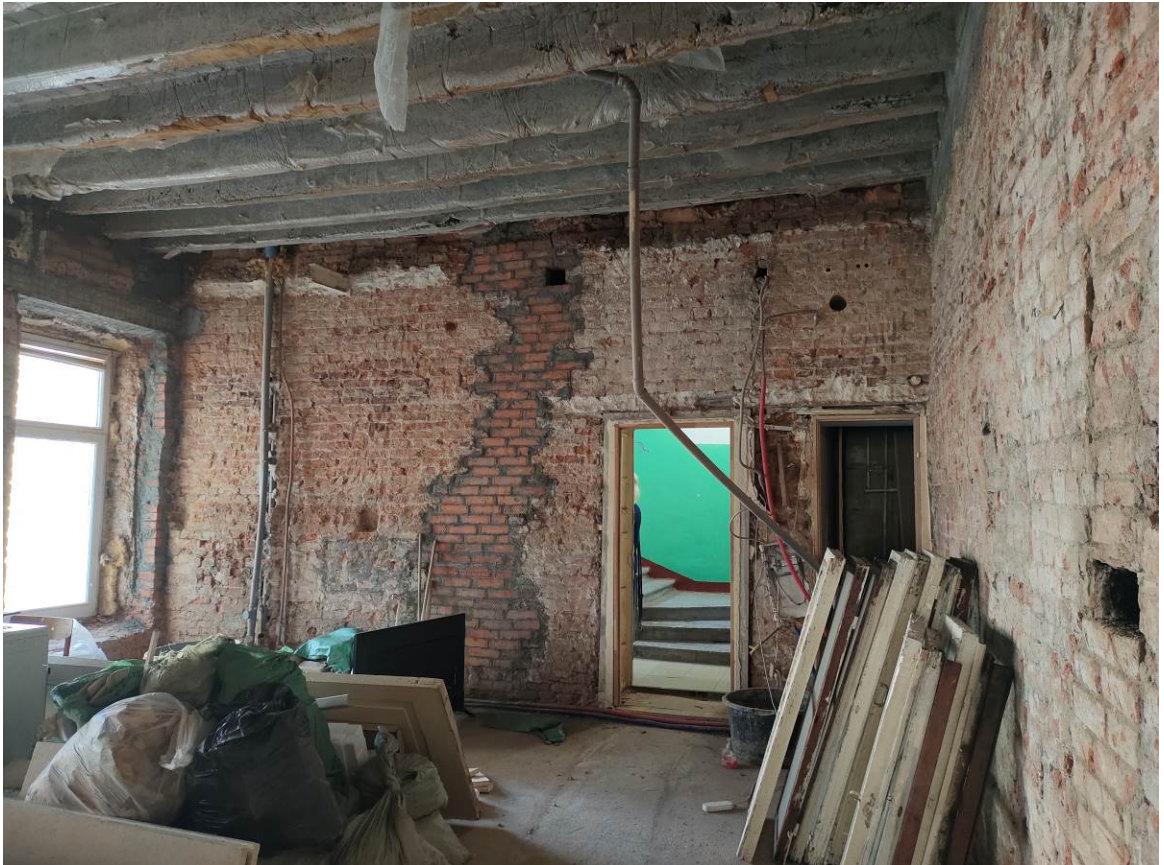
12. Выявленный ОКН «Дом Тампера» (г. Санкт-Петербург, Якубовича ул., д. 22). Помещение кв.№8.
