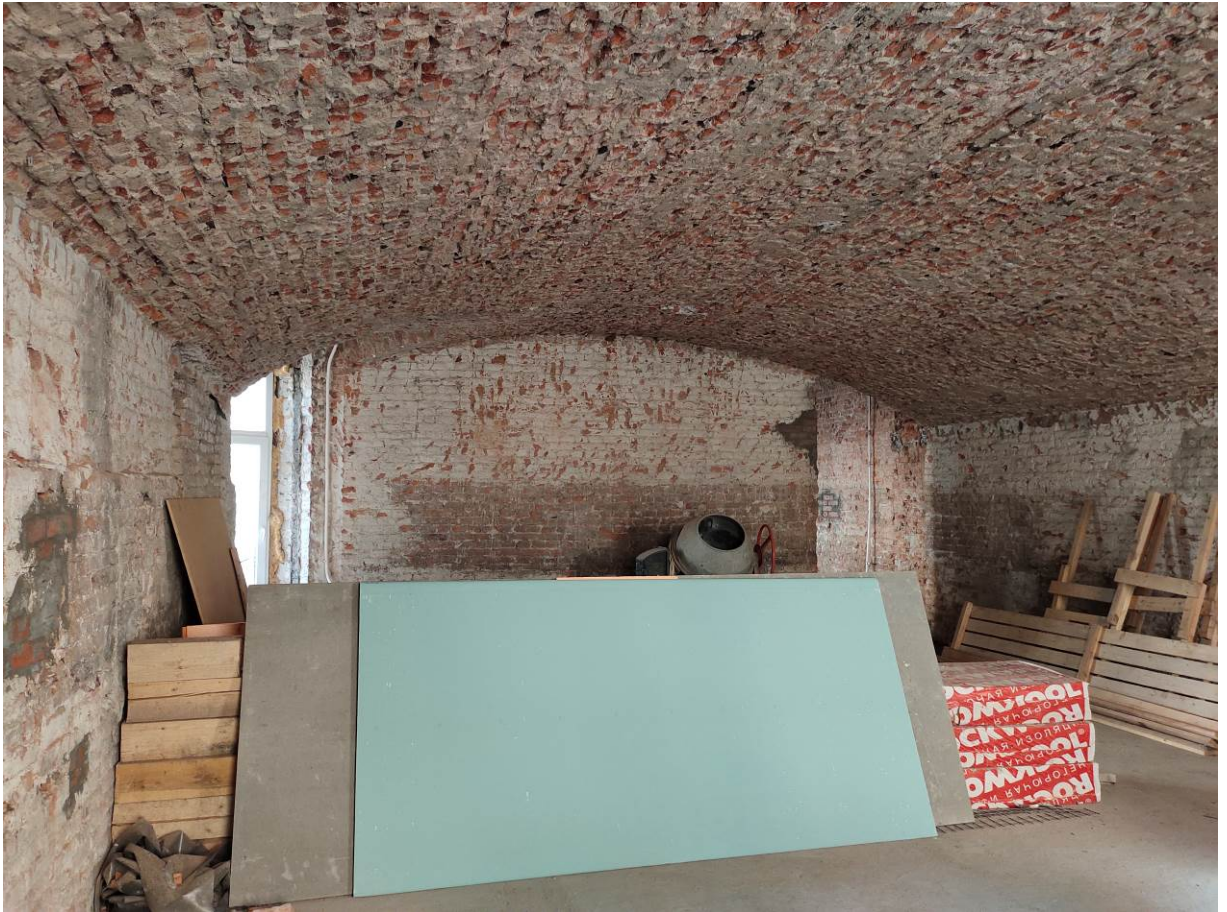
9. Выявленный ОКН «Дом Тампера» (г. Санкт-Петербург, Якубовича ул., д. 22). Помещение кв.№8.
