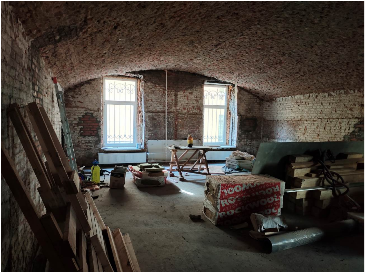
8. Выявленный ОКН «Дом Тампера» (г. Санкт-Петербург, Якубовича ул., д. 22). Помещение кв.№8.
