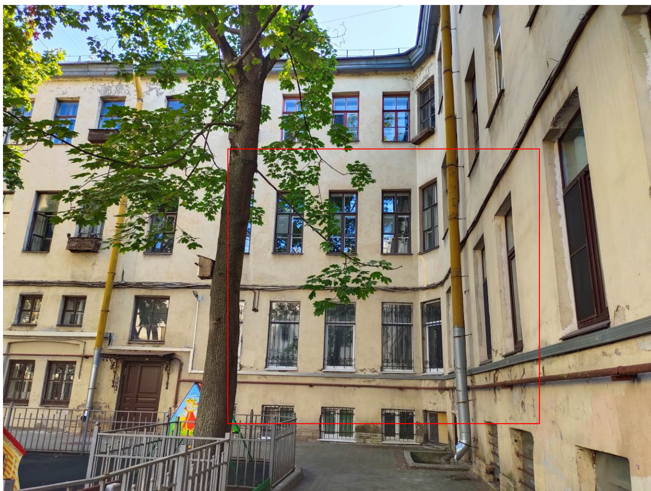
5. Выявленный ОКН «Дом Тампера» (г. Санкт-Петербург, Якубовича ул., д. 22). Дворовый фасад. Окна квартир №8 и №12.
