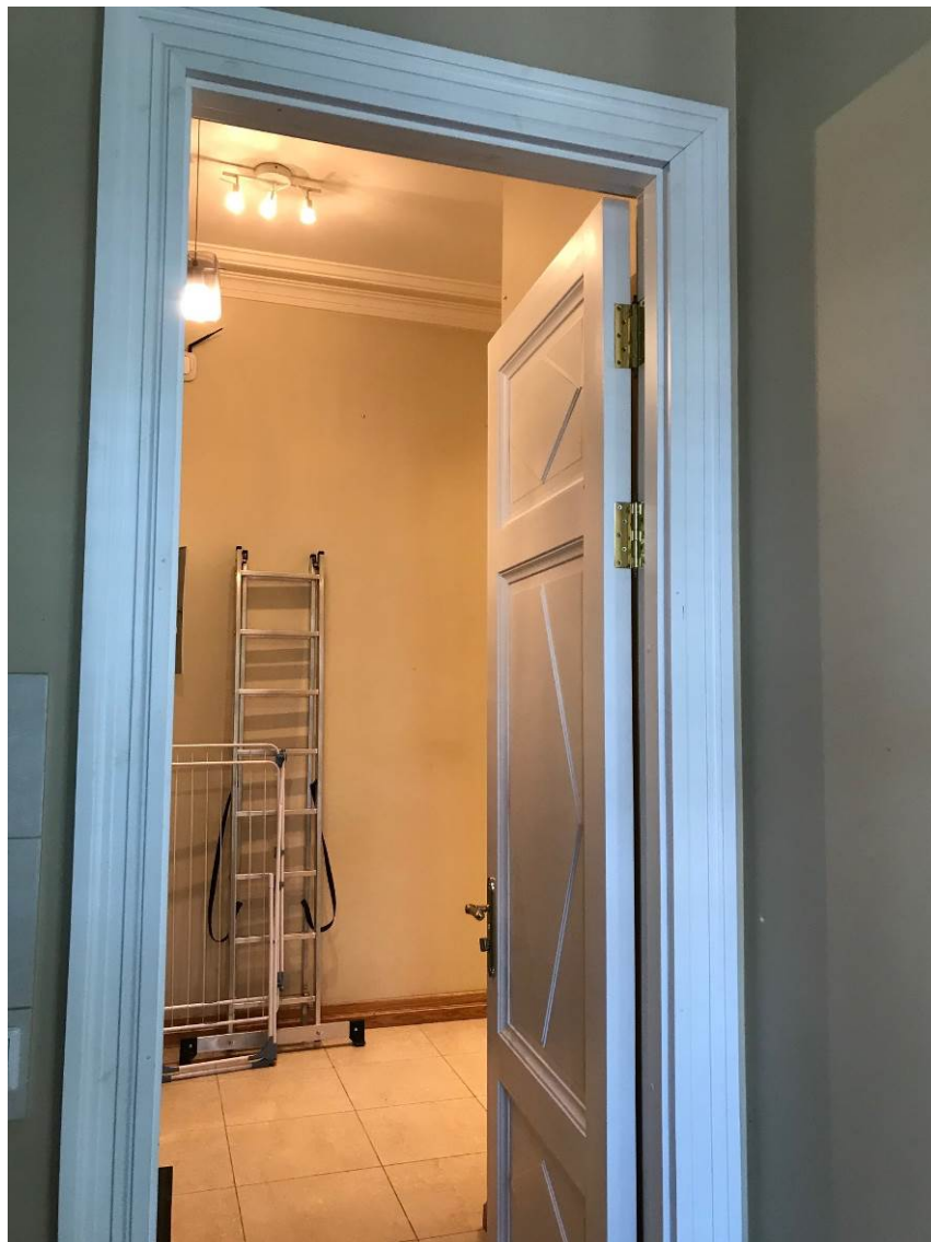
15. Выявленный ОКН «Дом Тампера» (г. Санкт-Петербург, Якубовича ул., д. 22). Помещение кв.№12.
