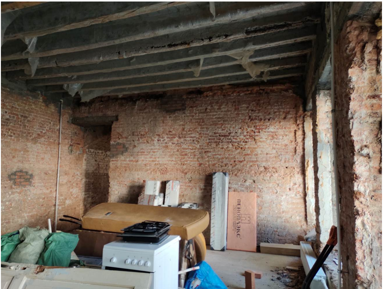
10. Выявленный объект культурного наследия «Дом Тампера» (г. Санкт-Петербург, Якубовича ул., д. 22). Помещение кв.№8.
