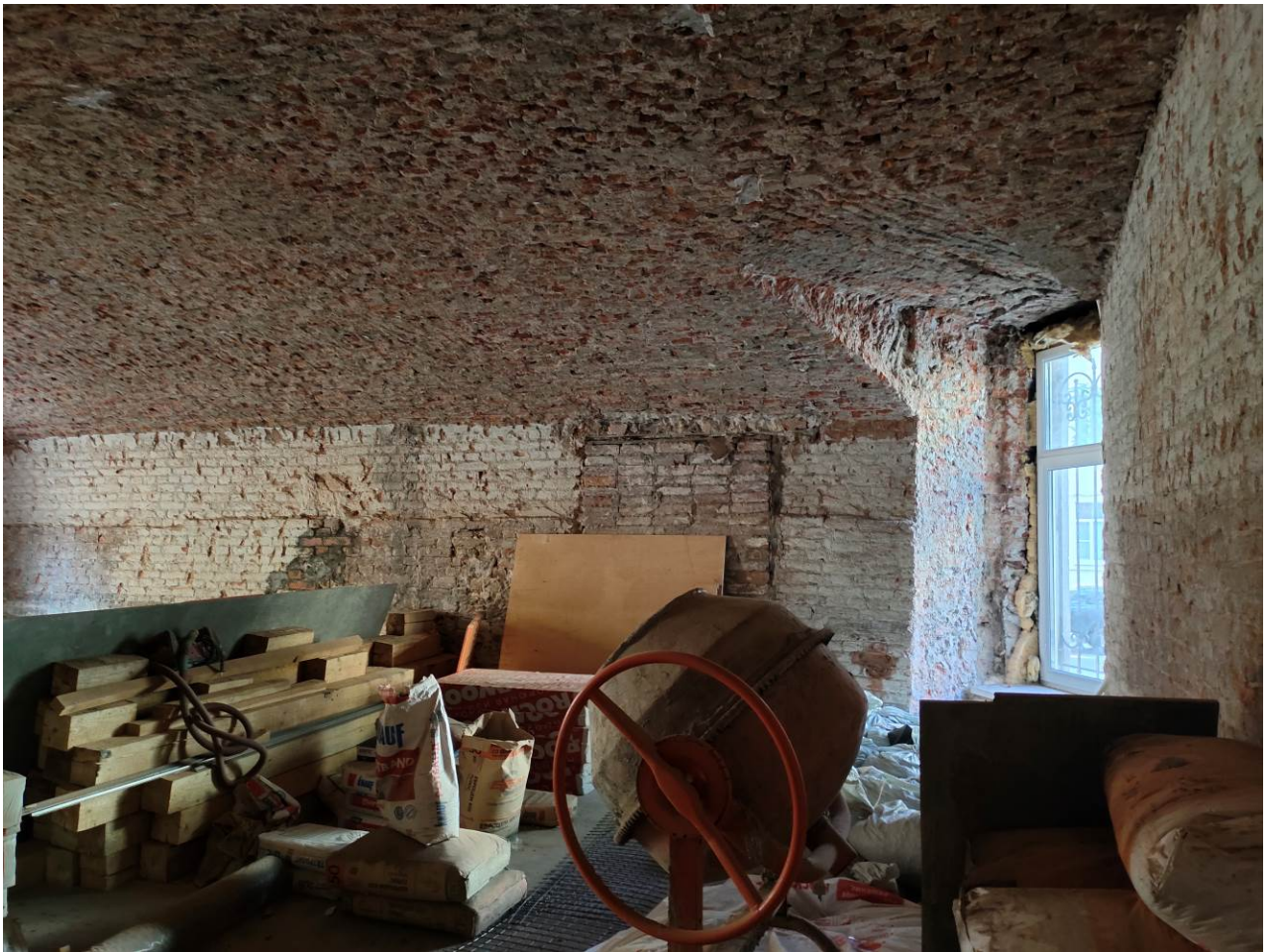
7. Выявленный ОКН «Дом Тампера» (г. Санкт-Петербург, Якубовича ул., д. 22). Помещение кв.№8.
