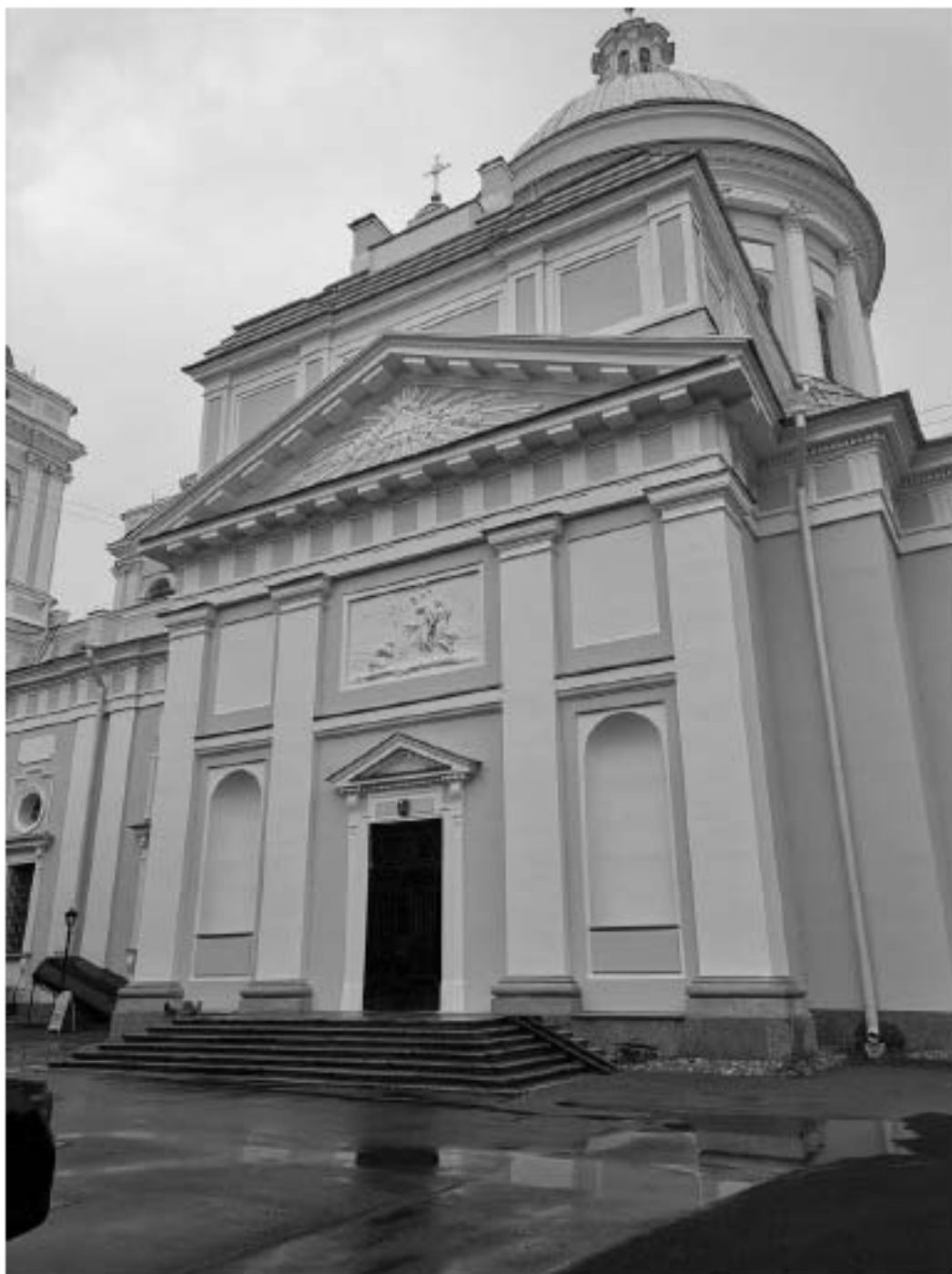
Фото 15. ОКН федерального значения «Собор Троицкий с двумя соединительными корпусами». Южный фасад. Фрагмент. Съёмка 05.07.2022 г.
