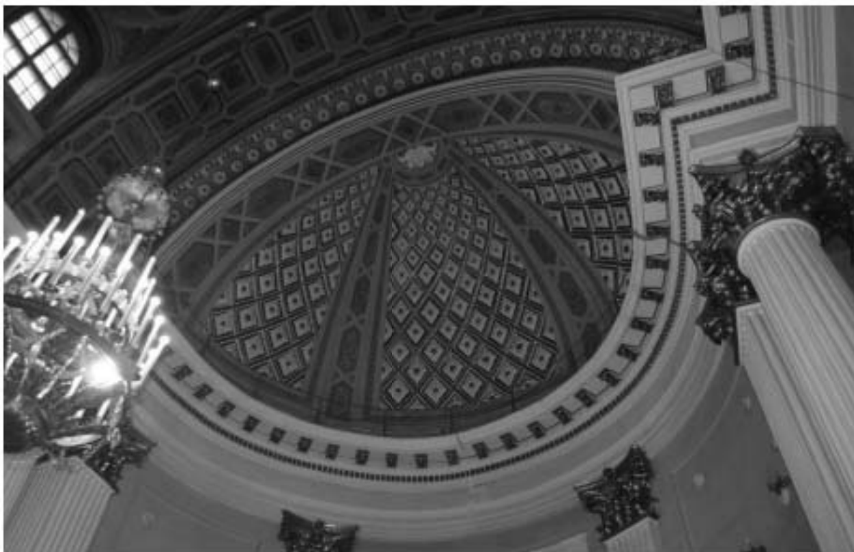
Фото 19. ОКН федерального значения «Собор Троицкий с двумя соединительными корпусами». Оформление конхи в западной стене здания. Съёмка 05.07.2022 г.
