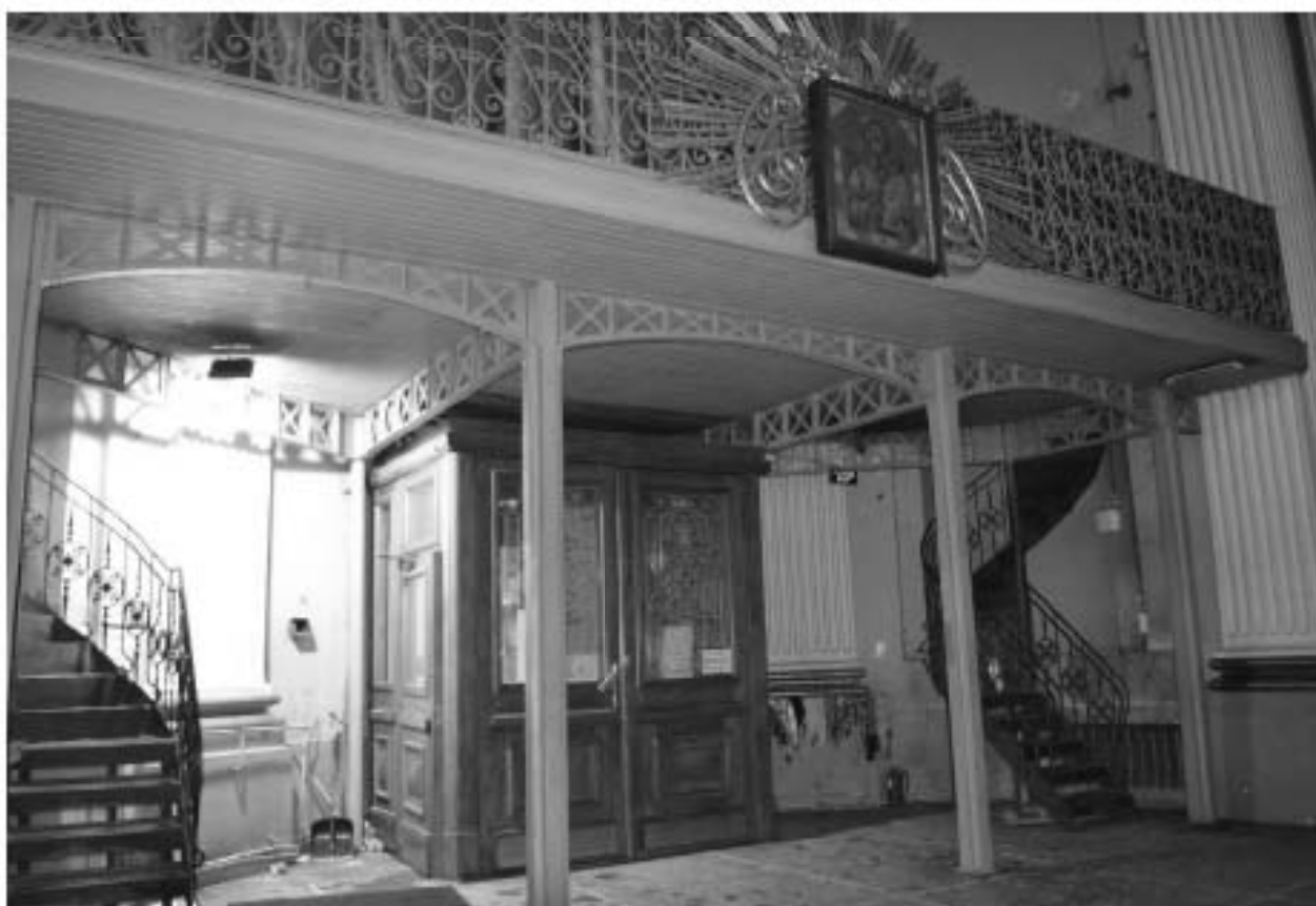
Фото 30. ОКН федерального значения «Собор Троицкий с двумя соединительными корпусами». Входной тамбур, вид на хоры. Съёмка 05.07.2022 г.
