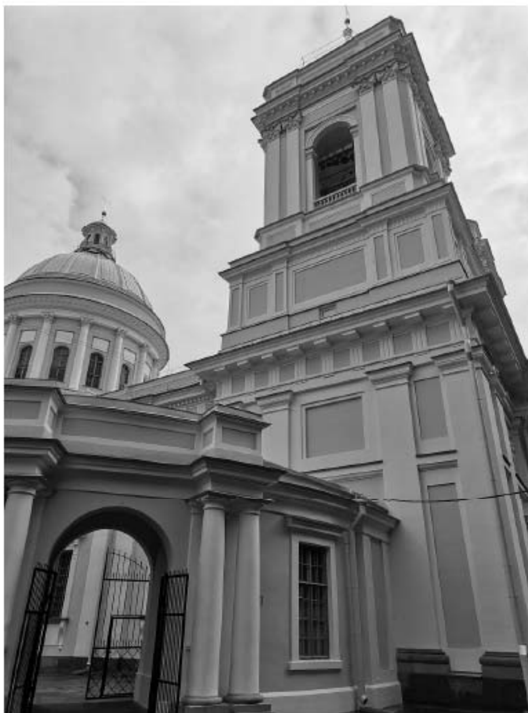
Фото 04. ОКН федерального значения «Собор Троицкий с двумя соединительными корпусами». Северный фасад. Северный соединительный корпус. Общий вид. Съёмка 05.07.2022 г.
