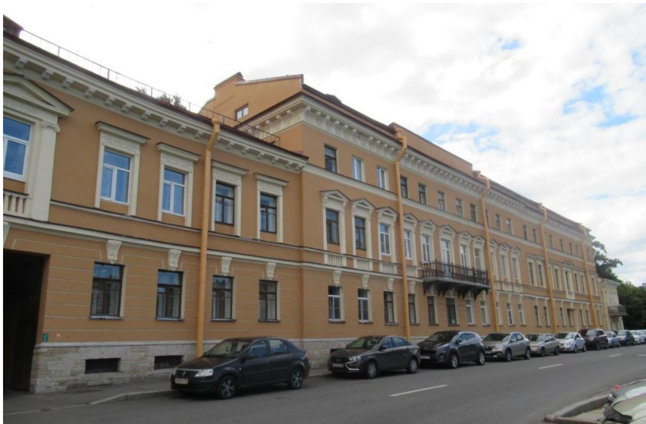
1. Лицевой (северный) фасад здания. Вид со стороны набережной реки Фонтанки.
