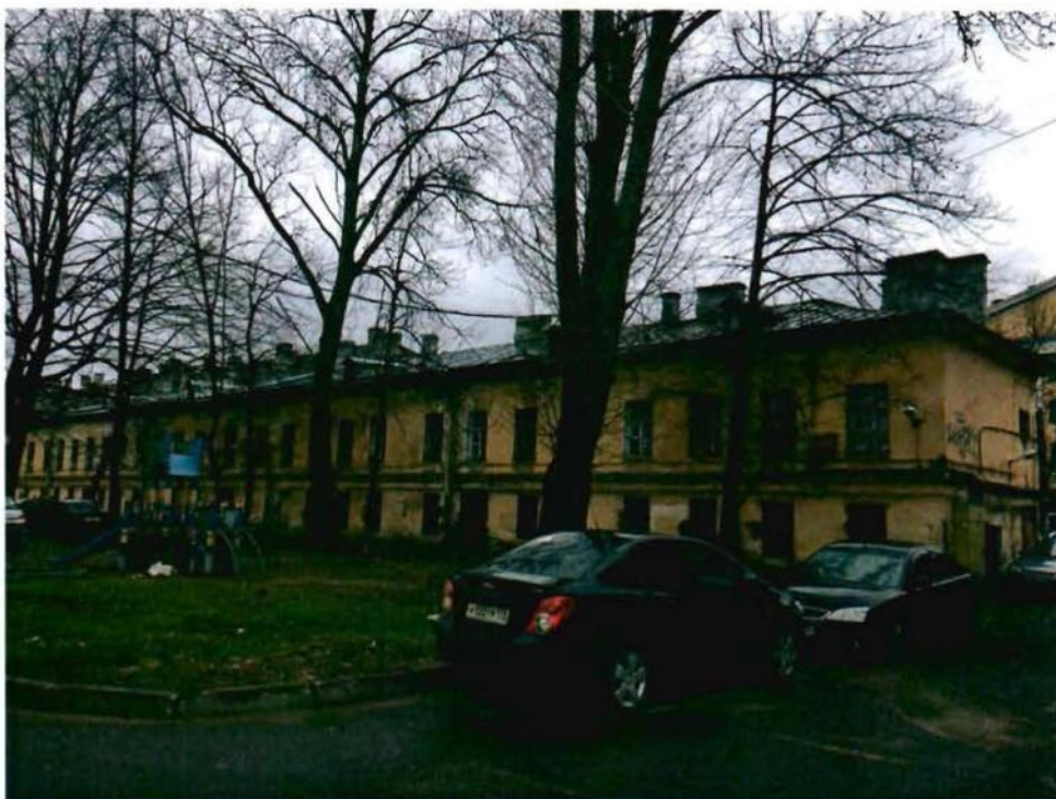
Фото 3. Западный дворовый фасад.
