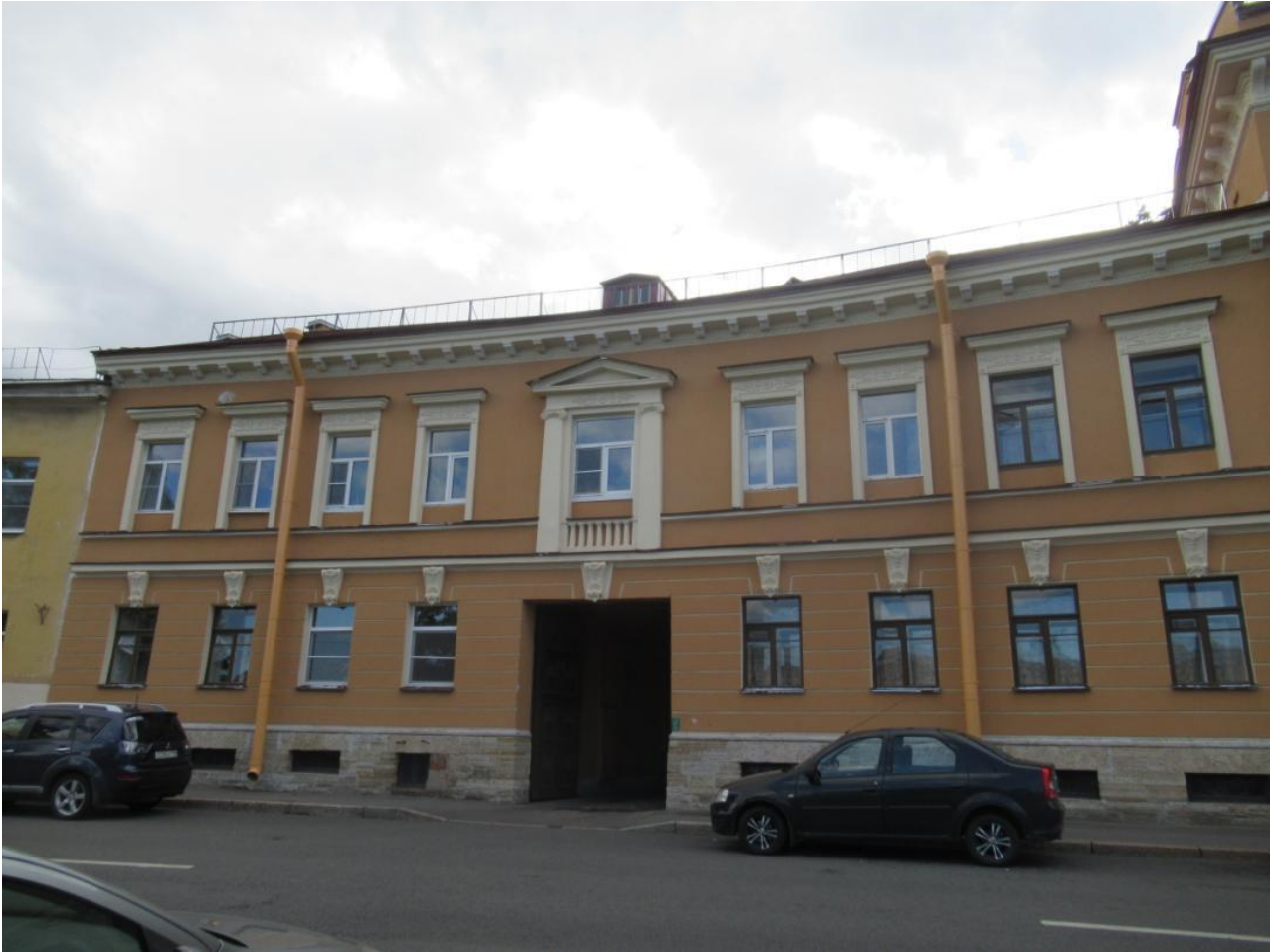
2. Фрагмент лицевого (северного) фасада здания. Вид со стороны набережной реки Фонтанки
