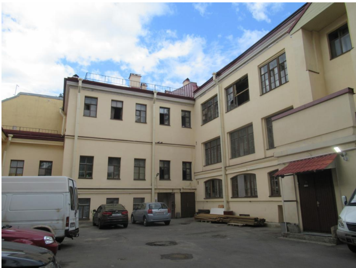
5. Фрагмент южного фасада лицевого флигеля и восточный фасад дворового флигеля.
