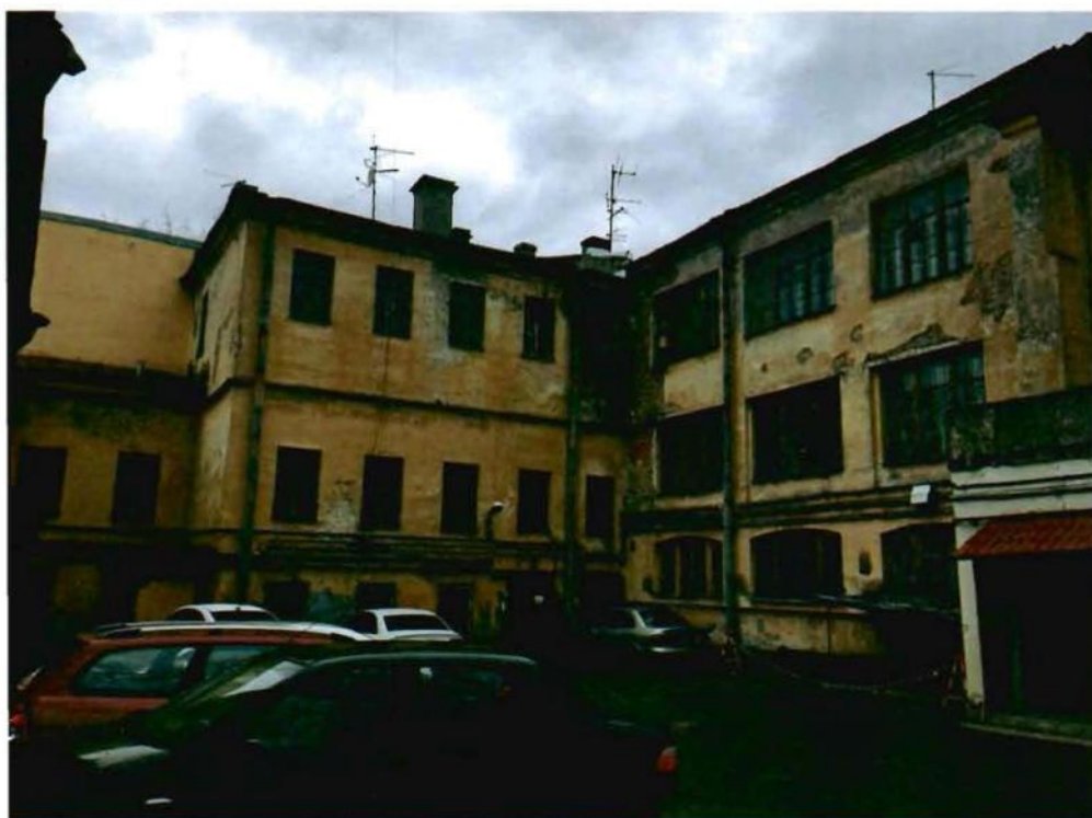
Фото 6. Южный и восточный дворовый фасад.
