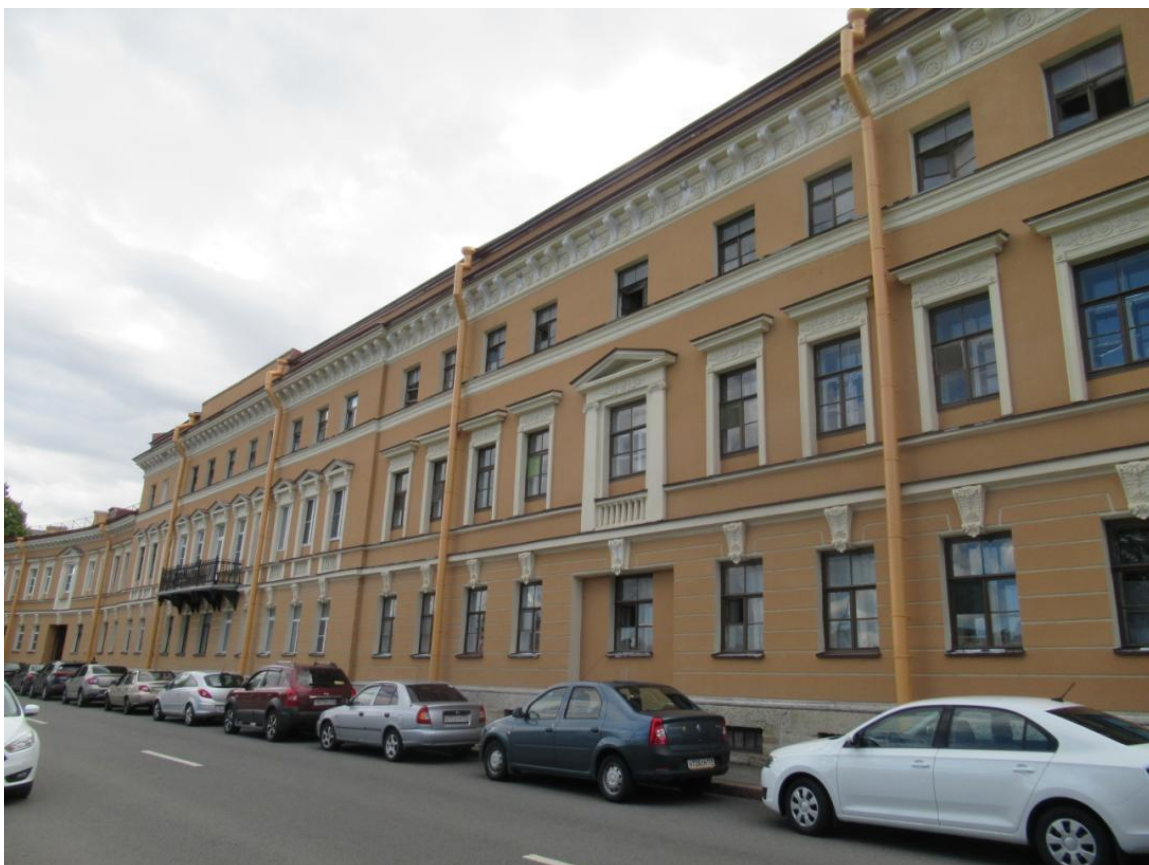
3. Лицевой (северный) фасад здания. Вид со стороны набережной реки Фонтанки.
