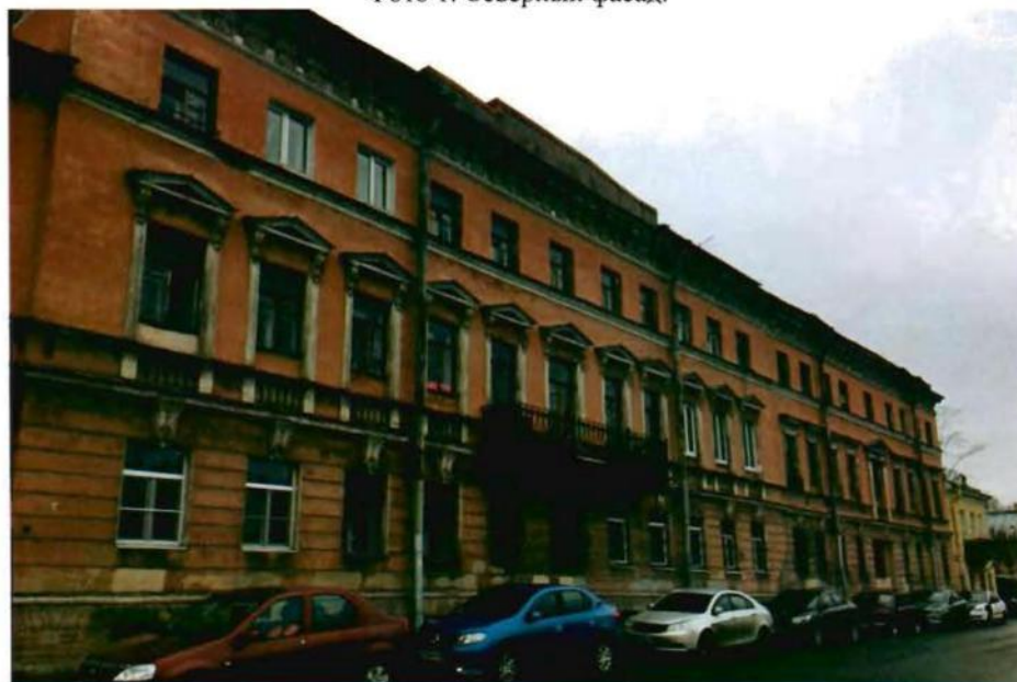
Фото 2. Часть северного фасада.
