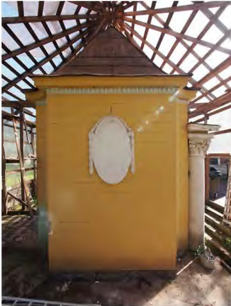
Фото 3. Северо-восточный фасад. Исторический оконный проем овального очертания заложен и оформлен в виде штукатурного медальона в обрамлении лепного декора. 25.08.2022
