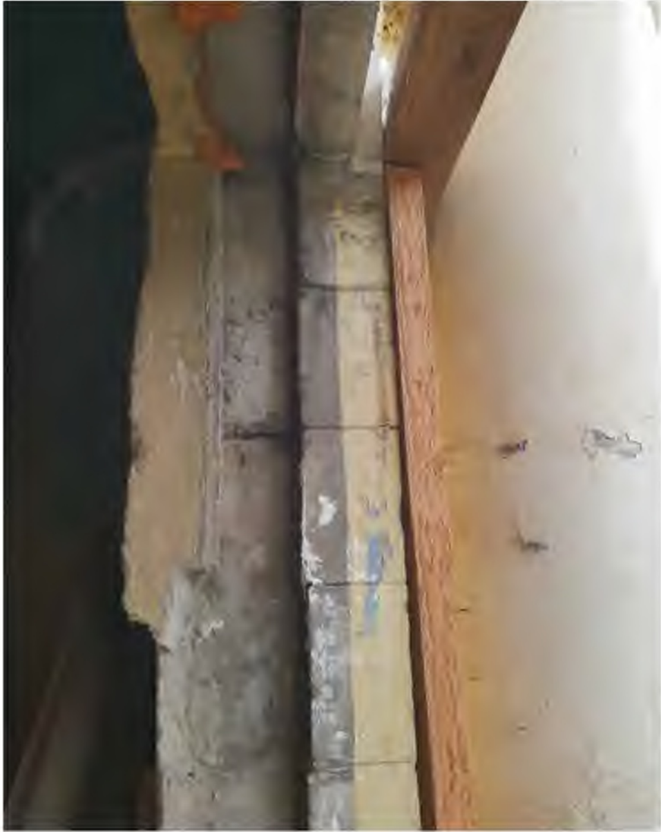
Фото 17. Фрагмент дверного проема северо-западного фасада с временным усилением деревянными элементами. 25.08.2022
