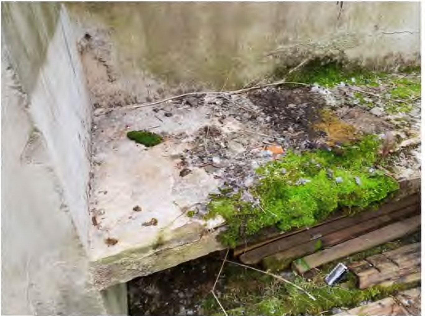
Фото 22. Фрагмент бетонной скамейки террасы стилобата (со стороны юго-западного фасада). 25.08.2022
