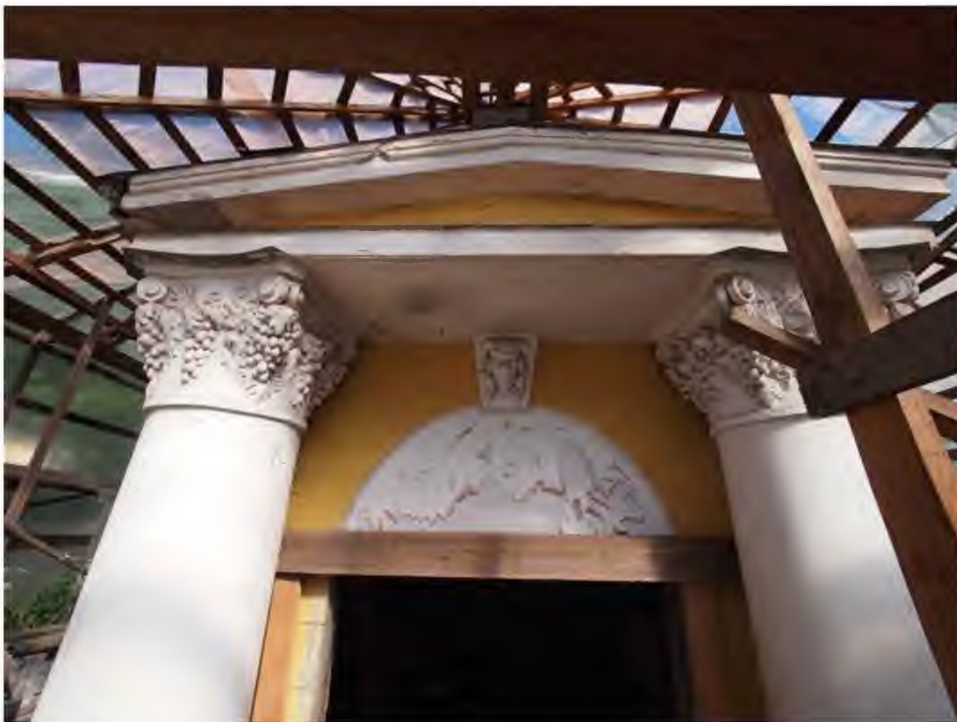
Фото 6. Фрагмент портика входа с треугольным фронтоном на колоннах композитного ордера (исторический антаблемент трапециевидной формы с надписью фирмы Бодо Эгесторф утрачен). 25.08.2022
