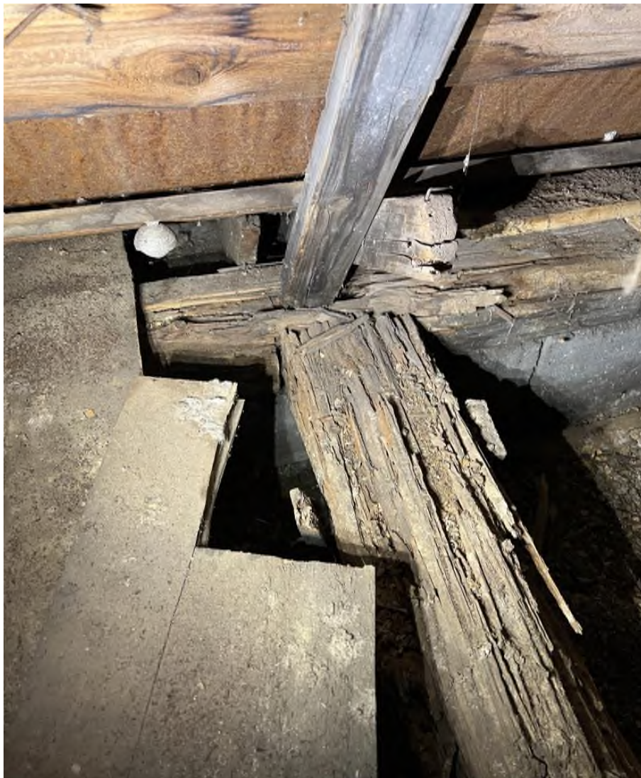
Фото 30. Участок перекрытия беседки. Дошчатое по деревянным балкам (позднейшее) 25.08.2022
