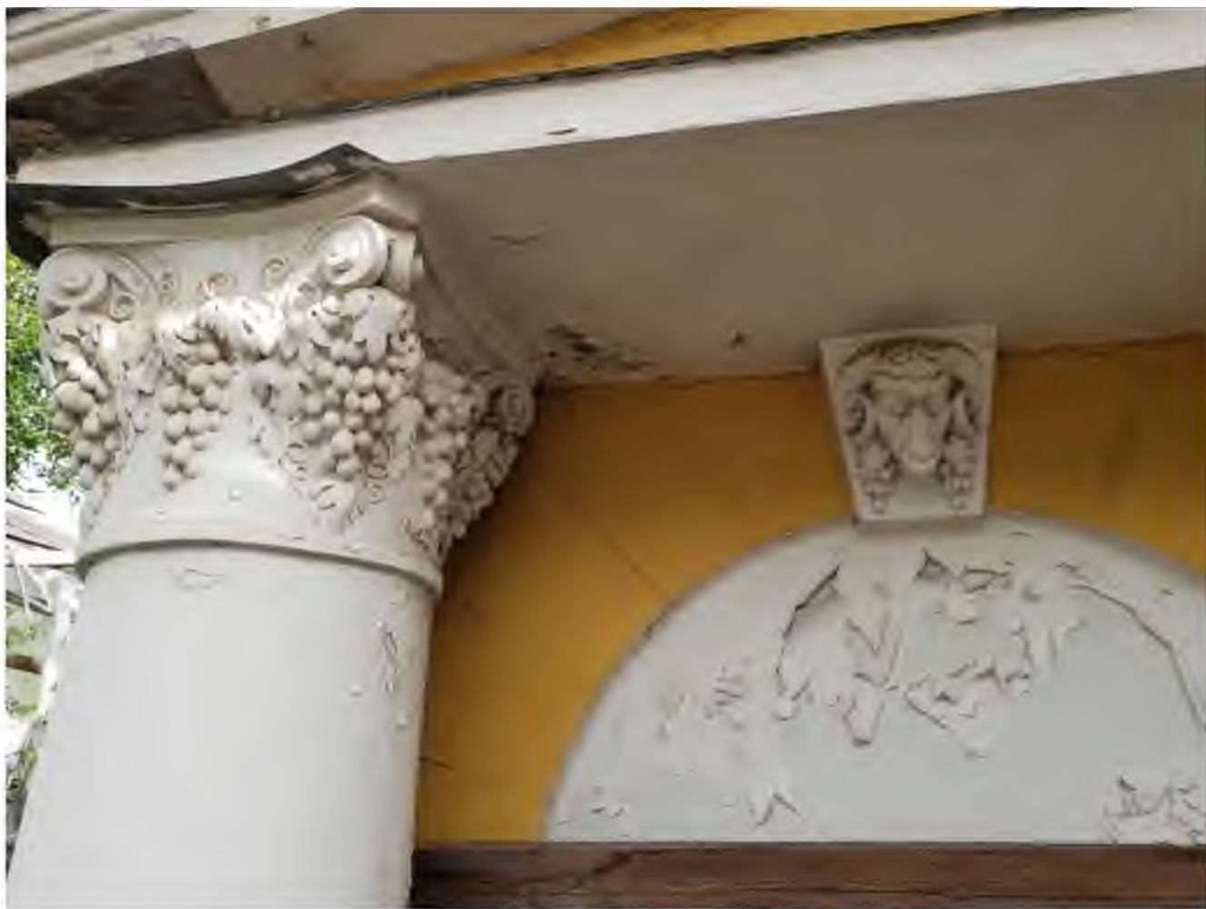
Фото 11. Фрагмент колонны композитного ордера, полуциркульный тимпан над дверным проемом, замковый камень с букранием (в виде головы овна). 25.08.2022
