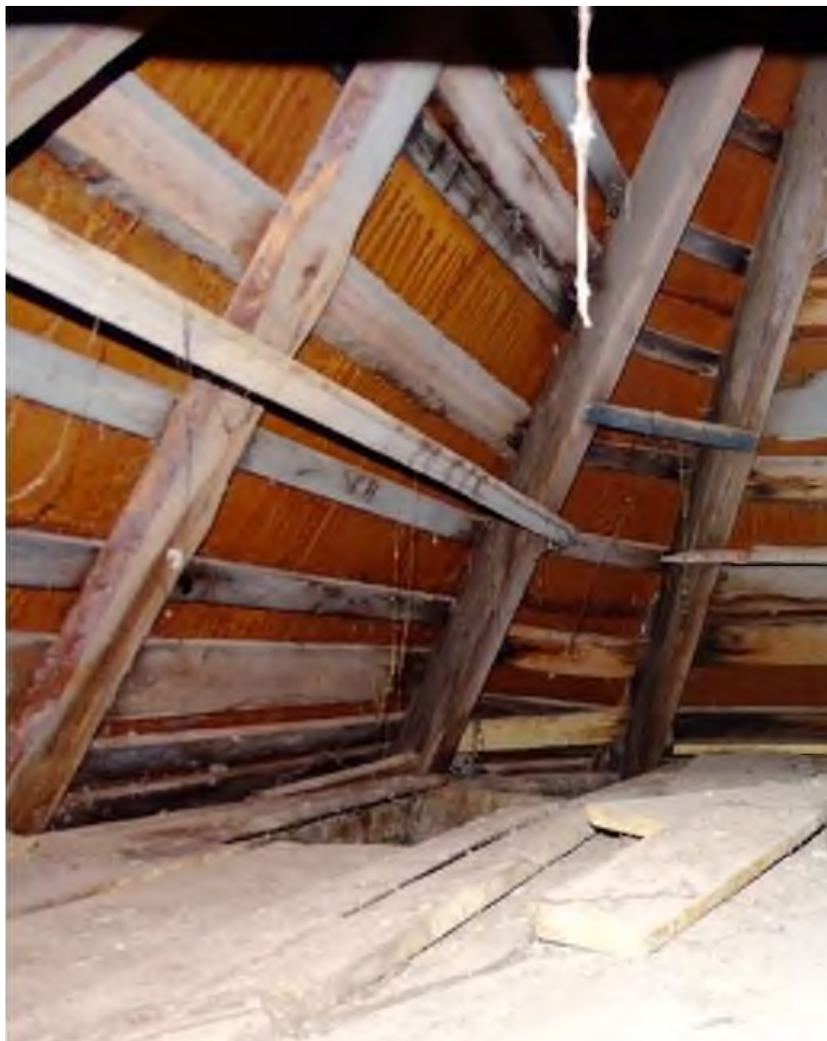
Фото 31. Фрагмент стропильной системы крыши (деревянные конструкции позднейшие) 25.08.2022
