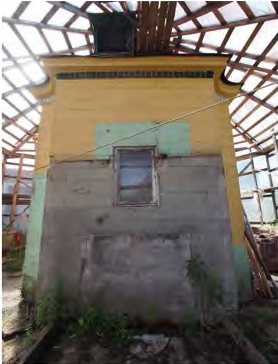
Фото 4. Юго-восточный фасад. Поздний оконный проем прямоугольной конфигурации (исторический проем овального очертания утрачен) 25.08.2022
