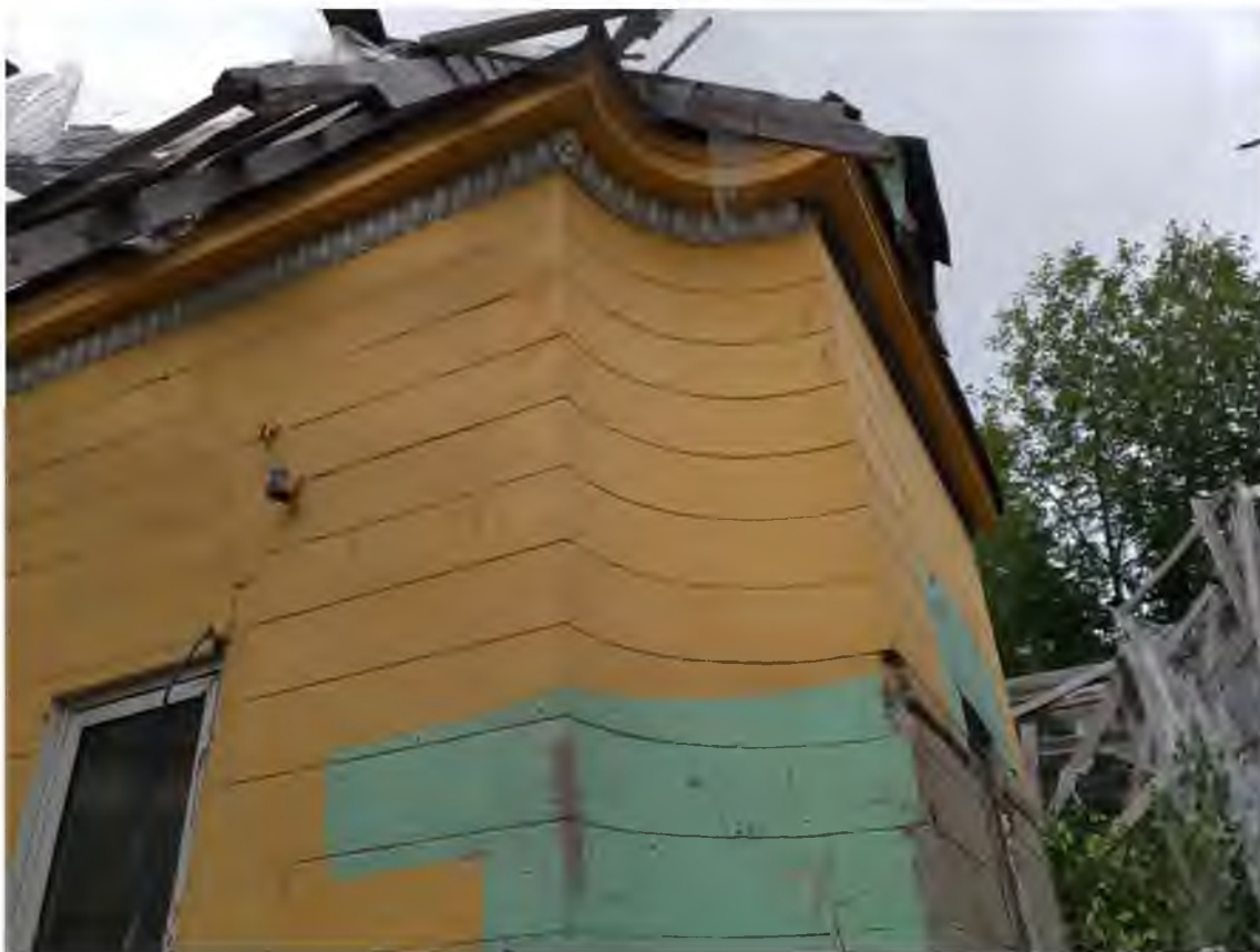
Фото 8. Фрагмент фасада с «обратным» скругленным углом в пересечении бетонных стен 25.08.2022
