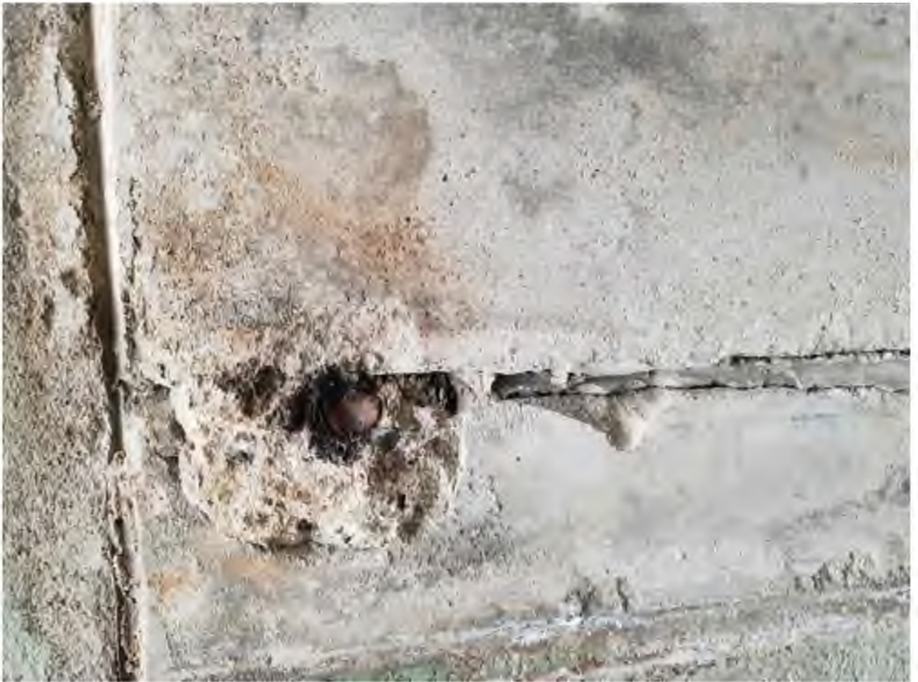
Фото 20. Фрагмент участка стены юго-восточного фасада. 25.08.2022
