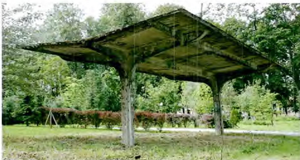
Фото №1. «Железобетонный навес товарищества "Железо-бетон"».
