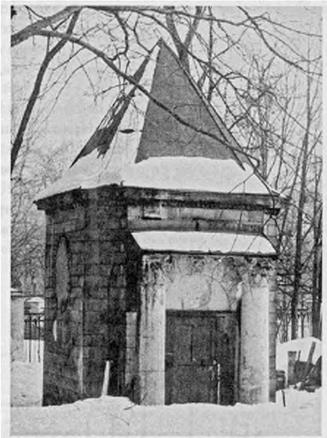
Илл. 41. Фотография сохранившегося павильона Бодо Эггесторф. [1990-е?] Опубликовано: Сооружения Международной строительно-художественной выставки 1908 г.// Памятники архитектуры и истории Санкт-Петербурга. Петроградский район. СПб., 2004. С. 353. https://www.citywalls.ru/photo345446.html
