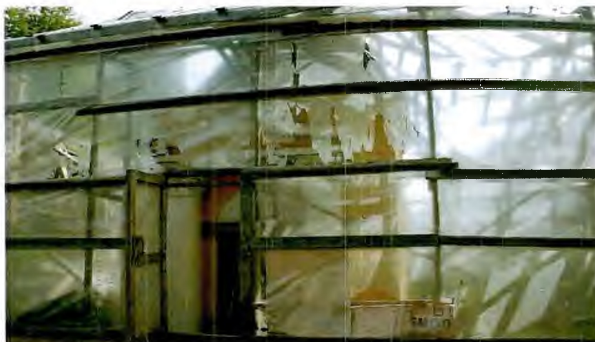
Фото №2. «Железобетонная беседка».
