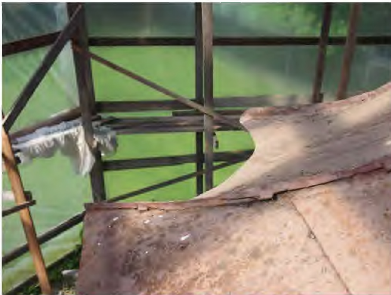
Фото 32. Фрагмент металлического покрытия крыши (тип соединения картин – одинарный стоячий фальц). 25.08.2022
