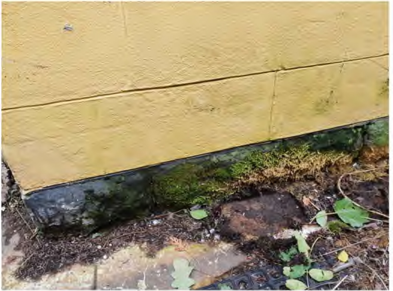
Фото 15. Фрагмент цокольной части фасада. 25.08.2022
