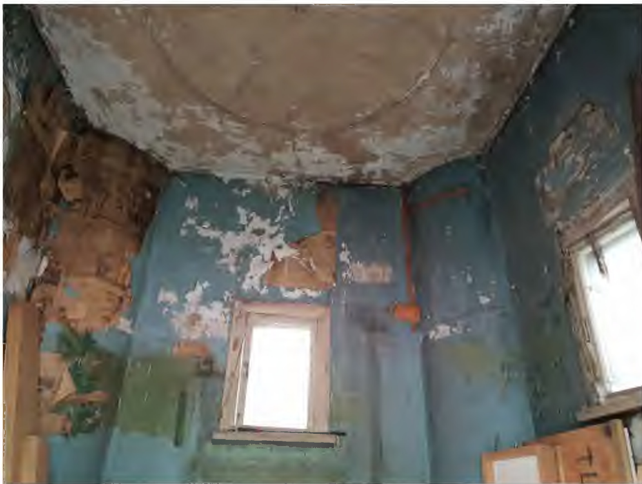
Фото 25. Фрагмент помещения беседки. Поздние оконные проемы прямоугольной конфигурации. 25.08.2022
