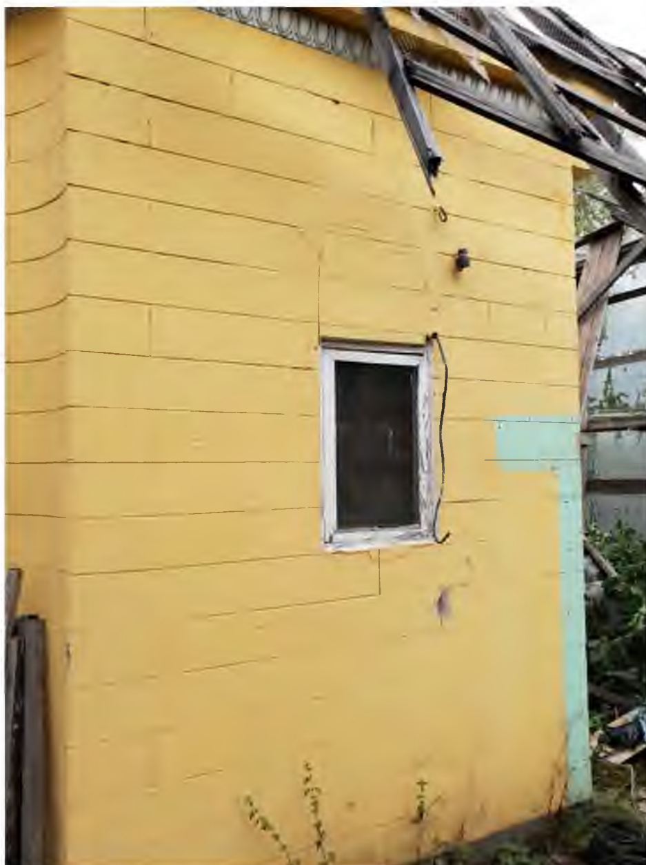
Фото 5. Юго-западный фасад. Поздний оконный проем прямоугольной конфигурации (исторический проем овального очертания утрачен) 25.08.2022
