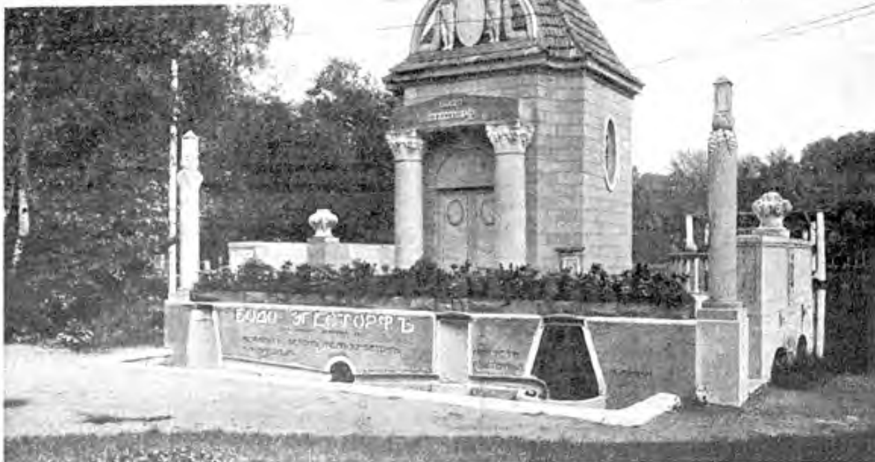
Павильонъ фирмы Бодо Эггесторффъ на Художественно-Строительной Выставкѣ 1908 г., построенъ изъ бетонныхъ пустотелыхъ фасадныхъ камней.
