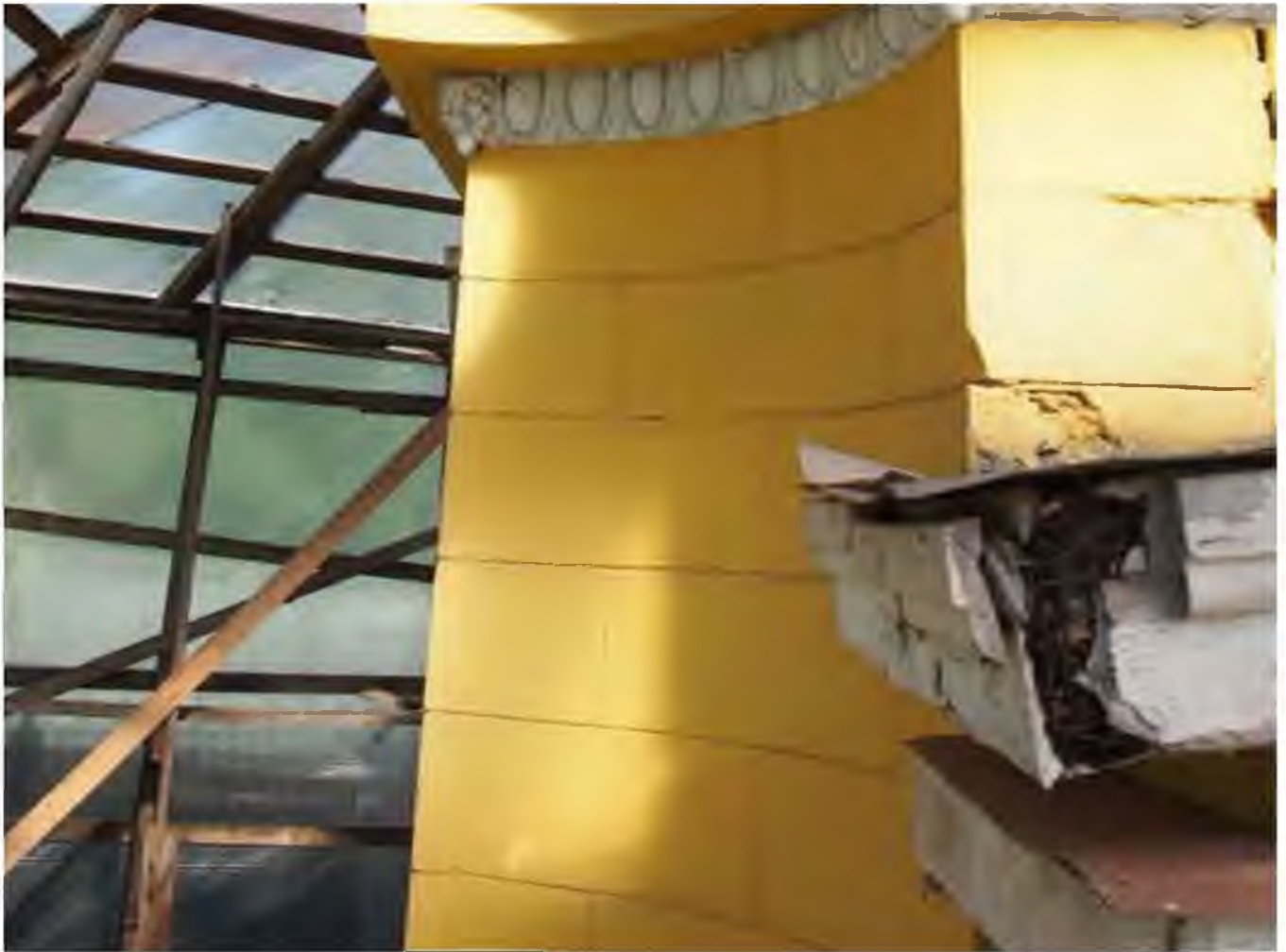
Фото 19. Фрагмент фасада со стороны угла северо-западного фасада. 25.08.2022
