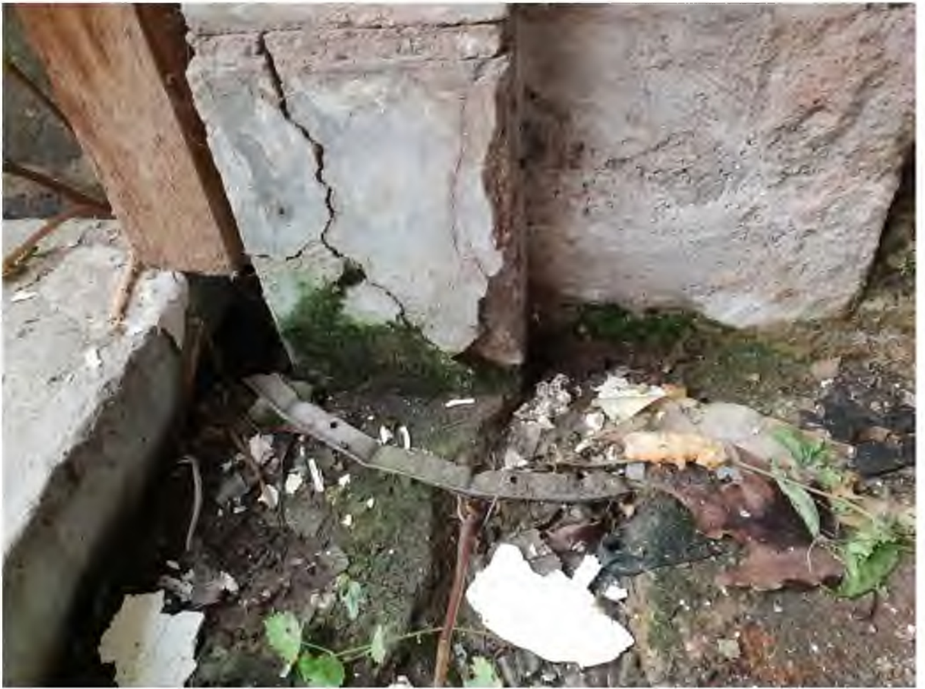
Фото 16. Фрагмент откоса дверного проема северо-западного фасада. 25.08.2022
