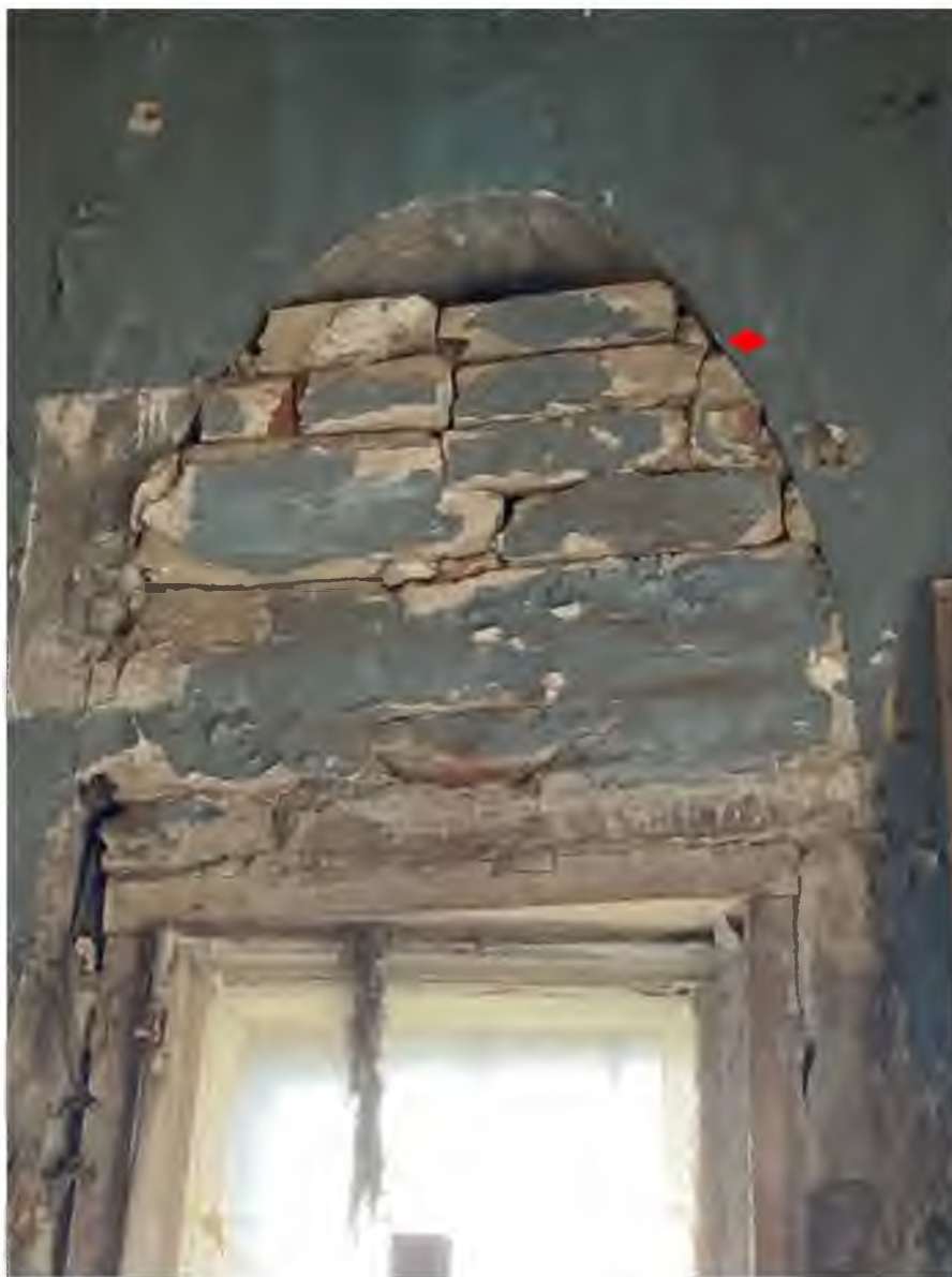
Фото 27. Фрагмент участка стены с закладкой кирпичом исторического оконного проема овального очертания 25.08.2022
