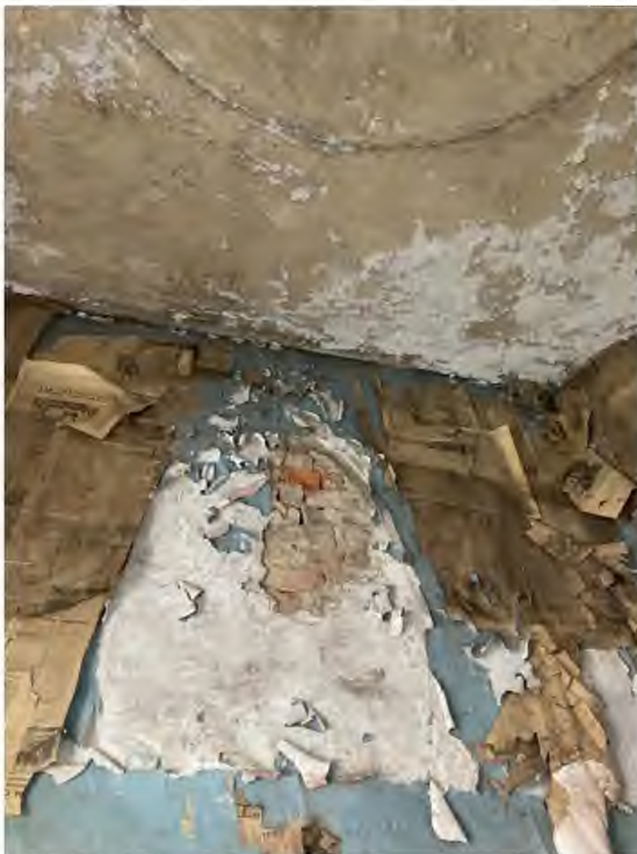
Фото 29. Фрагмент глухой стены в помещении беседки с заложеным историческим оконным проемом овальной очертания. 25.08.2022
