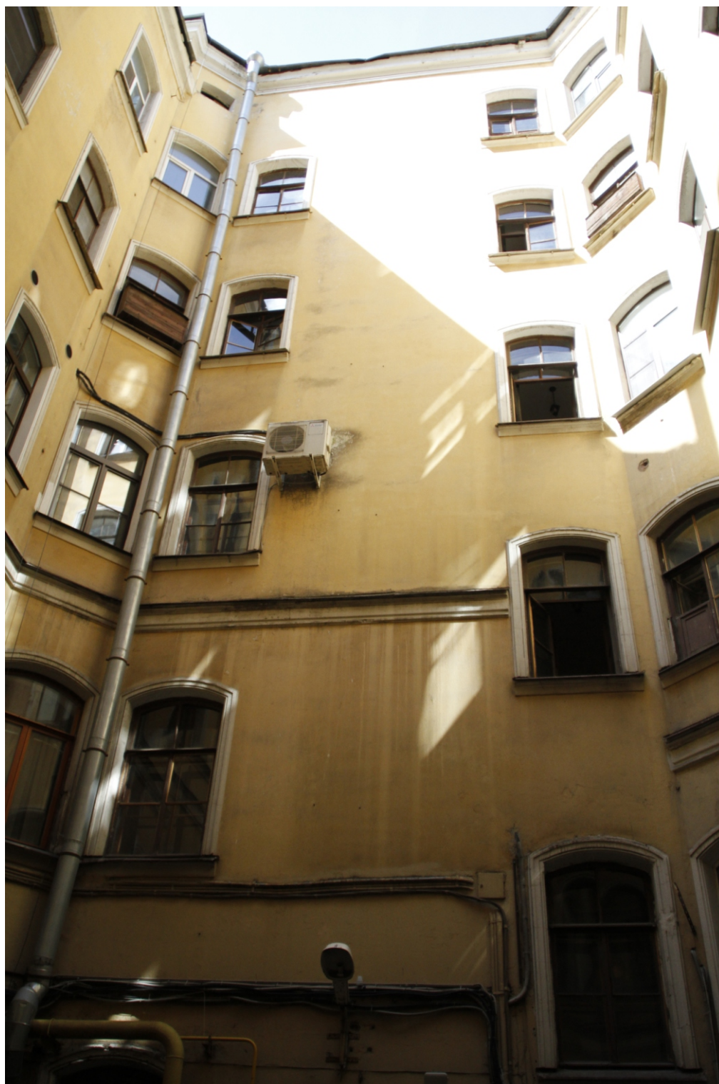
9. «Дом Г.Г.Елисеева». Санкт-Петербург, ул. Ломоносова, д.14, литера А. 1-й двор. Фрагмент дворового фасада. Фото: 01.07.2022 г.
