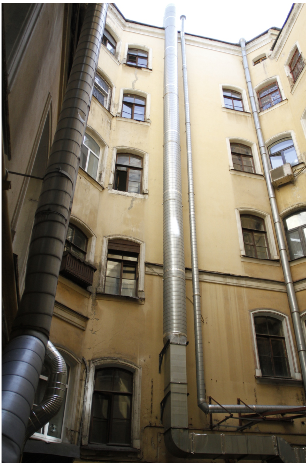
17. «Дом Г.Г.Елисеева». Санкт-Петербург, ул. Ломоносова, д.14, литера А. 2-й двор. Фрагмент дворового фасада. Фото: 01.07.2022 г.
