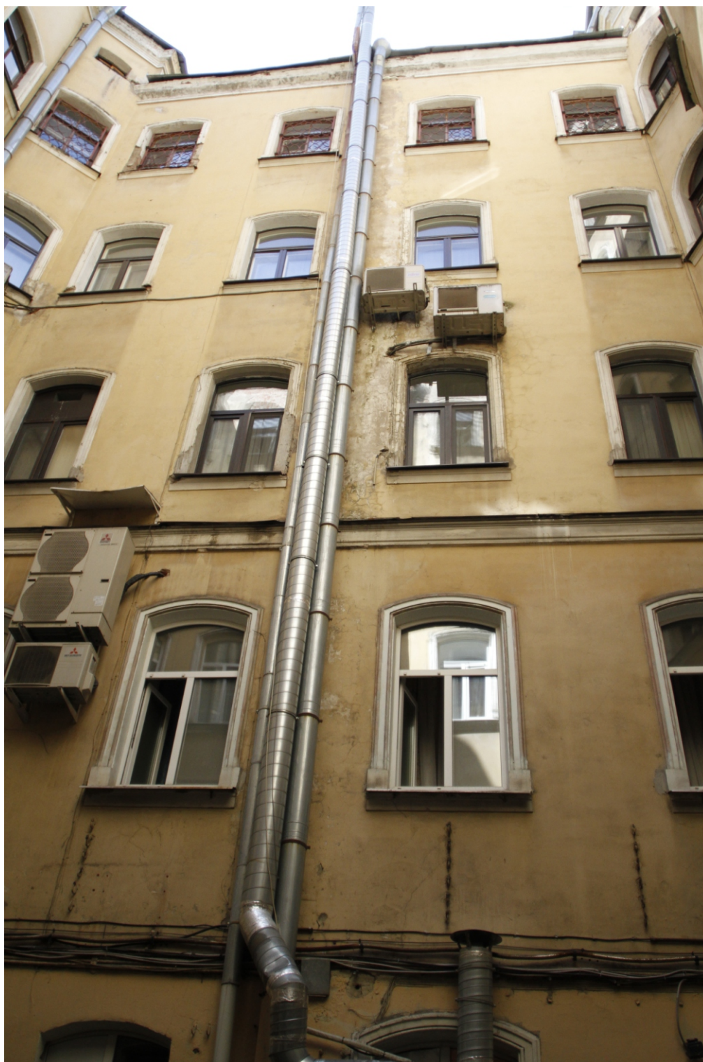
18. «Дом Г.Г.Елисеева». Санкт-Петербург, ул. Ломоносова, д.14, литера А. 2-й двор. Фрагмент дворового фасада. Фото: 01.07.2022 г.
