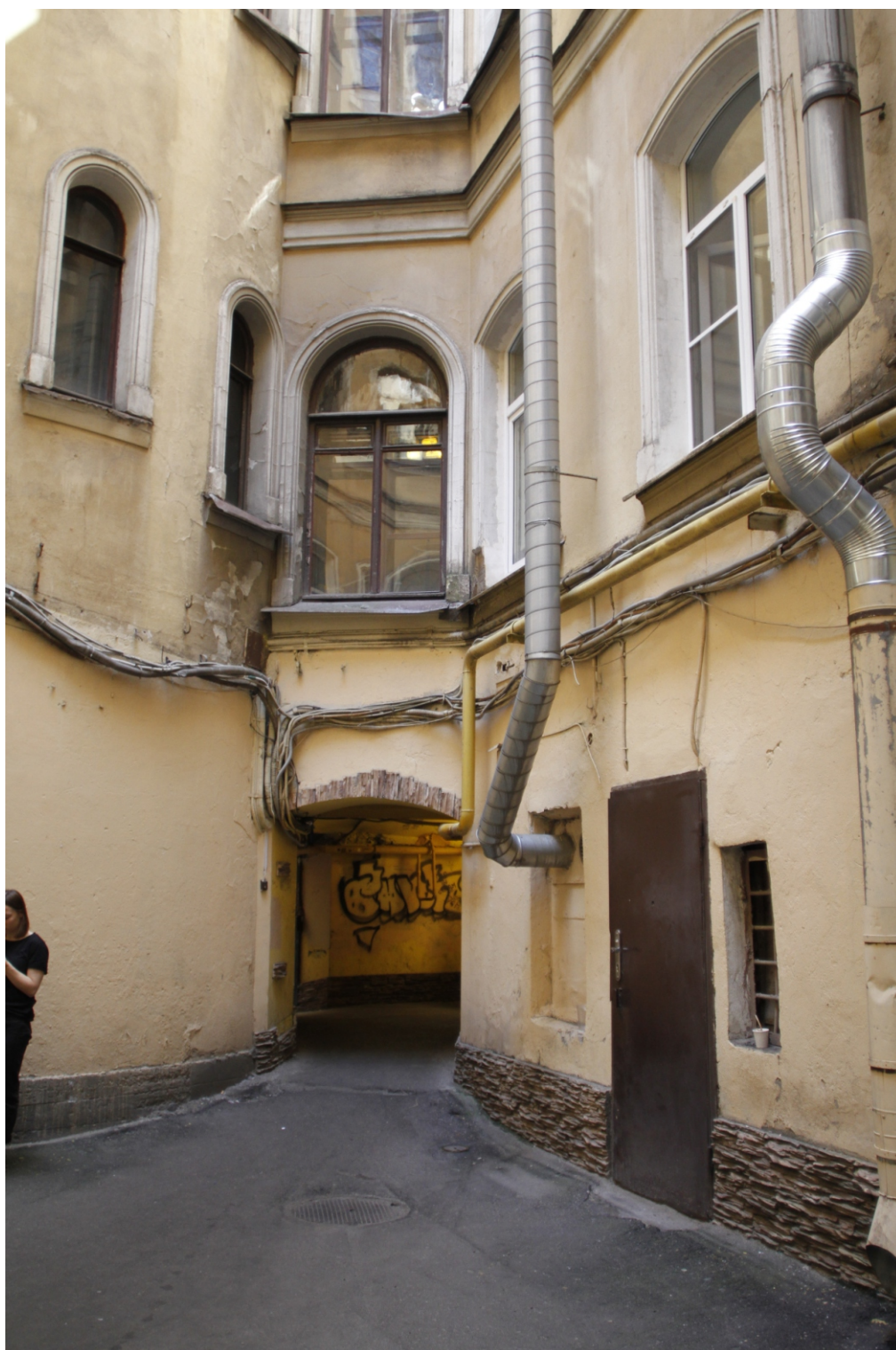
16. «Дом Г.Г.Елисеева». Санкт-Петербург, ул. Ломоносова, д.14, литера А. 2-й двор. Фрагмент дворового фасада. Фото: 01.07.2022 г.
