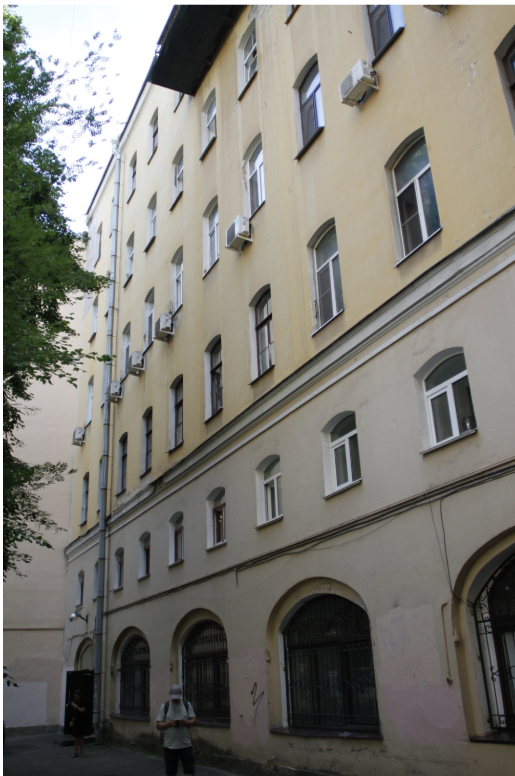
20. «Дом Г.Г.Елисеева». Санкт-Петербург, ул. Ломоносова, д.14, литера А. 3-й двор. Фрагмент фасада. Фото: 01.07.2022 г.
