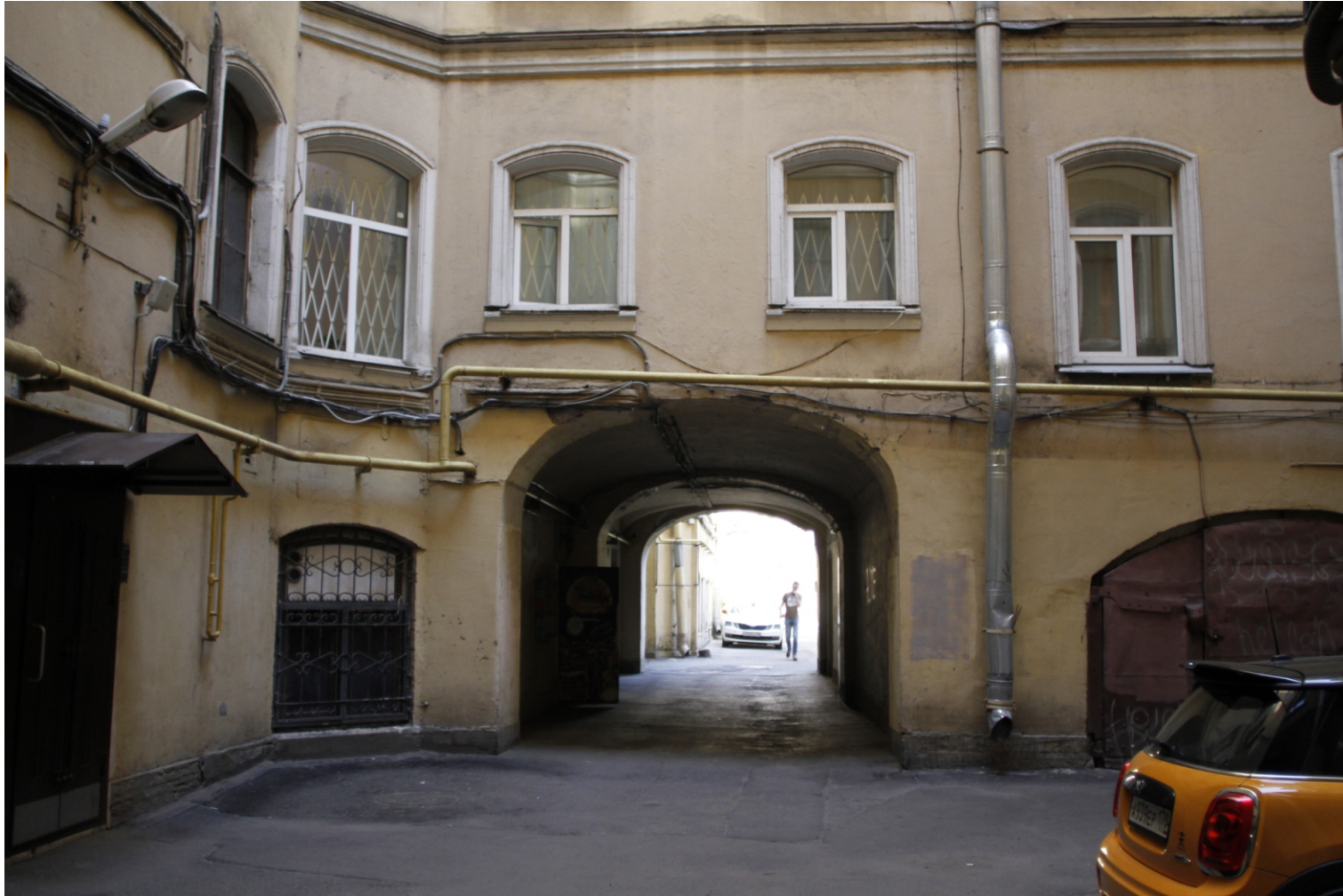
10. «Дом Г.Г.Елисеева». Санкт-Петербург, ул. Ломоносова, д.14, литера А. 1-й двор. Фрагмент дворового фасада. Фото: 01.07.2022 г.
