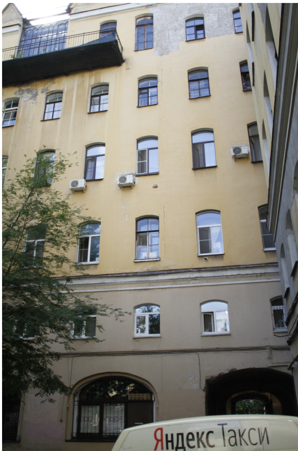
21. «Дом Г.Г.Елисеева». Санкт-Петербург, ул. Ломоносова, д.14, литера А. 3-й двор. Фрагмент фасада. Фото: 01.07.2022 г.
