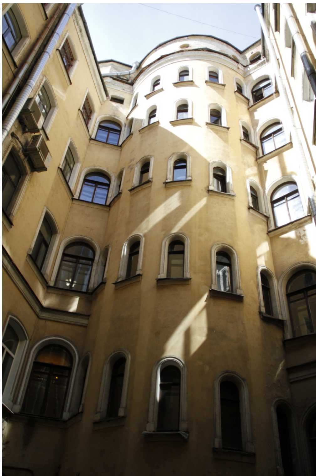
14. «Дом Г.Г.Елисеева». Санкт-Петербург, ул. Ломоносова, д.14, литера А. 1-й двор. Фрагмент дворового фасада. Фото: 01.07.2022 г.
