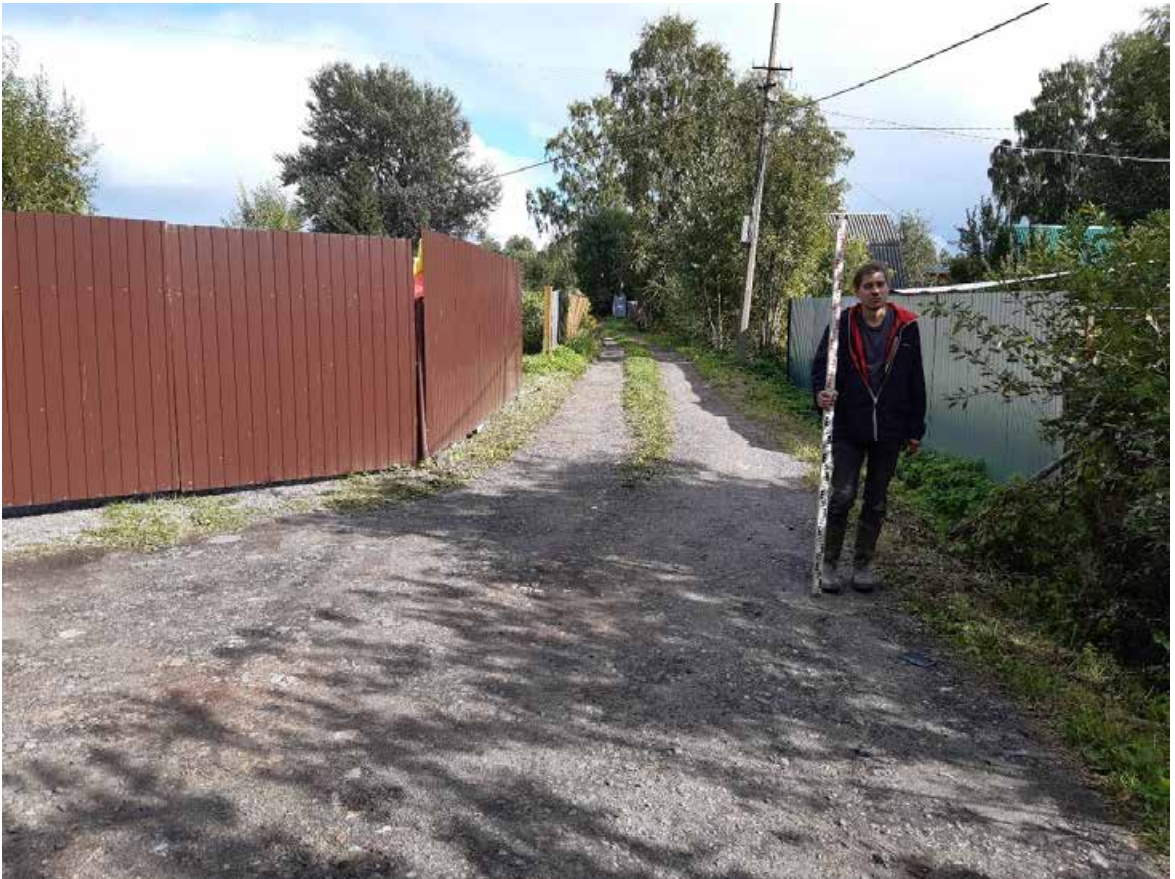
Рис. 73 Санкт-Петербург, Д. Рыбацкое. Общий вид трассы обследования. Точка съемки 23. Вид на восток.
