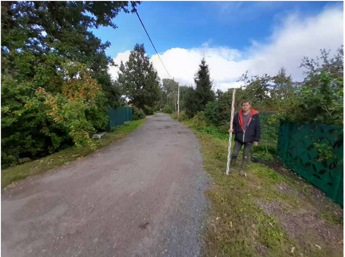
Рис. 67. Санкт-Петербург, Д. Рыбацкое. Общий вид трассы обследования. Точка съемки 20. Вид на запад.
