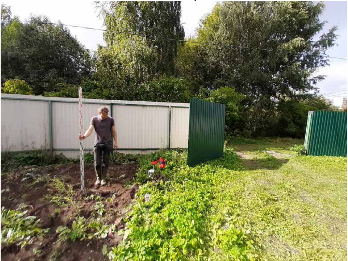
Рис. 89. Санкт-Петербург, Деревня Рыбацкое Шурф 2. Общий вид до начала работ. Вид на запад.
