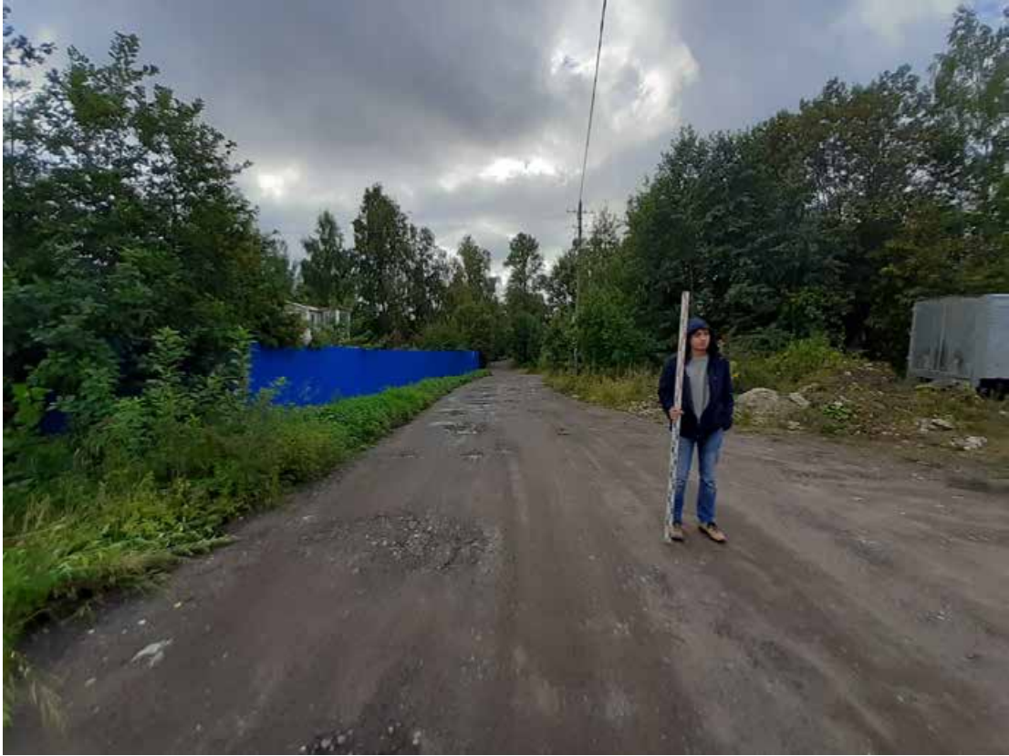
Рис. 47. Санкт-Петербург, Д. Рыбацкое. Общий вид трассы. обследования Точка съёмки 9. Вид на юг.
