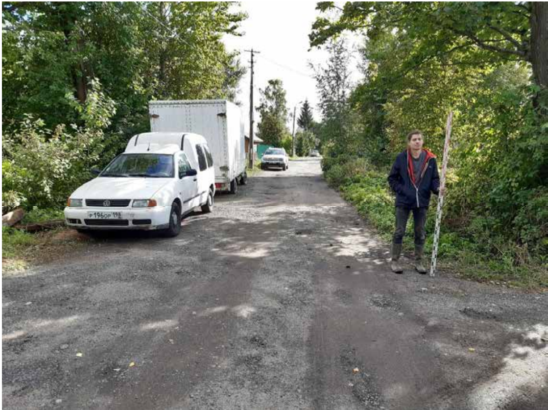
Рис. 74. Санкт-Петербург, Д. Рыбацкое. Общий вид трассы обследования. Точка съемки 23. Вид на юг.
