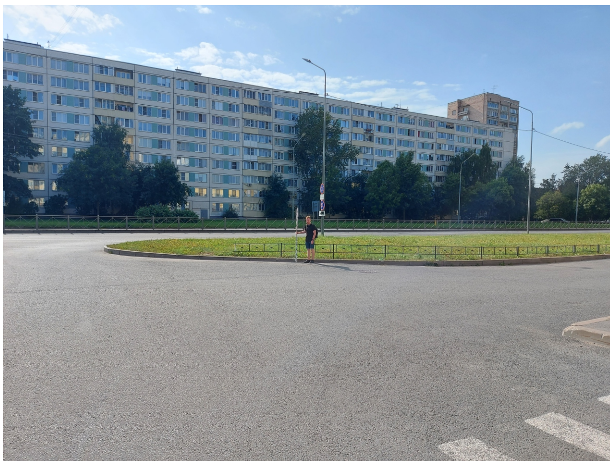
Точка фотофиксации 6. Южный участок обследуемой территории. Вид с В.
