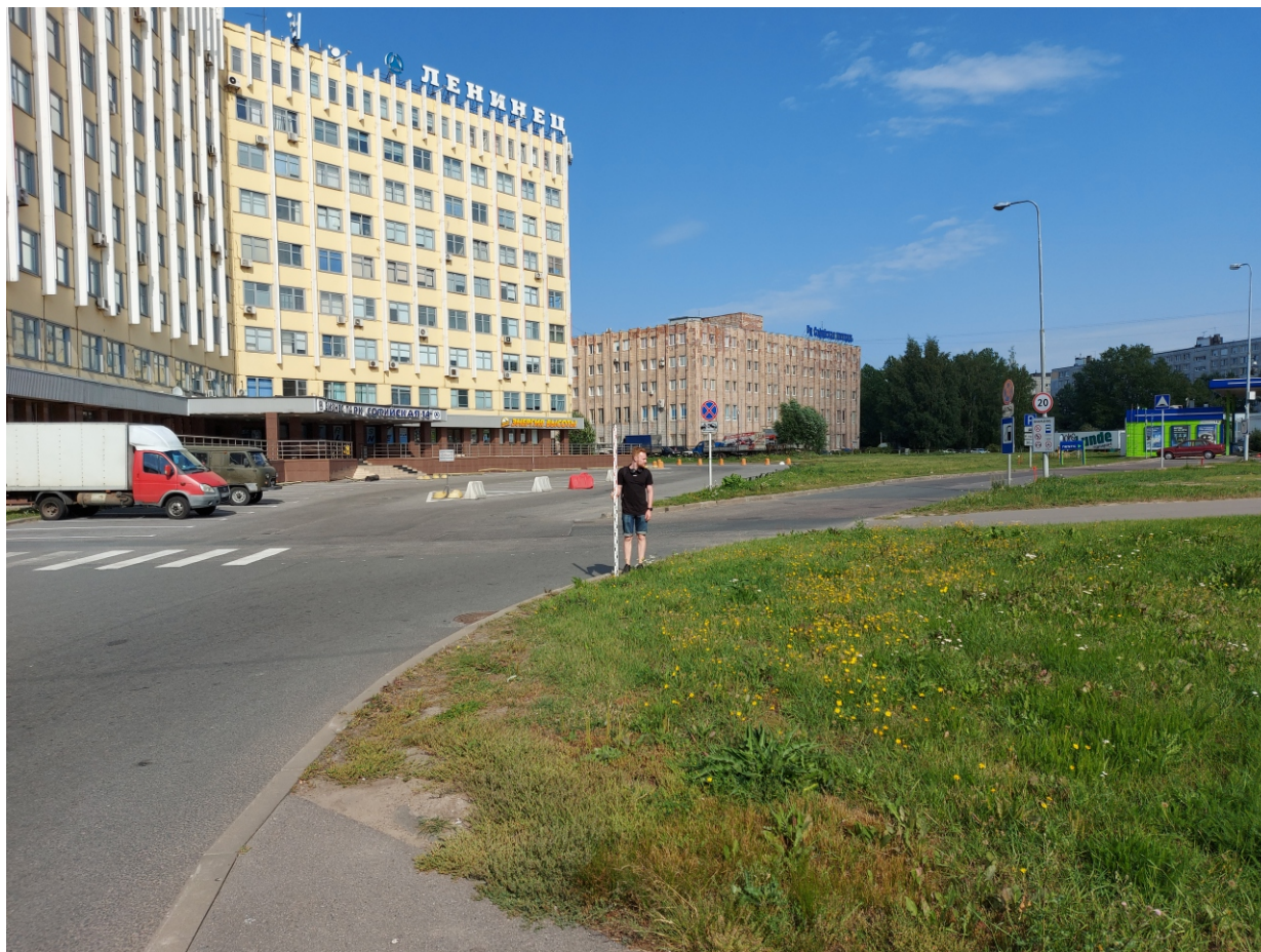
Точка фотофиксации 7. Южный участок обследуемой территории. Вид с ЮЗ.
