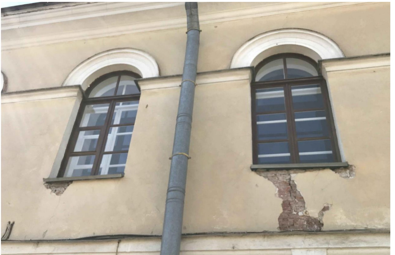
Фото 04. ОКН федерального значения «Дом плац-майорский» (Петропавловская крепость, дом 6 лит В). Северо-восточный фасад. Оконные проёмы в уровне второго этажа. Съёмка 17 мая 2021 г.
