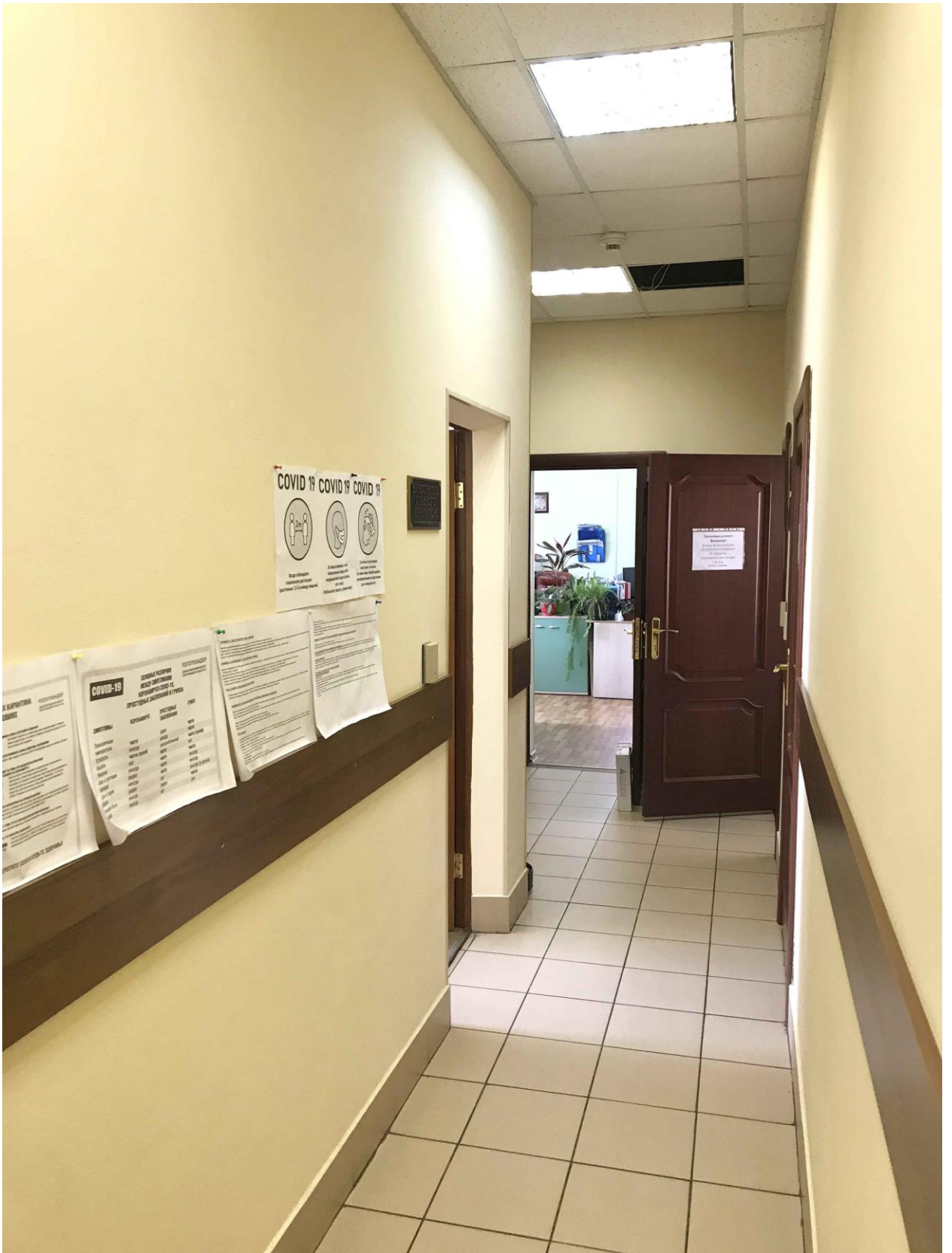
Фото 46. ОКН федерального значения «Дом плац-майорский» (Петропавловская крепость, дом 6 лит В). Второй этаж. Помещение 45. Общий вид. Съёмка 17 мая 2021 г.
