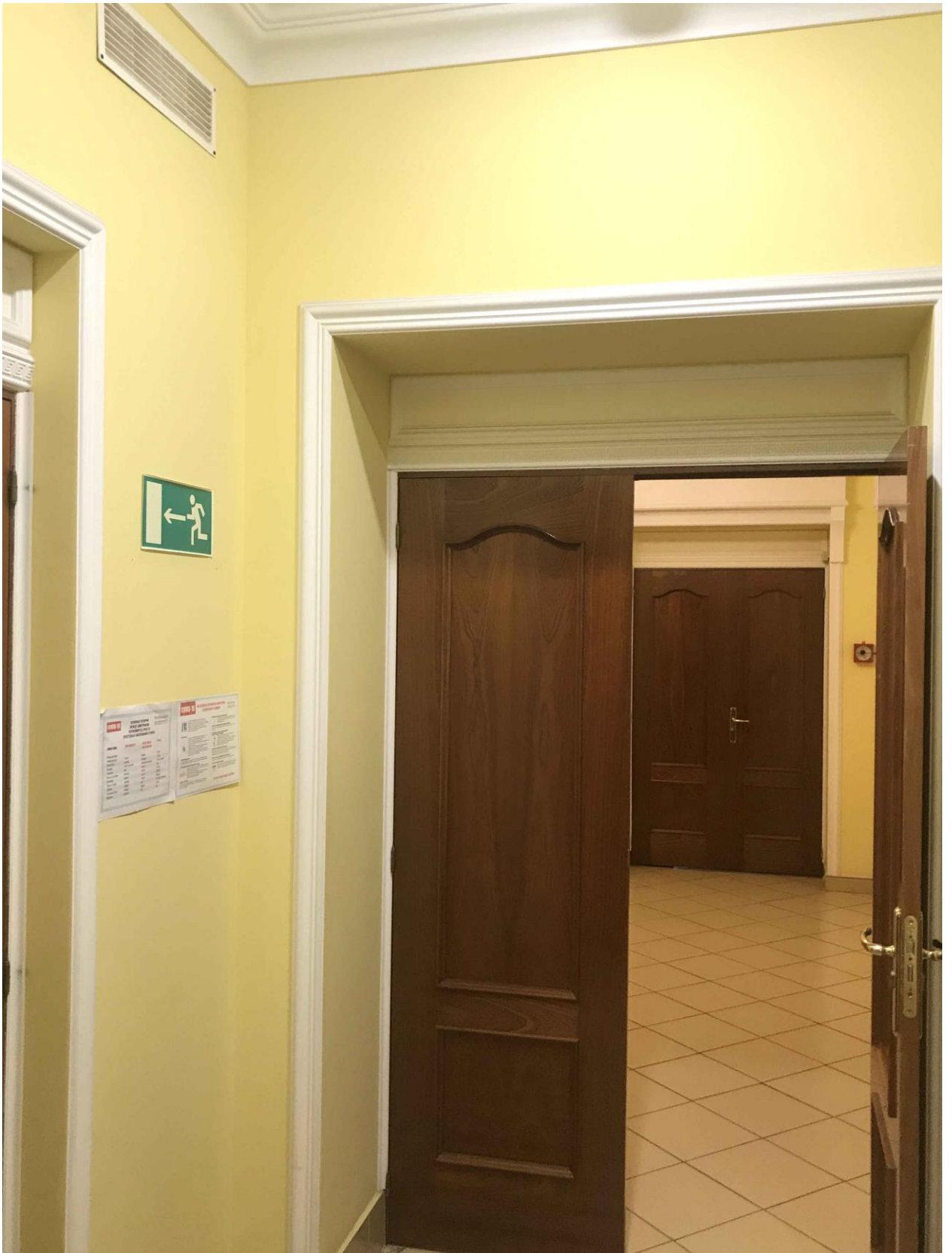
Фото 17. ОКН федерального значения «Дом плац-майорский» (Петропавловская крепость, дом 6 лит В). Первый этаж. Помещение 2. Общий вид. Съёмка 17 мая 2021 г.
