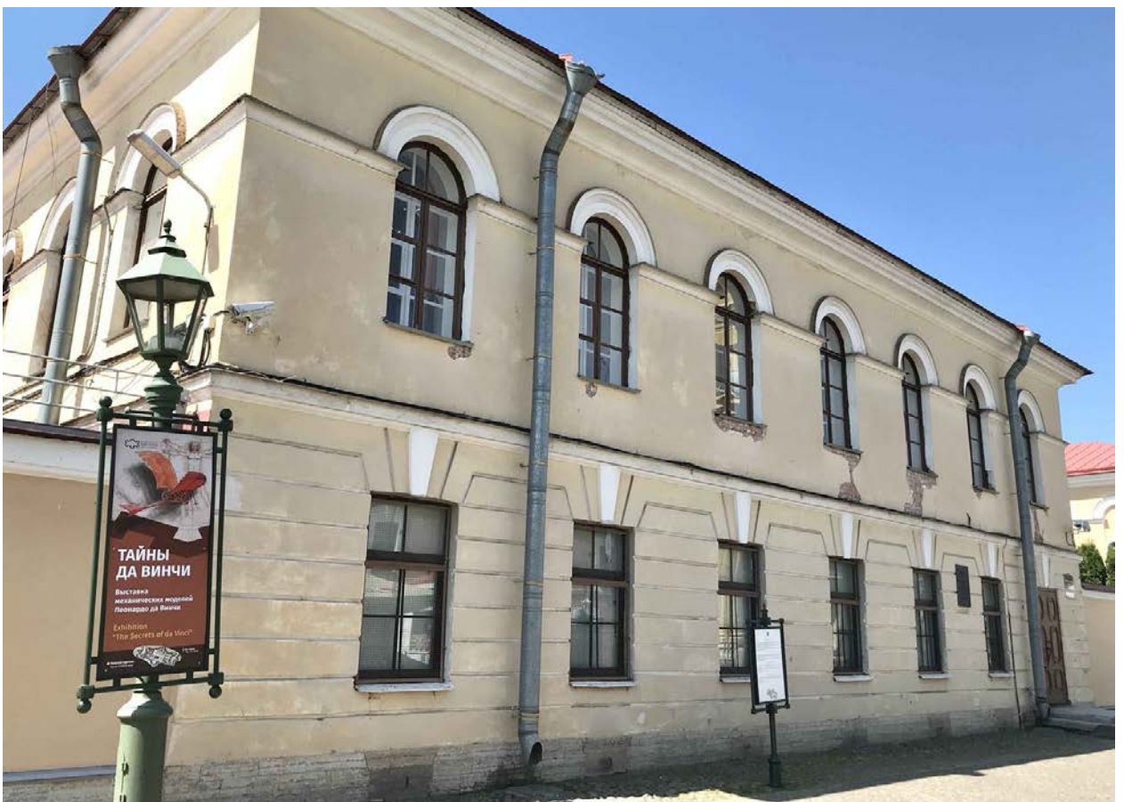
Фото 02. ОКН федерального значения «Дом плац-майорский» (Петропавловская крепость, дом 6 лит В). Северо-восточный фасад. Фрагмент. Съёмка 17 мая 2021 г.
