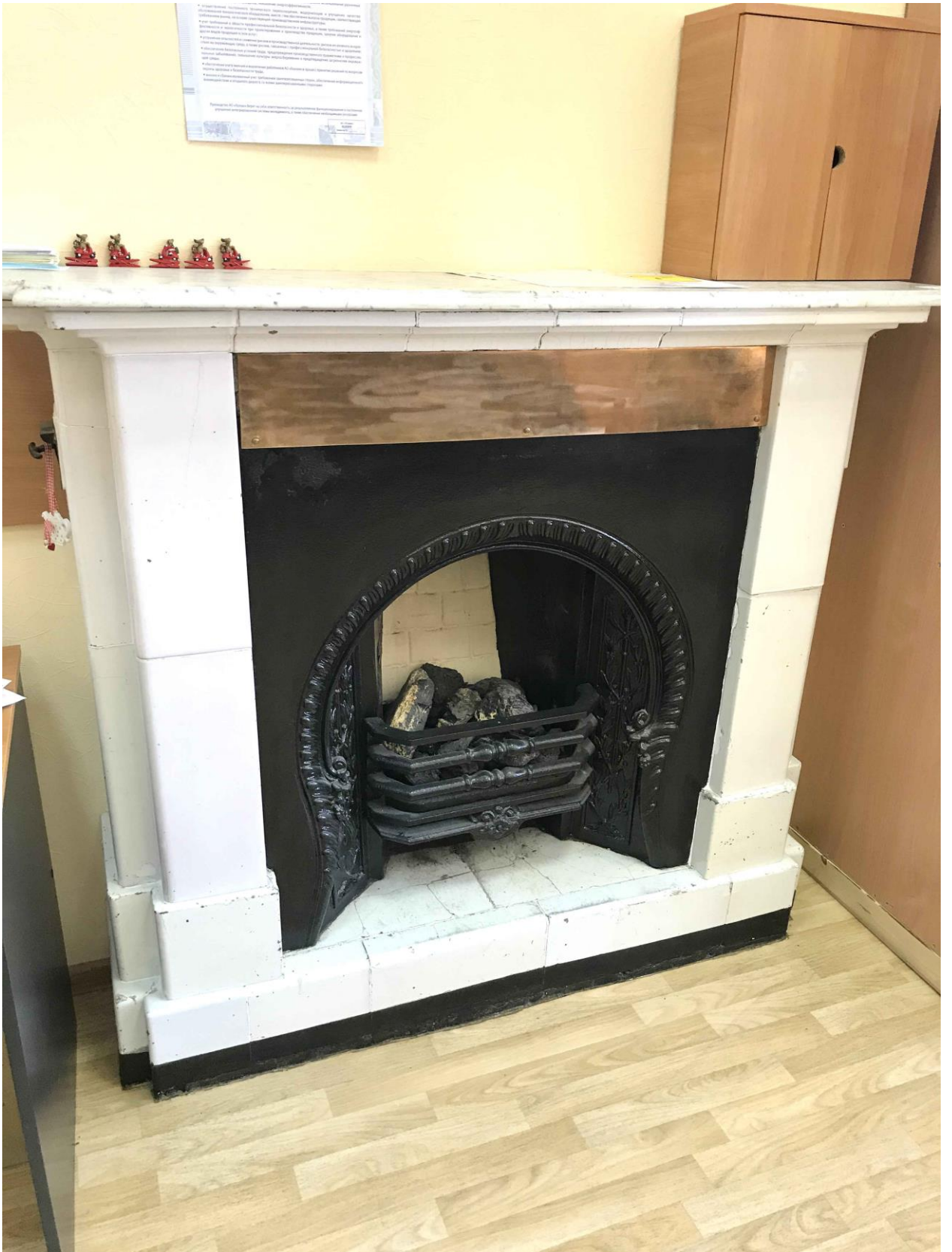
Фото 44. ОКН федерального значения «Дом плац-майорский» (Петропавловская крепость, дом 6 лит В). Второй этаж. Помещение 37. Камин. Съёмка 17 мая 2021 г.
