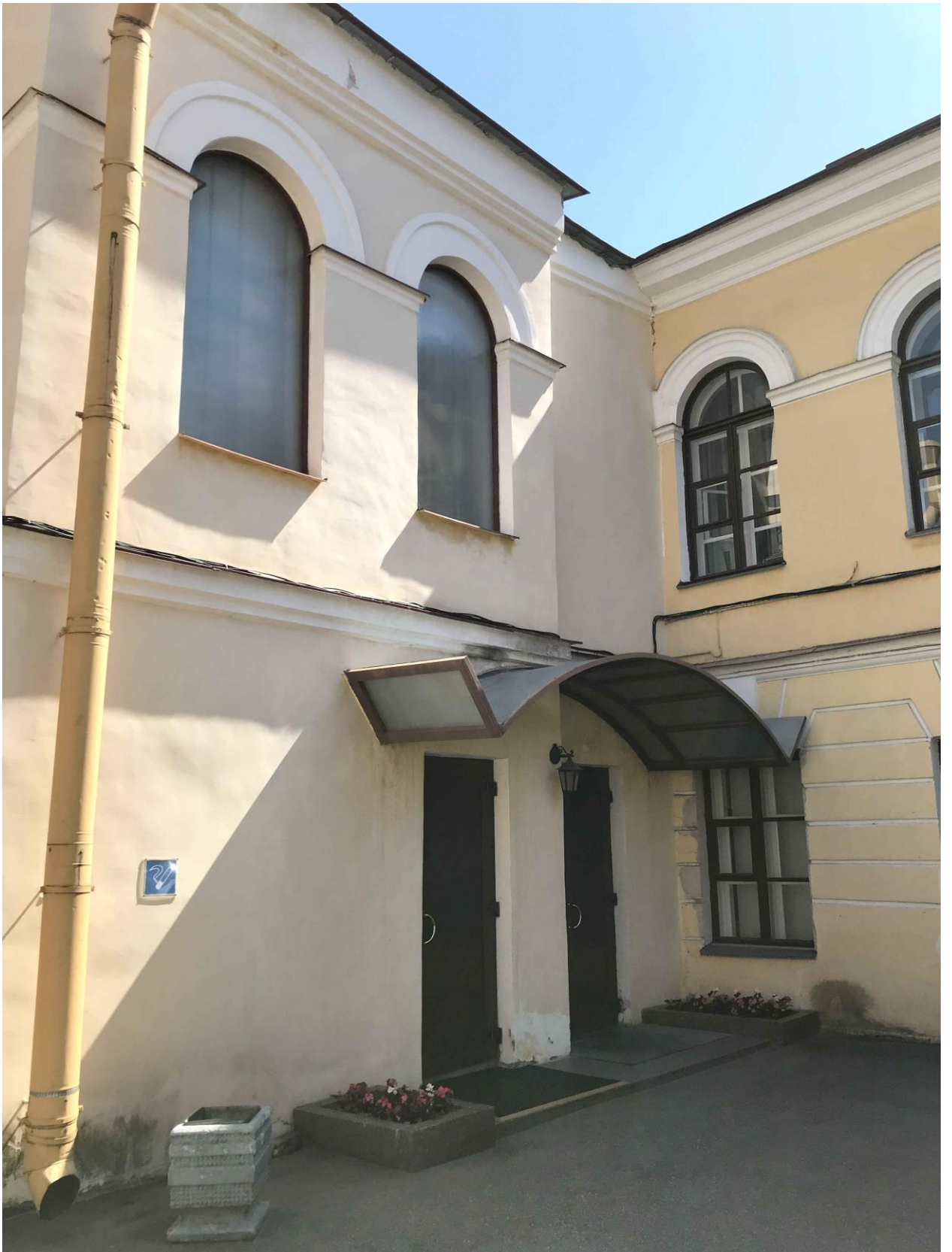
Фото 09. ОКН федерального значения «Дом плац-майорский» (Петропавловская крепость, дом 6 лит В). Северо-западный фасад. Фрагмент. Съёмка 17 мая 2021 г.
