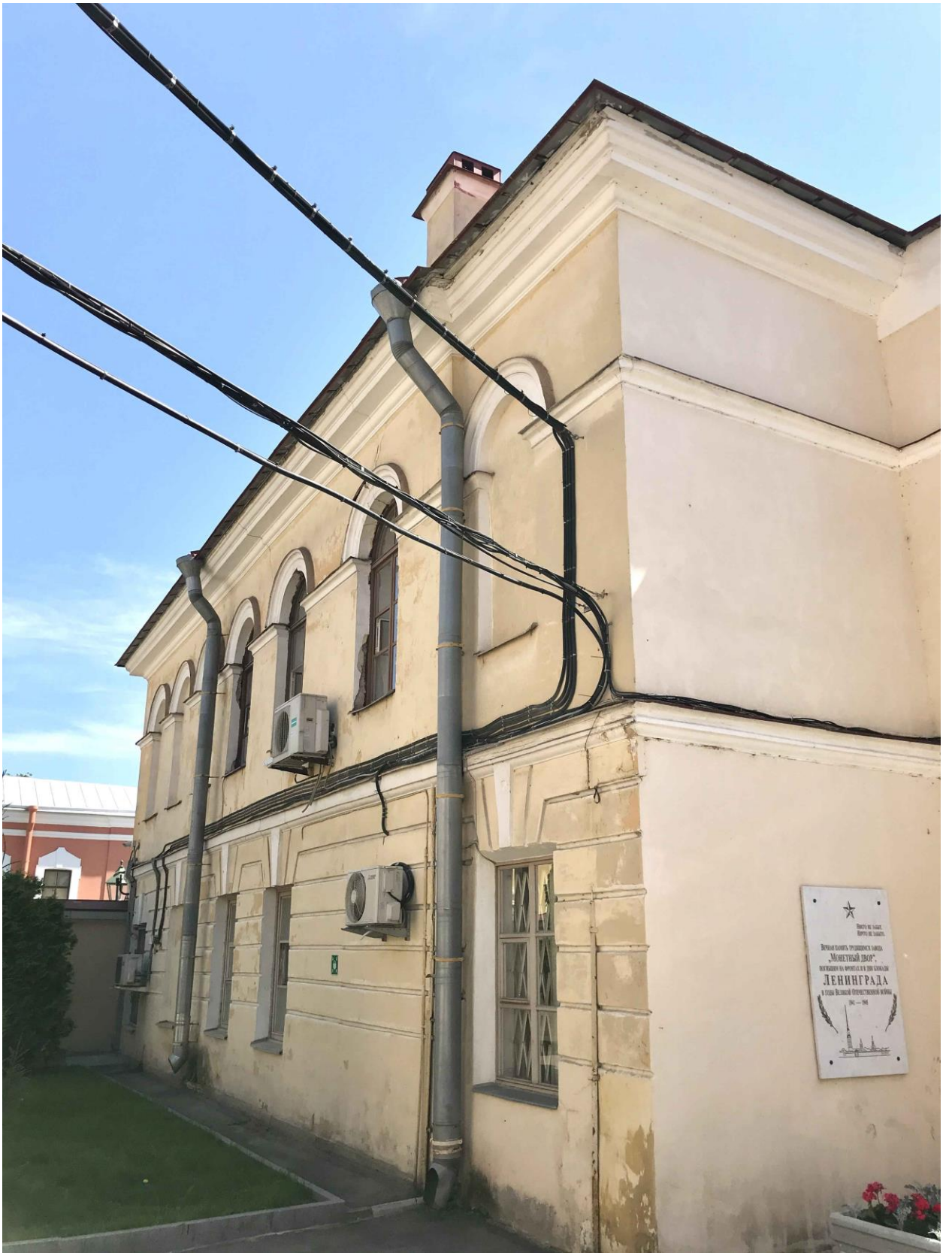
Фото 08. ОКН федерального значения «Дом плац-майорский» (Петропавловская крепость, дом 6 лит В). Северо-западный фасад. Фрагмент. Съёмка 17 мая 2021 г.
