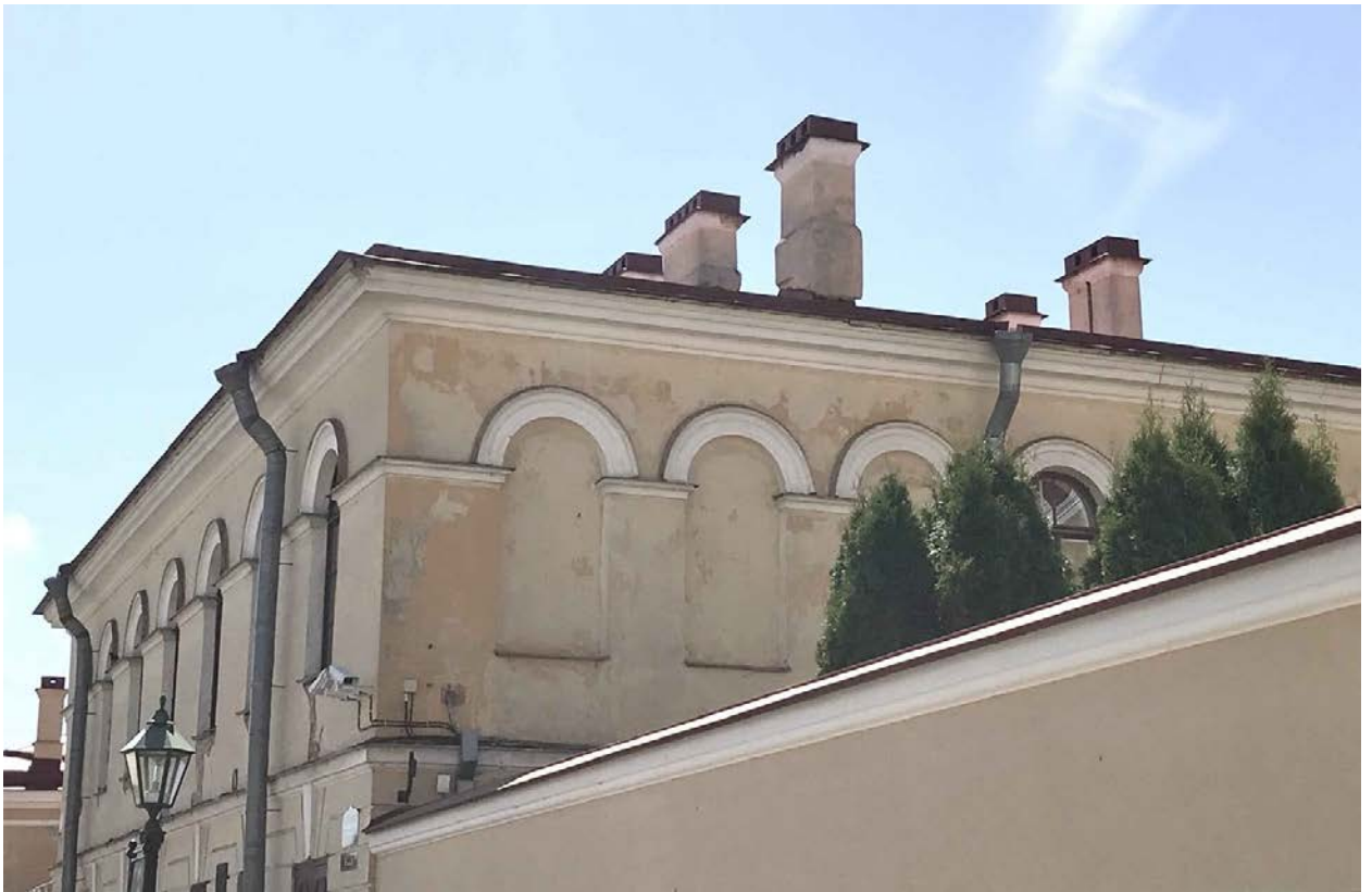
Фото 06. ОКН федерального значения «Дом плац-майорский» (Петропавловская крепость, дом 6 лит В). Северо-восточный и северо-западный фасады. Фрагмент. Съёмка 17 мая 2021 г.
