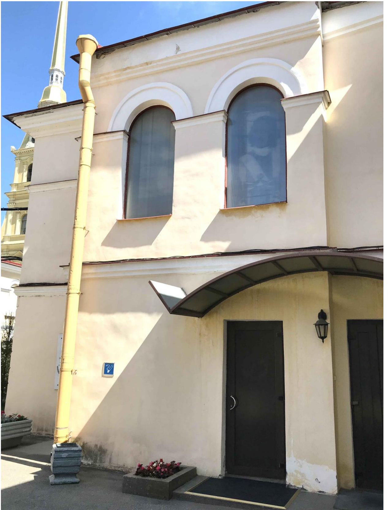
Фото 10. ОКН федерального значения «Дом плац-майорский» (Петропавловская крепость, дом 6 лит В). Северо-западный фасад. Оконные проёмы в уровне второго этажа. Крыльцо. Фрагмент. Съёмка 17 мая 2021 г.
