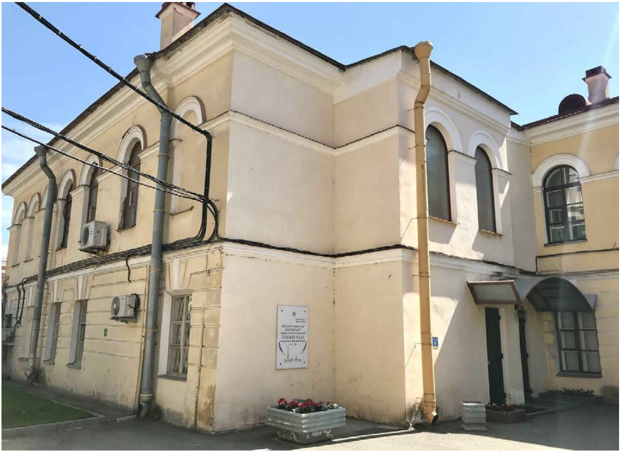
Фото 07. ОКН федерального значения «Дом плац-майорский» (Петропавловская крепость, дом 6 лит В). Северо-западный фасад. Общий вид. Съёмка 17 мая 2021 г.
