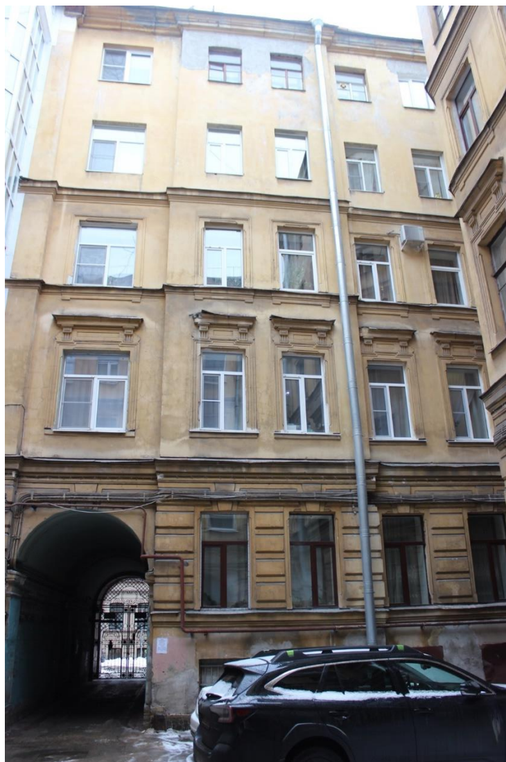
3. Здание по адресу: Санкт-Петербург, улица Чехова, д.3, Лит. А. Общий вид дворового фасада
