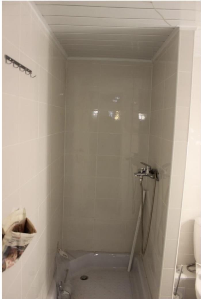
27. Здание по адресу: Санкт-Петербург, улица Чехова, д.3, Лит. А. Санузел в квартире №6.
