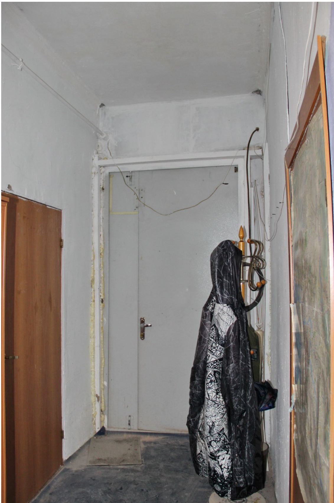
8 Санкт-Петербург, наб. реки Мойки, д. 82, Лит. А, кв. 45 Помещение № 1 Дата съемки: 25.11.2021
