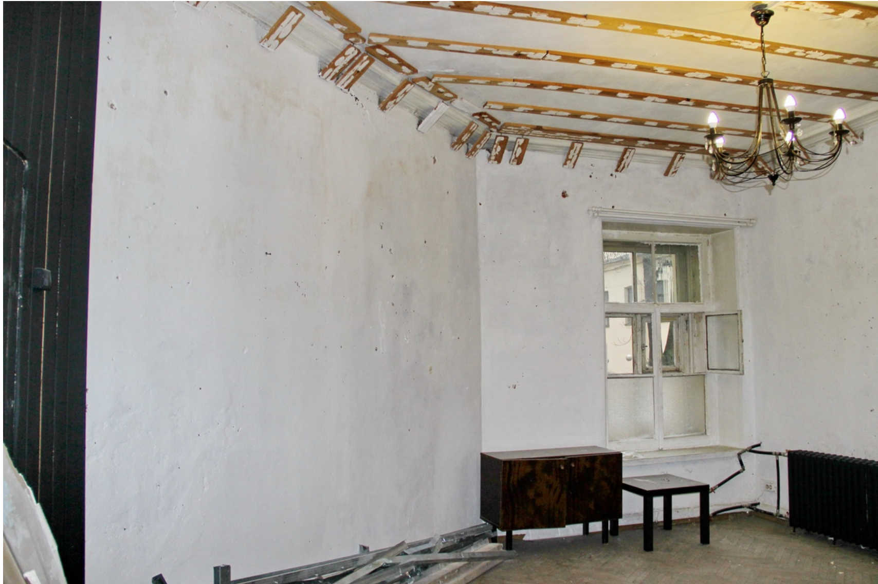
20 Санкт-Петербург, наб. реки Мойки, д. 82, Лит. А, кв. 45 Помещение № 6 Дата съемки: 25.11.2021
