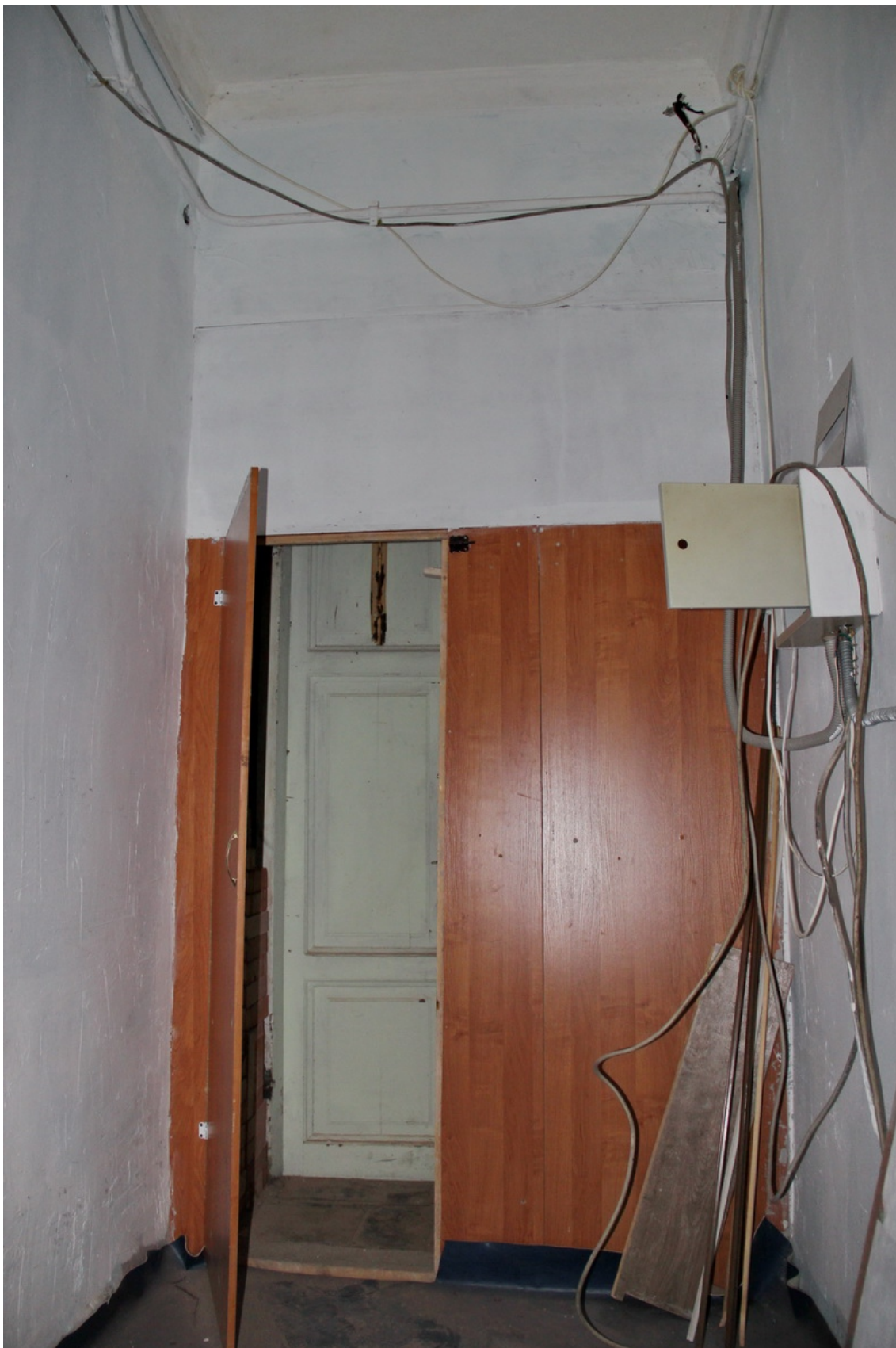
9 Санкт-Петербург, наб. реки Мойки, д. 82, Лит. А, кв. 45 Помещение № 1 Дата съемки: 25.11.2021
