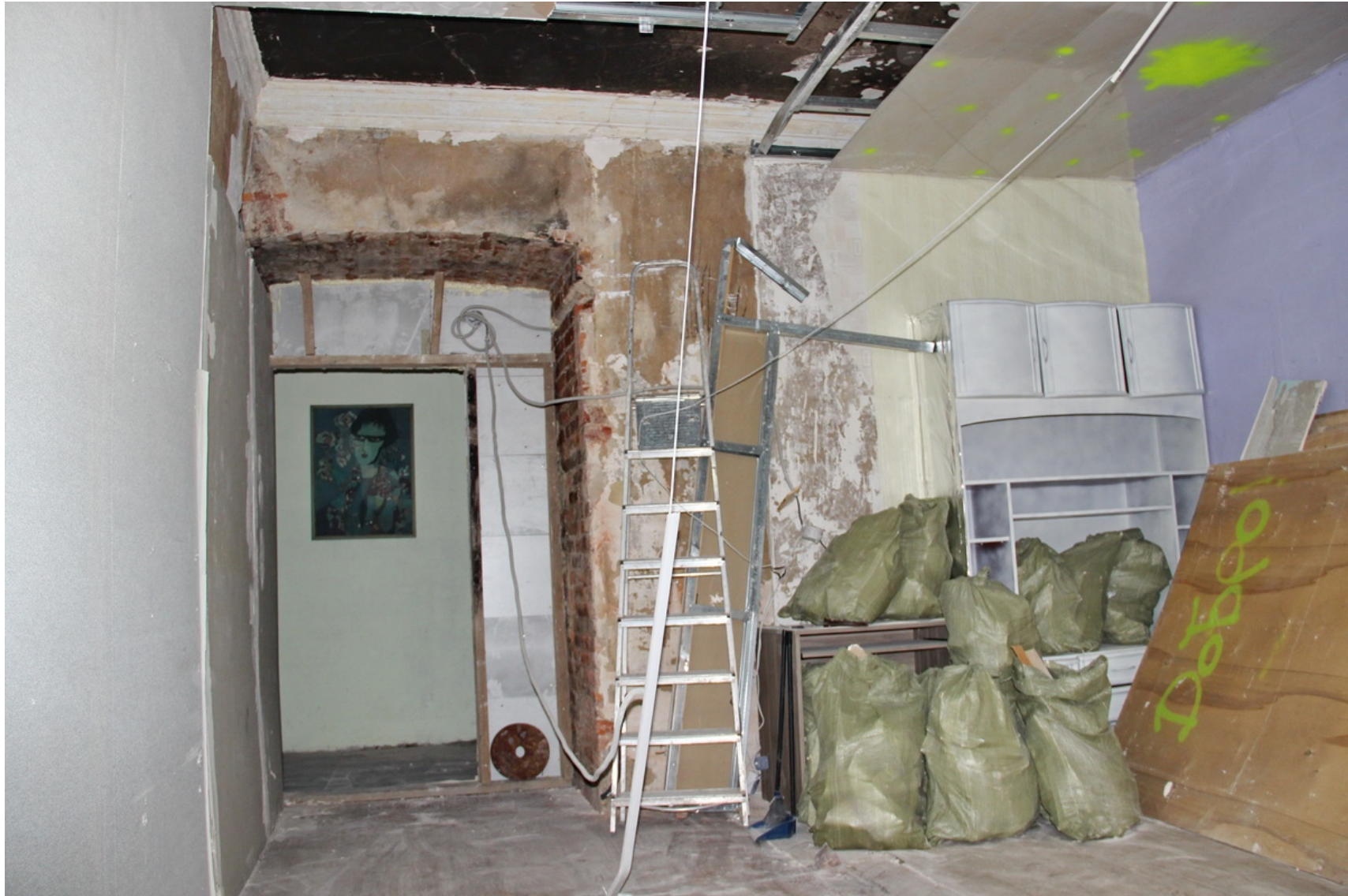
12 Санкт-Петербург, наб. реки Мойки, д. 82, Лит. А, кв. 45 Помещение № 2 Дата съемки: 25.11.2021
