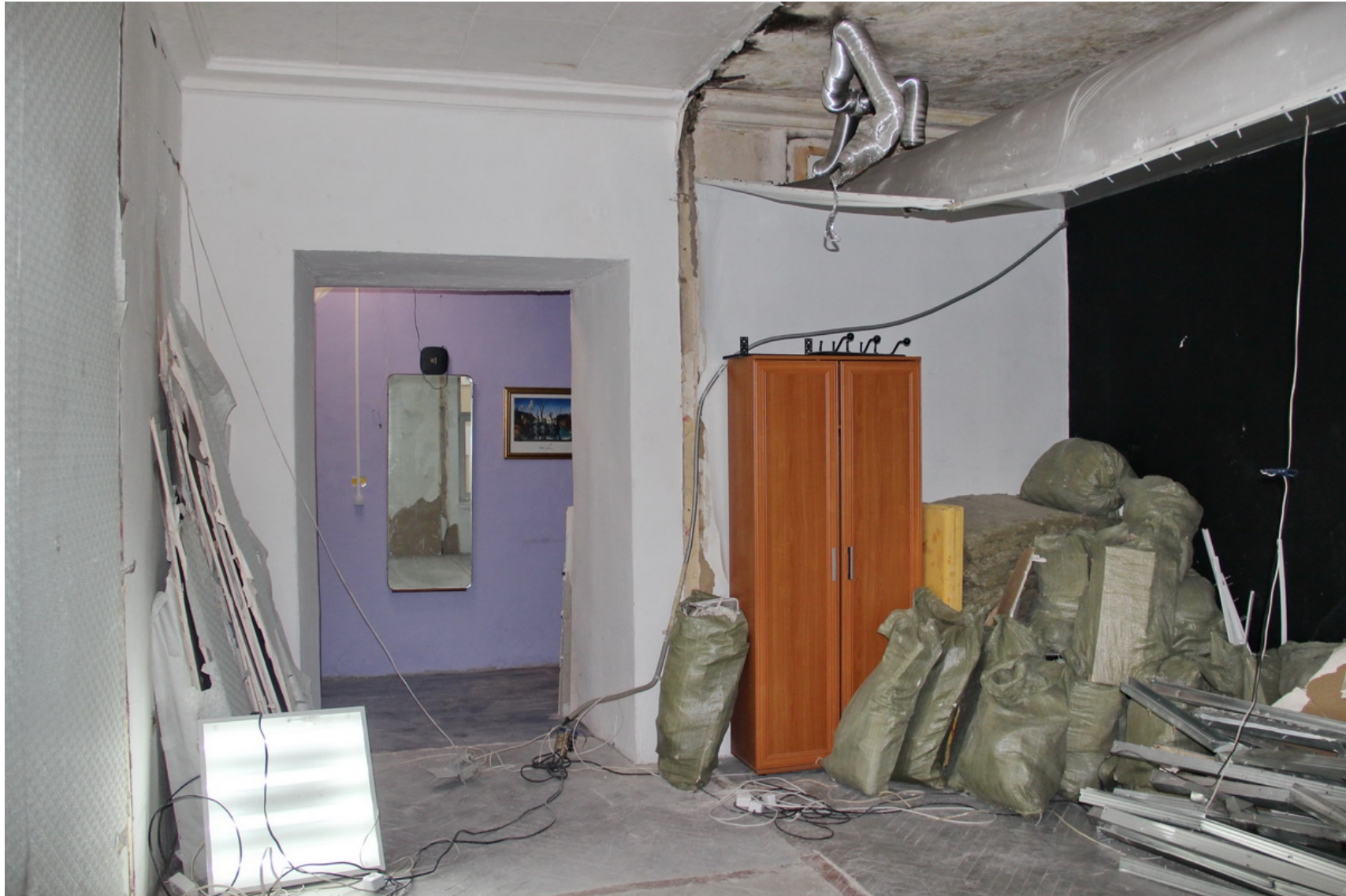
14 Санкт-Петербург, наб. реки Мойки, д. 82, Лит. А, кв. 45 Помещение № 3 Дата съемки: 25.11.2021
