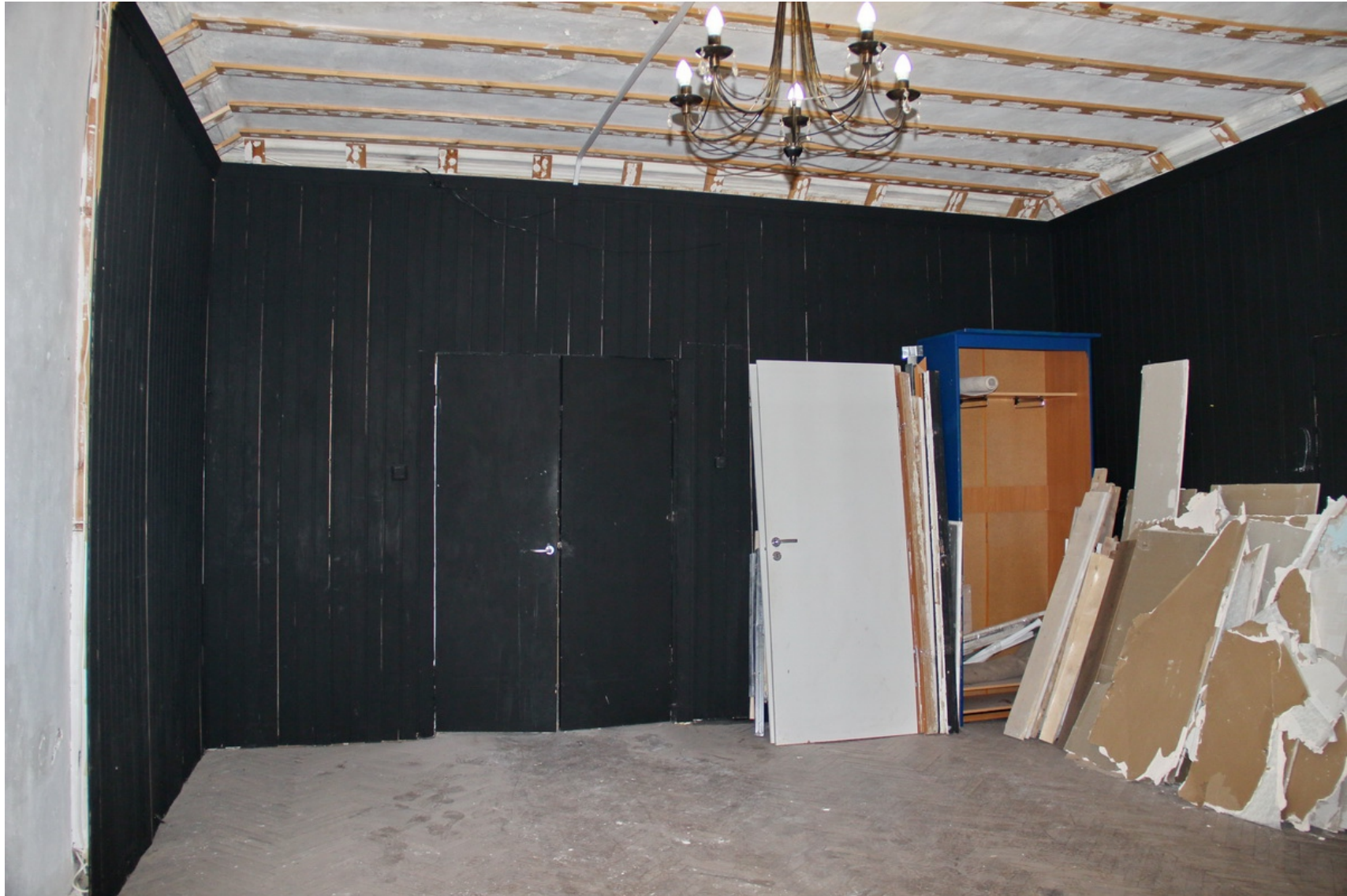
21 Санкт-Петербург, наб. реки Мойки, д. 82, Лит. А, кв. 45 Помещение № 6 Дата съемки: 25.11.2021
