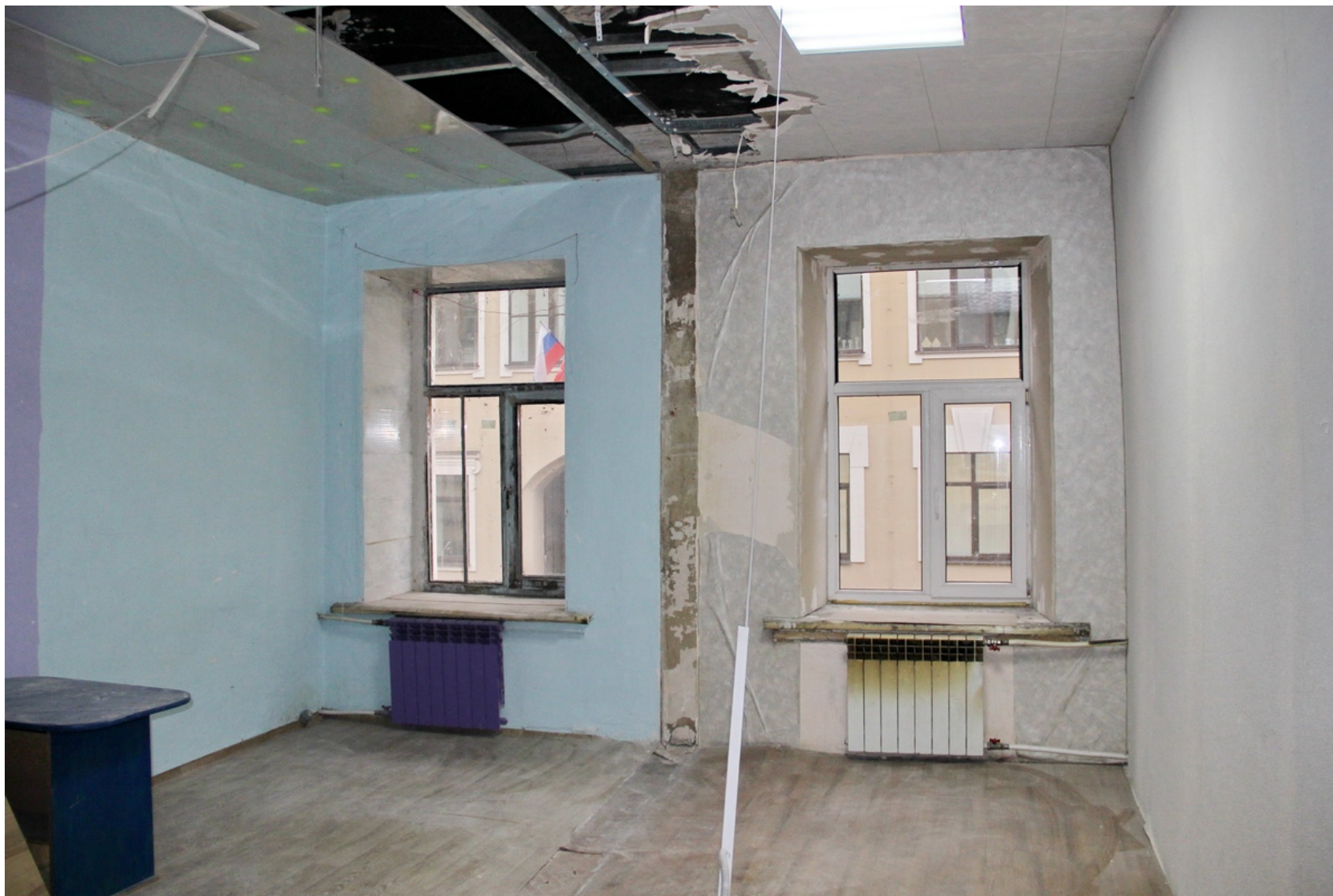
11 Санкт-Петербург, наб. реки Мойки, д. 82, Лит. А, кв. 45 Помещение № 2 Дата съемки: 25.11.2021
