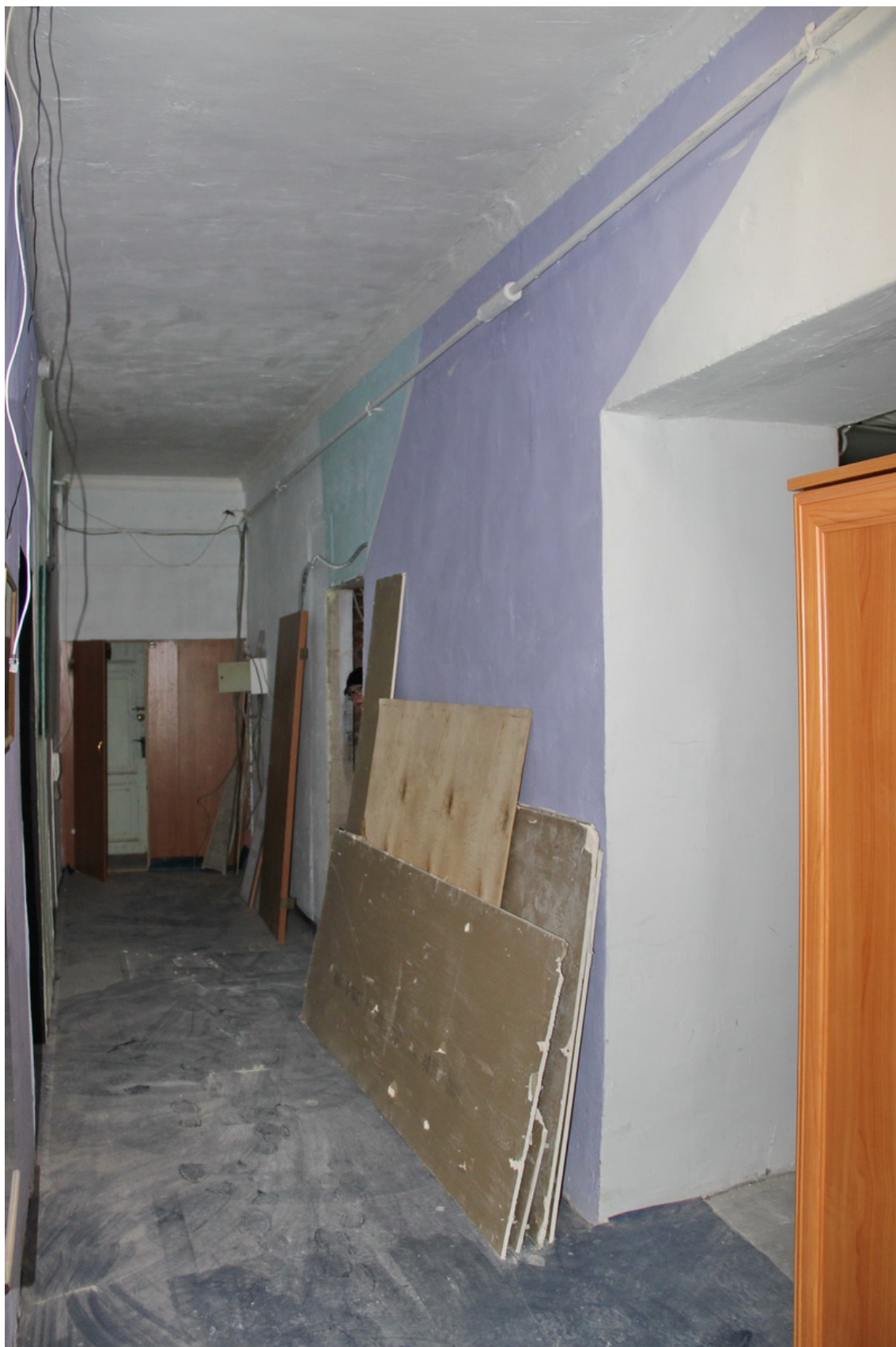
7 Санкт-Петербург, наб. реки Мойки, д. 82, Лит. А, кв. 45 Помещение № 1 Дата съемки: 25.11.2021
