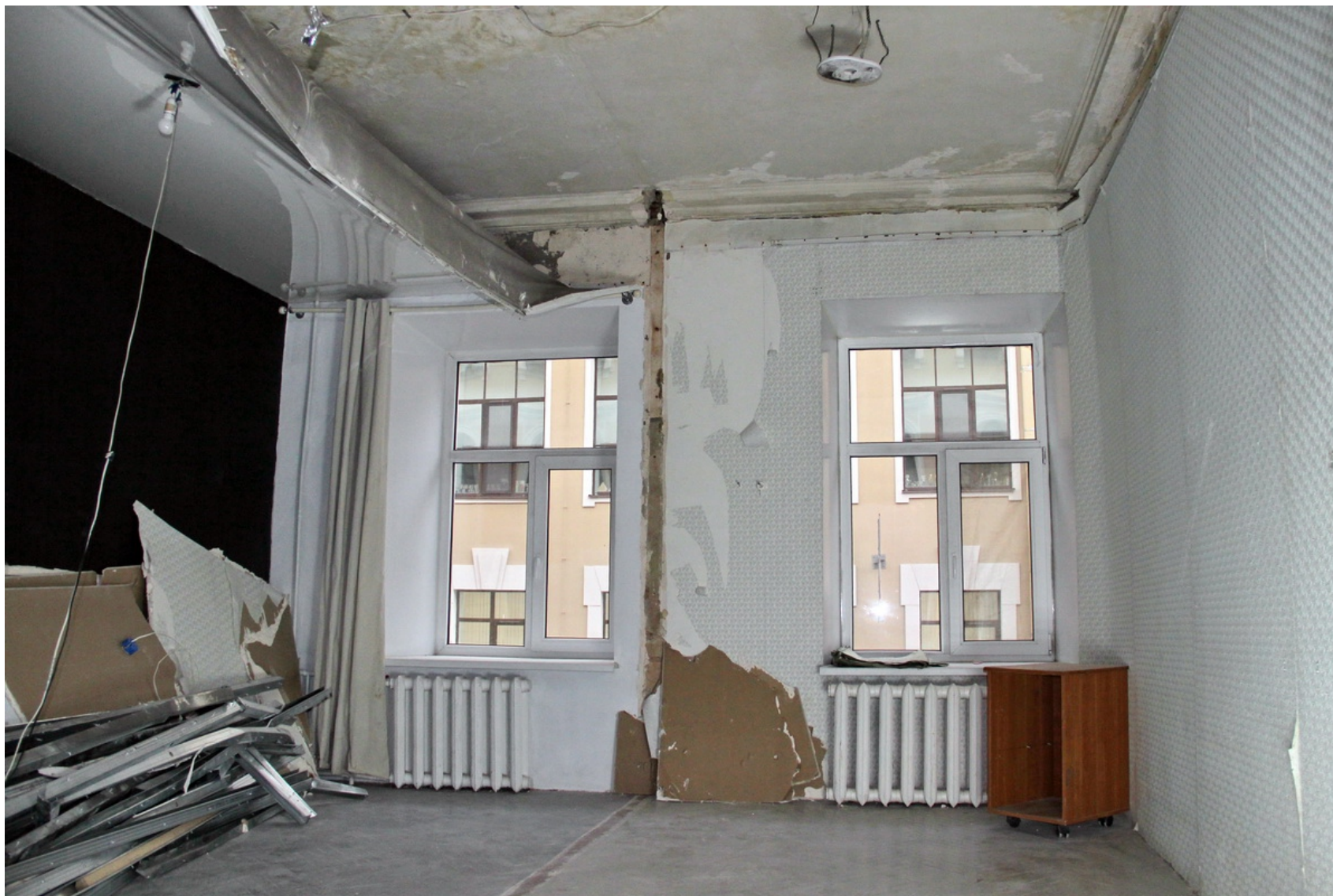
13 Санкт-Петербург, наб. реки Мойки, д. 82, Лит. А, кв. 45 Помещение № 3 Дата съемки: 25.11.2021
