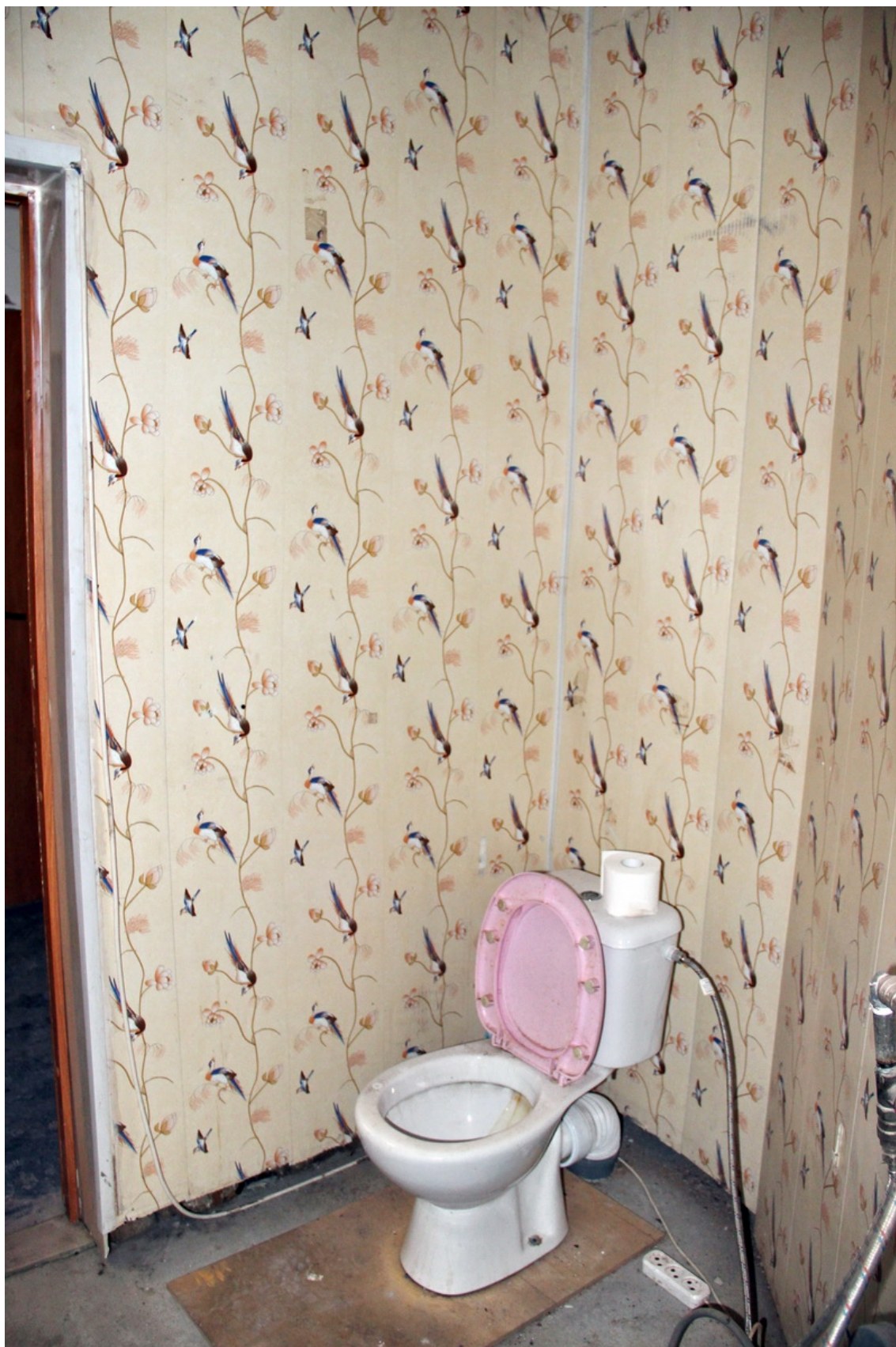
18 Санкт-Петербург, наб. реки Мойки, д. 82, Лит. А, кв. 45 Помещение № 5 Дата съемки: 25.11.2021
