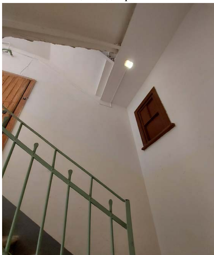
Фото 77. Вид на стену междуэтажной площадки черной 1ЛК.
