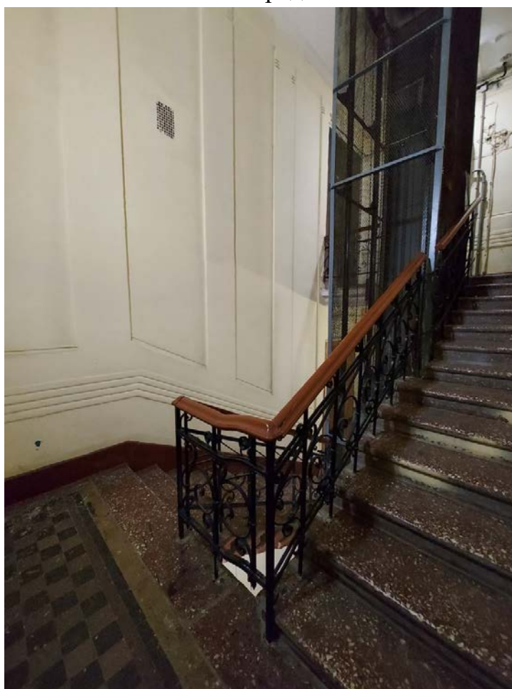
Фото 125. Общий вид парадной 2ЛК.
