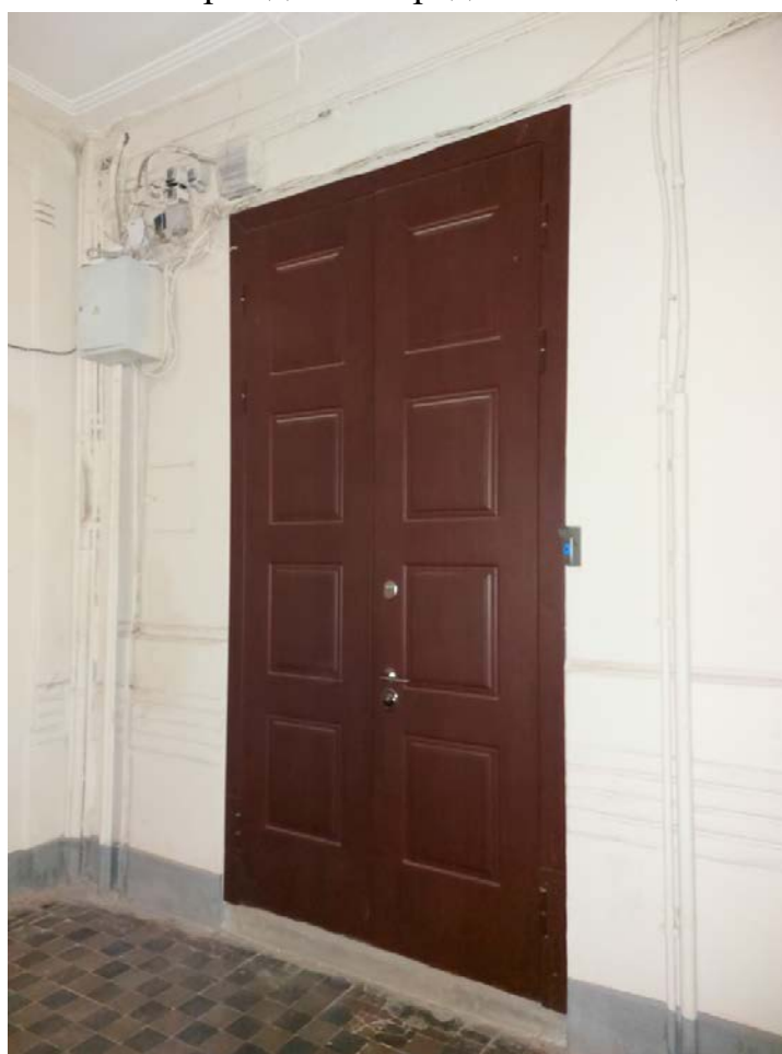
Фото 61. Дверное заполнение парадной части 1ЛК.
