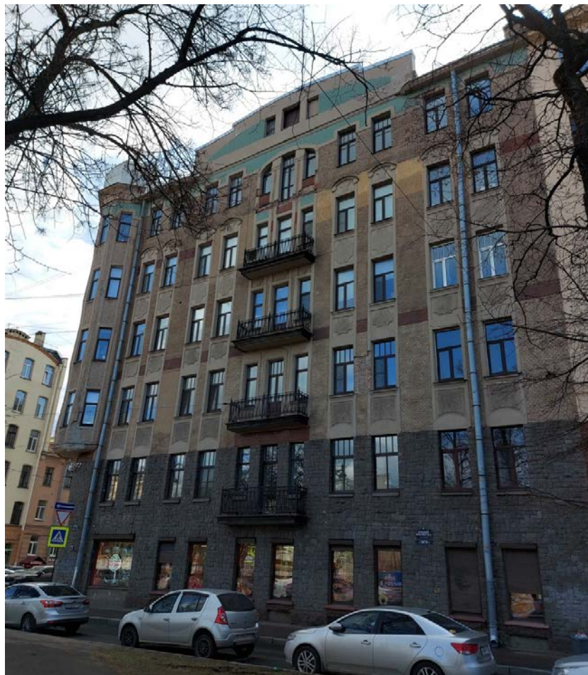
Фото 3. Северо-западный фасад, вид с запада.
