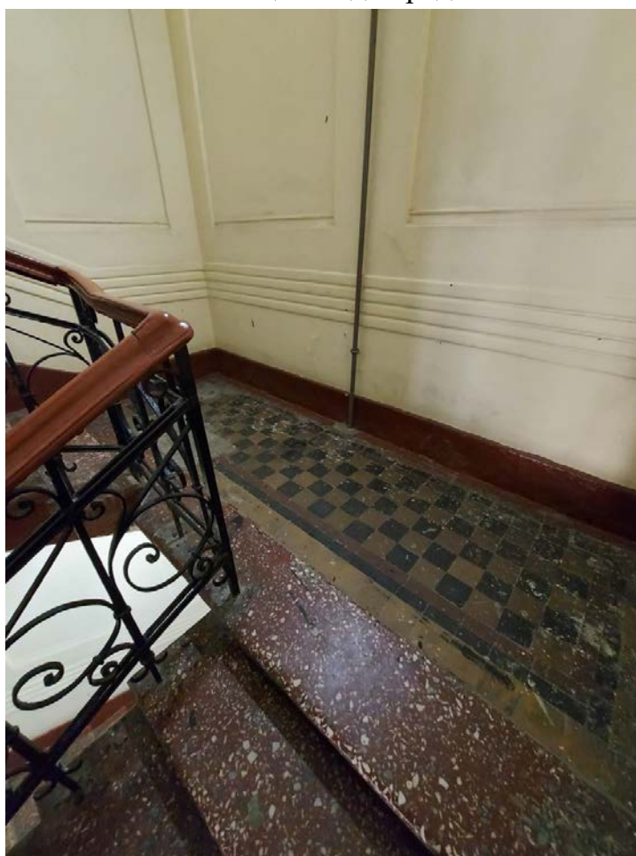
Фото 123. Оформление площадки парадной 2ЛК.
