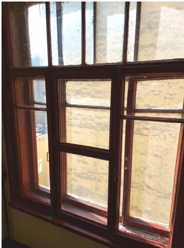
Фото 115. Оконное заполнение черной 2ЛК.
