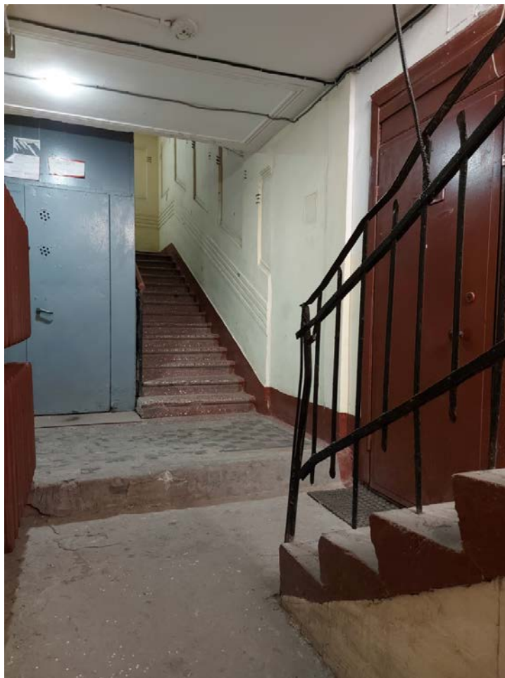
Фото 47. Вид на парадную часть лестницы 2ЛК.
