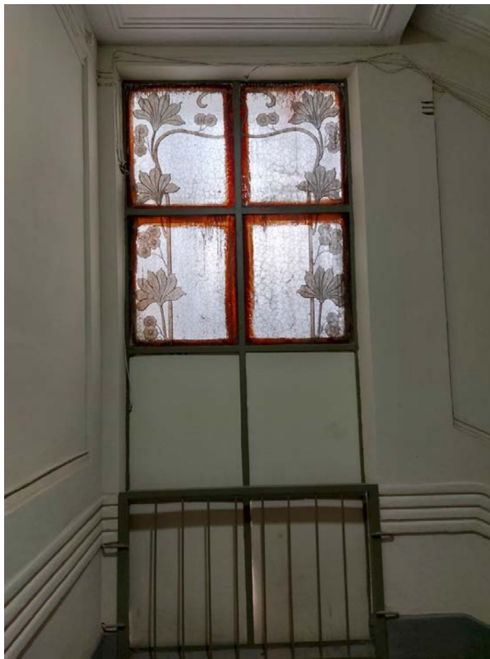
Фото 107. Оконный проем междуэтажной площадки парадной 1ЛК.
