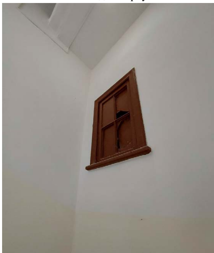
Фото 104. Проем в стене междуэтажной площадки 1ЛК.
