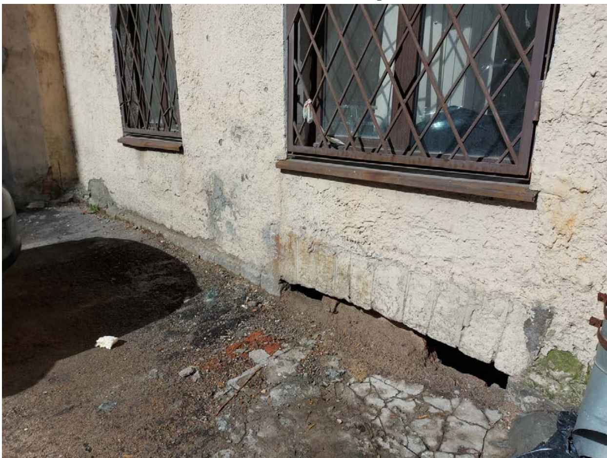
Фото 18. Цокольная часть, оформление подвального проема.
