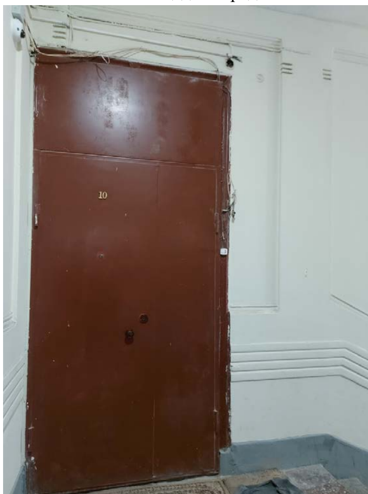
Фото 121. Дверное заполнение парадной 1ЛК.
