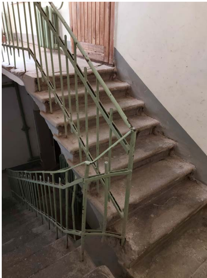
Фото 39. Лестница на 2 этаж черной лестницы 1ЛК.
