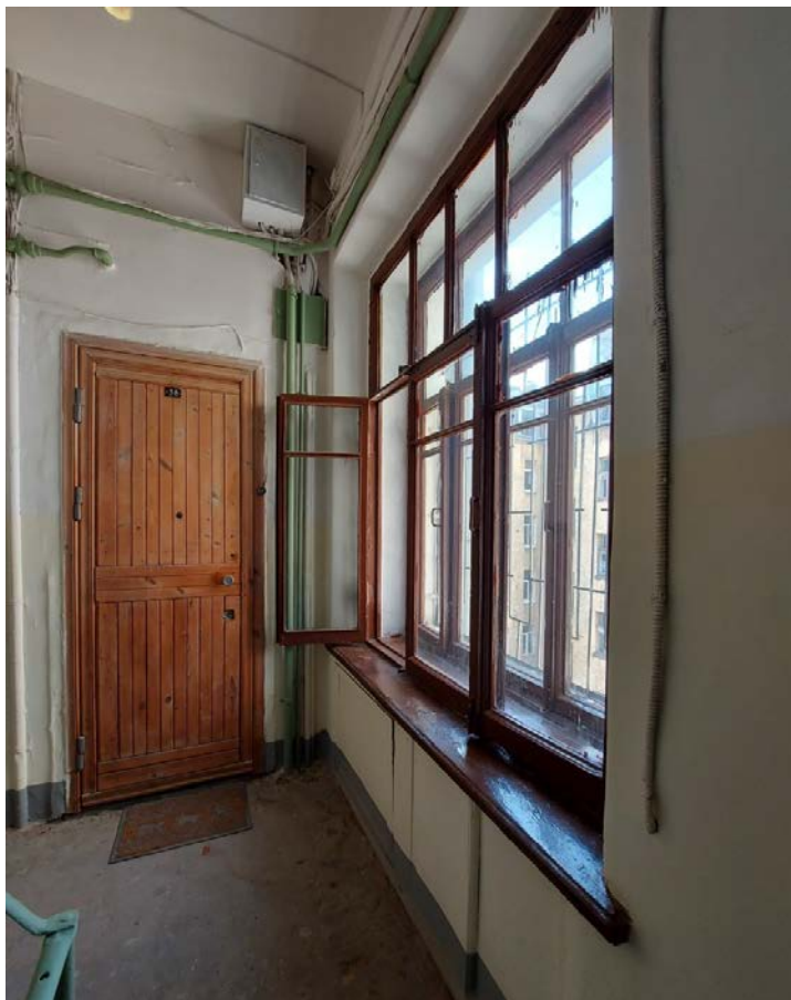
Фото 101. Оконный проем черной 1ЛК.
