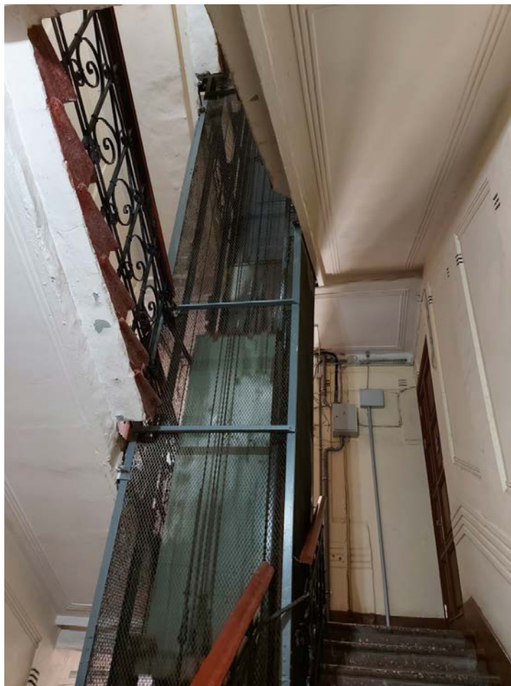
Фото 93. Лифтовая шахта 2ЛК.
