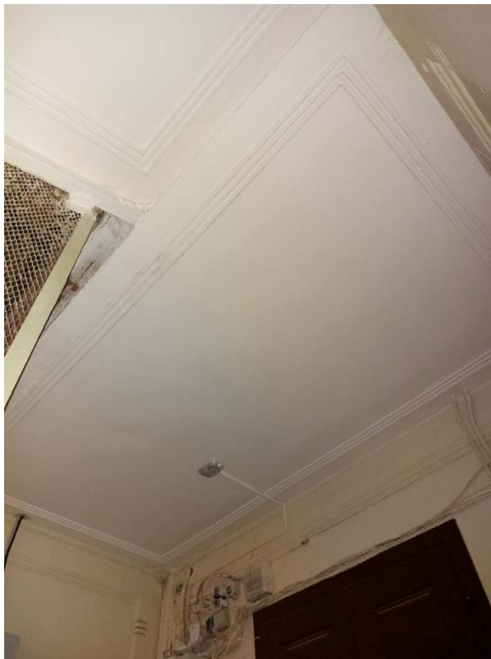
Фото 62. Оформление площадки 2 этажа парадной части 1ЛК.
