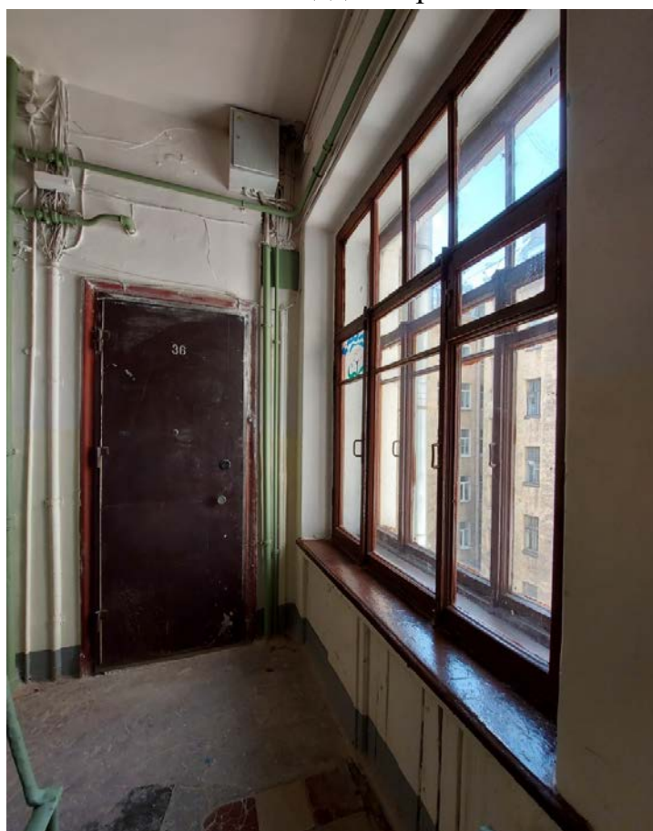
Фото 86. Оконный проем черной 1ЛК.
