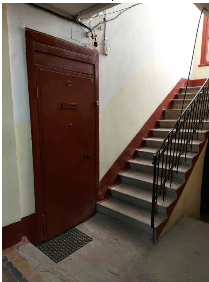
Фото 46. Вид на черную часть лестницы 2ЛК.
