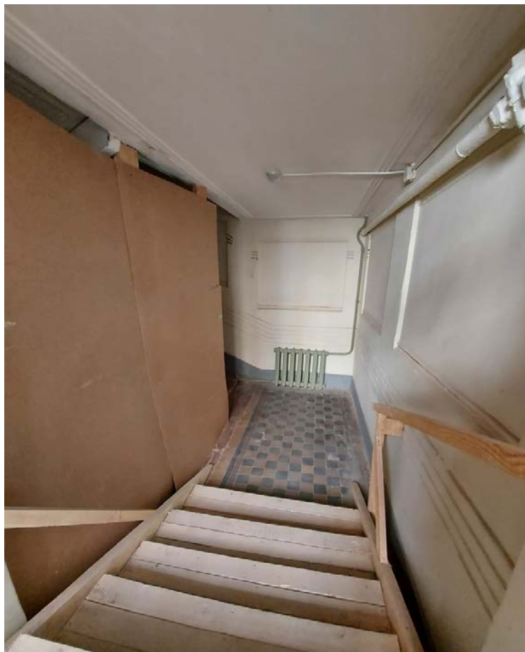
Фото 58. Междуэтажная площадка парадной 1ЛК.
