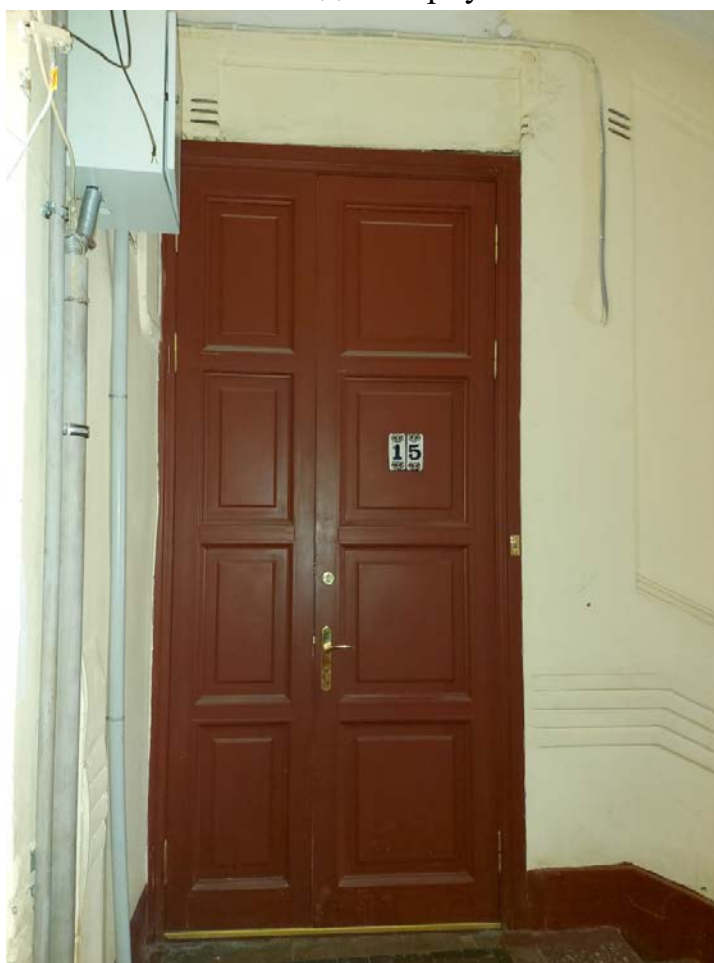
Фото 96. Дверной проем 2ЛК.
