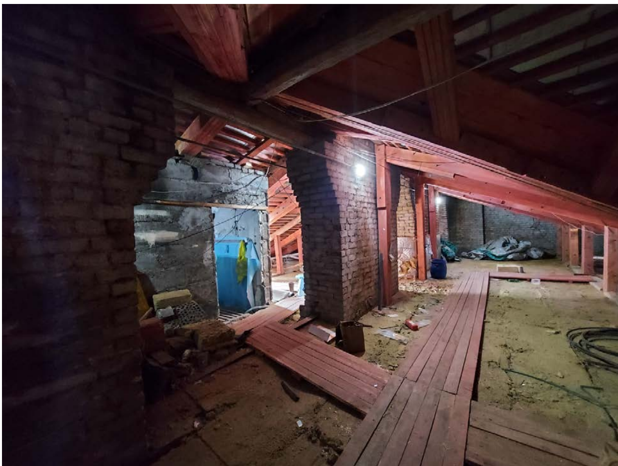
Фото 134. Вид вдоль северной части.
