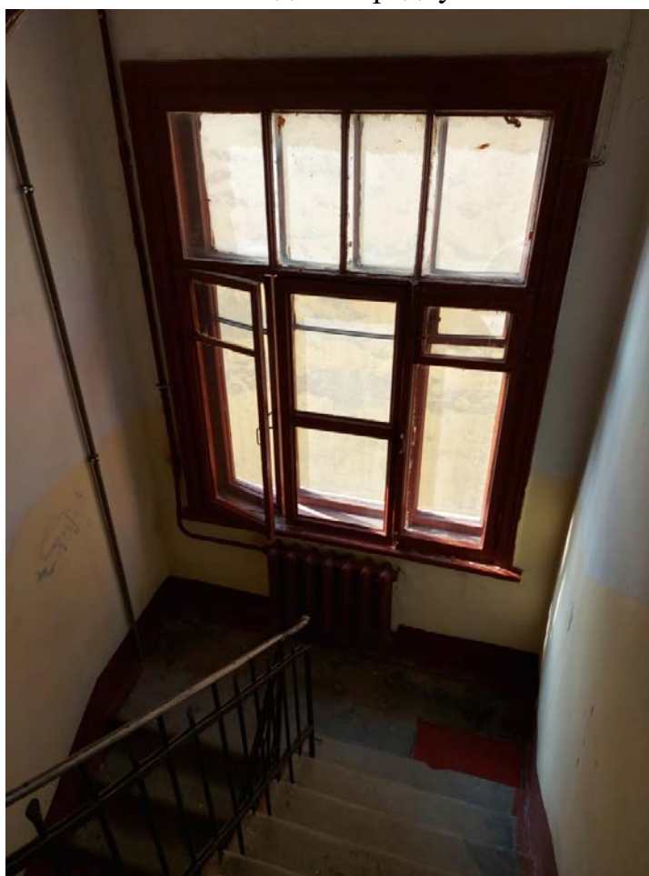
Фото 98. Оконный проем черной 2ЛК.
