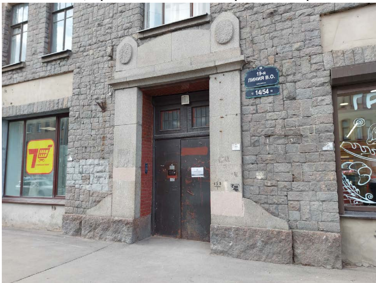
Фото 10. Дверной проем 1ЛК.
