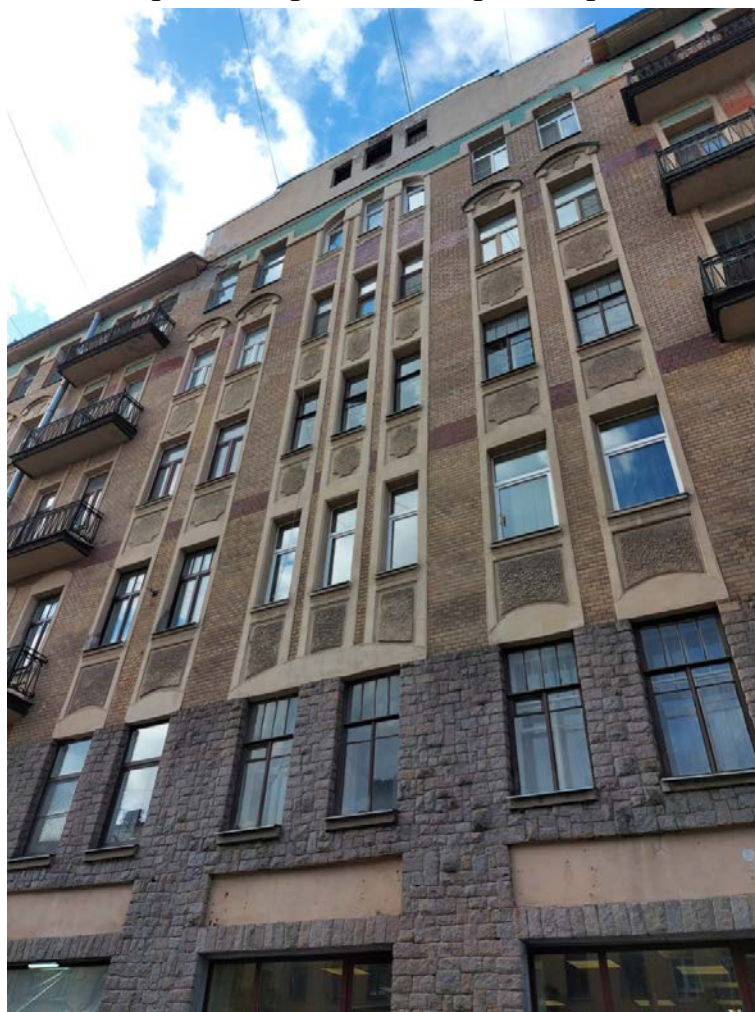
Фото 12. Фрагмент фасада, с севера.
