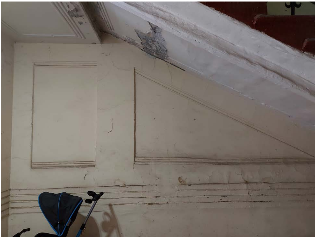
Фото 43. Северная стена вестибюля 2ЛК.
