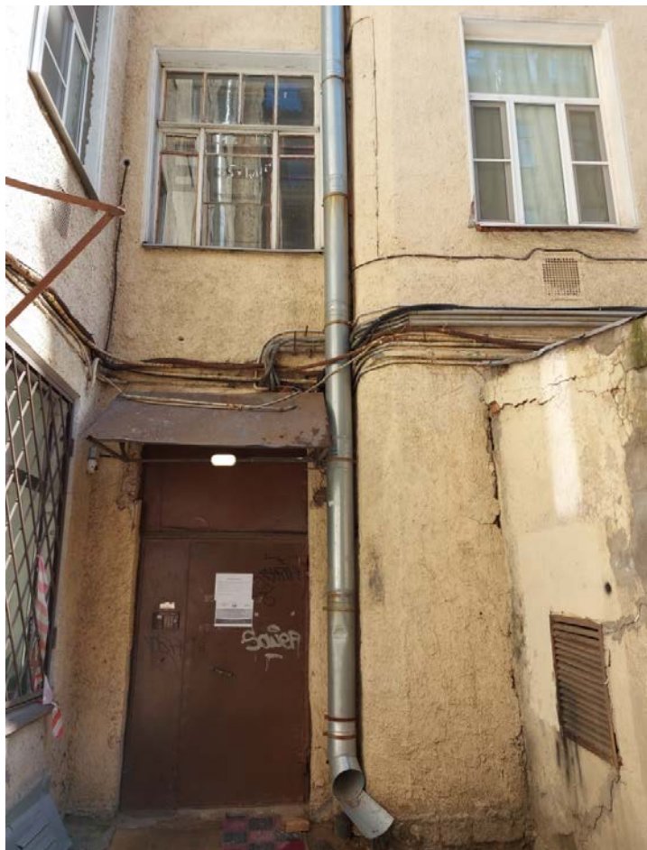
Фото 19. Дворовой дверной проем 1ЛК.
