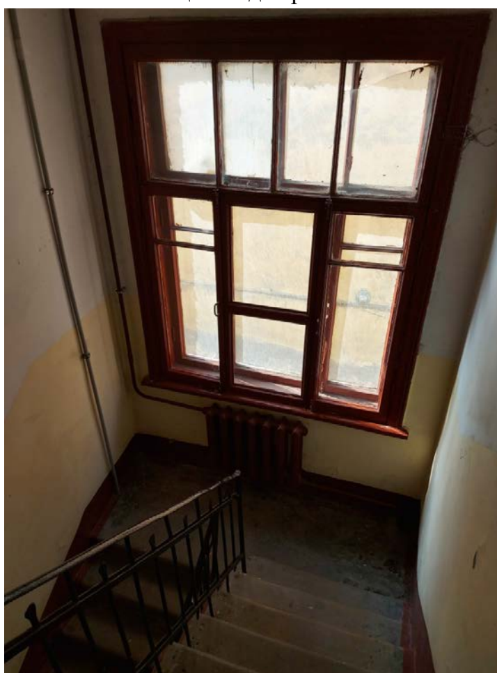
Фото 83. Оконный проем черной части 2ЛК.
