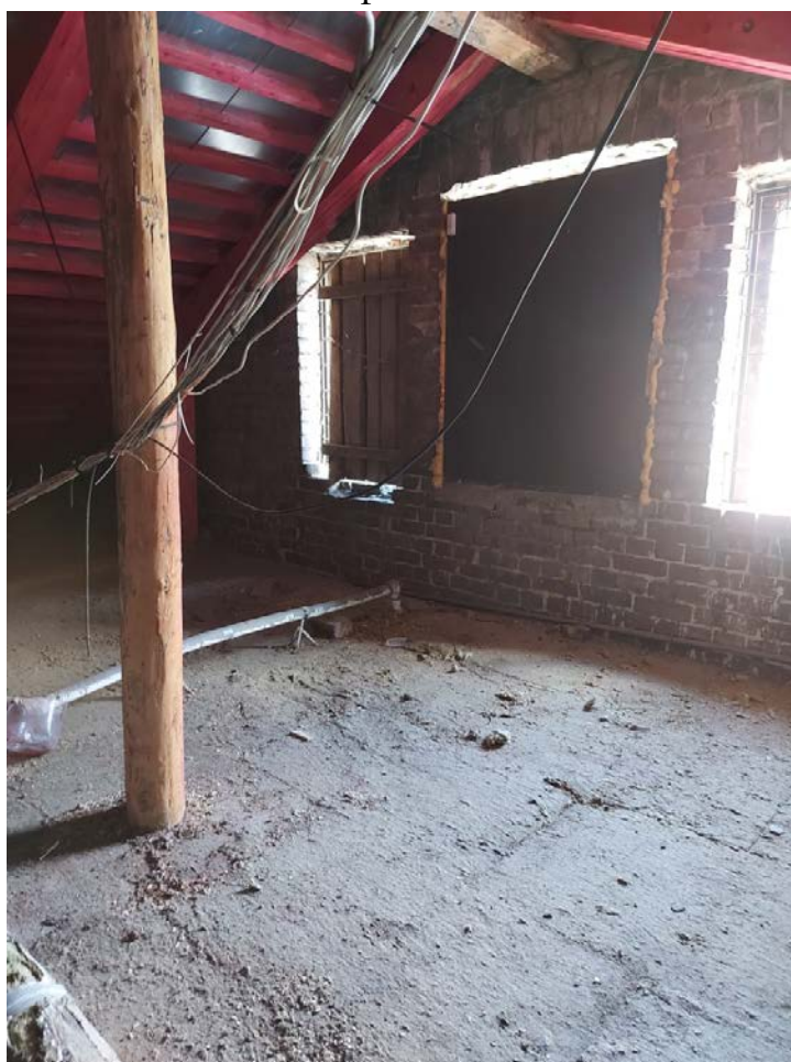
Фото 142. Аттиковая стенка северо-восточного фасада.
