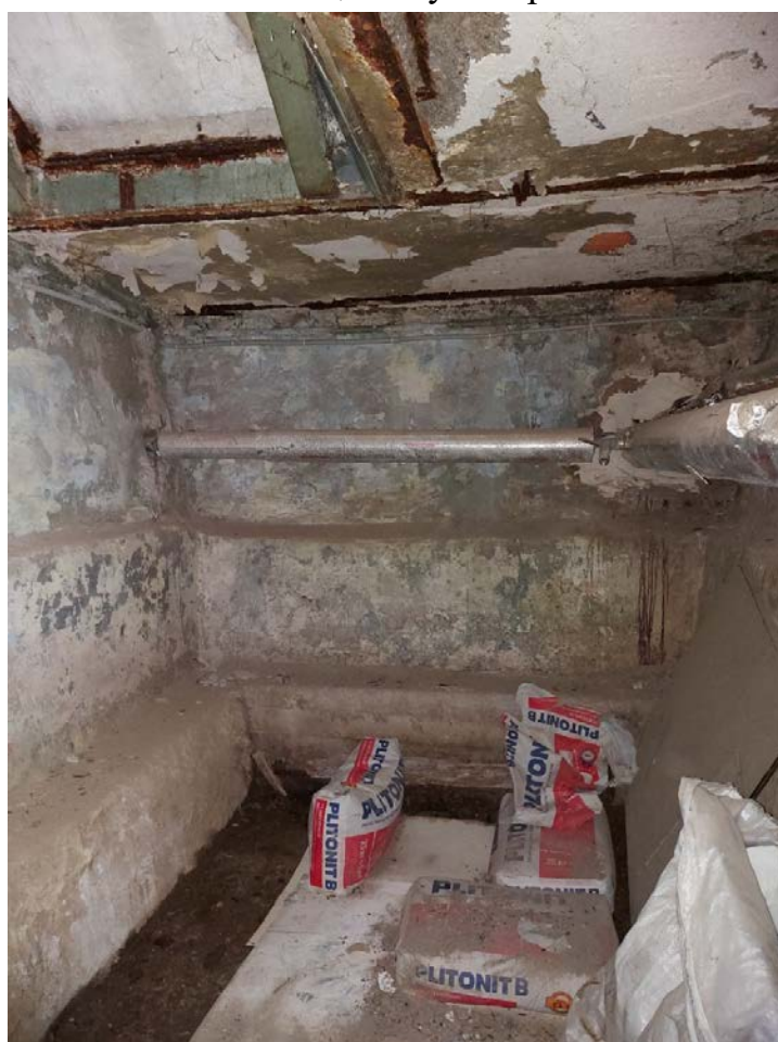
Фото 24. Под лестницей 1ЛК.
