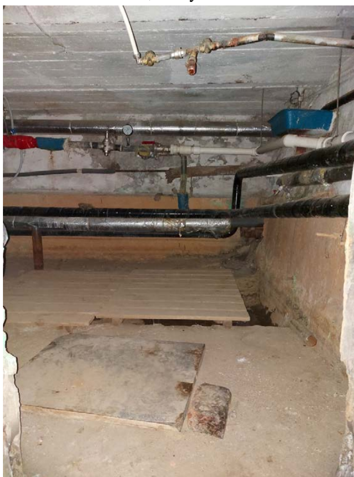
Фото 28. Помещение в центре у западной стены.
