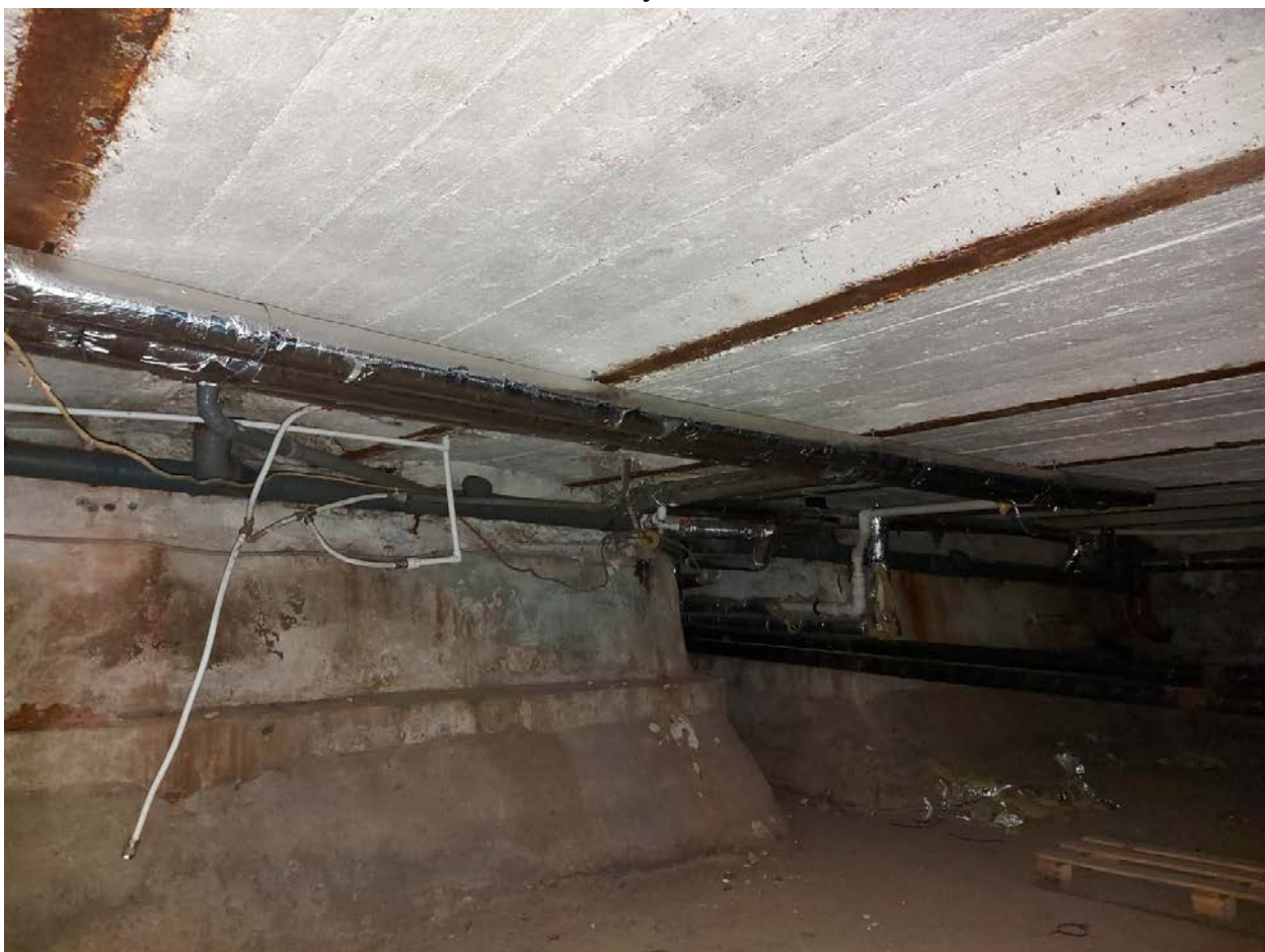
Фото 26. Проемы в центральной части.
