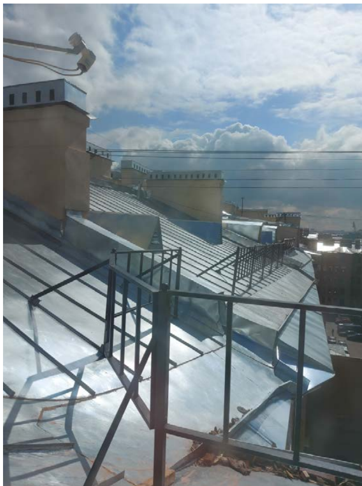
Фото 136. Вид крыши, дворовая часть.
