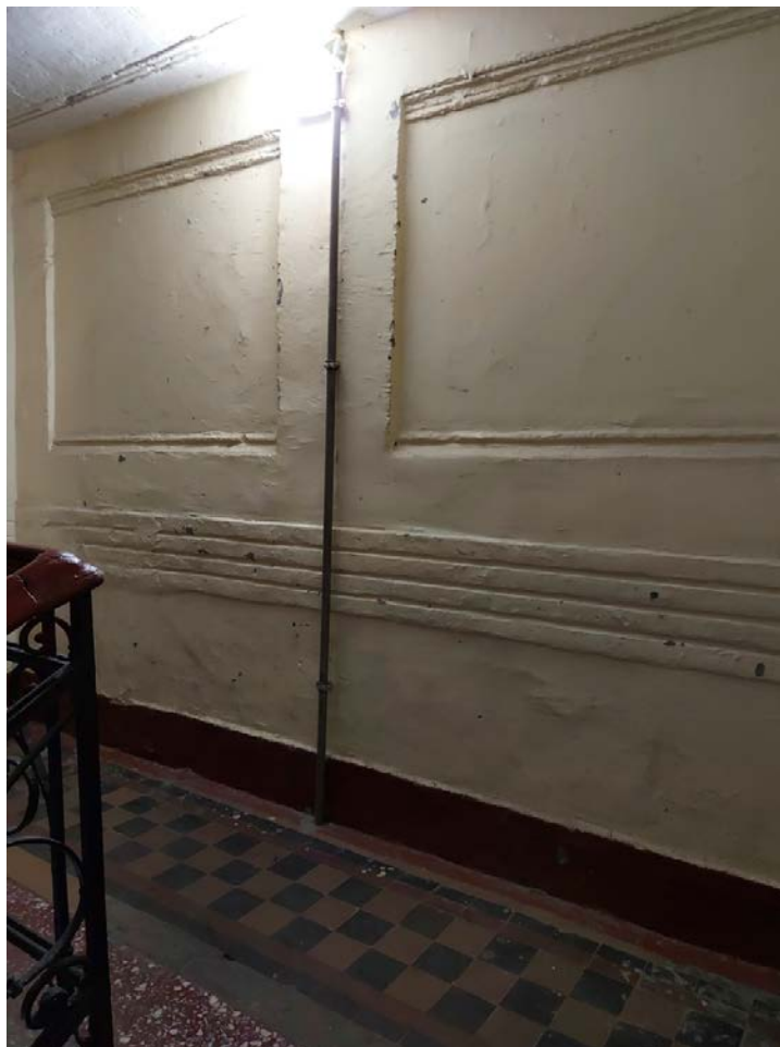
Фото 64. Междуэтажная площадка перед 2 этажом 2 ЛК.
