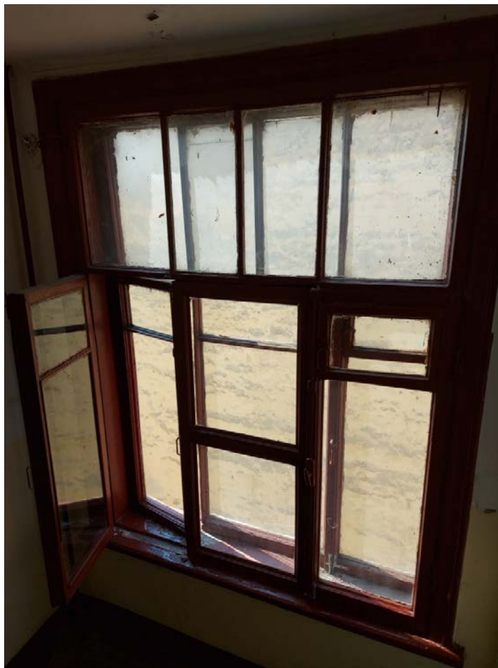
Фото 130. Оконный проем черной 2ЛК.
