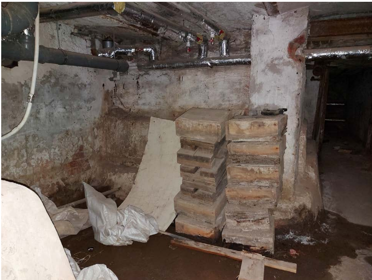
Фото 21. Фрагмент стен подвала.
