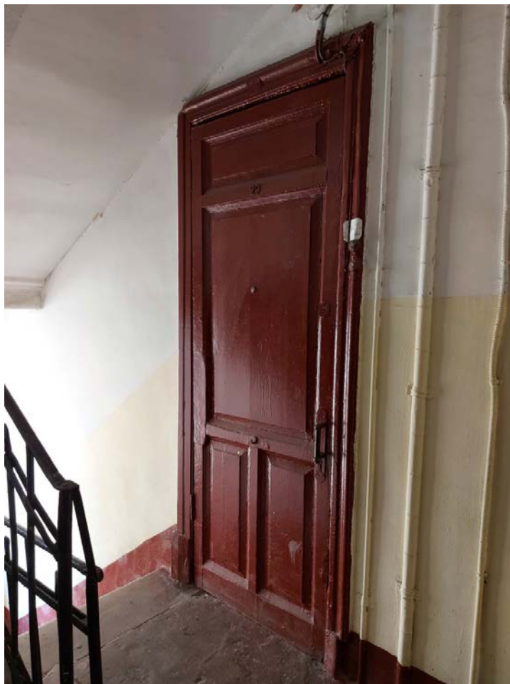
Фото 128. Дверное заполнение черной 2ЛК.
