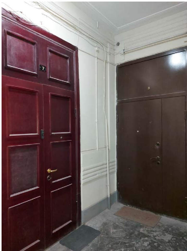
Фото 109. Проемы парадной 1ЛК.
