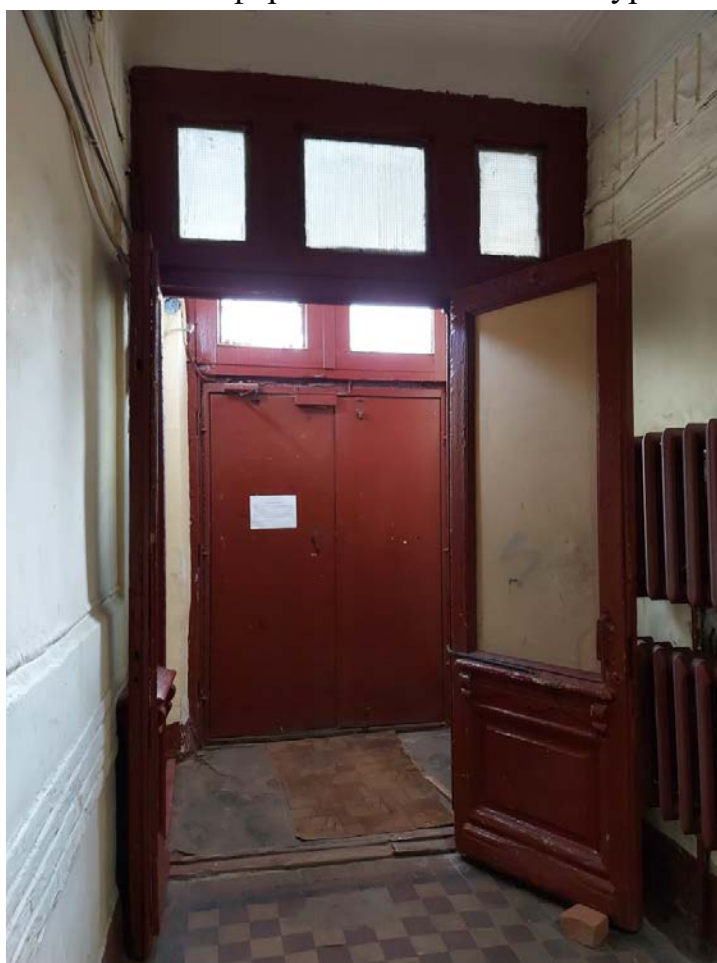
Фото 42. Тамбур с дверным проемом.
