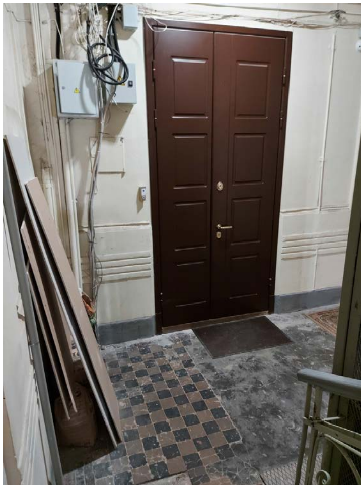
Фото 120. Площадка парадной 1ЛК.
