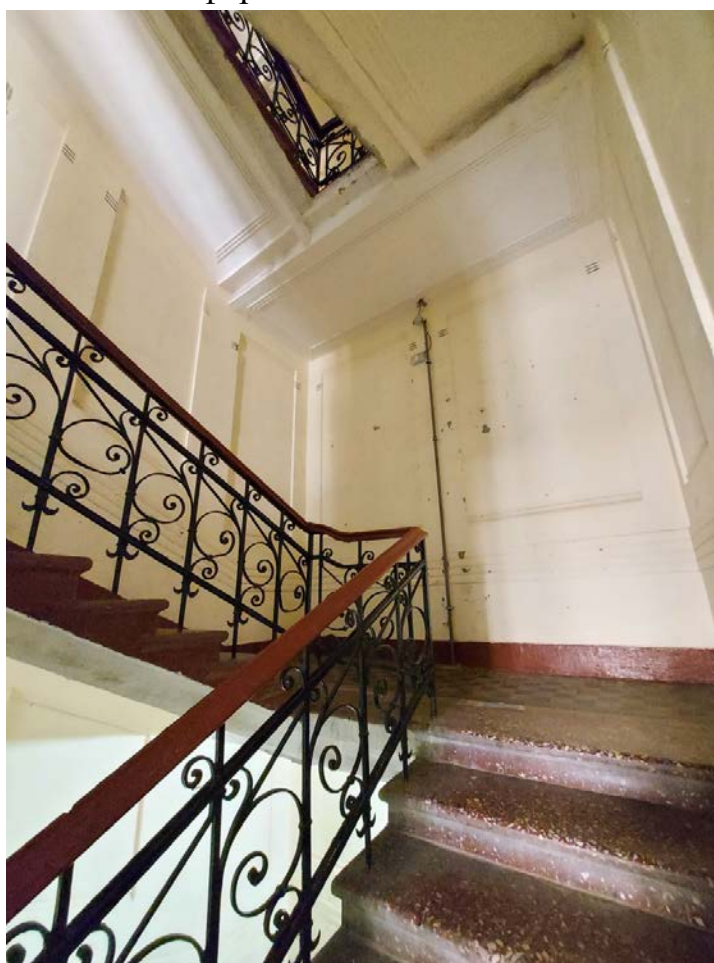
Фото 69. Лестница и площадка на 3 этаж 2ЛК.
