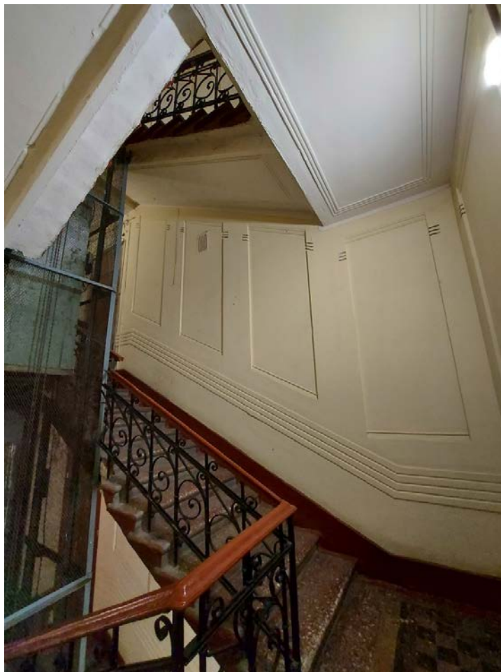
Фото 111. Оформление стены междуэтажной площадки 2ЛК.
