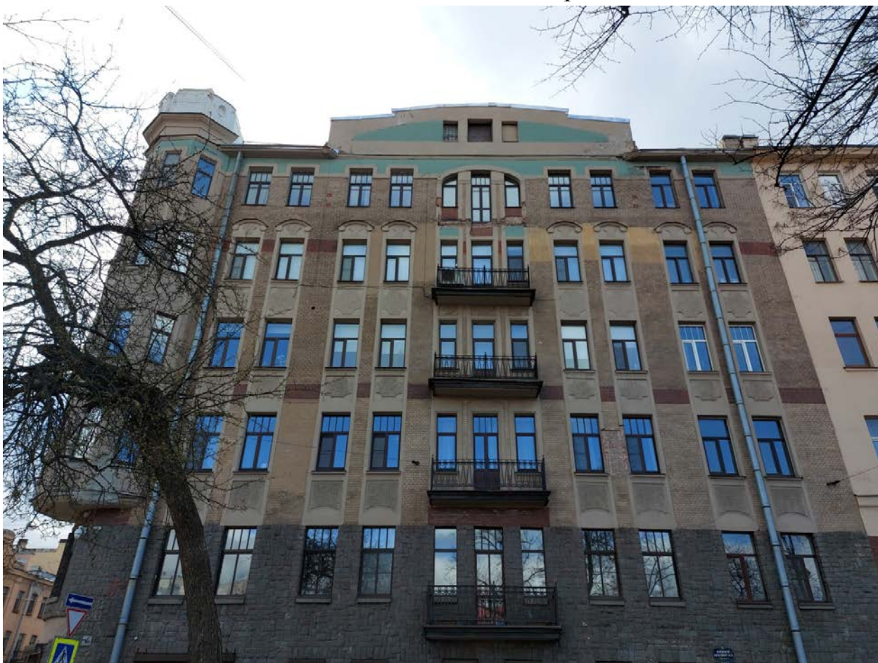
Фото 2. Вид с северо-запада.
