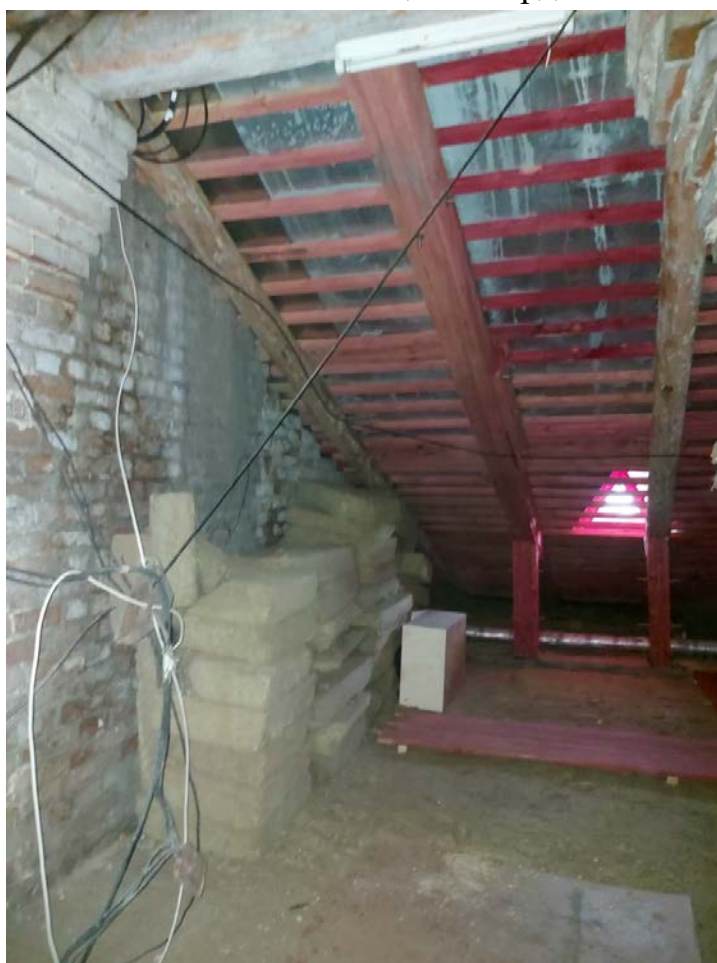
Фото 138. Вид на скат кровли.
