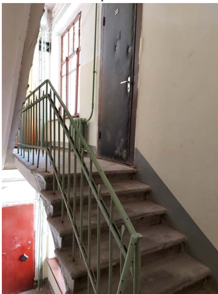
Фото 57. Междуэтажная площадка черной 1ЛК.
