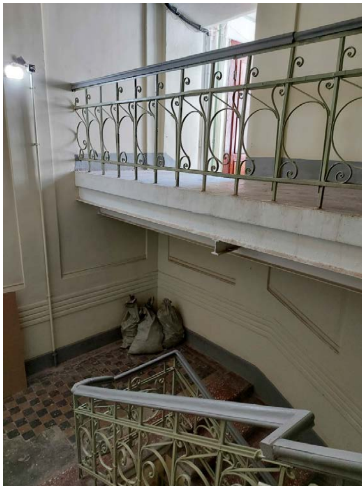
Фото 122. Общий вид парадной 1ЛК.
