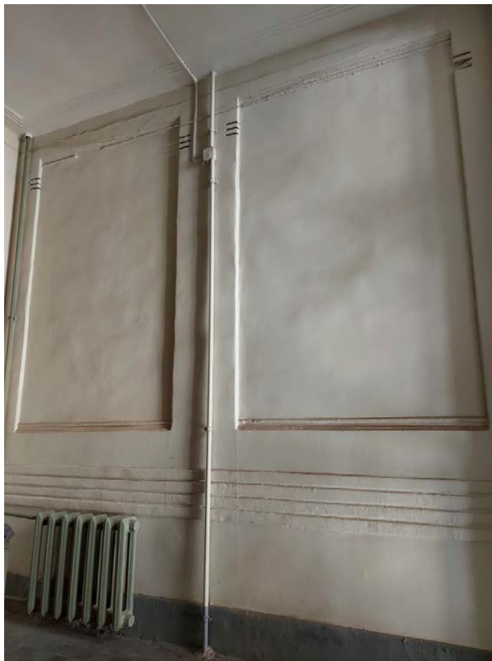
Фото 70. Оформление стен междуэтажной площадки парадной 1ЛК.
