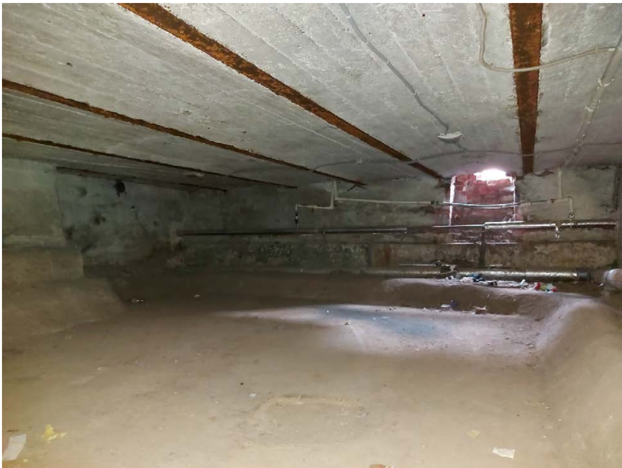
Фото 27. Помещение у восточной стены.
