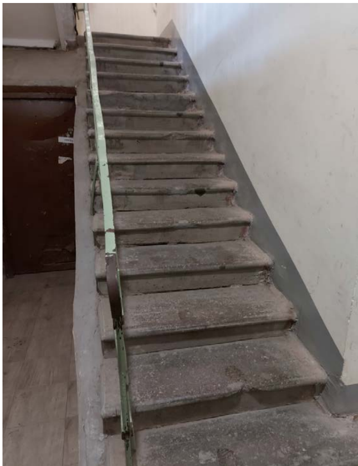
Фото 29. Черная лестница 1ЛК.
