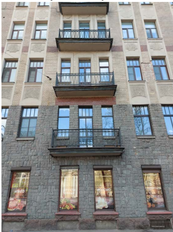
Фото 4. Балконы северо-западного фасада.
