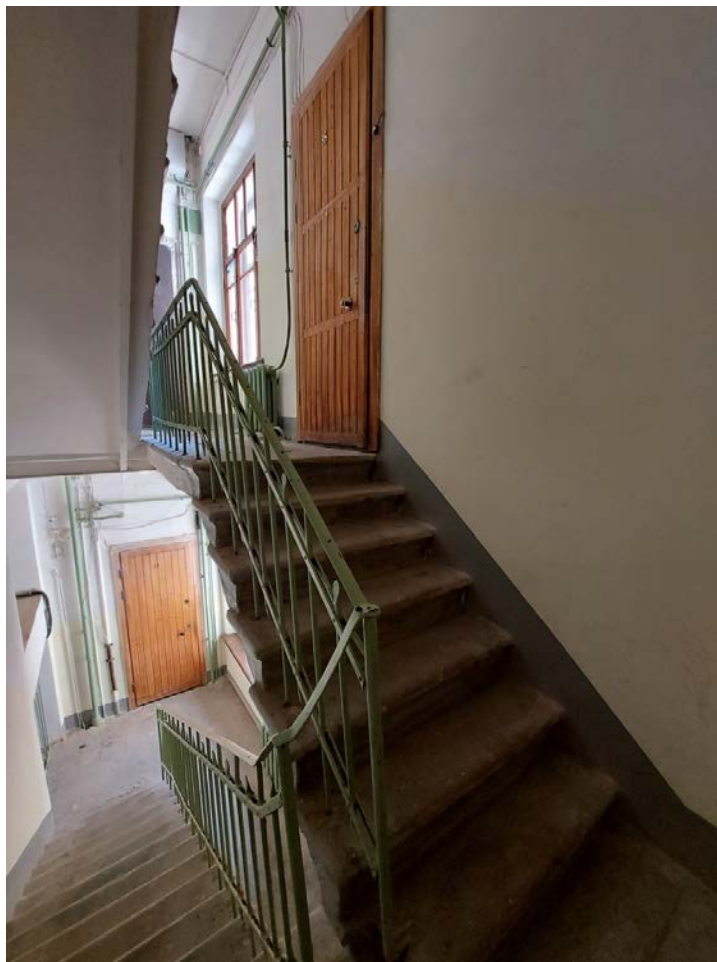
Фото 78. Междуэтажная площадка черной 1ЛК.
