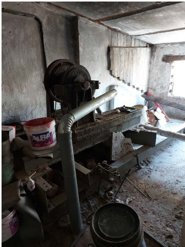
Фото 141. Лифтовая шахта 2ЛК.
