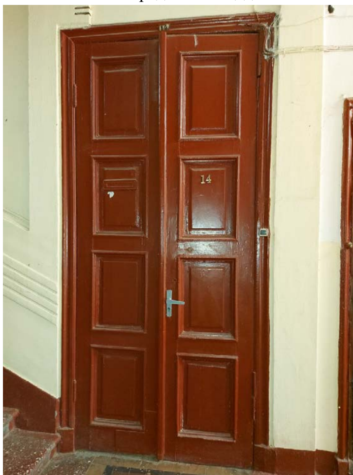
Фото 81. Дверное заполнение 2ЛК.
