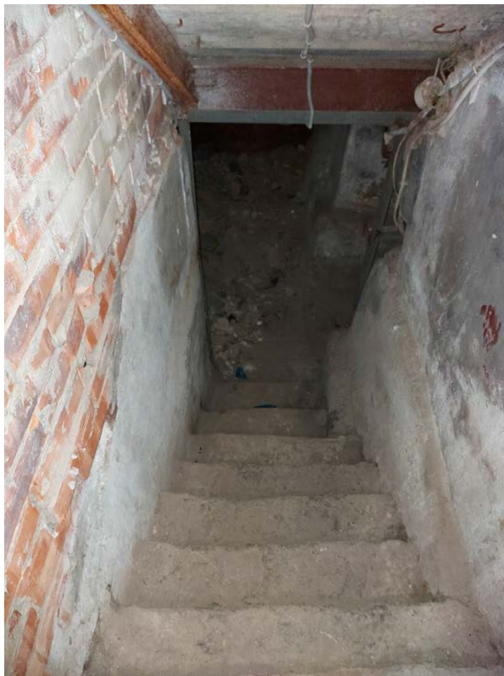
Фото 25. Лестница в южную часть подвала с 2ЛК.
