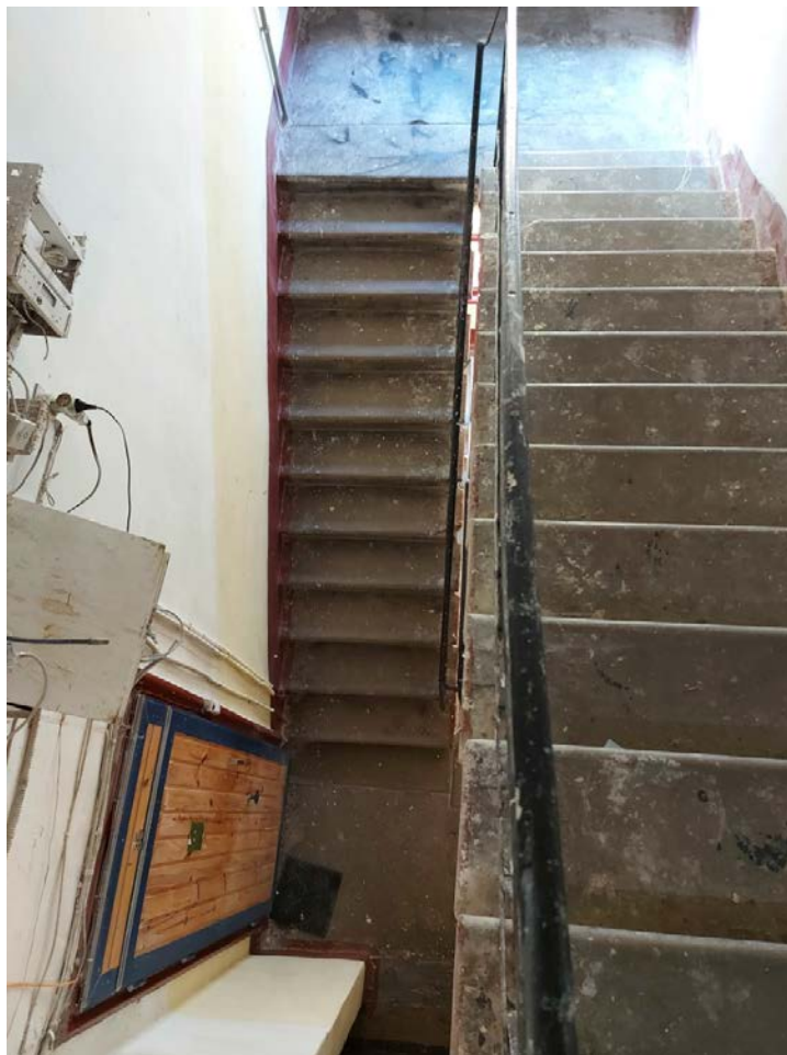
Фото 137. Вид лестницы на чердак 2ЛК.
