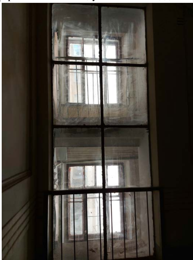
Фото 71. Оконные проемы междуэтажной площадки 1ЛК.
