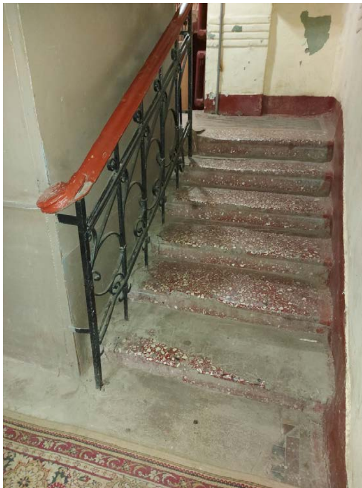
Фото 45. Лестница парадного входа 2ЛК.
