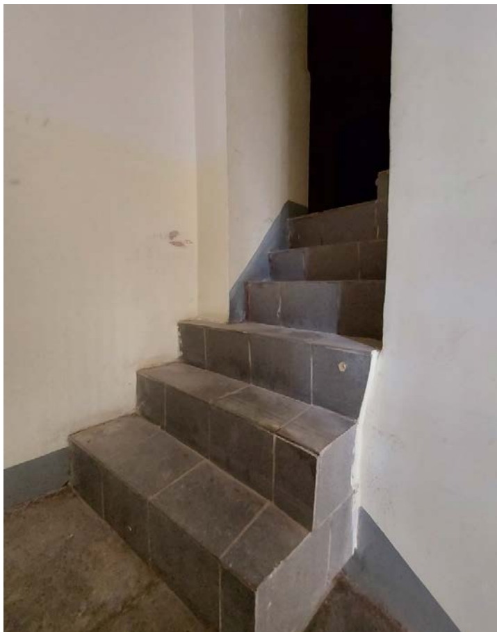
Фото 99. Лестница на пятый этаж парадной части 1ЛК.
