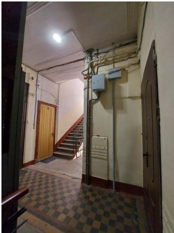
Фото 66. Вид этажа 2ЛК.
