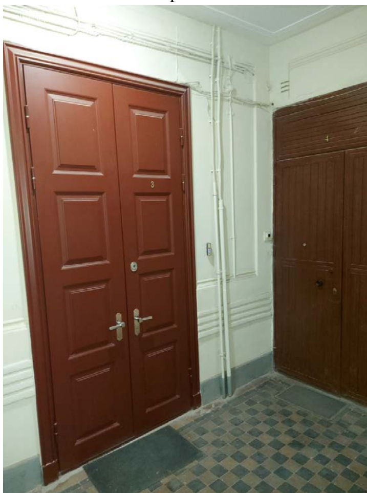
Фото 73. Дверные проемы парадной 1ЛК.
