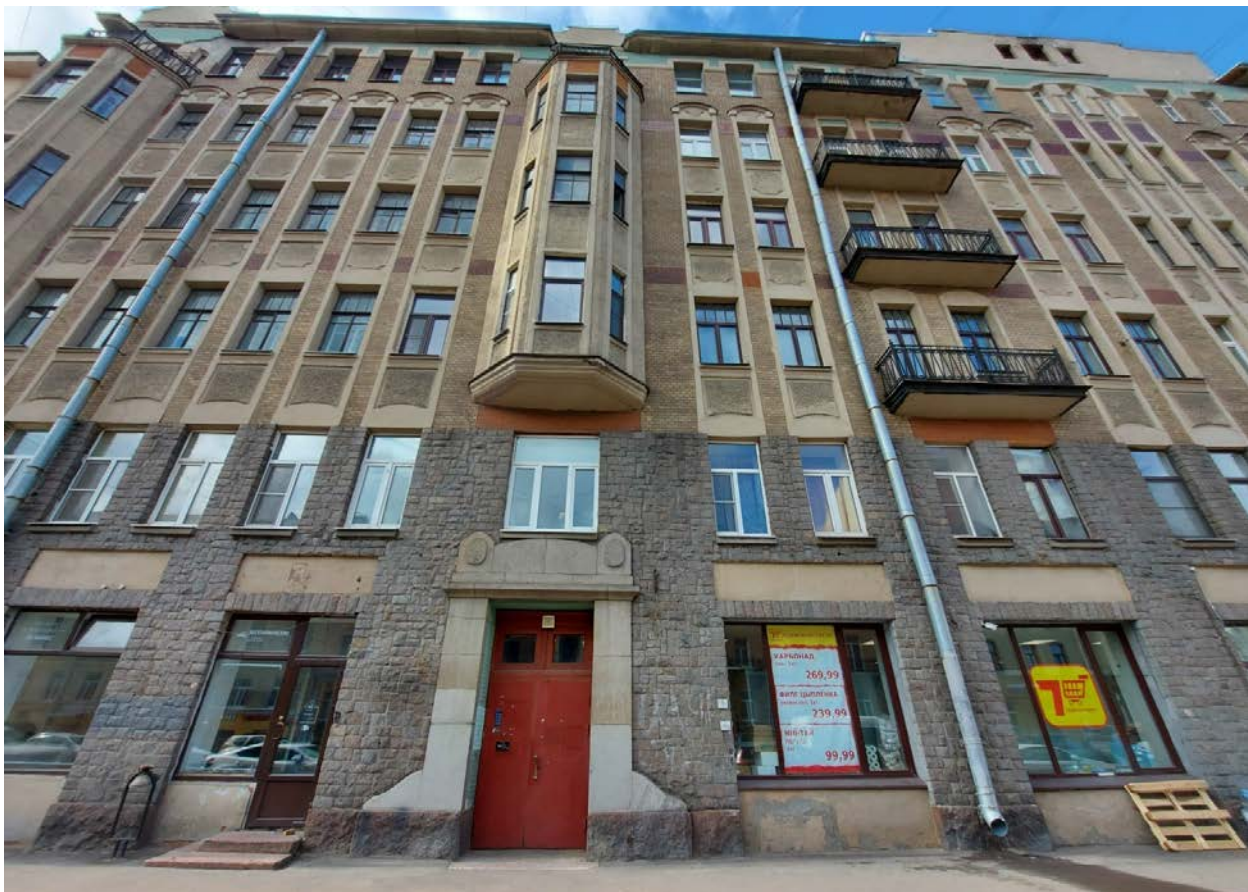
Фото 11. Фрагмент фасада с дверным проемом 2ЛК.
