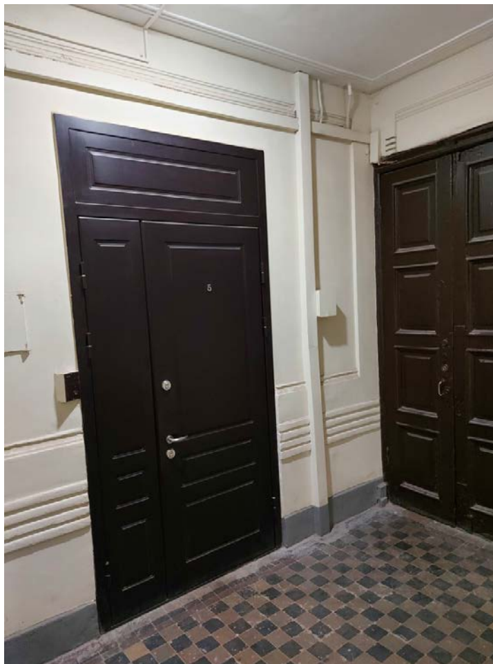
Фото 91 Площадка парадной 1ЛК.
