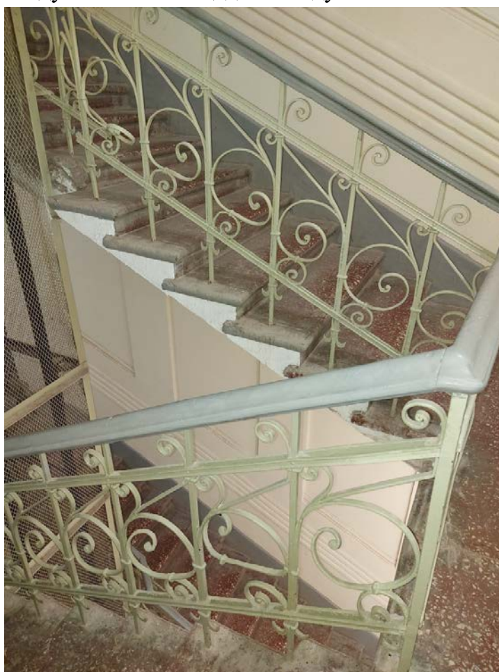
Фото 106. Ограждение лестницы парадной 1ЛК.
