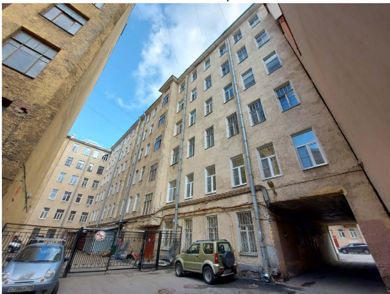
Фото 16. Общий вид с юга дворового фасада.
