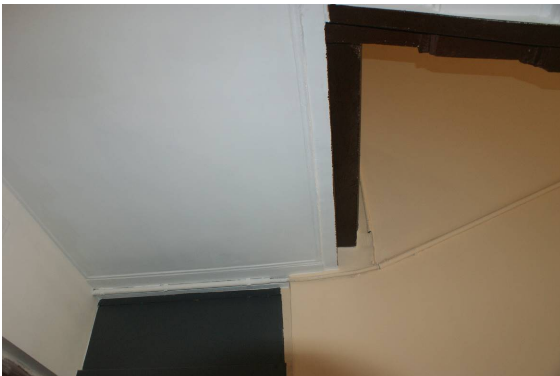
Фото 37. Лестница № 1. Площадка 5-го этажа. Оформление потолка. Съемка 19.04.2021 г. Штиглиц М. С
