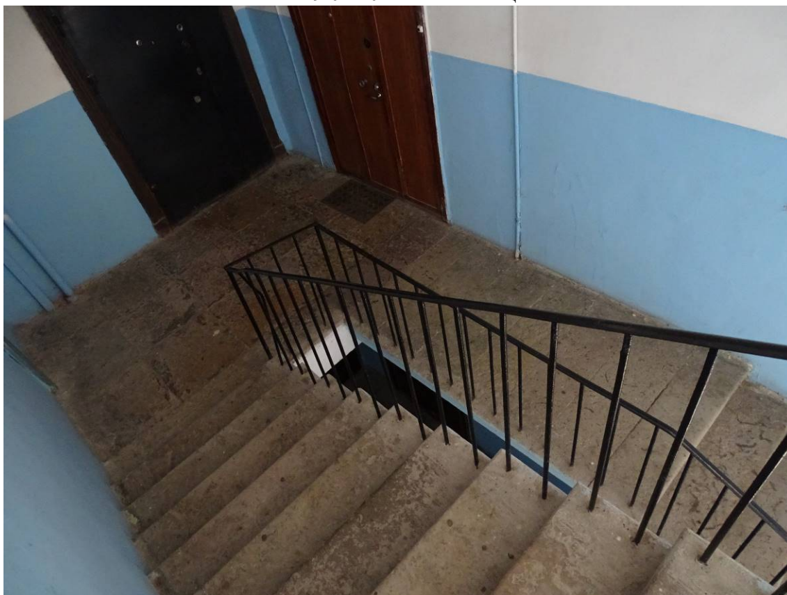
Фото 114. Лестница № 4. Вид на площадку 2-го этажа. Съемка 19.04.2021 г. Штиглиц М. С.
