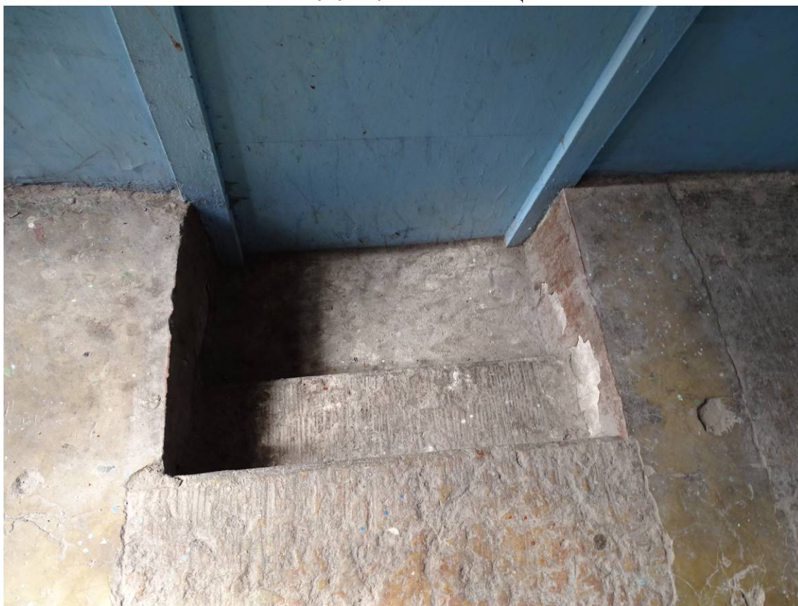
Фото 124. Лестница № 4. Площадка между 3-м и 4-м этажом. Съемка 19.04.2021 г. Штиглиц М. С.
