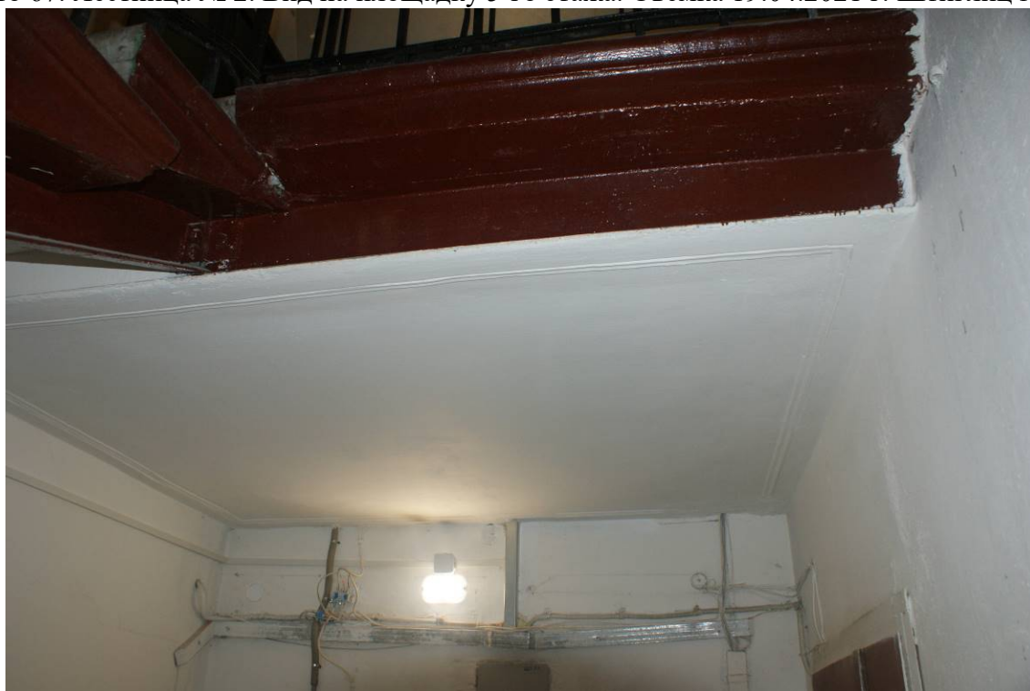
Фото 68. Лестница № 2. Площадка 5-го этажа. Оформление потолка. Съемка 19.04.2021 г. Штиглиц М. С.
