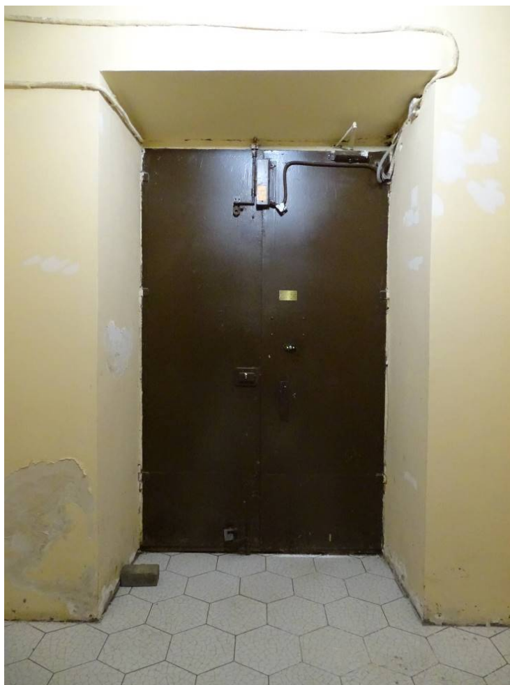
Фото 3. Лестница № 1. Вестибюль. 1-й этаж. Входная дверь. Съемка 19.04.2021 г. Штиглиц М. С.
