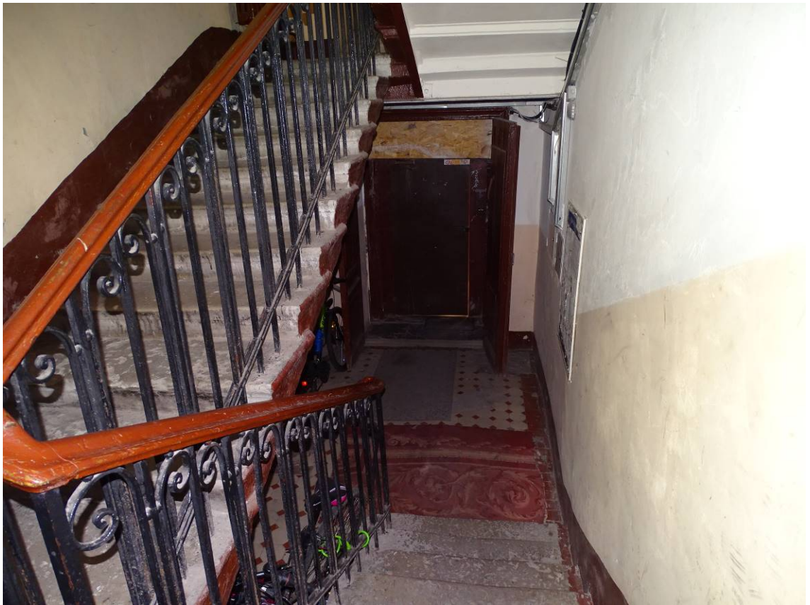
Фото 47. Лестница № 2. Вестибюль. 1-й этаж. Съёмка 19.04.2021 г. Штиглиц М. С.
