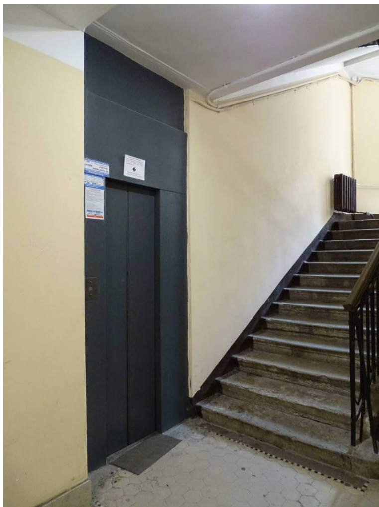
Фото 13. Лестница № 1. Вестибюль. 1-й этаж. Съемка 19.04.2021 г. Штиглиц М. С.
