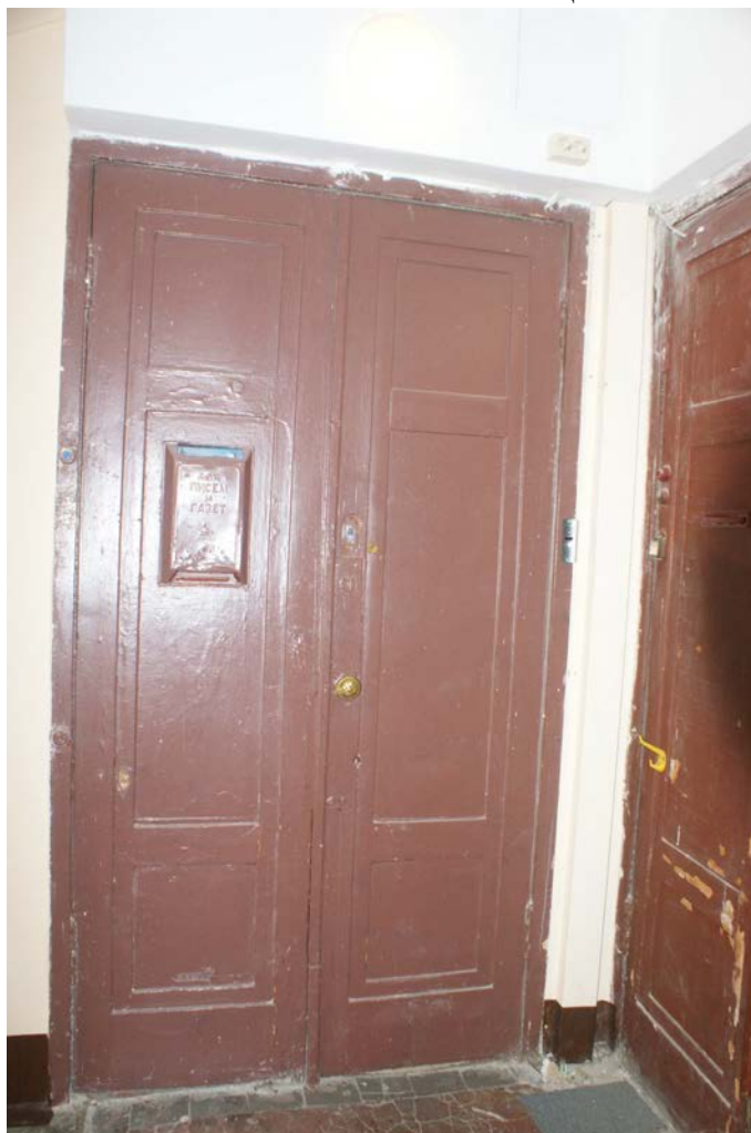
Фото 38. Лестница № 1. Площадка 5-го этажа. Дверной проем. Съемка 19.04.2021 г. Штиглиц М. С
