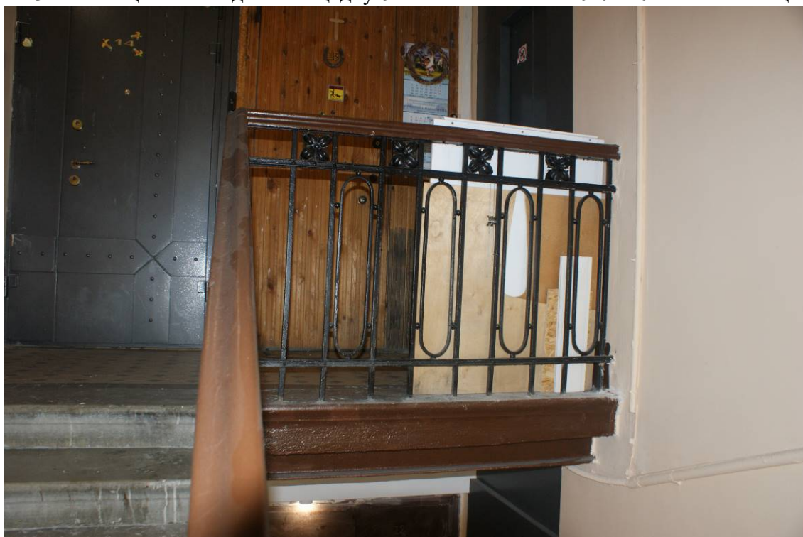
Фото 44. Лестница № 1. Площадка 6-го этажа. Лестничное ограждение. Съемка 19.04.2021 г. Штиглиц М. С.
