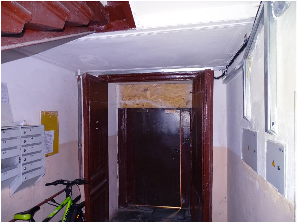
Фото 48. Лестница № 2. 1-й этаж. Входная дверь. Съёмка 19.04.2021 г. Штиглиц М. С.
