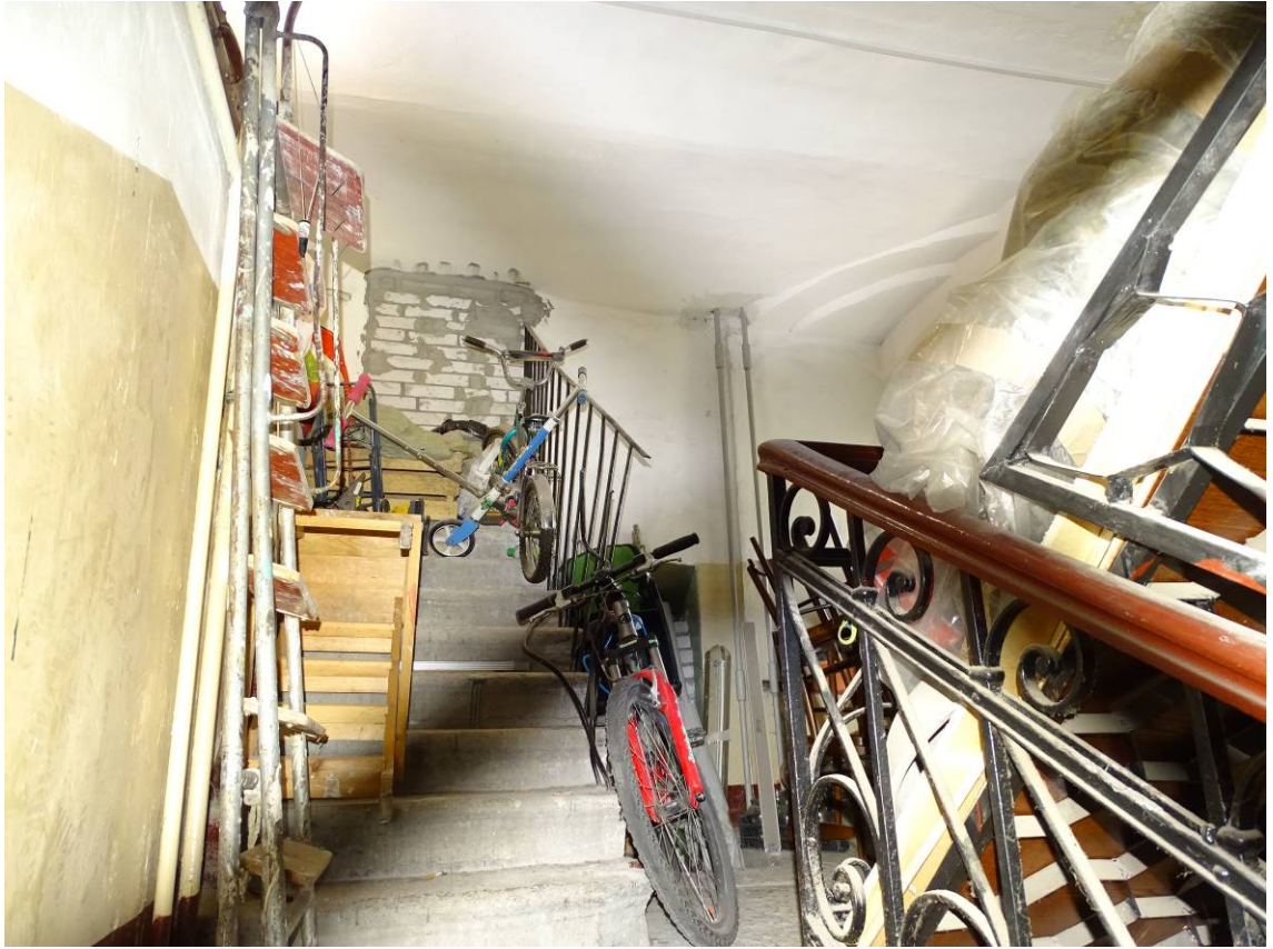
Фото 177. Лестница № 5. Площадка 6-го этажа. Съемка 19.04.2021 г. Штиглиц М. С.
