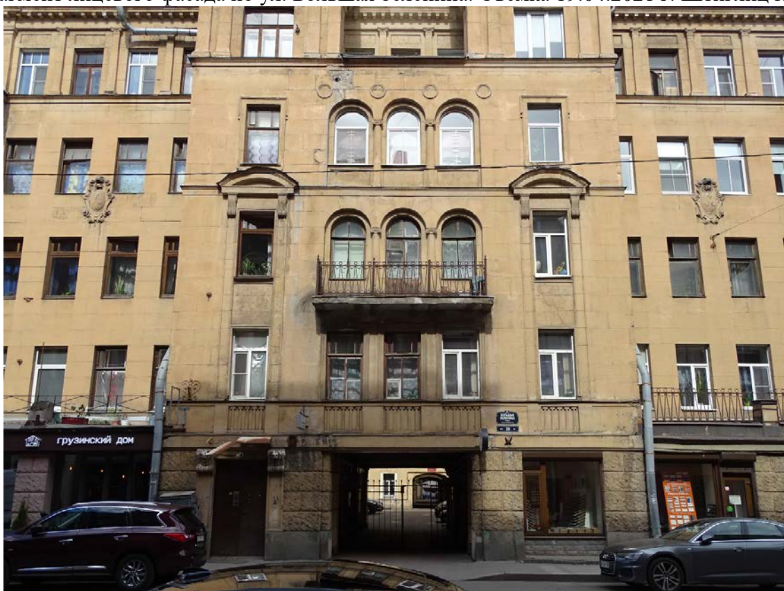
Фото 6. Здание по адресу: г. Санкт-Петербург, Большая Зеленина ул., дом 29, литера А. Фрагмент лицевого фасада по ул. Большая Зеленина. Ризалит с воротным проездом. Съемка 19.04.2021 г. Штиглиц М. С.
