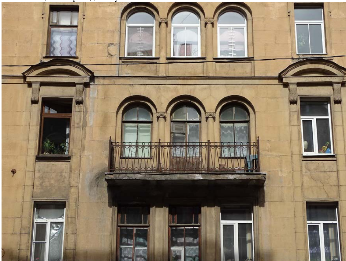
Фото 8. Здание по адресу: г. Санкт-Петербург, Большая Зеленина ул., дом 29, литера А. Фрагмент лицевого фасада по ул. Большая Зеленина. Балкон. Съемка 19.04.2021 г. Штиглиц М. С.
