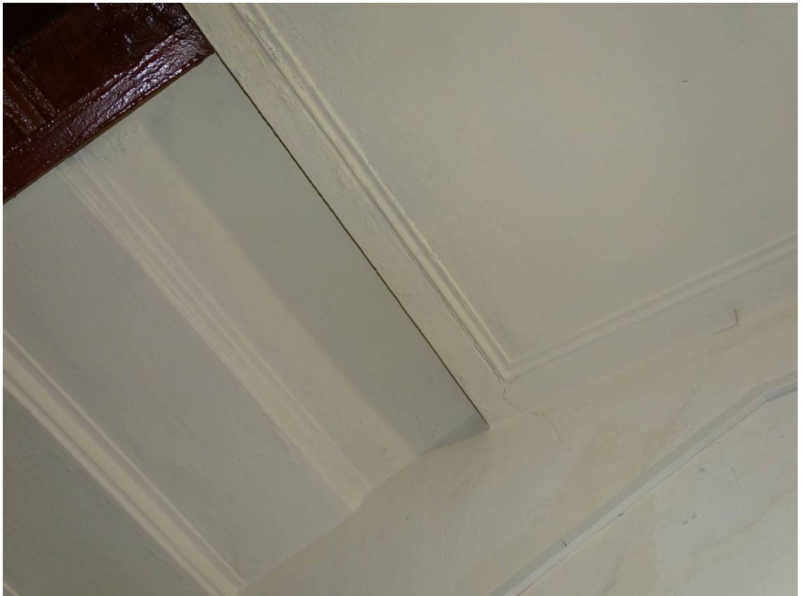
Фото 88. Лестница № 3. Площадка между 2-м и 3-м этажом. Оформление потолка. Съемка 19.04.2021 г. Штиглиц М. С.
