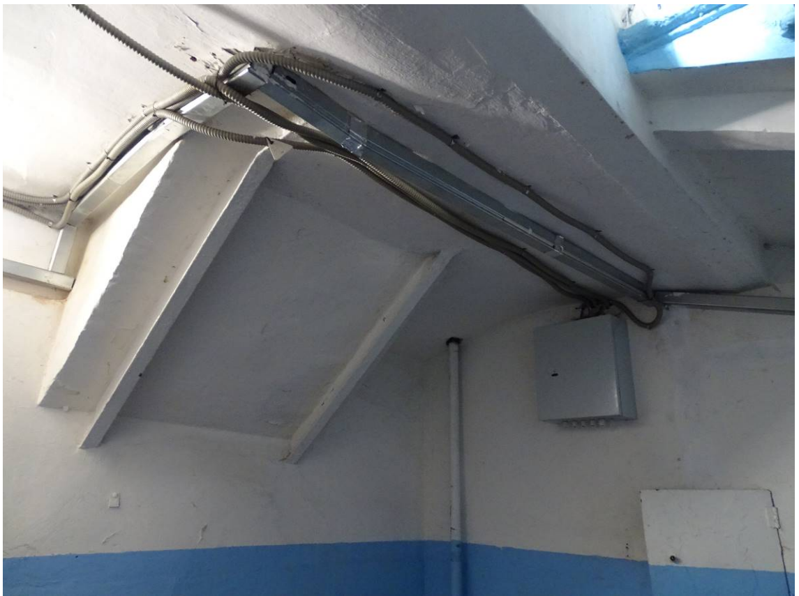
Фото 106. Лестница № 4. Вестибюль. 1-й этаж. Своды. Съемка 19.04.2021 г. Штиглиц М. С.
