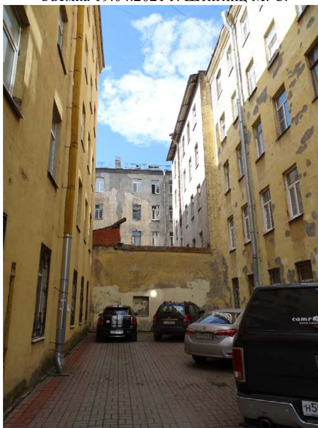
Фото 36. Здание по адресу: г. Санкт-Петербург, Большая Зеленина ул., дом 29, литера А. Северо-восточный и юго-западный фасад 5-ти этажного корпуса. Съемка 19.04.2021 г. Штиглиц М. С.
