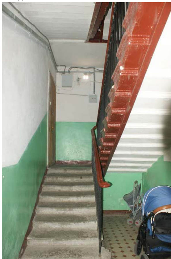
Фото 83. Лестница № 3. Вид на площадку 1-го этажа. Съемка 19.04.2021 г. Штиглиц М. С.
