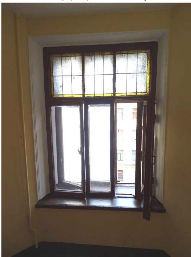
Фото 32. Лестница № 1. Площадка между 4-м и 5-м этажом. Оконное заполнение. Съемка 19.04.2021 г. Штиглиц М. С.
