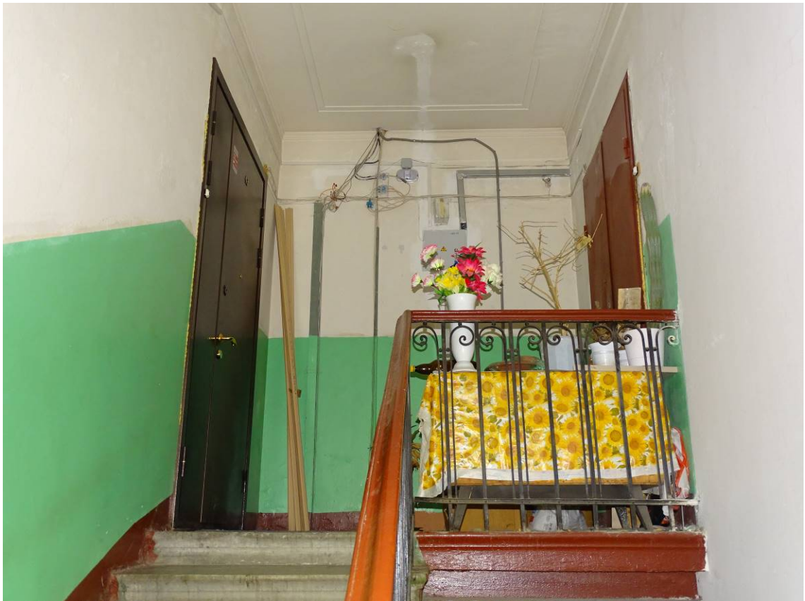
Фото 100. Лестница № 3. Вид на площадку 6-го этажа. Съемка 19.04.2021 г. Штиглиц М. С.
