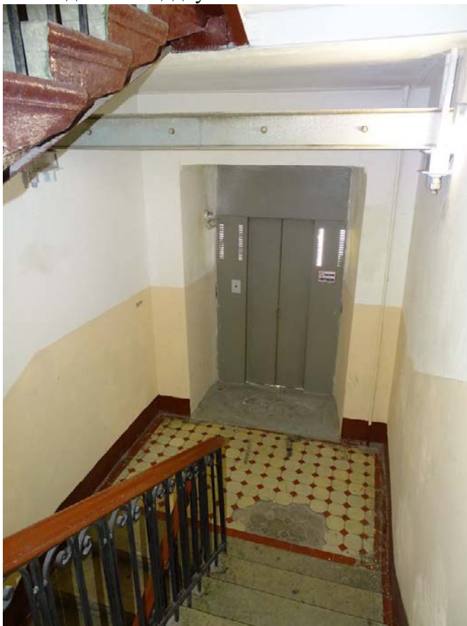
Фото 64. Лестница № 2. Вид на площадку м/у 4-м и 5-м этажом. Съемка 19.04.2021 г. Штиглиц М. С.
