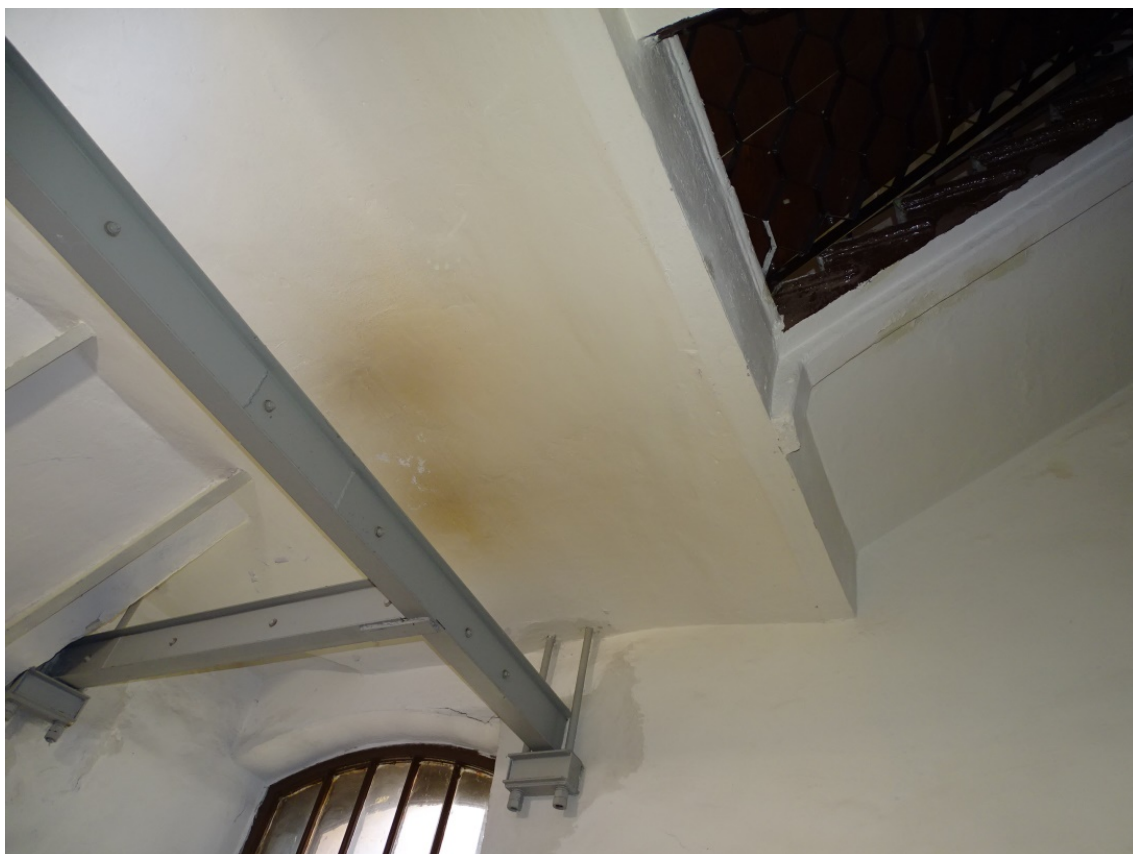
Фото 169. Лестница № 5. Площадка м/у 4-м и 5-м этажом. Своды. Съемка 19.04.2021 г. Штиглиц М. С.
