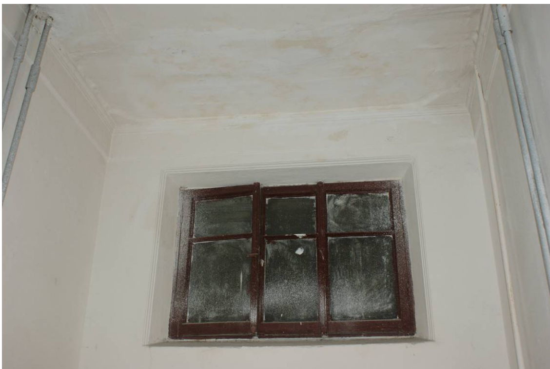
Фото 73. Лестница № 2. Площадка между 5-м и 6-м этажом. Оконный проем. Съемка 19.04.2021 г. Штиглиц М. С.
