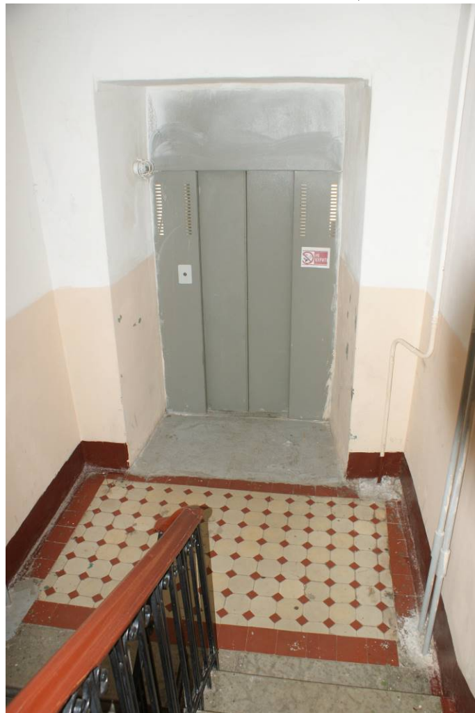
Фото 72. Лестница № 2. Площадка между 5-м и 6-м этажом. Съемка 19.04.2021 г. Штиглиц М. С.
