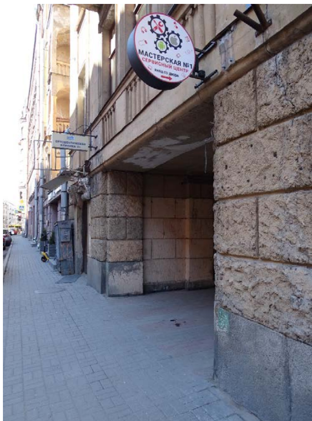
Фото 25. Здание по адресу: г. Санкт-Петербург, Большая Зеленина ул., дом 29, литера А. Воротный проезд Лицевого фасада по ул. Большая Зеленина. Съемка 19.04.2021 г. Штиглиц М. С.
