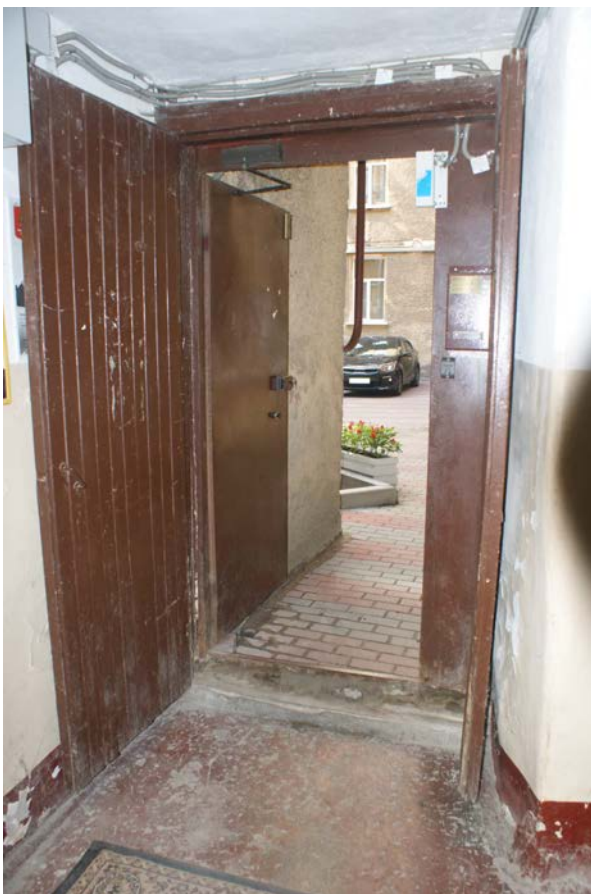
Фото 135. Лестница № 5. Вестибюль.1-й этаж. Входная дверь. Съемка 19.04.2021 г. Штиглиц М. С.
