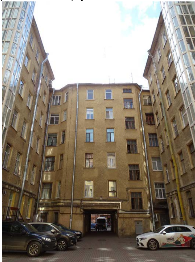
Фото 30. Здание по адресу: г. Санкт-Петербург, Большая Зеленина ул., дом 29, литера А. Дворовой фасад лицевого корпуса. Съемка 19.04.2021 г. Штиглиц М. С.
