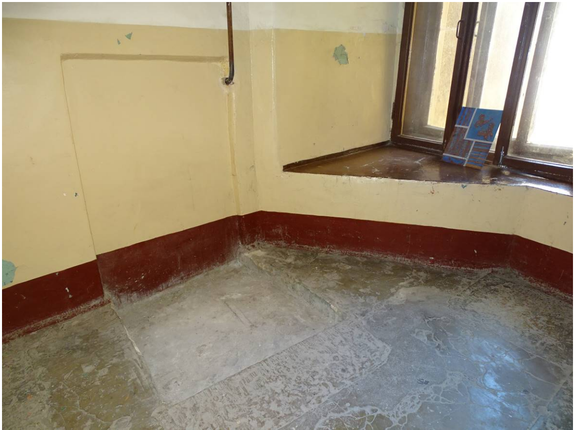
Фото 161. Лестница № 5. Площадка м/у 3-м и 4-м этажом. Съемка 19.04.2021 г. Штиглиц М. С.
