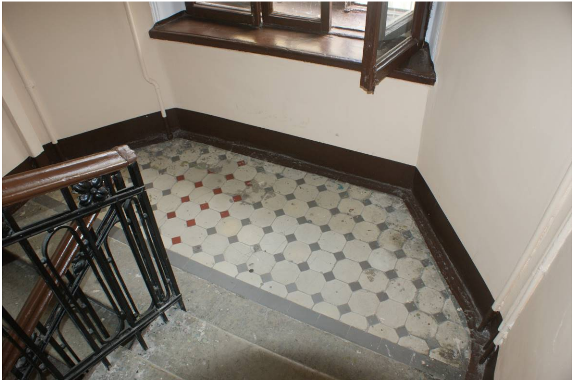
Фото 33. Лестница № 1. Площадка между 4-м и 5-м этажом. Покрытие пола. Съемка 19.04.2021 г. Штиглиц М. С.
