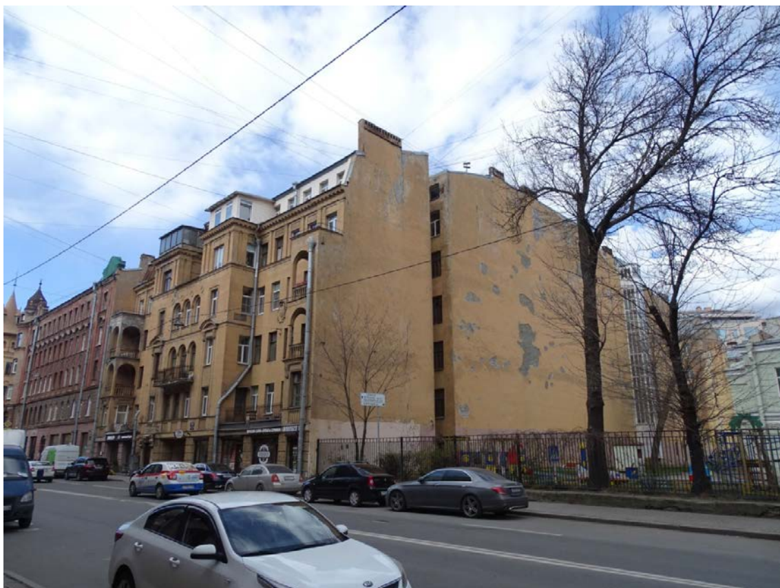
Фото 1. Здание по адресу: г. Санкт-Петербург, Большая Зеленина ул., дом 29, литера А. Лицевой фасад по ул. Большая Зеленина. Съемка 19.04.2021 г. Штиглиц М. С.
