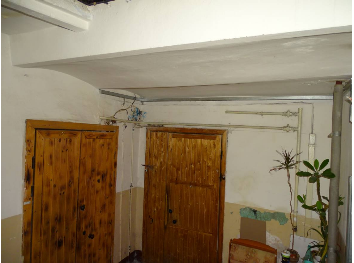
Фото 173. Лестница № 5. Площадка 5-го этажа. Своды. Съемка 19.04.2021 г. Штиглиц М. С.
