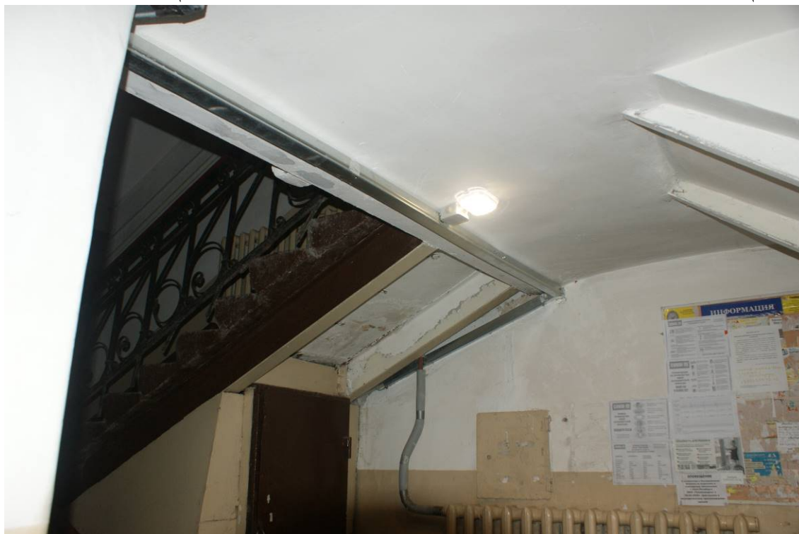
Фото 138. Лестница № 5. Вестибюль. 1-й этаж. Съемка 19.04.2021 г. Штиглиц М. С.
