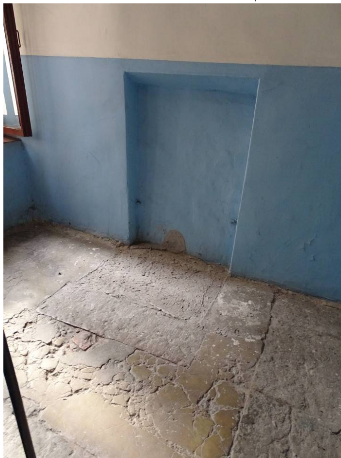
Фото 118. Лестница № 4. Площадка между 2-м и 3-м этажом. Съемка 19.04.2021 г. Штиглиц М. С.
