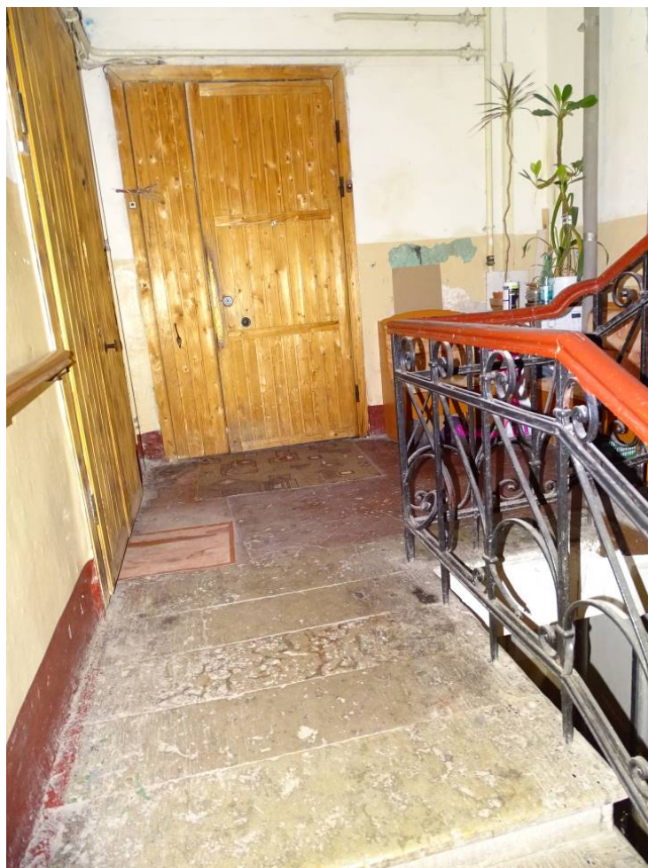
Фото 171. Лестница № 5. Площадка 5-го этажа. Съемка 19.04.2021 г. Штиглиц М. С.
