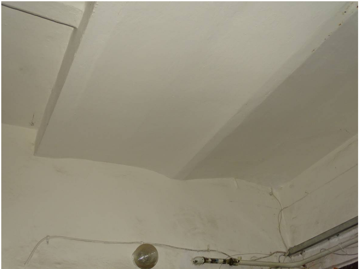
Фото 159. Лестница № 5. Площадка 3-го этажа. Своды. Съемка 19.04.2021 г. Штиглиц М. С.
