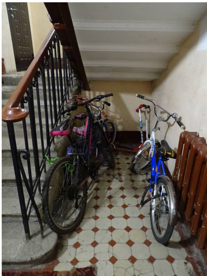
Фото 49. Лестница № 2. Вестибюль. 1-й этаж. Пространство под лестницей. Съемка 19.04.2021 г. Штиглиц М. С.
