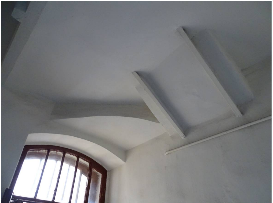
Фото 122. Лестница № 4. Площадка м/у 3-м и 4-м этажом. Съемка 19.04.2021 г. Штиглиц М. С.
