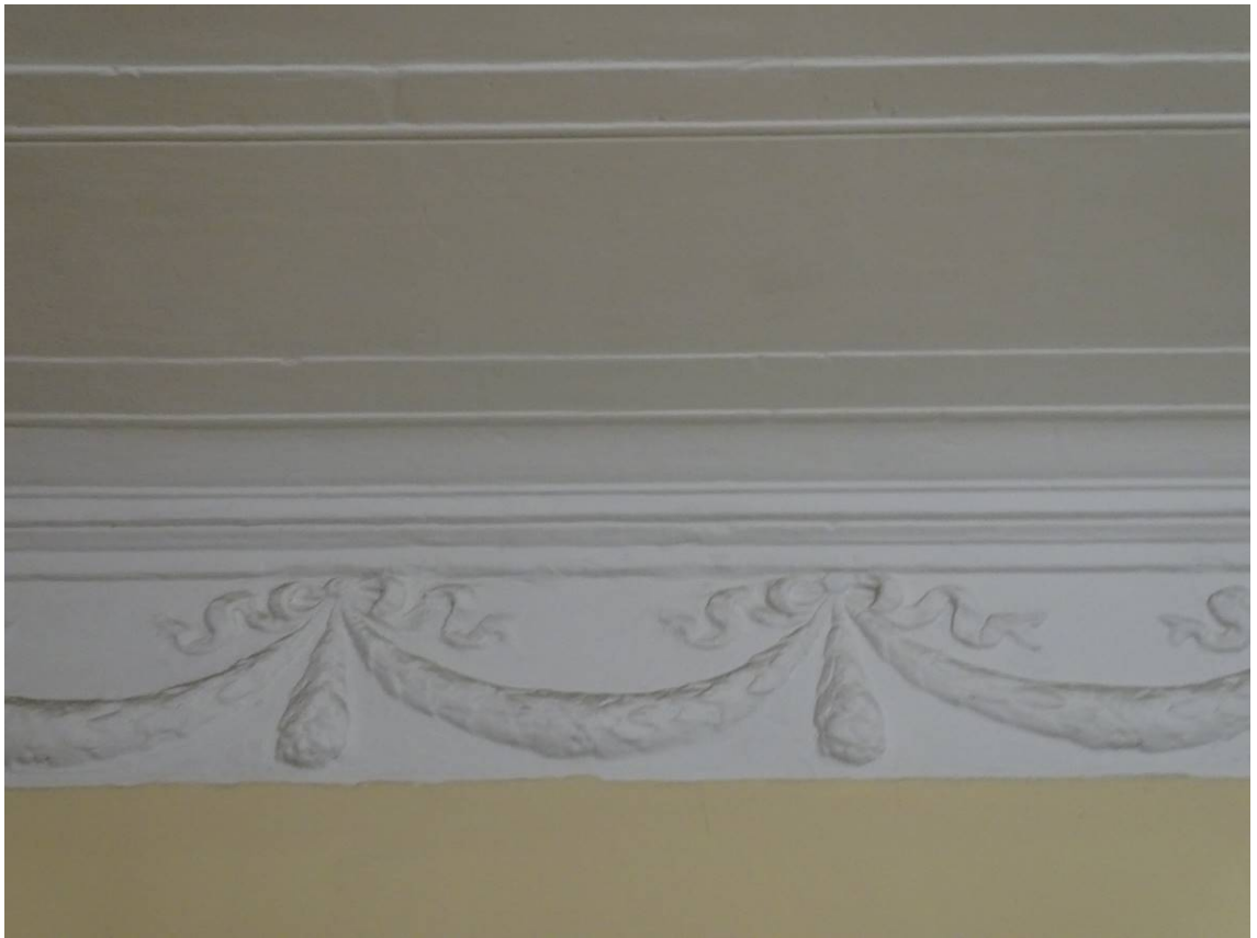
Фото 7. Лестница № 1. Вестибюль.1-й этаж. Лепной фриз. Съемка 19.04.2021 г. Штиглиц М. С.
