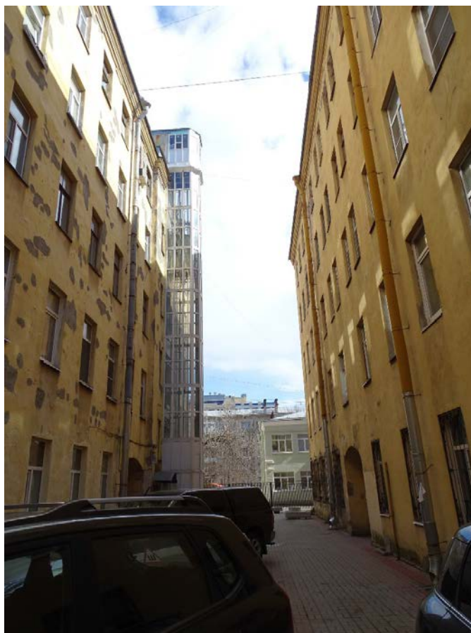
Фото 39. Здание по адресу: г. Санкт-Петербург, Большая Зеленина ул., дом 29, литера А. Северо-восточный и юго-западный фасад 5-ти этажного корпуса. Съемка 19.04.2021 г. Штиглиц М. С.
