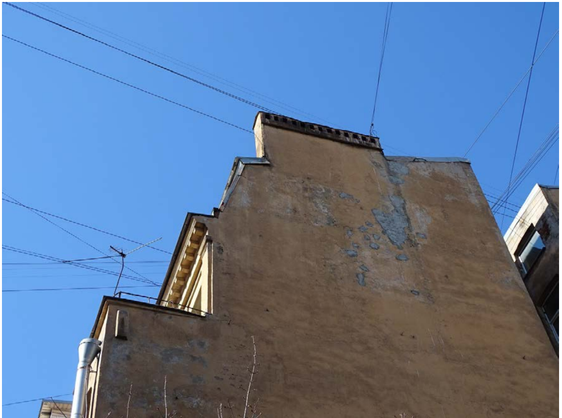
Фото 11. Здание по адресу: г. Санкт-Петербург, Большая Зеленина ул., дом 29, литера А. Брандмауэр. Съемка 19.04.2021 г. Штиглиц М. С.
