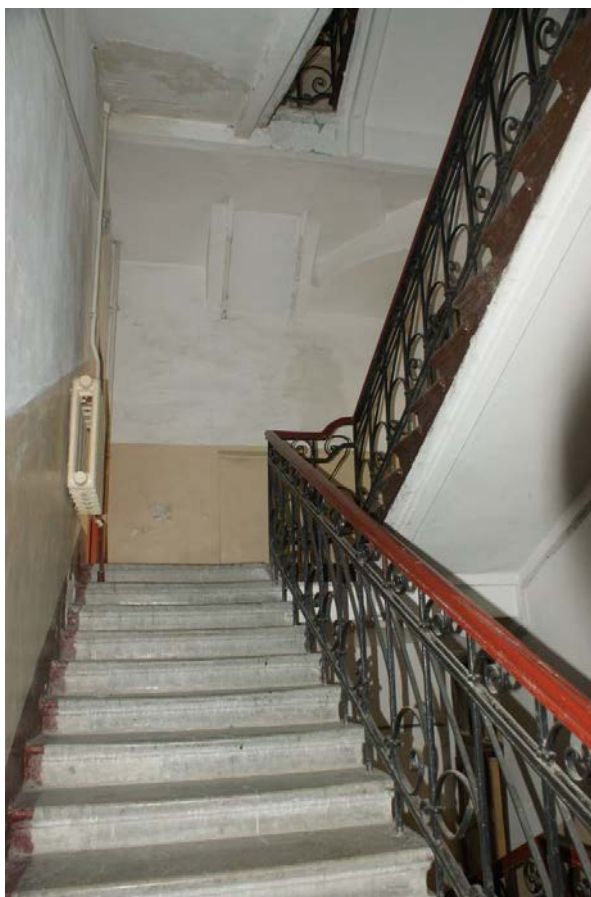
Фото 151. Лестница № 5. Вид на площадку м/у 2-м и 3-м этажом. Съемка 19.04.2021 г. Штиглиц М. С.
