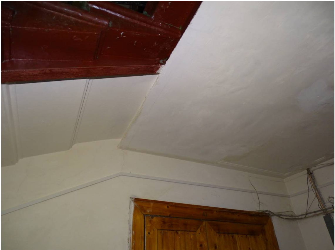
Фото 96. Лестница № 3. Площадка 5-го этажа. Оформление потолка. Съемка 19.04.2021 г. Штиглиц М. С.
