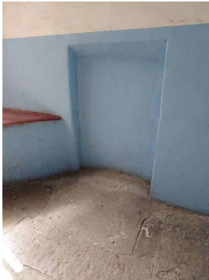
Фото 112. Лестница № 4. Площадка м/у 1-м и 2-м этажом. Съемка 19.04.2021 г. Штиглиц М. С.
