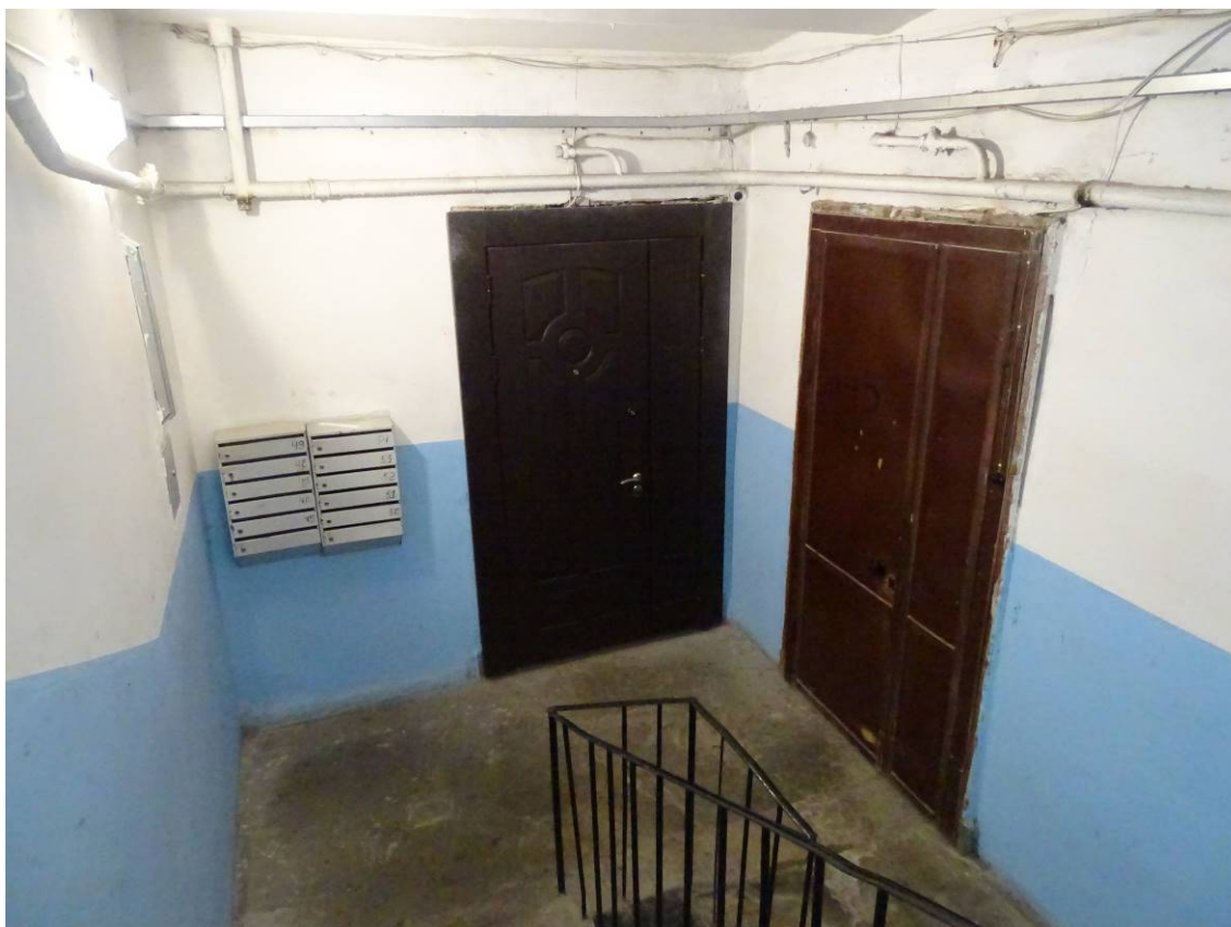
Фото 109. Лестница № 4. Вид на площадку 1-го этажа. Съемка 19.04.2021 г. Штиглиц М. С.
