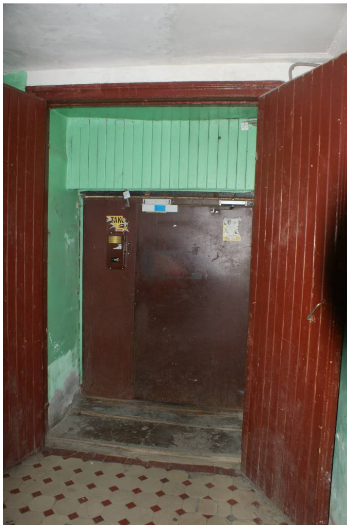
Фото 76. Лестница № 3. Вестибюль.1-й этаж. Съемка 19.04.2021 г. Штиглиц М. С.
