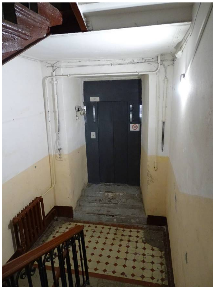
Фото 55. Лестница № 2. Вид на площадку м/у 1-м и 2-м этажом. Съемка 19.04.2021 г. Штиглиц М. С.
