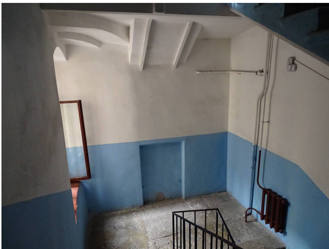
Фото 116. Лестница № 4. Вид на площадку м/у 2-м и 3-м этажом. Съемка 19.04.2021 г. Штиглиц М. С.
