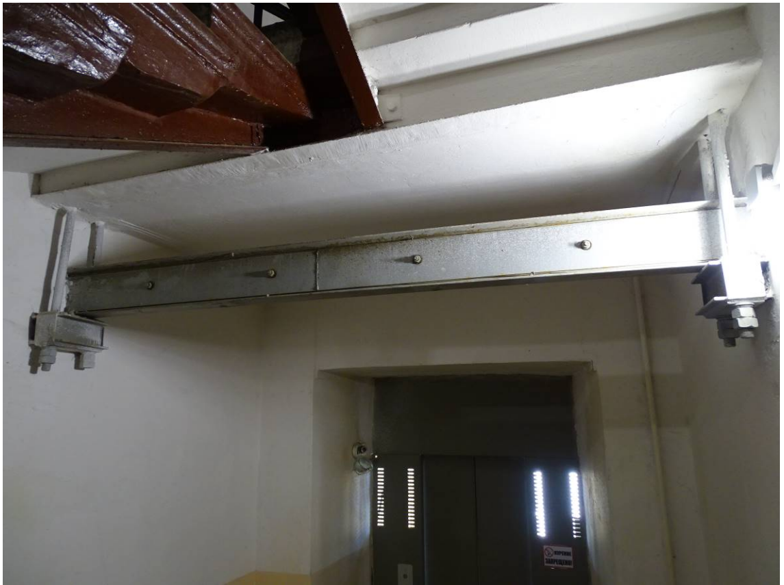
Фото 65. Лестница № 2. Площадка м/у 4-м и 5-м этажом. Съемка 19.04.2021 г. Штиглиц М. С.
