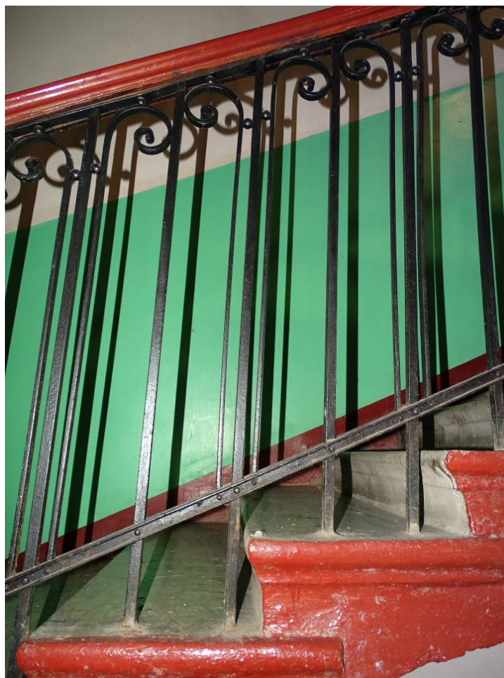
Фото 92. Лестница № 3. Лестничное ограждение. Съемка 19.04.2021 г. Штиглиц М. С.
