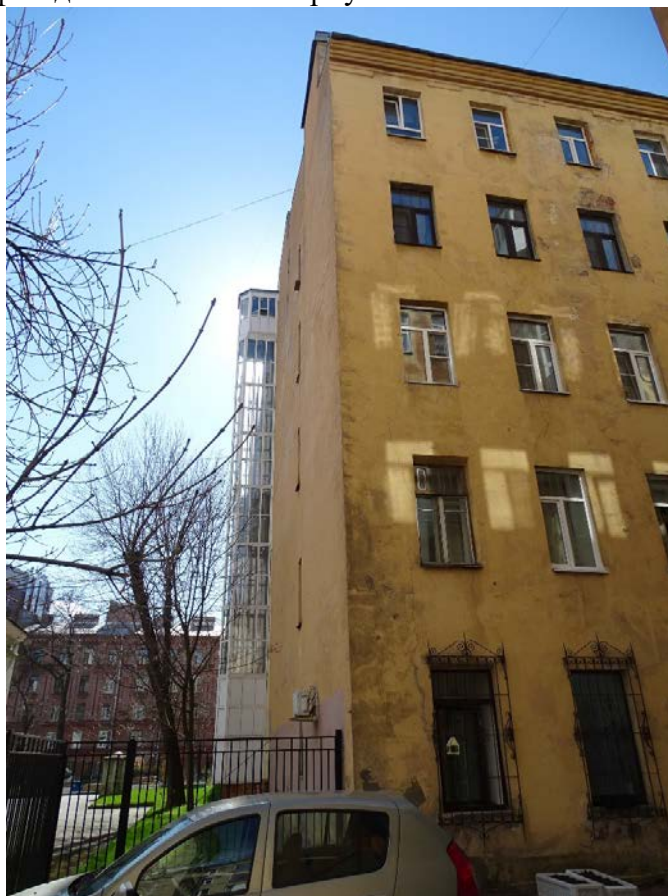
Фото 38. Здание по адресу: г. Санкт-Петербург, Большая Зеленина ул., дом 29, литера А. Юго-западный фасад 5-ти этажного корпуса. Съемка 19.04.2021 г. Штиглиц М. С.
