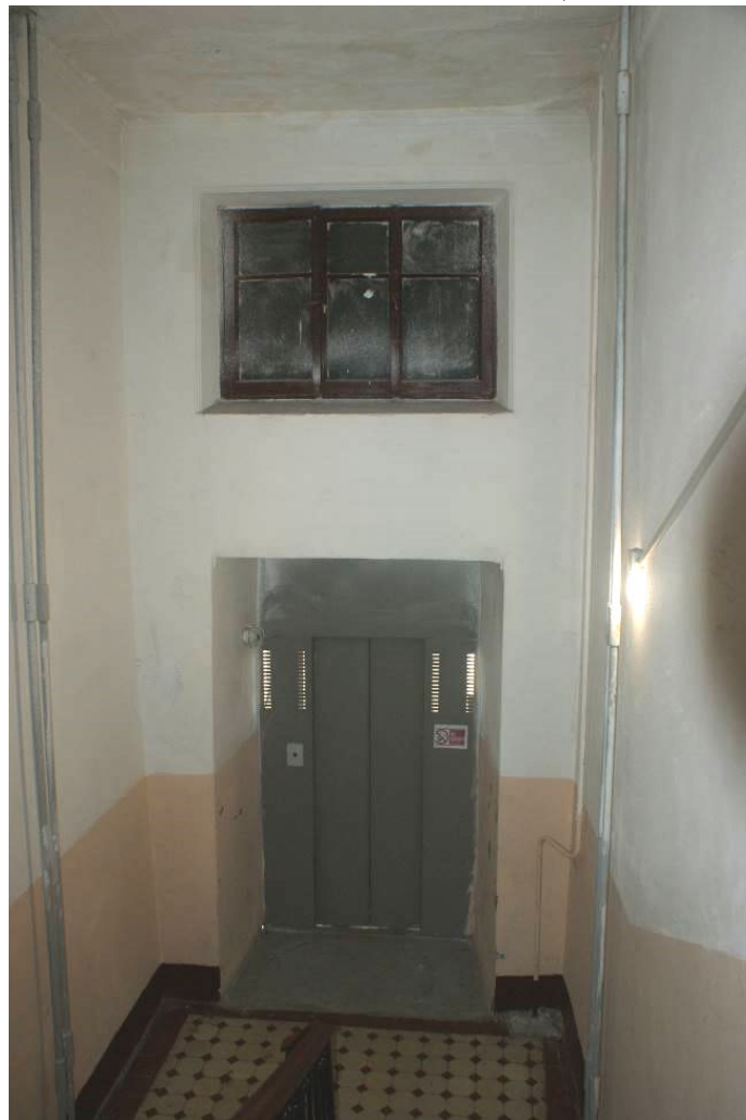
Фото 70. Лестница № 2. Вид на площадку м/у 5-м и 6-м этажом. Съемка 19.04.2021 г. Штиглиц М. С.
