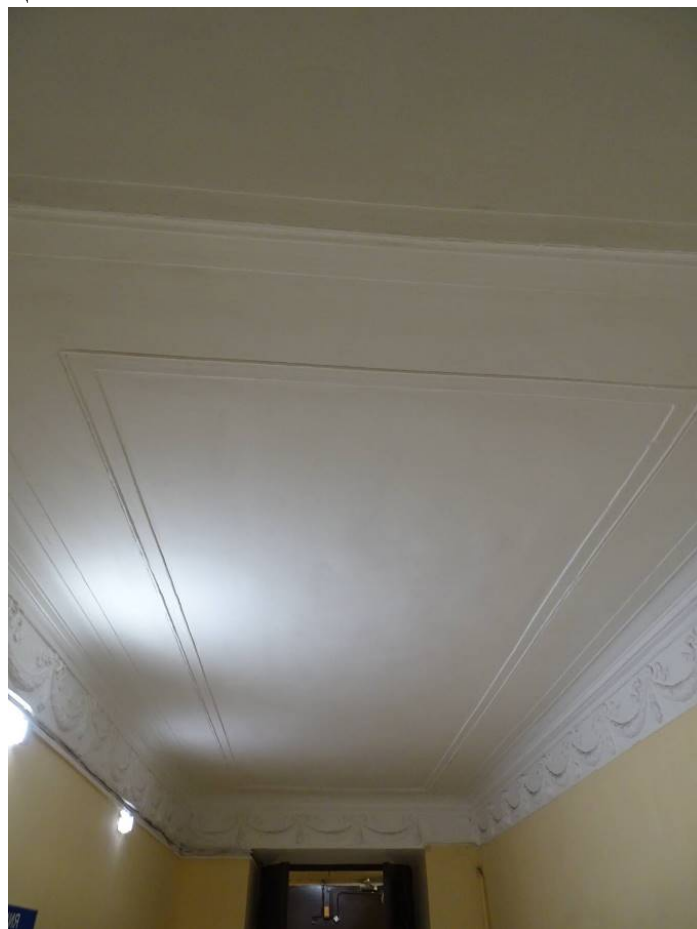
Фото 2. Лестница № 1. Вестибюль.1-й этаж. Своды. Съёмка 19.04.2021 г. Штиглиц М. С.
