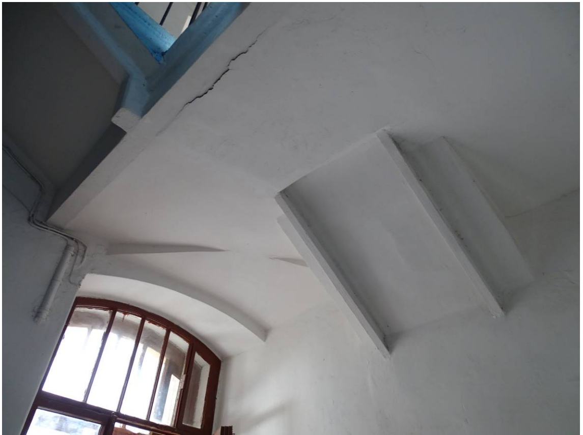
Фото 111. Лестница № 4. Площадка м/у 1-м и 2-м этажом. Своды. Съемка 19.04.2021 г. Штиглиц М. С.
