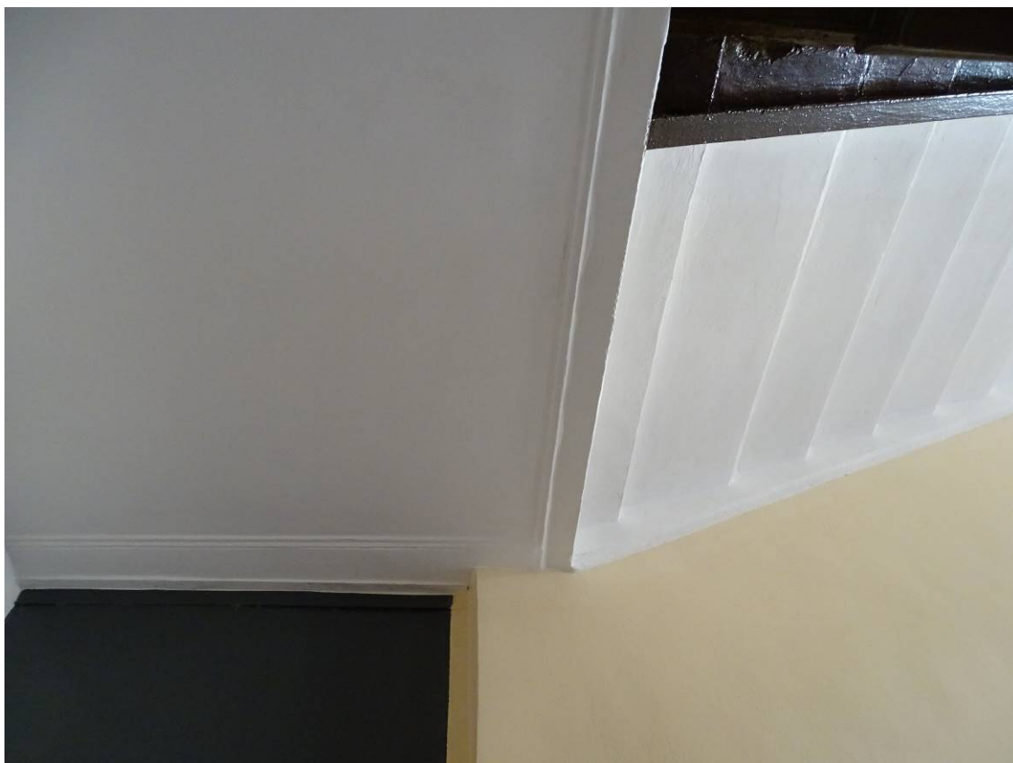
Фото 27. Лестница № 1. 3-й этаж. Оформление потолка. Съемка 19.04.2021 г. Штиглиц М. С.
