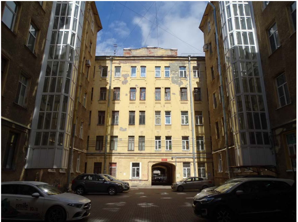
Фото 29. Здание по адресу: г. Санкт-Петербург, Большая Зеленина ул., дом 29, литера А. Дворовой фасад лицевого корпуса. Съемка 19.04.2021 г. Штиглиц М. С.
