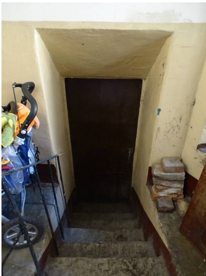
Фото 167. Лестница № 5. Площадка м/у 4-м и 5-м этажом. Съемка 19.04.2021 г. Штиглиц М. С.
