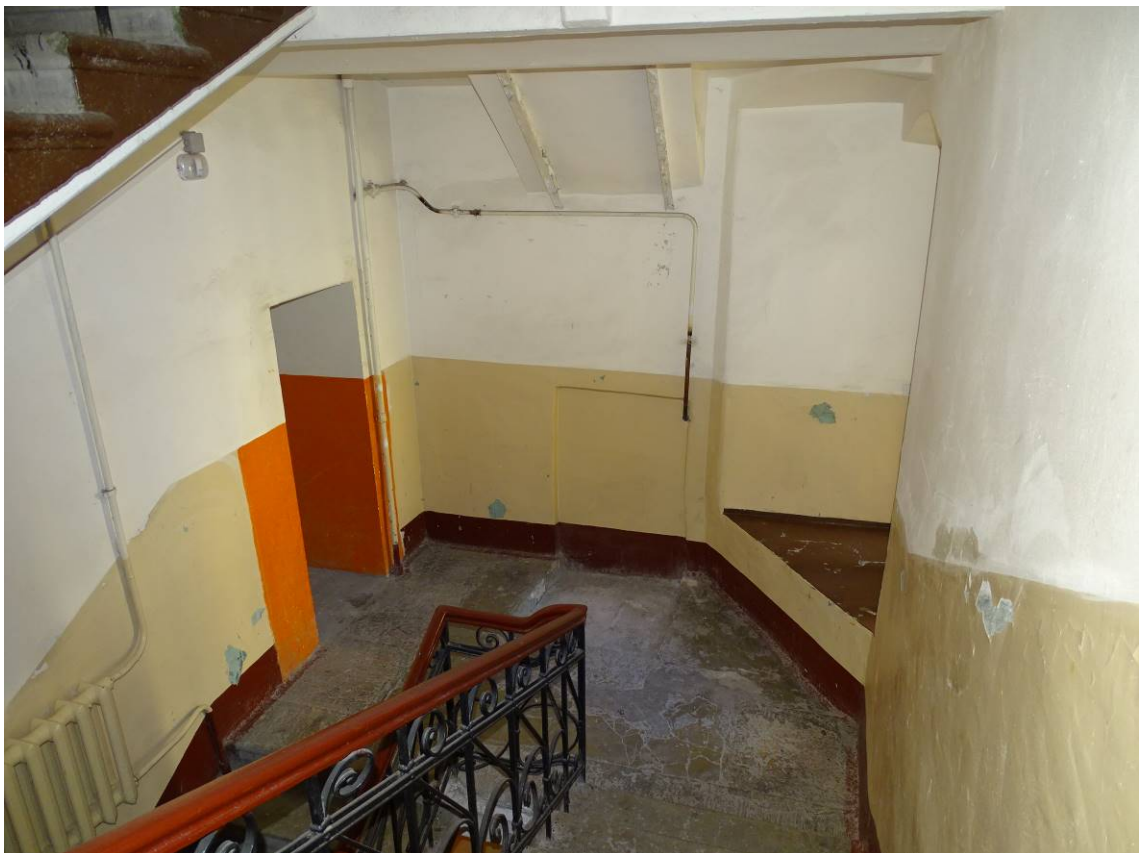
Фото 160. Лестница № 5. Вид на площадку м/у 3-м и 4-м этажом. Съемка 19.04.2021 г. Штиглиц М. С.
