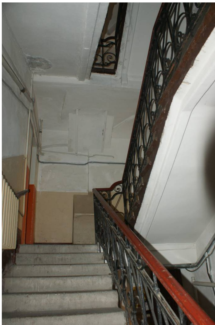
Фото 143. Лестница № 5. Вид на площадку м/у 1-м и 2-м этажом. Съемка 19.04.2021 г. Штиглиц М. С.
