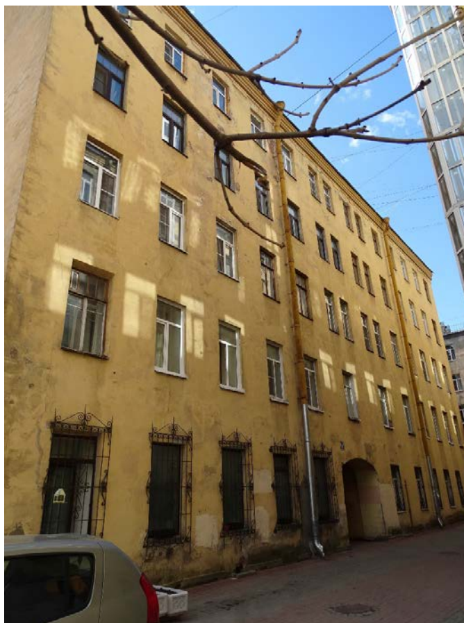
Фото 37. Здание по адресу: г. Санкт-Петербург, Большая Зеленина ул., дом 29, литера А. Юго-западный фасад 5-ти этажного корпуса. Съемка 19.04.2021 г. Штиглиц М. С.
