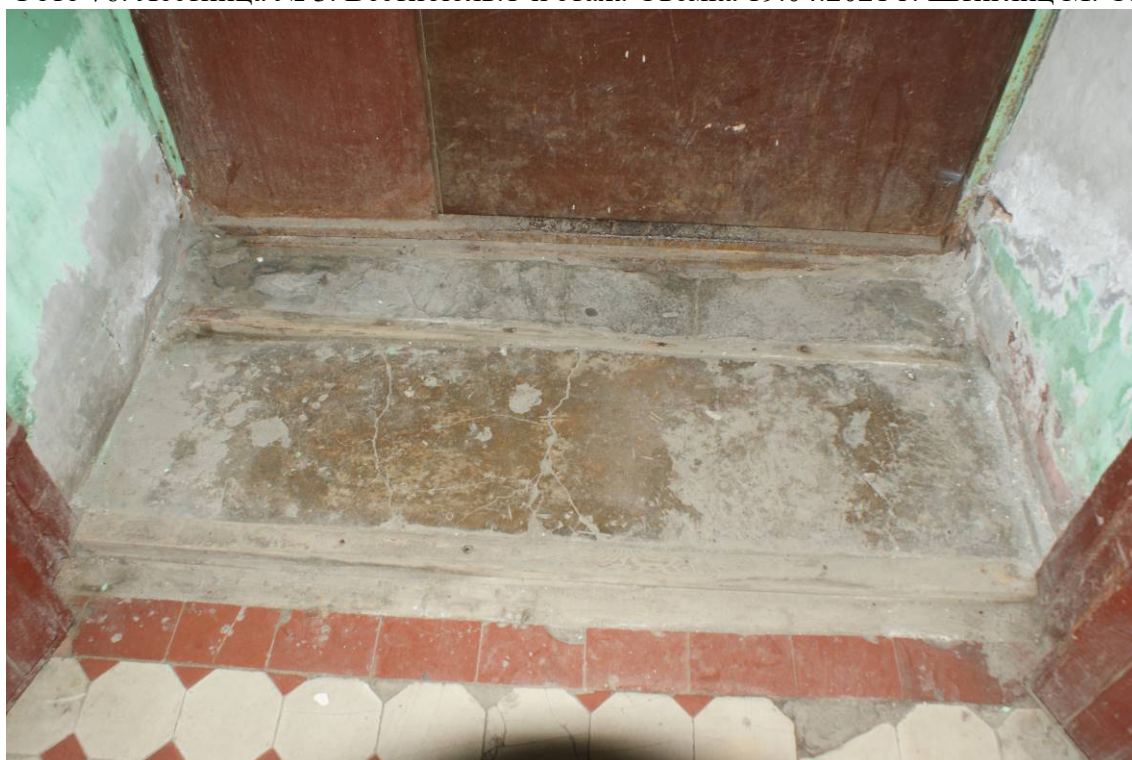
Фото 77. Лестница № 3. Вестибюль.1-й этаж. Съемка 19.04.2021 г. Штиглиц М. С.
