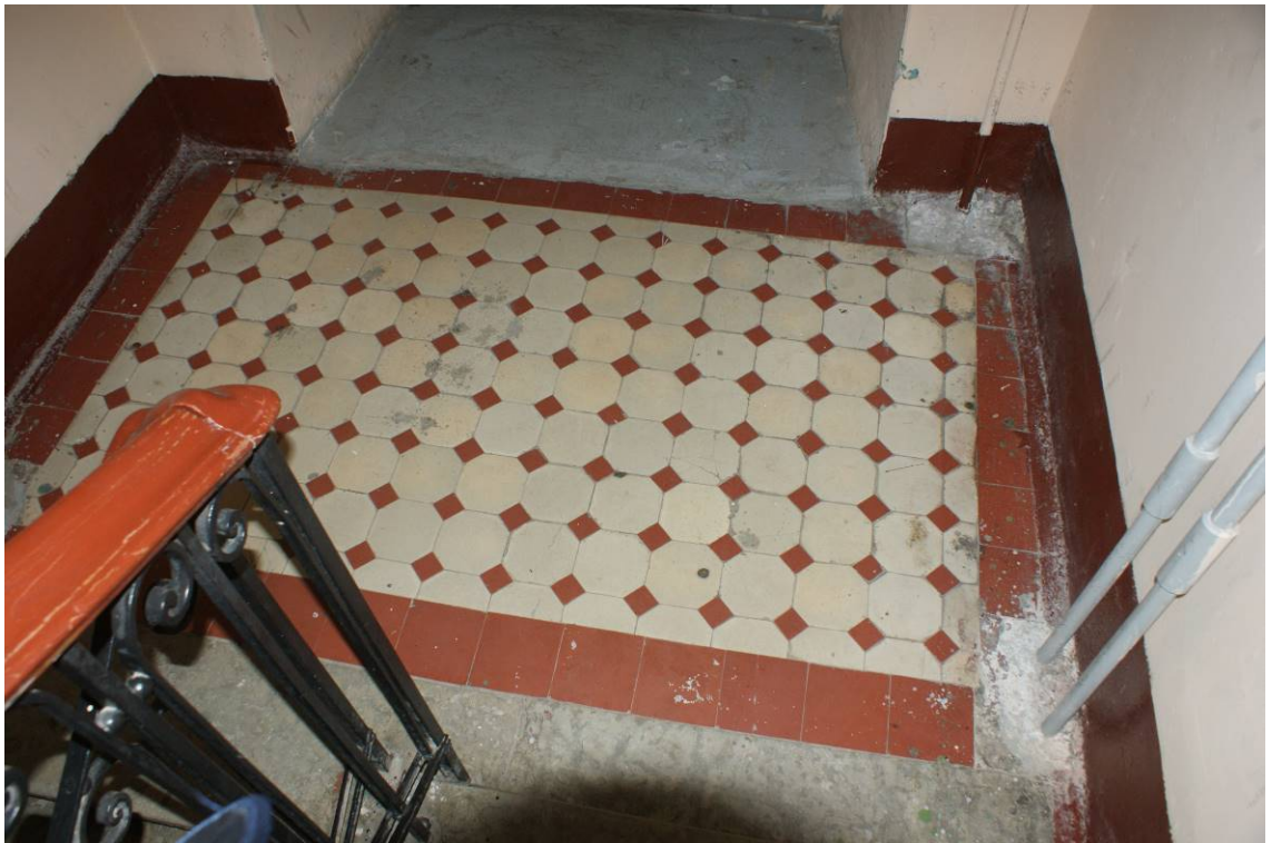
Фото 71. Лестница № 2. Площадка между 5-м и 6-м этажом. Покрытие пола. Съемка 19.04.2021 г. Штиглиц М. С.
