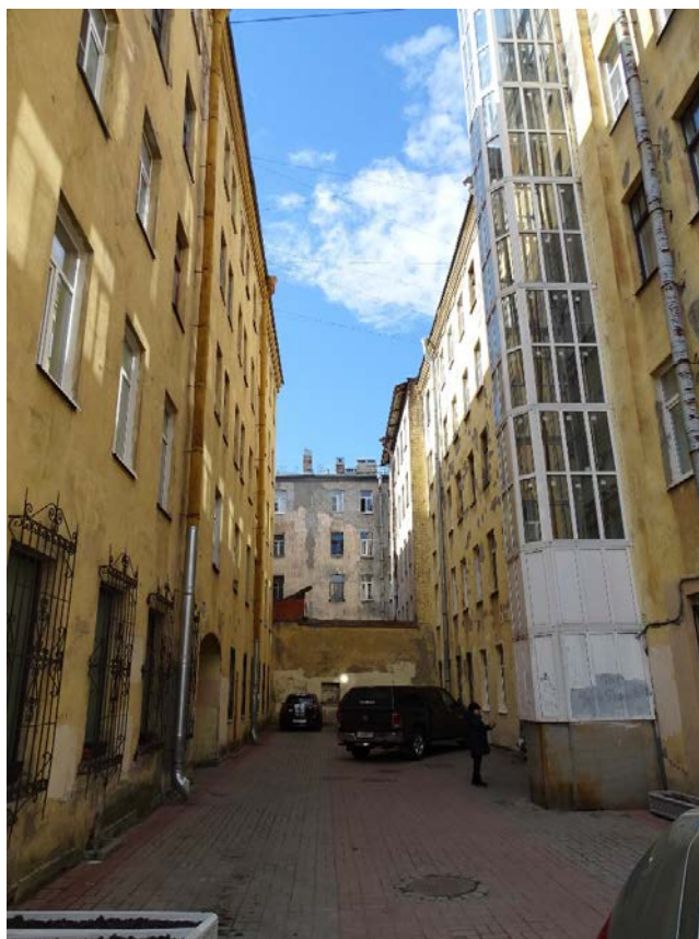
Фото 35. Здание по адресу: г. Санкт-Петербург, Большая Зеленина ул., дом 29, литера А. Северо-восточный и юго-западный фасад 5-ти этажного корпуса. Съемка 19.04.2021 г. Штиглиц М. С.
