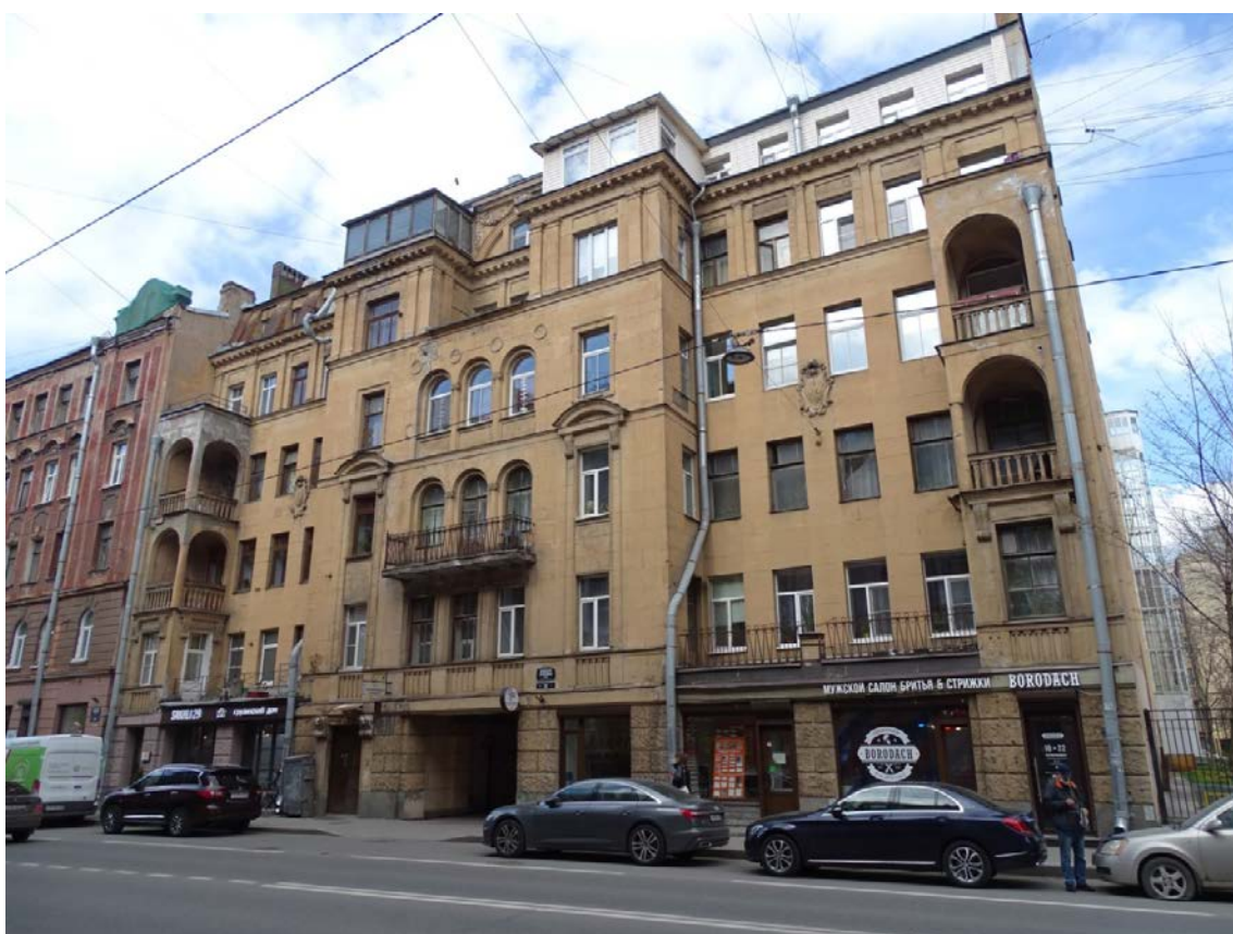
Фото 2. Здание по адресу: г. Санкт-Петербург, Большая Зеленина ул., дом 29, литера А. Лицевой фасад по ул. Большая Зеленина. Съемка 19.04.2021 г. Штиглиц М. С.
