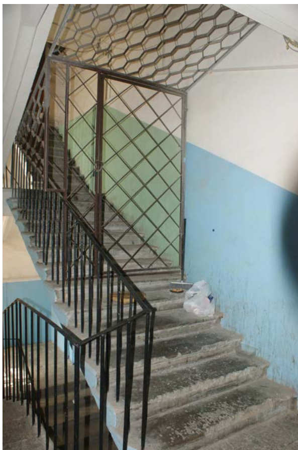
Фото 133. Лестница № 4. Закрытая металлическая решетка на 6-й этаж. Съемка 19.04.2021 г. Штиглиц М. С.
