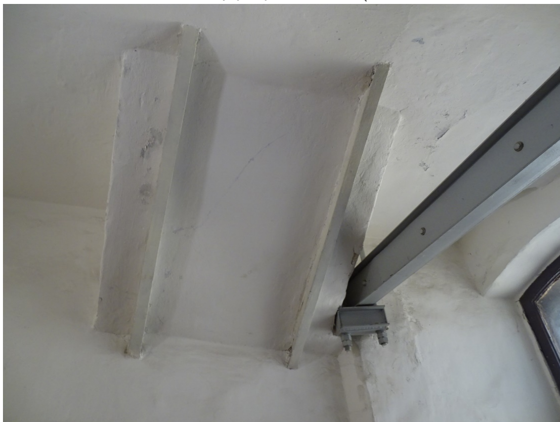
Фото 168. Лестница № 5. Площадка м/у 4-м и 5-м этажом. Своды. Съемка 19.04.2021 г. Штиглиц М. С.
