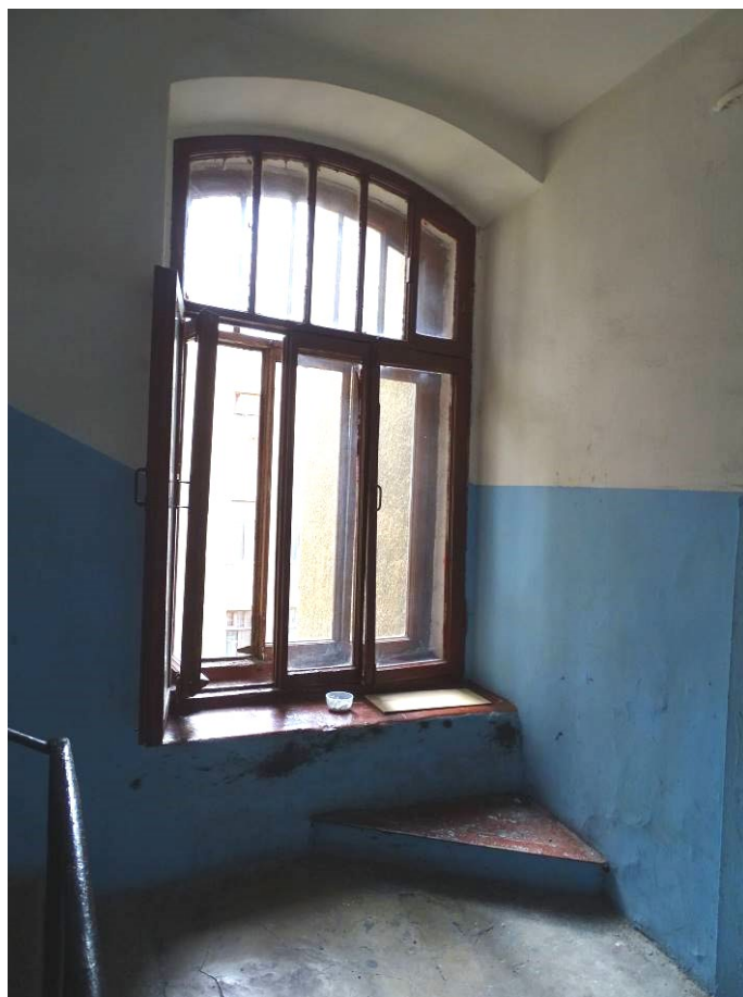
Фото 123. Лестница № 4. Площадка между 3-м и 4-м этажом. Оконный проем. Съемка 19.04.2021 г. Штиглиц М. С.
