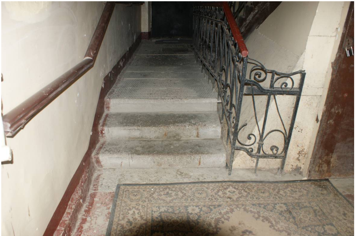
Фото 139. Лестница № 5. Вестибюль. 1-й этаж. Съёмка 19.04.2021 г. Штиглиц М. С.
