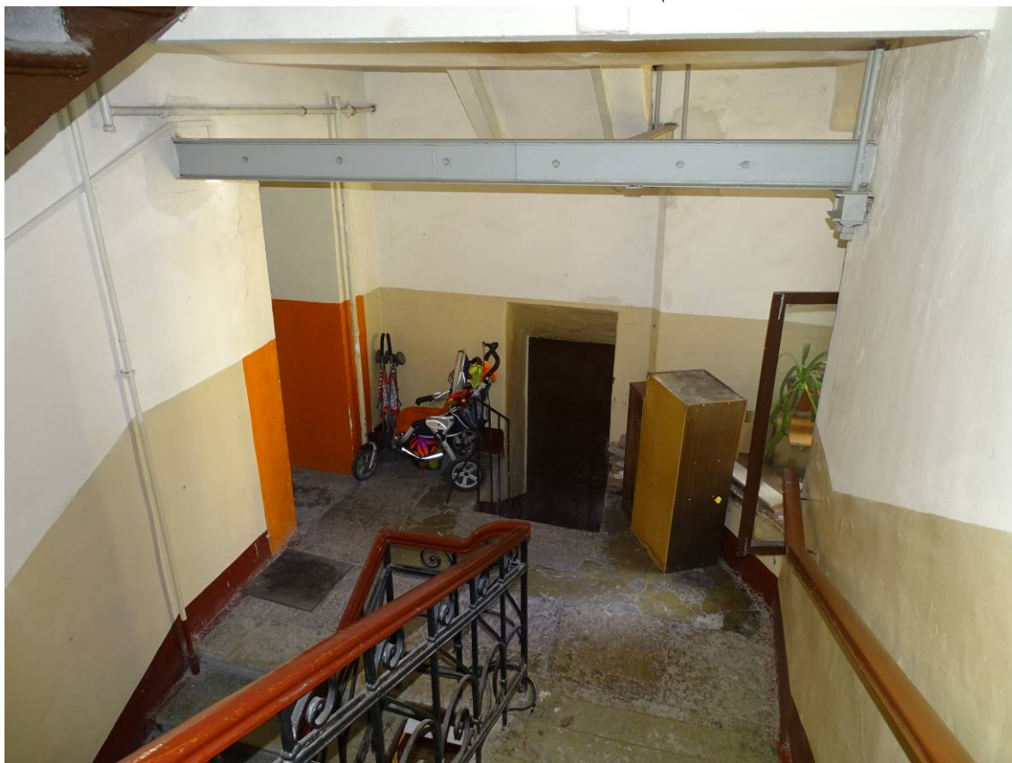
Фото 166. Лестница № 5. Вид на площадку м/у 4-м и 5-м этажом. Съемка 19.04.2021 г. Штиглиц М. С.
