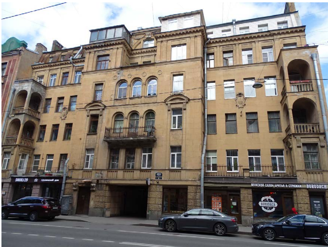
Фото 3. Здание по адресу: г. Санкт-Петербург, Большая Зеленина ул., дом 29, литера А. Лицевой фасад по ул. Большая Зеленина. Съемка 19.04.2021 г. Штиглиц М. С.
