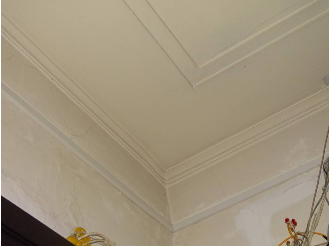
Фото 102. Лестница № 3. Площадка 6-го этажа. Оформление потолка. Съемка 19.04.2021 г. Штиглиц М. С.
