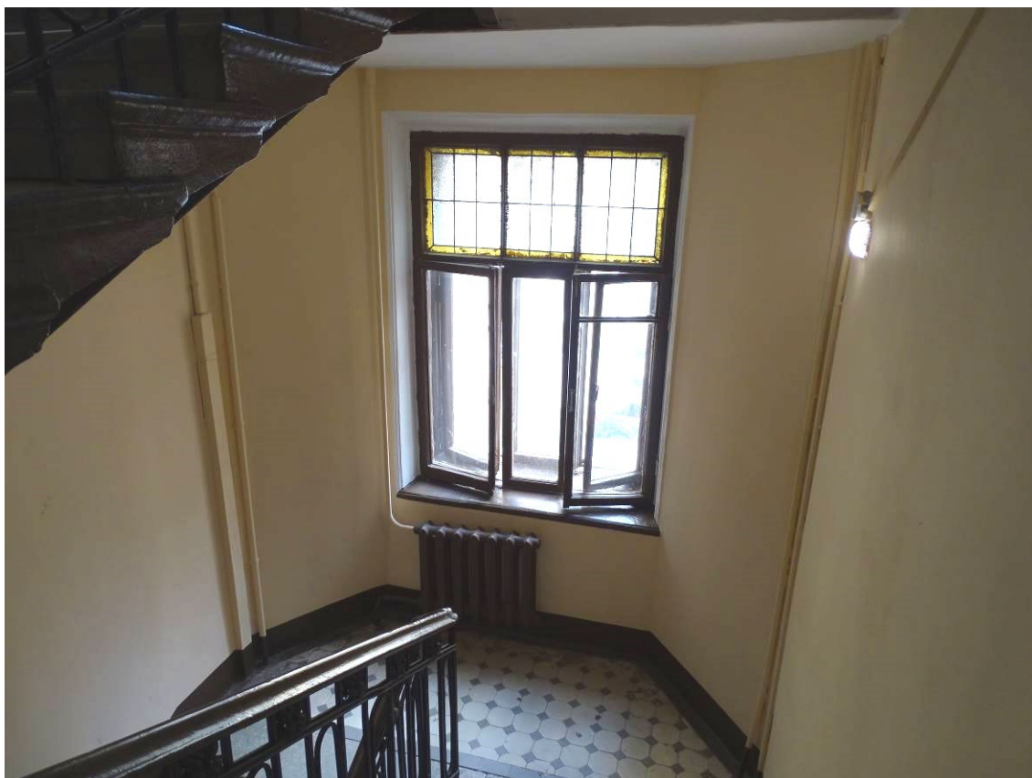
Фото 23. Лестница № 1. Вид на площадку м/у 2-м и 3-м этажом. Съемка 19.04.2021 г. Штиглиц М. С.
