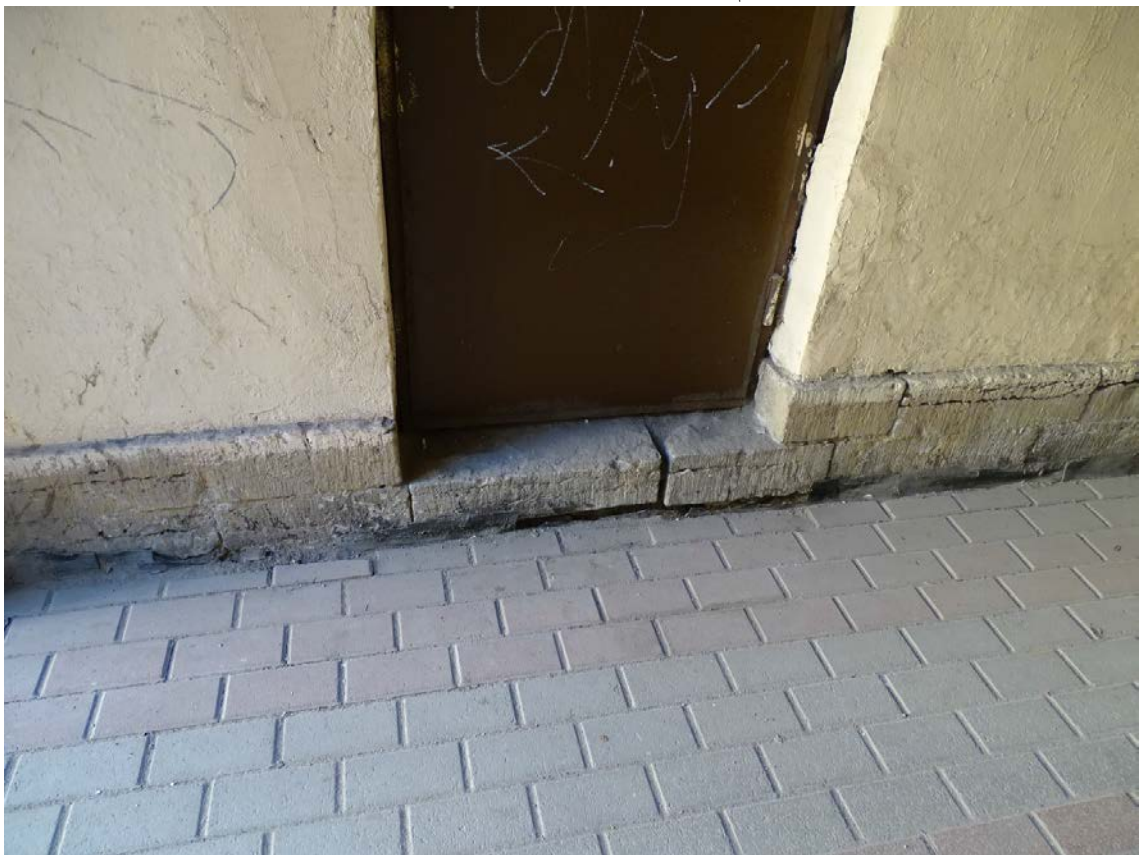
Фото 28. Здание по адресу: г. Санкт-Петербург, Большая Зеленина ул., дом 29, литера А. Воротный проезд Лицевого фасада по ул. Большая Зеленина. Цоколь Съемка 19.04.2021 г. Штиглиц М. С.
