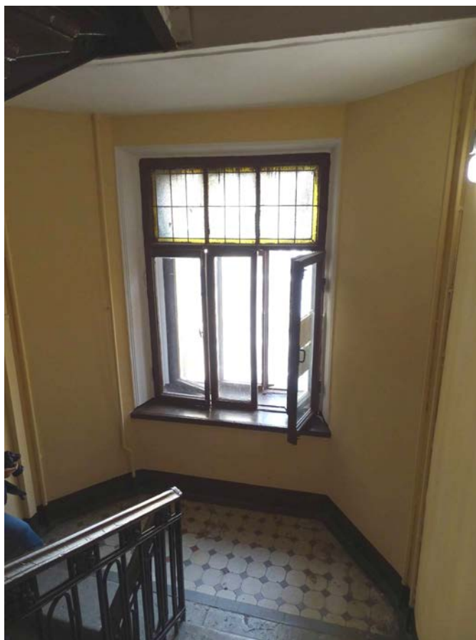
Фото 31. Лестница № 1. Вид на площадку м/у 4-м и 5-м этажом. Съемка 19.04.2021 г. Штиглиц М. С.
