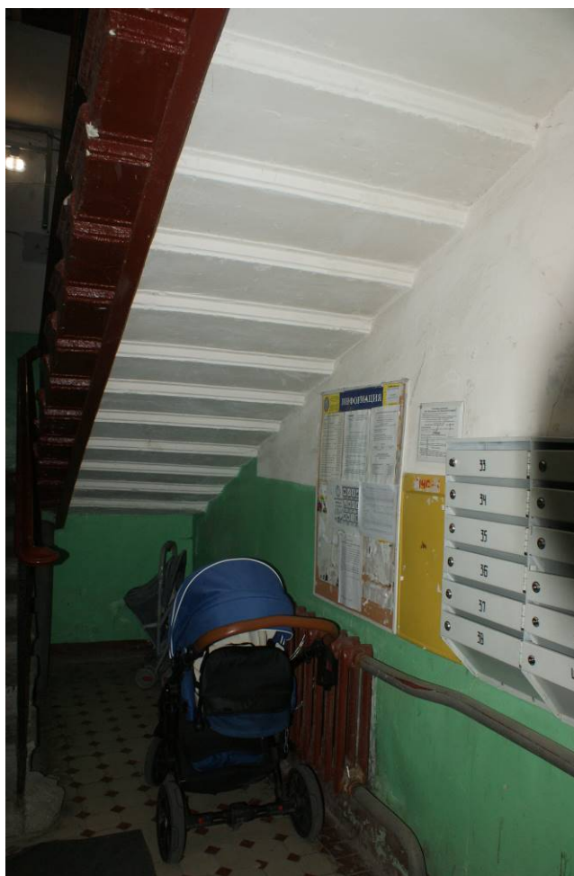
Фото 81. Лестница № 3. Вестибюль 1-го этажа. Пространство под лестницей. Съемка 19.04.2021 г. Штиглиц М. С.
