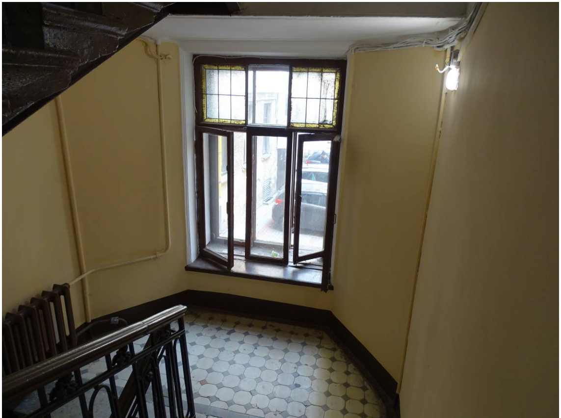
Фото 15. Лестница № 1. Вид на площадку м/у 1-м и 2-м этажом. Съемка 19.04.2021 г. Штиглиц М. С.
