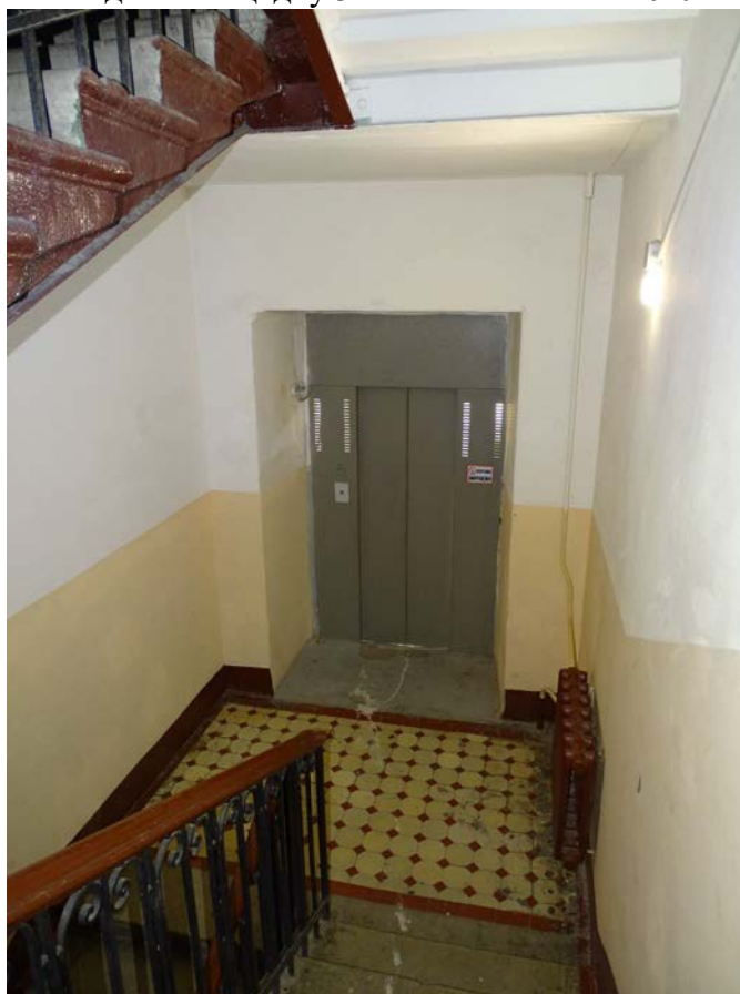
Фото 62. Лестница № 2. Вид на площадку м/у 3-м и 4-м этажом. Съемка 19.04.2021 г. Штиглиц М. С.
