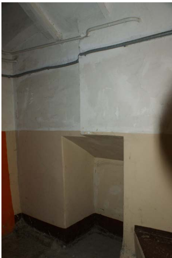
Фото 147. Лестница № 5. Площадка м/у 1-м и 2-м этажом. Съемка 19.04.2021 г. Штиглиц М. С.
