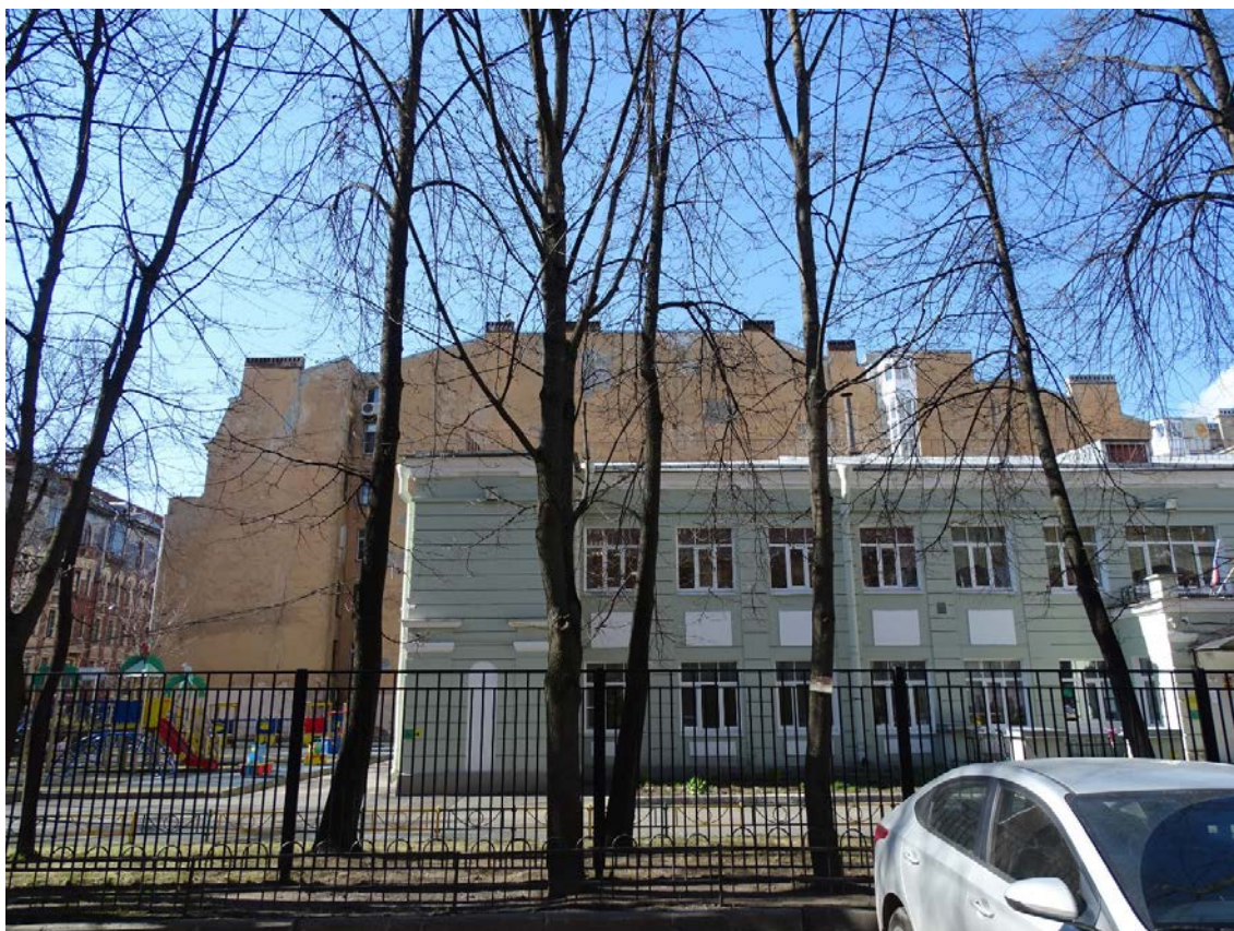
Фото 10. Здание по адресу: г. Санкт-Петербург, Большая Зеленина ул., дом 29, литера А. Брандмауэр. Съемка 19.04.2021 г. Штиглиц М. С.
