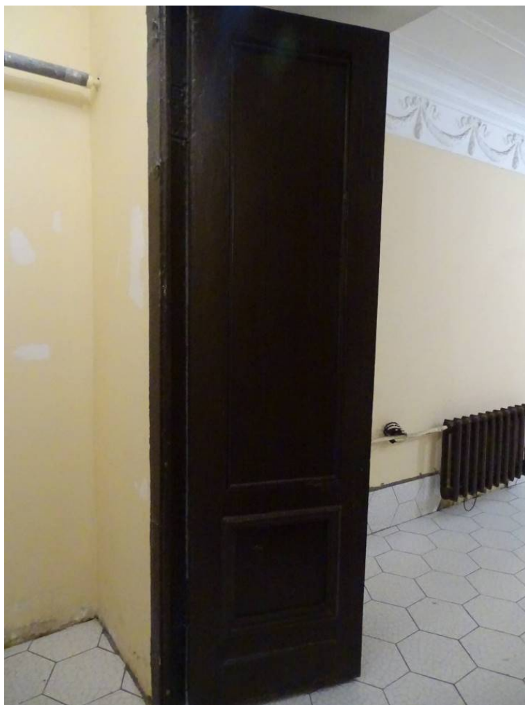
Фото 5. Лестница № 1. 1-й этаж. Тамбур. Дверь. Съёмка 19.04.2021 г. Штиглиц М. С.
