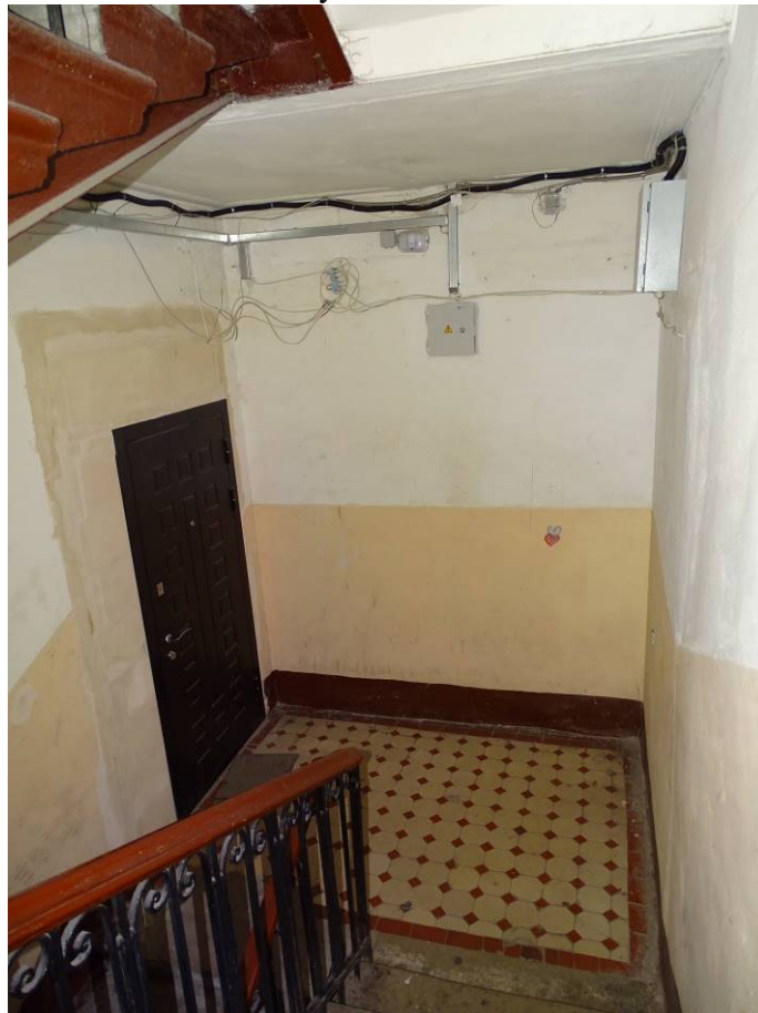
Фото 52. Лестница № 2. Вид на площадку 1-го этажа. Съемка 19.04.2021 г. Штиглиц М. С.
