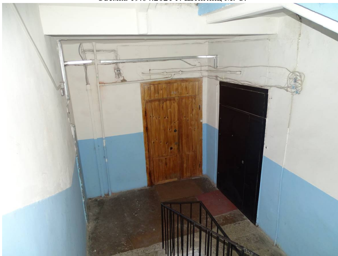
Фото 120. Лестница № 4. Вид на площадку 3-го этажа. Съемка 19.04.2021 г. Штиглиц М. С.
