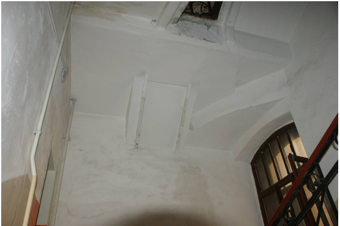
Фото 153. Лестница № 5. Площадка между 2-м и 3-м этажом. Своды. Съемка 19.04.2021 г. Штиглиц М. С.
