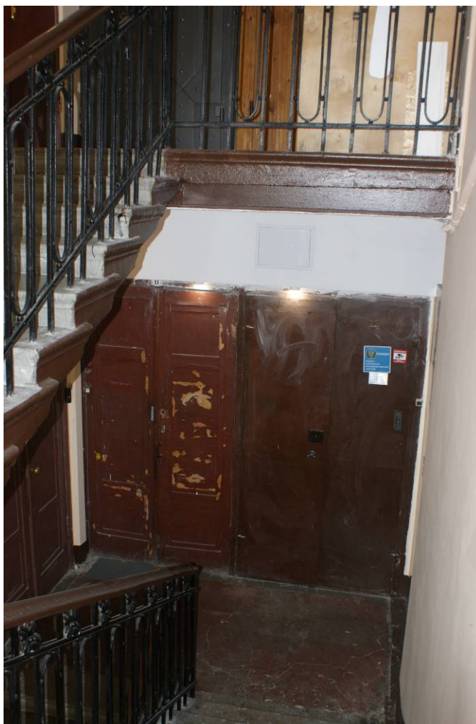
Фото 35. Лестница № 1. Вид на площадку 5-го этажа. Съемка 19.04.2021 г. Штиглиц М. С.
