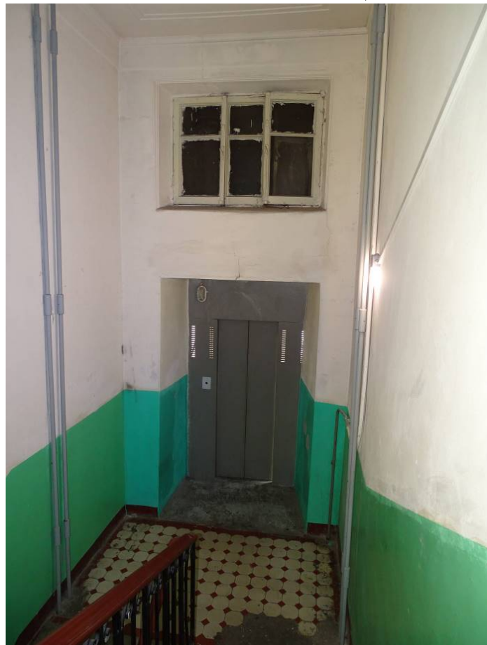
Фото 97. Лестница № 3. Вид на площадку м/у 5-м и 6-м этажом. Съемка 19.04.2021 г. Штиглиц М. С.
