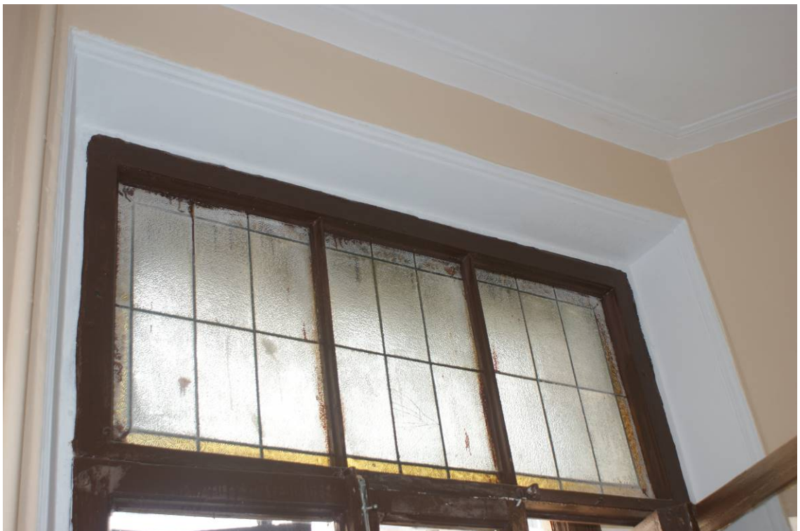
Фото 34. Лестница № 1. Площадка между 4-м и 5-м этажом. Оконное заполнение. Съемка 19.04.2021 г. Штиглиц М. С.
