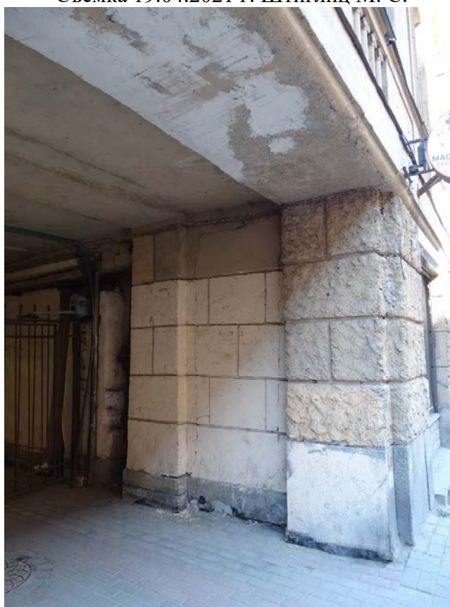
Фото 26. Здание по адресу: г. Санкт-Петербург, Большая Зеленина ул., дом 29, литера А. Воротный проезд Лицевого фасада по ул. Большая Зеленина. Съемка 19.04.2021 г. Штиглиц М. С.
