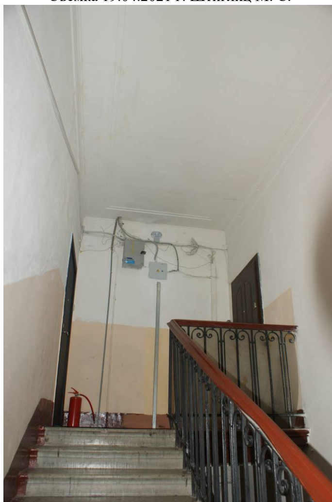
Фото 74. Лестница № 2. Вид на площадку 6-го этажа. Съемка 19.04.2021 г. Штиглиц М. С.
