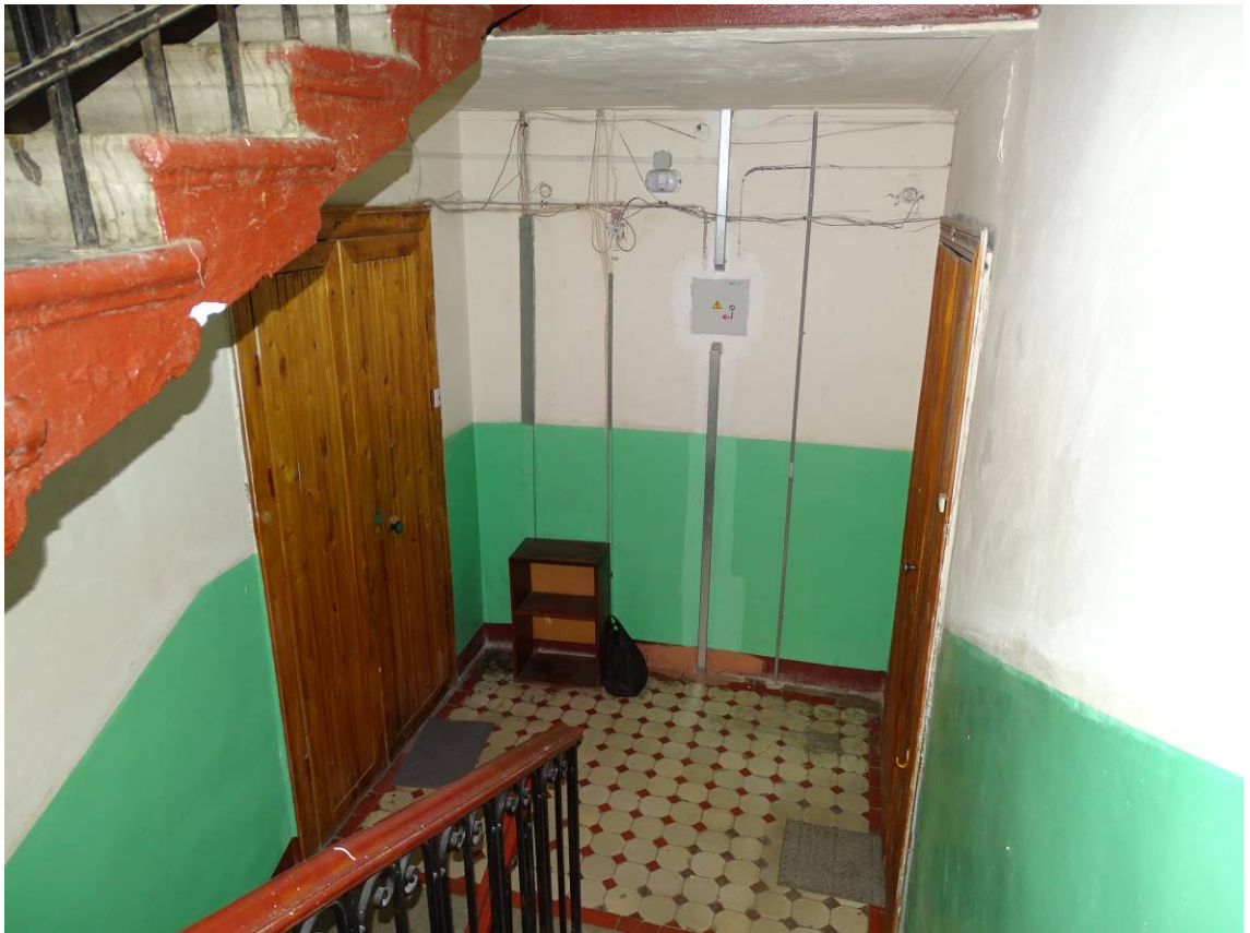
Фото 94. Лестница № 3. Вид на площадку 5-го этажа. Съемка 19.04.2021 г. Штиглиц М. С.
