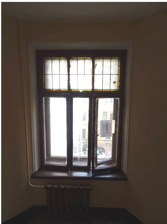
Фото 29. Лестница № 1. Площадка между 3-м и 4-м этажом. Оконный проем. Съемка 19.04.2021 г. Штиглиц М. С.
