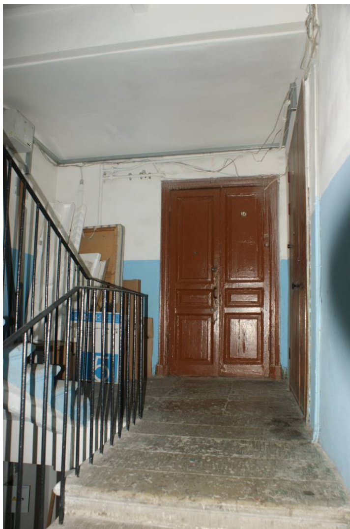
Фото 131. Лестница № 4. Площадка 5-го этажа. Съемка 19.04.2021 г. Штиглиц М. С.
