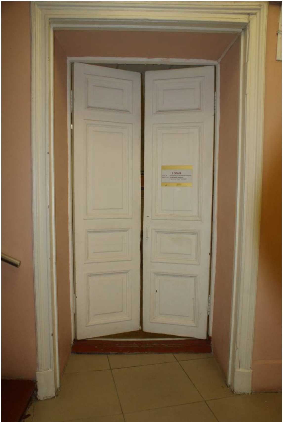
Фото 18. Лестница № 2: Площадка 1-го этажа. Оформление двери.
