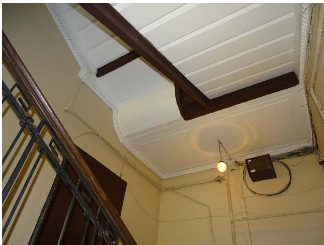
Фото 56. Лестница № 3: 2 этаж. Съемка 26.04.2021 г. Михайловская Г. В.
