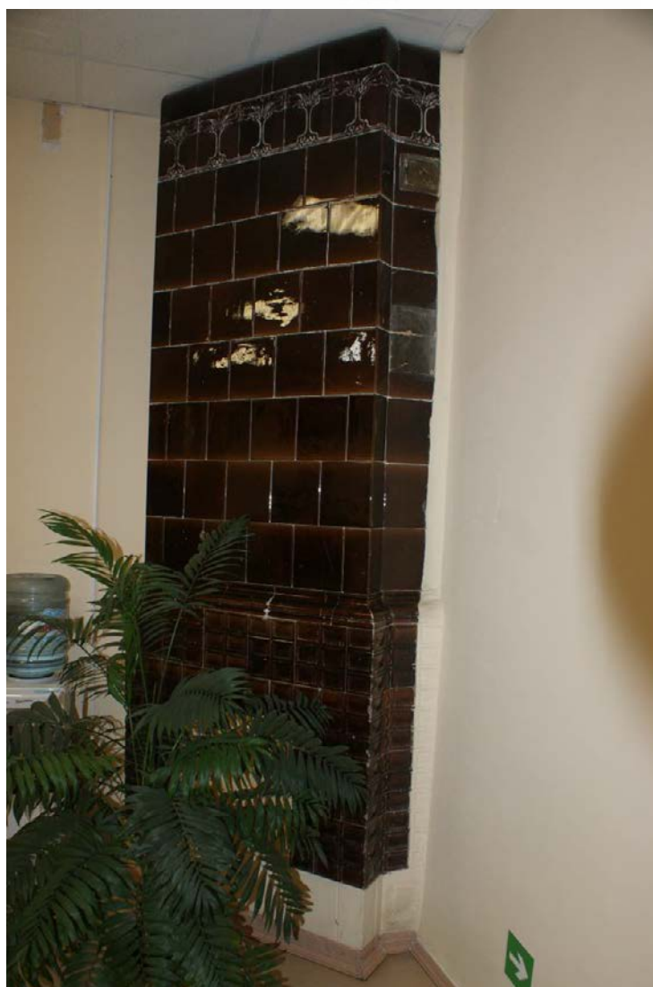
Фото 15. 4-й этаж. Помещение 3/50,5. Печь угловая. Съемка 26.04.2021 г. Михайловская Г. В.
