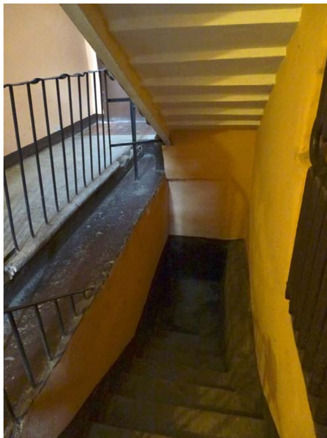
Фото 1. Лестница № 1: 1 этаж. Съёмка 26.04.2021 г. Михайловская Г. В.
