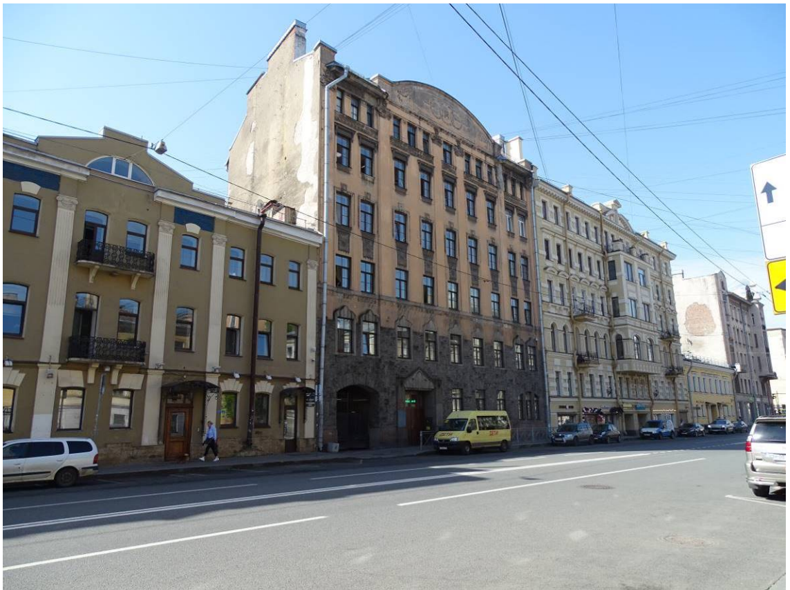
Фото 1. Вид на лицевой фасад через ул. Жуковского. Съемка 26.04.2021 г. Михайловская Г. В.
