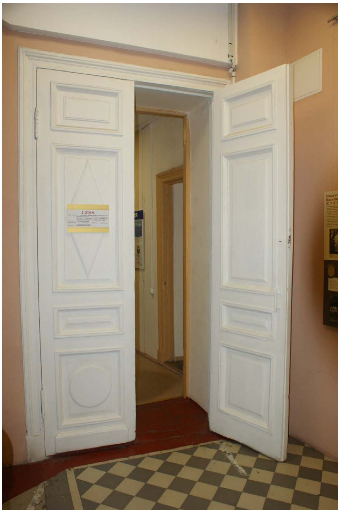
Фото 28. Лестница № 2: Площадка 3-го этажа. Оформление двери.
