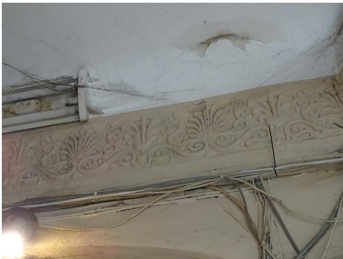
Фото 48. Лестница № 3: Вестибюль 1-го этажа. Съёмка 26.04.2021 г. Михайловская Г. В.
