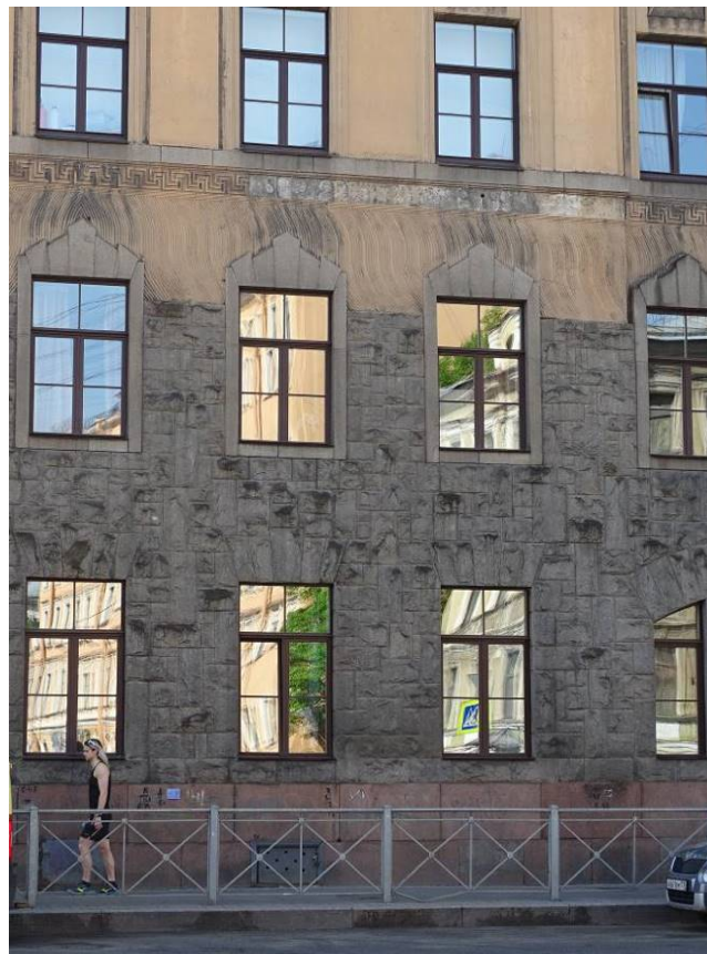
Фото 10. Лицевой фасад. Фрагмент. Съемка 26.04.2021 г. Михайловская Г. В.
