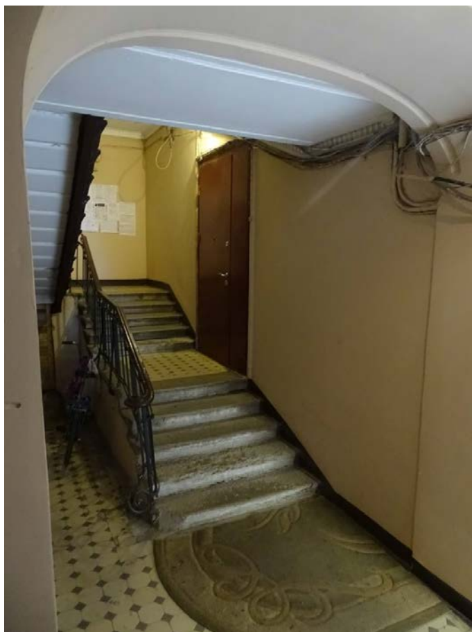
Фото 45. Лестница № 3: Вестибюль 1-го этажа. Съемка 26.04.2021 г. Михайловская Г. В.
