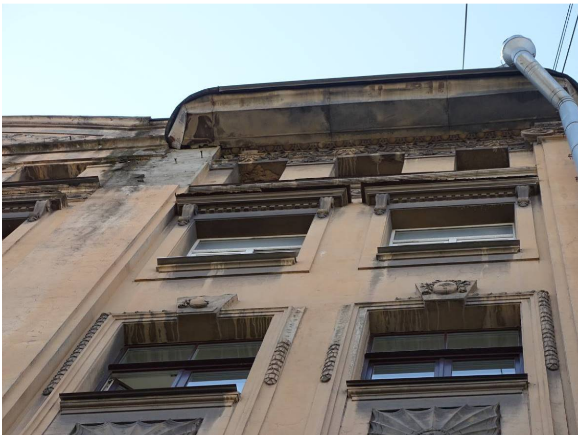
Фото 16. Лицевой фасад. Фрагмент. Съемка 26.04.2021 г. Михайловская Г. В.
