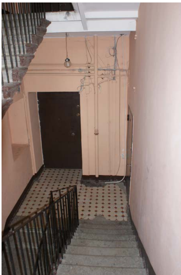
Фото 3. Лестница № 1: 1 этаж. Съёмка 26.04.2021 г. Михайловская Г. В.
