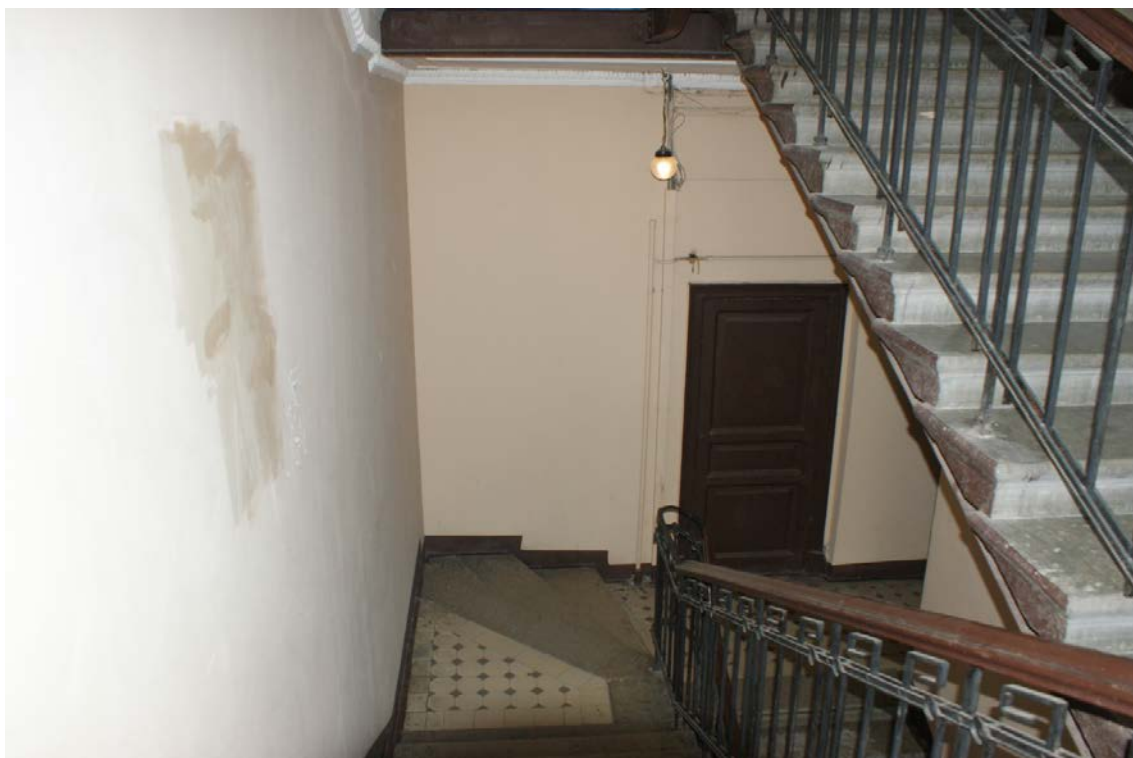
Фото 67. Лестница № 3: 4-й этаж. Съемка 26.04.2021 г. Михайловская Г. В.
