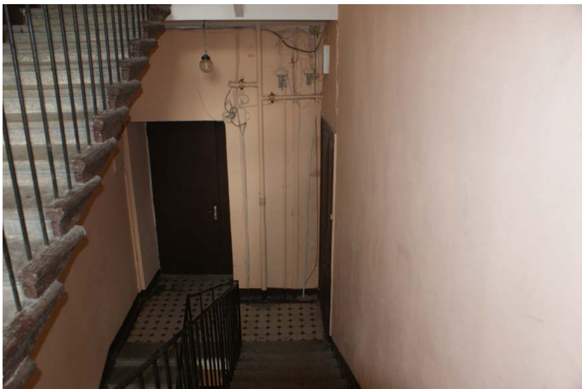
Фото 7. Лестница № 1: 2 этаж. Съемка 26.04.2021 г. Михайловская Г. В.
