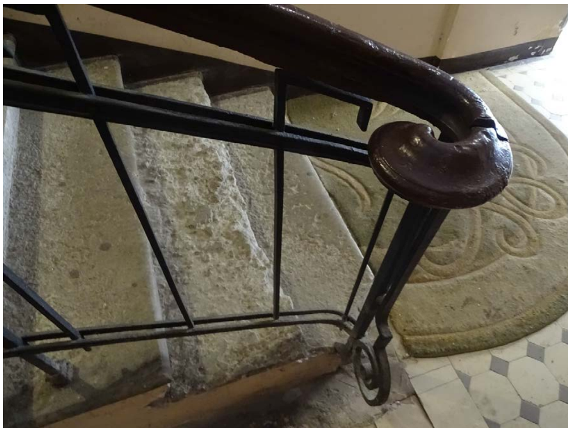
Фото 46. Лестница № 3: Вестибюль 1-го этажа. Съемка 26.04.2021 г. Михайловская Г. В.
