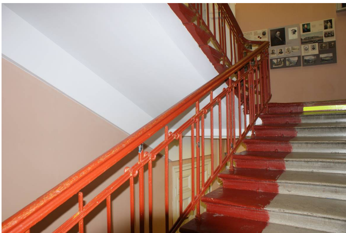
Фото 27. Лестница № 2: 3 этаж. Фрагмент лестничного ограждения. Съемка 26.04.2021 г. Михайловская Г. В.
