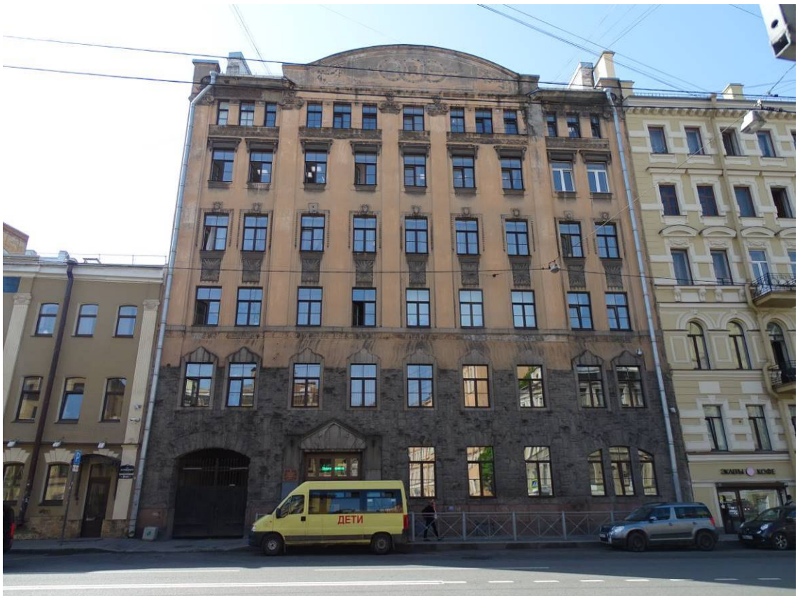
Фото 2. Вид на лицевой фасад через ул. Жуковского. Съемка 26.04.2021 г. Михайловская Г. В.
