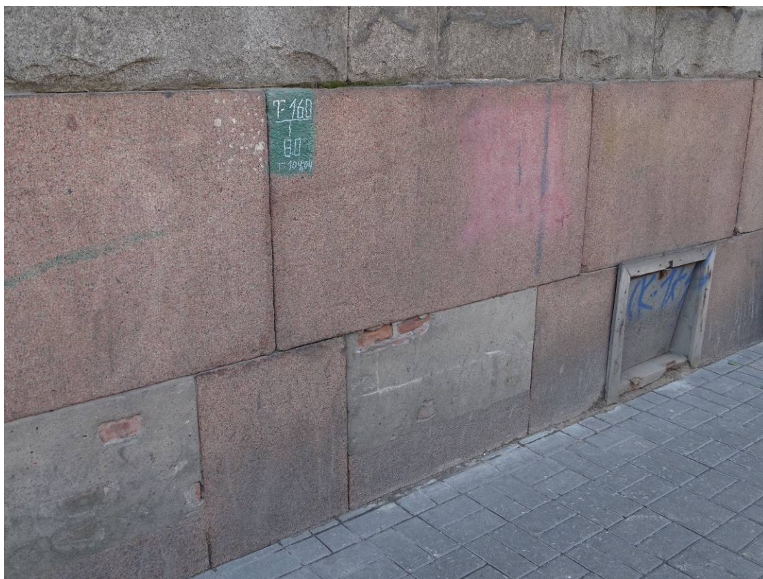
Фото 15. Гранитный цоколь. Лицевой фасад. Фрагмент. Съемка 26.04.2021 г. Михайловская Г. В.
