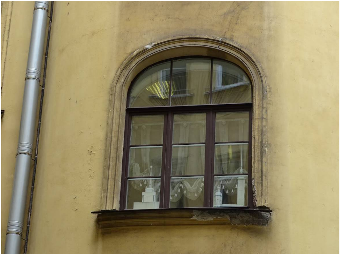
Фото 34. Замкнутый двор. Фрагмент фасада. Окно между 2-м и 3-м этажом. Съемка 26.04.2021 г. Михайловская Г. В.
