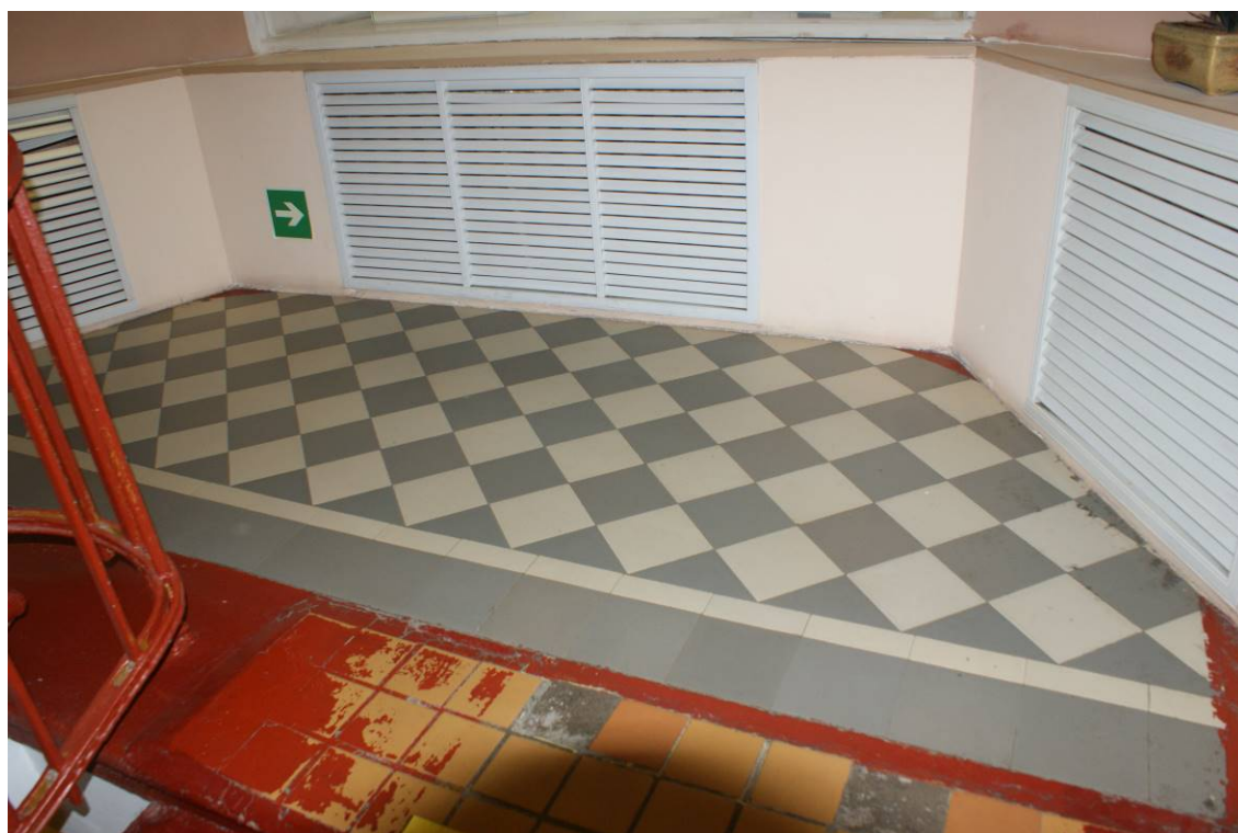
Фото 25. Лестница № 2: Площадка между 2-м и 3-м этажом. Покрытие пола. Съемка 26.04.2021 г. Михайловская Г. В.
