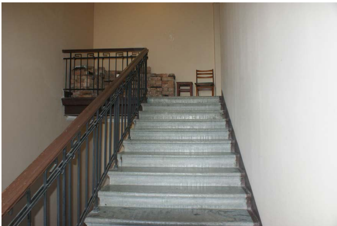
Фото 71. Лестница № 3: 6 этаж. Съемка 26.04.2021 г. Михайловская Г. В.
