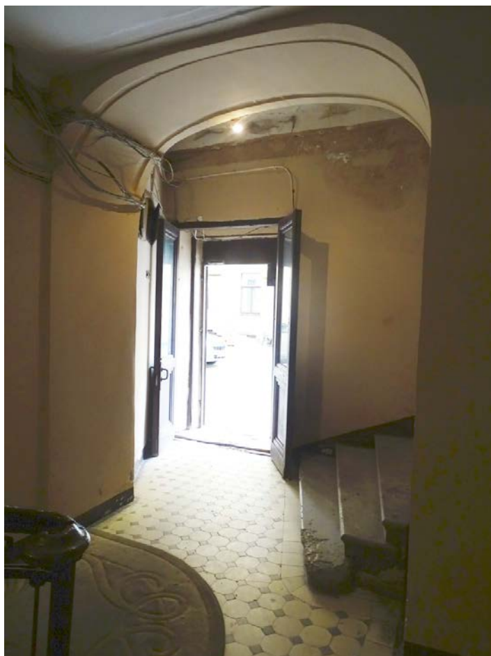
Фото 47. Лестница № 3: Вестибюль 1-го этажа. Съёмка 26.04.2021 г. Михайловская Г. В.
