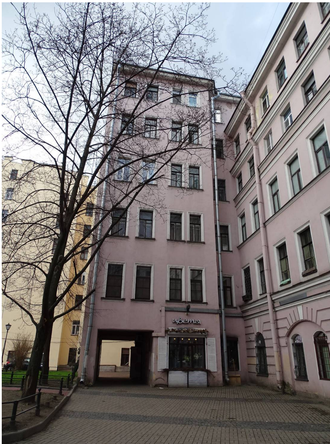
Фото 19. Дворовые фасады. Съемка 26.04.2021 г. Михайловская Г. В.
