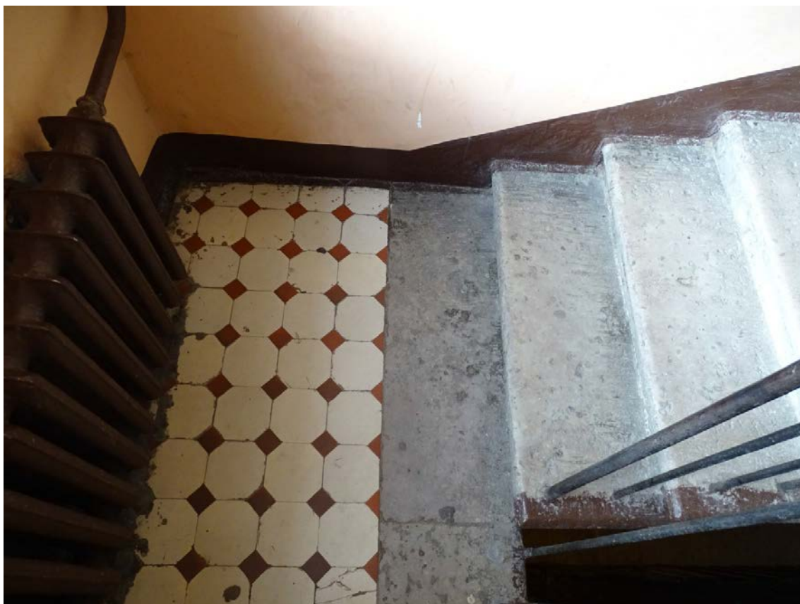
Фото 5. Лестница № 1: Площадка между 1 и 2 этажом. Съемка 26.04.2021 г. Михайловская Г. В.
