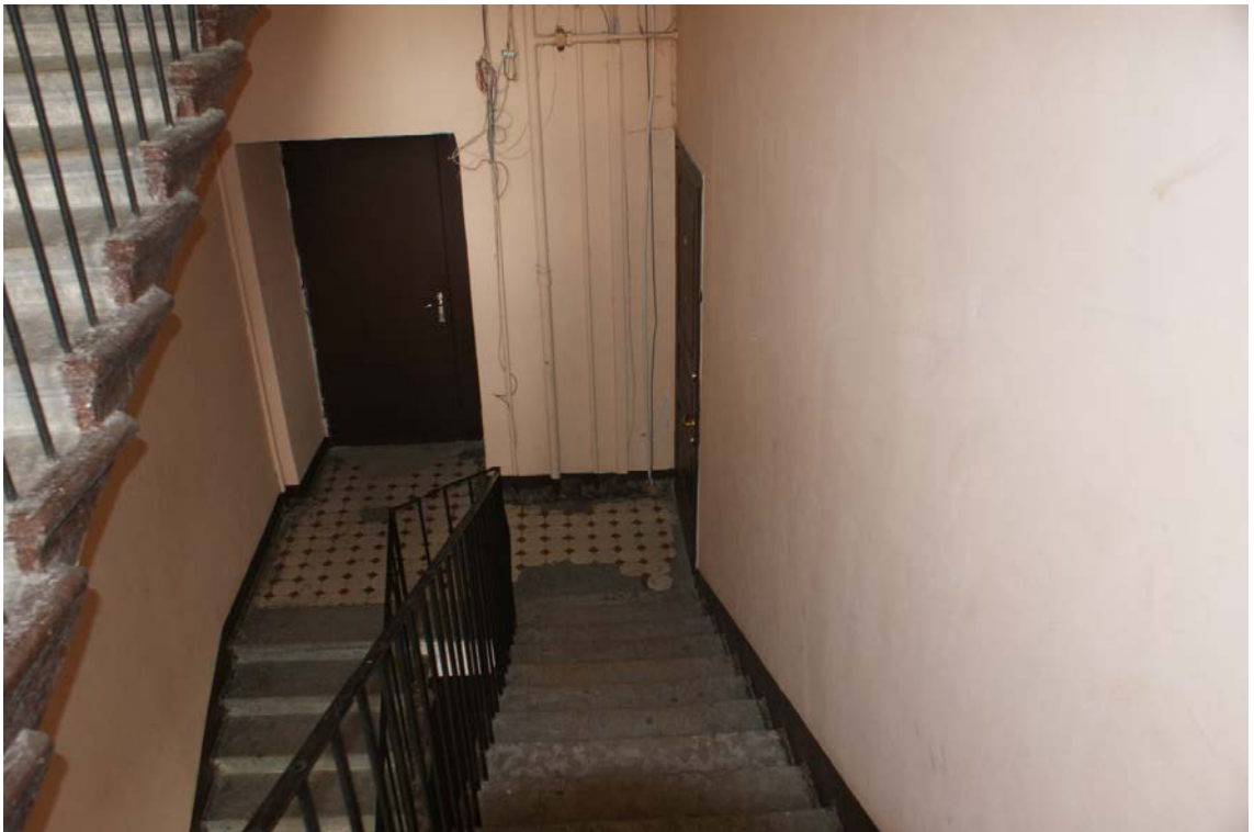
Фото 9. Лестница № 1: 3 этаж. Съемка 26.04.2021 г. Михайловская Г. В.
