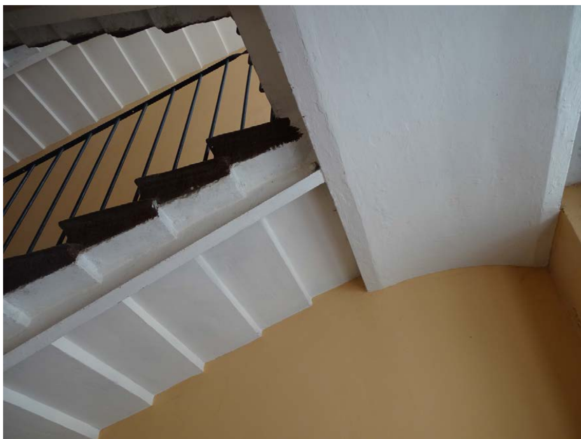
Фото 4. Лестница № 1: Площадка между 1 и 2 этажом. Съёмка 26.04.2021 г. Михайловская Г. В.
