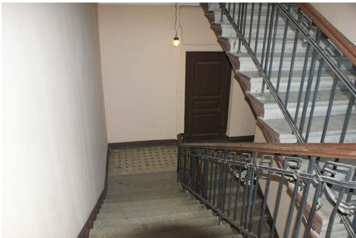
Фото 69. Лестница № 3: 5-й этаж. Съемка 26.04.2021 г. Михайловская Г. В.
