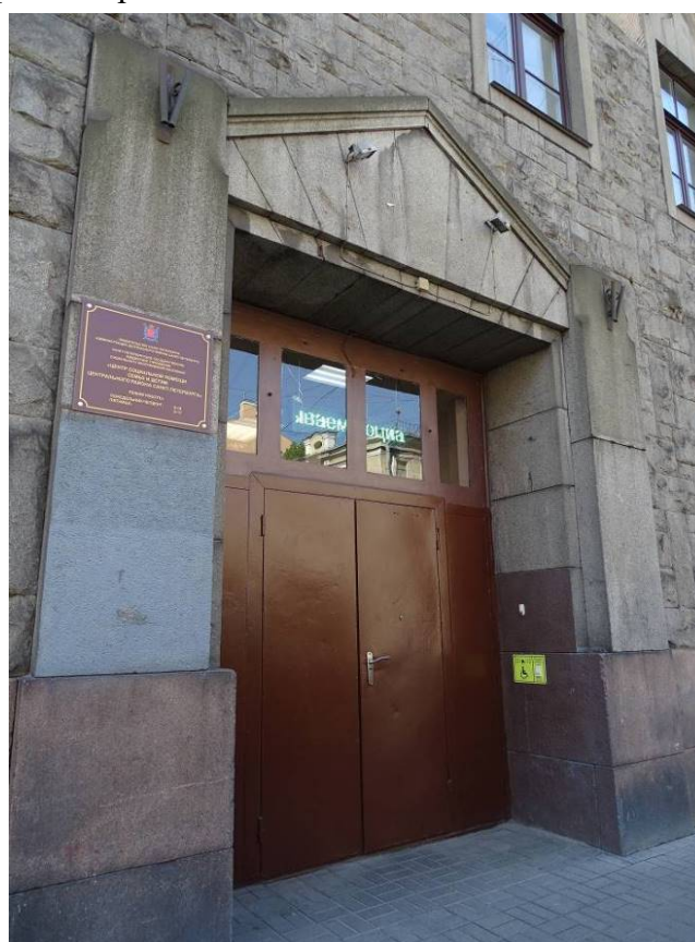
Фото 13. Дверной проем с треугольным профилированным фронтоном. Лицевой фасад. Съемка 26.04.2021 г. Михайловская Г. В.
