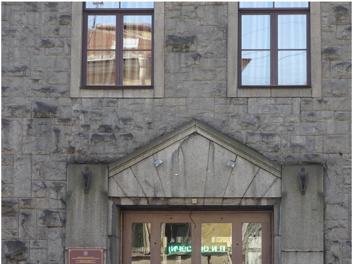
Фото 9. Треугольный профилированный фронтон дверного проема. Лицевой фасад. Съемка 26.04.2021 г. Михайловская Г. В.
