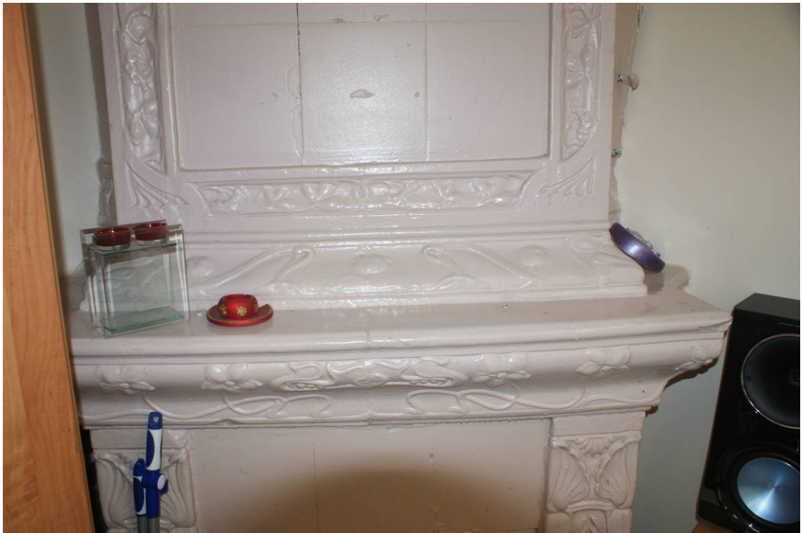
Фото 6. 3-й этаж. Помещение 11/28,1. Печь угловая. Профилированная полочка. Съемка 26.04.2021 г. Михайловская Г. В.
