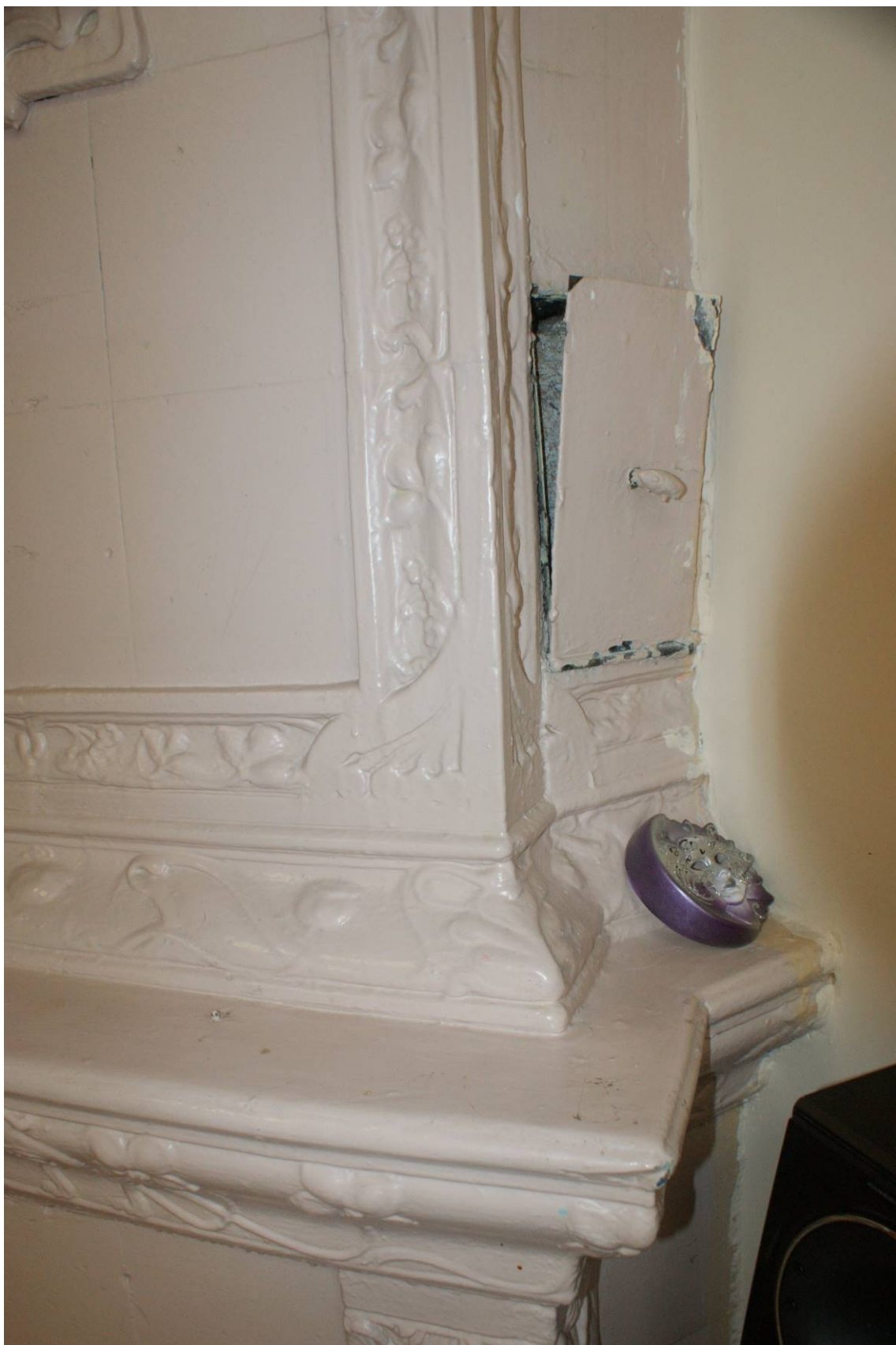
Фото 8. 3-й этаж. Помещение 11/28,1. Печь угловая. Прямоугольная дверца «вьюшка» с овальной ручкой. Съемка 26.04.2021 г. Михайловская Г. В.
