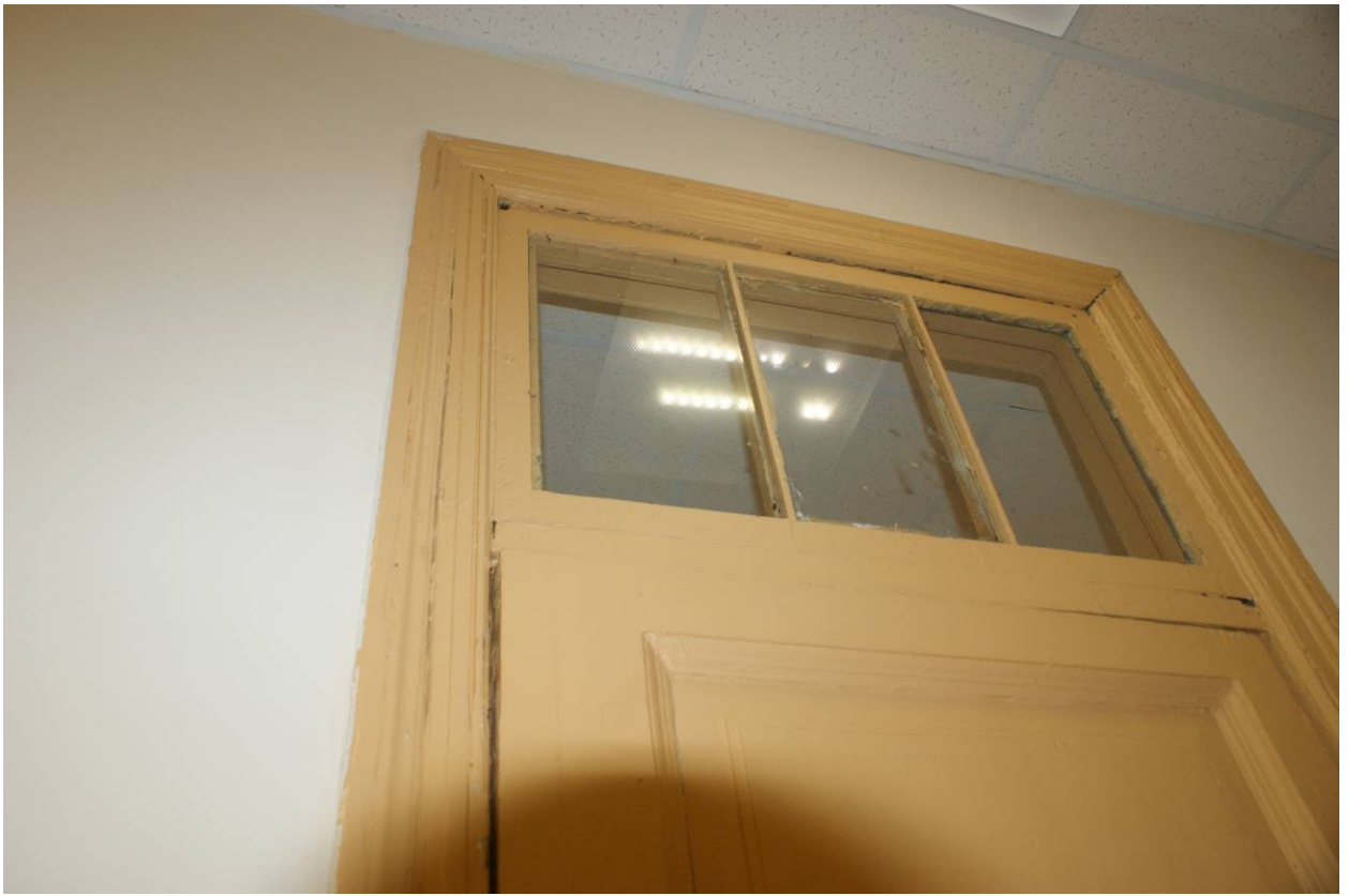
Фото 22. 4-й этаж. Помещение 1/12,7. Оформление двери. Съемка 26.04.2021 г. Михайловская Г. В.
