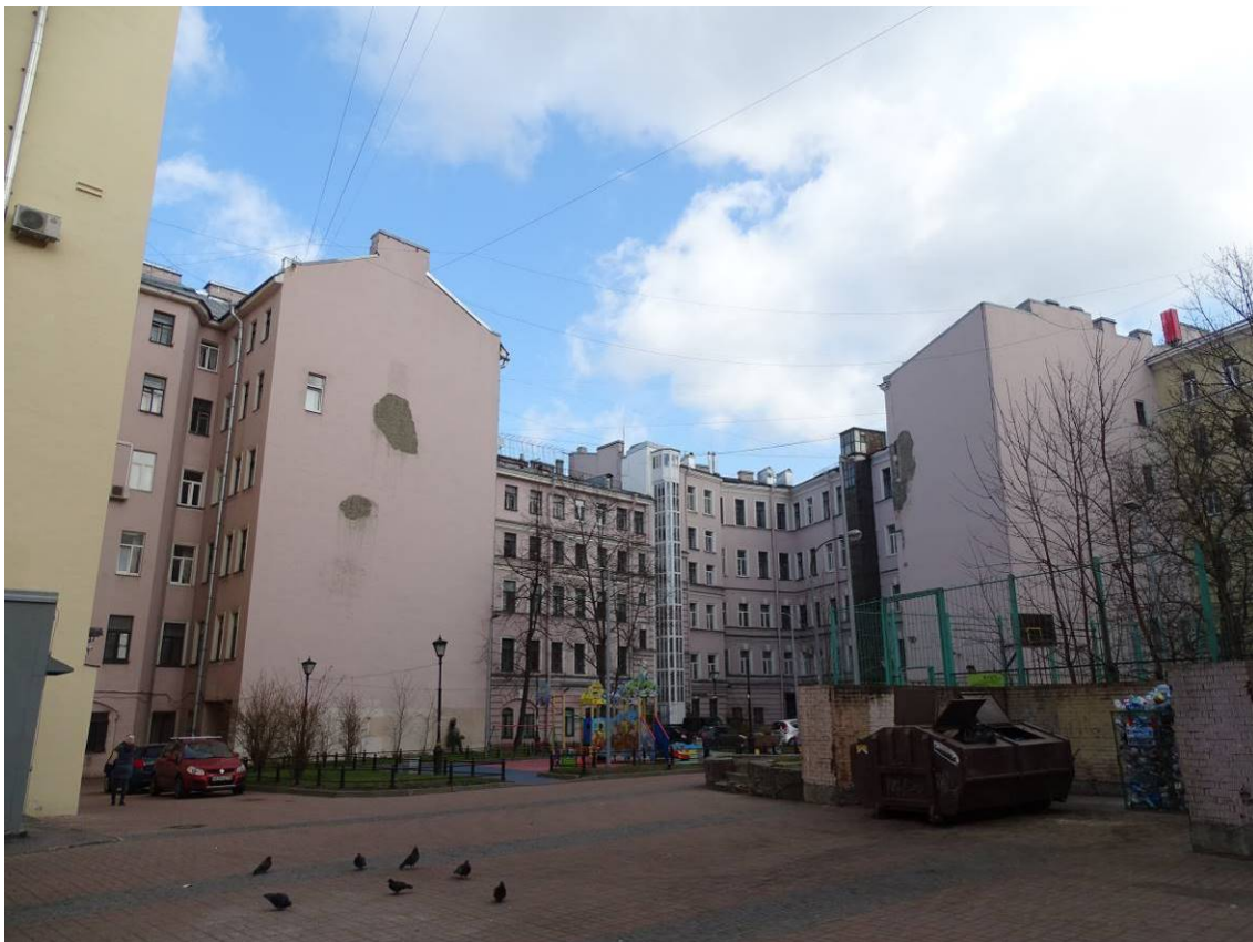
Фото 17. Дворовые фасады. Съемка 26.04.2021 г. Михайловская Г. В.
