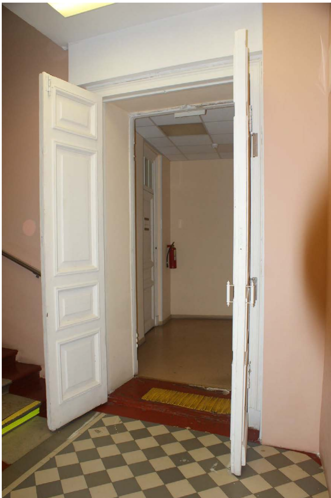
Фото 38. Лестница № 2: Площадка 5-го этажа. Оформление двери.
