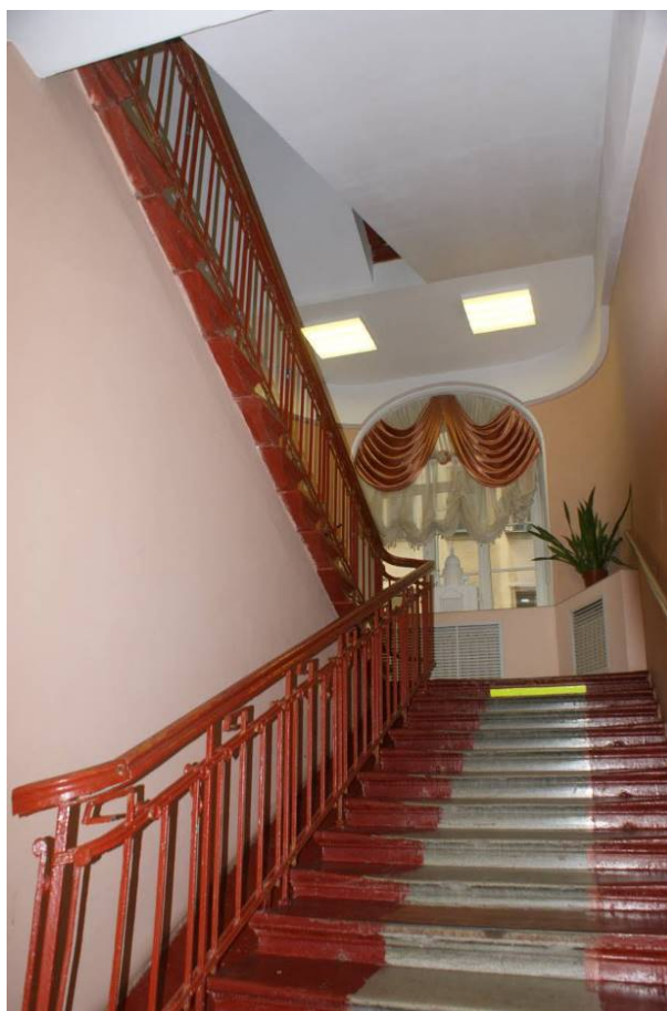
Фото 19. Лестница № 2: Вид на площадку между 1-м и 2-м этажом. Съемка 26.04.2021 г. Михайловская Г. В.
