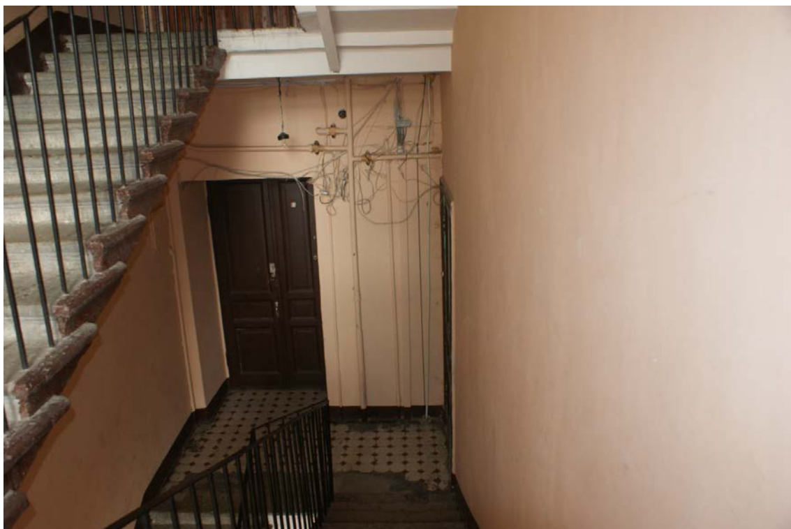
Фото 11. Лестница № 1: 4 этаж. Съёмка 26.04.2021 г. Михайловская Г. В.
