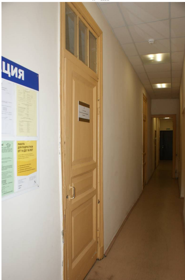
Фото 21. 4-й этаж. Помещение 1/12,7. Оформление двери. Съемка 26.04.2021 г. Михайловская Г. В.
