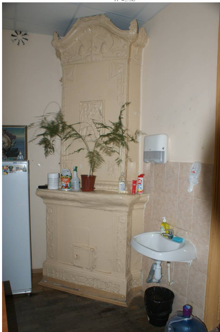
Фото 9. 3-й этаж. Помещение 12/53,6. Печь угловая. Съемка 26.04.2021 г. Михайловская Г. В.
