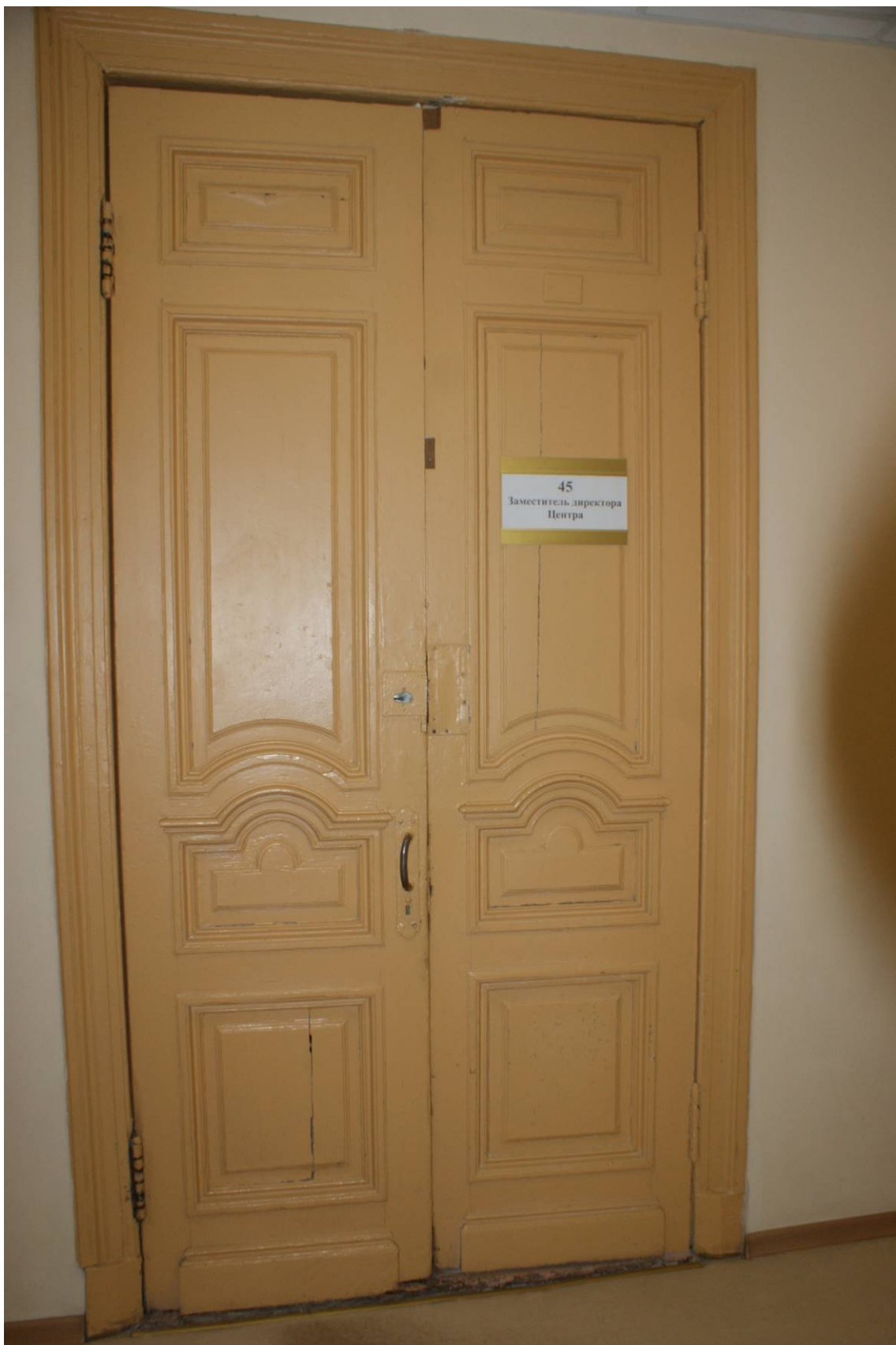
Фото 19. 4-й этаж. Помещение 3/50,5. Оформление двери. Съемка 26.04.2021 г. Михайловская Г. В.
