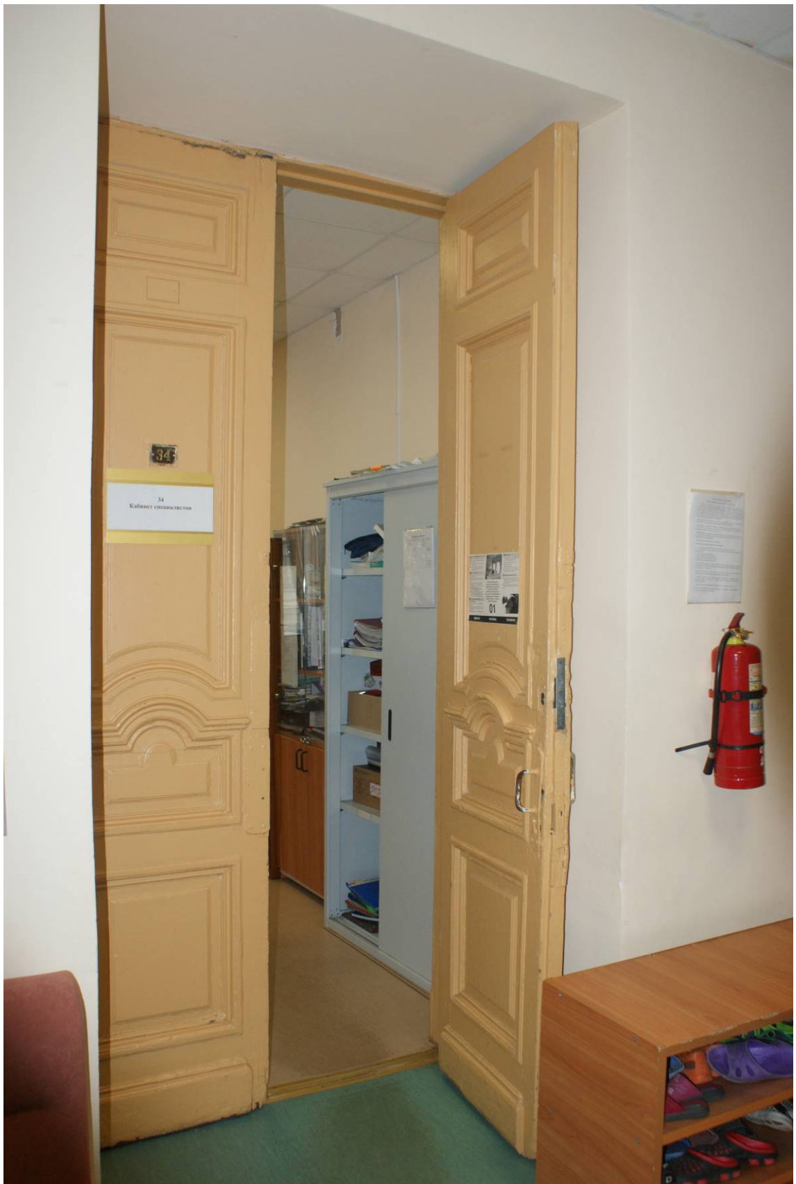
Фото 3. 3-й этаж. Помещение 3/51,6. Оформление двери. Съемка 26.04.2021 г. Михайловская Г. В.
