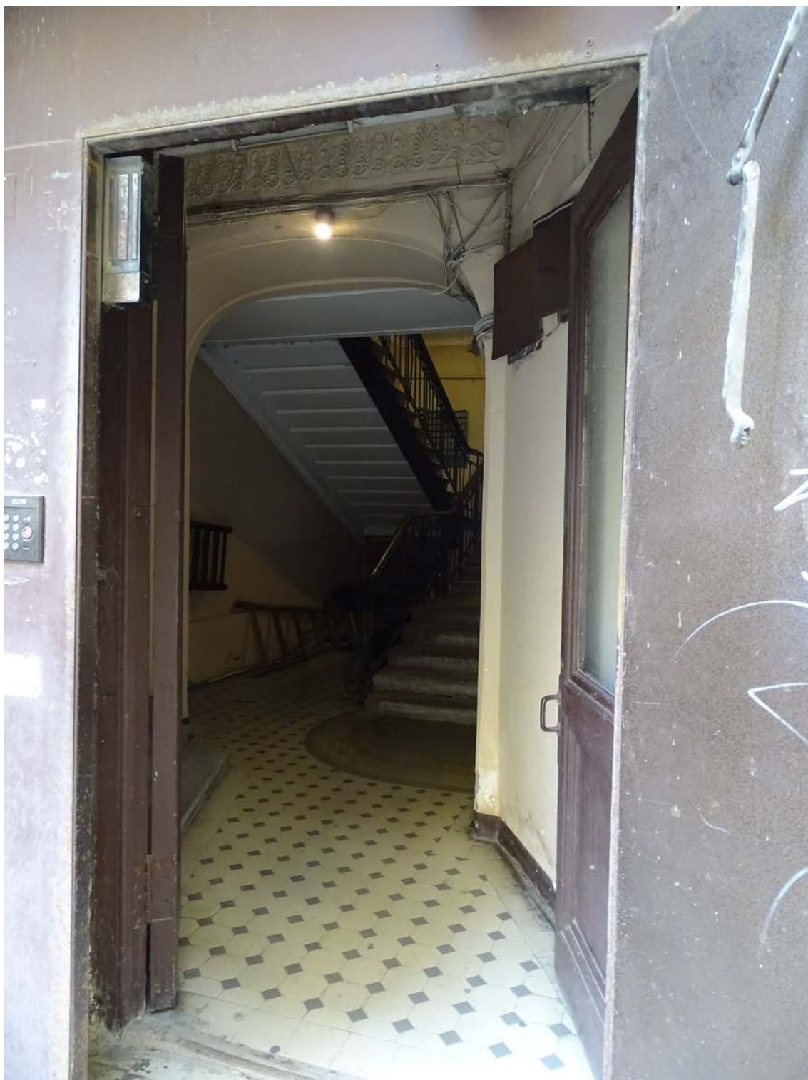
Фото 43. Лестница № 3: Вестибюль 1-го этажа. Съемка 26.04.2021 г. Михайловская Г. В.
