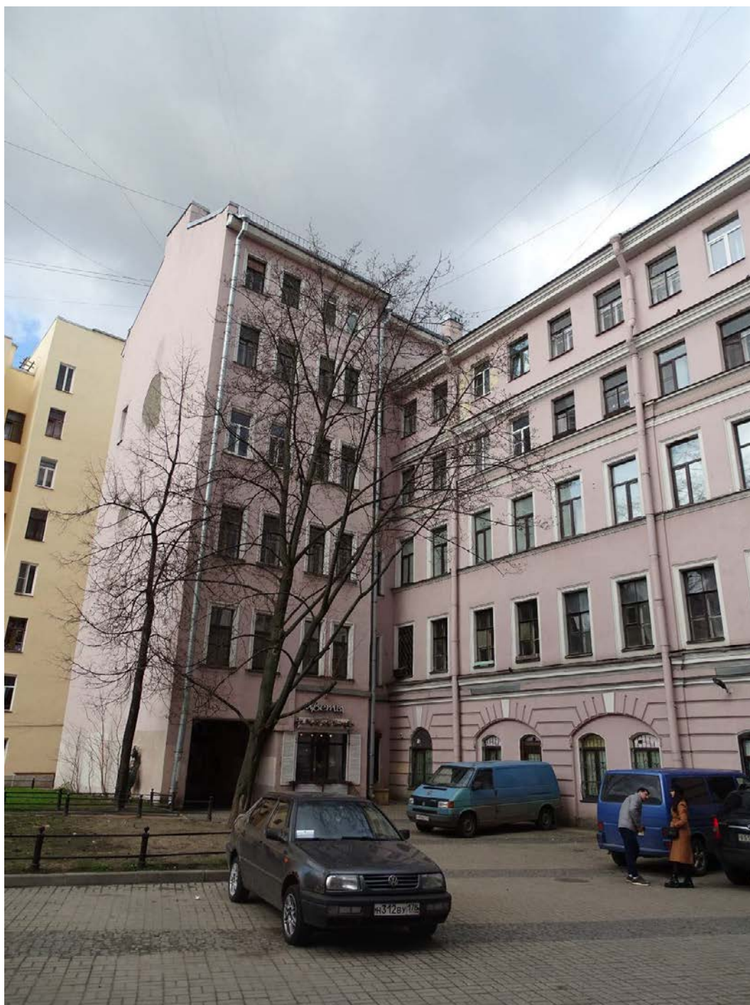
Фото 18. Дворовые фасады. Съемка 26.04.2021 г. Михайловская Г. В.
