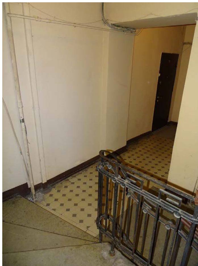
Фото 55. Лестница № 3: 2 этаж. Съемка 26.04.2021 г. Михайловская Г. В.
