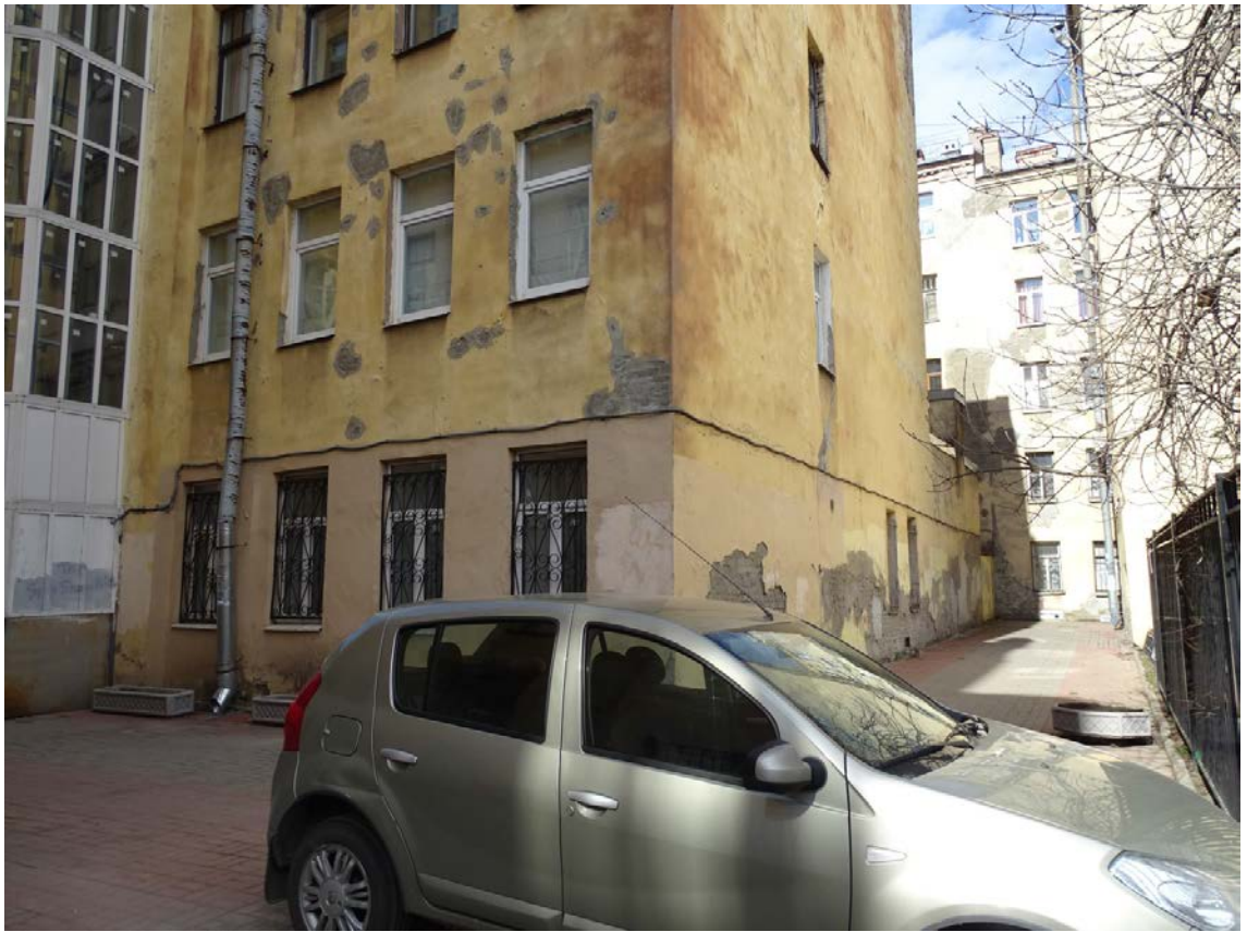
Фото 32. Здание по адресу: г. Санкт-Петербург, Большая Зеленина ул., дом 29, литера Б. Фрагмент северо-восточного фасада 5-ти этажного корпуса. Съемка 19.04.2021 г. Штиглиц М. С.
