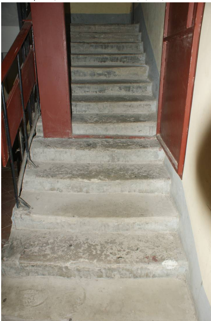
Фото 10. Лестница № 6. 1-й этаж. Съемка 19.04.2021 г. Штиглиц М. С.
