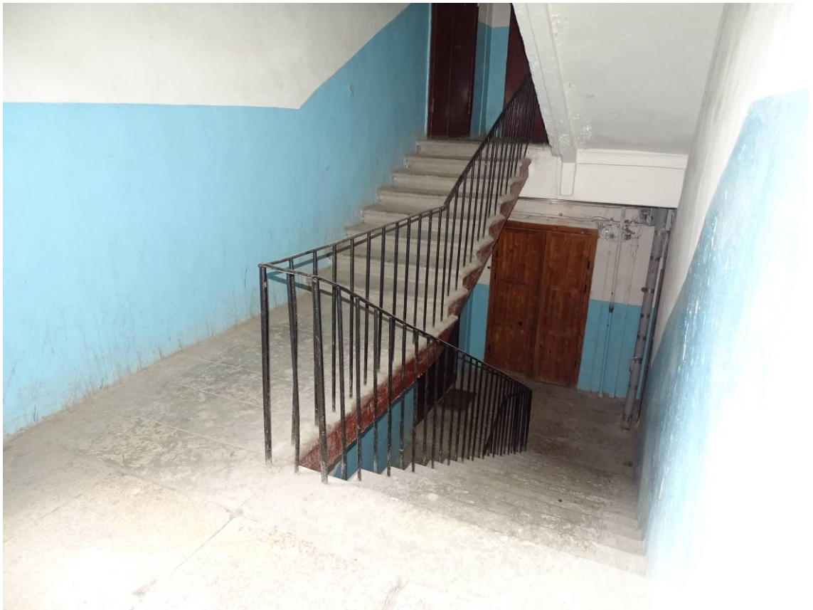
Фото 60. Лестница № 7. 3-й этаж. Съемка 19.04.2021 г. Штиглиц М. С.
