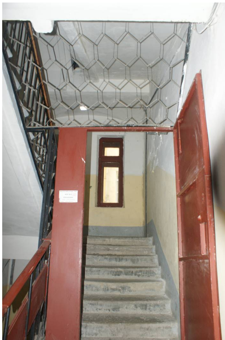
Фото 11. Лестница № 6. 1-й этаж. Съемка 19.04.2021 г. Штиглиц М. С.
