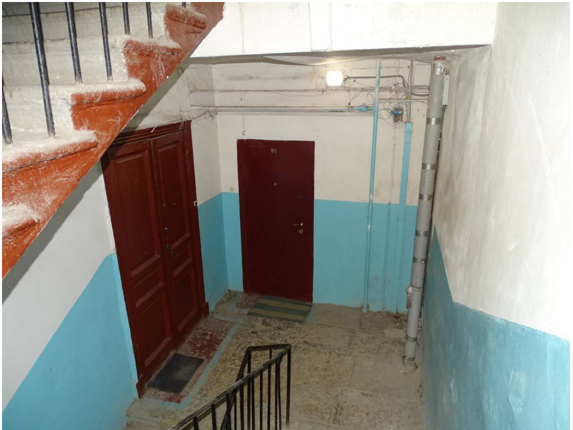
Фото 64. Лестница № 7. 4-й этаж. Съемка 19.04.2021 г. Штиглиц М. С.
