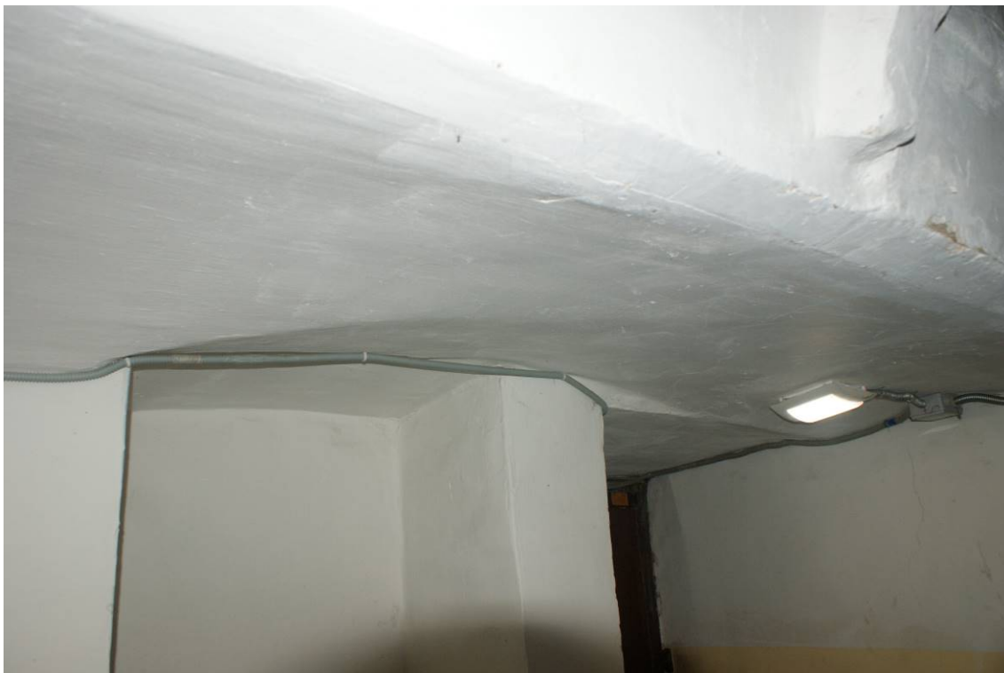
Фото 3. Лестница № 6. 1-й этаж. Перекрытие. Съемка 19.04.2021 г. Штиглиц М. С.
