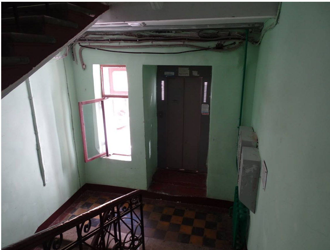
Фото 92. Лестница № 8. Площадка между 1-м и 2-м этажом. Съемка 19.04.2021 г. Штиглиц М. С.
