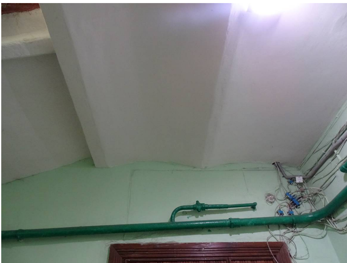
Фото 91. Лестница № 8. 1-й этаж. Вестибюль. Своды. Съемка 19.04.2021 г. Штиглиц М. С.
