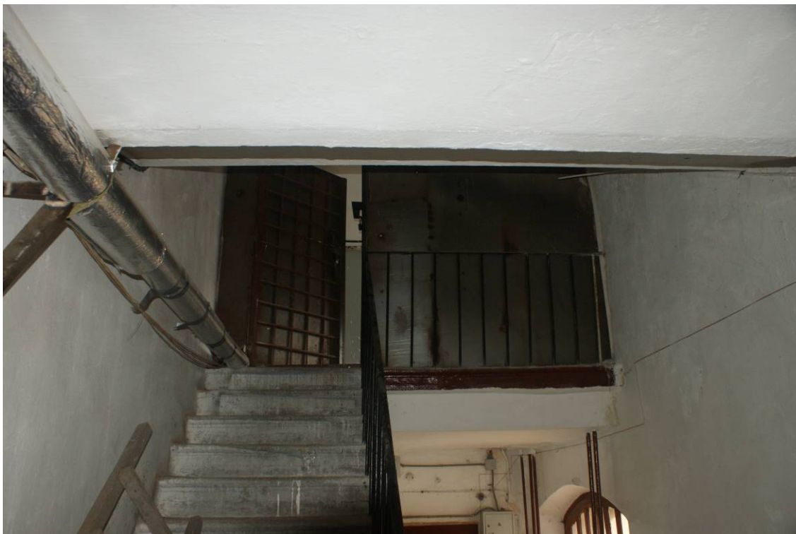
Фото 78. Лестница № 7. Выход на технический этаж. Съемка 19.04.2021 г. Штиглиц М. С.
