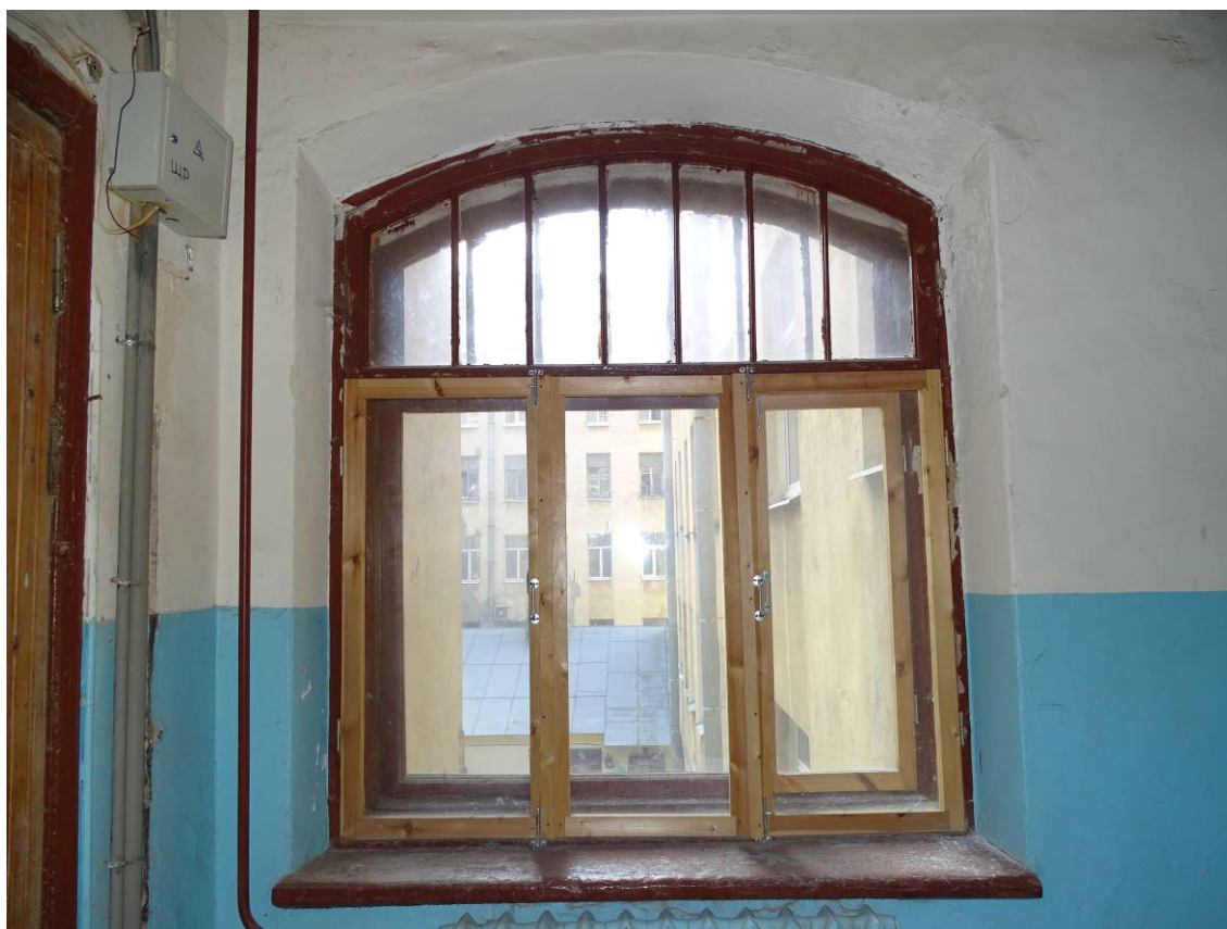
Фото 59. Лестница № 7. 3-й этаж. Съемка 19.04.2021 г. Штиглиц М. С.
