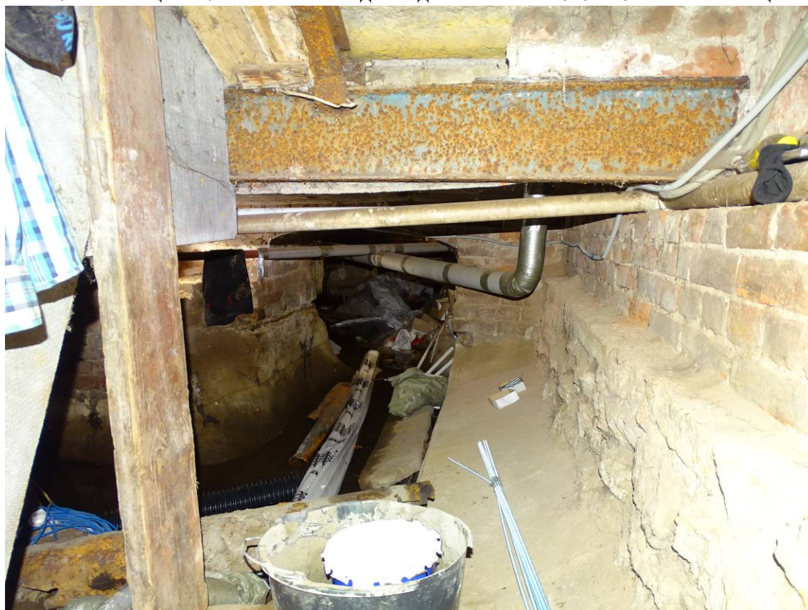
Фото 41. Лестница № 7. Подвал. Съемка 19.04.2021 г. Штиглиц М. С.
