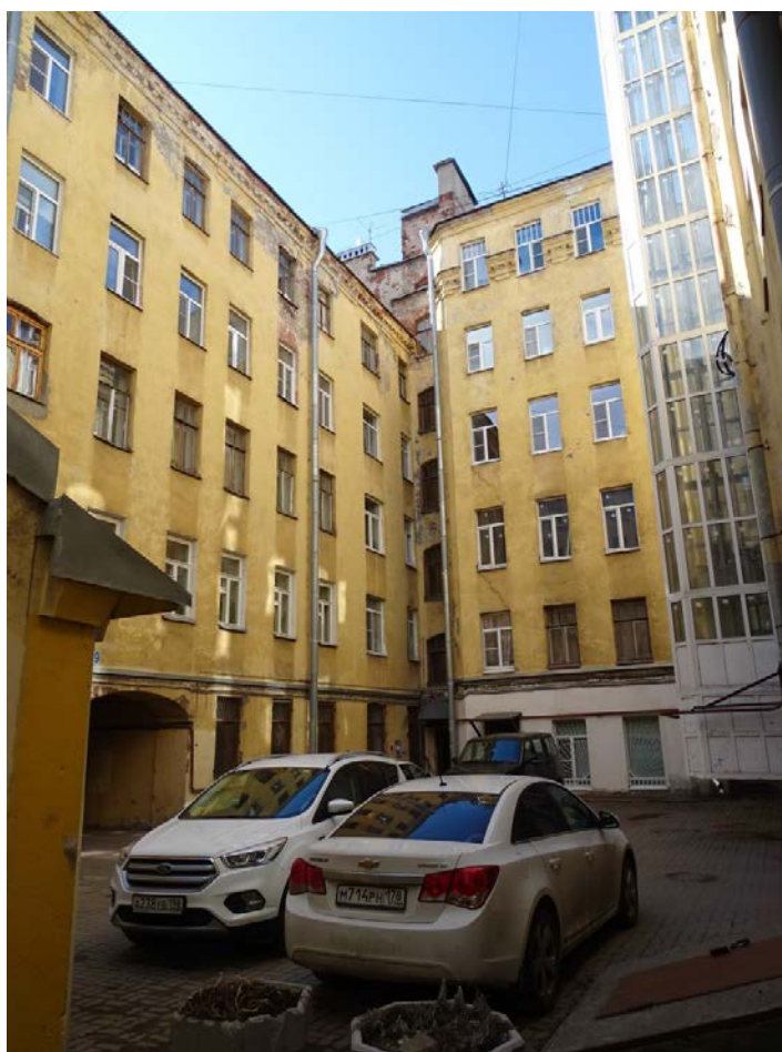
Фото 21. Здание по адресу: г. Санкт-Петербург, Большая Зеленина ул., дом 29, литера Б. Фрагмент дворового фасада. Лицевой корпус. Съемка 19.04.2021 г. Штиглиц М. С.
