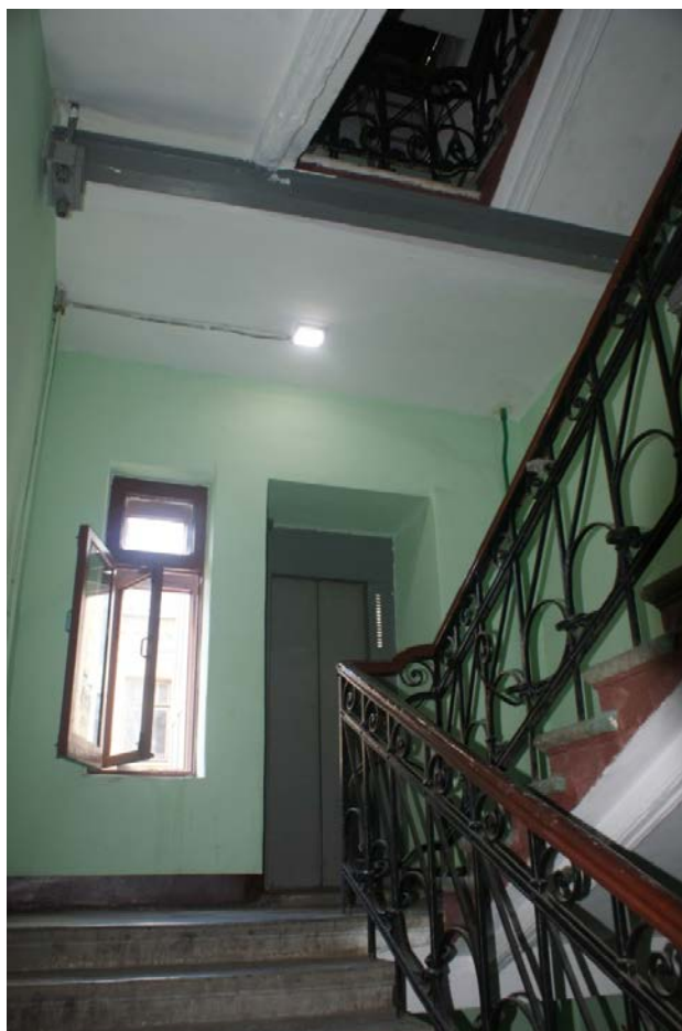
Фото 104. Лестница № 8. Площадка между 4-м и 5-м этажом. Съемка 19.04.2021 г. Штиглиц М. С.
