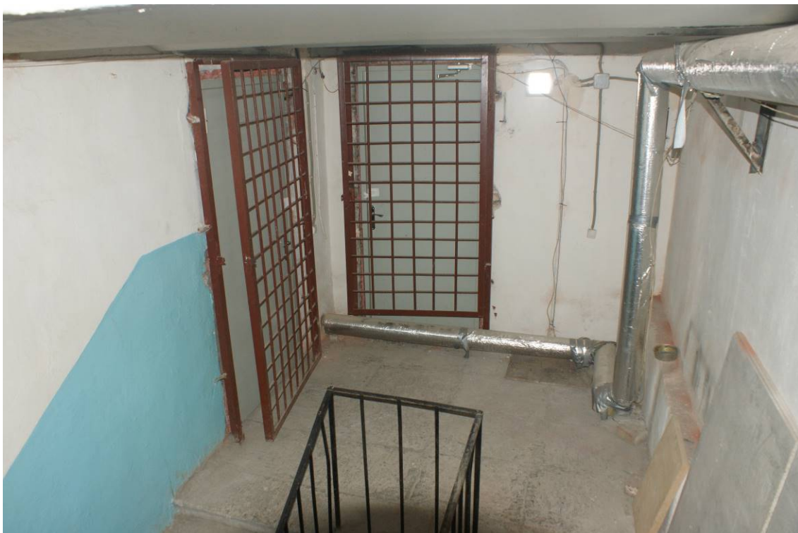
Фото 74. Лестница № 7. Выход на технический этаж. Съёмка 19.04.2021 г. Штиглиц М. С.
