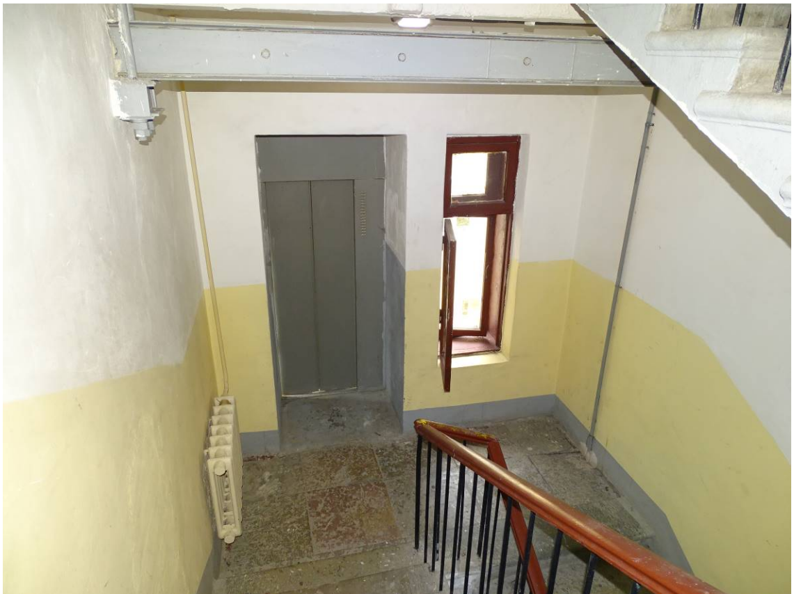
Фото 20. Лестница № 6. Площадка между 3-м и 4-м этажом. Съемка 19.04.2021 г. Штиглиц М. С.
