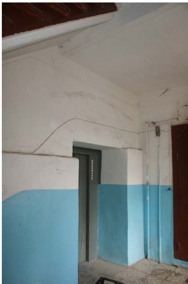
Фото 72. Лестница № 7. 6-й этаж. Съемка 19.04.2021 г. Штиглиц М. С.
