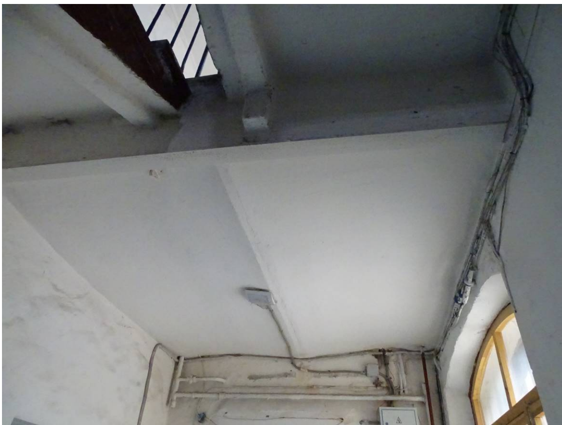
Фото 52. Лестница № 7. 1-й этаж. Своды. Съемка 19.04.2021 г. Штиглиц М. С.
