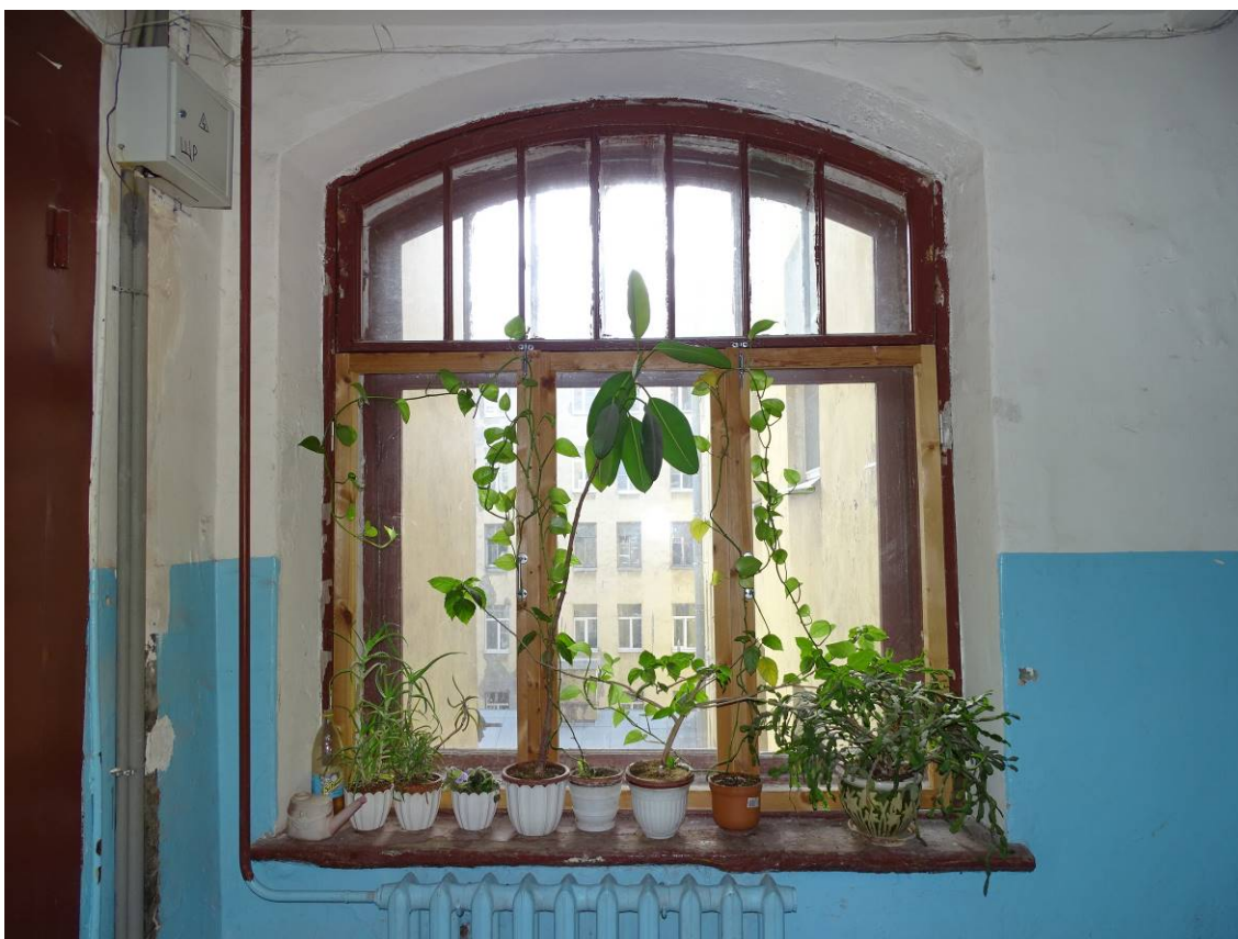
Фото 63. Лестница № 7. 4-й этаж. Съемка 19.04.2021 г. Штиглиц М. С.
