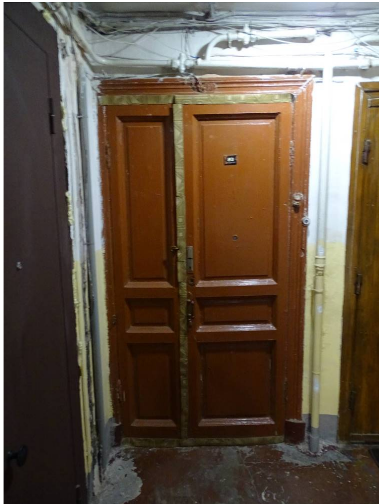
Фото 26. Лестница № 6. 5-й этаж. Съемка 19.04.2021 г. Штиглиц М. С.
