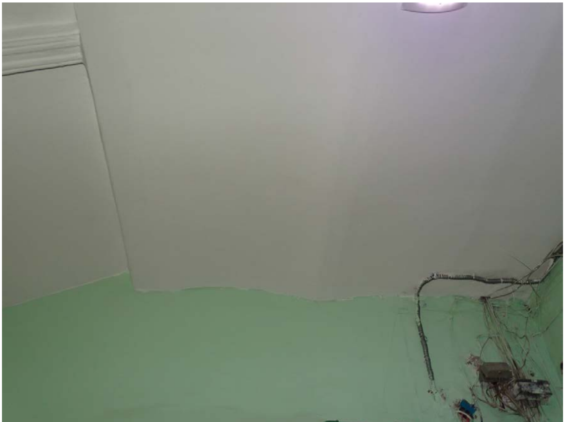
Фото 103. Лестница № 8. 4-й этаж. Своды. Съемка 19.04.2021 г. Штиглиц М. С.
