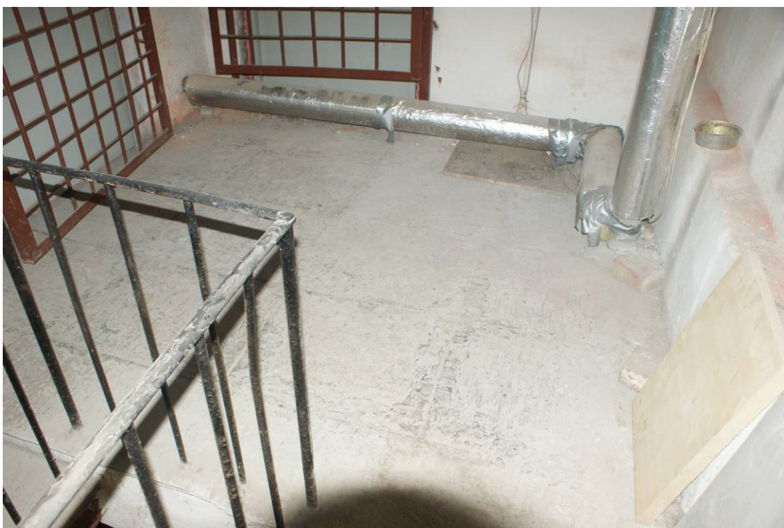
Фото 75. Лестница № 7. Выход на технический этаж. Съёмка 19.04.2021 г. Штиглиц М. С.
