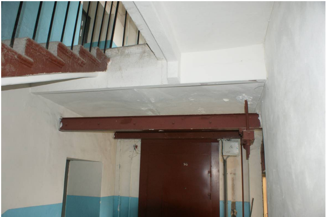
Фото 66. Лестница № 7. 5-й этаж. Съемка 19.04.2021 г. Штиглиц М. С.
