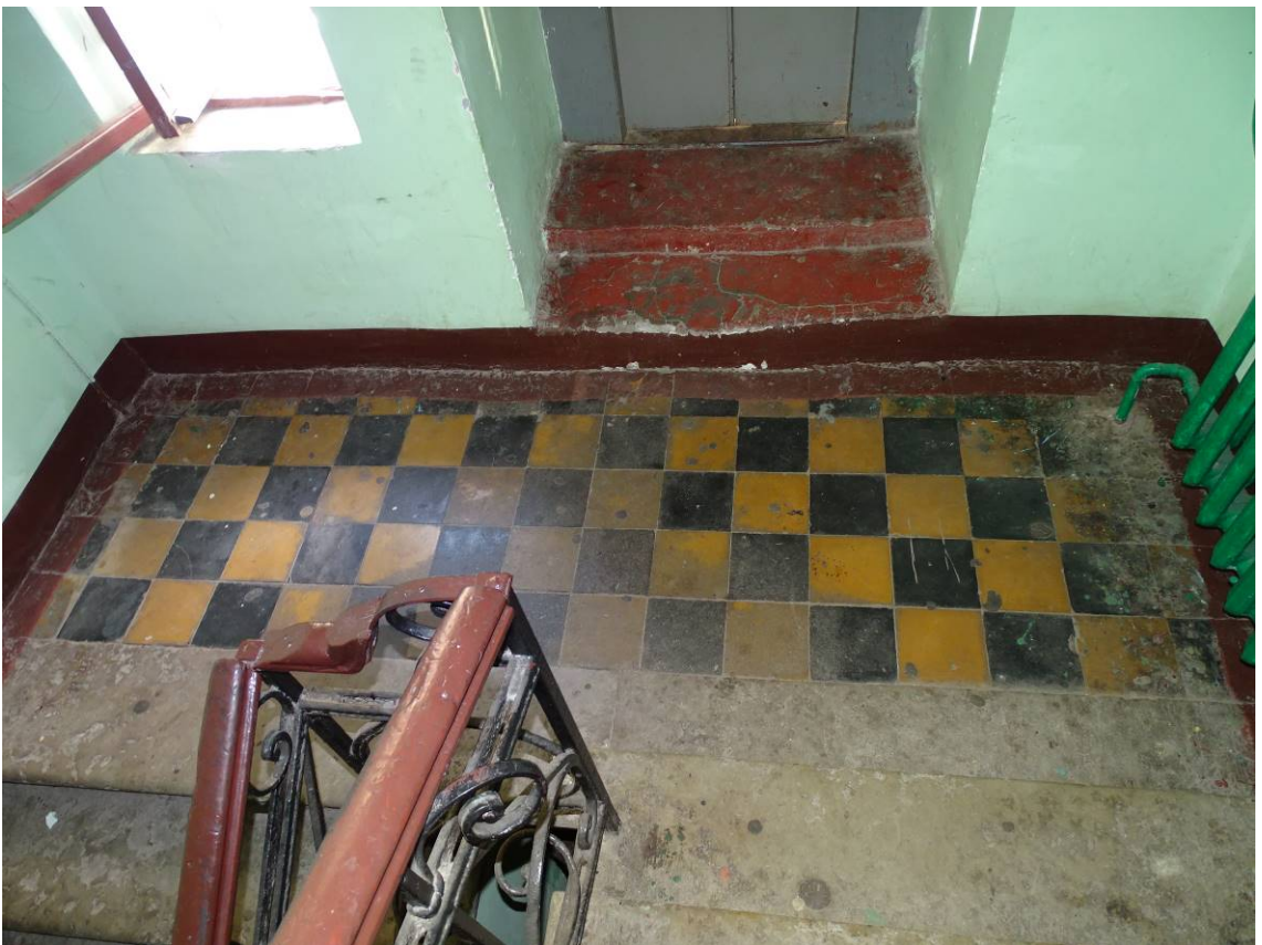
Фото 95. Лестница № 8. Площадка между 1-м и 2-м этажом. Покрытие пола. Съемка 19.04.2021 г. Штиглиц М. С.
