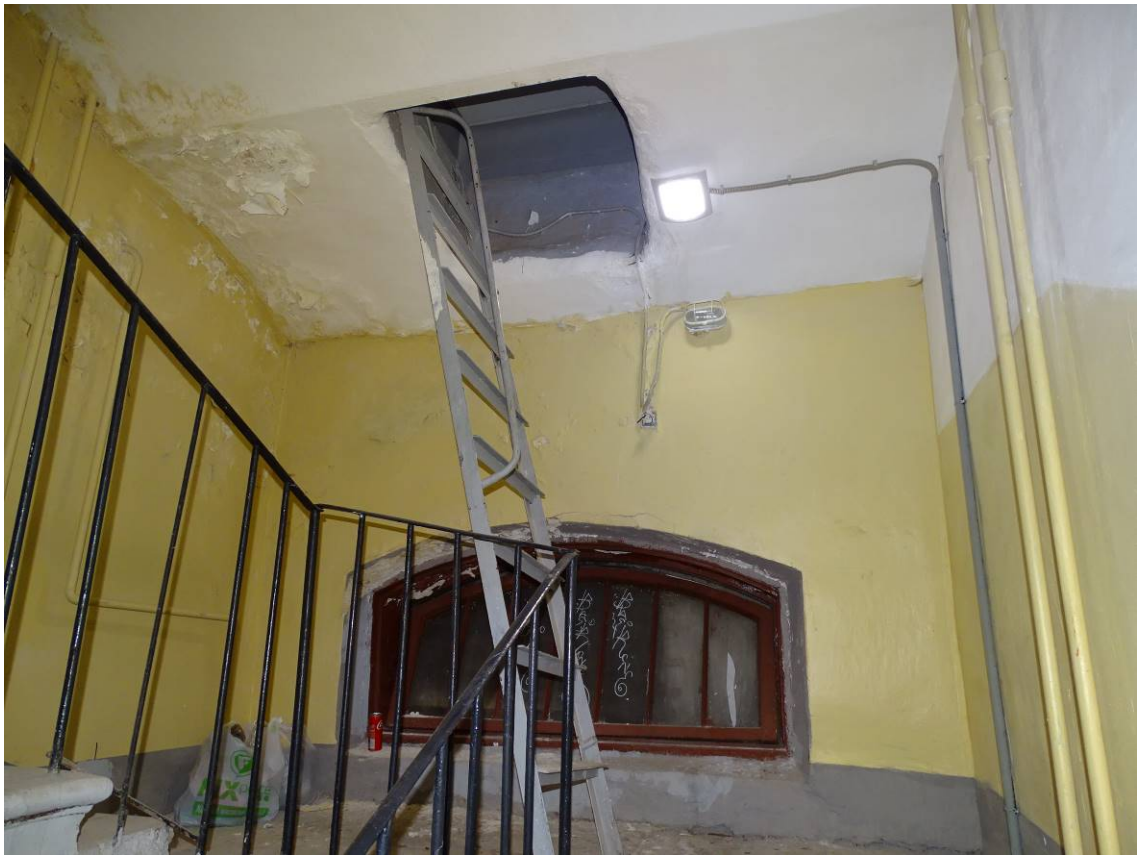
Фото 29. Лестница № 6. Площадка между 5-м и чердачным этажом. Съемка 19.04.2021 г. Штиглиц М. С.
