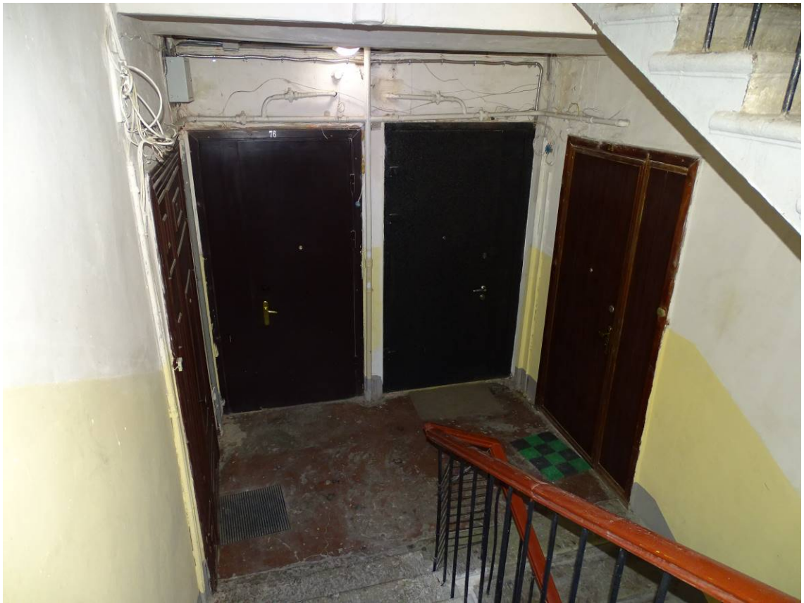
Фото 21. Лестница № 6. 4-й этаж. Съемка 19.04.2021 г. Штиглиц М. С.
