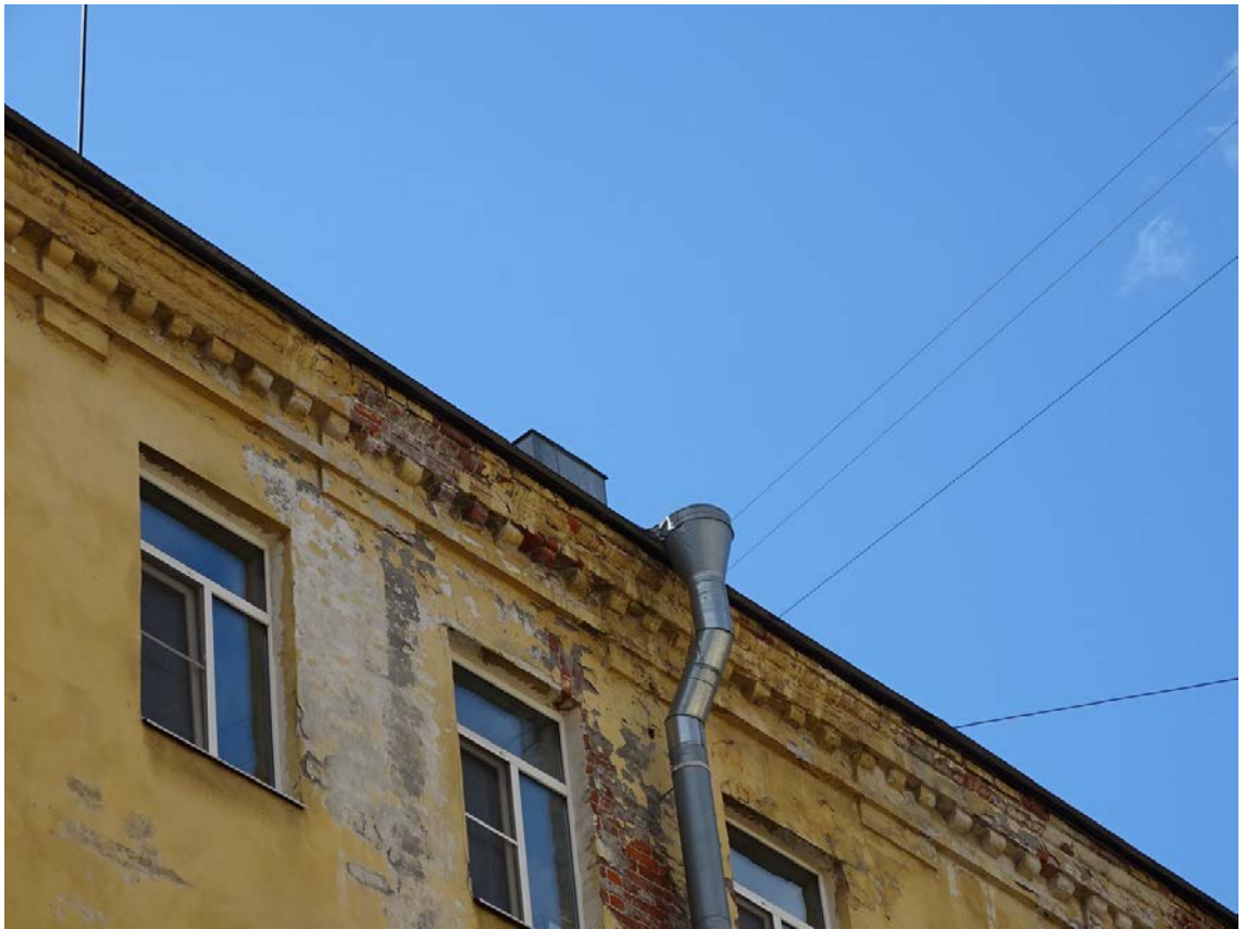
Фото 23. Здание по адресу: г. Санкт-Петербург, Большая Зеленина ул., дом 29, литера Б. Фрагмент дворового фасада. Съемка 19.04.2021 г. Штиглиц М. С.
