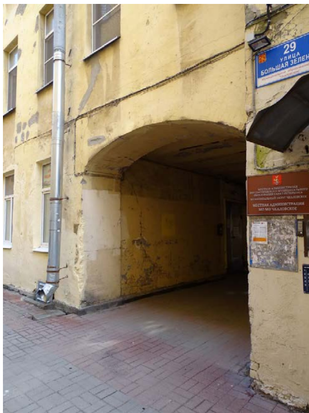
Фото 33. Здание по адресу: г. Санкт-Петербург, Большая Зеленина ул., дом 29, литера Б. Фрагмент северо-восточного фасада 5-ти этажного корпуса. Воротный проезд. Съемка 19.04.2021 г. Штиглиц М. С.
