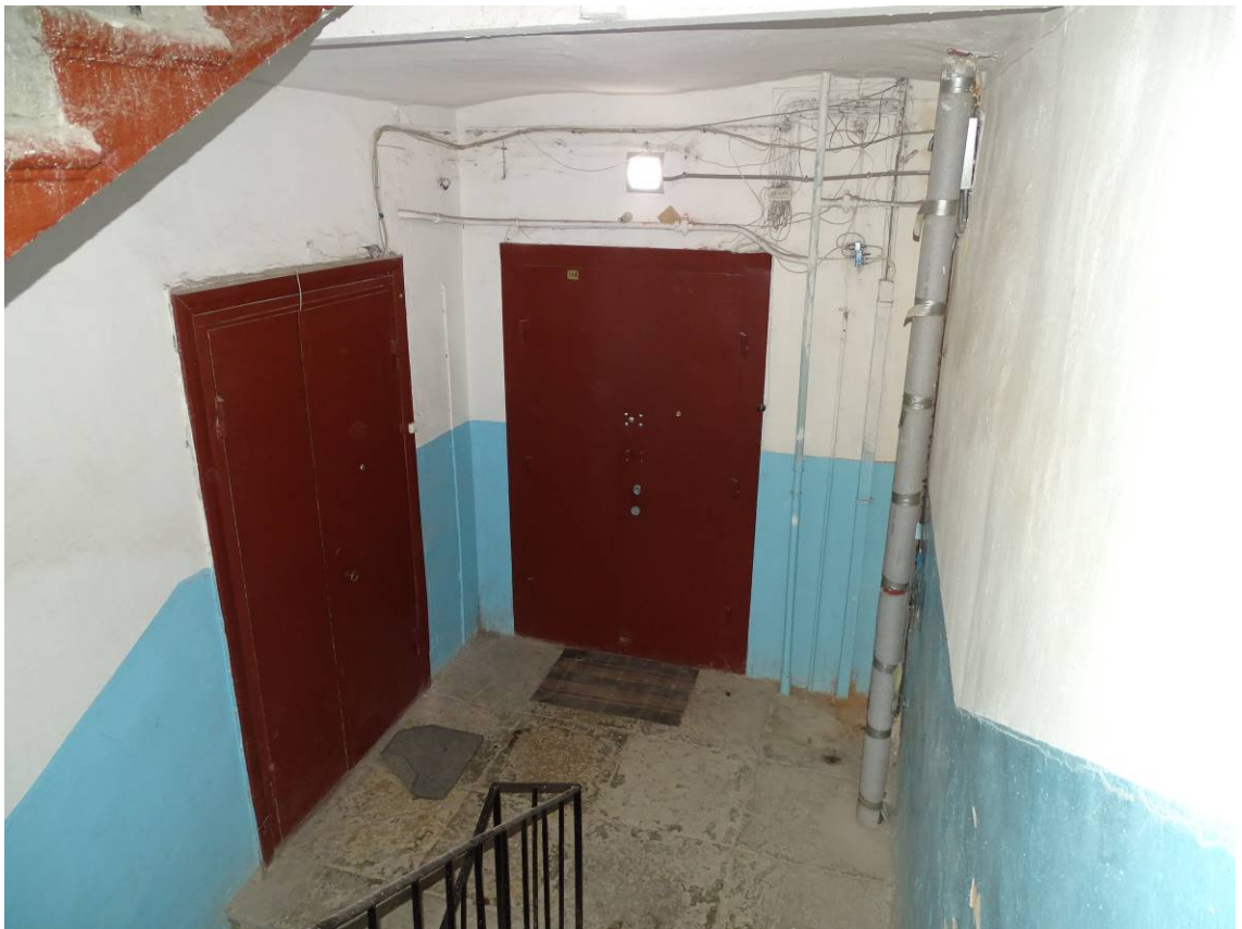
Фото 61. Лестница № 7. 3-й этаж. Съемка 19.04.2021 г. Штиглиц М. С.
