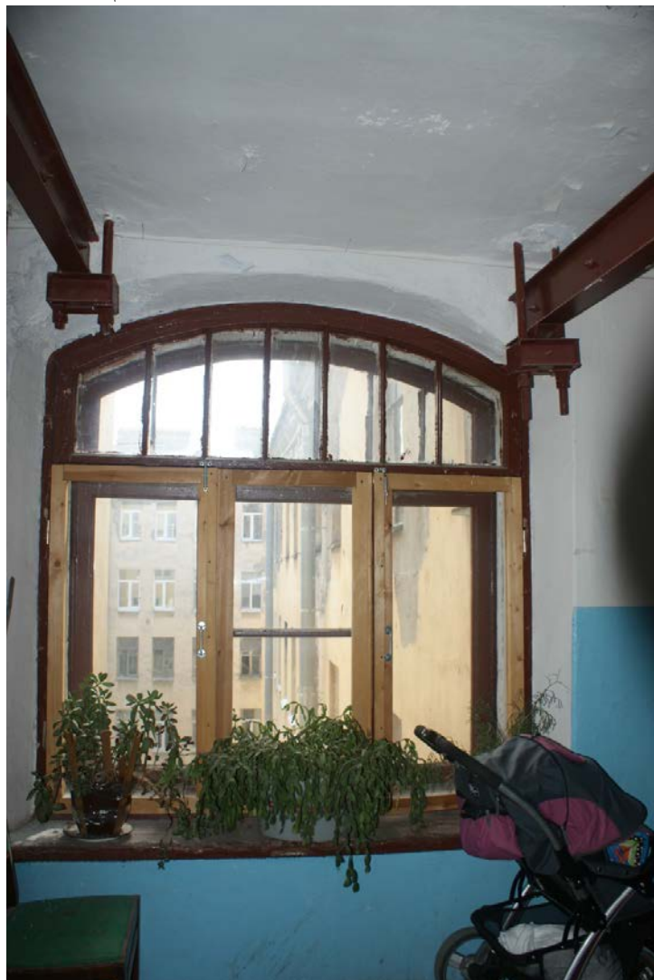
Фото 67. Лестница № 7. 5-й этаж. Съемка 19.04.2021 г. Штиглиц М. С.
