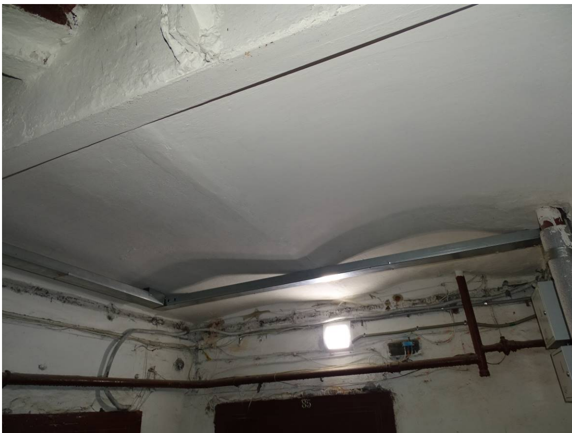
Фото 48. Лестница № 7. 1-й этаж. Своды. Съемка 19.04.2021 г. Штиглиц М. С.
