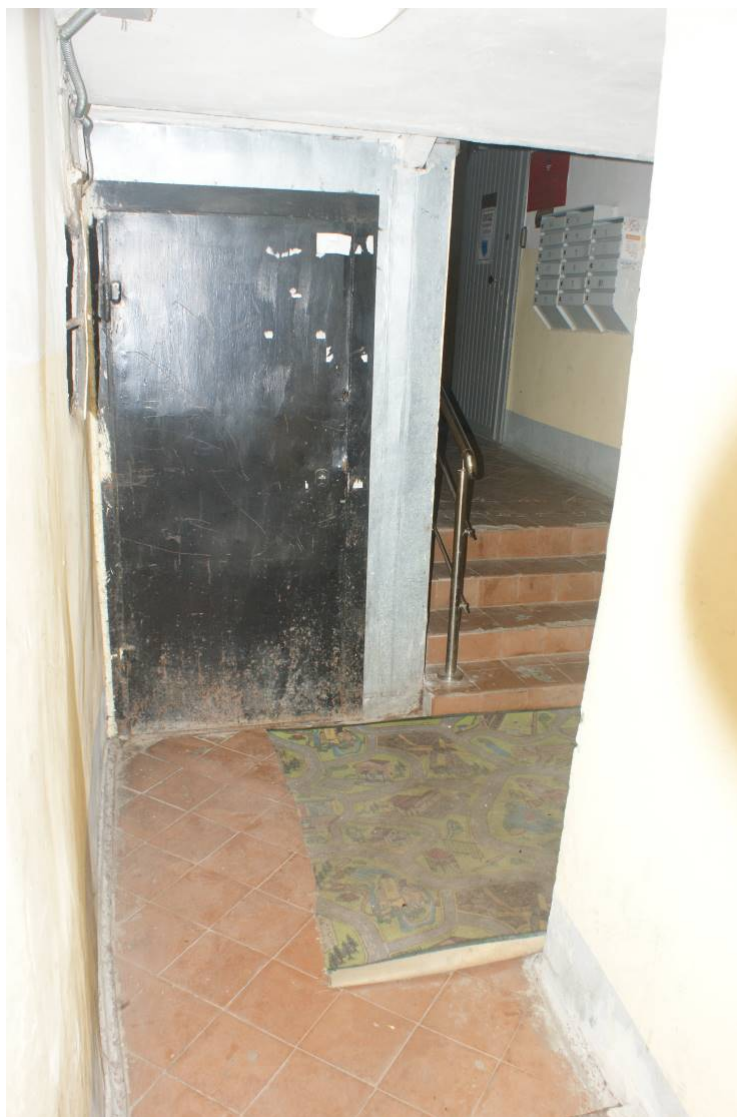
Фото 7. Лестница № 6. 1-й этаж. Съемка 19.04.2021 г. Штиглиц М. С.
