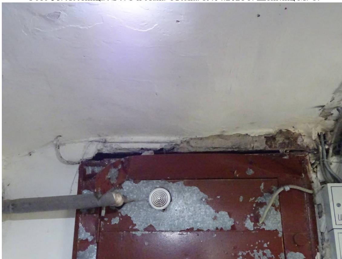
Фото 39. Лестница № 7. 1-й этаж. Съемка 19.04.2021 г. Штиглиц М. С.
