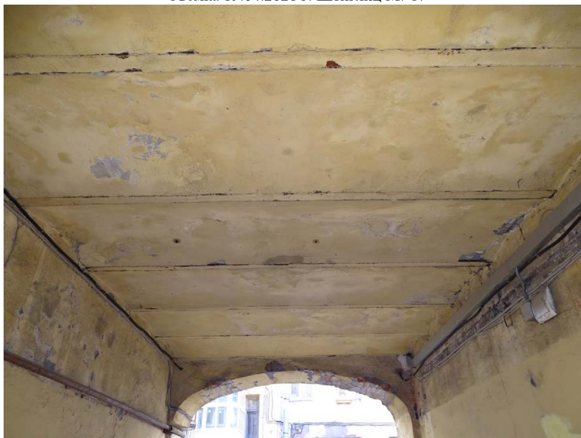
Фото 34. Здание по адресу: г. Санкт-Петербург, Большая Зеленина ул., дом 29, литера Б. Воротный проезд северо-восточного фасада 5-ти этажного корпуса. Воротный проезд. Съемка 19.04.2021 г. Штиглиц М. С.
