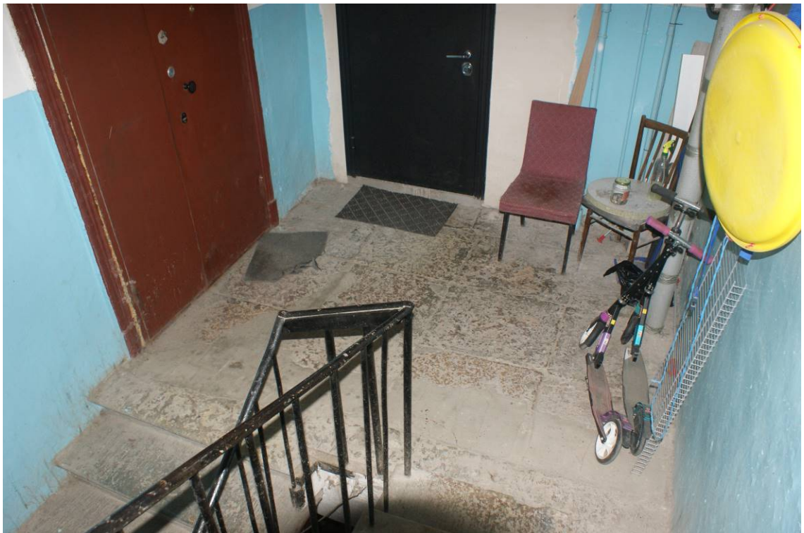
Фото 69. Лестница № 7. 5-й этаж. Съёмка 19.04.2021 г. Штиглиц М. С.
