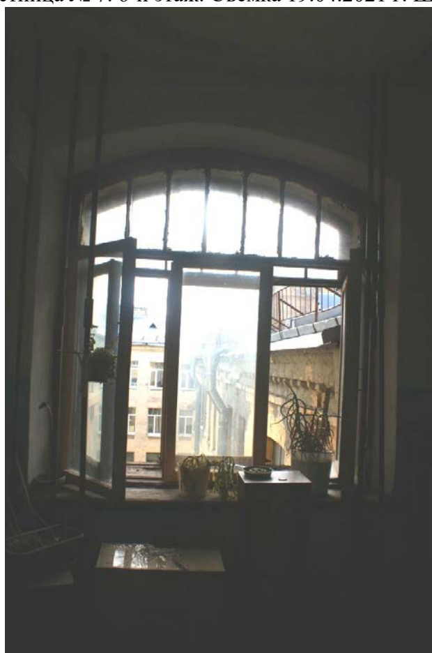
Фото 73. Лестница № 7. 6-й этаж. Съемка 19.04.2021 г. Штиглиц М. С.
