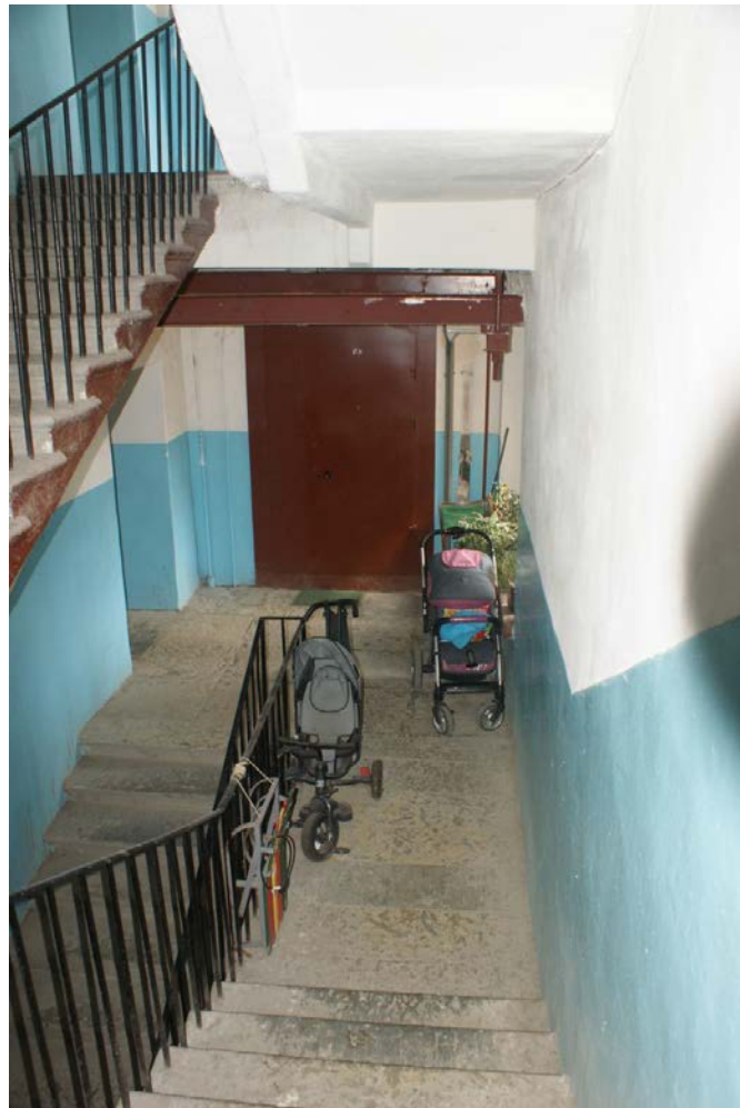
Фото 65. Лестница № 7. 5-й этаж. Съемка 19.04.2021 г. Штиглиц М. С.
