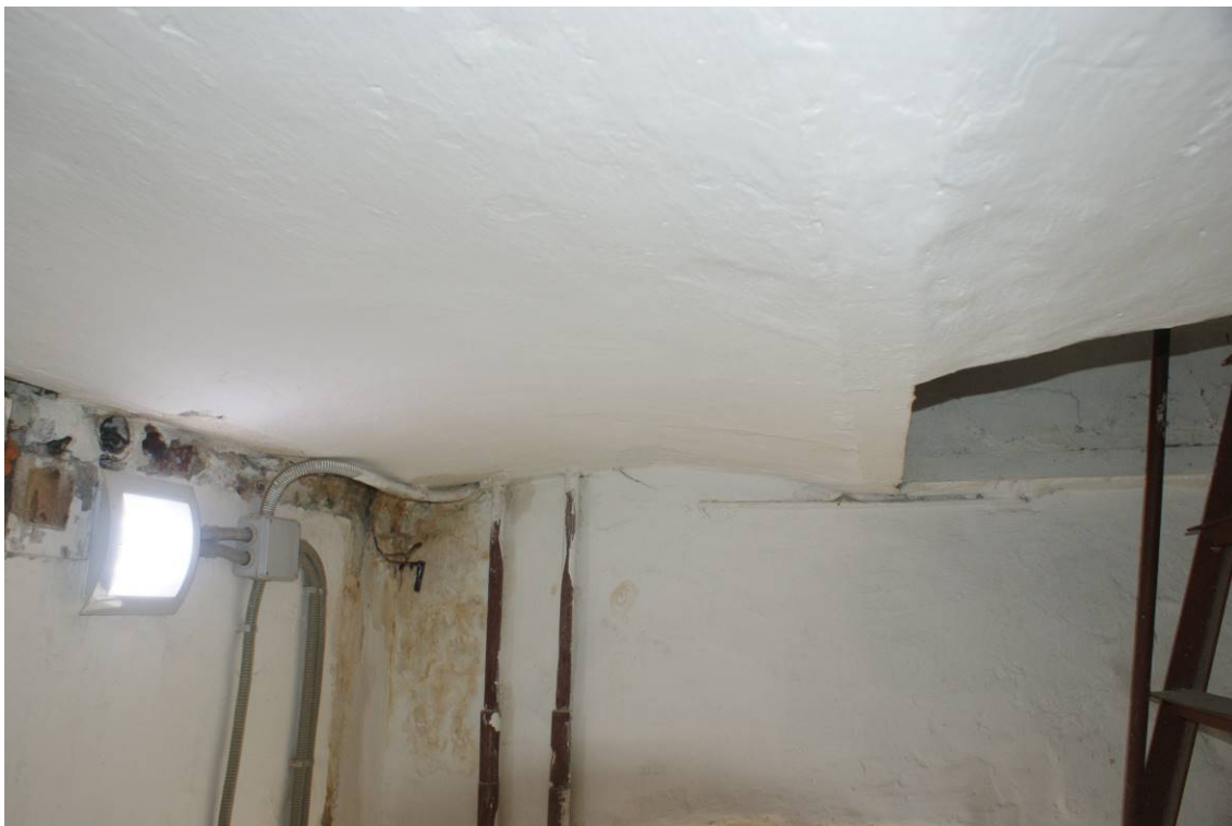
Фото 80. Лестница № 7. Технический этаж. Своды. Съемка 19.04.2021 г. Штиглиц М. С.
