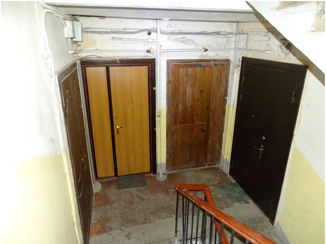
Фото 15. Лестница № 6. 2-й этаж. Съемка 19.04.2021 г. Штиглиц М. С.
