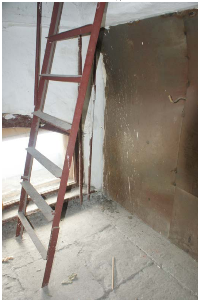
Фото 81. Лестница № 7. Технический этаж. Выход на кровлю. Съемка 19.04.2021 г. Штиглиц М. С.
