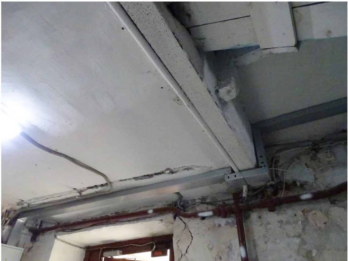
Фото 37. Лестница № 7. 1-й этаж. Перекрытие. Съемка 19.04.2021 г. Штиглиц М. С.
