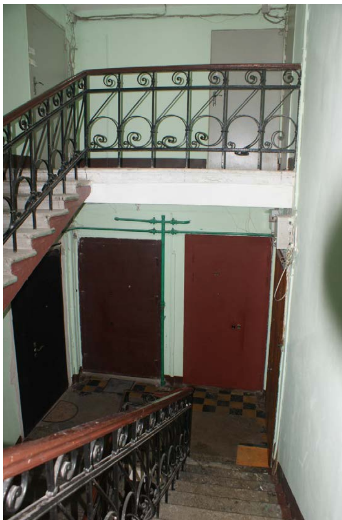
Фото 108. Лестница № 8. 5-й этаж. Съемка 19.04.2021 г. Штиглиц М. С.
