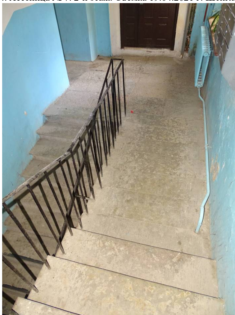
Фото 55. Лестница № 7. Площадка 2-го этажа. Съемка 19.04.2021 г. Штиглиц М. С.
