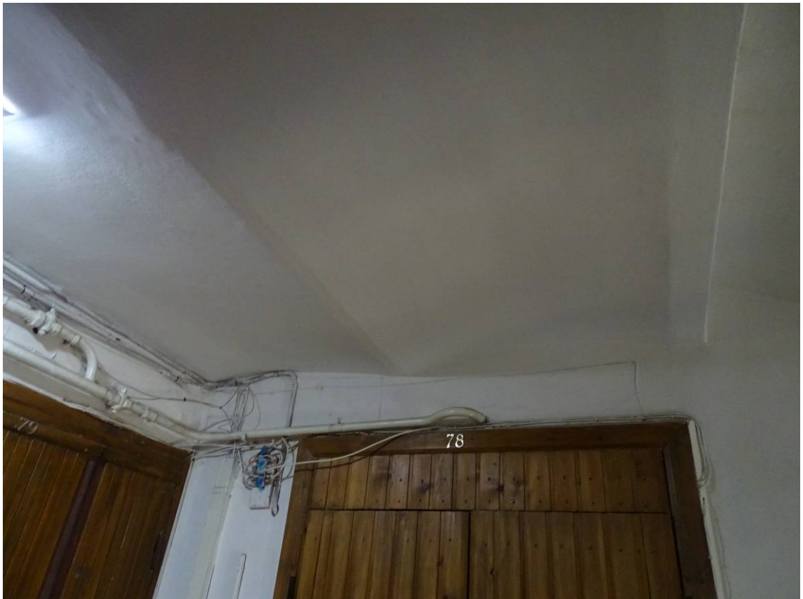
Фото 27. Лестница № 6. 5-й этаж. Своды. Съемка 19.04.2021 г. Штиглиц М. С.
