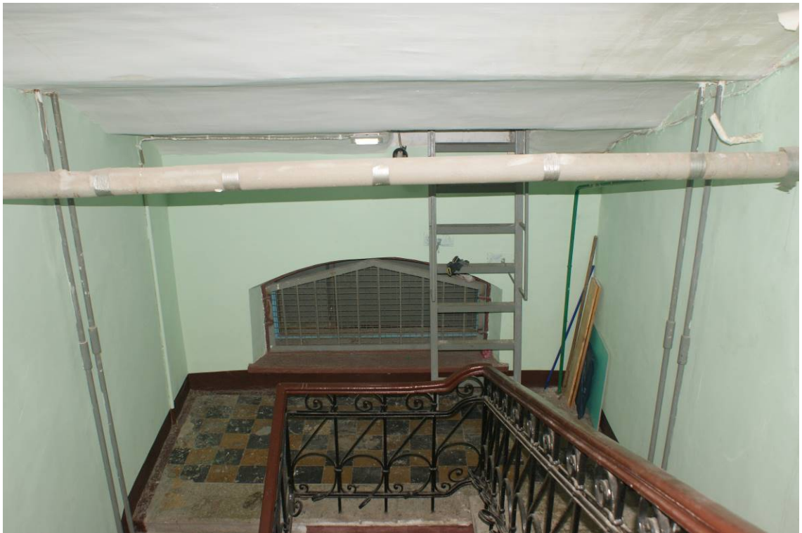
Фото 110. Лестница № 8. Площадка между 5-м и 6-м этажом. Съемка 19.04.2021 г. Штиглиц М. С.
