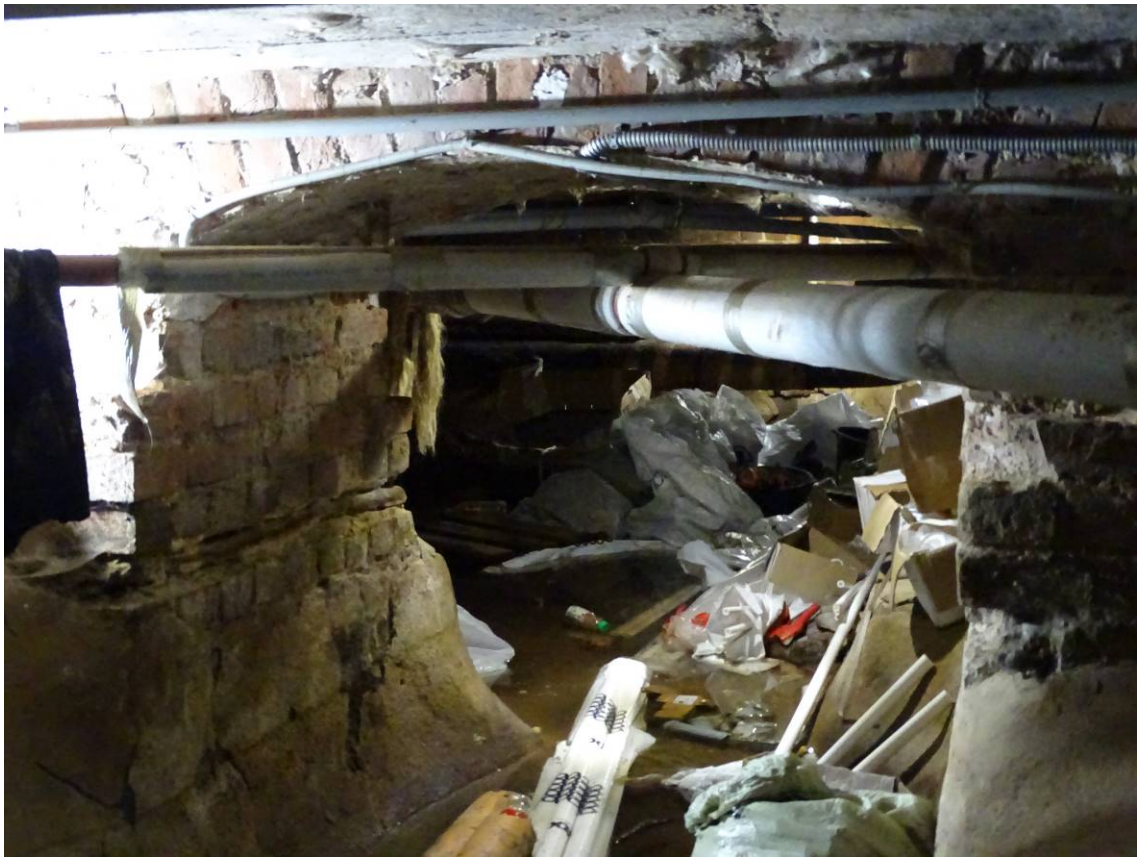
Фото 44. Лестница № 7. Подвал. Съемка 19.04.2021 г. Штиглиц М. С.
