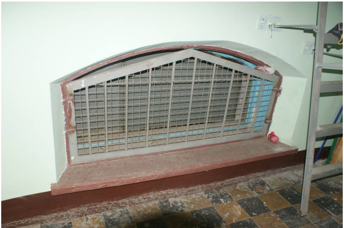
Фото 111. Лестница № 8. Площадка между 5-м и 6-м этажом. Съемка 19.04.2021 г. Штиглиц М. С.
