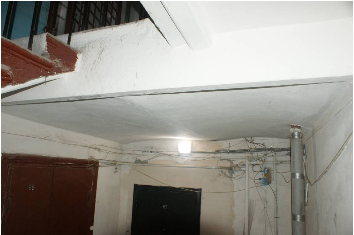
Фото 68. Лестница № 7. 5-й этаж. Своды. Съёмка 19.04.2021 г. Штиглиц М. С.
