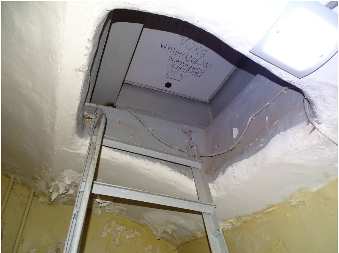
Фото 31. Лестница № 6. Площадка между 5-м и чердачным этажом. Съемка 19.04.2021 г. Штиглиц М. С.
