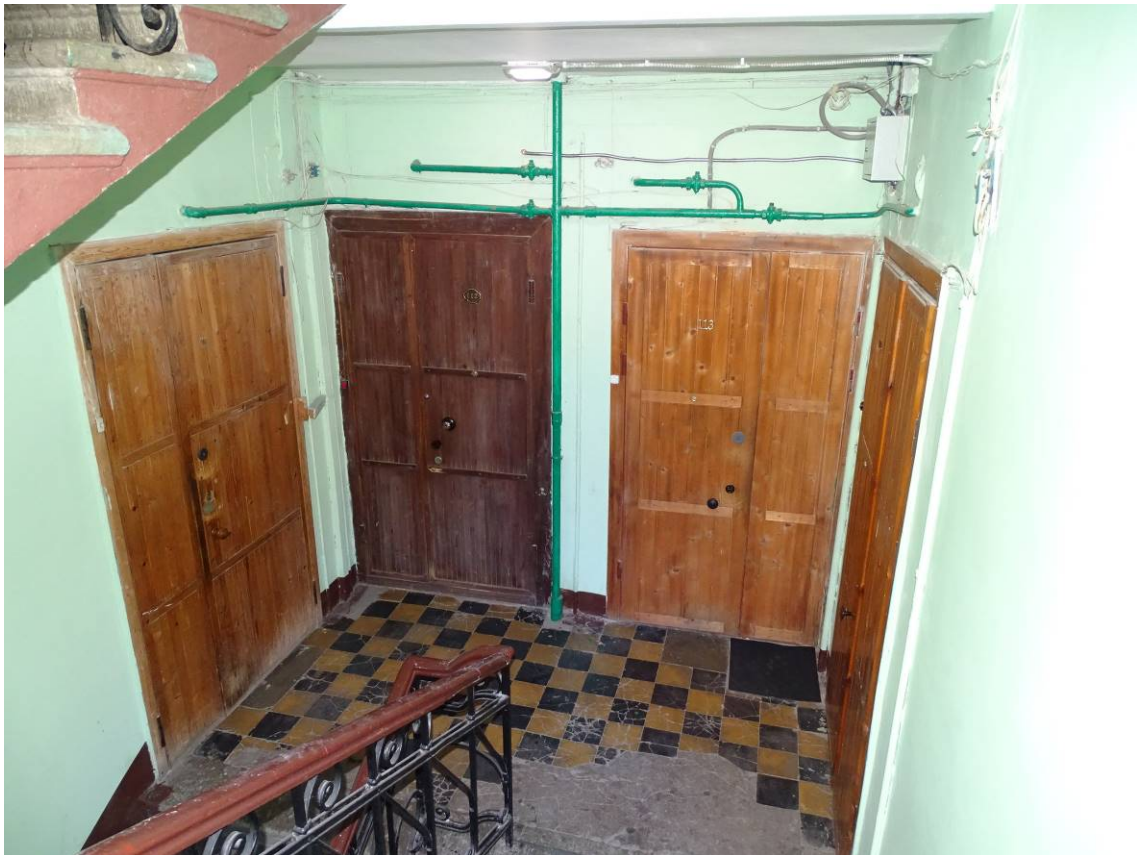
Фото 102. Лестница № 8. 4-й этаж. Съемка 19.04.2021 г. Штиглиц М. С.
