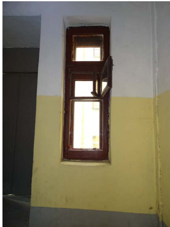
Фото 18. Лестница № 6. Площадка между 2-м и 3-м этажом. Съемка 19.04.2021 г. Штиглиц М. С.
