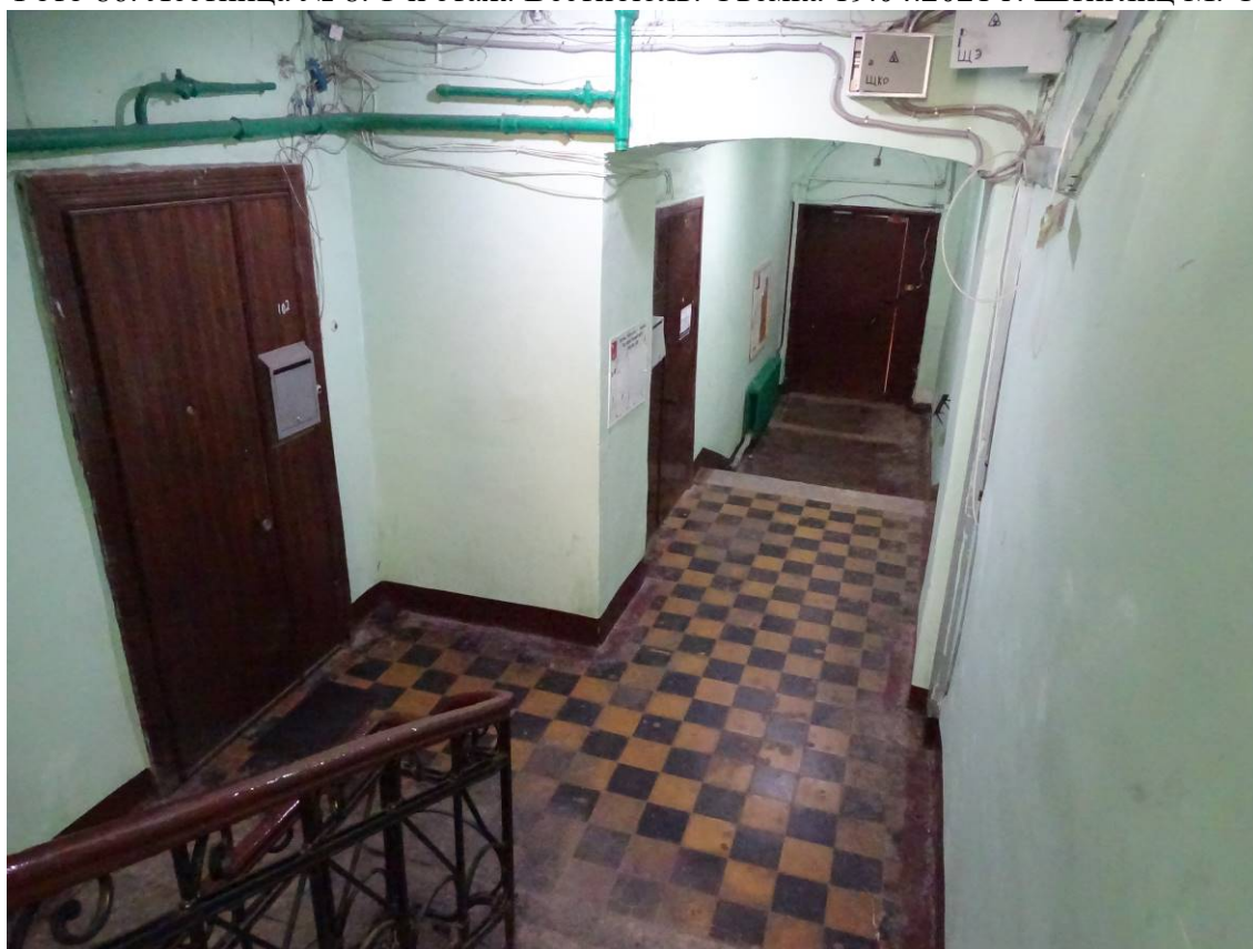
Фото 87. Лестница № 8. 1-й этаж. Вестибюль. Съемка 19.04.2021 г. Штиглиц М. С.
