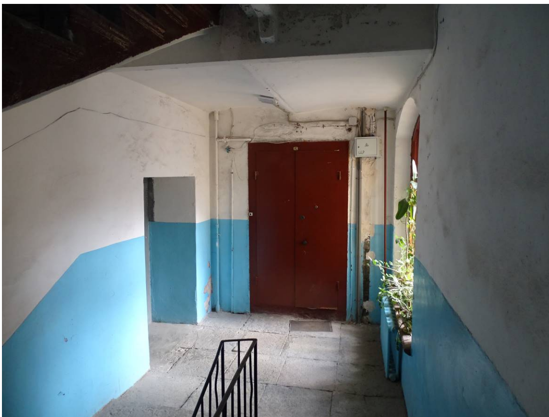
Фото 62. Лестница № 7. 4-й этаж. Съемка 19.04.2021 г. Штиглиц М. С.
