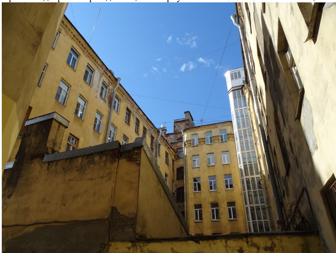
Фото 22. Здание по адресу: г. Санкт-Петербург, Большая Зеленина ул., дом 29, литера Б. Фрагмент дворового фасада. Съемка 19.04.2021 г. Штиглиц М. С.
