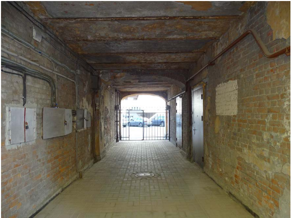
Фото 17. Здание по адресу: г. Санкт-Петербург, Большая Зеленина ул., дом 29, литера Б. Воротный проезд по фасаду ул. Петрозаводской. Съемка 19.04.2021 г. Штиглиц М. С.
