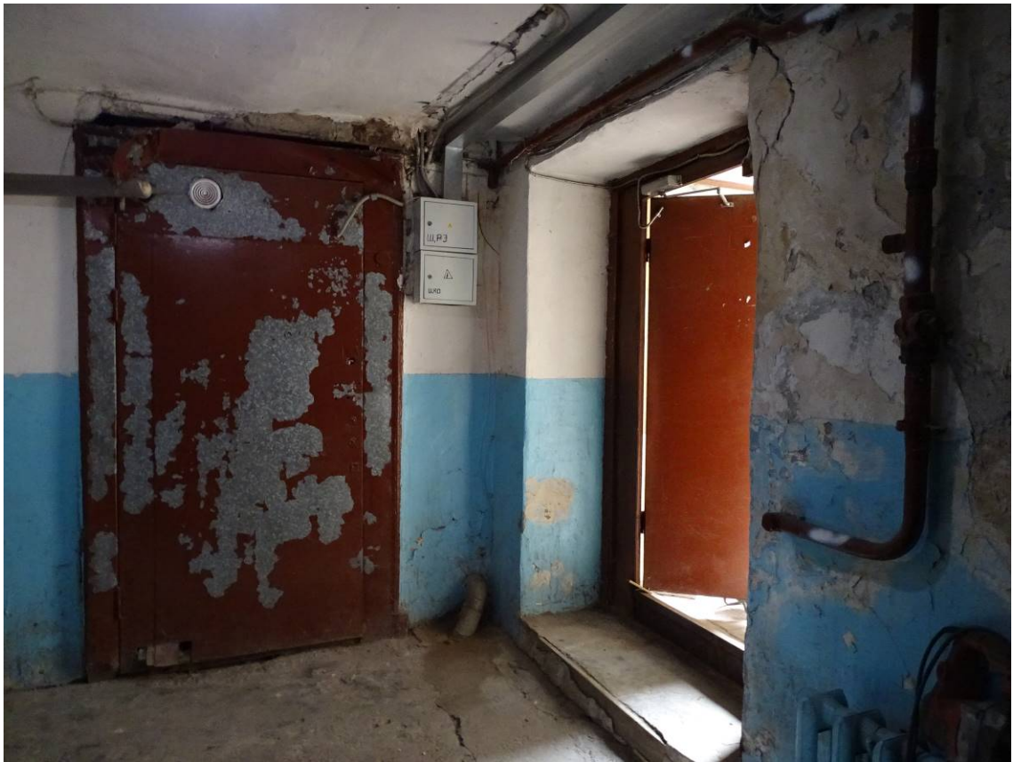
Фото 36. Лестница № 7. 1-й этаж. Съемка 19.04.2021 г. Штиглиц М. С.
