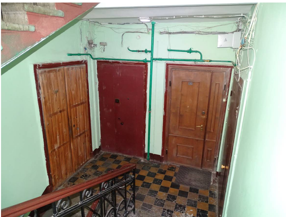
Фото 99. Лестница № 8. 3-й этаж. Съемка 19.04.2021 г. Штиглиц М. С.
