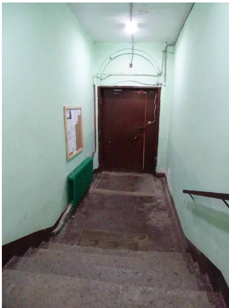
Фото 86. Лестница № 8. 1-й этаж. Вестибюль. Съемка 19.04.2021 г. Штиглиц М. С.
