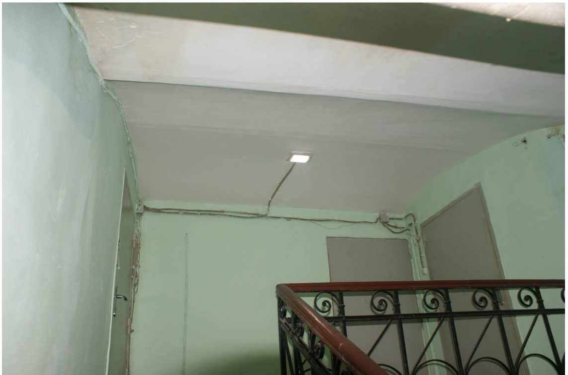
Фото 115. Лестница № 8. Чердачный этаж. Своды. Съемка 19.04.2021 г. Штиглиц М. С.
