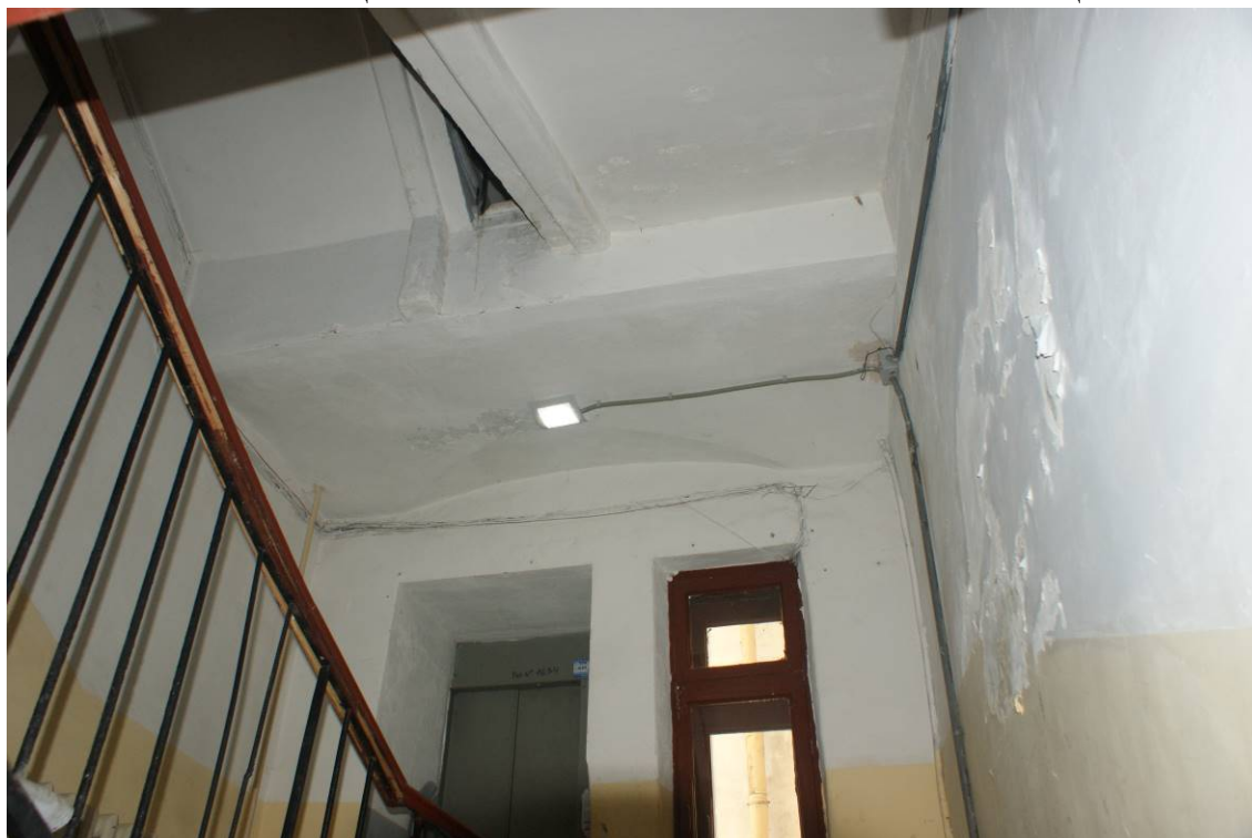
Фото 12. Лестница № 6. Площадка между 1-м и 2-м этажом. Съемка 19.04.2021 г. Штиглиц М. С.
