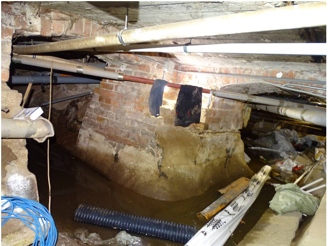
Фото 42. Лестница № 7. Подвал. Съемка 19.04.2021 г. Штиглиц М. С.
