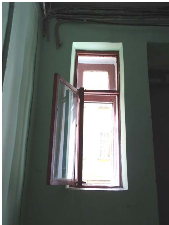
Фото 93. Лестница № 8. Площадка между 1-м и 2-м этажом. Съемка 19.04.2021 г. Штиглиц М. С.
