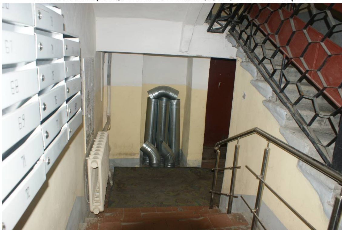
Фото 2. Лестница № 6. 1-й этаж. Съемка 19.04.2021 г. Штиглиц М. С.
