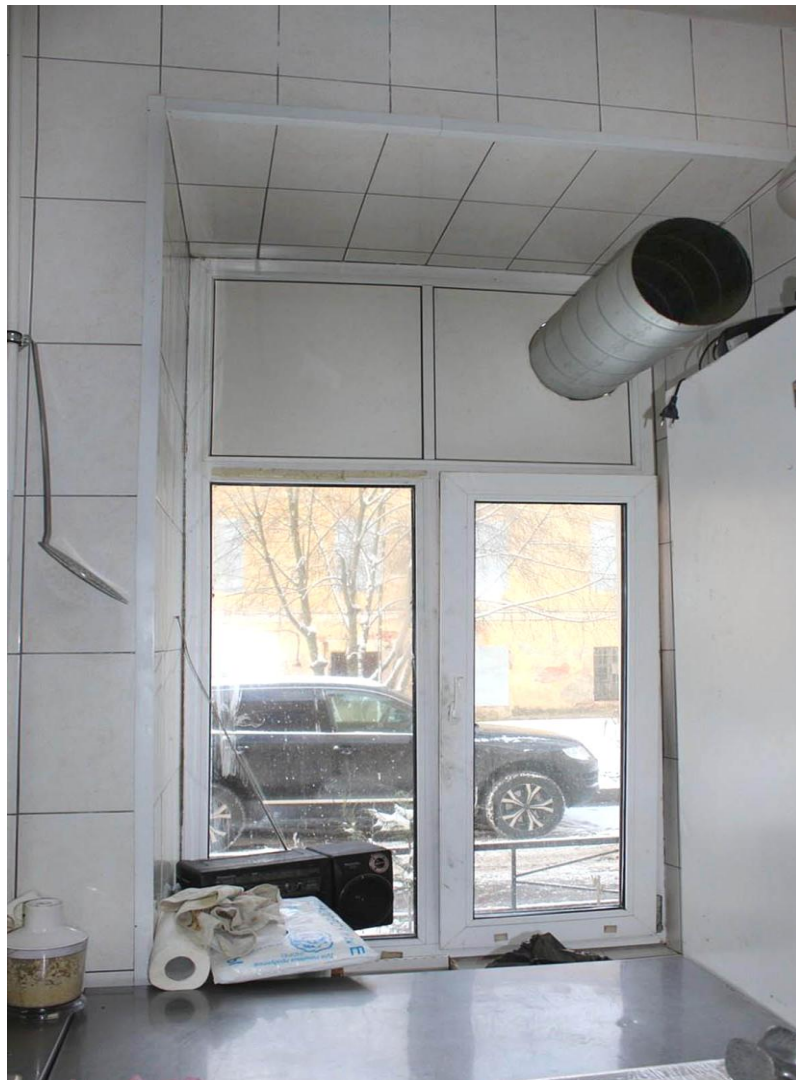
Фото.8. Кронштадт, Коммунистическая ул., д. 3 лит. А. Оконный проем в пом. 3-Н(3) с поздним заполнением.
