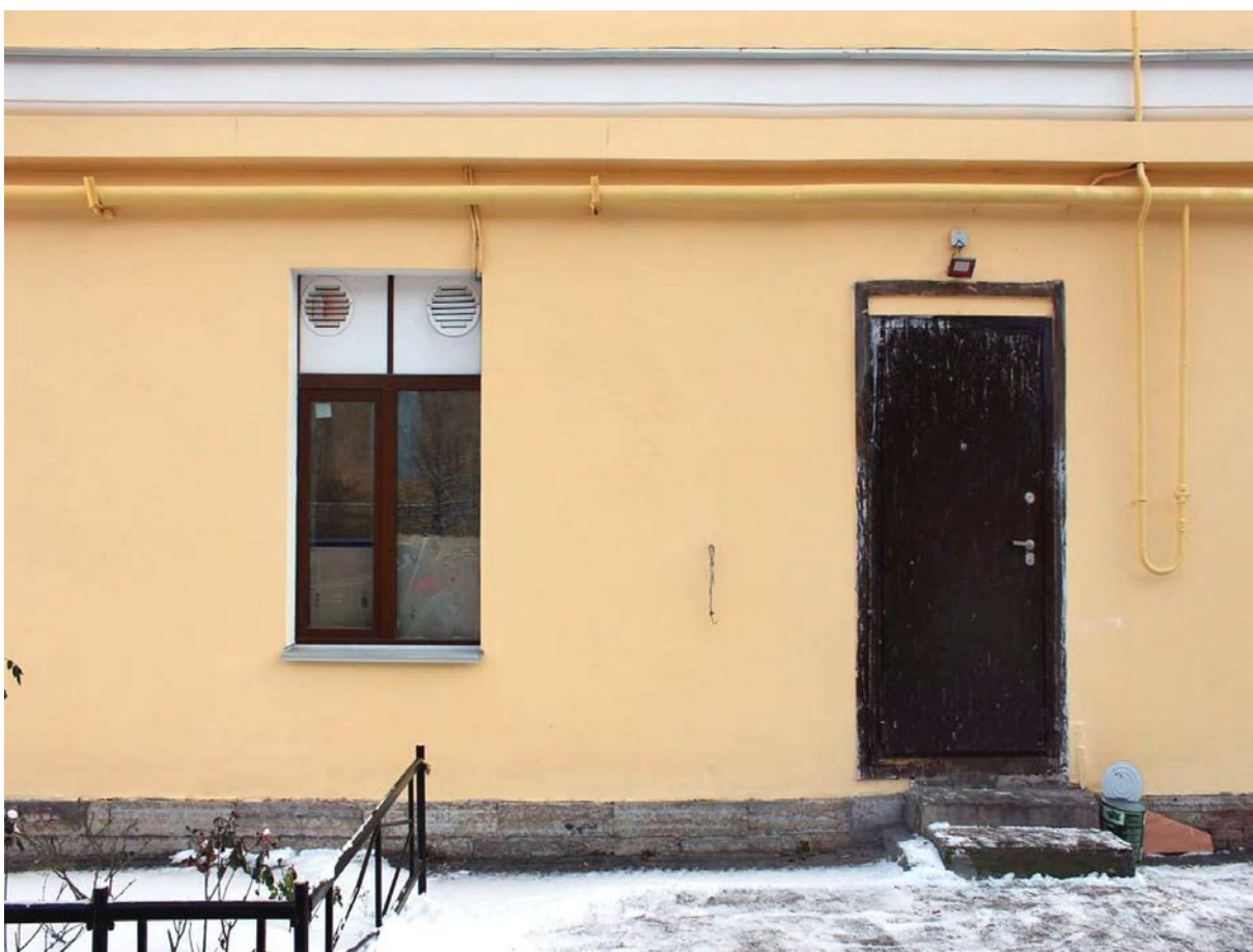
Фото.3. Кронштадт, Коммунистическая ул., д. 3 лит. А. Дворовый фасад. Фрагмент, – поздний дверной проем, устроенный вместо оконного.
