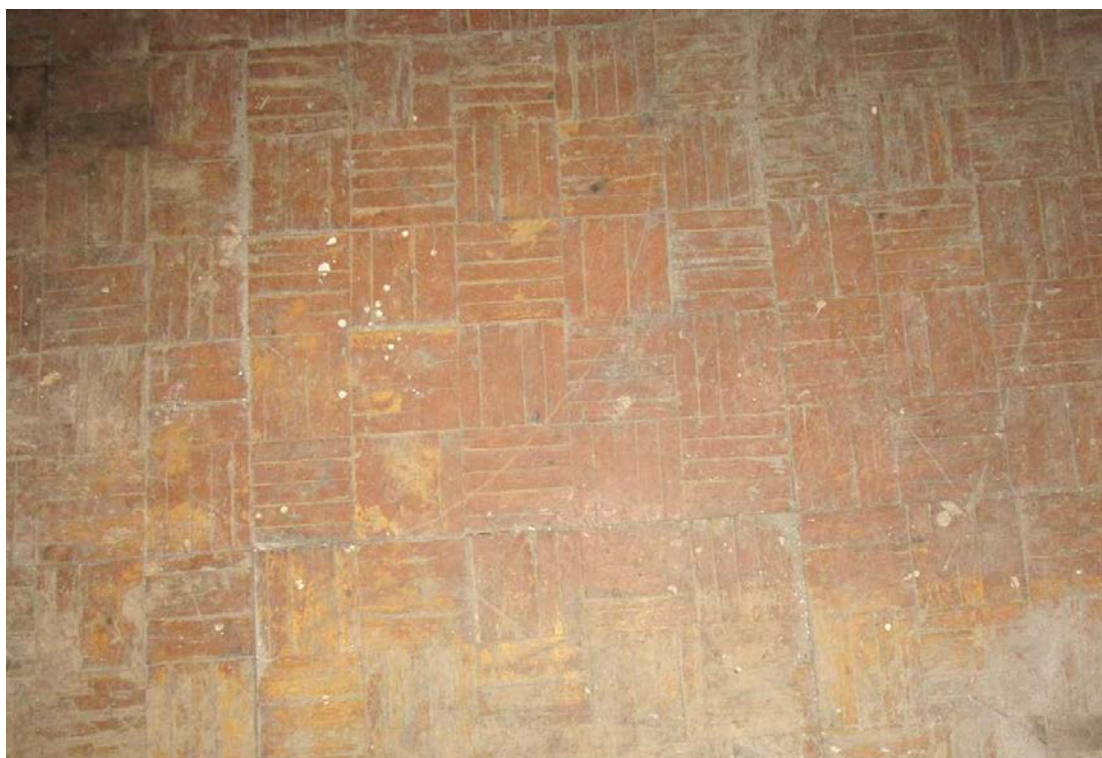
Фото.9. Кронштадт, Коммунистическая ул., д. 3 лит.А. Покрытие пола в помещении 3-Н(7).
