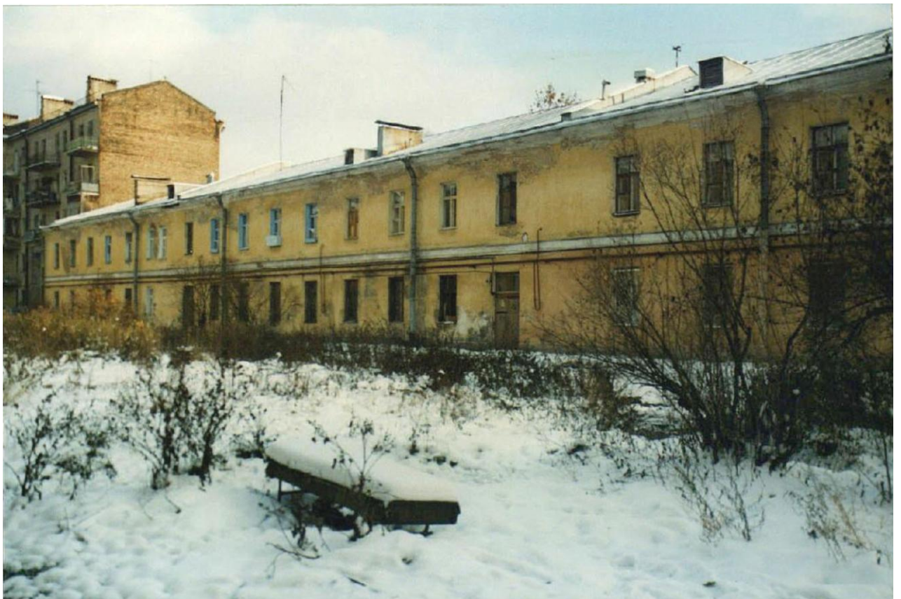
Илл. 20. Служебный корпус казарм. Общий вид западного фасада. Фотография 2002 г. – Архив КГИОП.
