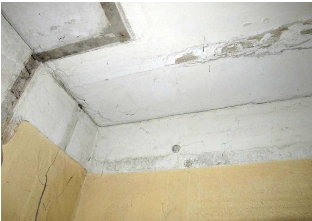
Фото.5. Кронштадт, Коммунистическая ул., д. 3 лит. А. Часть перекрытия над помещением 3-Н(3)
