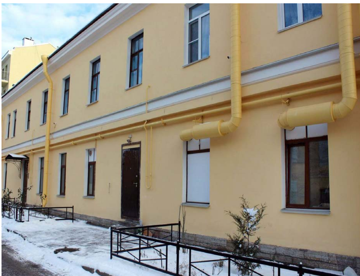
Фото.2. Кронштадт, Коммунистическая ул., д. 3 лит. А. Дворовый фасад. Вид с запада.
