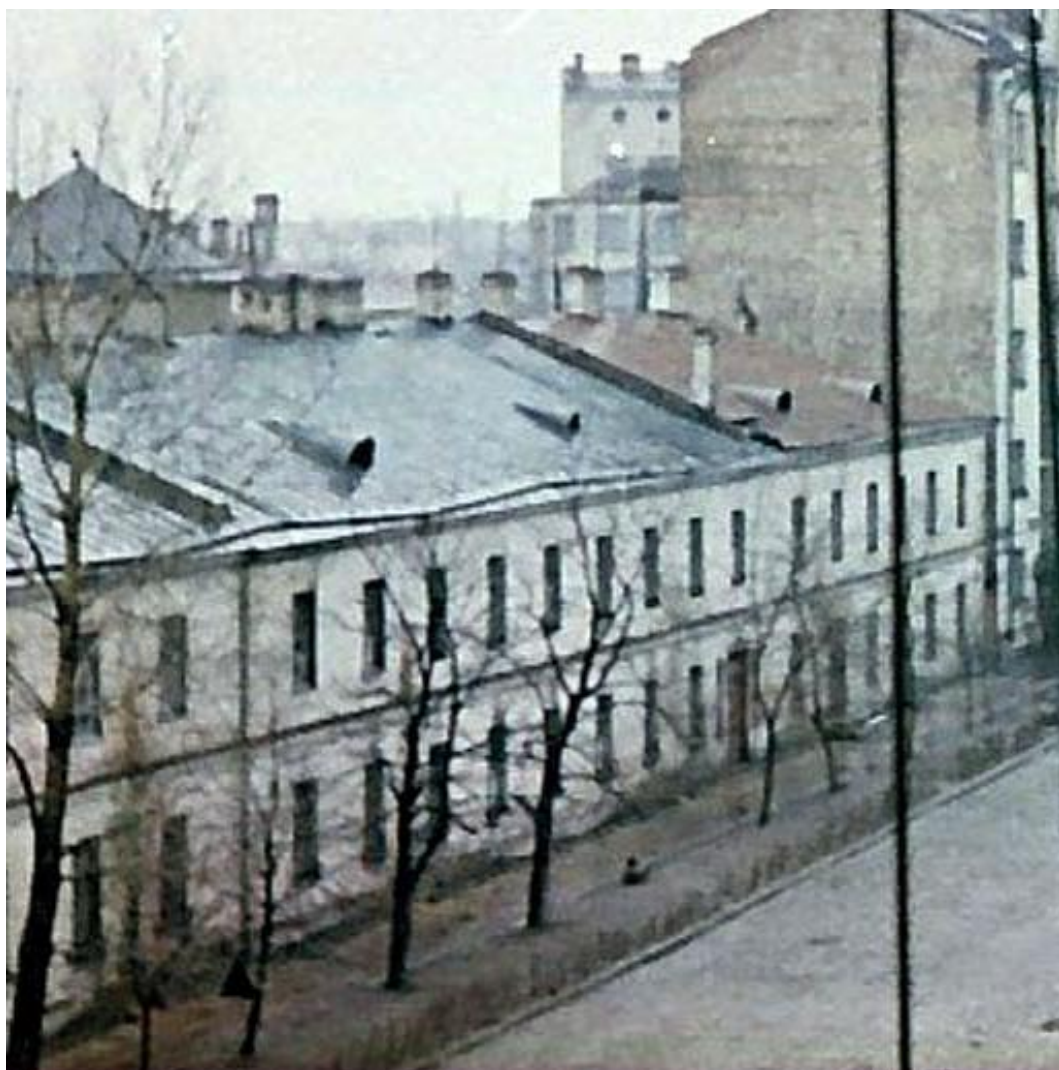
Илл. 18. «Коммунистическая ул. на север», д. 3 и 5. Фотография середины 1960-х гг. (внизу – увеличенный фрагмент, часть здания с пом. 3-Н в 1-м этаже)
