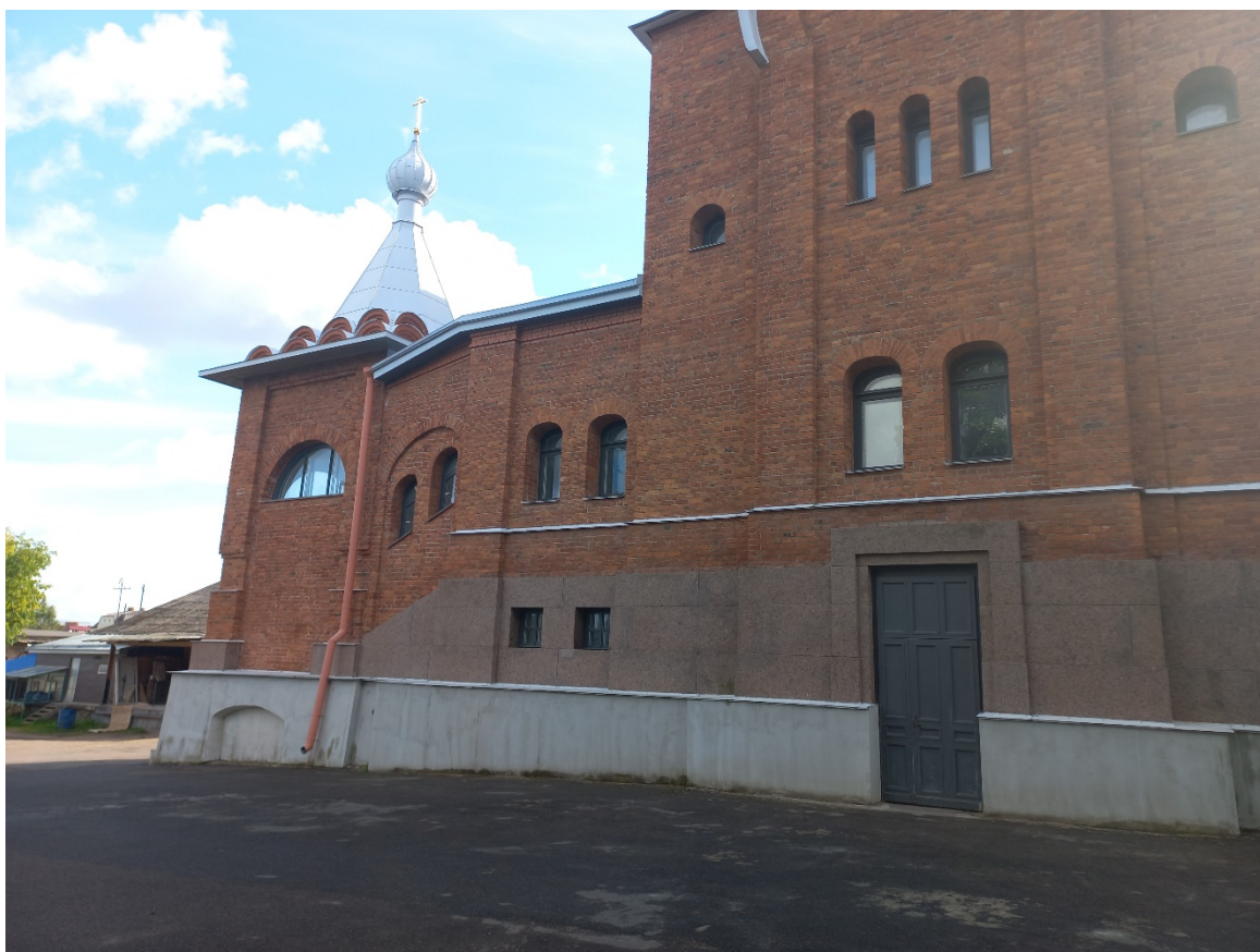
Фото 5. Фрагмент западного фасада. Вид на северо-западный придел
