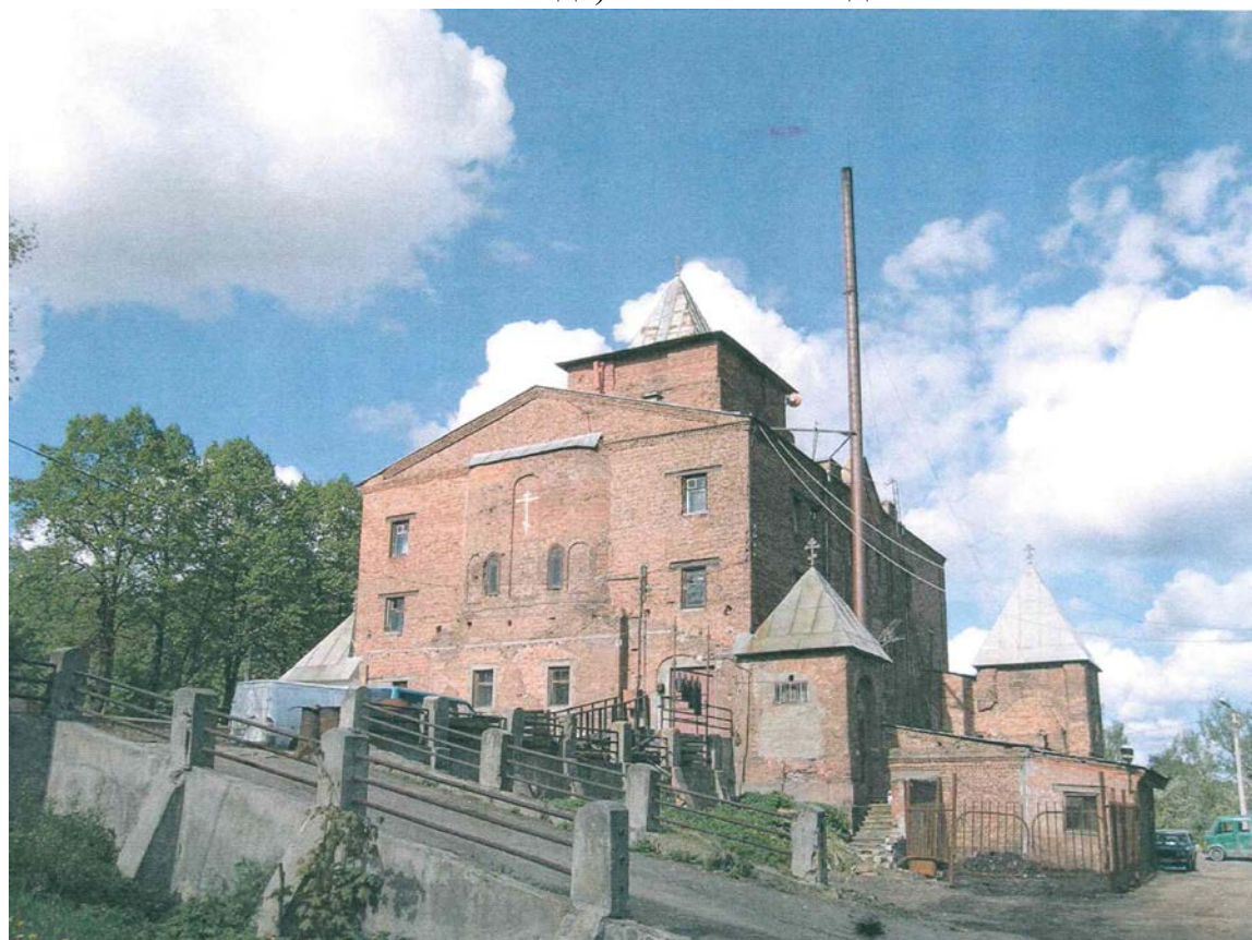
Илл. 14. Общий вид храма св. Серафима Саровского до начала реставрации (вид с северо-востока). Фото 2012 года
