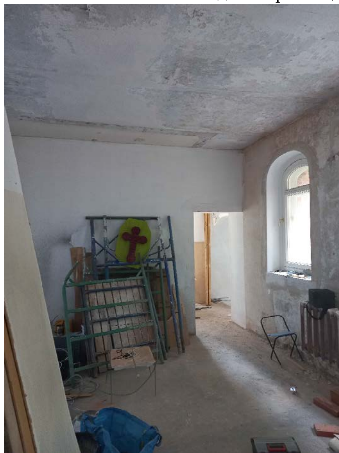
Фото 14. Помещение при молельном зале. Вид с запада
