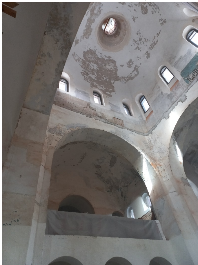
Фото 16. Центральная часть южного фасада. Вид с юго-востока
