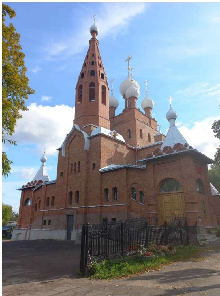
Фото 3. Общий вид с юго-запада
