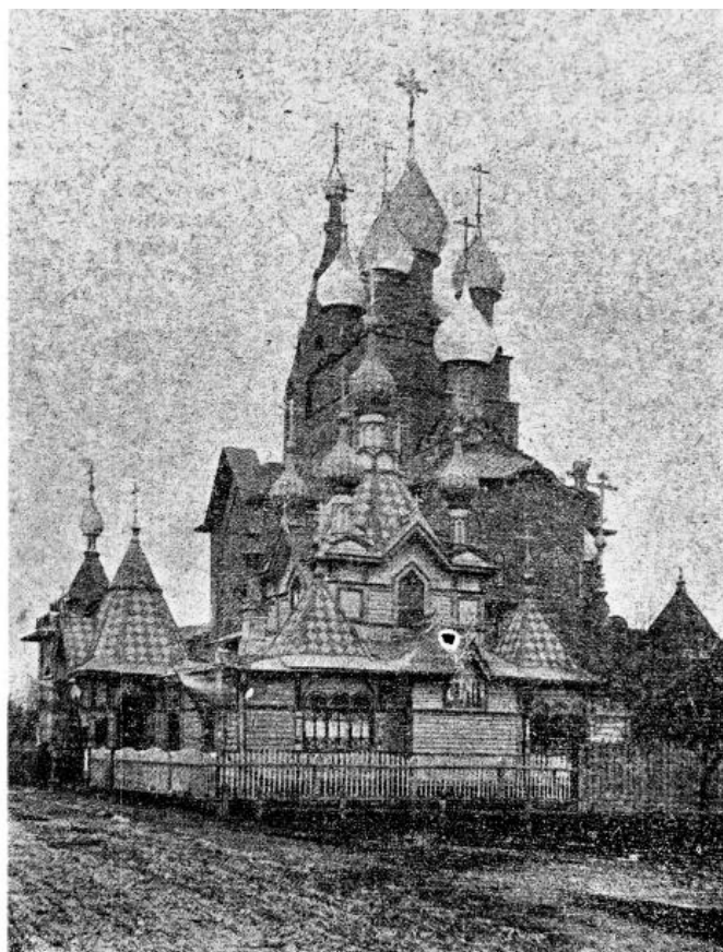
Церковь во имя преподобного Серафима Саровского при подворье Дивеевского монастыря в Старомъ Петергофѣ, освященная 6-го Октября.
