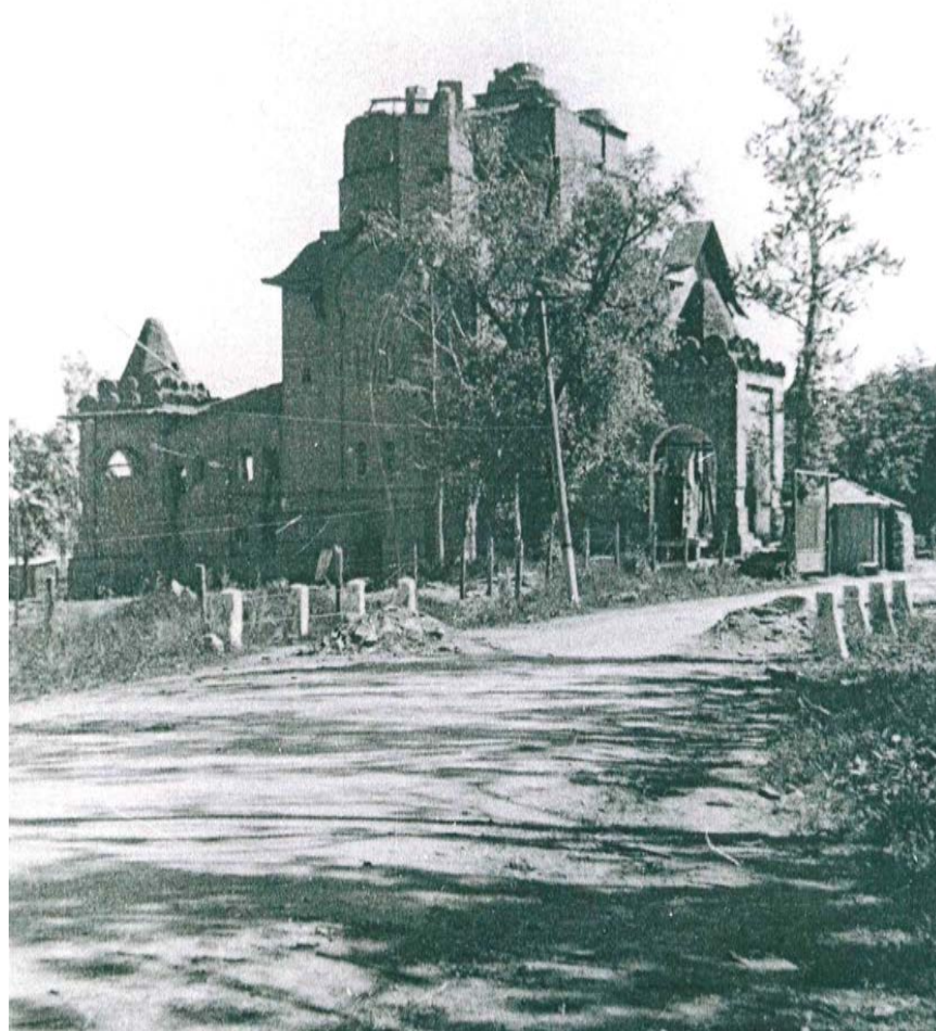
Илл. 12. Общий вид храма св. Серафима Саровского после разрушений 1941-1944 гг. // ЦГА КФФД СПб, инв. № Ар 61750
