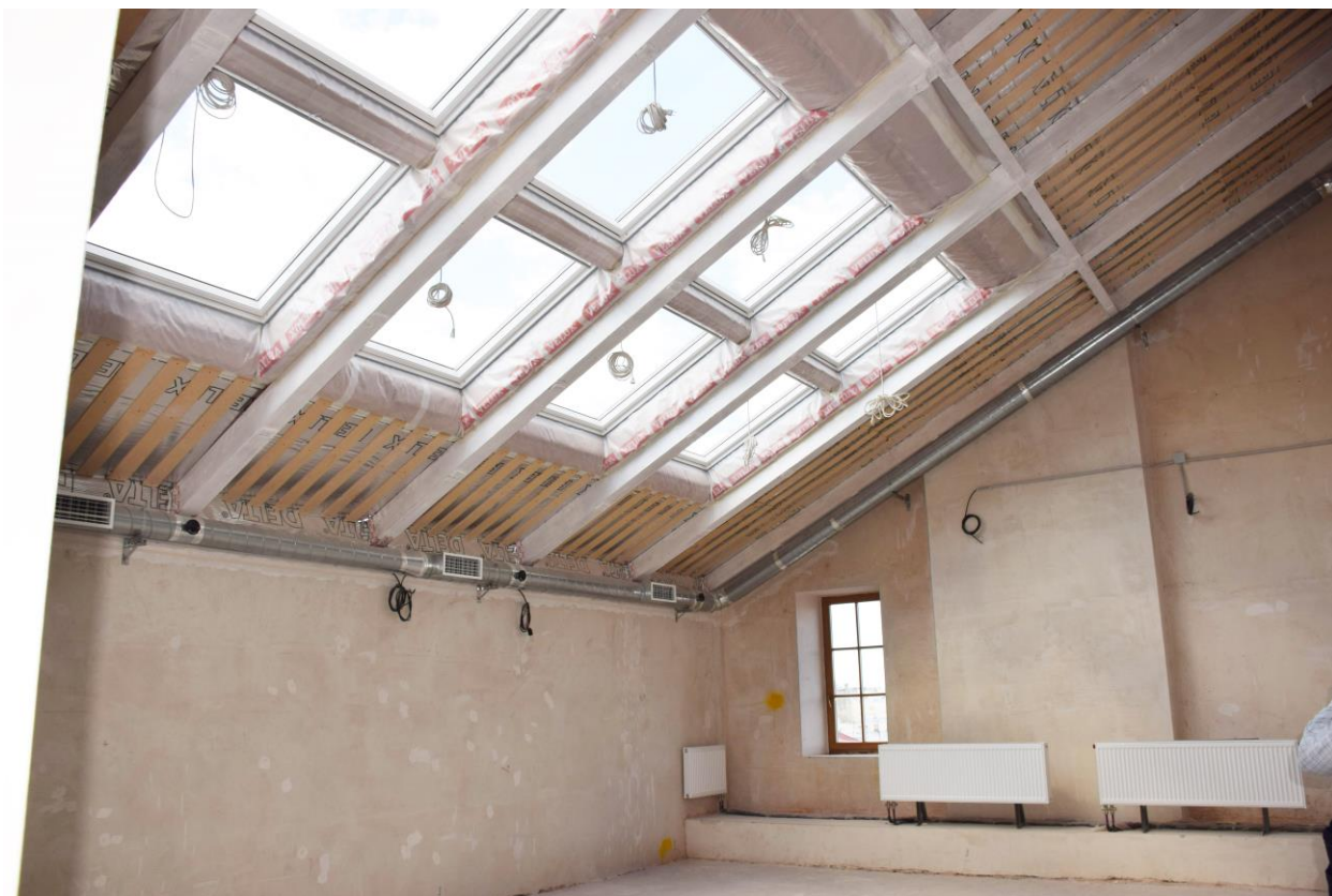
28. Доходный дом Н.В.Спиридонова. Помещения пятого этажа (кровельное остекление со стороны Фурштатской ул.).
