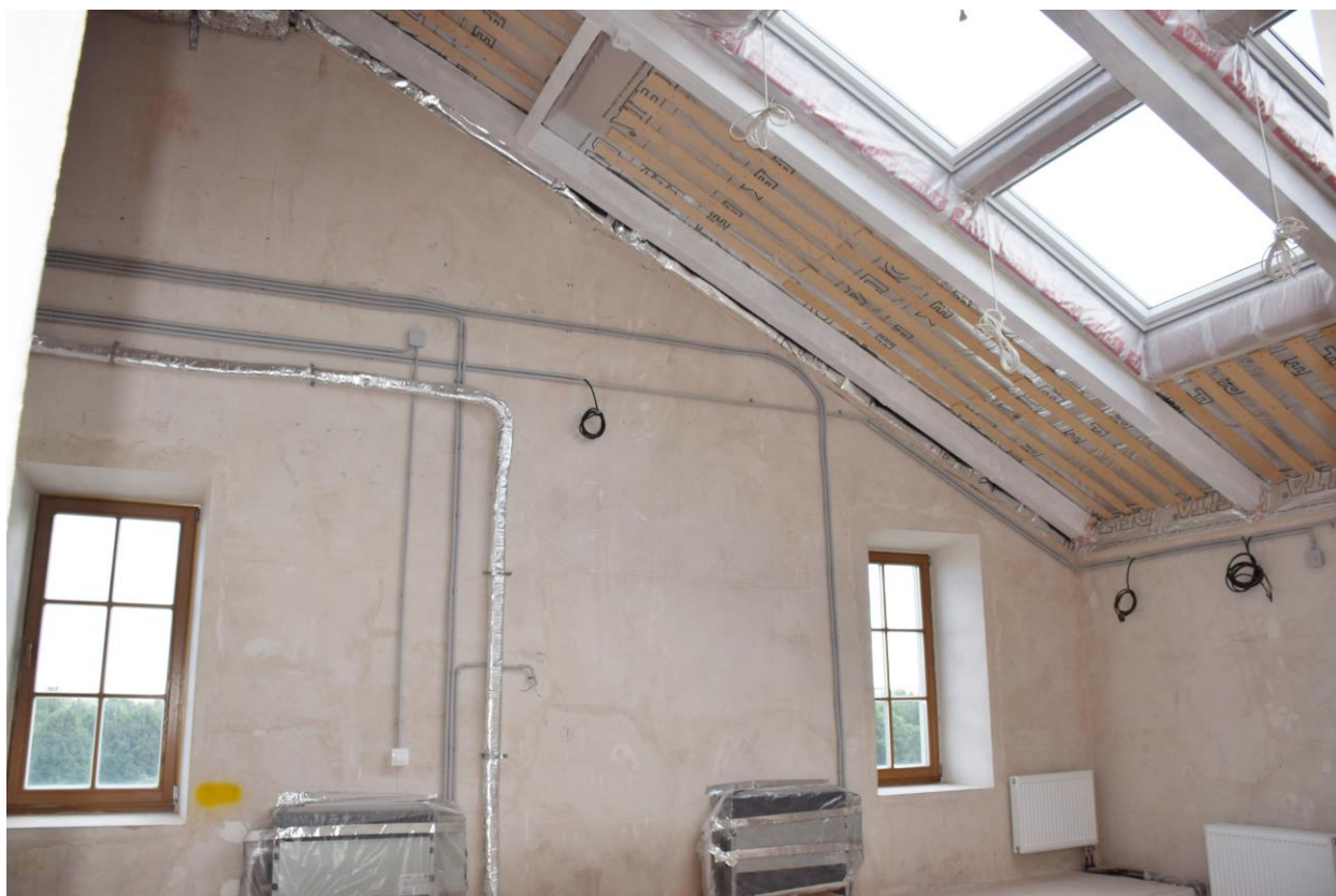
29. Доходный дом Н.В.Спиридонова. Помещения пятого этажа. Кровельное остекление со стороны Фурштатской ул., окна в сторону Потемкинской ул.).
