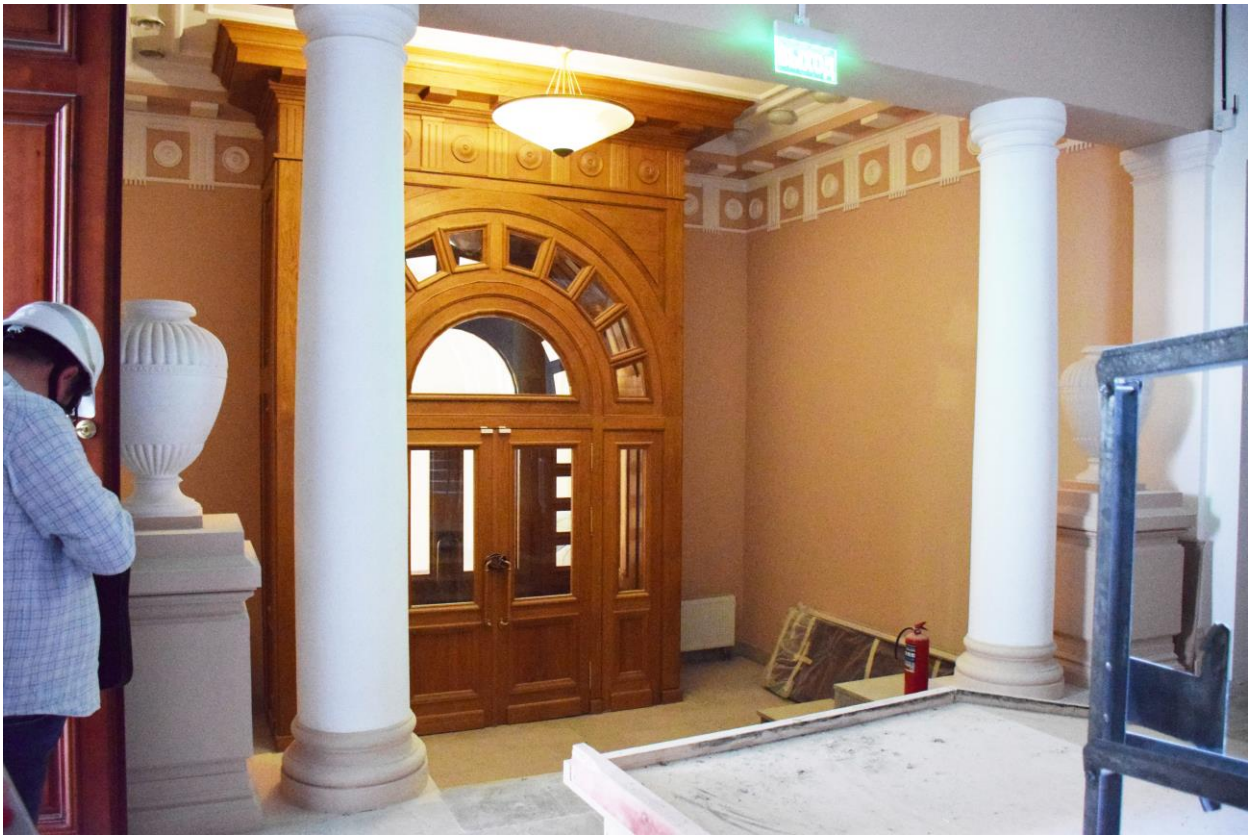
13. Доходный дом Н.В.Спиридонова. Помещения первого этажа с элементами предмета охраны.
