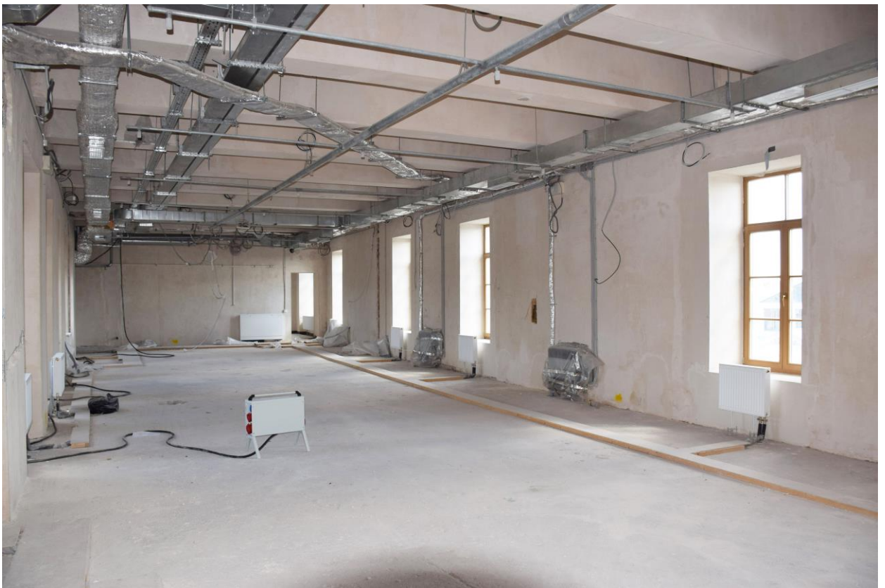
31. Доходный дом Н.В.Спиридонова. Помещения пятого этажа.
