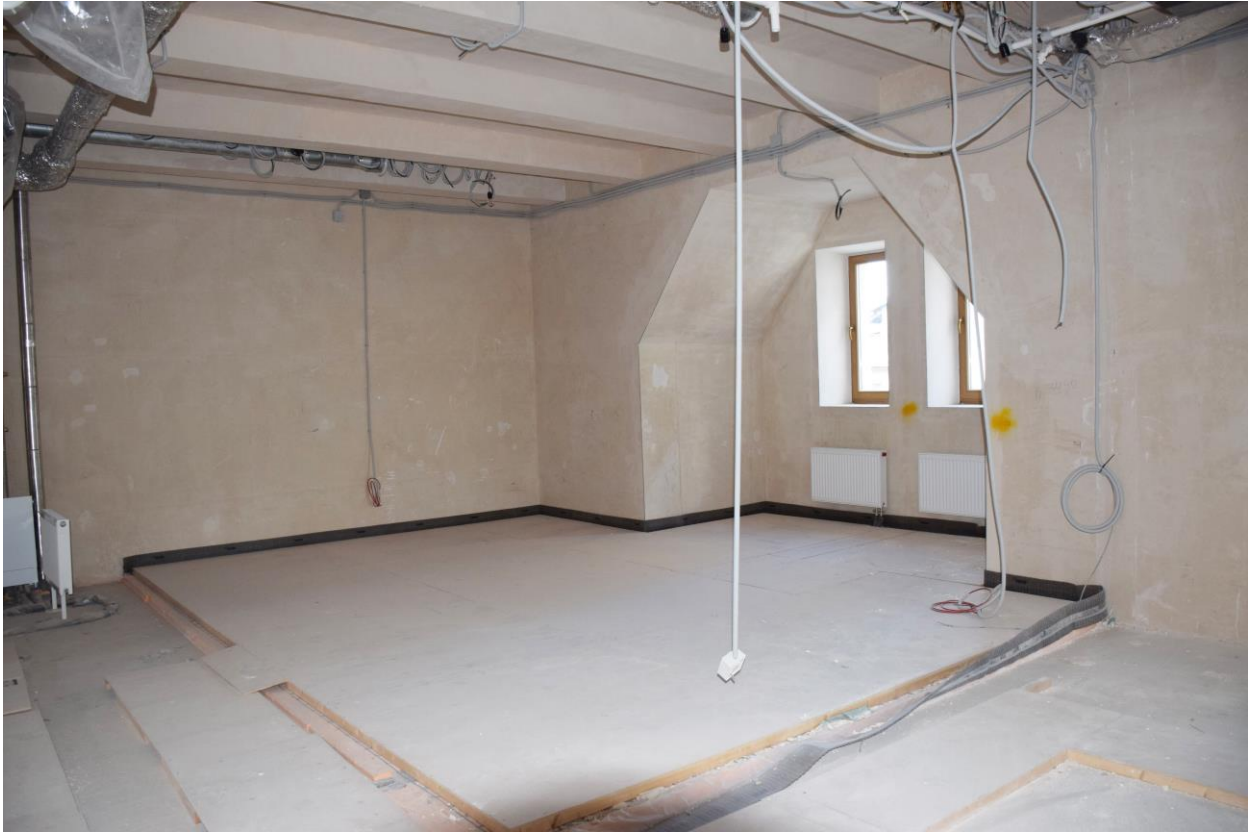
30. Доходный дом Н.В.Спиридонова. Помещения пятого этажа.
