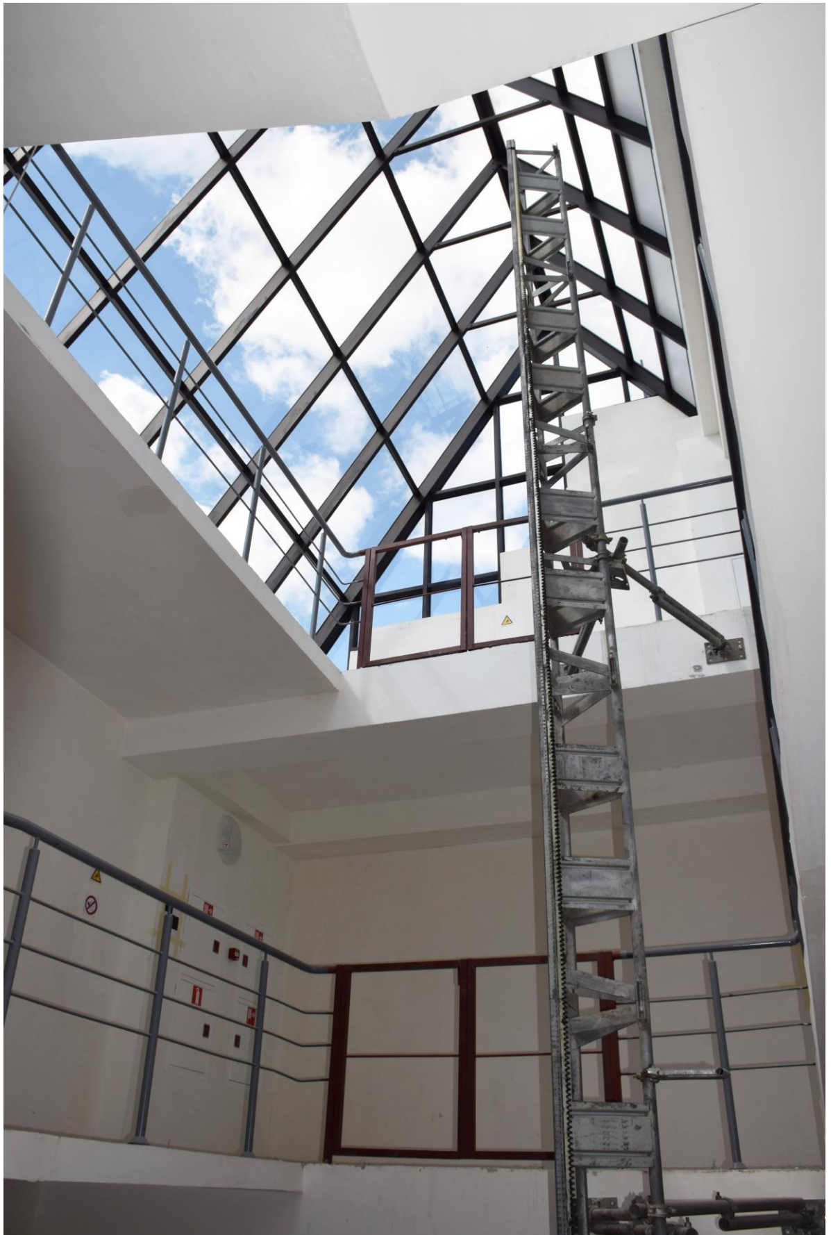
32. Доходный дом Н.В.Спиридонова. Помещения шестого этажа. Главная лестница, световой фонарь.
