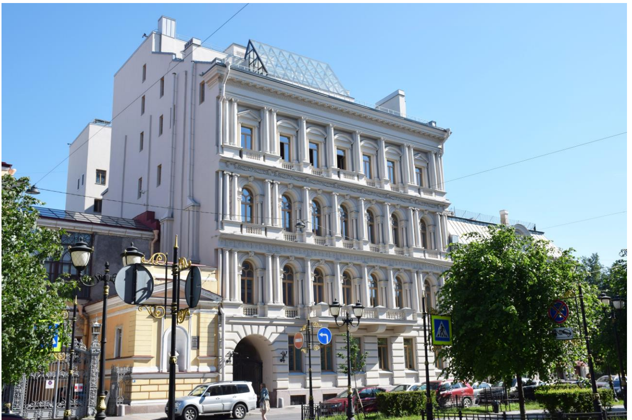
2. Доходный дом Н.В.Спиридонова (Фурштатская ул., 60). Главный фасад по Фурштатской ул.
