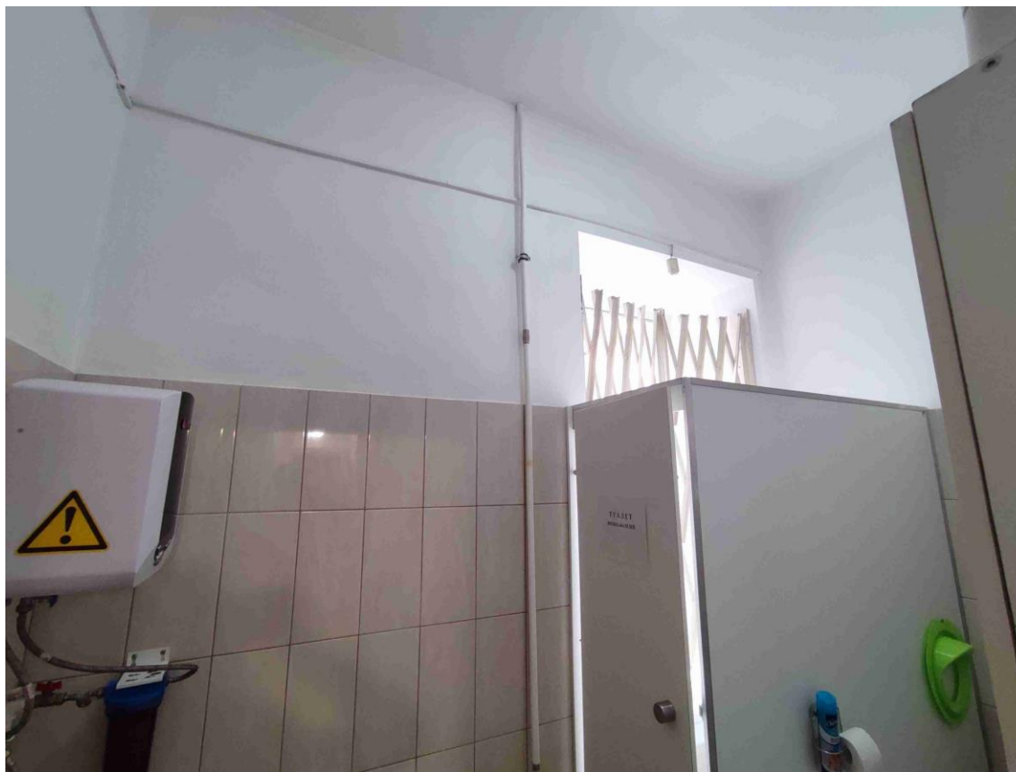
25. Общий вид. пом. № 5-Н (22) в уровне 1-го этажа.
