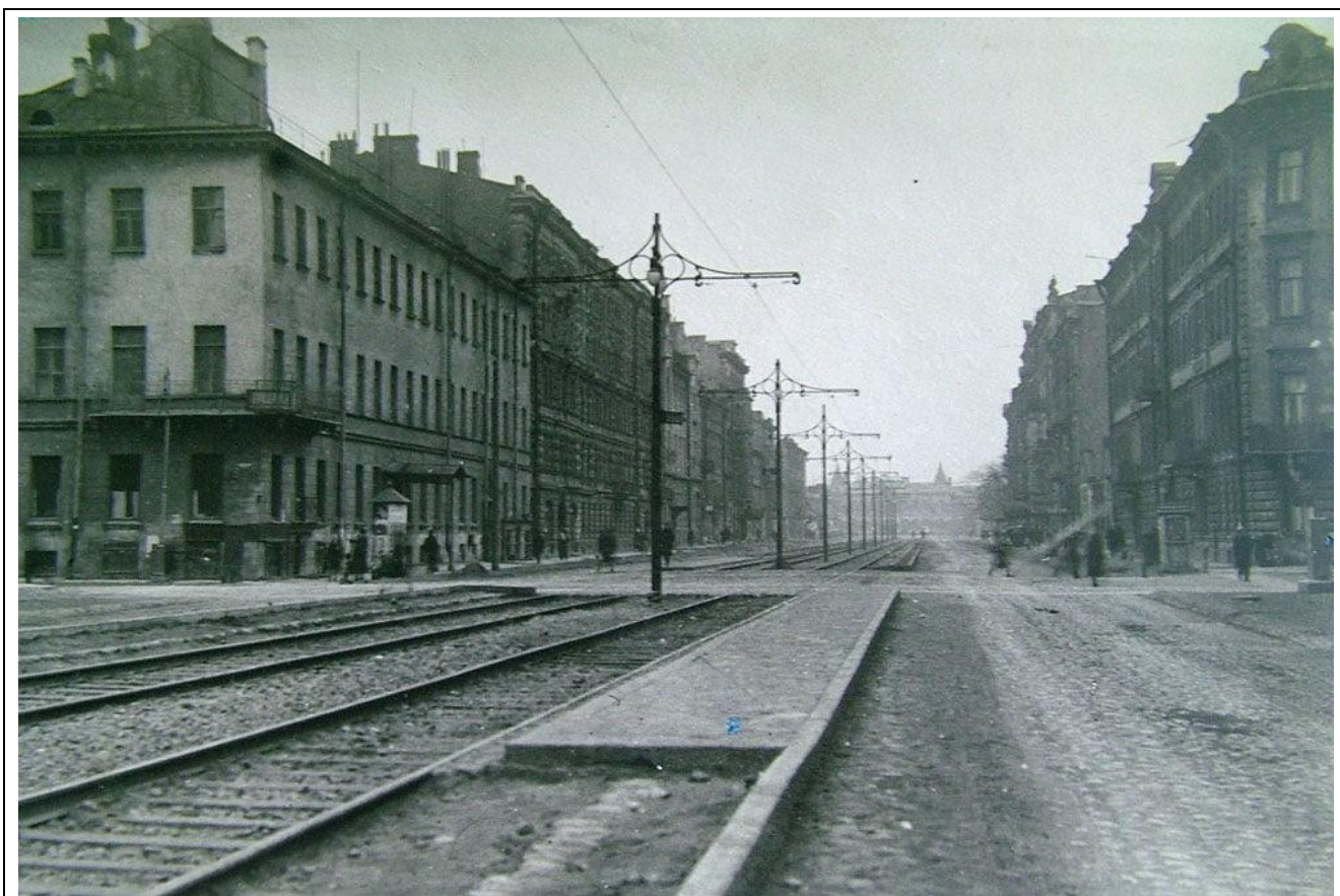
5. Ул. Марата. Новая линия на открытом полотне в окончанном виде. Переезд у Социалистической ул. — 10/1-1930. Из архива ленинградского ГТУ. https://transphoto.org/photo/565577/
