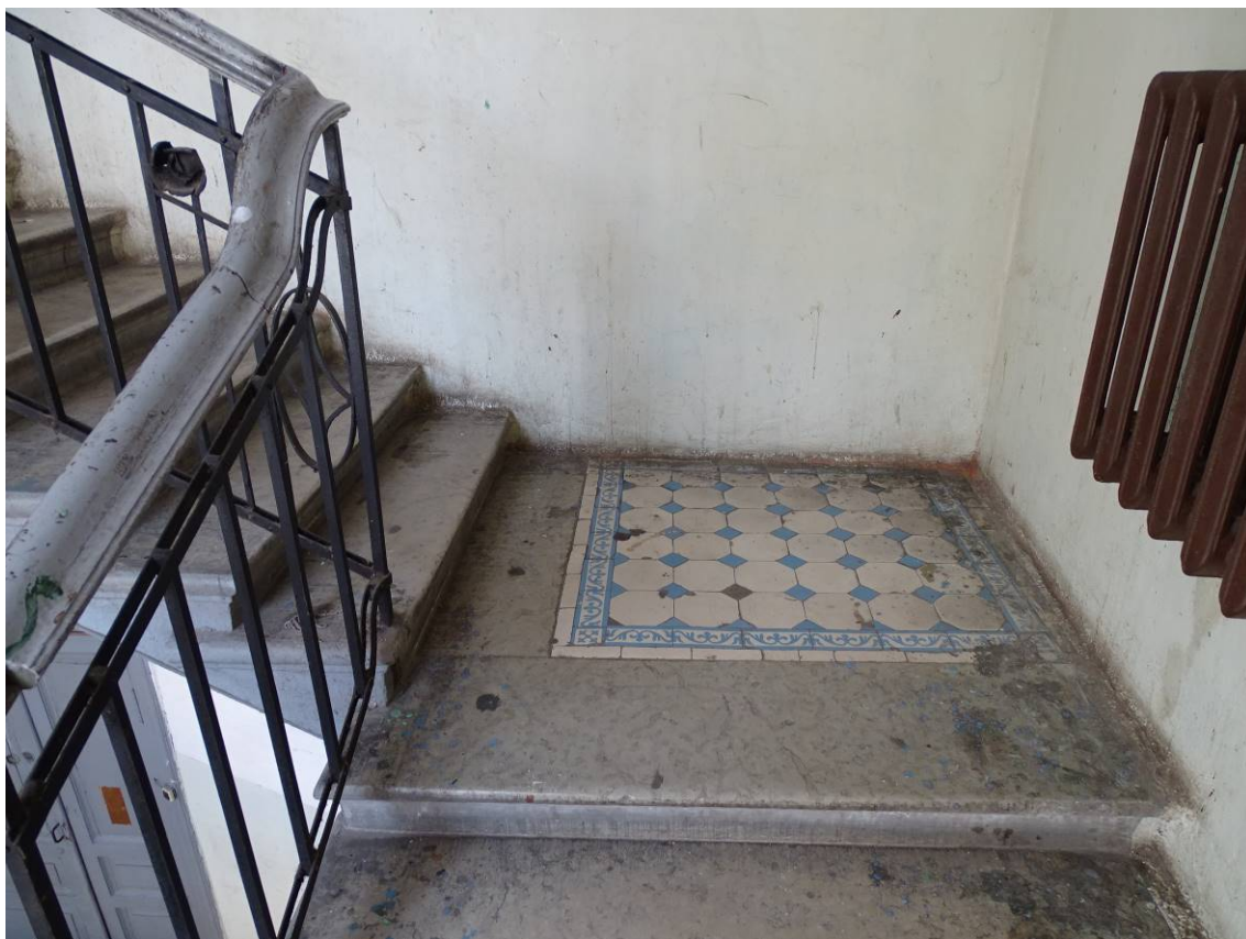
Фото 43. Лестница № 2. Площадка между 2 и 3 этажом. Метлахская плитка. Съемка 26.04.2021 г. Трушковский В. Э.
