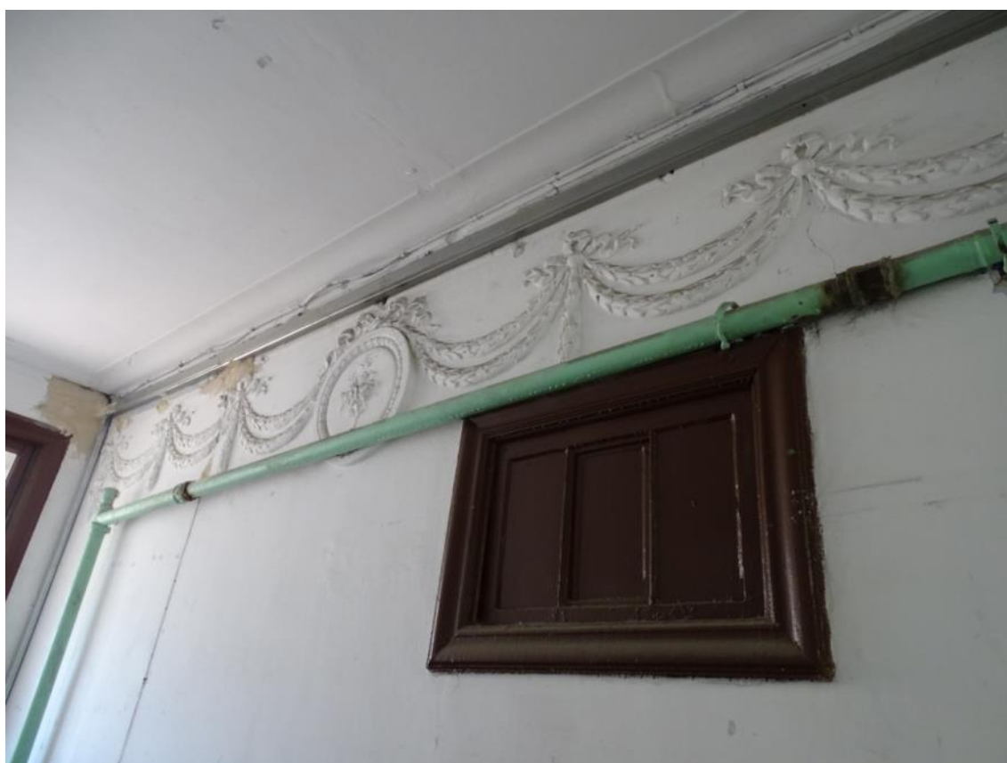
Фото 33. Лестница № 2. 1 этаж. Лепные композиции из гирлянд. Съемка 26.04.2021 г. Трушковский В. Э.
