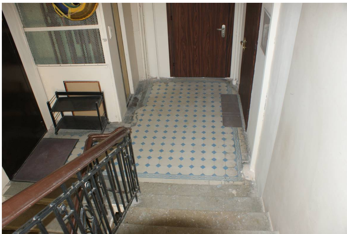
Фото 24. Лестница № 1. 5 этаж. Метлахская плитка. Съемка 26.04.2021 г. Трушковский В. Э.
