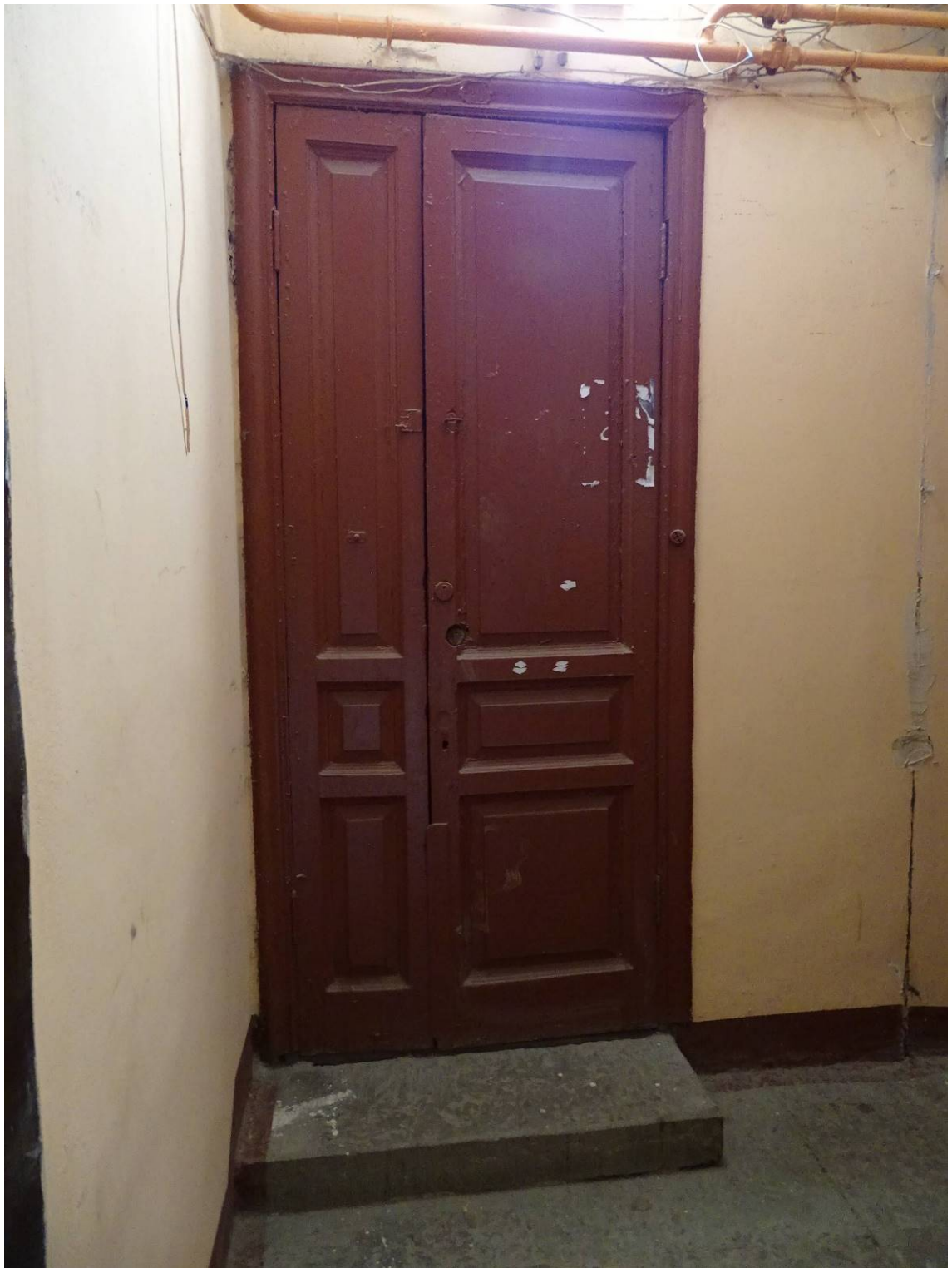
Фото 124. Лестница №6. 1 этаж. Съемка 26.04.2021 г. Трушковский В.Э
