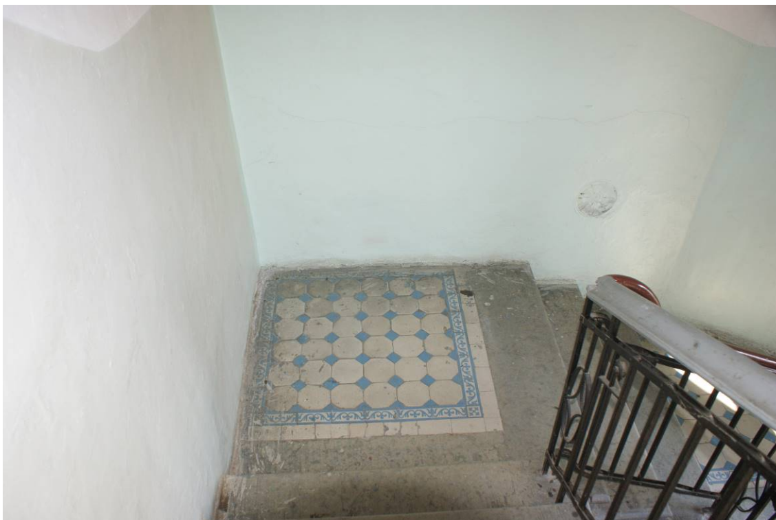
Фото 64. Лестница № 2. Площадка между 5 и 6 этажом. Метлахская плитка. Съемка 26.04.2021 г. Трушковский В. Э.
