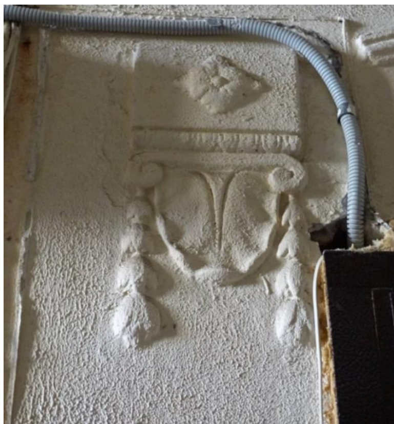
Фото 101. Лестница № 4. 2 этаж. Оформление стен лестничной клетки. Лепные композиции растительного характера. Съемка 26.04.2021 г. Трушковский В. Э.
