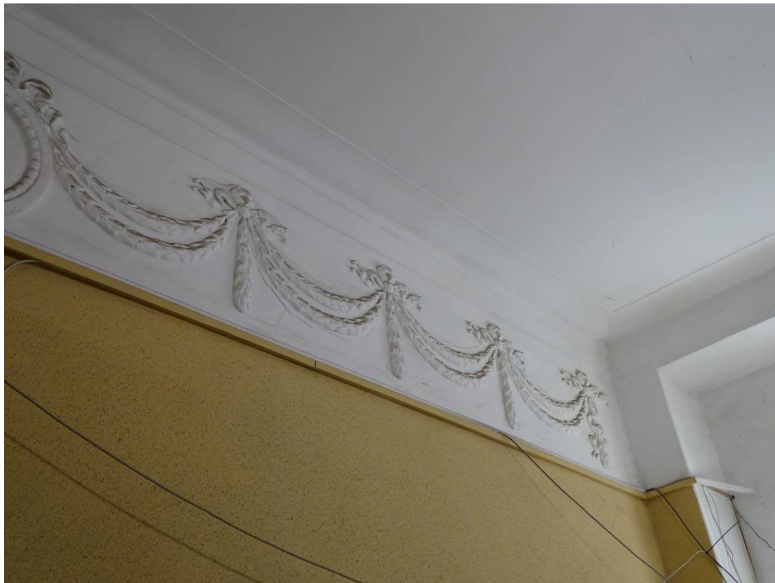
Фото 2. Лестница № 1. 1 этаж. Лепные композиции из гирлянд. Съёмка 26.04.2021 г. Трушковский В. Э.
