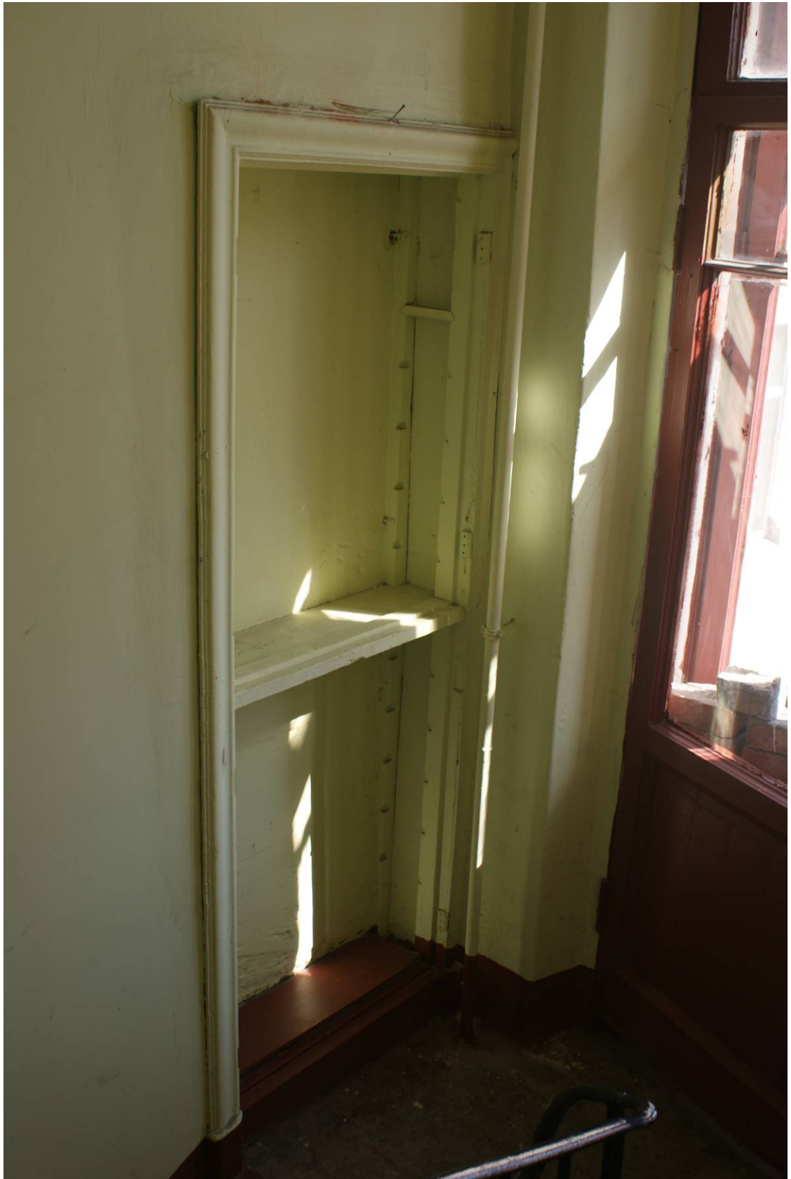
Фото 83. Лестница № 3. Площадка между 4 и 5 этажом. Ниша. Съемка 26.04.2021 г. Трушковский В. Э.
