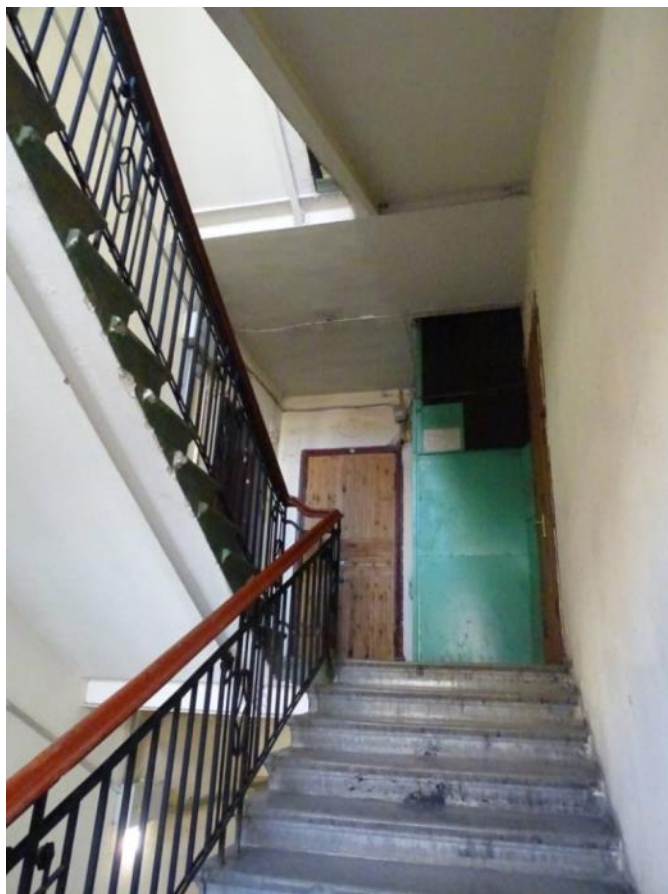
Фото 97. Лестница № 4. 2 этаж. Съемка 26.04.2021 г. Трушковский В. Э.
