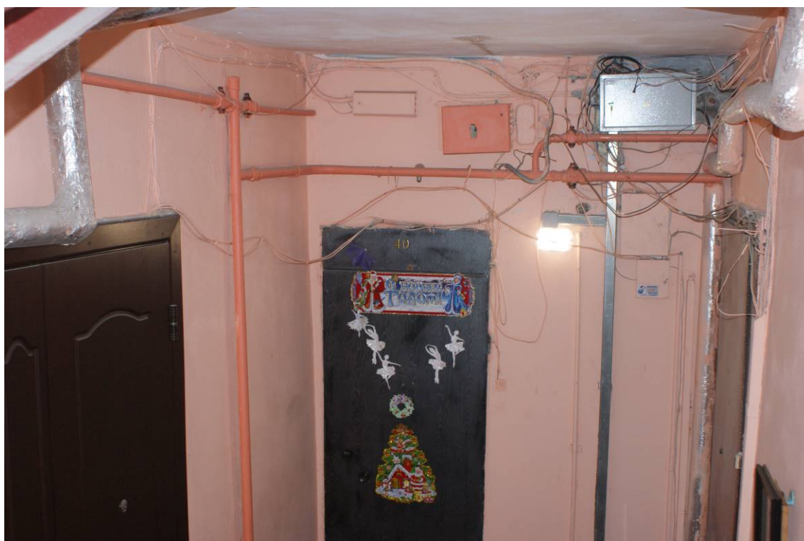
Фото 138. Лестница №6. 6 этаж. Съемка 26.04.2021 г. Трушковский В. Э.
