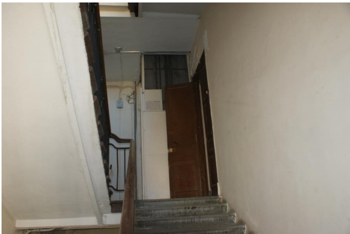
Фото 109. Лестница № 4. 5 этаж. Съемка 26.04.2021 г. Трушковский В. Э.
