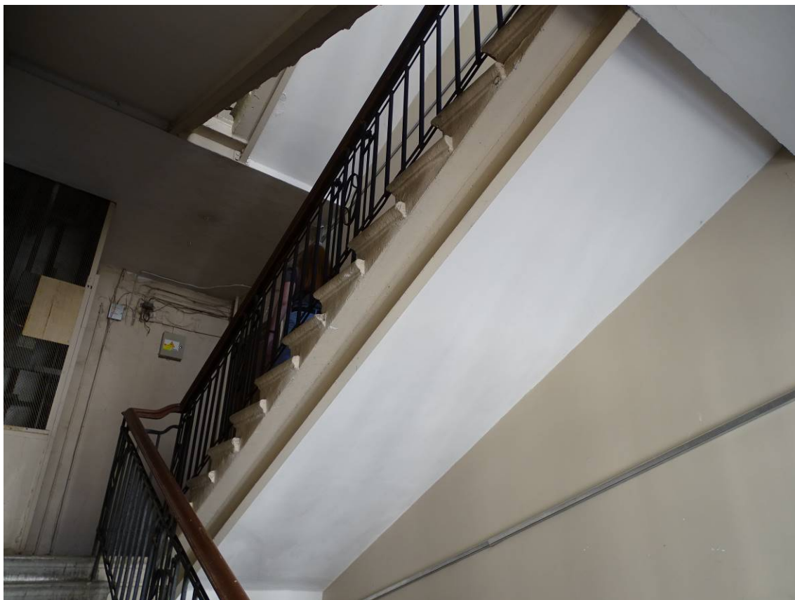
Фото 19. Лестница № 1. 4 этаж. Лестничный марш. Съемка 26.04.2021 г. Трушковский В. Э.
