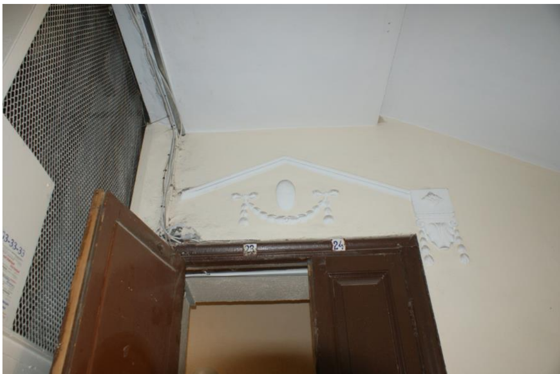
Фото 110. Лестница № 4. 5 этаж. Оформление стен лестничной клетки. Лепные композиции растительного характера. Съемка 26.04.2021 г. Трушковский В. Э.
