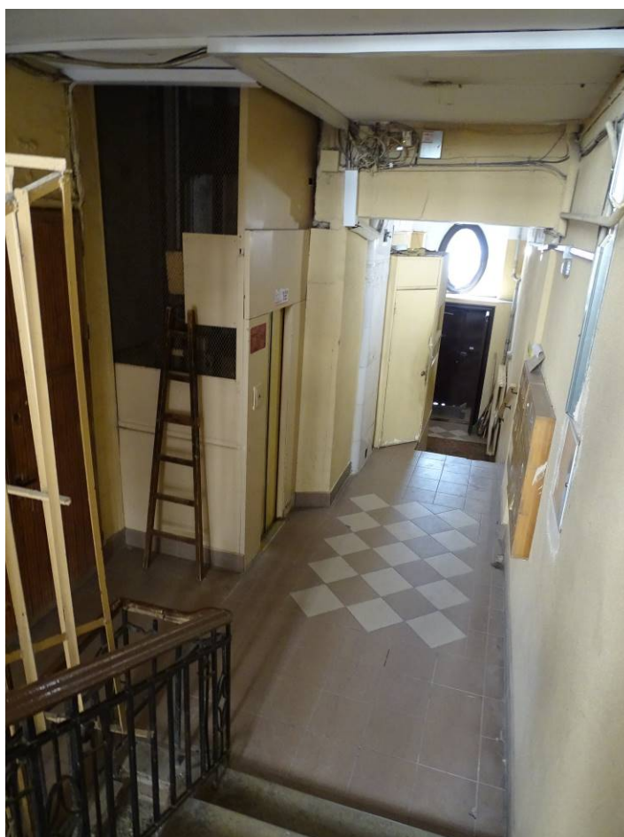
Фото 4. Лестница № 1. 1 этаж. Съемка 26.04.2021 г. Трушковский В. Э.
