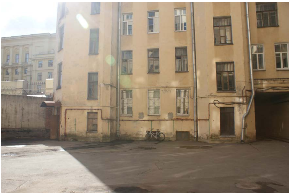
Фото 49. Фрагмент западного фасада западного внутреннего двора. 2-й, 3-й, 4-й, 5-й, 6-й этажи. Съемка 26.04.2021 г. Трушковский В.Э.
