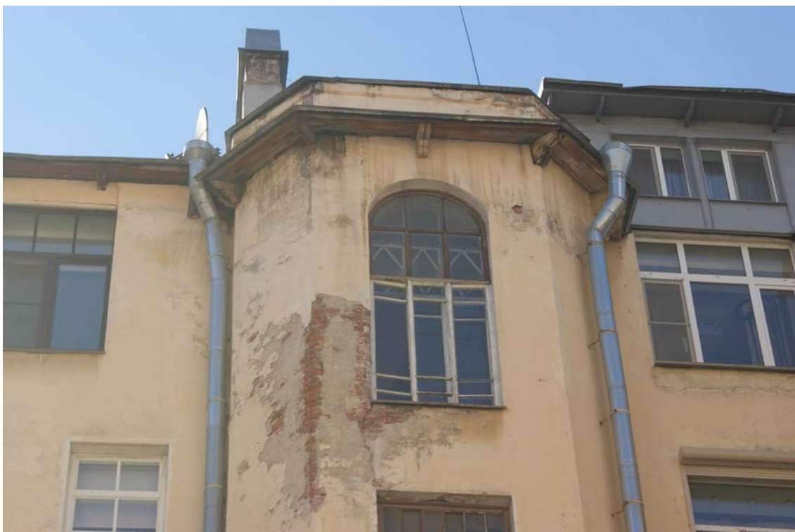
Фото 52. Фрагмент западного фасада западного внутреннего двора. Ризалит. 6-й этаж. Съемка 26.04.2021 г. Трушковский В.Э.
