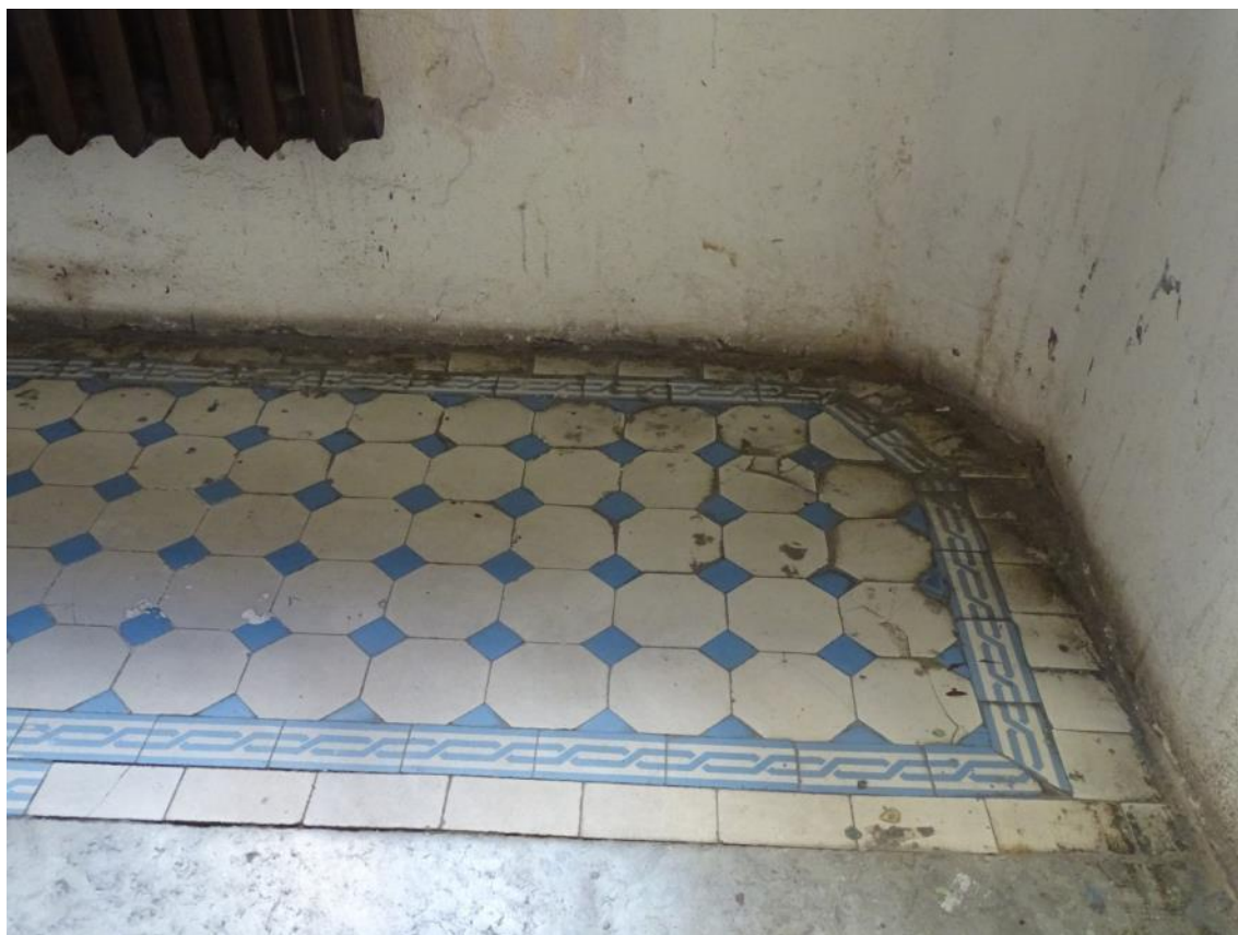
Фото 95. Лестница № 4. Площадка между 1 и 2 этажом. Метлахская плитка. Съемка 26.04.2021 г. Трушковский В. Э.
