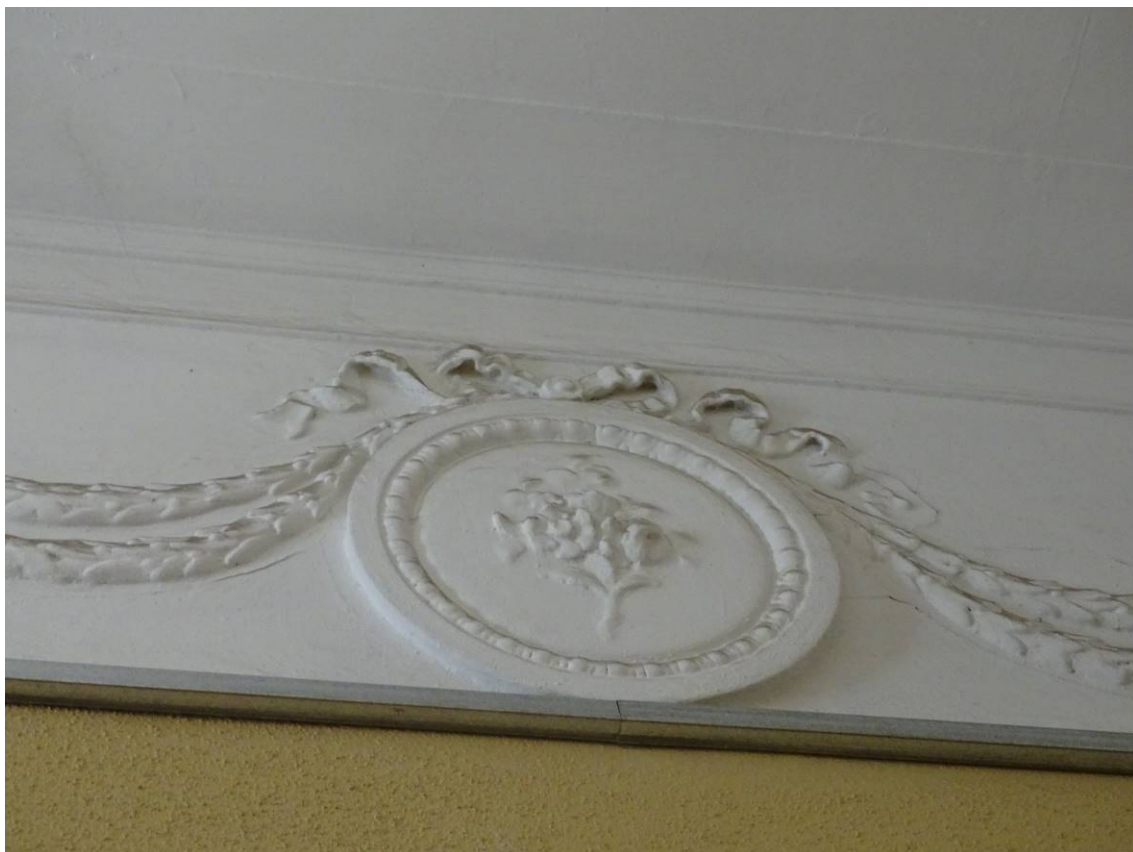
Фото 3. Лестница № 1. 1 этаж. Розетка. Съемка 26.04.2021 г. Трушковский В. Э.
