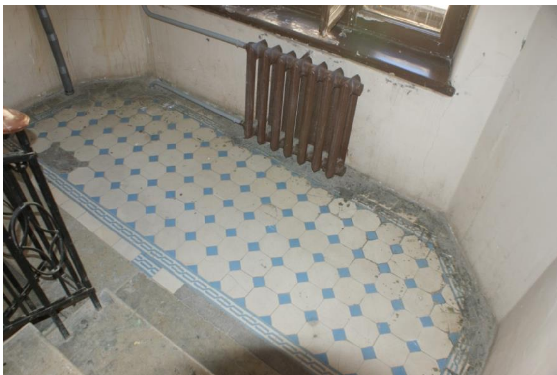
Фото 18. Лестница № 1. Площадка между 3 и 4 этажом. Метлахская плитка. Съемка 26.04.2021 г. Трушковский В. Э.
