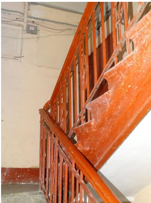
Фото 117. Лестница № 5. 1 этаж. Съемка 26.04.2021 г. Трушковский В. Э.
