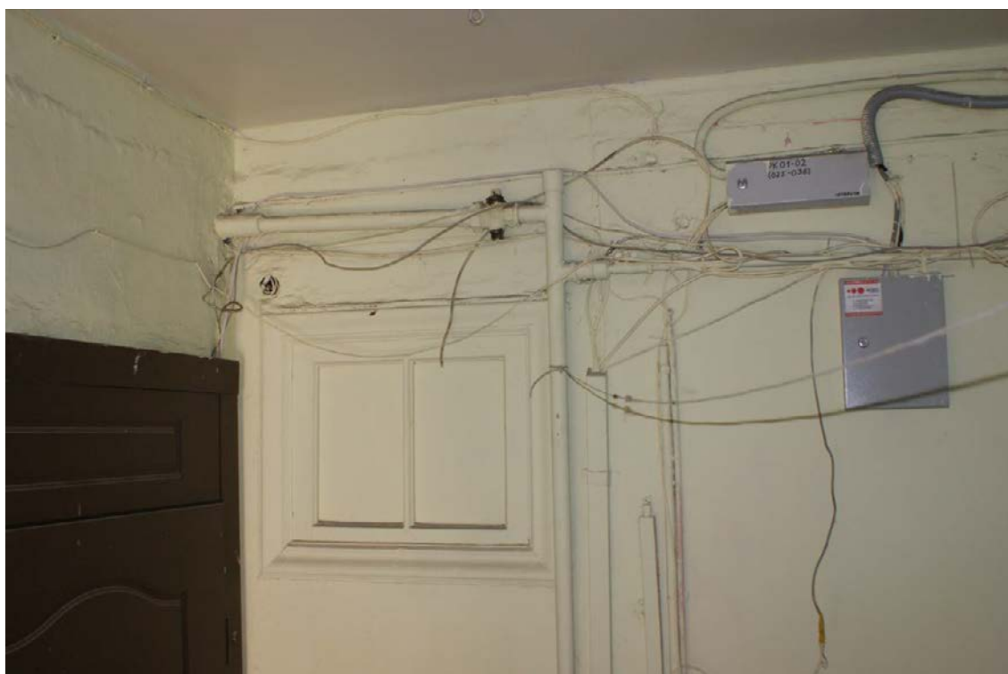
Фото 85. Лестница № 3. 5 этаж. Съемка 26.04.2021 г. Трушковский В. Э.
