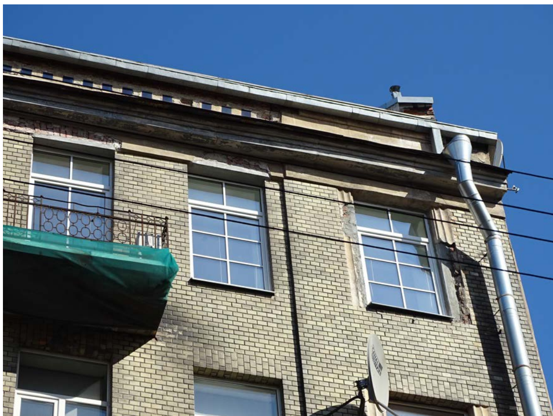
Фото 44. Фрагмент лицевого фасада. 5-й этаж. Съемка 26.04.2021 г. Трушковский В.Э.
