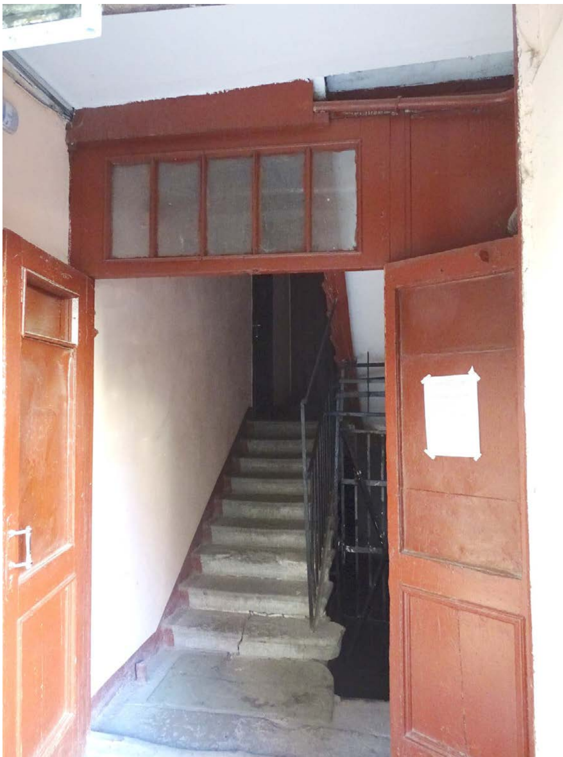
Фото 120. Лестница №6. 1 этаж. Вход в лестничную клетку. Съемка 26.04.2021 г. Трушковский В. Э.
