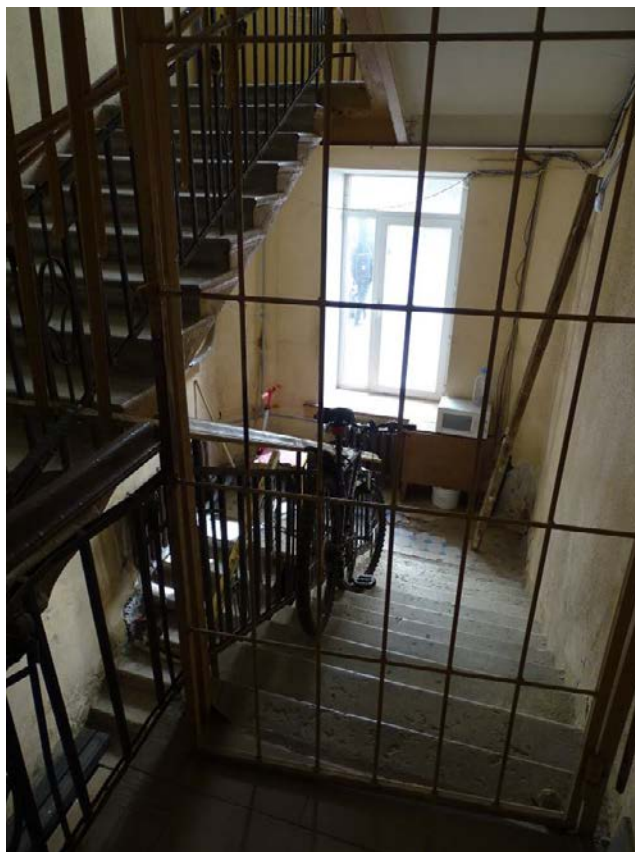
Фото 8. Лестница № 1. 1 этаж. Площадка между 1 и подвальным этажом. Съемка 26.04.2021 г. Трушковский В. Э.
