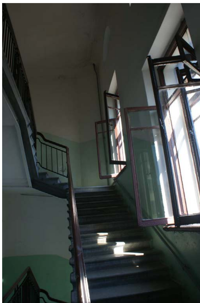
Фото 63. Лестница № 2. Площадка между 5 и 6 этажом. Съёмка 26.04.2021 г. Трушковский В. Э.
