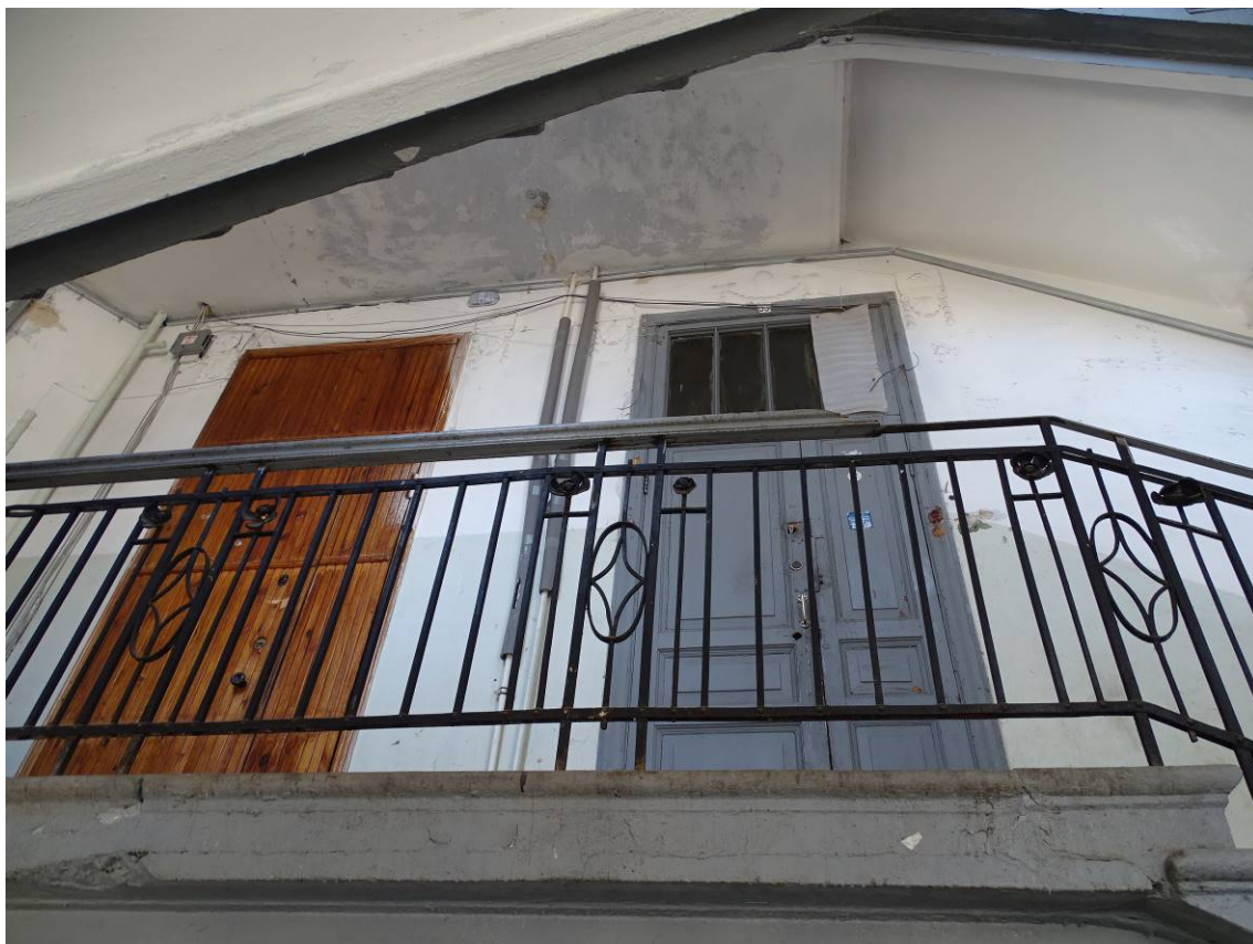
Фото 44. Лестница № 2. 3 этаж. Съемка 26.04.2021 г. Трушковский В. Э.
