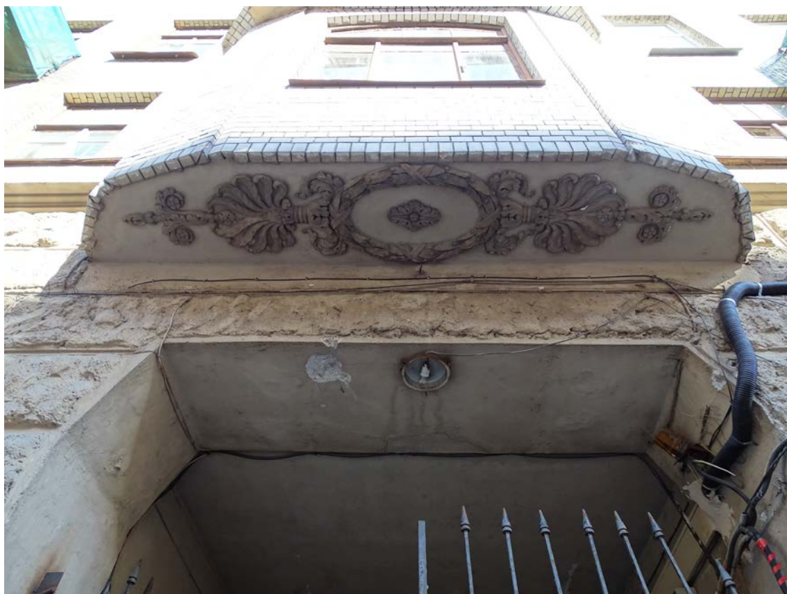
Фото 47. Фрагмент лицевого фасада. Оформление основания эркера. Съемка 26.04.2021 г. Трушковский В.Э.
