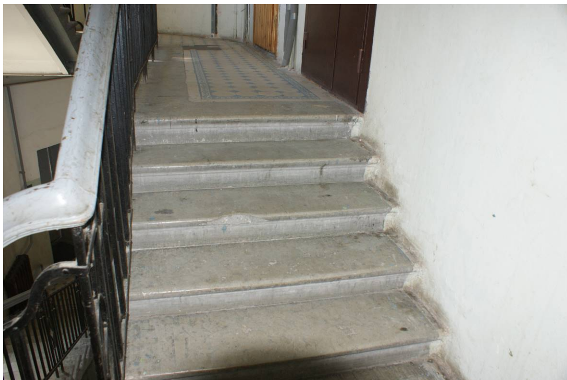
Фото 49. Лестница № 2. 4 этаж. Съемка 26.04.2021 г. Трушковский В. Э.
