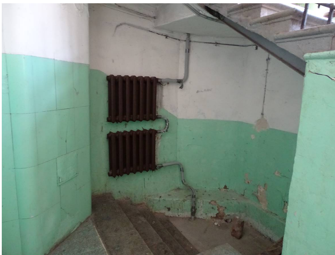
Фото 35. Лестница № 2. 1 этаж. Съёмка 26.04.2021 г. Трушковский В. Э.
