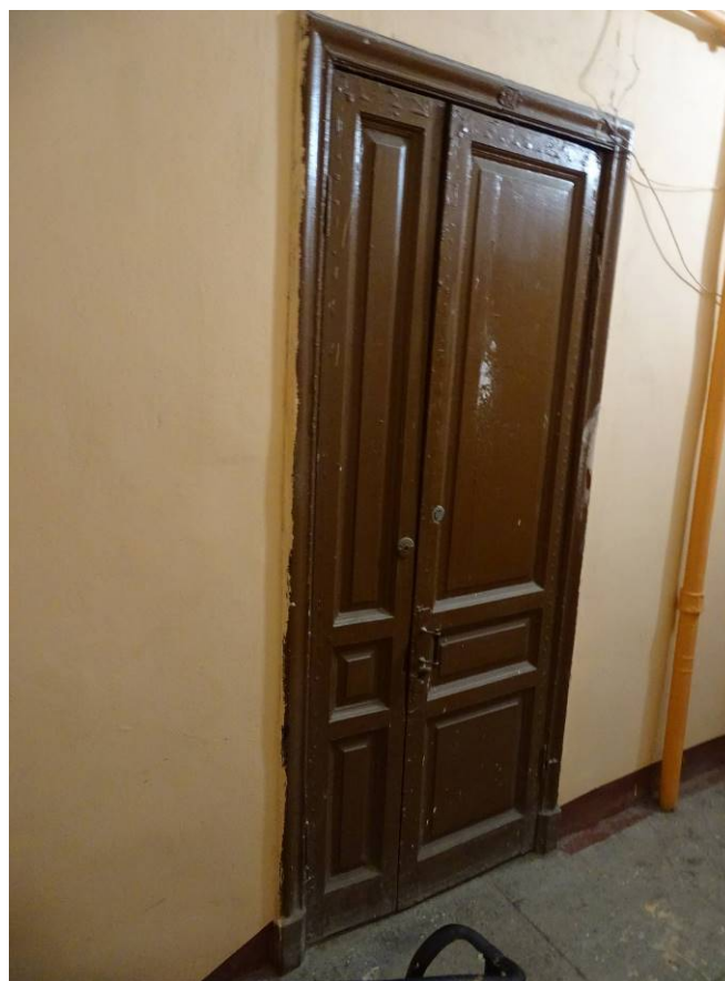
Фото 129. Лестница №6. 2 этаж. Съемка 26.04.2021 г. Трушковский В.Э
