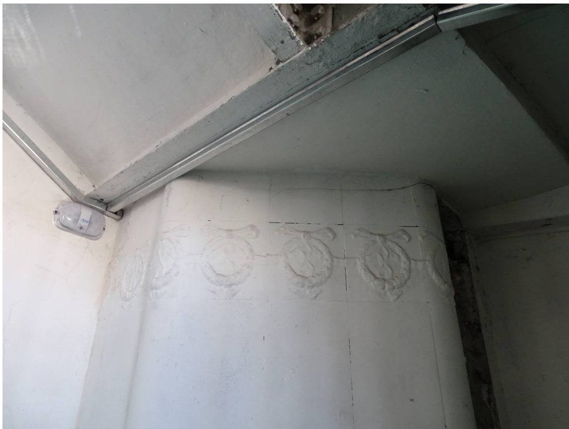
Фото 36. Лестница № 2. 1 этаж. Фрагмент печи изразцовой. Съемка 26.04.2021 г. Трушковский В. Э.
