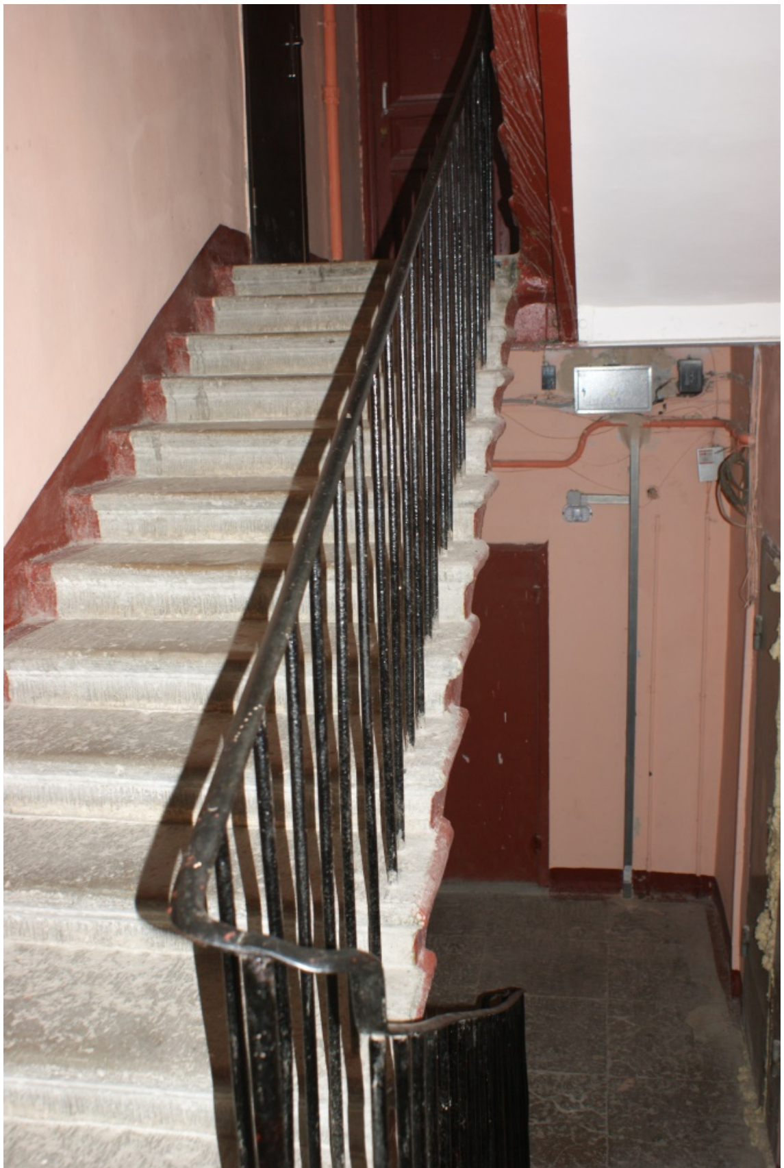
Фото 132. Лестница №6. 3 этаж. Съемка 26.04.2021 г. Трушковский В.Э
