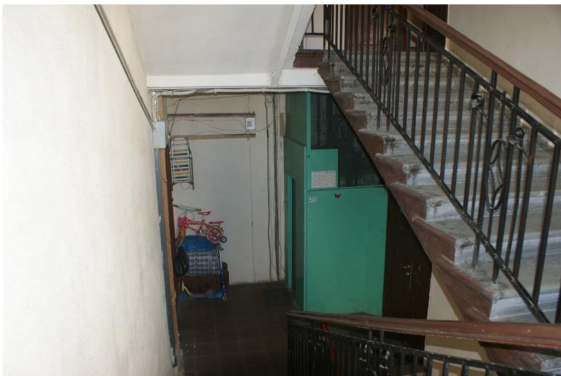
Фото 107. Лестница № 4. 4 этаж. Съемка 26.04.2021 г. Трушковский В. Э.
