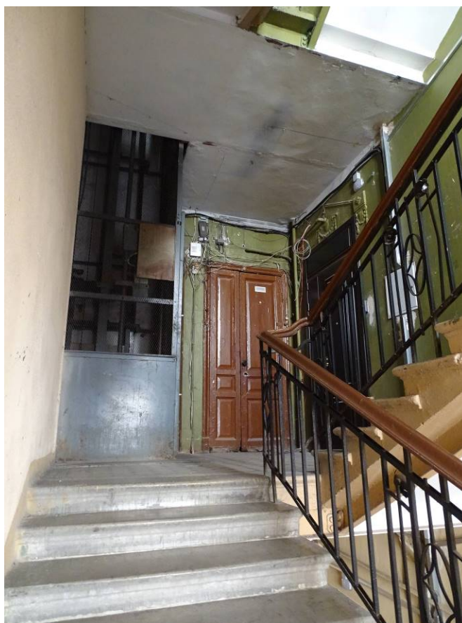
Фото 12. Лестница № 1. 2 этаж. Съемка 26.04.2021 г. Трушковский В. Э.
