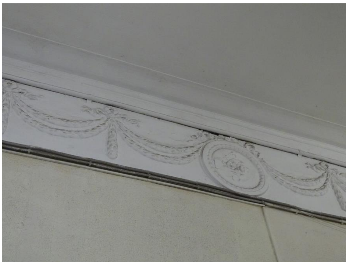
Фото 92. Лестница № 4. 1 этаж. Лепные композиции из гирлянд. Съемка 26.04.2021 г. Трушковский В. Э.
