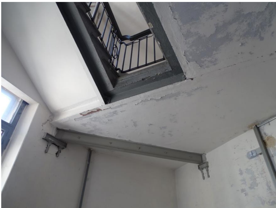
Фото 46. Лестница № 2. 3 этаж. Междуэтажное перекрытие. Съемка 26.04.2021 г. Трушковский В. Э.
