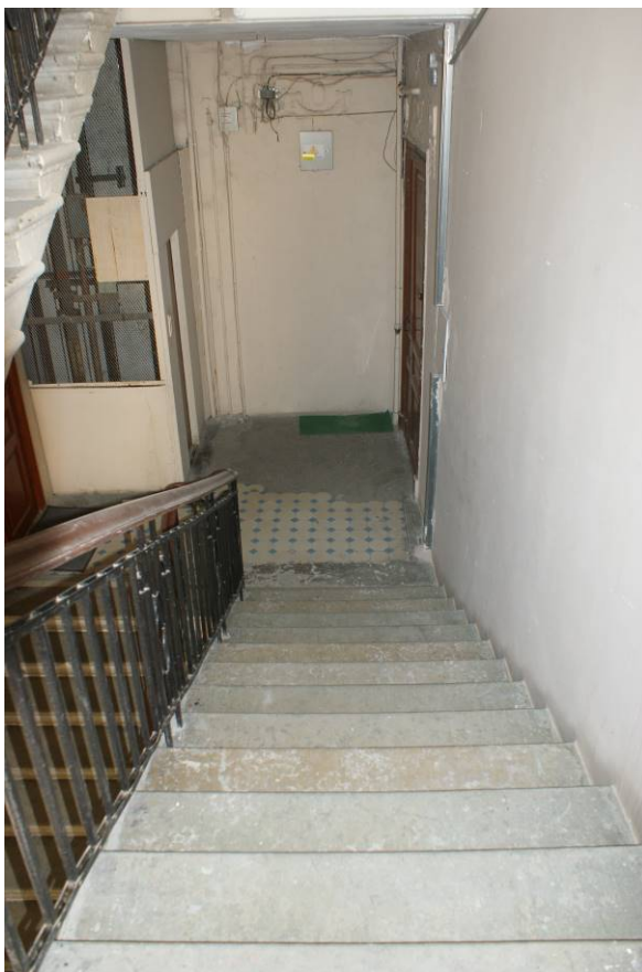
Фото 20. Лестница № 1. 4 этаж. Съемка 26.04.2021 г. Трушковский В. Э.
