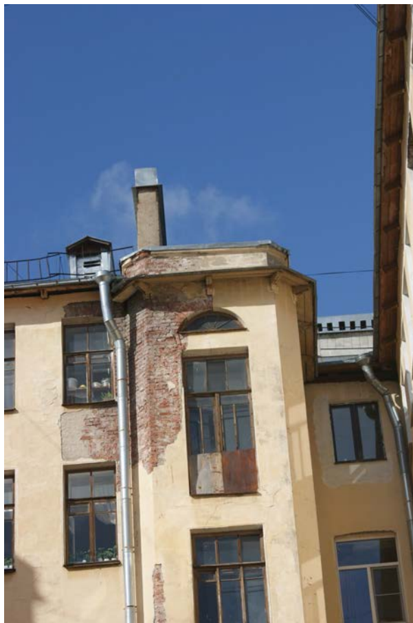
Фото 57. Фрагмент северного фасада западного внутреннего двора. Ризалит. 6-й этаж. Съемка 26.04.2021 г. Трушковский В.Э.
