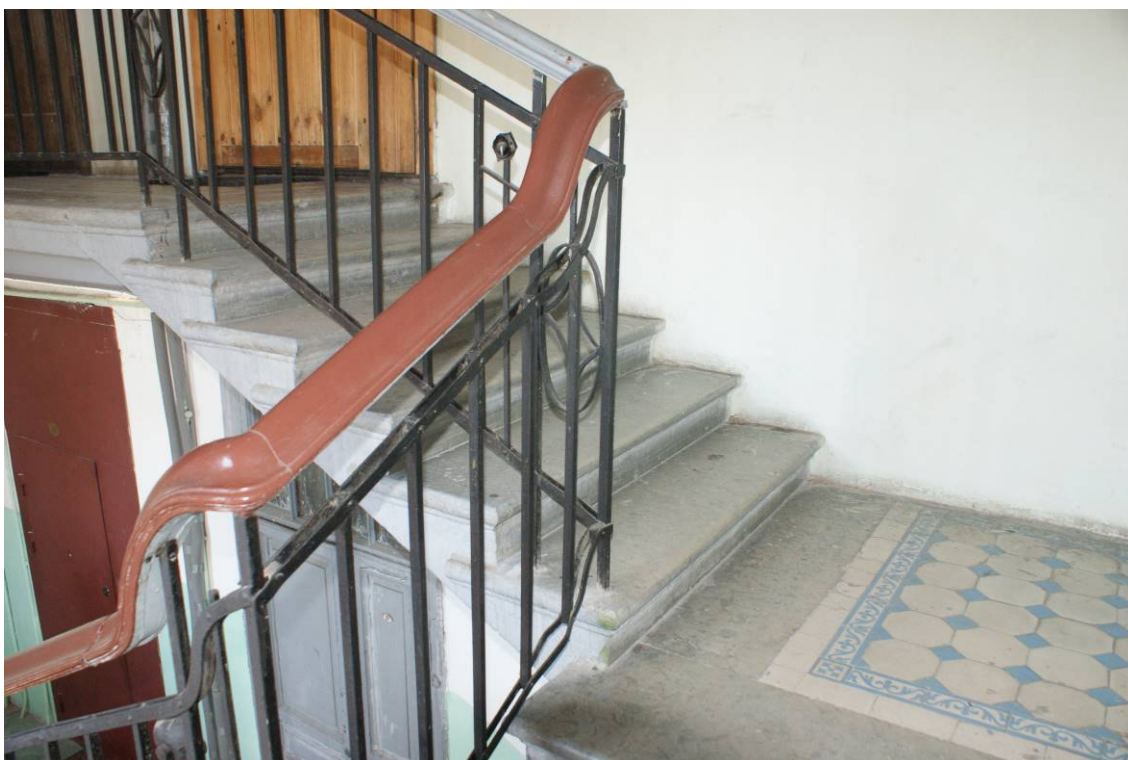
Фото 65. Лестница № 2. Лестничный марш на 6-й этаж. Съемка 26.04.2021 г. Трушковский В. Э.
