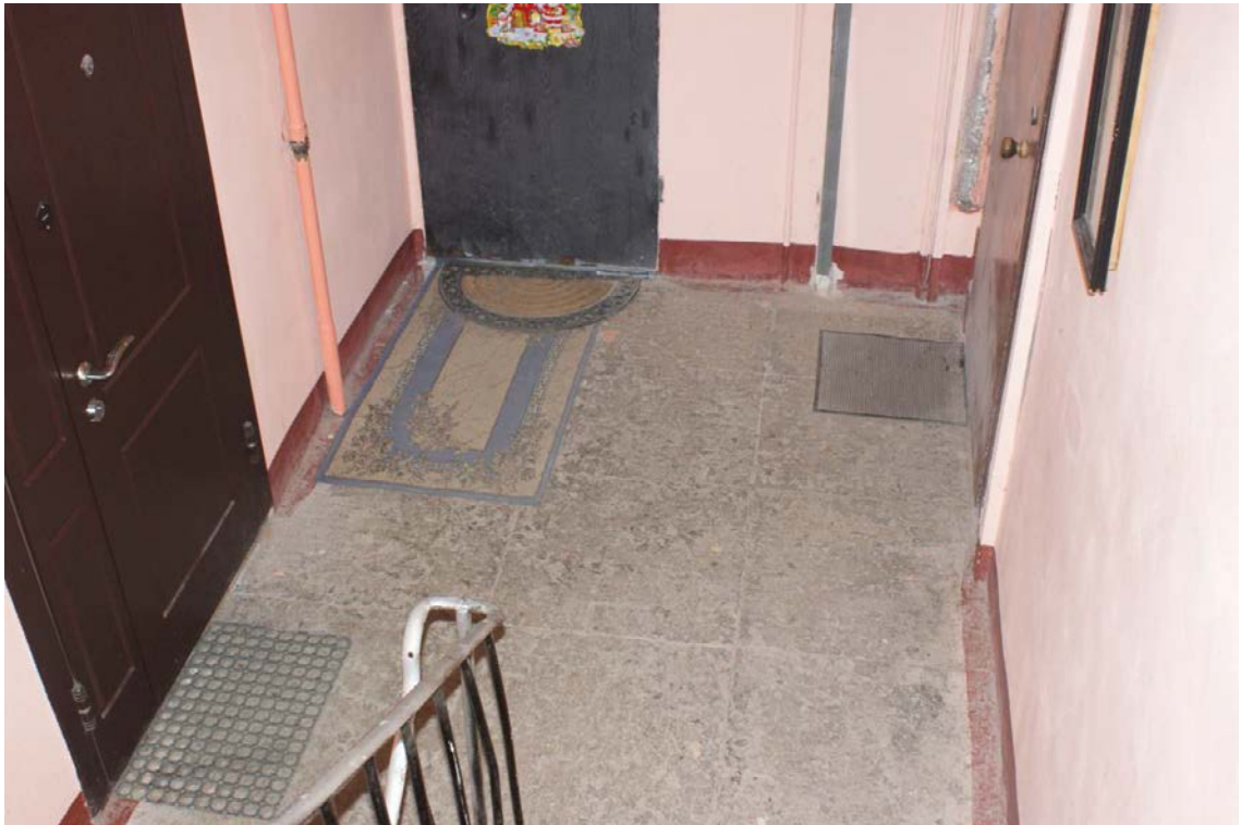
Фото 139. Лестница №6. 6 этаж. Съемка 26.04.2021 г. Трушковский В. Э.
