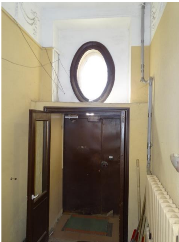
Фото 1. Лестница № 1. 1 этаж. Вход в парадную. Съёмка 26.04.2021 г. Трушковский В. Э.
