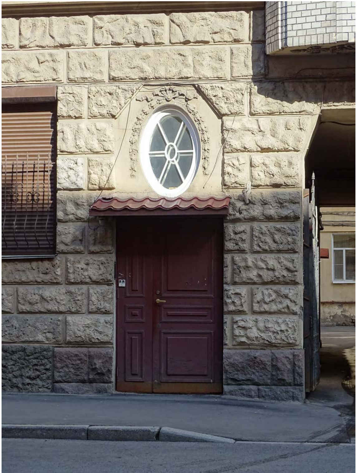
Фото 42. Фрагмент лицевого фасада. Дверной проем. Съемка 26.04.2021 г. Трушковский В.Э.
