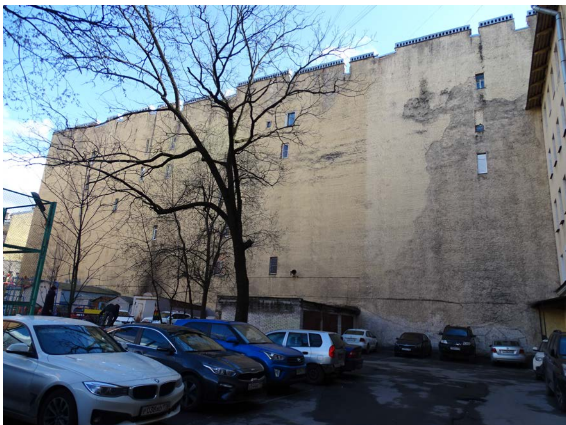
Фото 73. Северный торцевой фасад. Съемка 26.04.2021 г. Трушковский В.Э.
