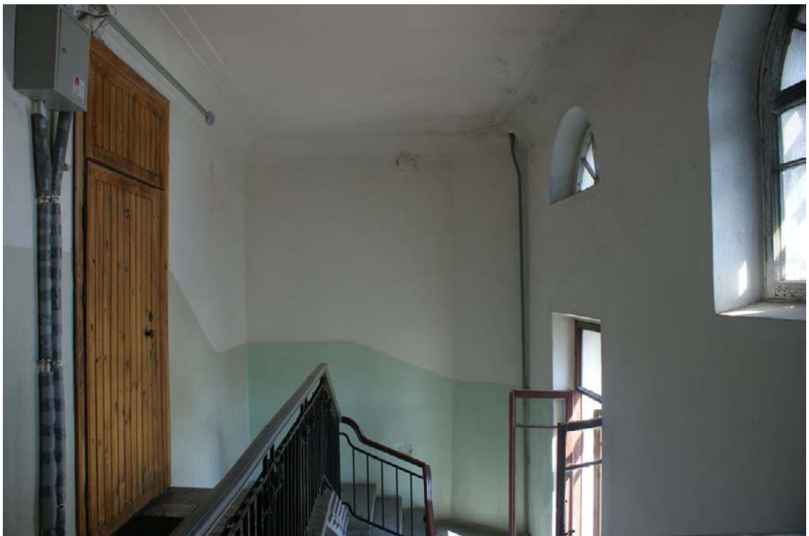
Фото 67. Лестница № 2. 6 этаж. Съёмка 26.04.2021 г. Трушковский В. Э.
