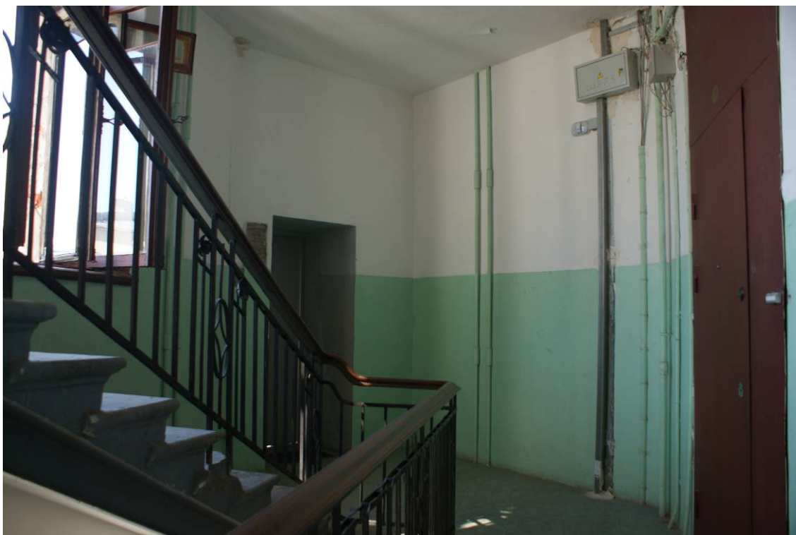
Фото 56. Лестница № 2. 5 этаж. Съёмка 26.04.2021 г. Трушковский В. Э.
