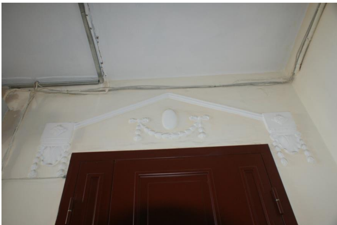
Фото 111. Лестница № 4. 5 этаж. Оформление стен лестничной клетки. Лепные композиции растительного характера. Съемка 26.04.2021 г. Трушковский В. Э.
