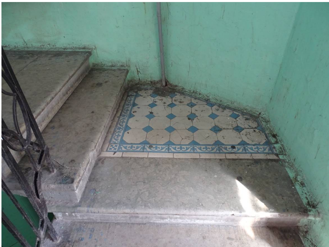
Фото 39. Лестница № 2. Площадка между 1 и 2 этажом. Метлахская плитка. Съемка 26.04.2021 г. Трушковский В. Э.
