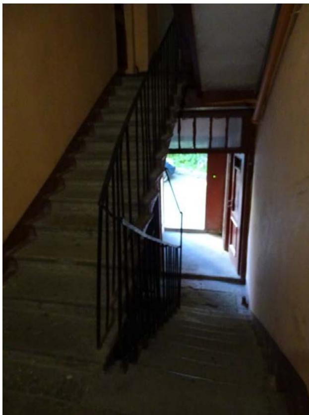
Фото 122. Лестница №6. 1 этаж. Вход в лестничную клетку. Съемка 26.04.2021 г. Трушковский В. Э.
