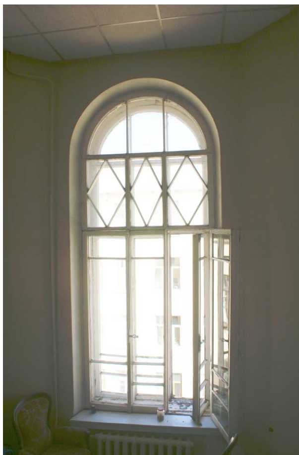
Фото 27. Лестница № 1. Площадка между 5 и 6 этажом. Съемка 26.04.2021 г. Трушковский В. Э.
