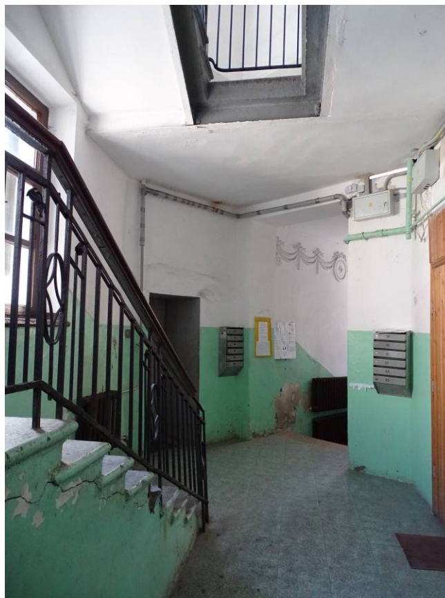
Фото 37. Лестница № 2. 1 этаж. Съемка 26.04.2021 г. Трушковский В. Э.
