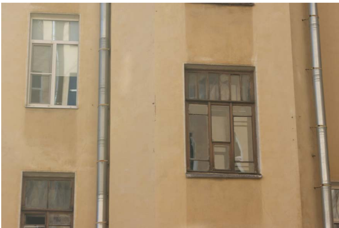
Фото 53. Фрагмент западного фасада западного внутреннего двора. Ризалит. 5-й этаж. Съемка 26.04.2021 г. Трушковский В.Э.
