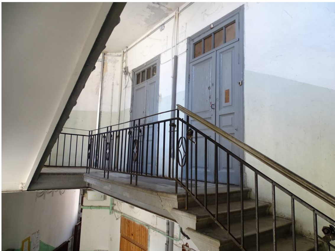
Фото 40. Лестница № 2. 2 этаж. Съемка 26.04.2021 г. Трушковский В. Э.
