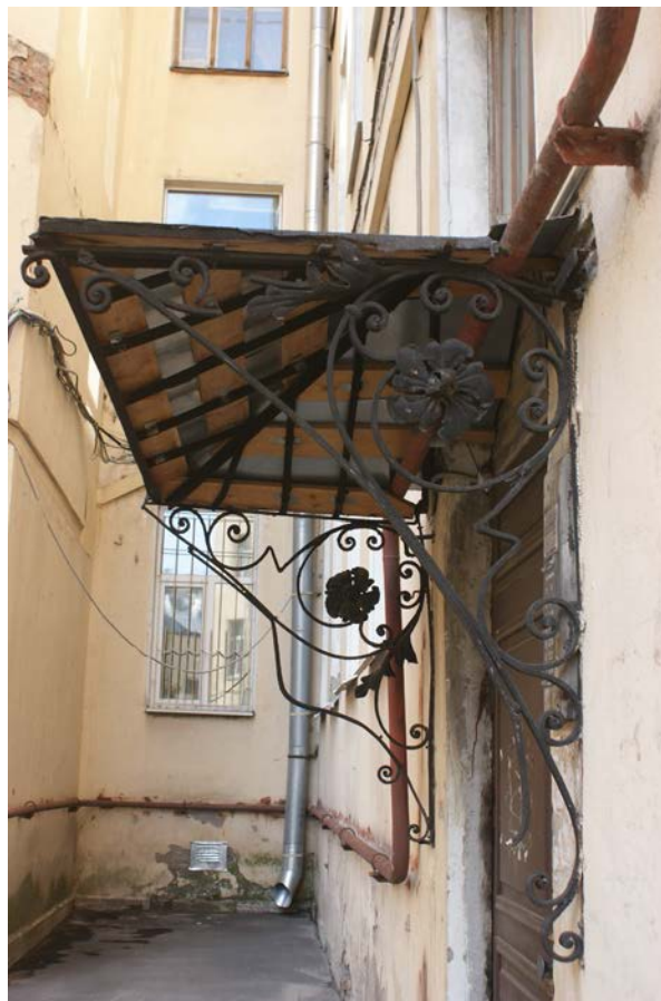
Фото 61. Козырек дверного проема восточного фасада западного внутреннего двора. Съемка 26.04.2021 г. Трушковский В.Э.
