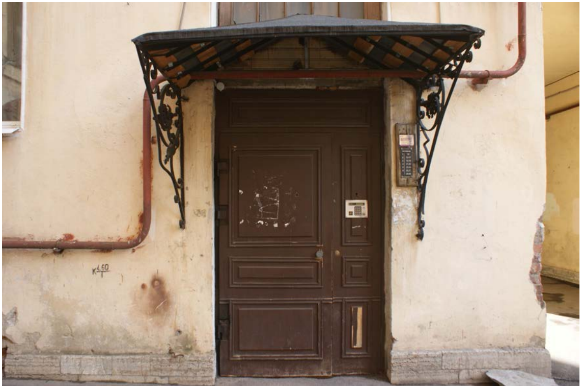
Фото 60. Дверной проем восточного фасада западного внутреннего двора. Съемка 26.04.2021 г. Трушковский В.Э.
