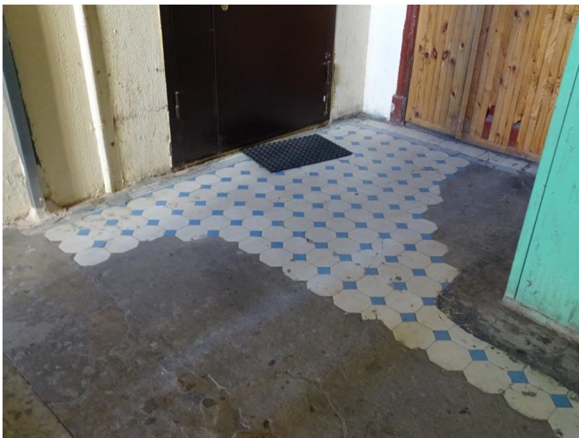
Фото 99. Лестница № 4. 2 этаж. Метлахская плитка. Съемка 26.04.2021 г. Трушковский В. Э.
