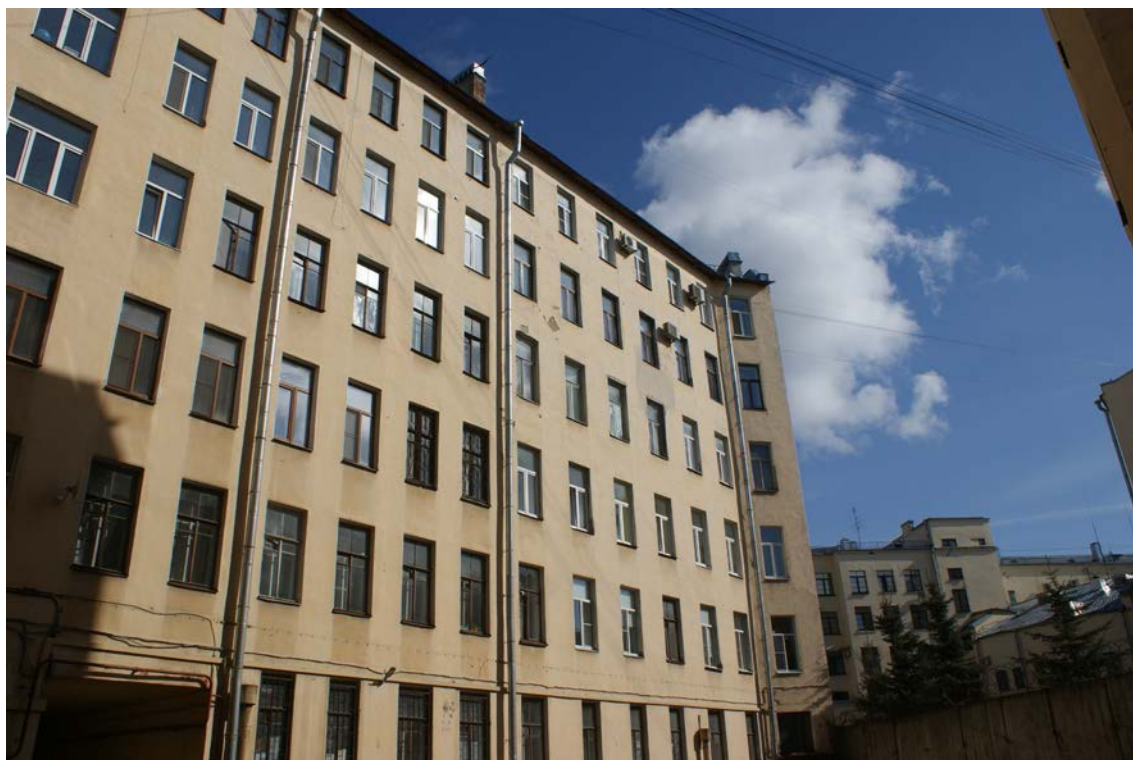
Фото 59. Фрагмент восточного фасада западного внутреннего двора. Съемка 26.04.2021 г. Трушковский В.Э.
