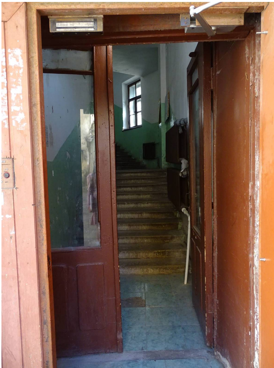
Фото 30. Лестница № 2. 1 этаж. Вход в парадную. Съемка 26.04.2021 г. Трушковский В. Э.
