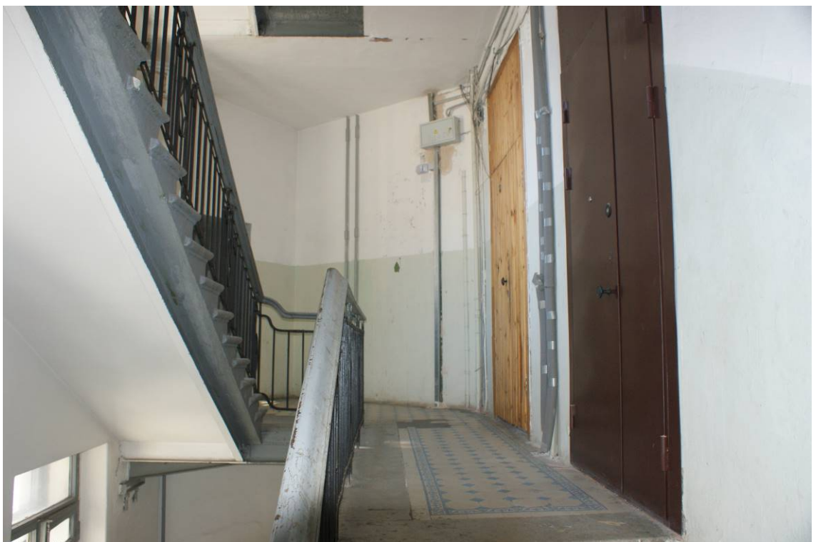
Фото 51. Лестница № 2. 4 этаж. Съемка 26.04.2021 г. Трушковский В. Э.
