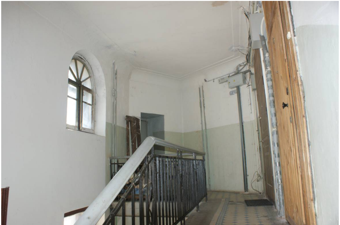
Фото 66. Лестница № 2. 6 этаж. Съёмка 26.04.2021 г. Трушковский В. Э.
