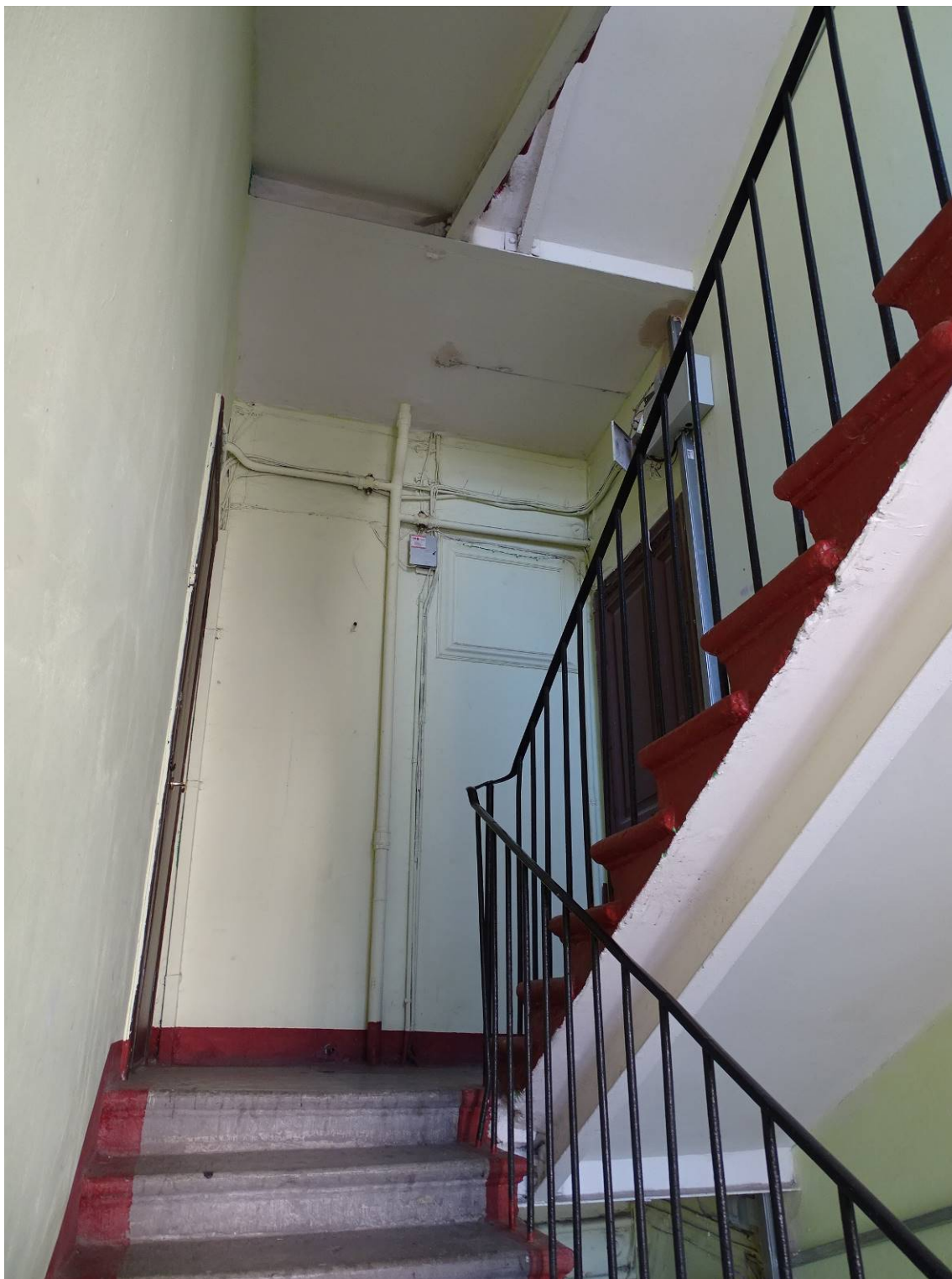
Фото 78. Лестница № 3. 3 этаж. Съемка 26.04.2021 г. Трушковский В. Э.
