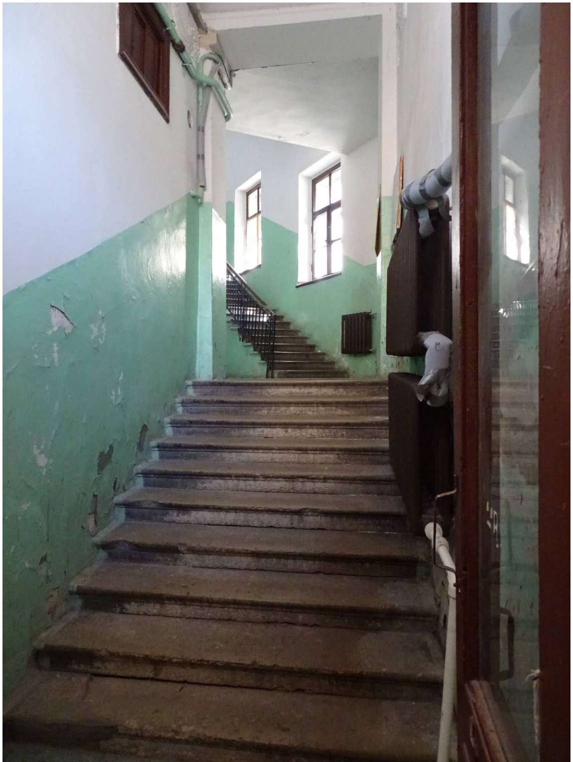
Фото 31. Лестница № 2. 1 этаж. Вход в парадную. Съемка 26.04.2021 г. Трушковский В. Э.
