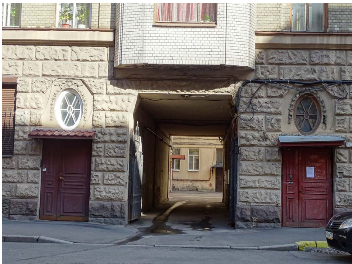
Фото 41. Фрагмент лицевого фасада. Воротный проем. Съемка 26.04.2021 г. Трушковский В.Э.
