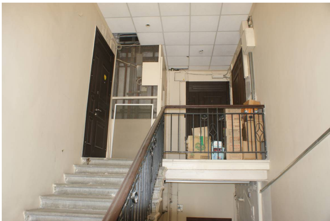
Фото 28. Лестница № 1. 6 этаж. Съемка 26.04.2021 г. Трушковский В. Э.
