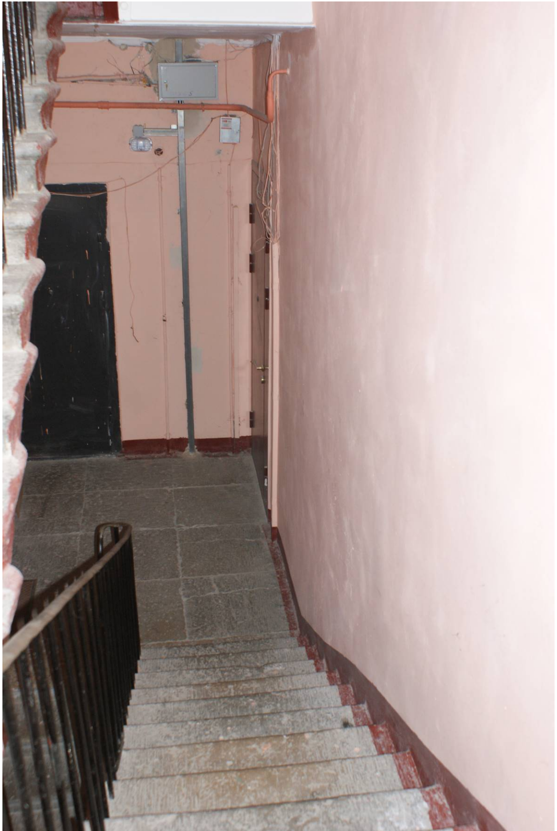
Фото 136. Лестница №6. 5 этаж. Съемка 26.04.2021 г. Трушковский В. Э.
