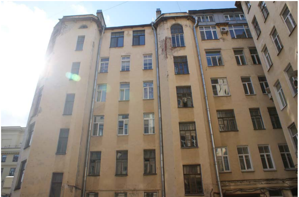
Фото 48. Фрагмент западного фасада западного внутреннего двора. 2-й, 3-й, 4-й, 5-й, 6-й этажи. Съемка 26.04.2021 г. Трушковский В.Э.
