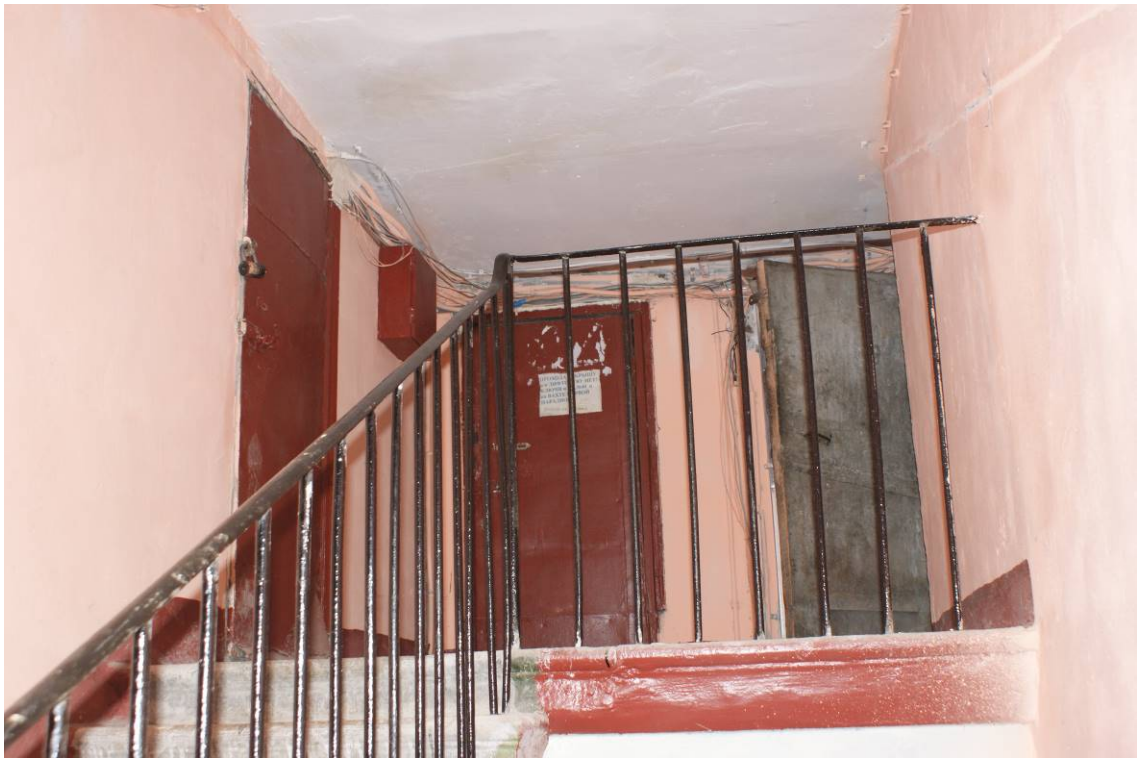
Фото 141. Лестница №6. 7 этаж. Съёмка 26.04.2021 г. Трушковский В.Э
