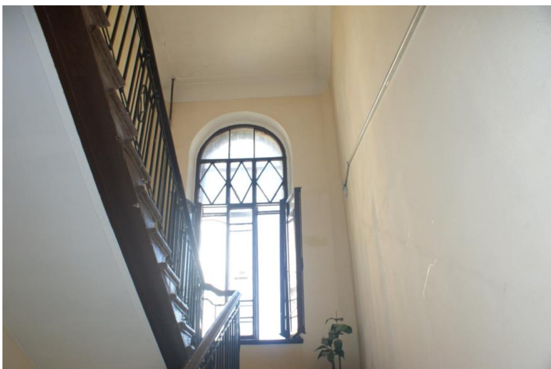
Фото 113. Лестница № 4. Площадка между 5 и 6 этажом. Съёмка 26.04.2021 г. Трушковский В. Э.
