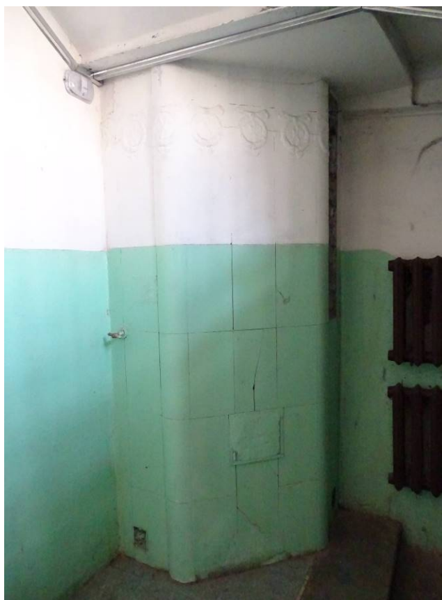
Фото 34. Лестница № 2. 1 этаж. Печь изразцовая. Съёмка 26.04.2021 г. Трушковский В. Э.
