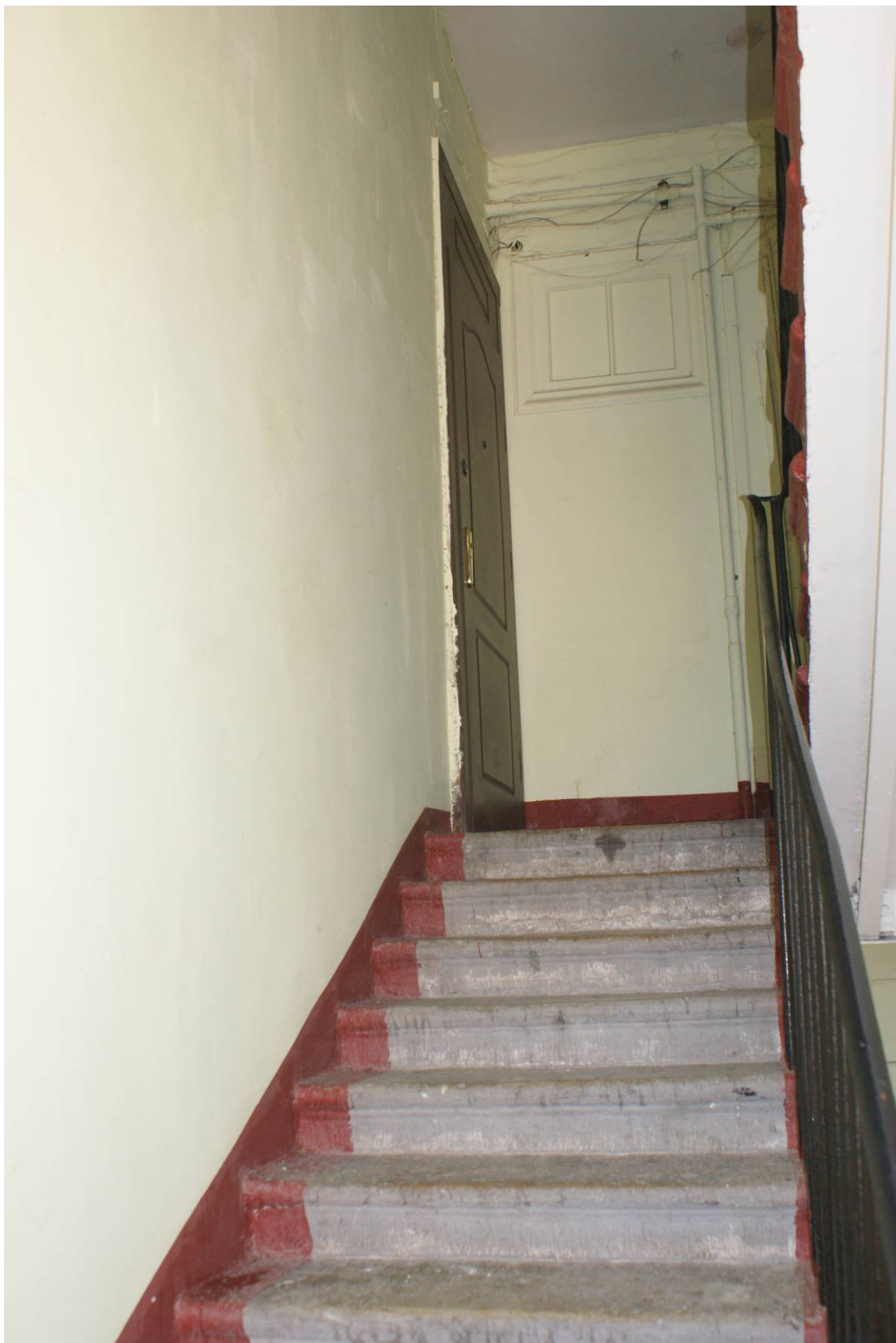
Фото 82. Лестница № 3. 4 этаж. Съемка 26.04.2021 г. Трушковский В. Э.
