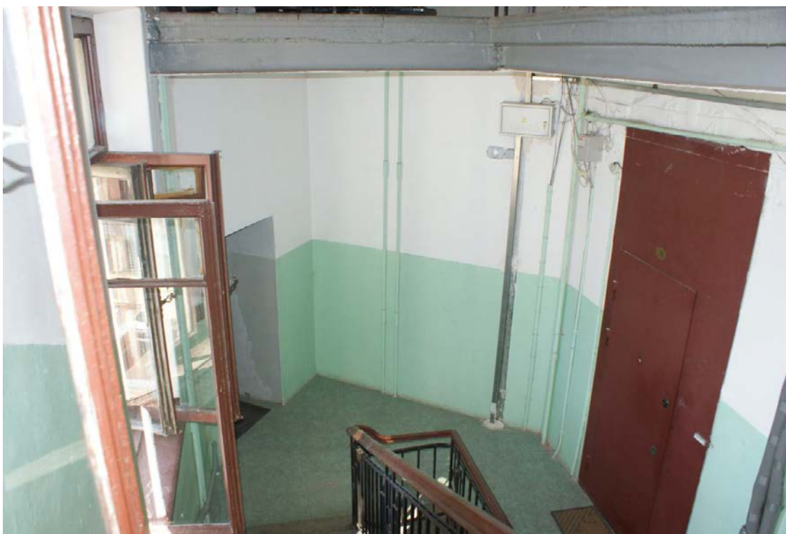
Фото 61. Лестница № 2. 5 этаж. Съемка 26.04.2021 г. Трушковский В. Э.
