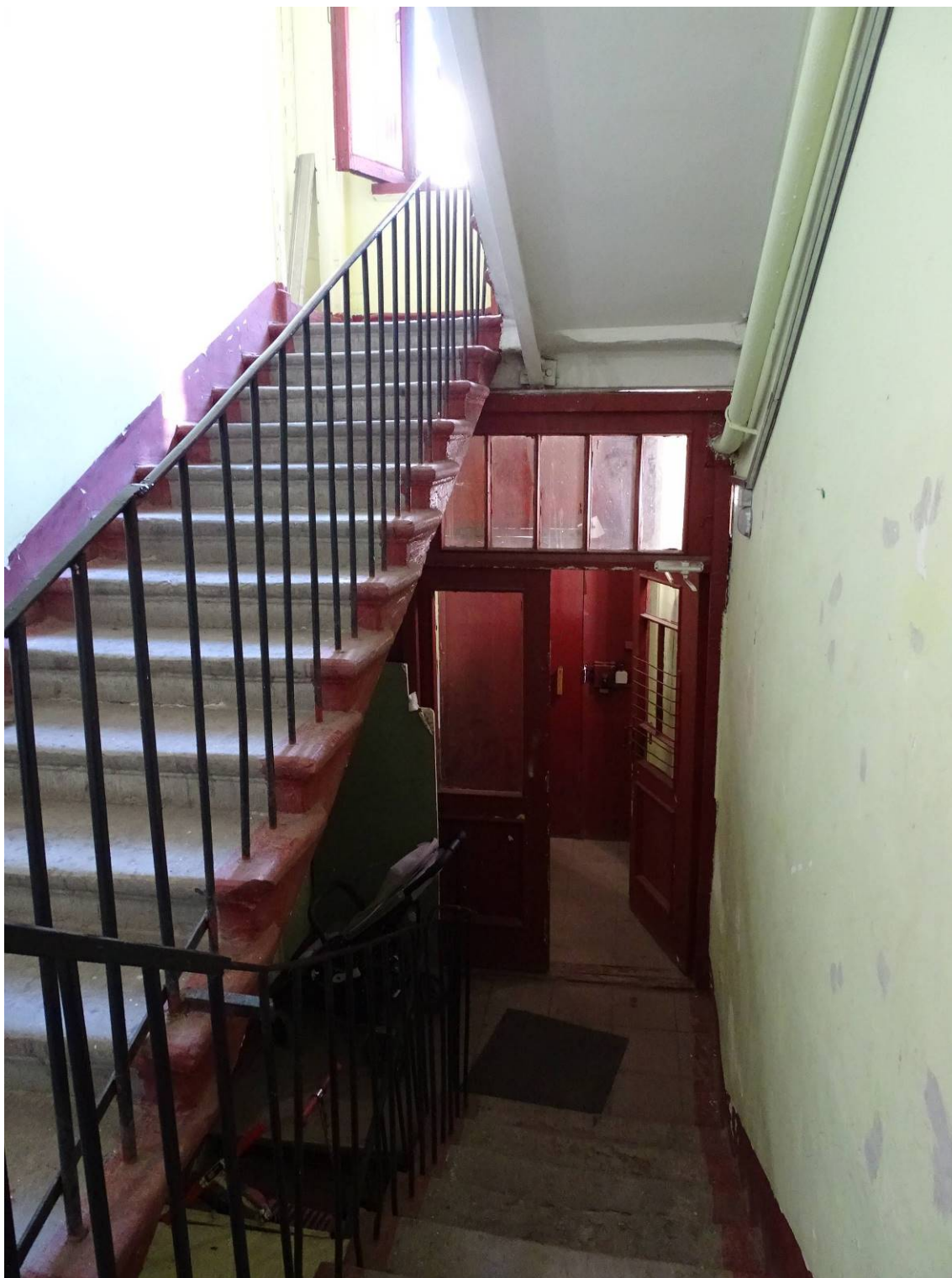
Фото 70. Лестница № 3.1 этаж. Вход в парадную. Съемка 26.04.2021 г. Трушковский В. Э.
