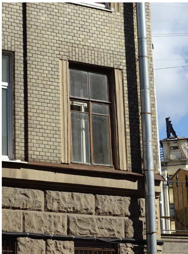
Фото 46. Фрагмент лицевого фасада. Оконный проем 2-го этажа. Съемка 26.04.2021 г. Трушковский В.Э.
