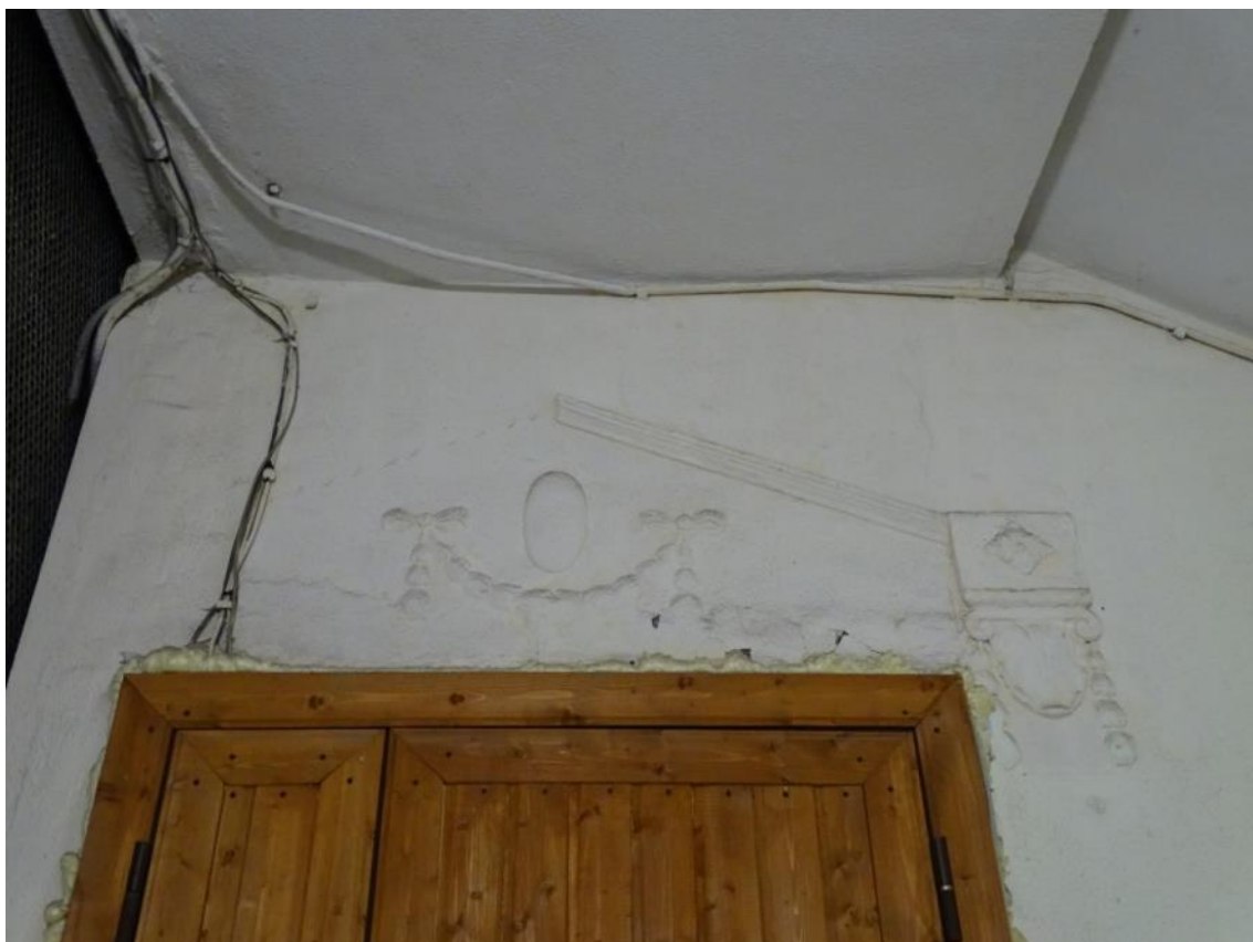
Фото 100. Лестница № 4. 2 этаж. Оформление стен лестничной клетки. Лепные композиции растительного характера. Съемка 26.04.2021 г. Трушковский В. Э.
