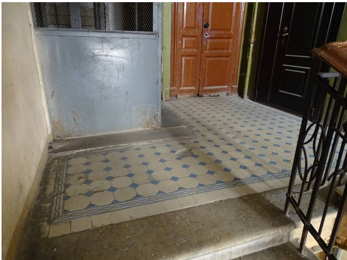
Фото 13. Лестница № 1. 2 этаж. Метлахская плитка. Съемка 26.04.2021 г. Трушковский В. Э.
