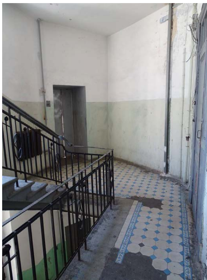
Фото 41. Лестница № 2. 2 этаж. Метлахская плитка. Съемка 26.04.2021 г. Трушковский В. Э.
