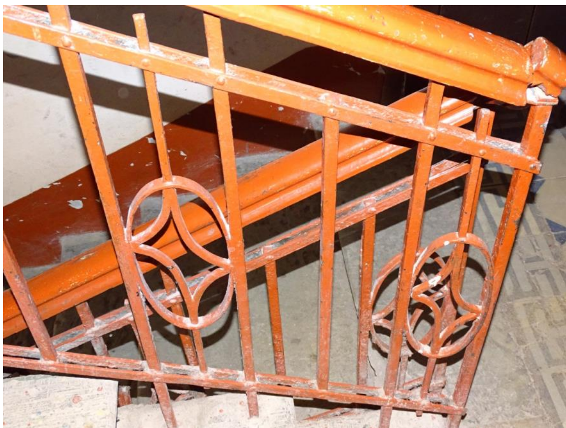
Фото 118. Лестница № 5. 1 этаж. Фрагмент лестничного ограждения. Съемка 26.04.2021 г. Трушковский В.Э
