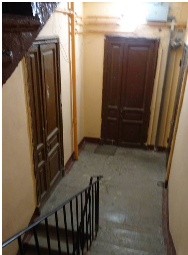
Фото 128. Лестница №6. 2 этаж. Съемка 26.04.2021 г. Трушковский В. Э.
