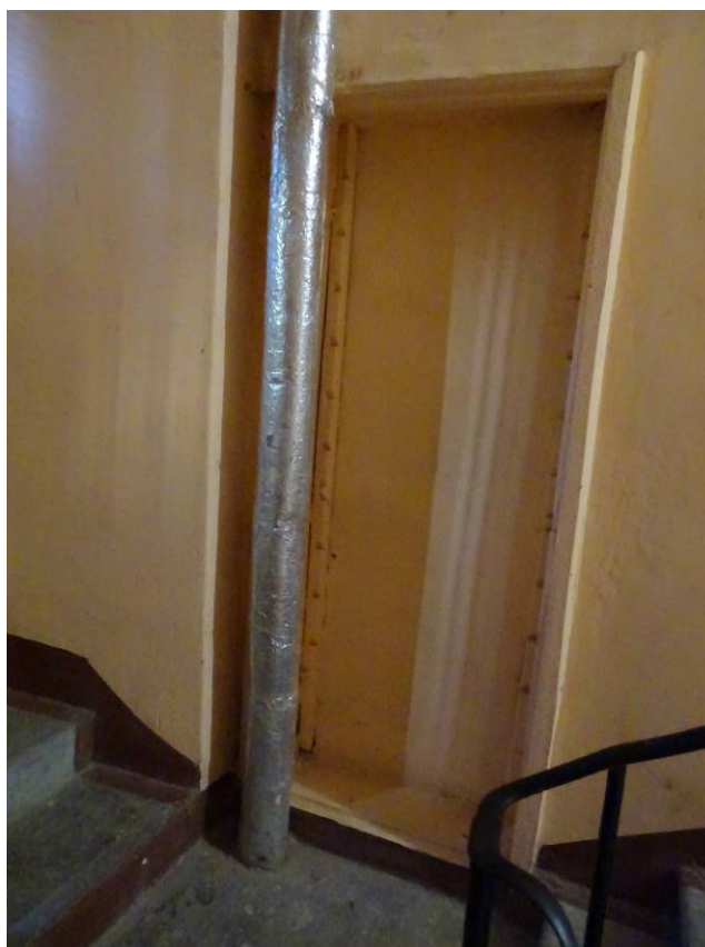
Фото 126. Лестница №6. Площадка между 1 и 2 этажом. Ниша. Съемка 26.04.2021 г. Трушковский В. Э.
