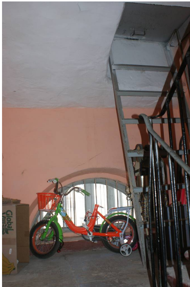
Фото 140. Лестница №6. Площадка между 6 и 7 этажом. Съемка 26.04.2021 г. Трушковский В.Э
