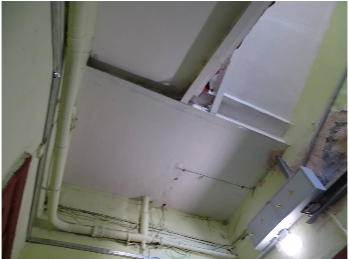
Фото 73. Лестница № 3. 1 этаж. Междуэтажное перекрытие. Съемка 26.04.2021 г. Трушковский В. Э.
