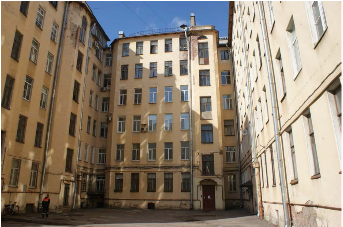
Фото 56. Северный фасад западного внутреннего двора. Съемка 26.04.2021 г. Трушковский В.Э.
