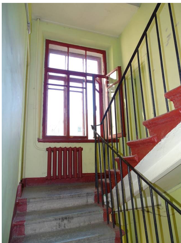
Фото 77. Лестница № 3. Площадка между 2 и 3 этажом. Съёмка 26.04.2021 г. Трушковский В. Э.
