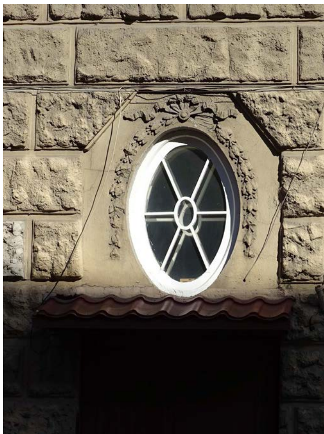
Фото 43. Фрагмент лицевого фасада. Оформление овального оконного проема. Съемка 26.04.2021 г. Трушковский В.Э.
