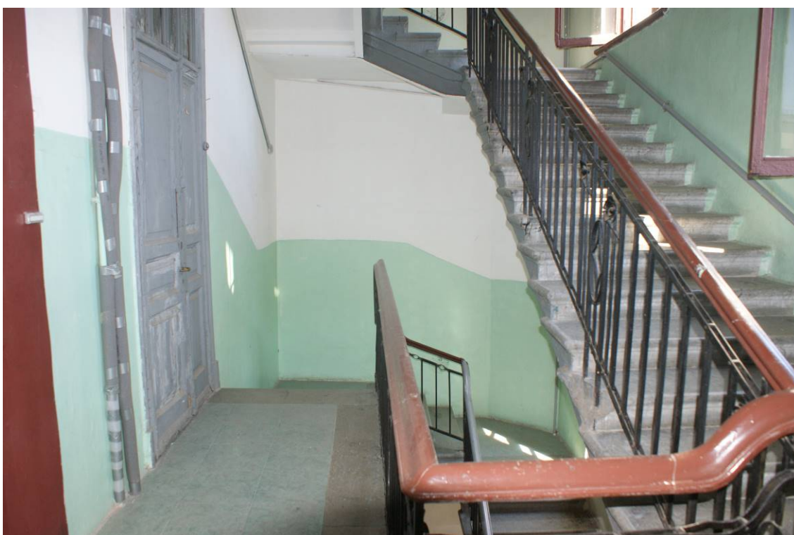
Фото 57. Лестница № 2. 5 этаж. Съёмка 26.04.2021 г. Трушковский В. Э.
