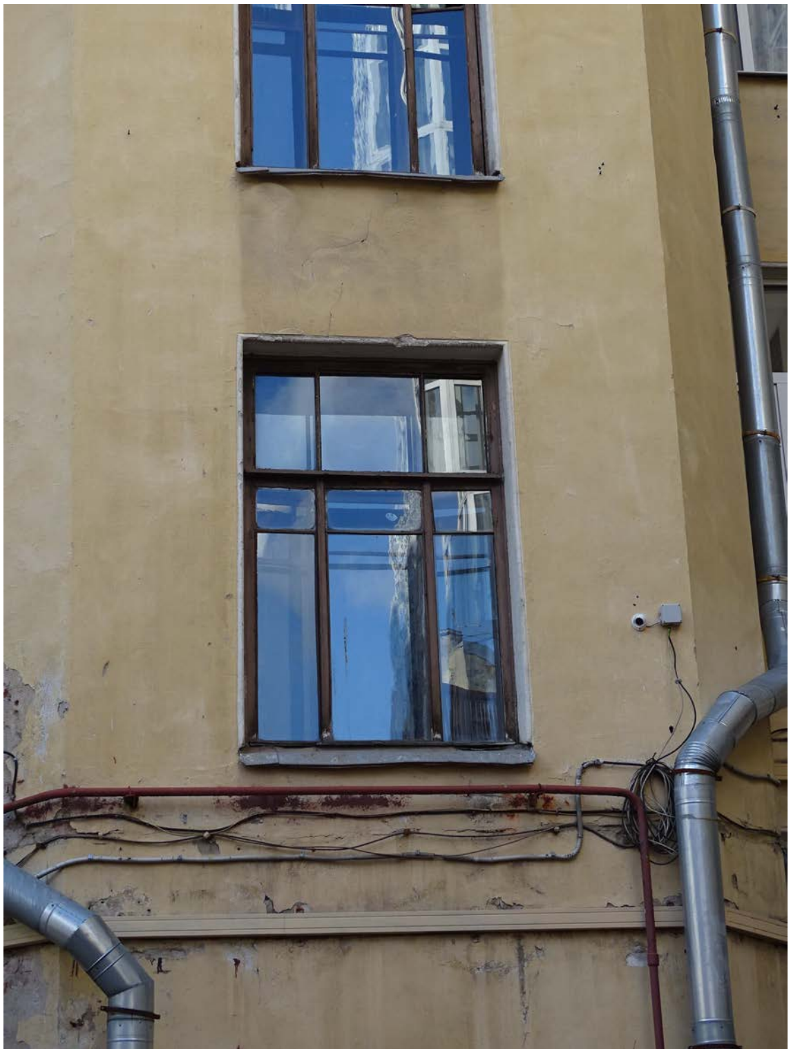
Фото 67. Фрагмент западного фасада восточного внутреннего двора. Ризалит. 2-й этаж. Съемка 26.04.2021 г. Трушковский В.Э.
