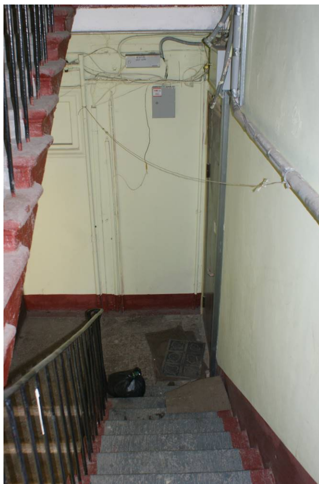
Фото 86. Лестница № 3. 5 этаж. Съемка 26.04.2021 г. Трушковский В. Э.
