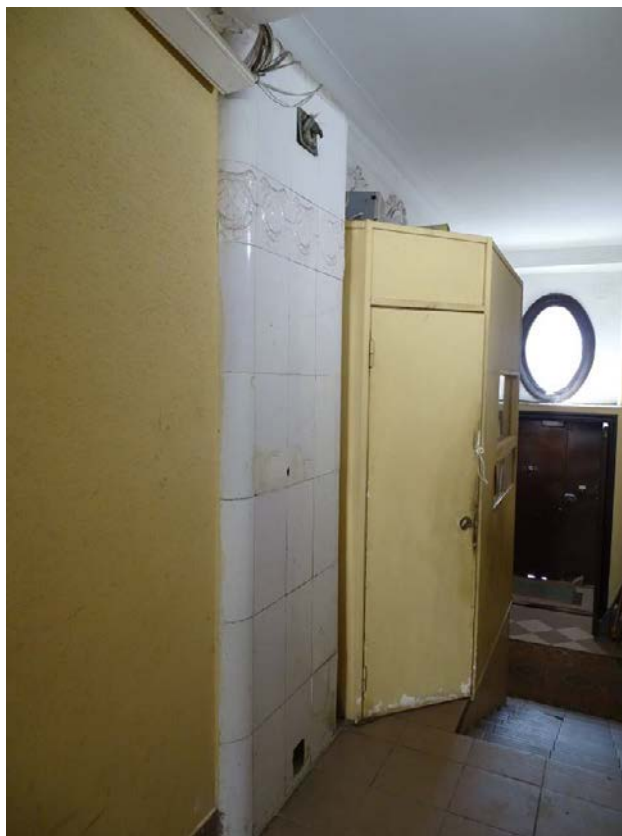
Фото 5. Лестница № 1. 1 этаж. Печь белого изразца. Съемка 26.04.2021 г. Трушковский В. Э.
