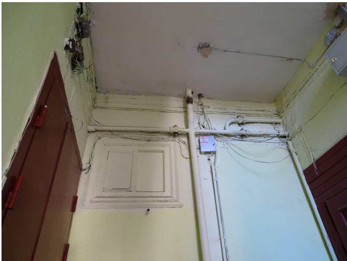
Фото 76. Лестница № 3. 2 этаж. Съёмка 26.04.2021 г. Трушковский В. Э.
