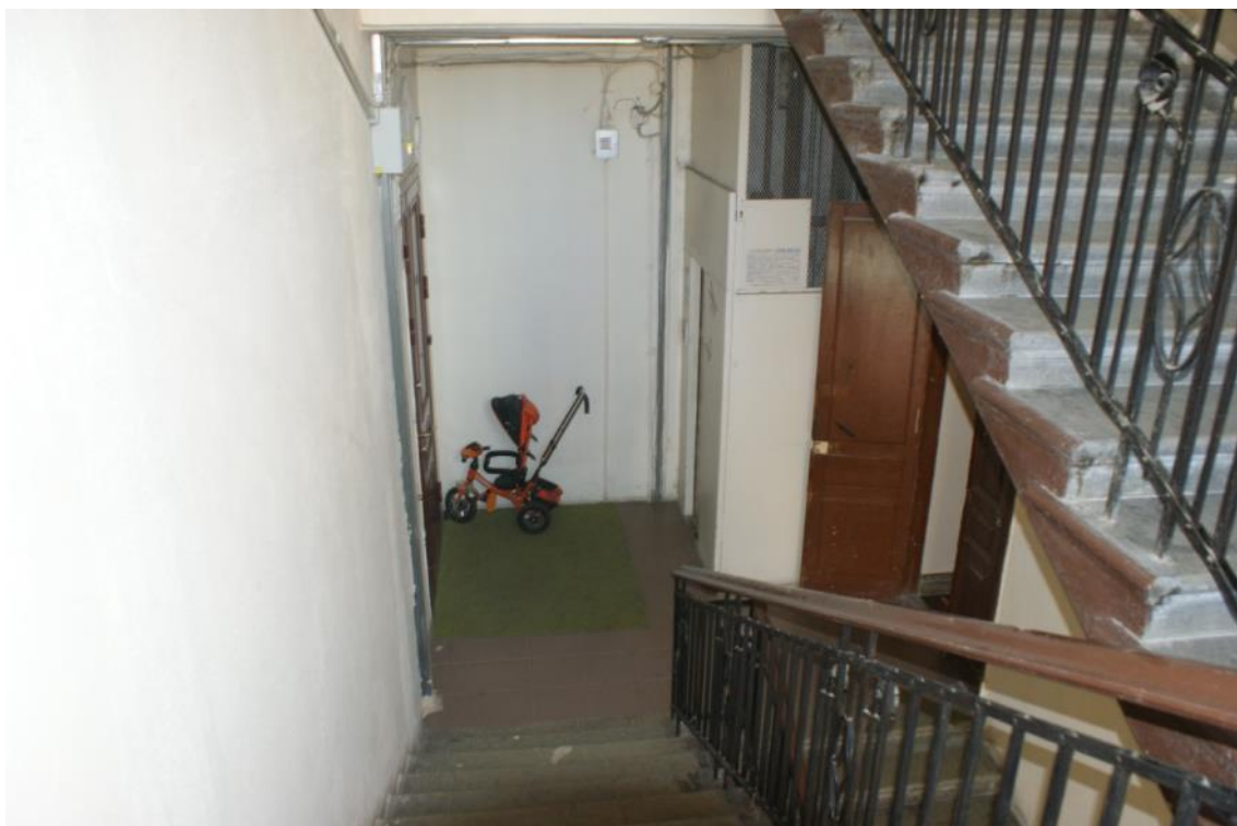
Фото 1121. Лестница № 4. 5 этаж. Съёмка 26.04.2021 г. Трушковский В. Э.
