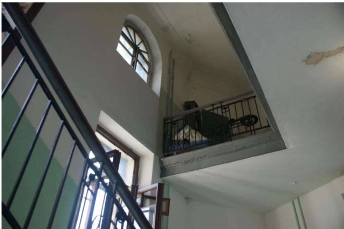
Фото 62. Лестница № 2. 6 этаж. Съёмка 26.04.2021 г. Трушковский В. Э.
