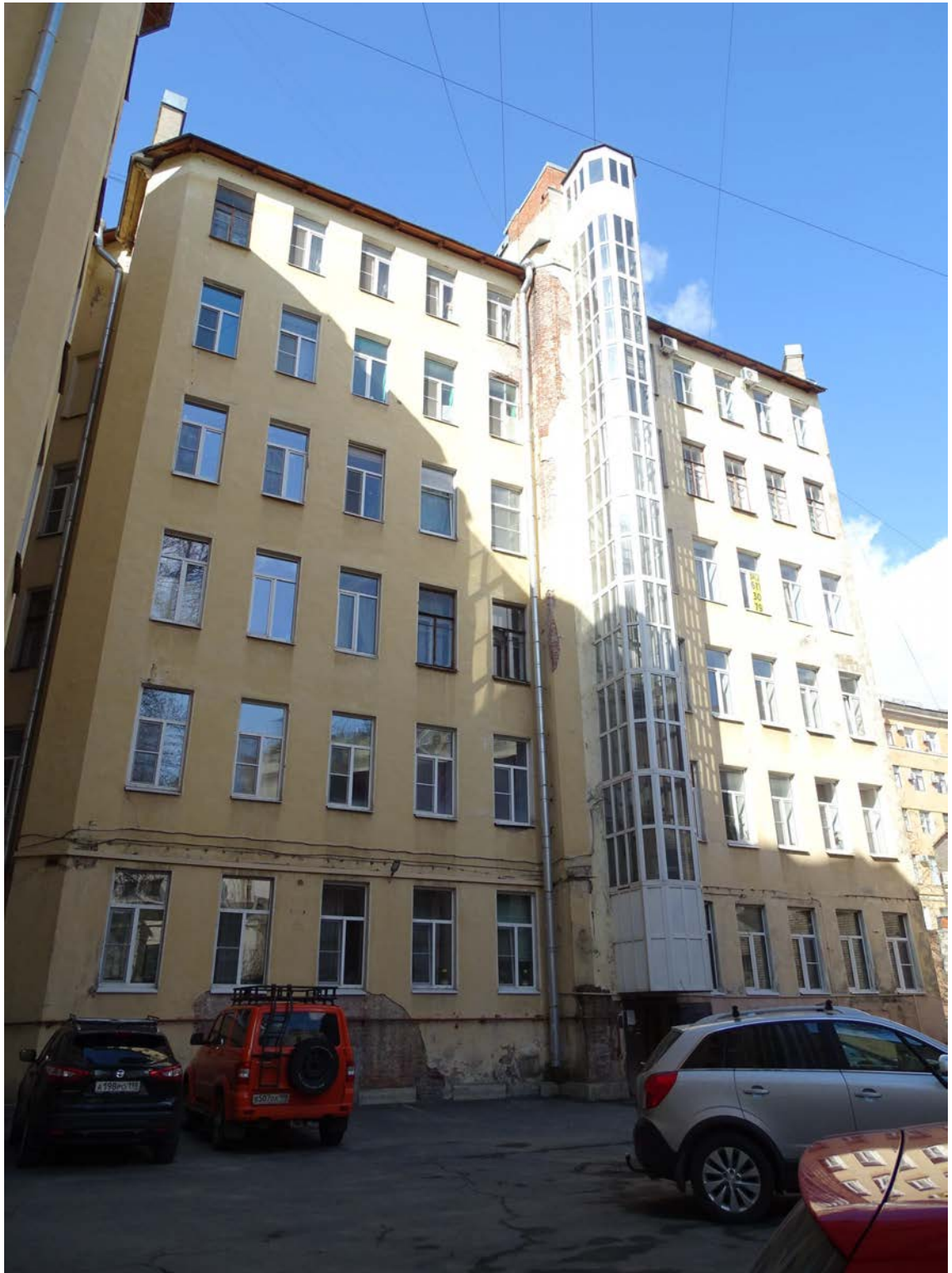
Фото 69. Северный фасад восточного внутреннего двора. 2-й, 3-й этаж. Съемка 26.04.2021 г. Трушковский В.Э.
