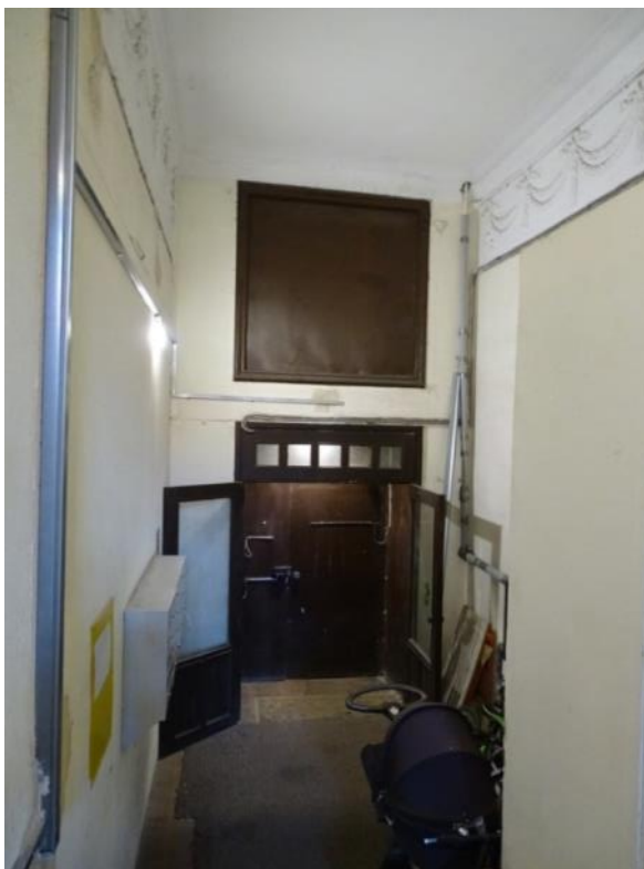
Фото 91. Лестница № 4. 1 этаж. Вход в парадную. Съемка 26.04.2021 г. Трушковский В. Э.
