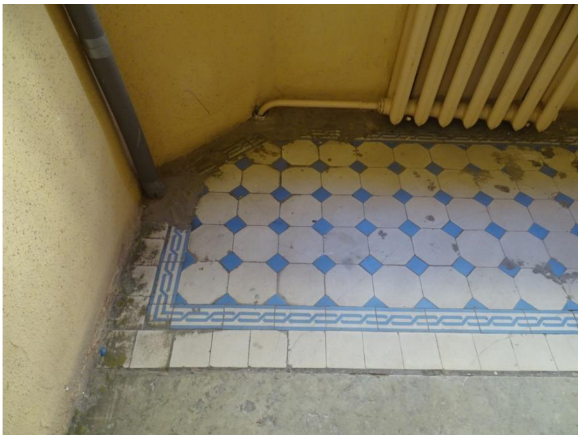
Фото 11. Лестница № 1. Площадка между 1 и 2 этажом. Метлахская плитка. Съемка 26.04.2021 г. Трушковский В. Э.
