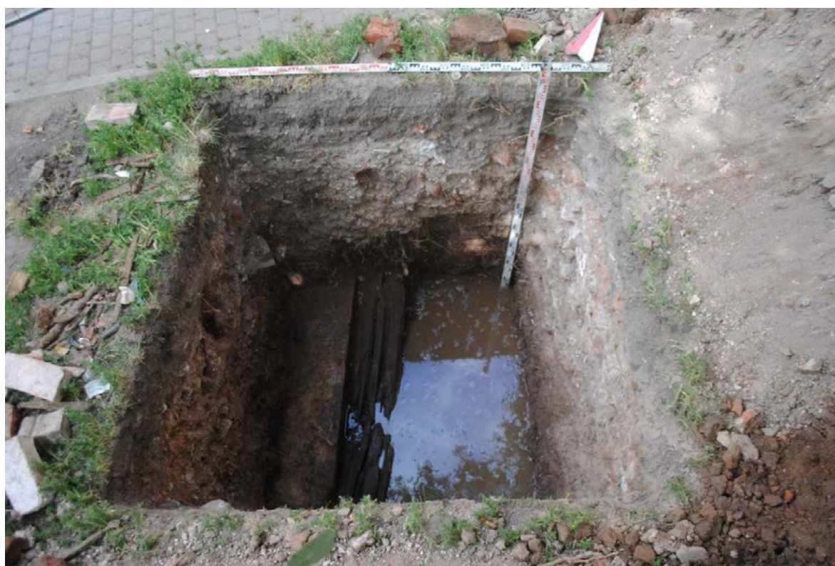
Рис. 33. Санкт-Петербург, Невский пр., между д. 148 и д. 150. Шурф 1. Фиксация по уровню грунтовых вод. Уровень прекращения работ. Вид на северо-запад
