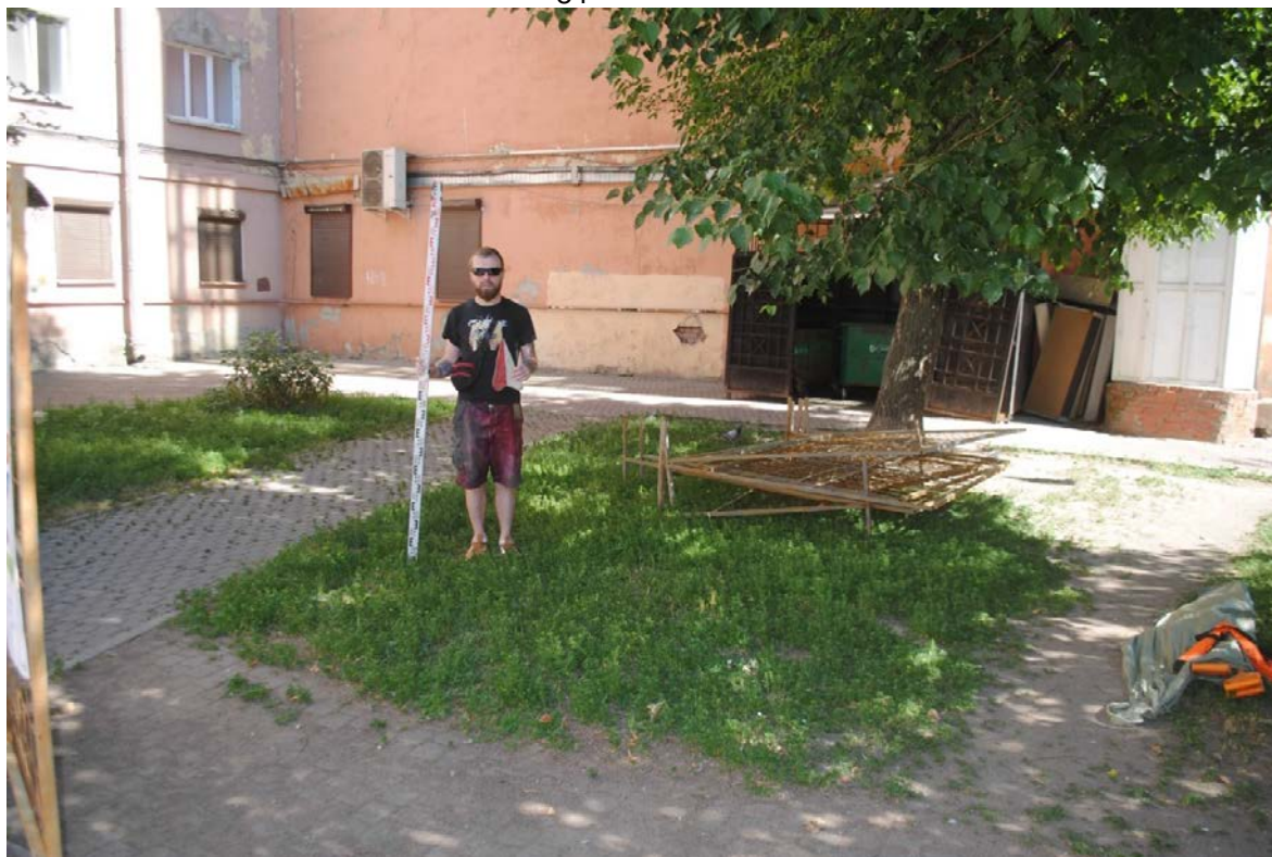
Рис. 32. Санкт-Петербург, Невский пр., между д. 148 и д. 150. Шурф 1. Фотофиксация до начала работ. Вид на север
