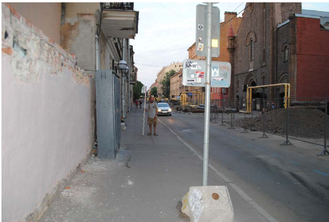
Рис. 31. Санкт-Петербург, сквер б/н на пересечении ул. Некрасова и ул. Маяковского. Общий вид участка обследования. Точка съёмки 7. Вид на восток
