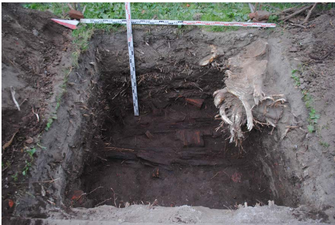
Рис. 33. Санкт-Петербург, сквер б/н на пересечении ул. Некрасова и ул. Маяковского. Шурф 1. Фотофиксация по уровню деревянной конструкции. Вид на восток
