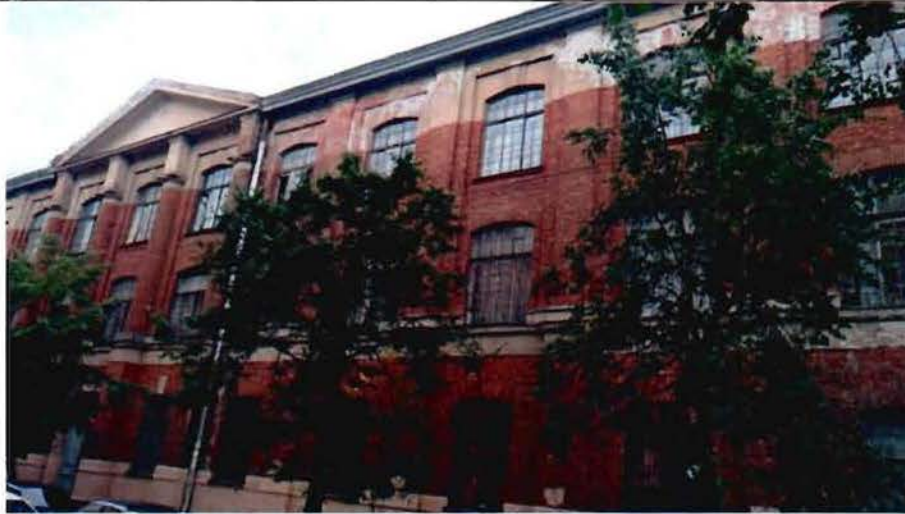
1. Фрагмент северо-восточного фасада
