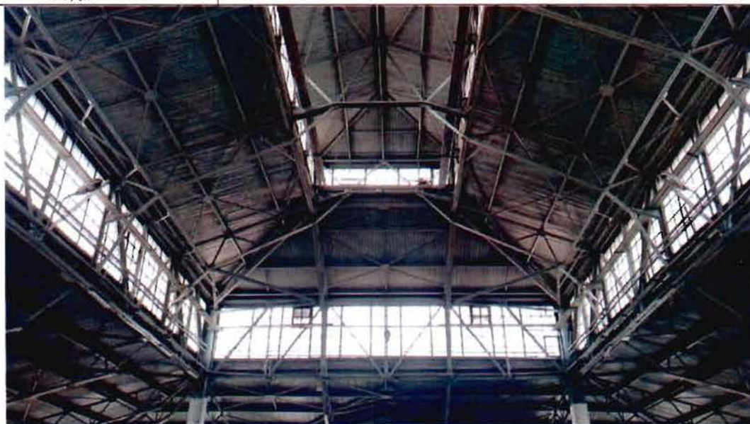
7. Металлоконструкции светового фонаря
