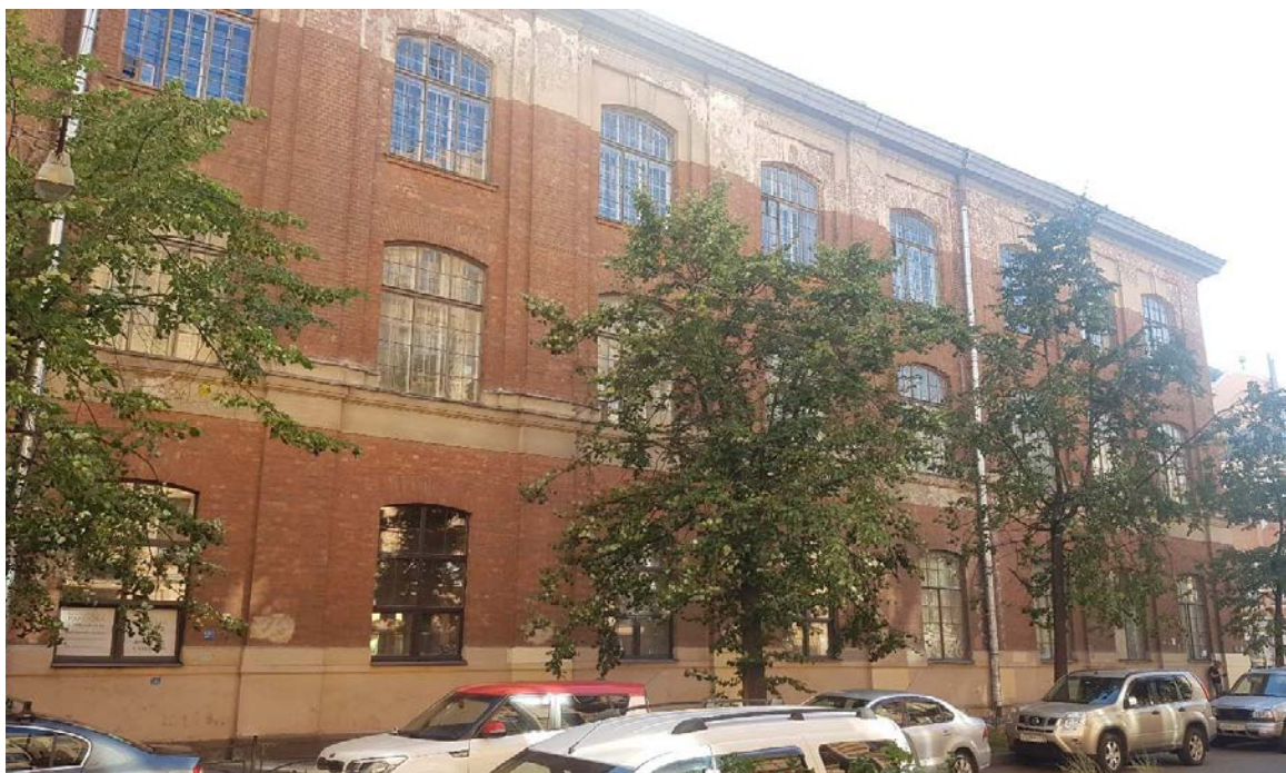
Фото 7. Лицевой фасад памятника по ул. Гатчинская. Правое крыло.
