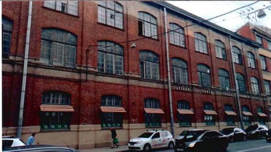
2. Фрагмент северо-западного фасада
