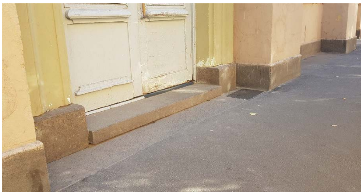
Фото 12. Лицевой фасад по ул. Гатчинская. Цоколь. Гранитная ступень.
