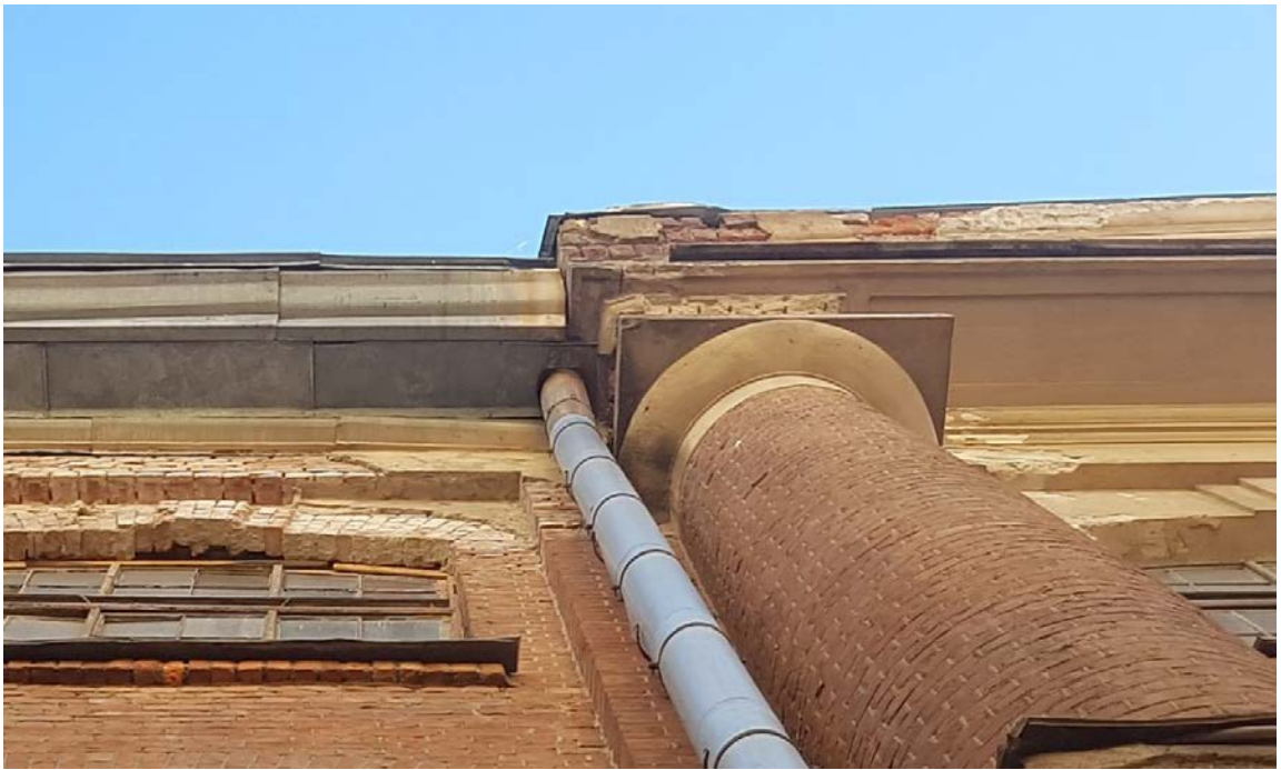
Фото 13. Лицевой фасад по ул. Гатчинская. Карниз.
