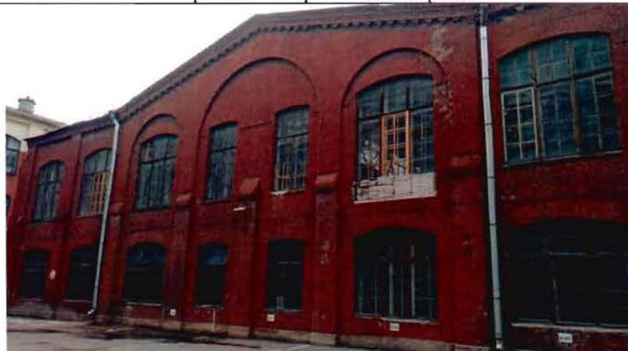
3. Фрагмент юго-западного фасада
