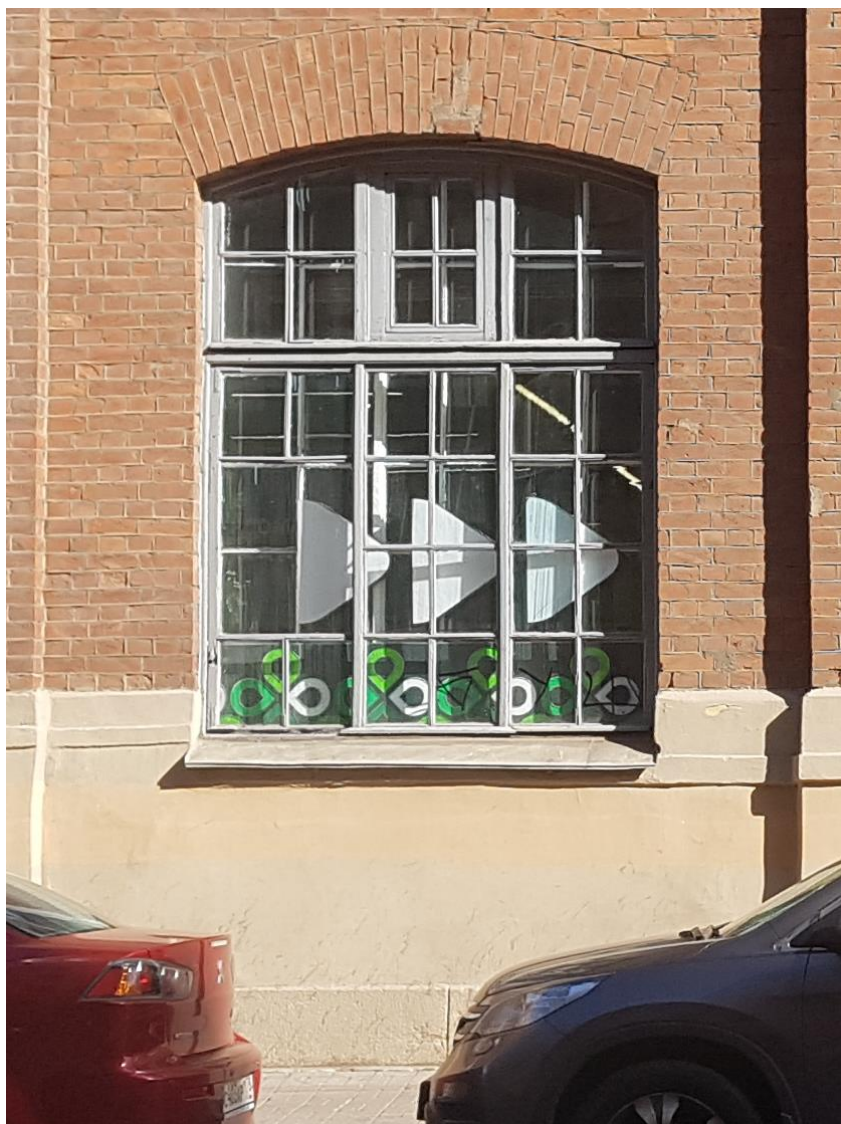
Фото 5. Лицевой фасад по Чкаловскому пр. Расстекловка окна в уровне 1-го этажа.
