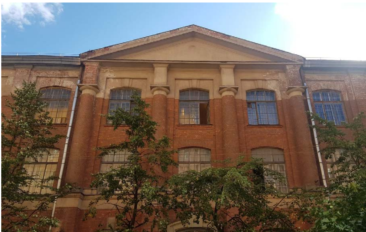
Фото 9. Лицевой фасад по ул. Гатчинская. Портик из трехчетвертных колонн по оси парадного входа, увенчанный фронтоном.
