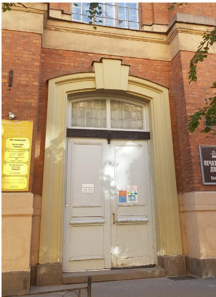
Фото 11. Лицевой фасад по ул. Гатчинская. Оформление парадного входа.
