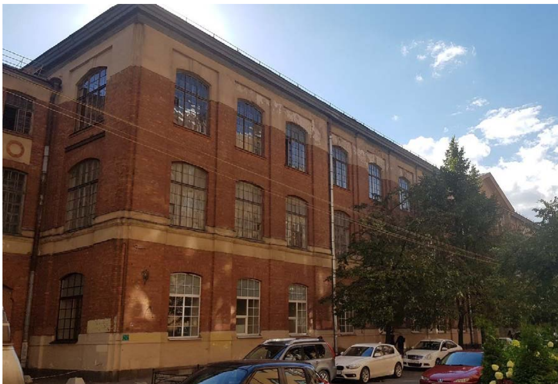
Фото 15. Лицевой фасад памятника по ул. Гатчинская. Левое крыло.
