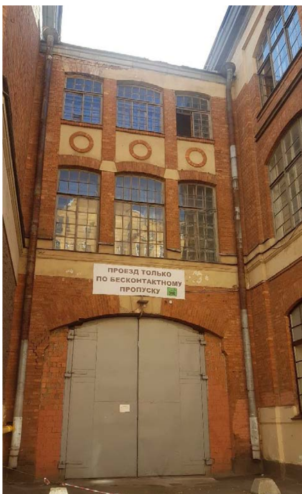
Фото 16. Лицевой фасад по ул. Гатчинская. Соединительный переход над проездной аркой.
