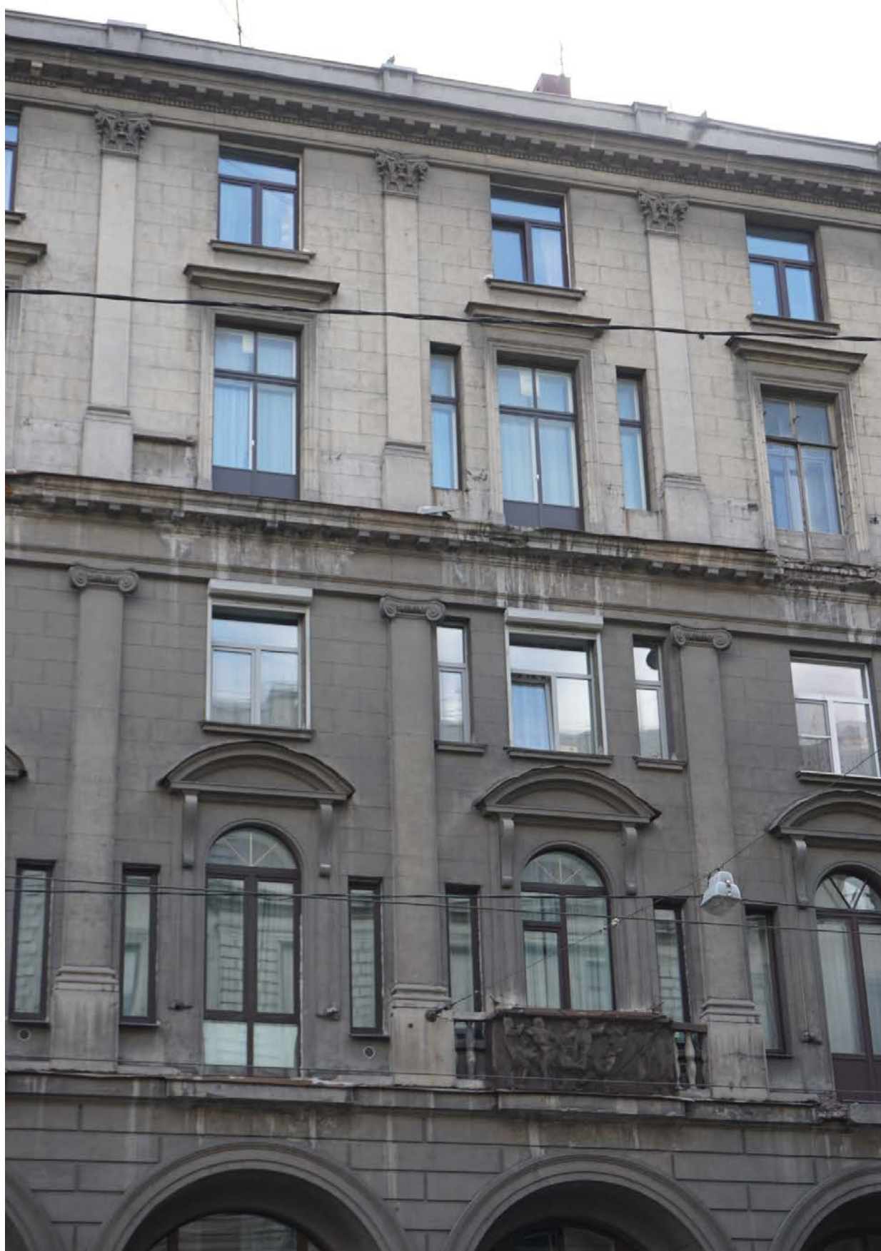
10. Дом Г.А. Бурмистрова. Ул. Куйбышева, д.3, лит.А. Фрагмент лицевого фасада в уровне 3-6 этажей.
