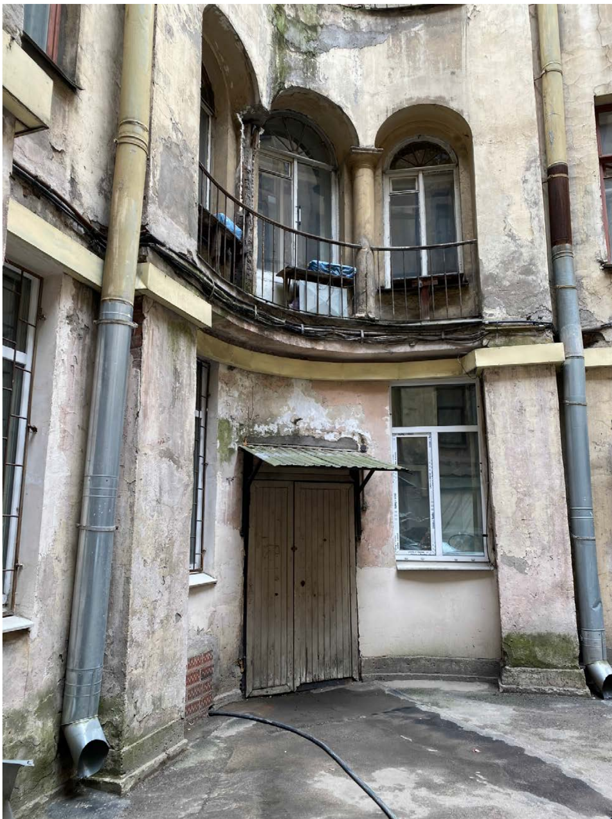
18. Дом Г.А. Бурмистрова. Ул. Куйбышева, д.3, лит.А. Северо-западный угол внутреннего двора в уровне 1-2 этажей.
