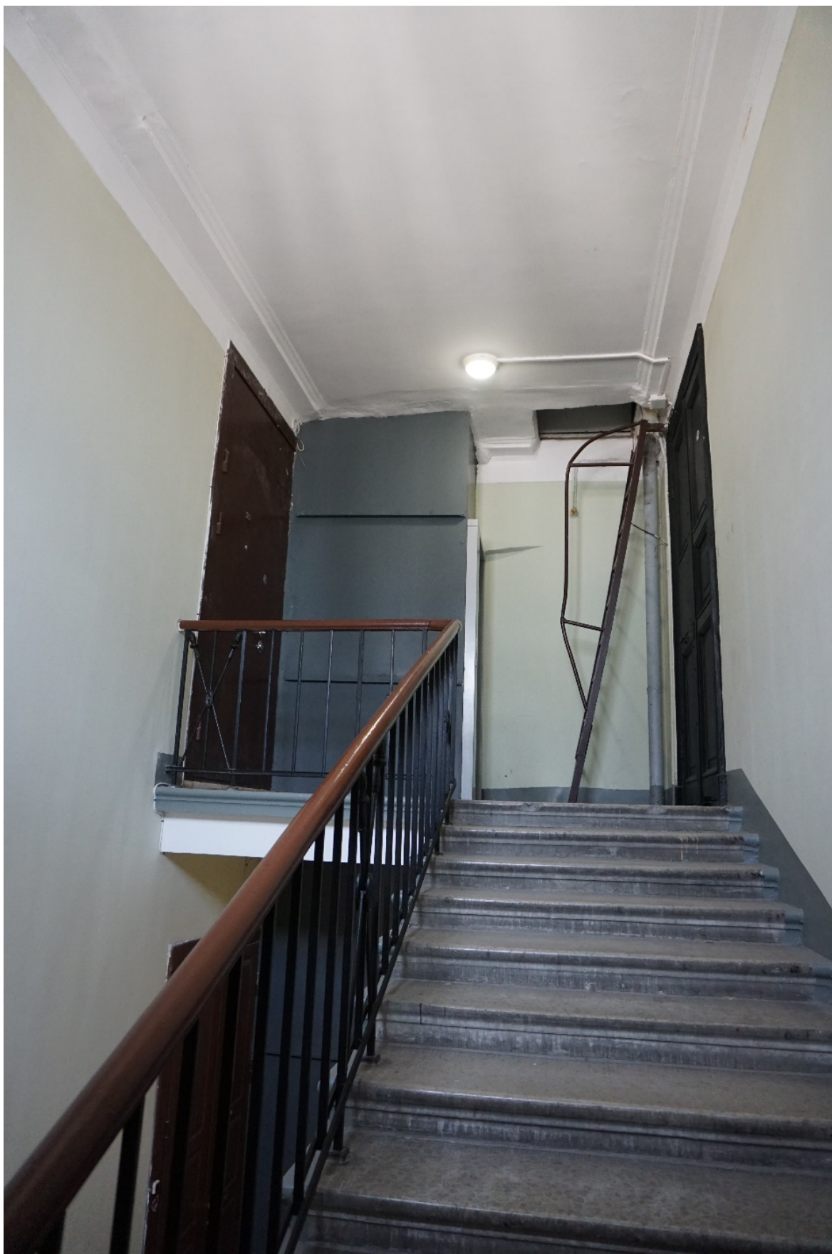
53. Дом Г.А. Бурмирова. Ул. Куйбышева, д.3, лит.А. Вид снизу на площадку 6 этажа лестницы заднего корпуса.
