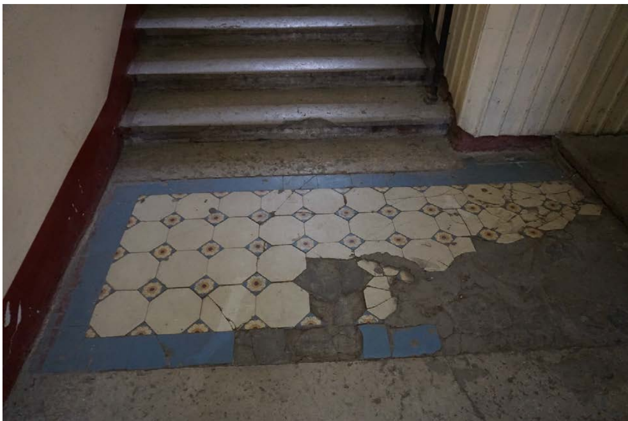
27. Дом Г.А. Бурмирова. Ул. Куйбышева, д.3, лит.А. Метлахская плитка парадной лестницы.
