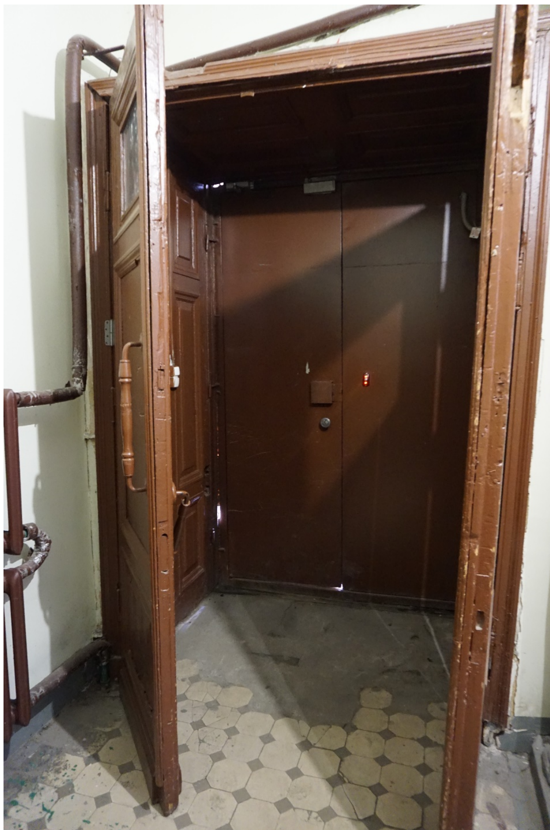
42. Дом Г.А. Бурмистрова. Ул. Куйбышева, д.3, лит.А. Тамбур лестницы заднего корпуса, вид из холла.
