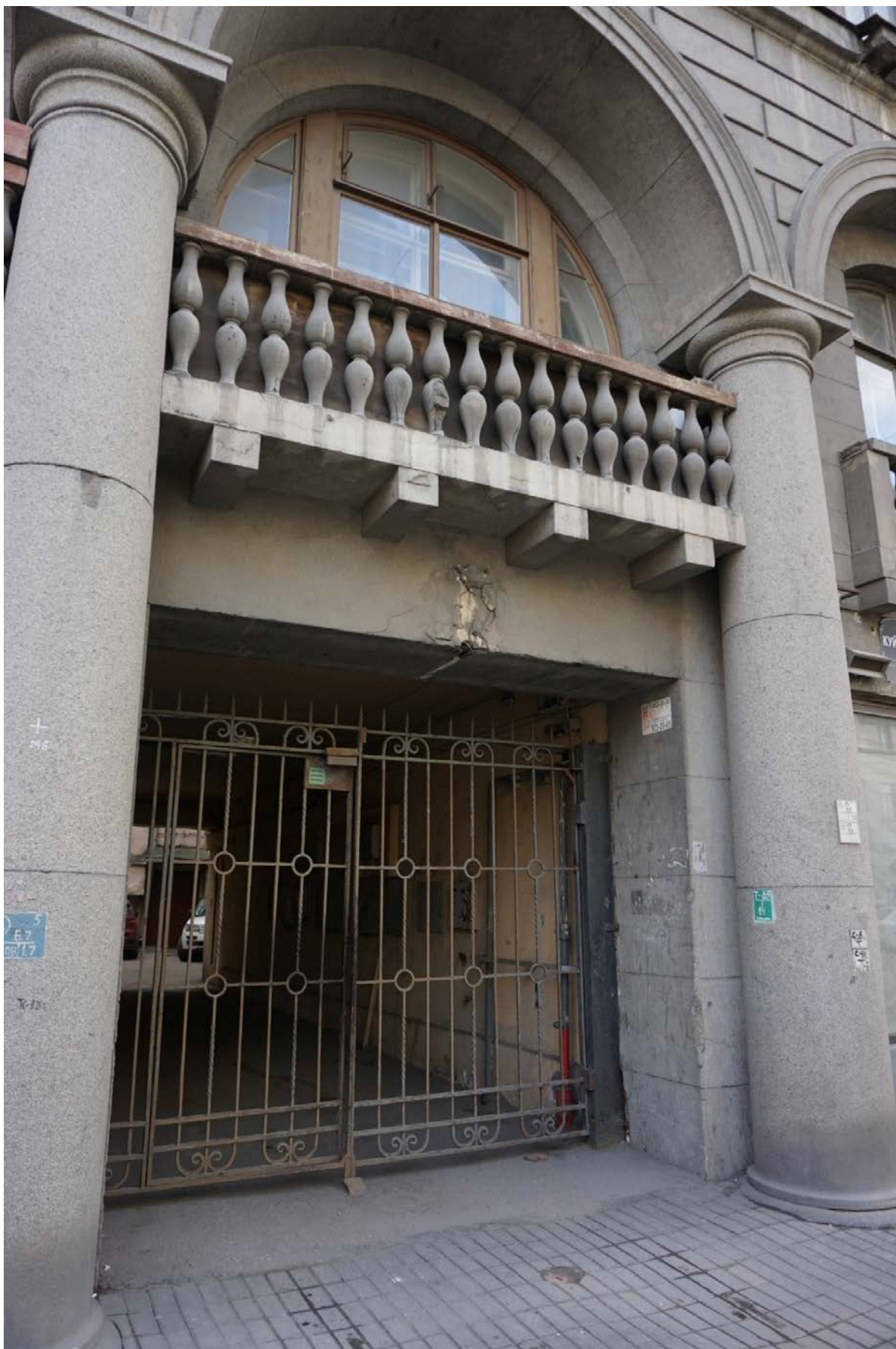
б. Дом Г.А. Бурмистрова. Ул. Куйбышева, д.3, лит.А. Вид на арку дворового проезда со стороны лицевого фасада.
