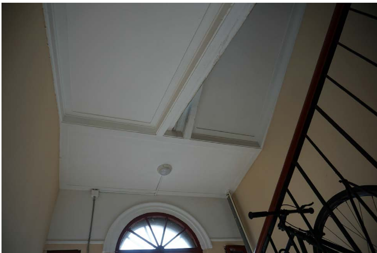
36. Дом Г.А. Бурмистрова. Ул. Куйбышева, д.3, лит.А. Вид на потолок площадки между 4 и 5 этажами парадной лестницы.
