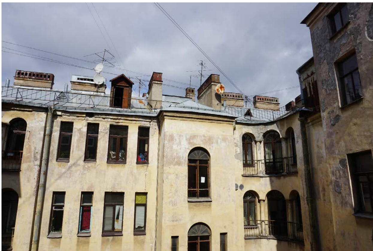
54. Дом Г.А. Бурмистрова. Ул. Куйбышева, д.3, лит.А. Фрагмент крыши лицевого фасада, вид из окна лестницы заднего корпуса.
