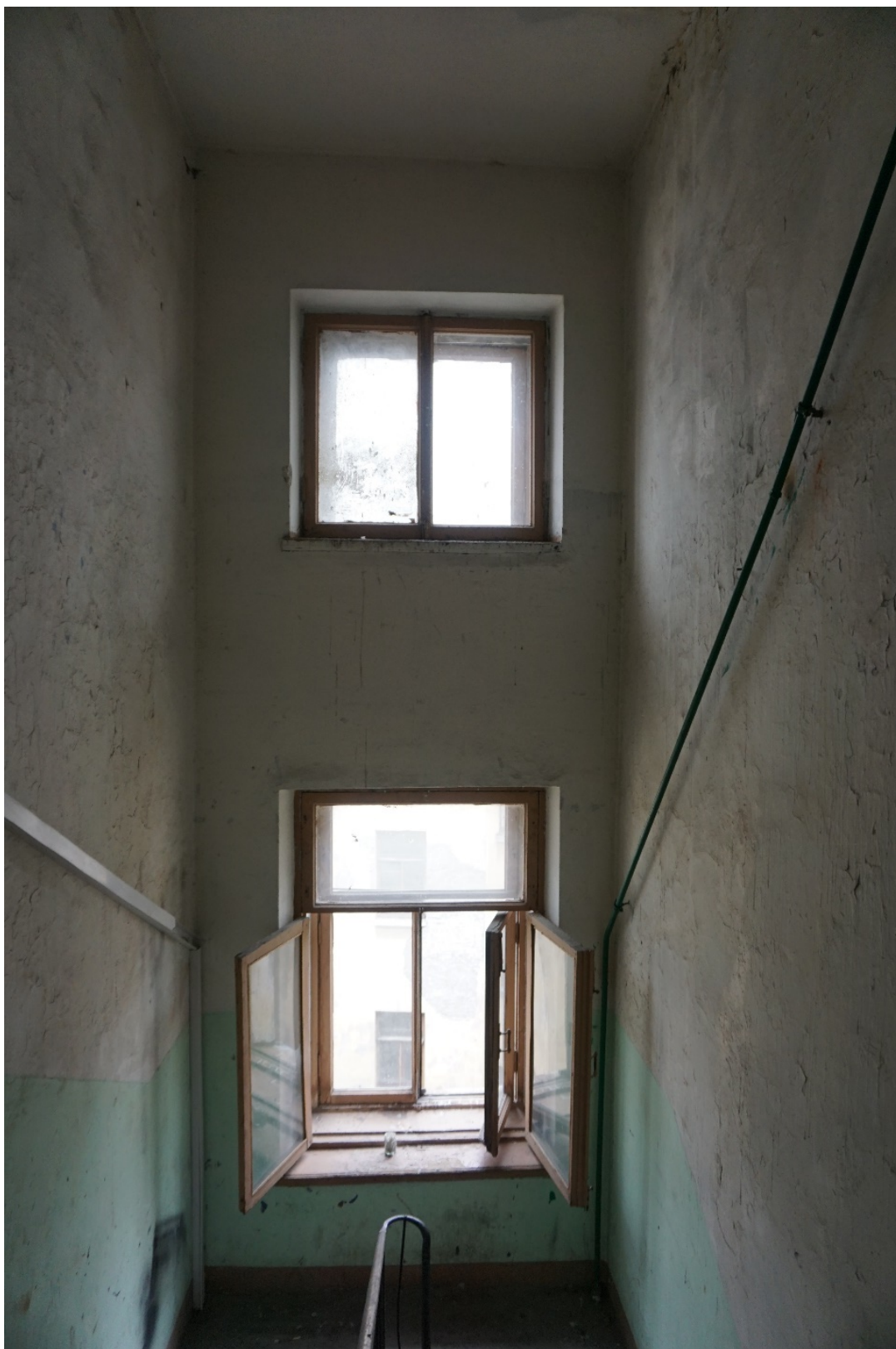
58. Дом Г.А. Бурмистрова. Ул. Куйбышева, д.3, лит.А. Лестница бокового (северо-восточного) дворового корпуса. Вид с верхней площадки.
