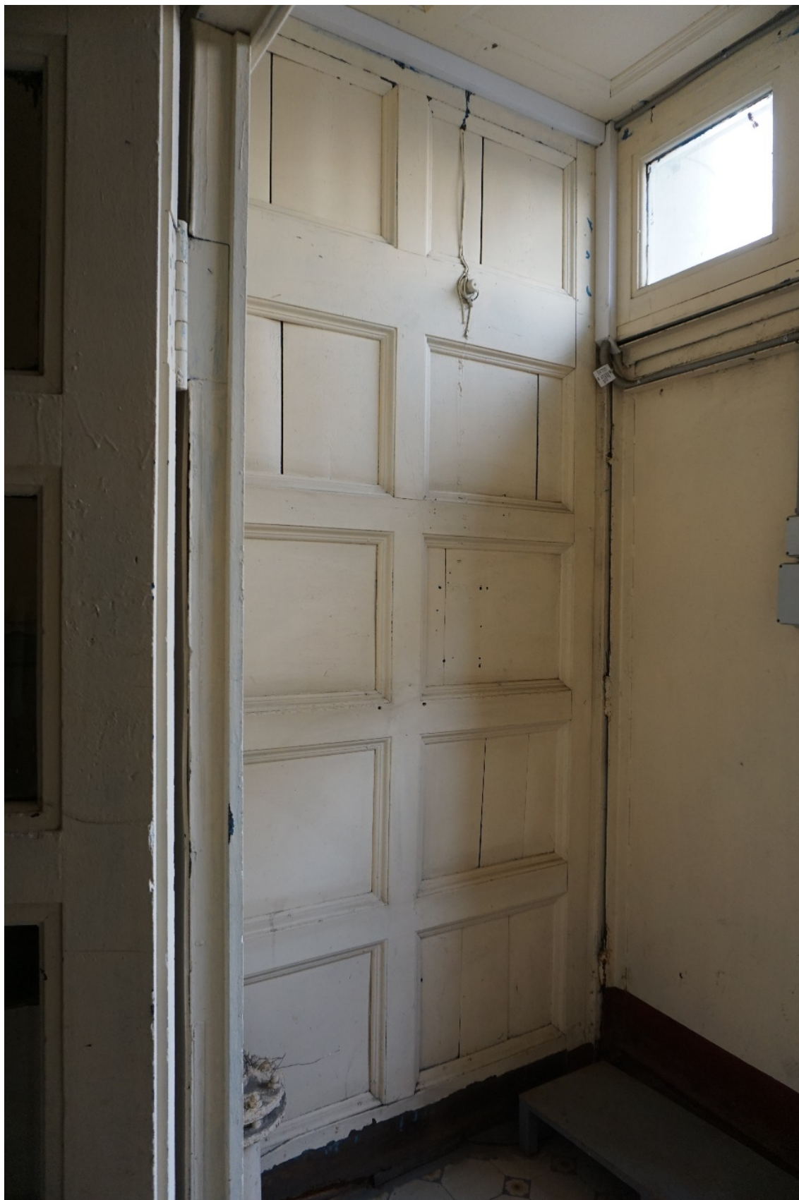
23. Дом Г.А. Бурмирова. Ул. Куйбышева, д.3, лит.А. Фрагмент филенчатой деревянной отделки тамбура парадной лестницы.
