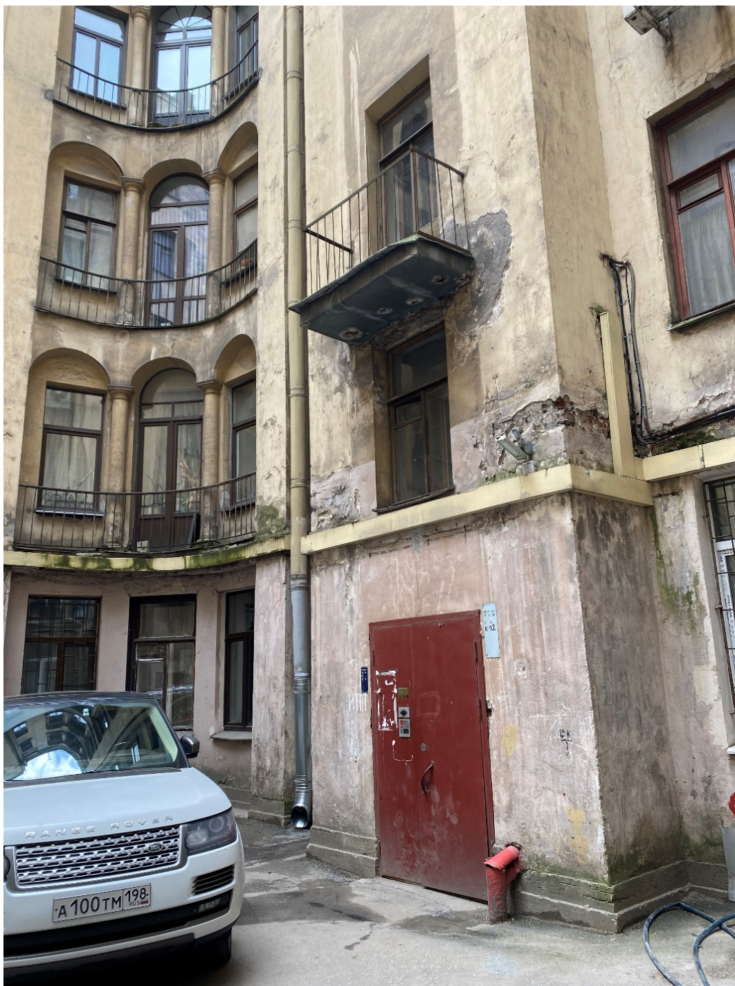
20. Дом Г.А. Бурмирова. Ул. Куйбышева, д.3, лит.А. Вид на северо-восточный угол внутреннего двора в уровне 1-4 этажей.
