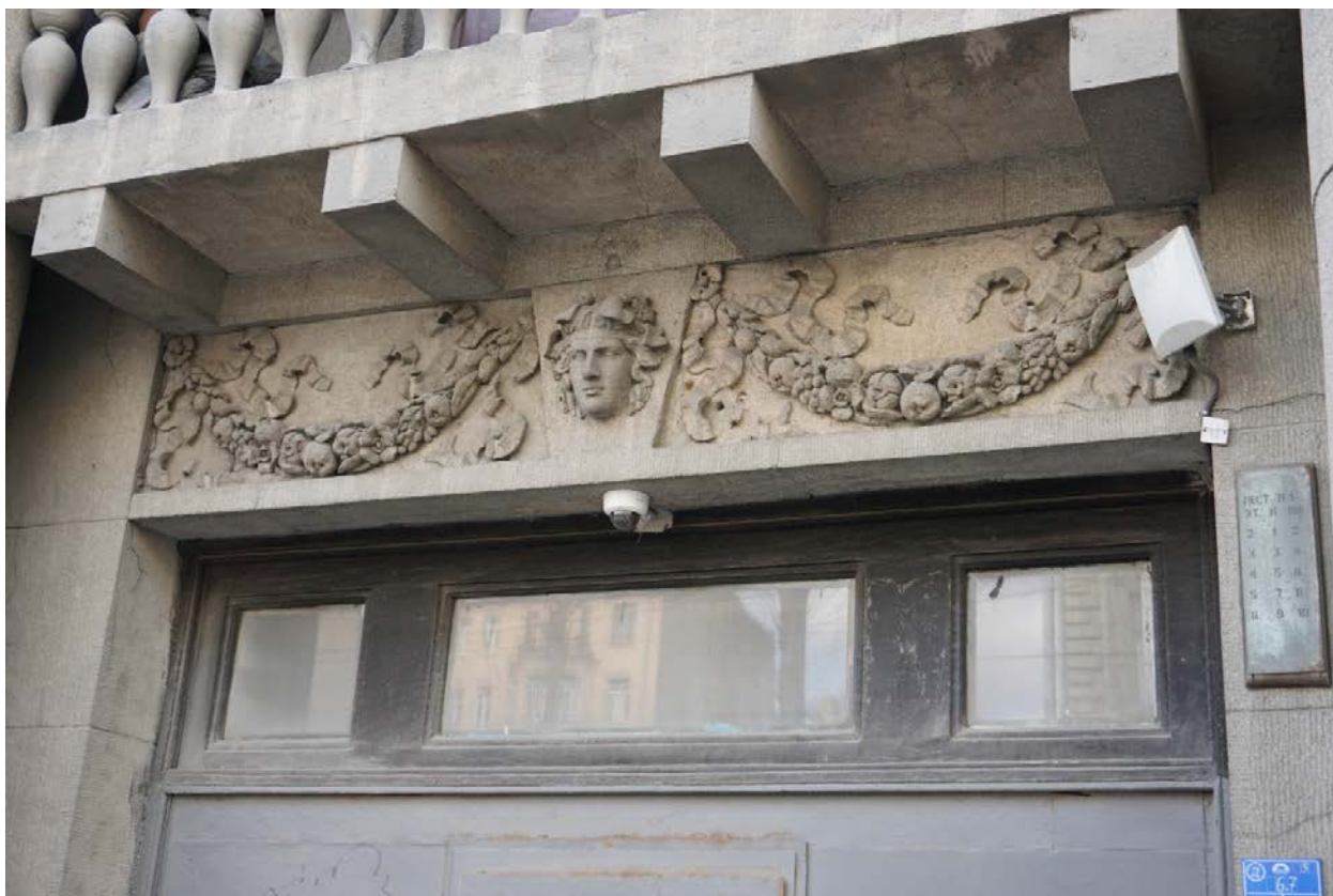
4. Дом Г.А. Бурмистрова. Ул. Куйбышева, д.3, лит.А. Верхняя часть фходной группы лицевого фасада.
