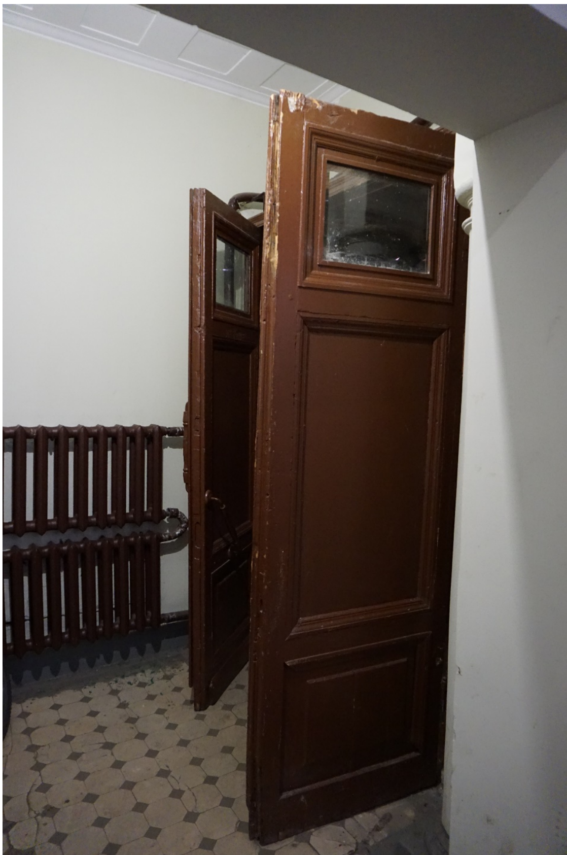
43. Дом Г.А. Бурмирова. Ул. Куйбышева, д.3, лит.А. Внутренние двери тамбура лестницы заднего корпуса.
