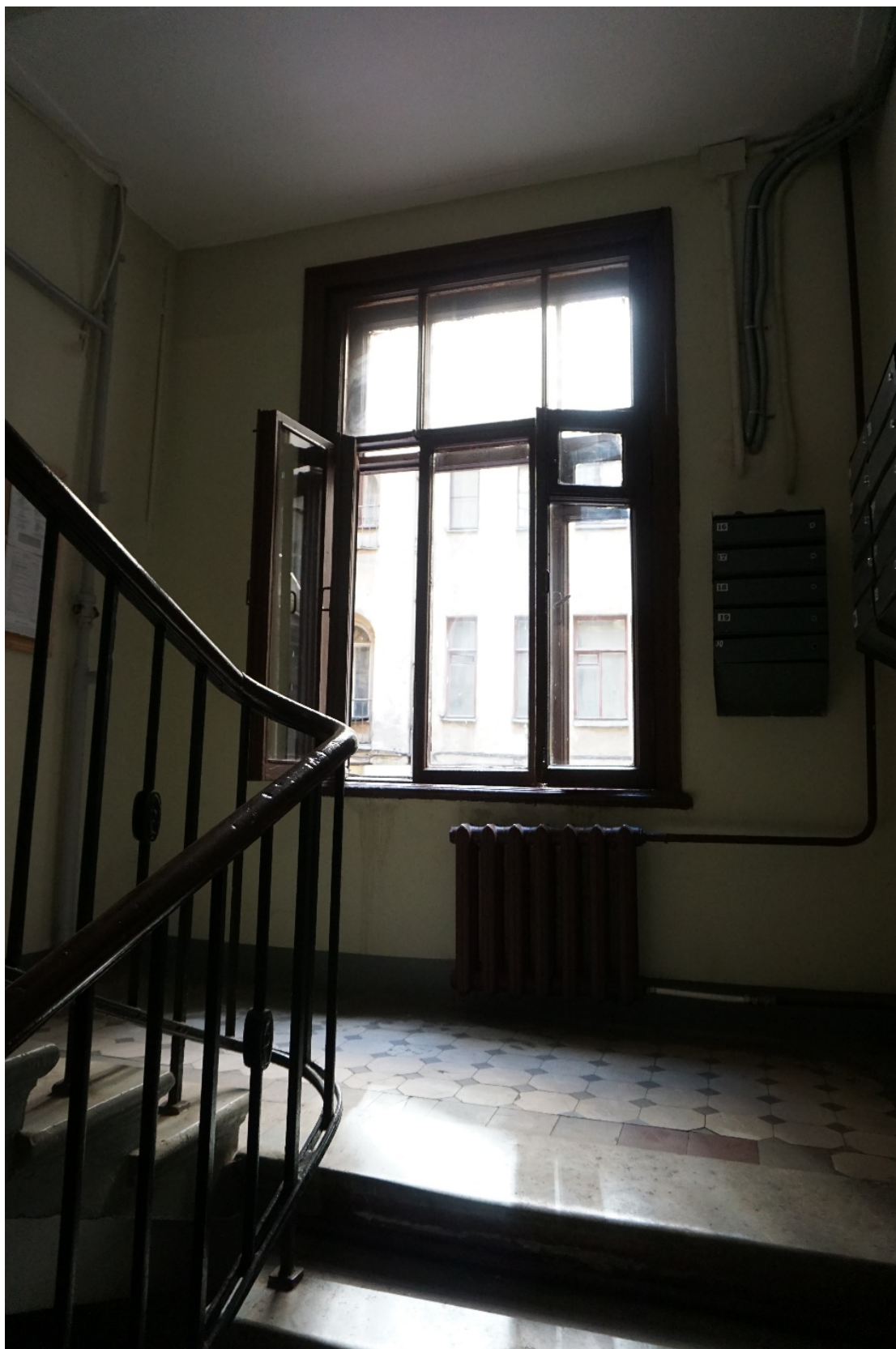
49. Дом Г.А. Бурмирова. Ул. Куйбышева, д.3, лит.А. Межэтажная площадка лестницы заднего корпуса.
