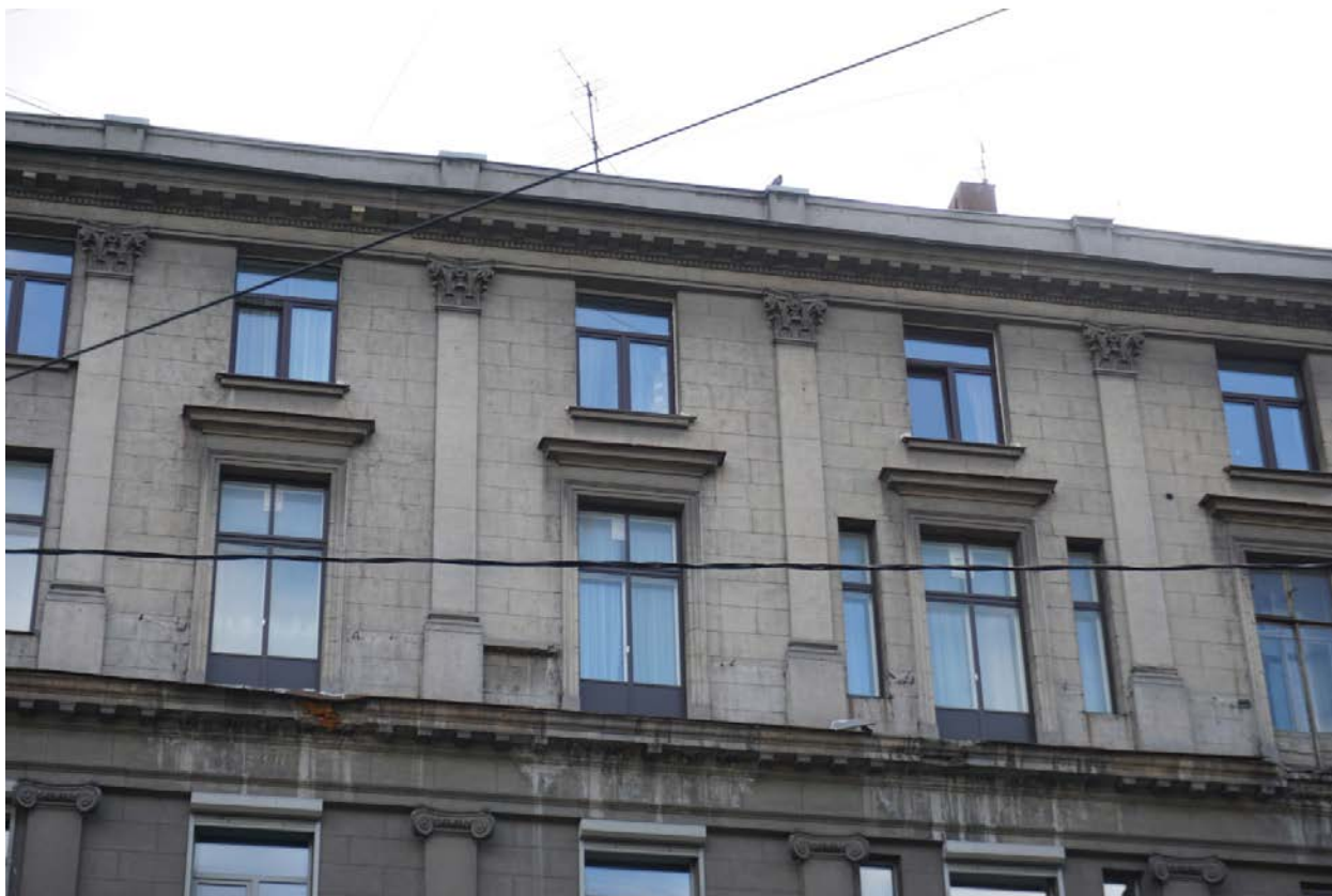
11. Дом Г.А. Бурмистрова. Ул. Куйбышева, д.3, лит.А. Фрагмент лицевого фасада в уровне 5-6 этажей.
