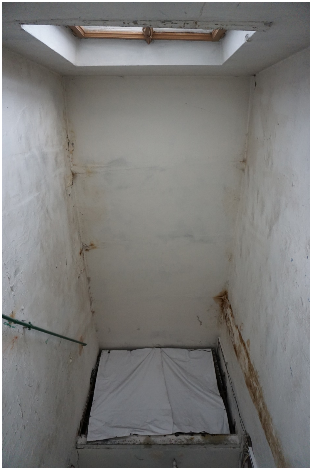
59. Дом Г.А. Бурмирова. Ул. Куйбышева, д.3, лит.А. Лестница бокового (северо-восточного) дворового корпуса. Потолок 6 этажа.
