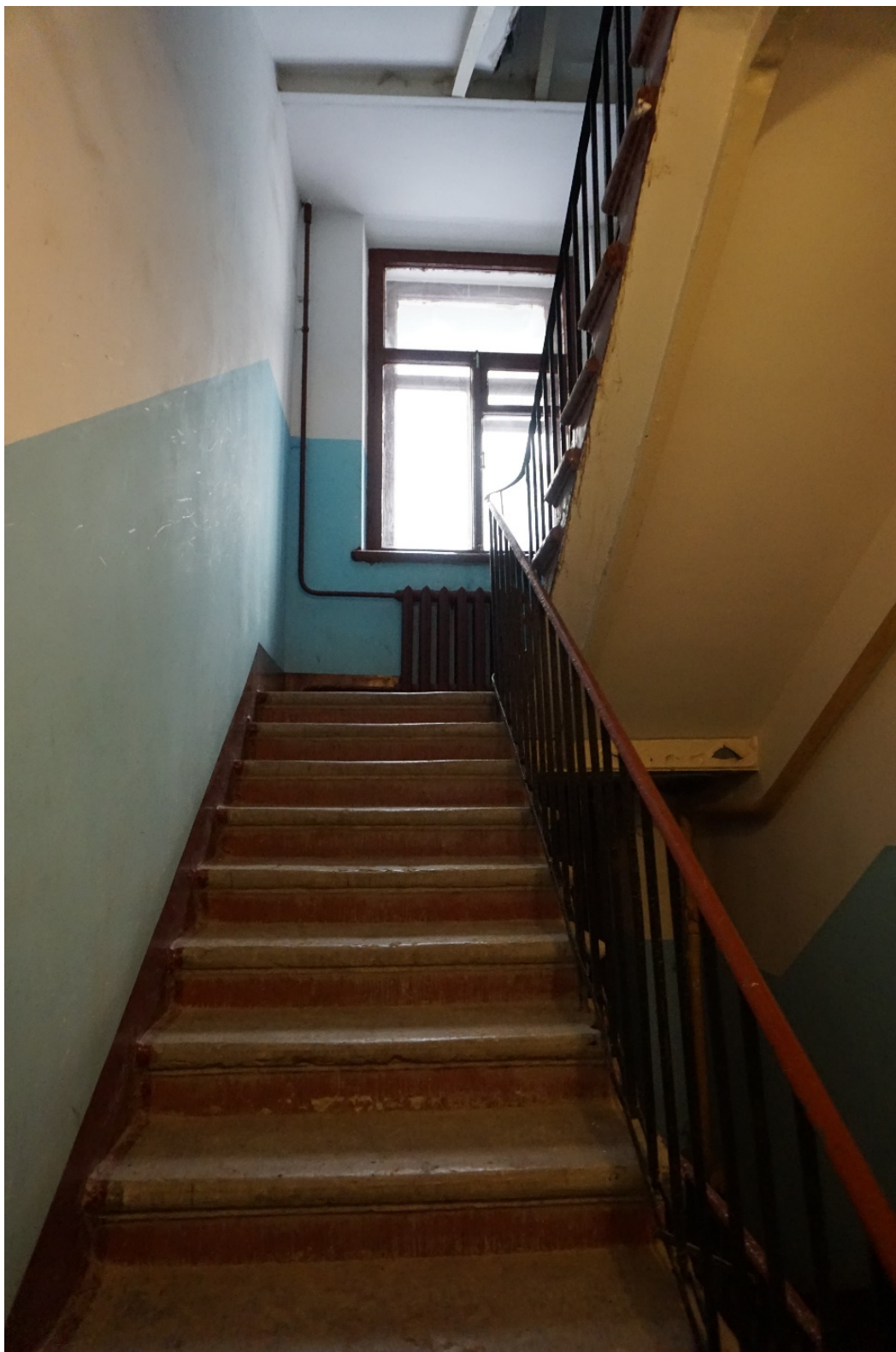
56. Дом Г.А. Бурмистрова. Ул. Куйбышева, д.3, лит.А. Лестница бокового (северо-восточного) дворового корпуса. Вид наверх с площадки 1 этажа.
