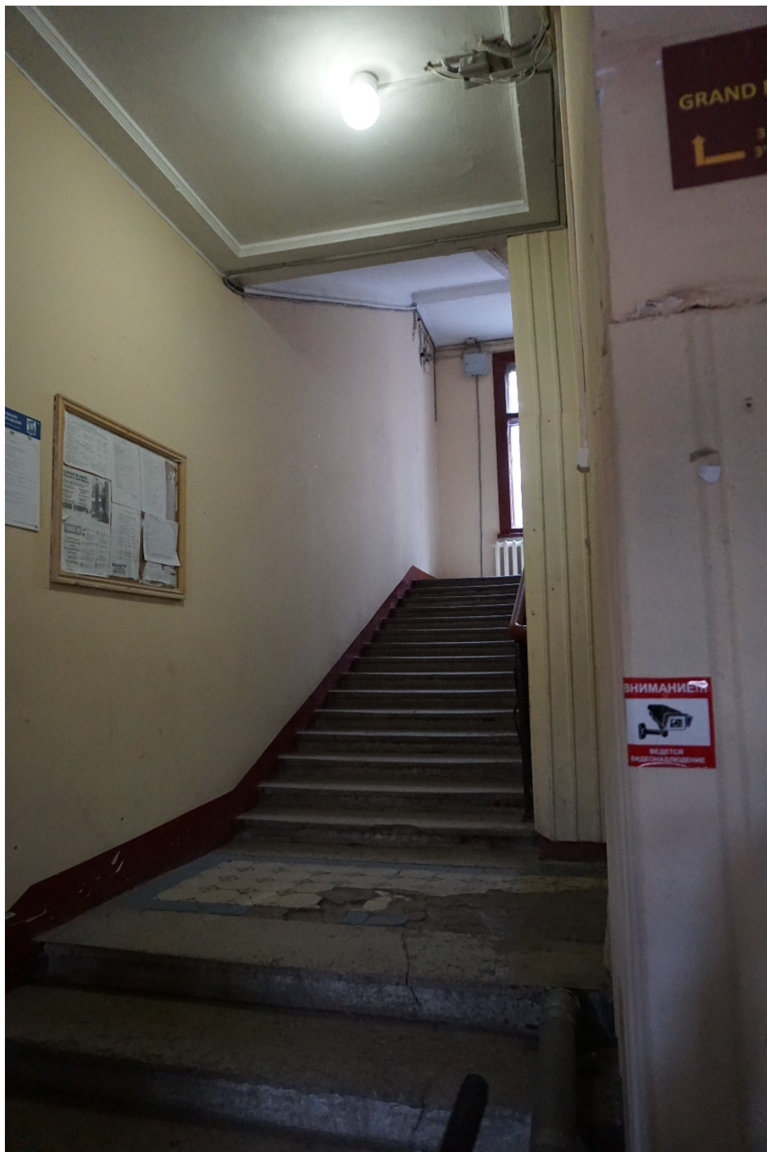
26. Дом Г.А. Бурмирова. Ул. Куйбышева, д.3, лит.А. Парадная лестница. Вид на лестницу из холла.
