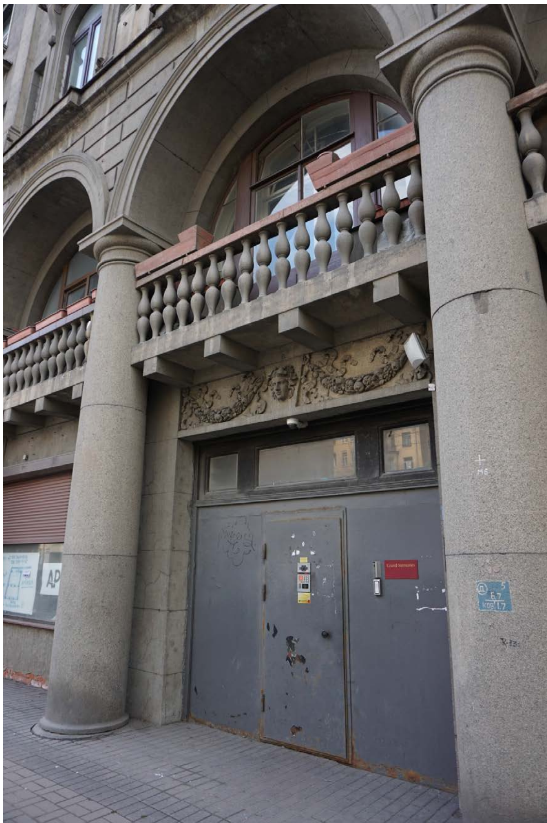
3. Дом Г.А. Бурмирова. Ул. Куйбышева, д.3, лит.А. Лицевой фасад. Вход на парадную лестницу.
