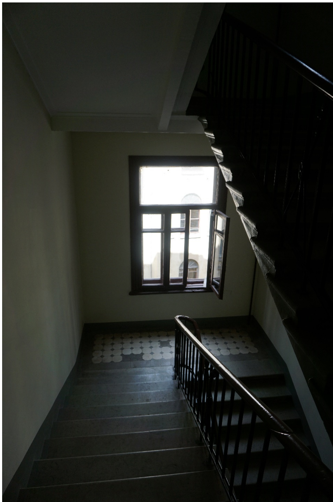
50. 2. Дом Г.А. Бурмистрова. Ул. Куйбышева, д.3, лит.А. Вид сверху на межэтажную площадку лестницы заднего корпуса.
