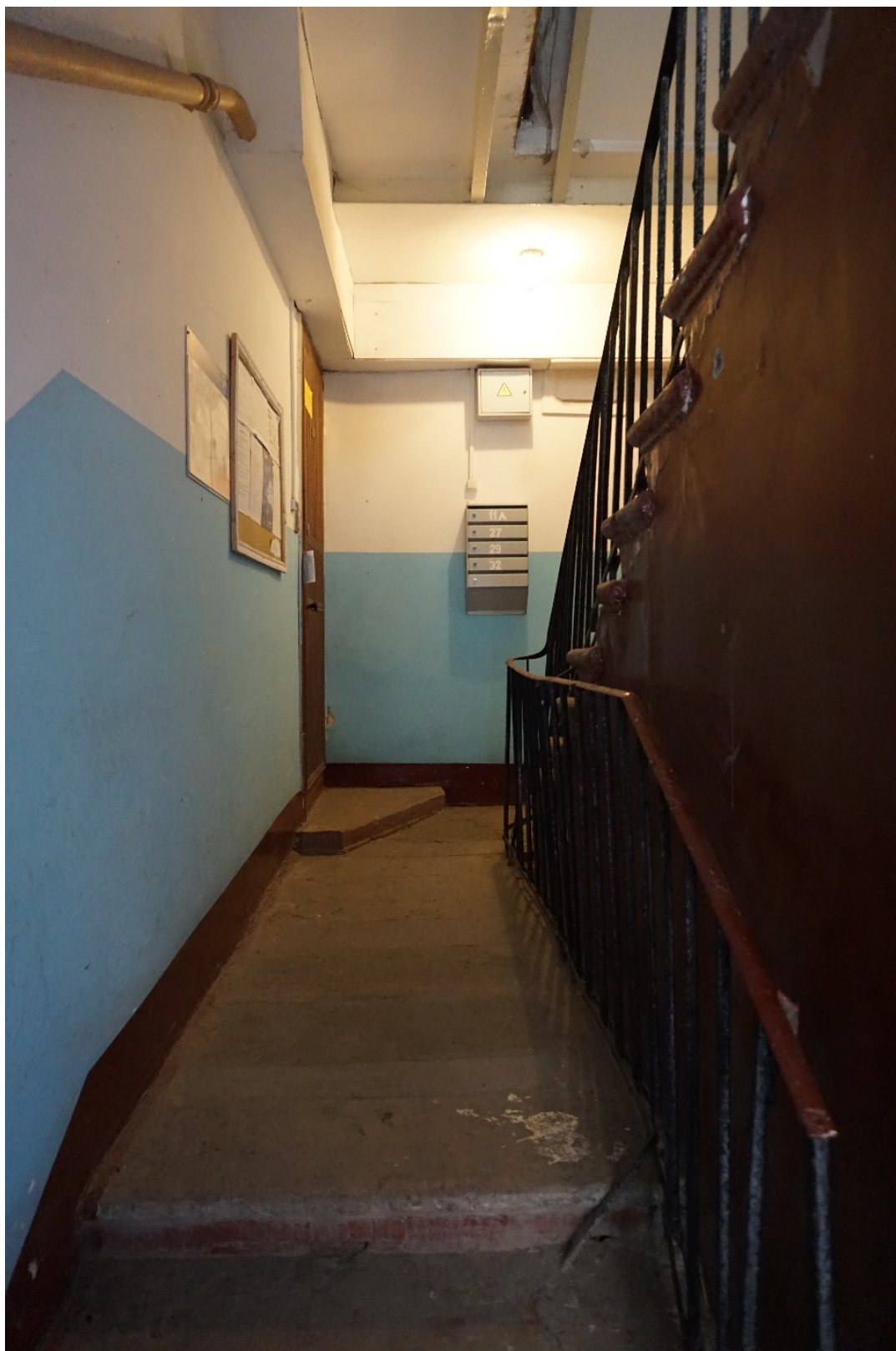
55. Дом Г.А. Бурмирова. Ул. Куйбышева, д.3, лит.А. Лестница бокового (северо-восточного) дворового корпуса. Вид из холла на площадку 1 этажа.
