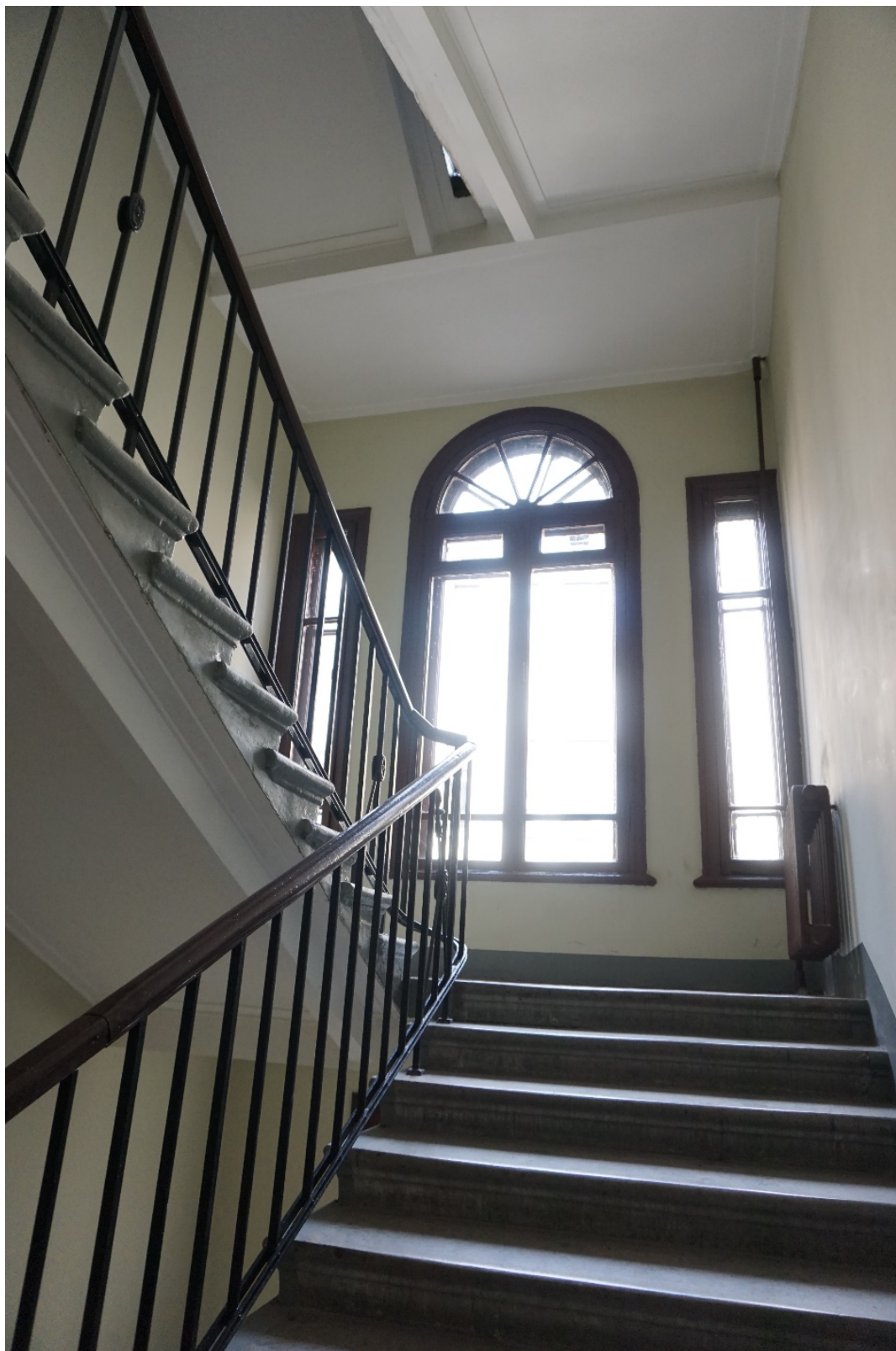
51. Дом Г.А. Бурмистрова. Ул. Куйбышева, д.3, лит.А. Вид снизу на площадку между 4 и 5 этажами лестницы заднего корпуса.
