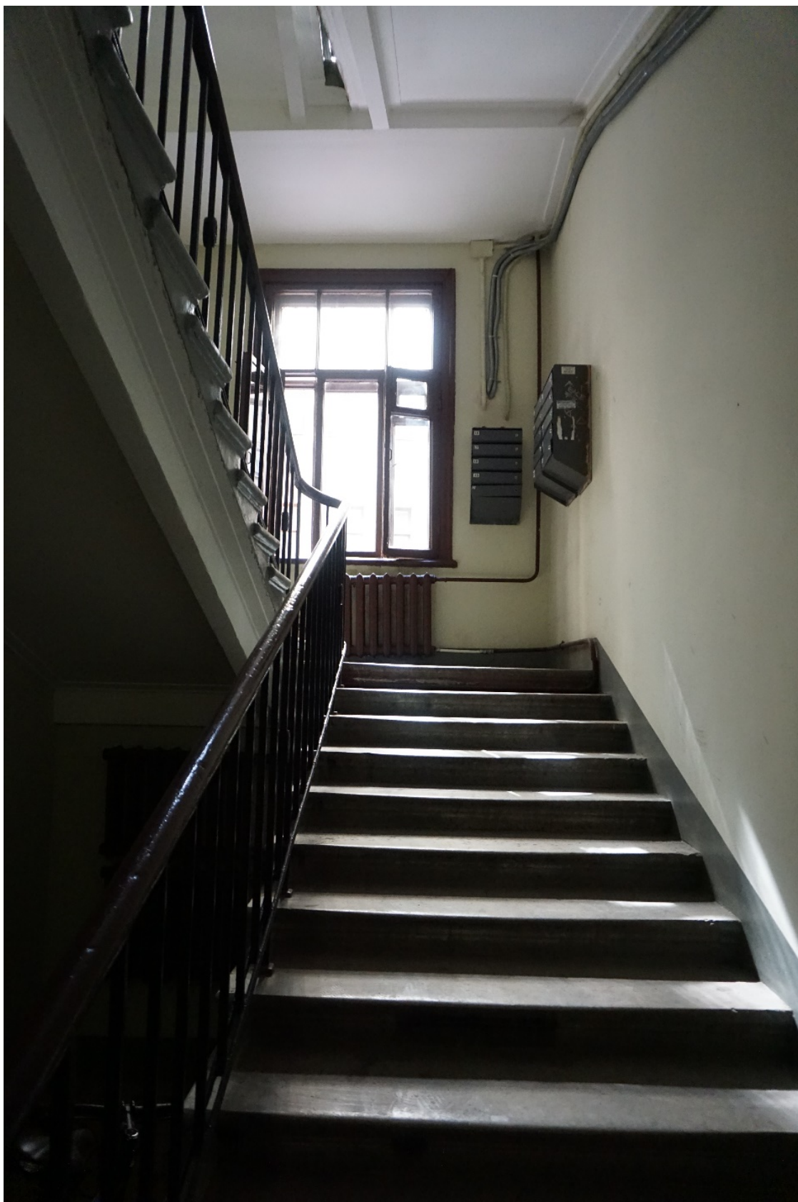
48. Дом Г.А. Бурмирова. Ул. Куйбышева, д.3, лит.А. Вид снизу на межэтажную площадку лестницы заднего корпуса.
