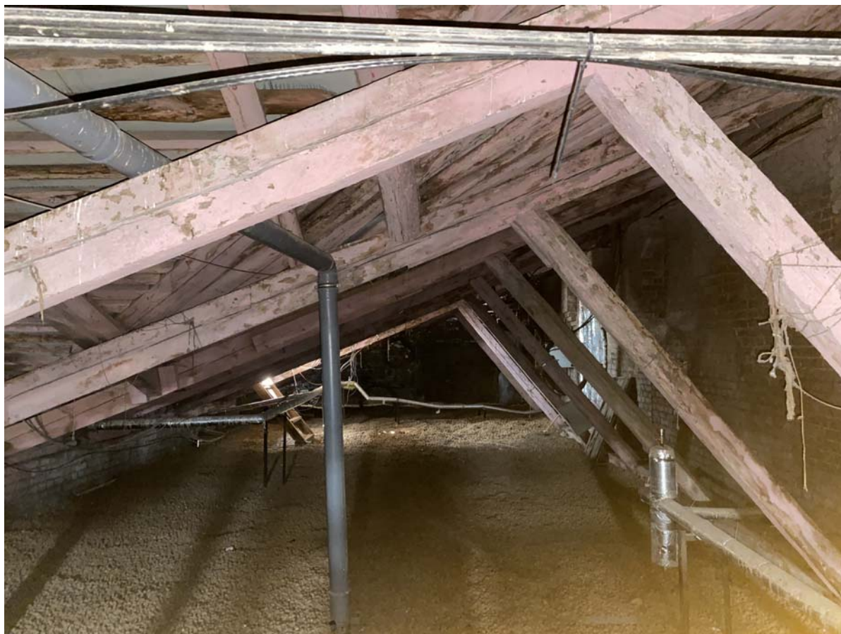
16. Стропильная система здания. Фрагмент.
