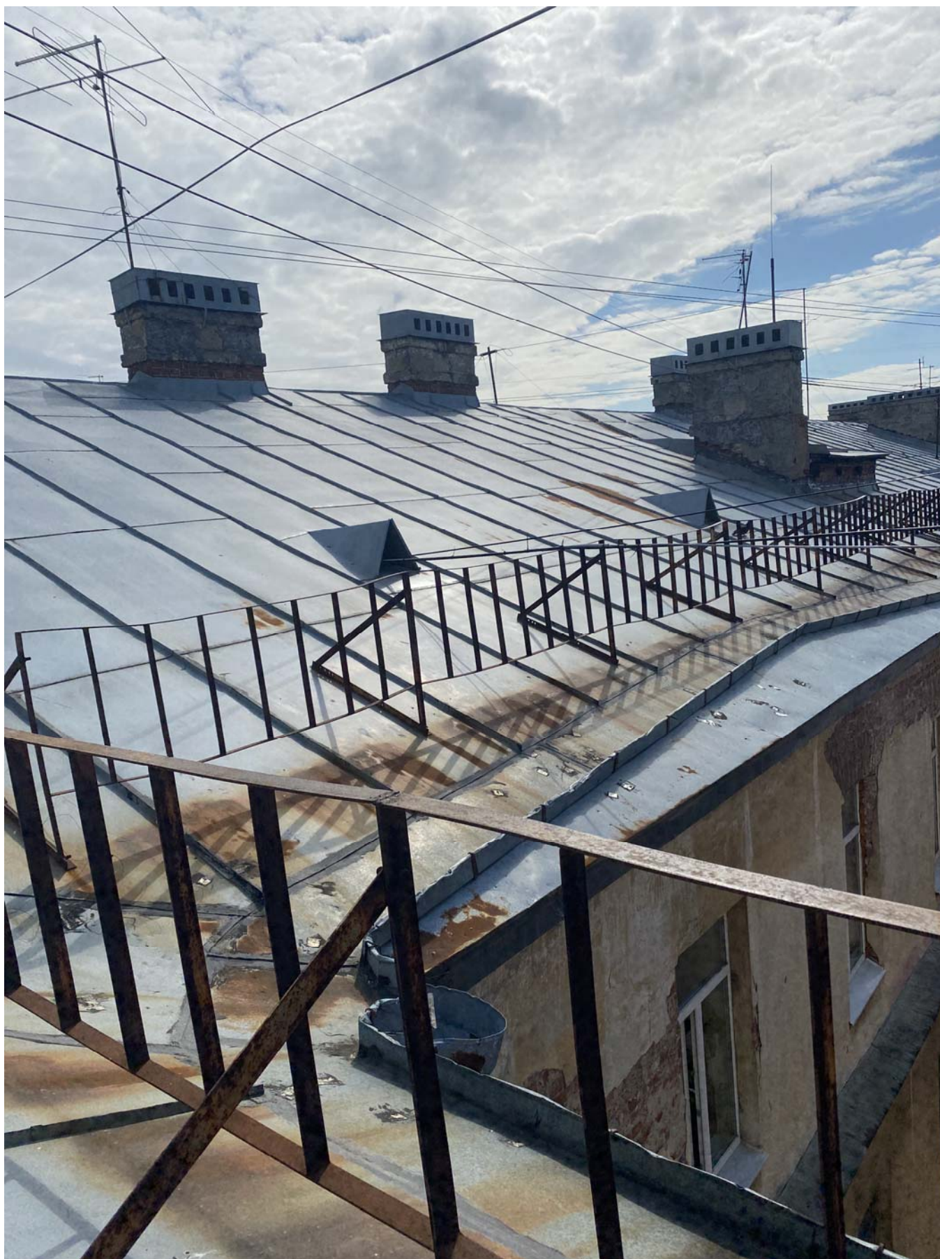
20. Окрытие кровли. Фрагмент
