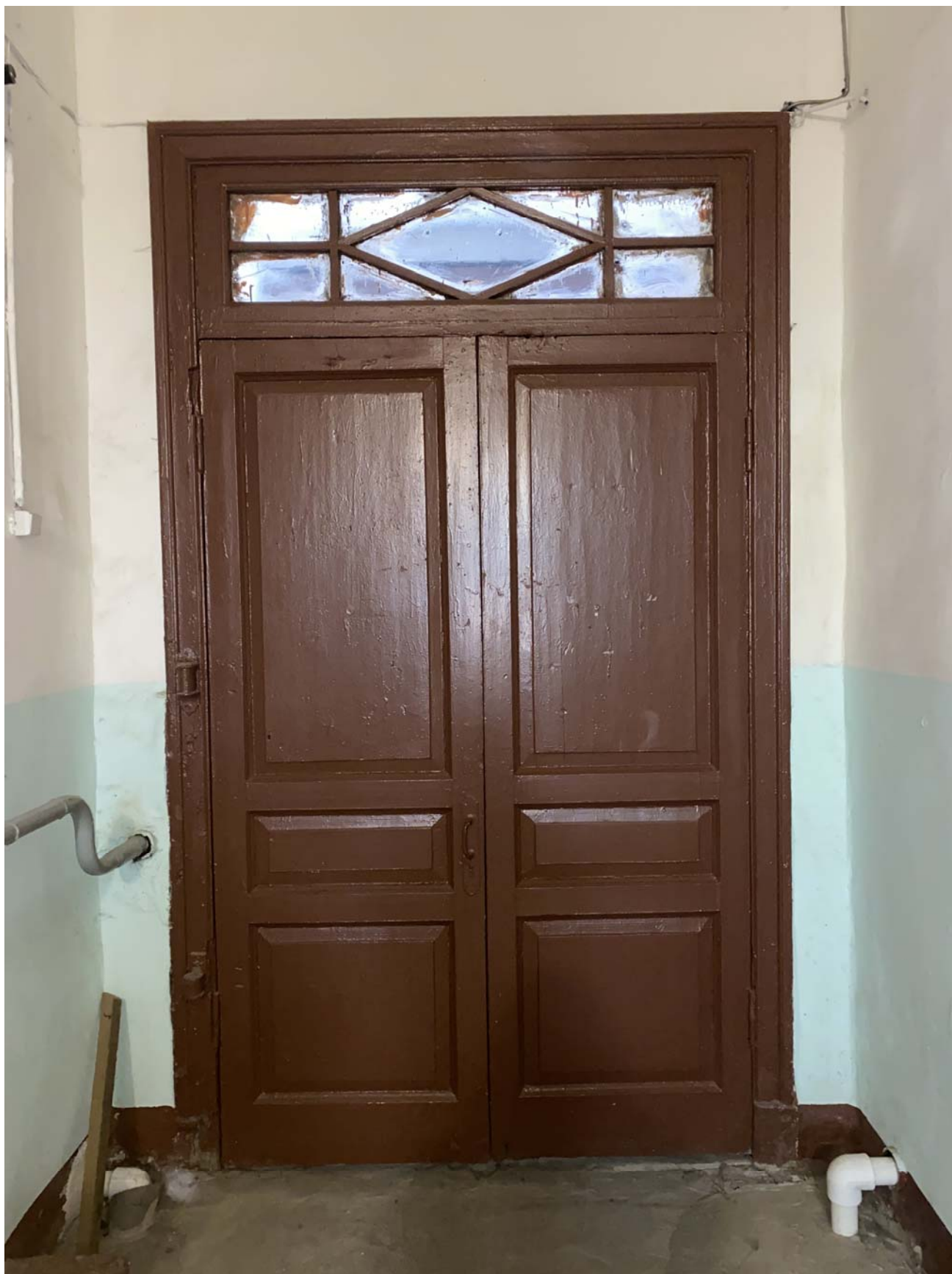
41. Дверное заполнение в вестибюле ЛК 5
