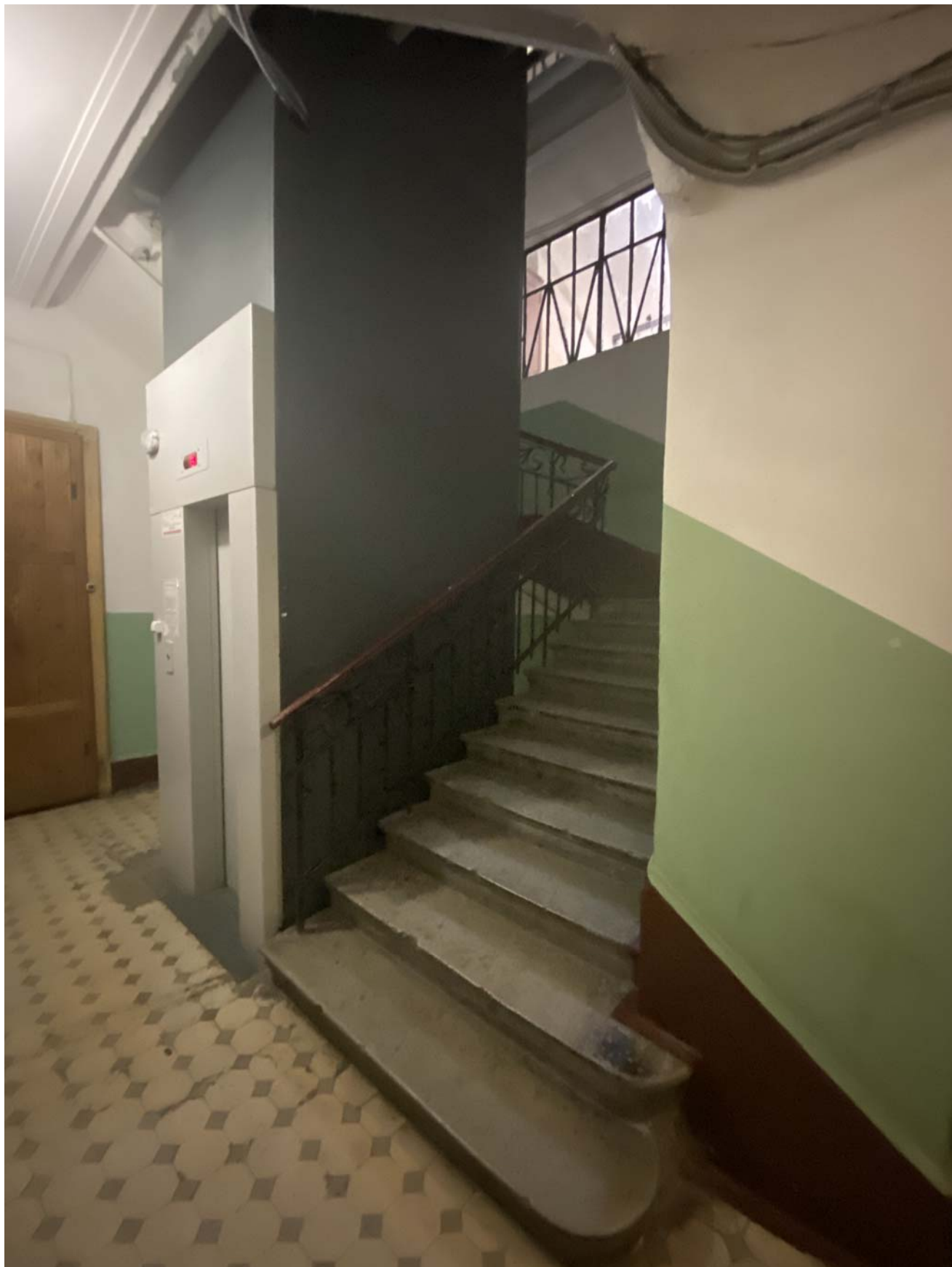
31.Площадка 1 этажа ЛК2
