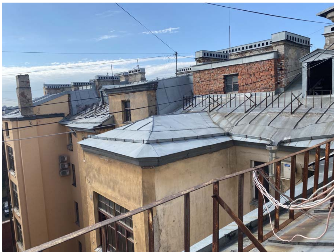
19. Окрытие кровли. Фрагмент
