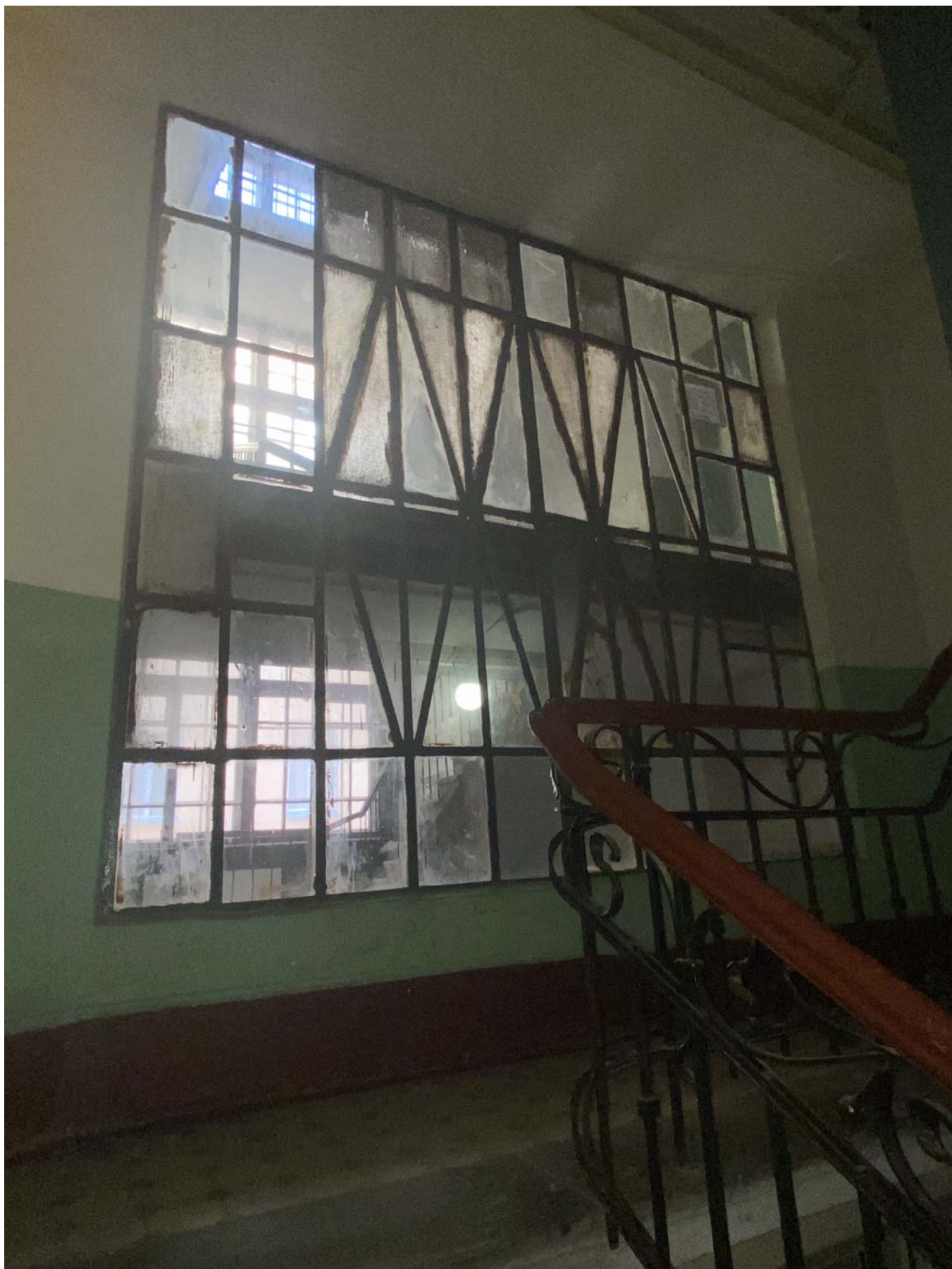
27. Междуетажная площадка ЛК 1
