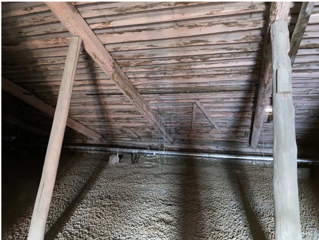
15. Стропильная система здания. Фрагмент.
