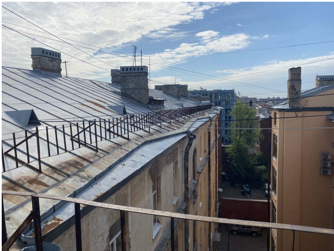
18. Окрытие кровли. Фрагмент
