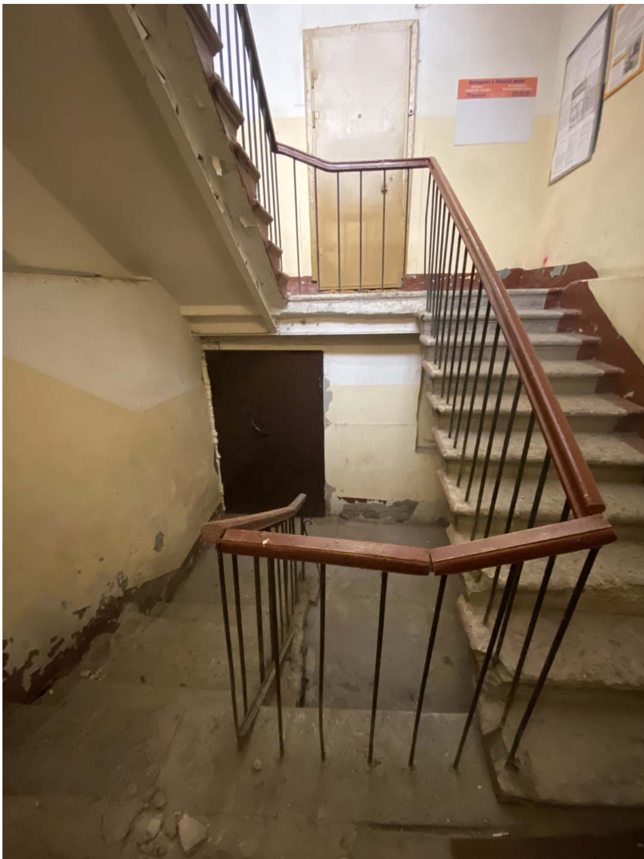
37. Площадка 1 этажа ЛК 3
