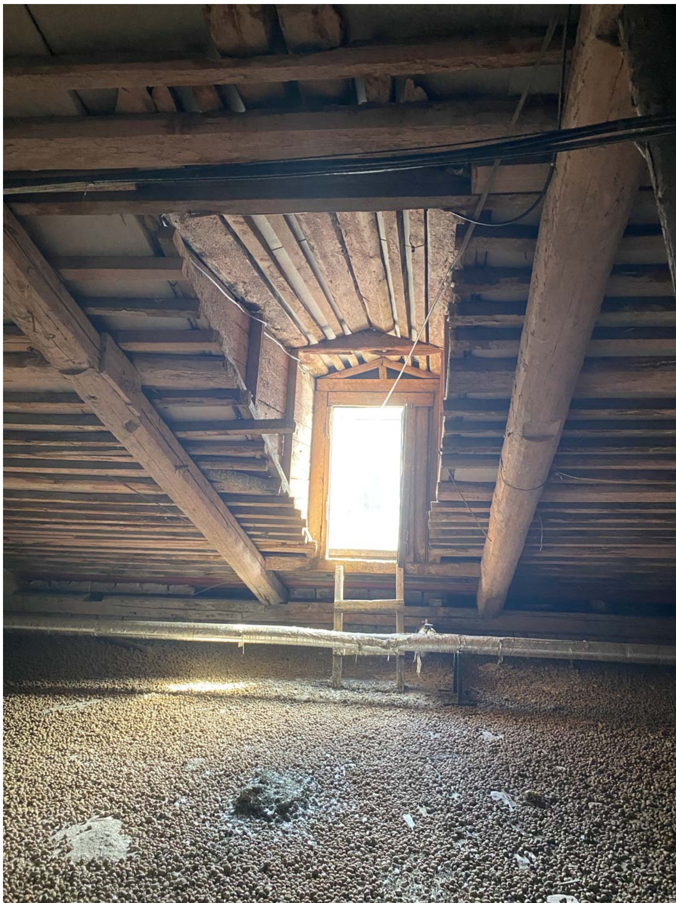
17. Стропильная система здания.Фрагмент.
