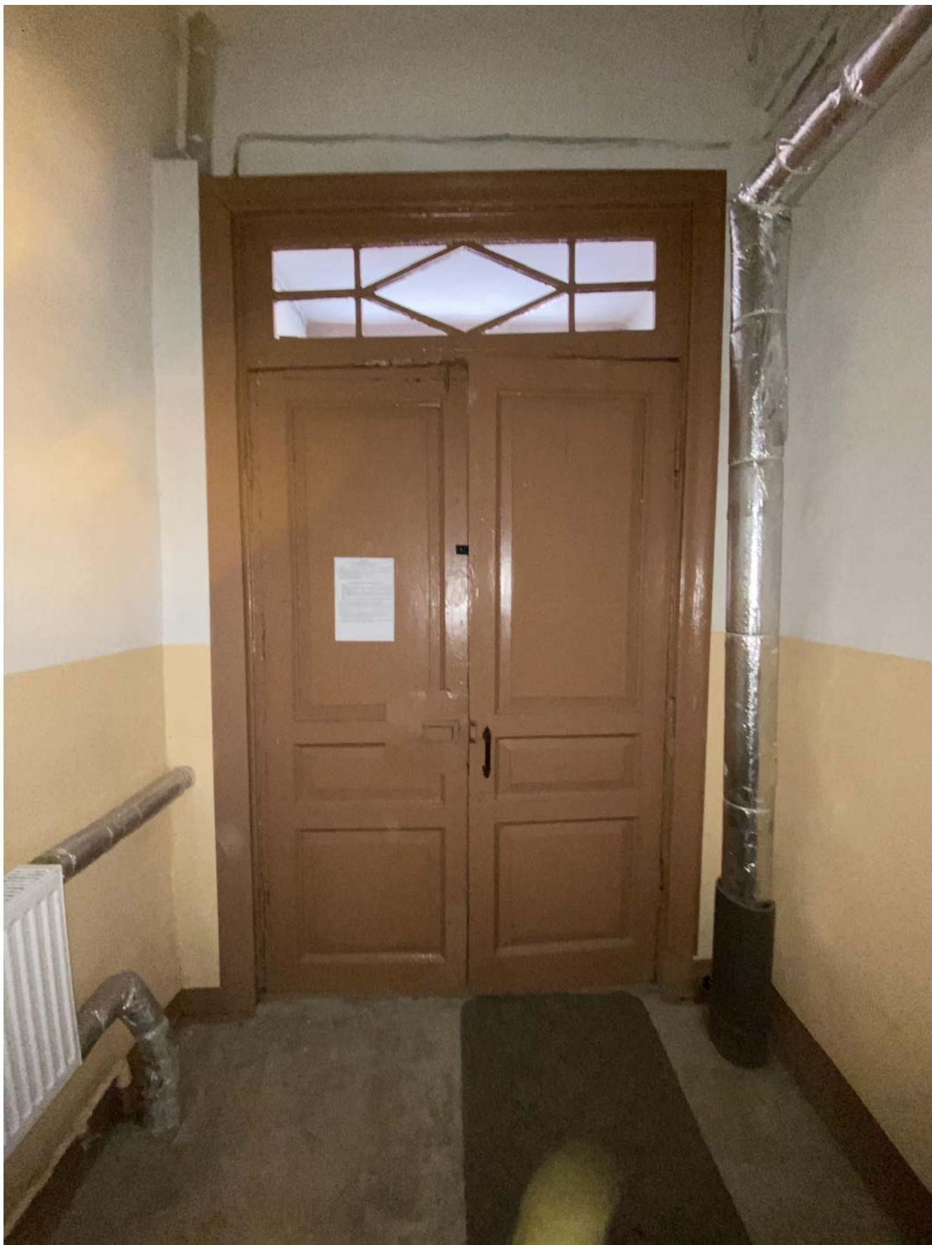
46. Дверное заполнение в вестибюле ЛК 7
