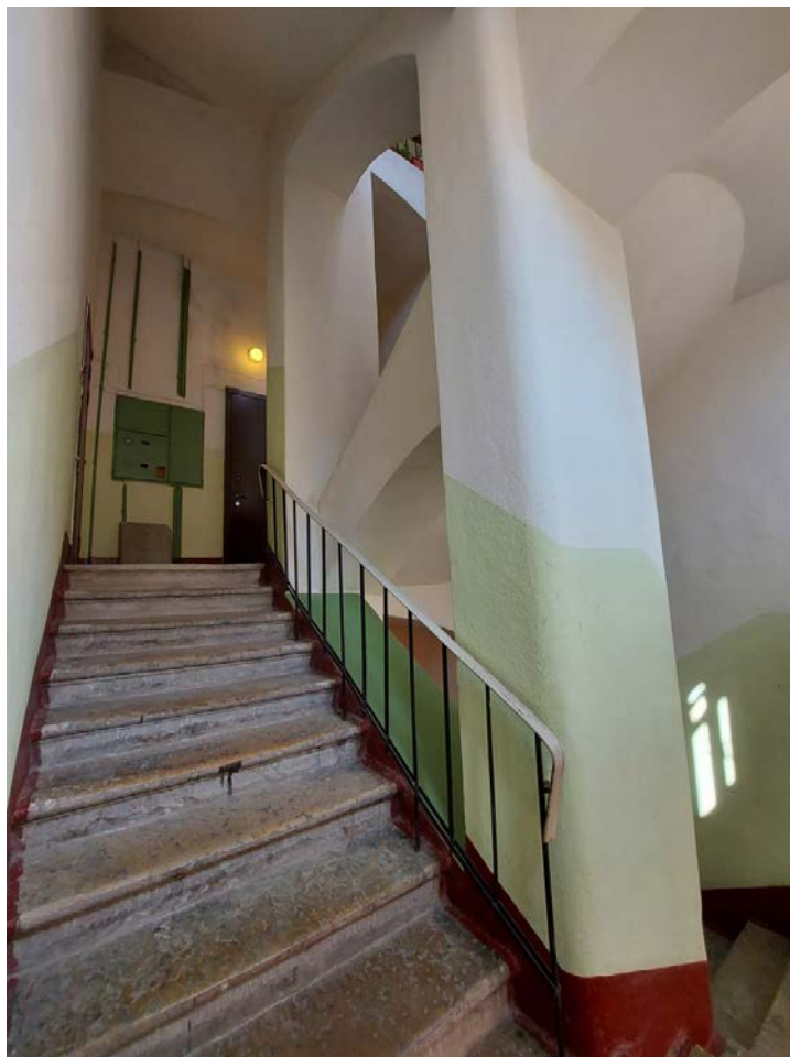
Фото 101. 2ЛК. Лестничный марш.
