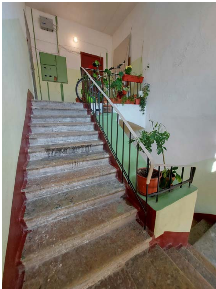
Фото 125. 2ЛК. Лестничный марш.
