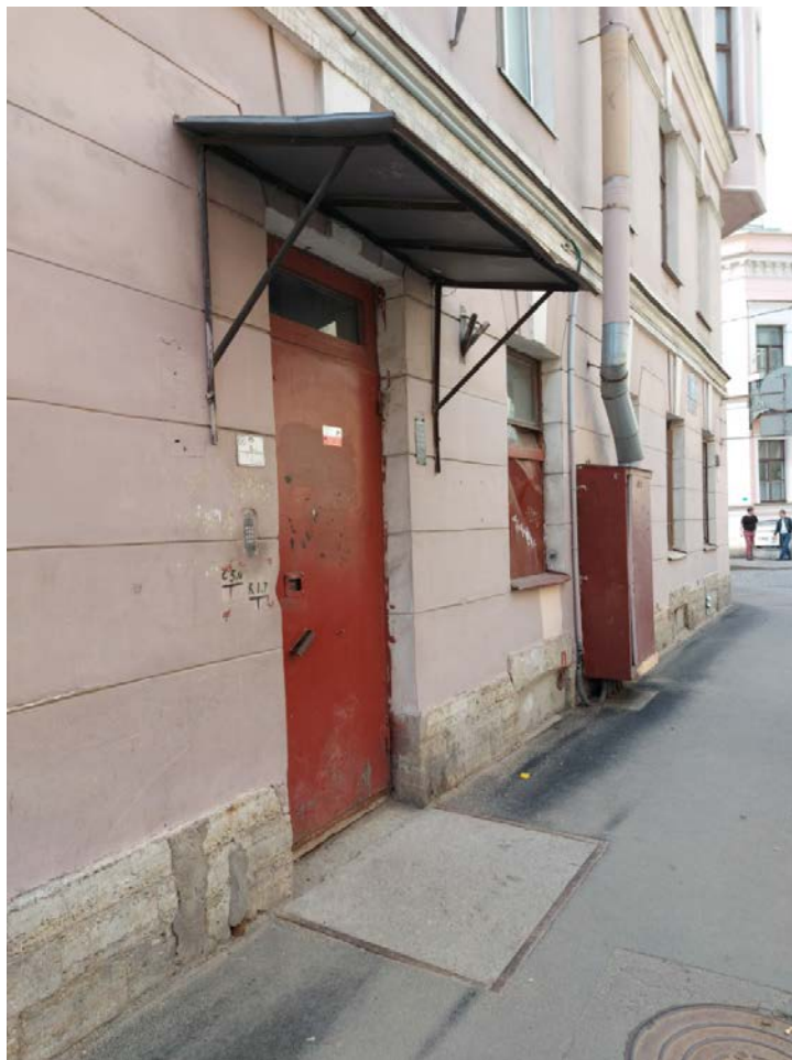
Фото 11. Дверной проем восточного фасада.
