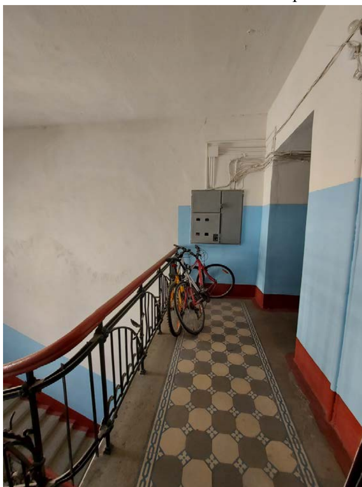
Фото 118. 1ЛК. Площадка этажа.
