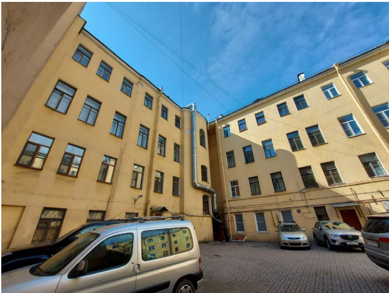
Фото 23. Вид дворовых фасадов с юго-востока.
