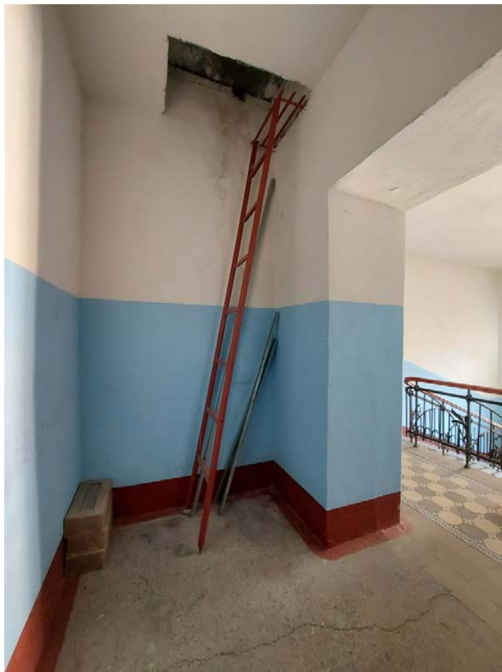
Фото 121 1ЛК. Лестница на чердак.
