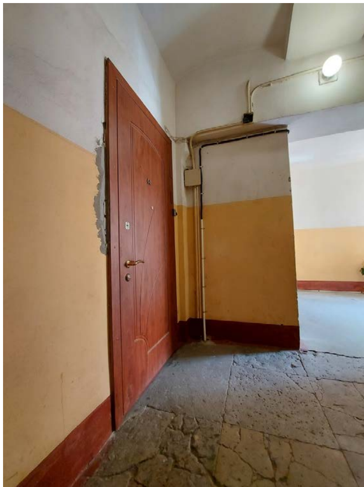
Фото 85. 4ЛК. Площадка этажа.
