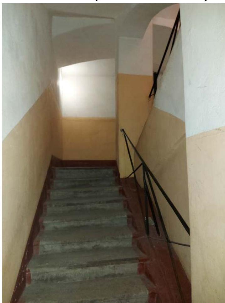
Фото 62. 4ЛК. Лестничный марш.
