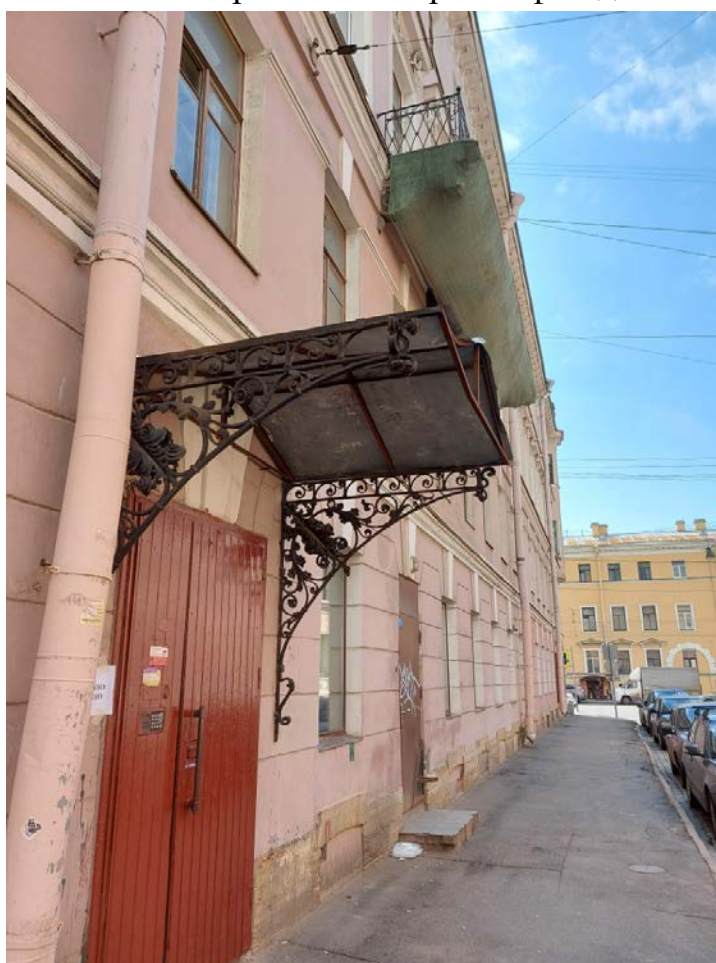
Фото 6. Проемы северного фасада
