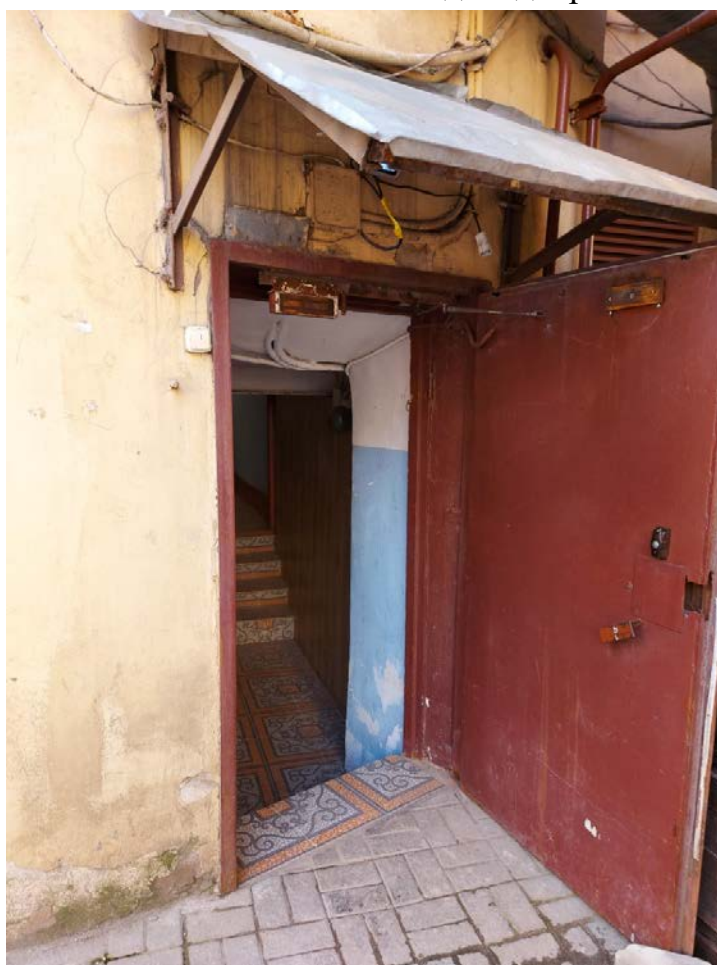
Фото 44. 1ЛК. Вход со двора
