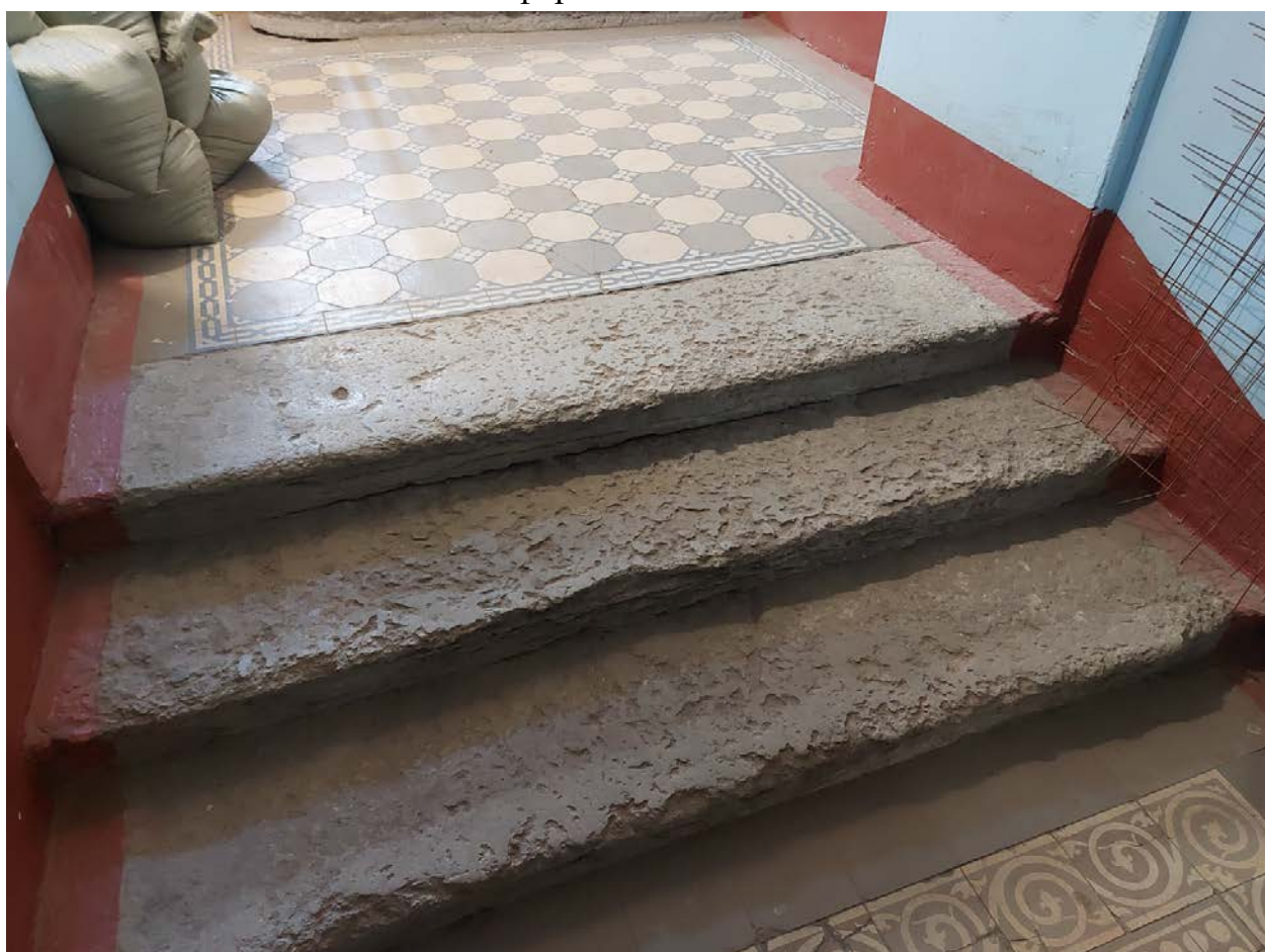
Фото 40. 1ЛК. Лестница в вестибюле.
