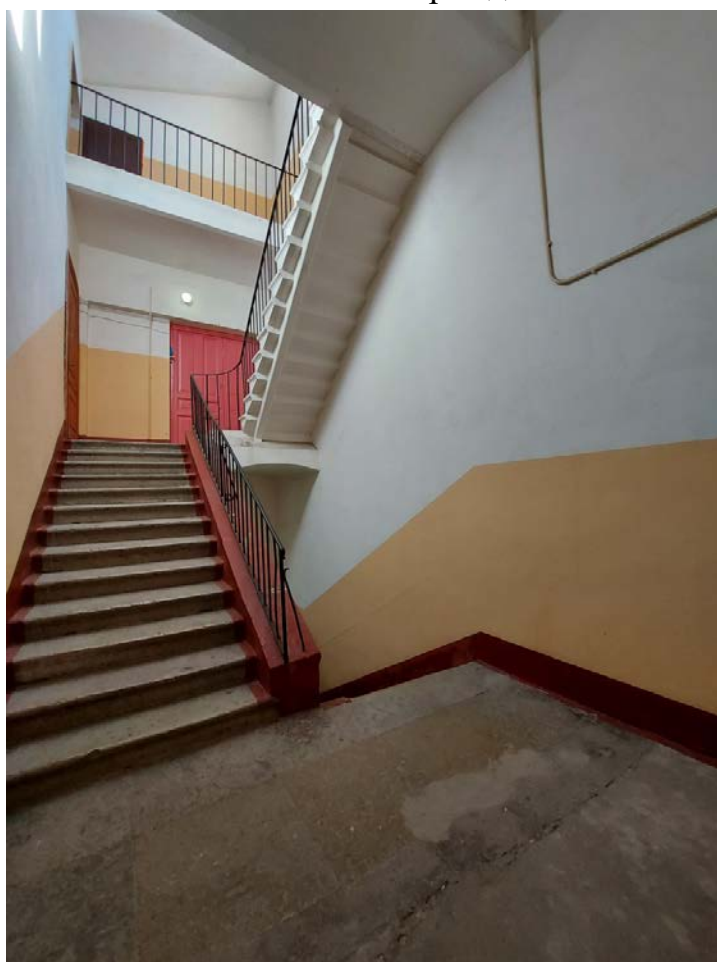
Фото 114. 4ЛК. Междуэтажная площадка
