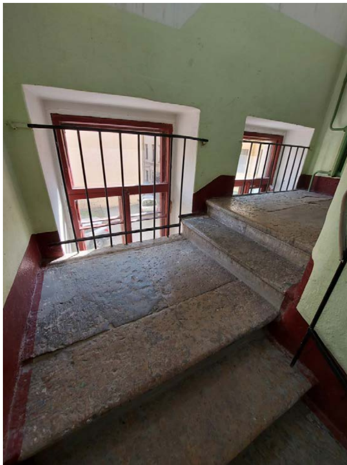
Фото 99. Междуетажная площадка 2ЛК.
