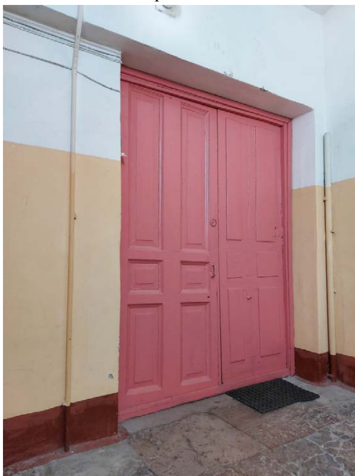
Фото 136. 4ЛК. Проем в холл
