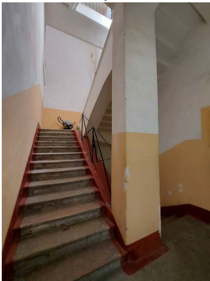
Фото 112. 4ЛК. Общий вид лестницы.
