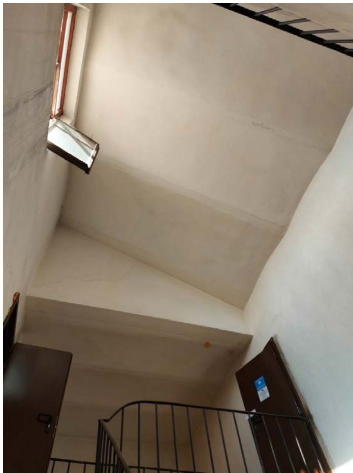
Фото 140. Чердачное перекрытие 4ЛК.
