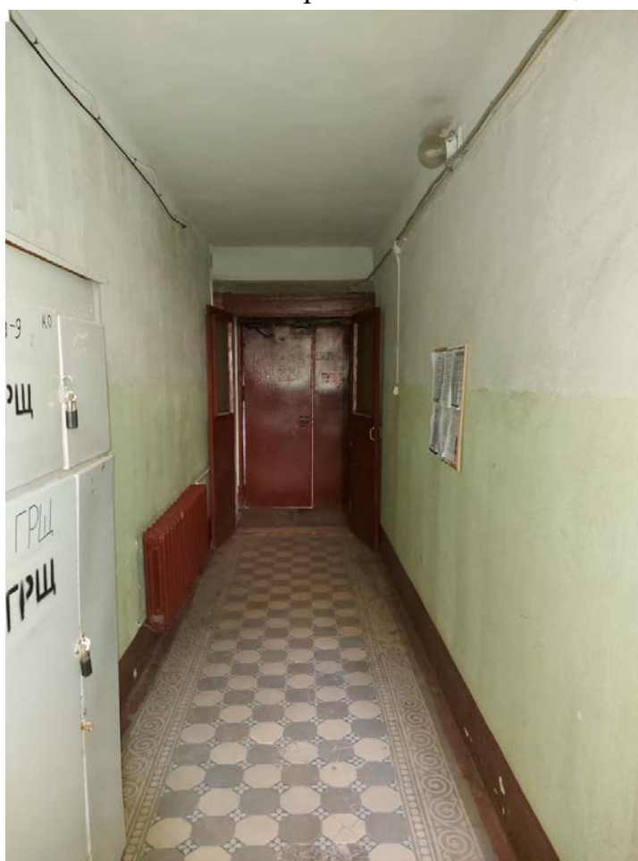
Фото 56. ЗЛК. Вестибюль, общий вид.
