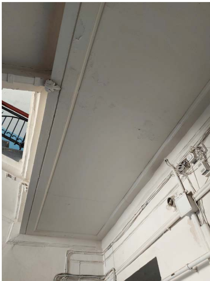
Фото 70. 1ЛК. Перекрытие площадки этажа.
