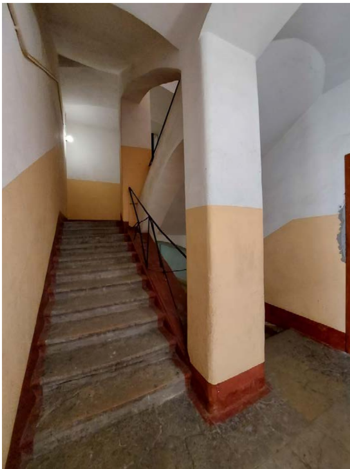
Фото 89. 4ЛК. Лестничный марш.
