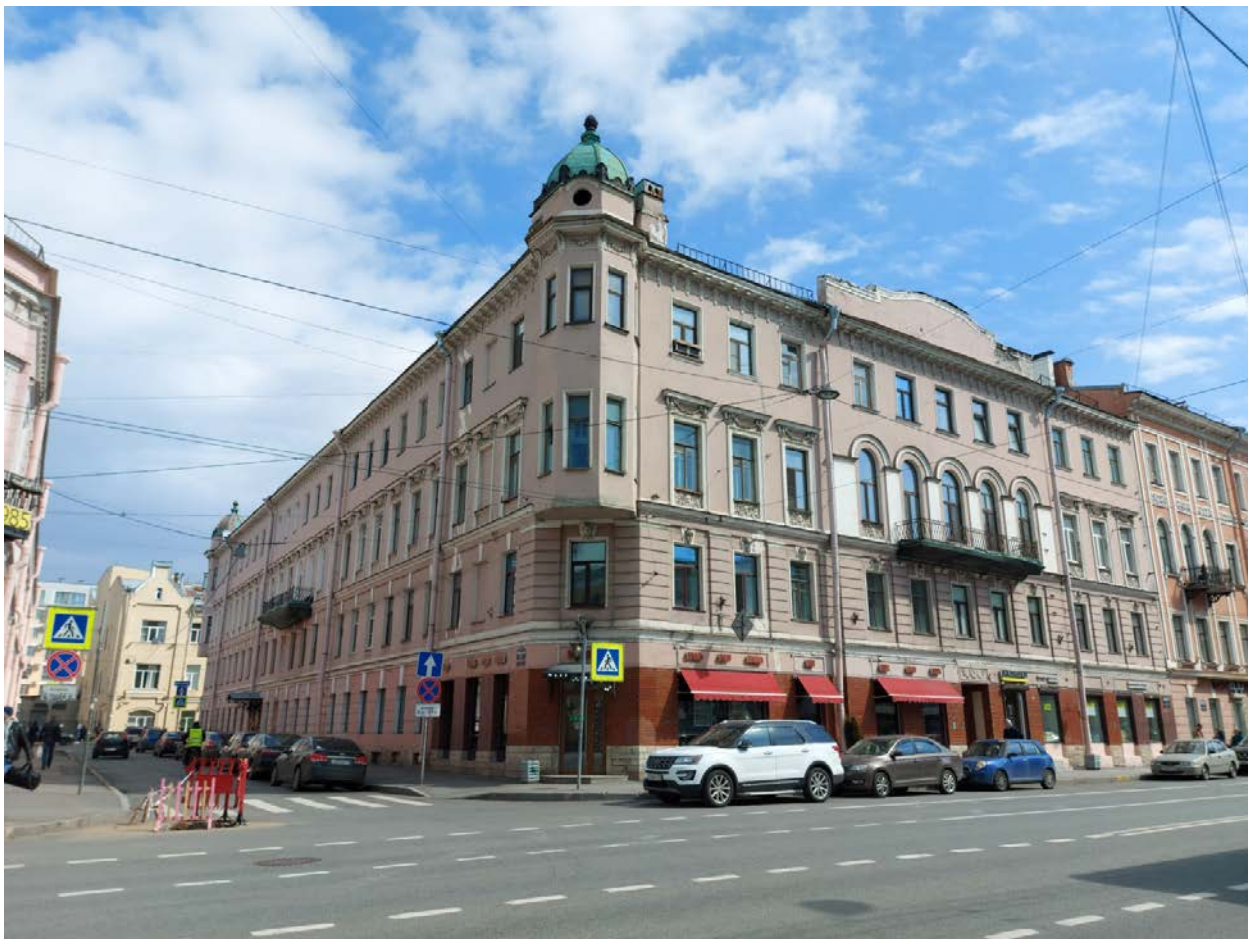
Фото 1. Вид с северо-запада.
