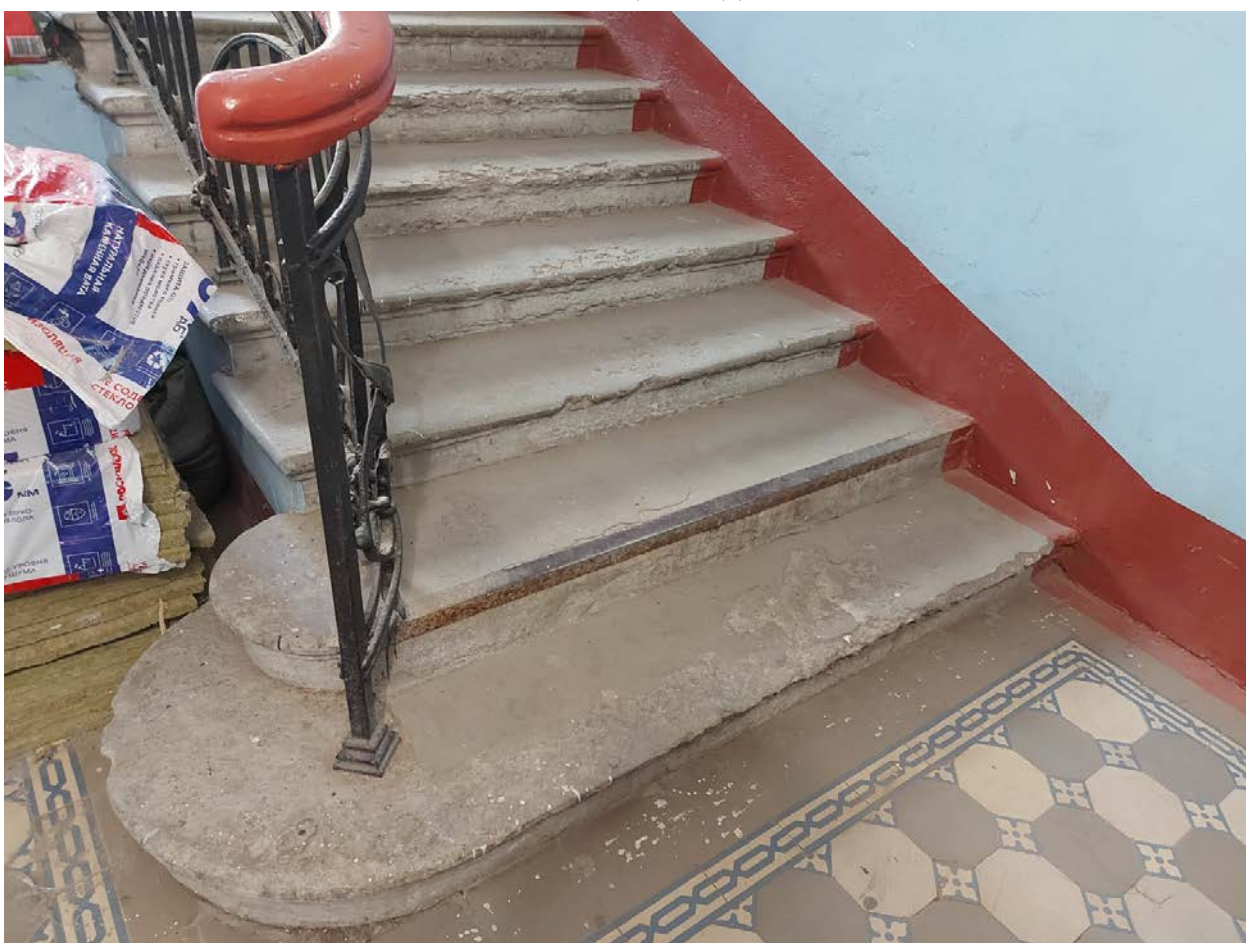
Фото 42. 1ЛК. Лестничный марш.
