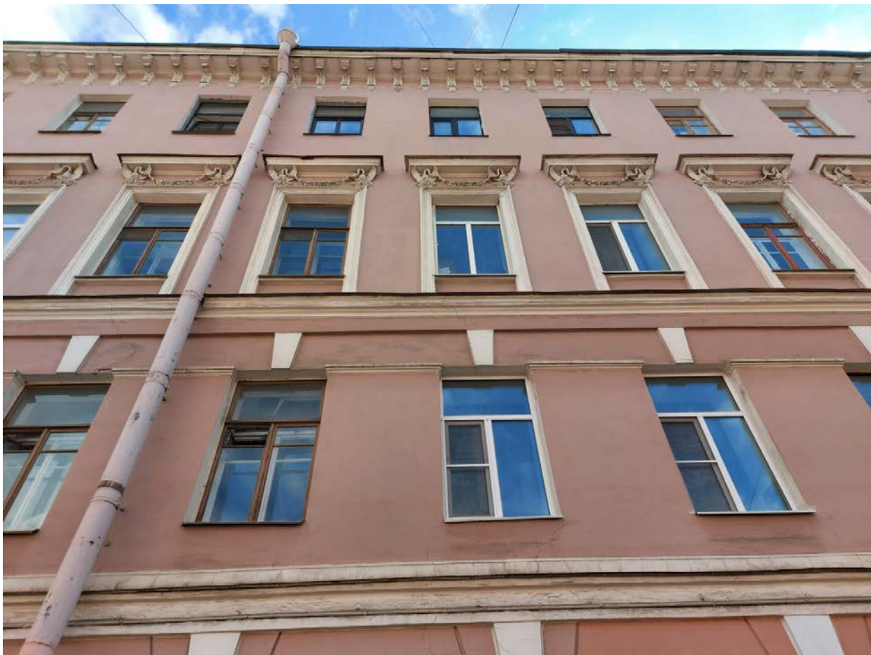
Фото 5. Фрагмент северного фасада..
