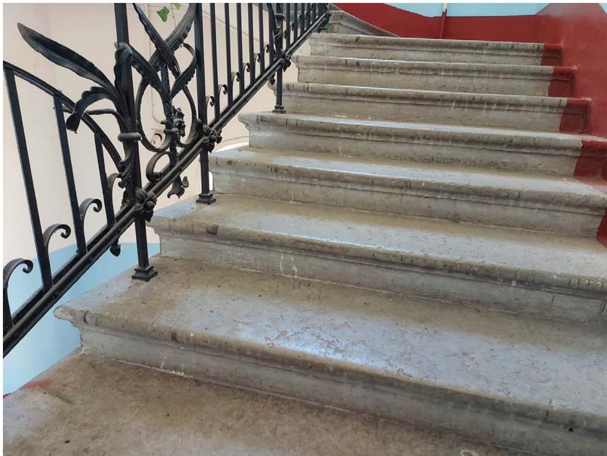
Фото 115. Лестничный марш 1ЛК.
