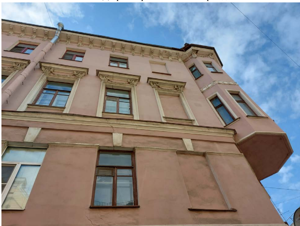
Фото 12. Фрагмент восточного фасада.
