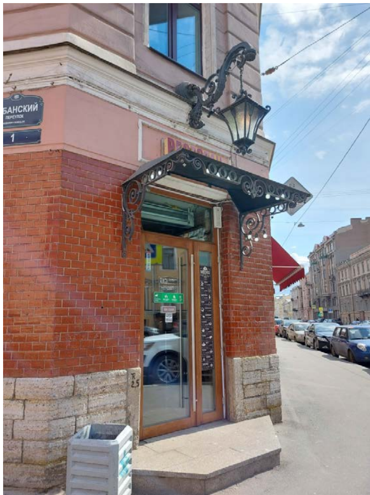
Фото 15. Дверной проем западного угла.
