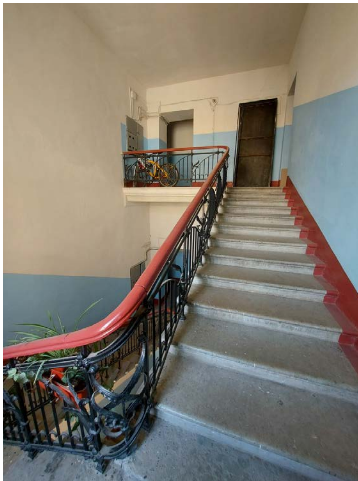
Фото 117. 1ЛК. Лестничный марш.
