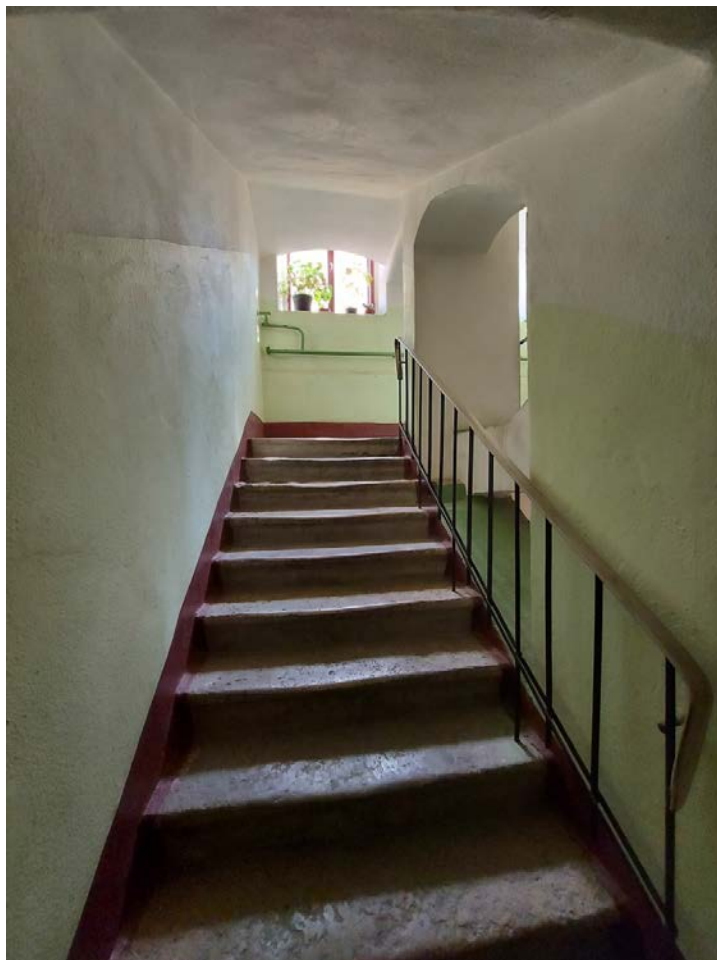
Фото 49. 2ЛК. Лестничный марш.
