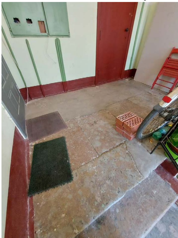
Фото 126. 2ЛК. Площадка этажа.
