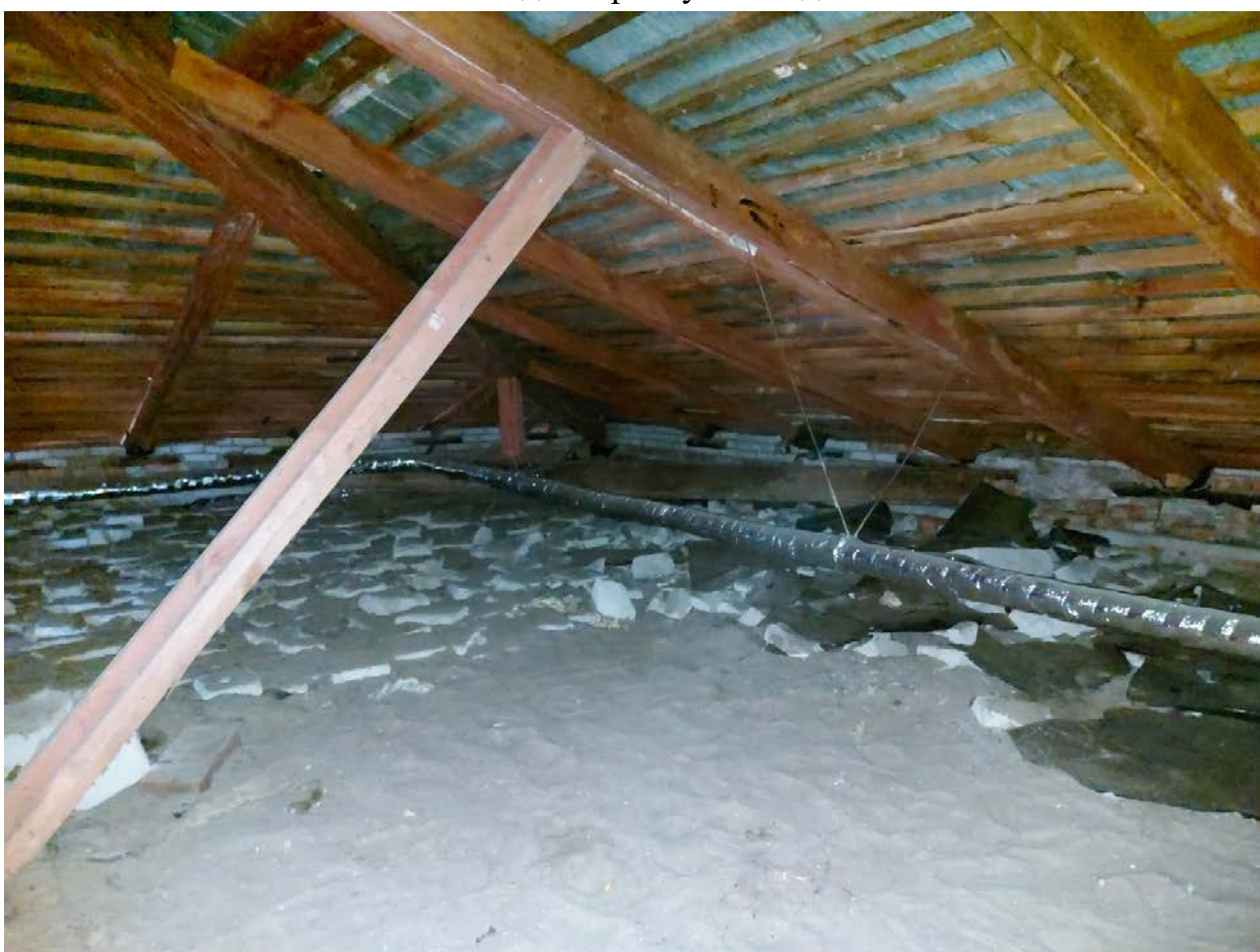
Фото 153. Восточная часть чердака.
