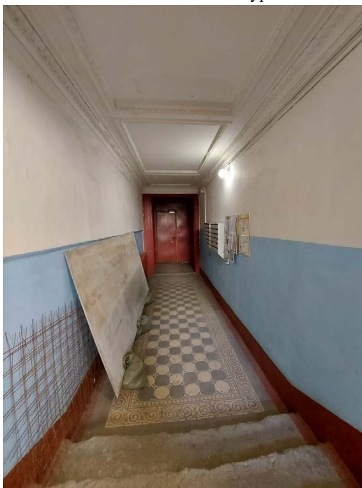
Фото 38. 1ЛК. Общий вид вестибюля.
