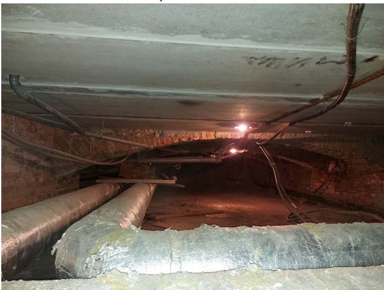
Фото 36. Вид на северную часть подвала.
