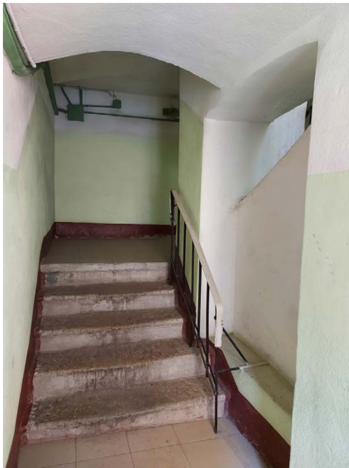
Фото 47. 2ЛК Лестничный марш.
