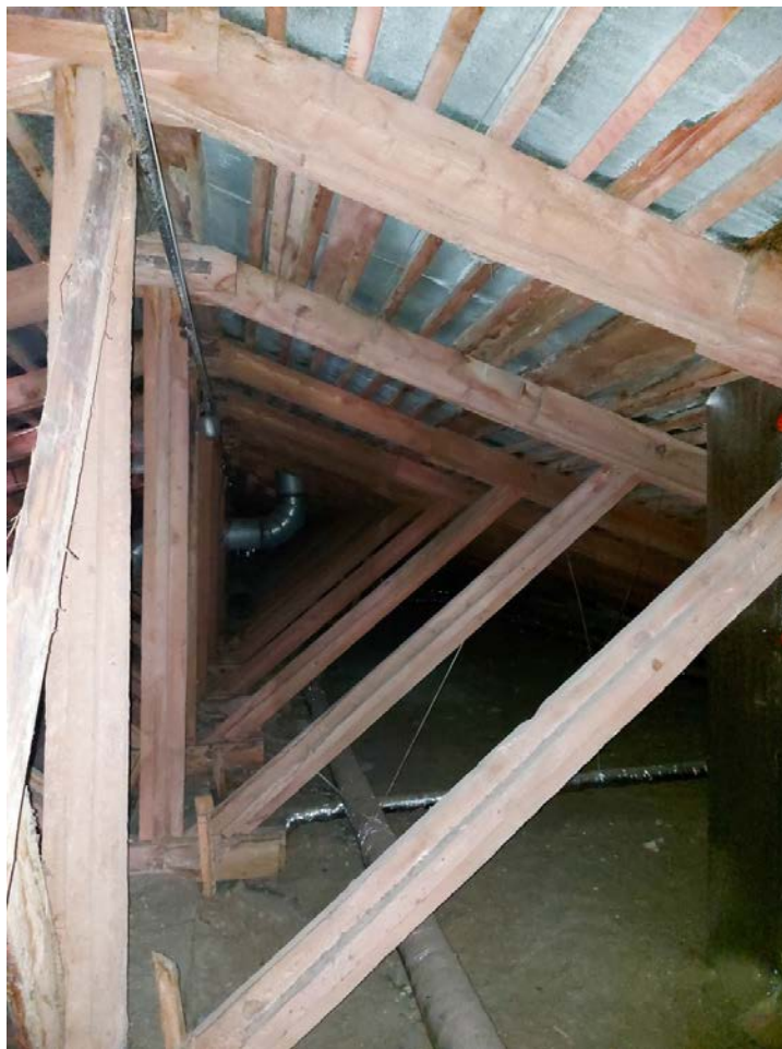
Фото 144. Вид на запад, стропила.
