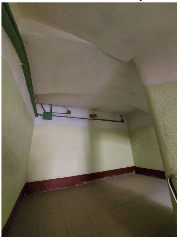
Фото 48. 2ЛК. Междуетажная площадка.
