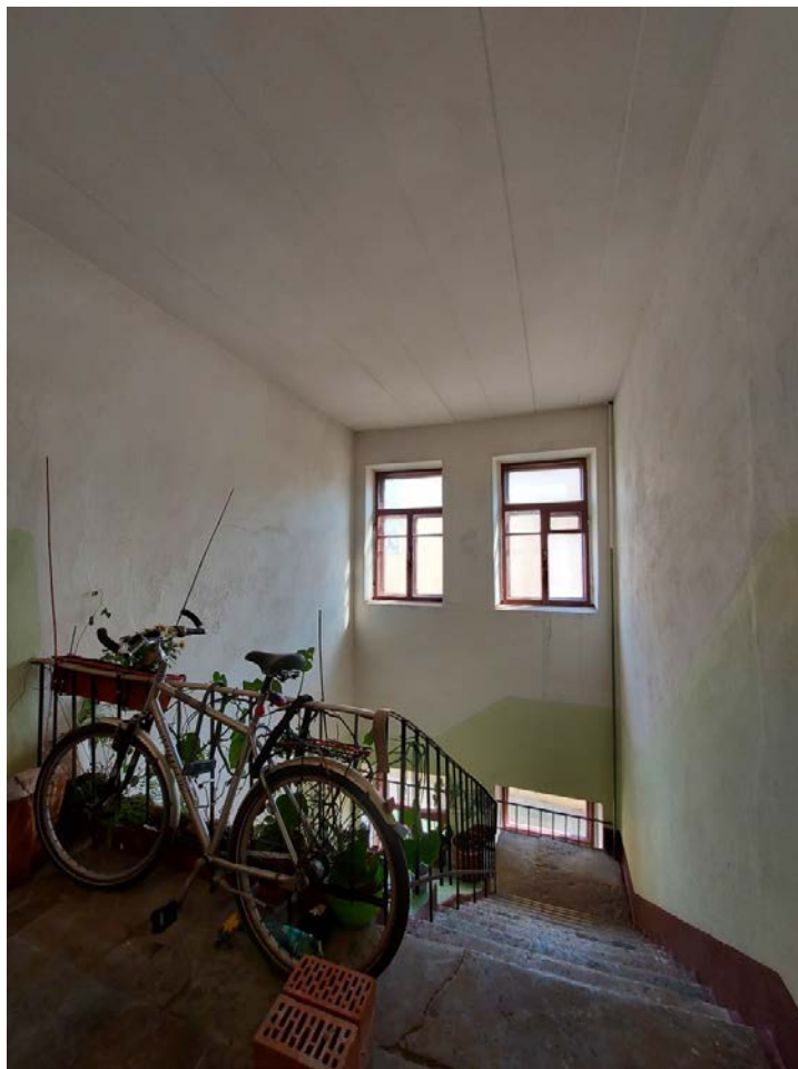
Фото 127. 2ЛК. Общий вид и перекрытие.
