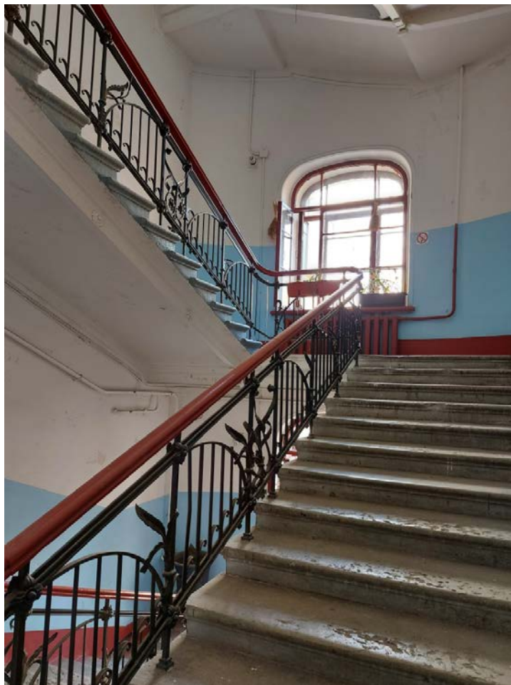
Фото 91. 1ЛК. Лестничный марш.
