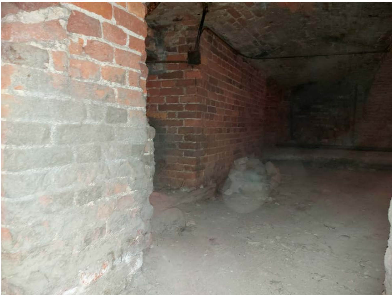
Фото 33. Вид на северную часть подвала.
