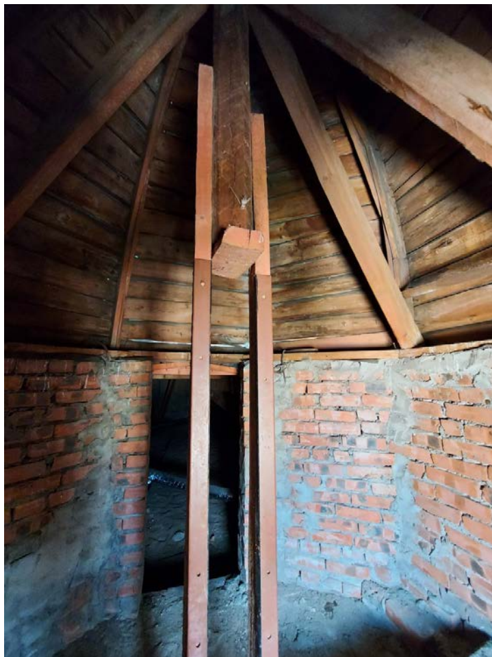
Фото 148. Проем в северо-восточной башне.
