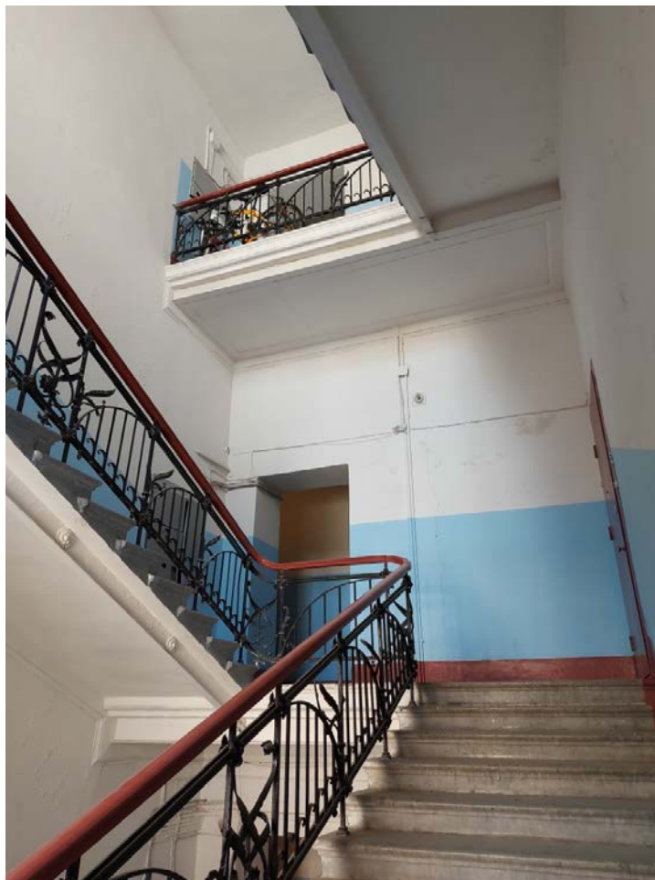
Фото 95. Лестничный марш 1ЛК.
