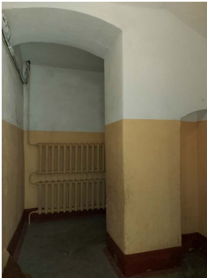
Фото 61. 4ЛК. Проем входа на лестницу.
