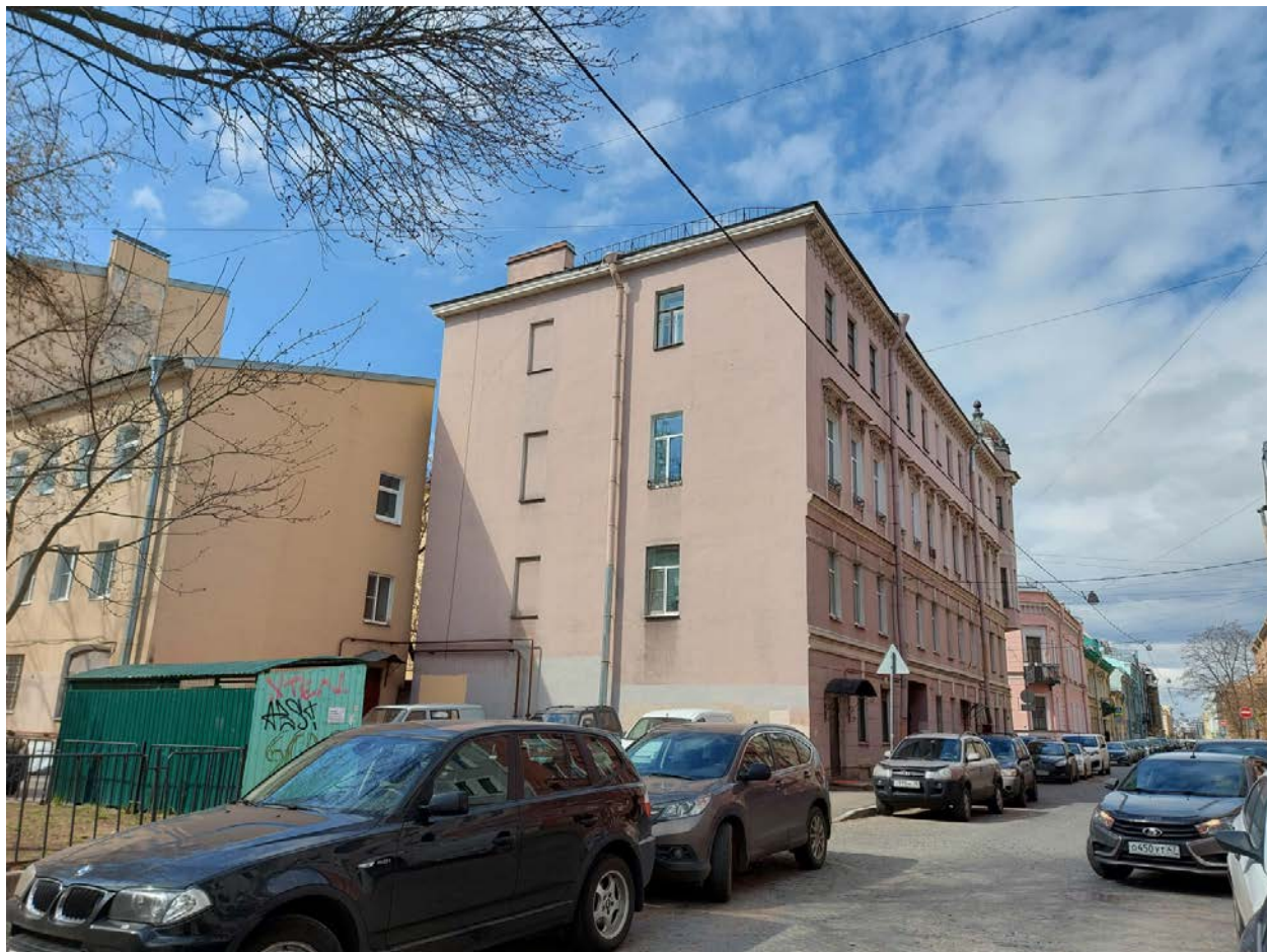
Фото 9. Общий вид с юго-востока.
