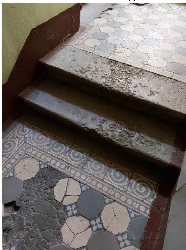
Фото 58. ЗЛК. Ступени из вестибюля.
