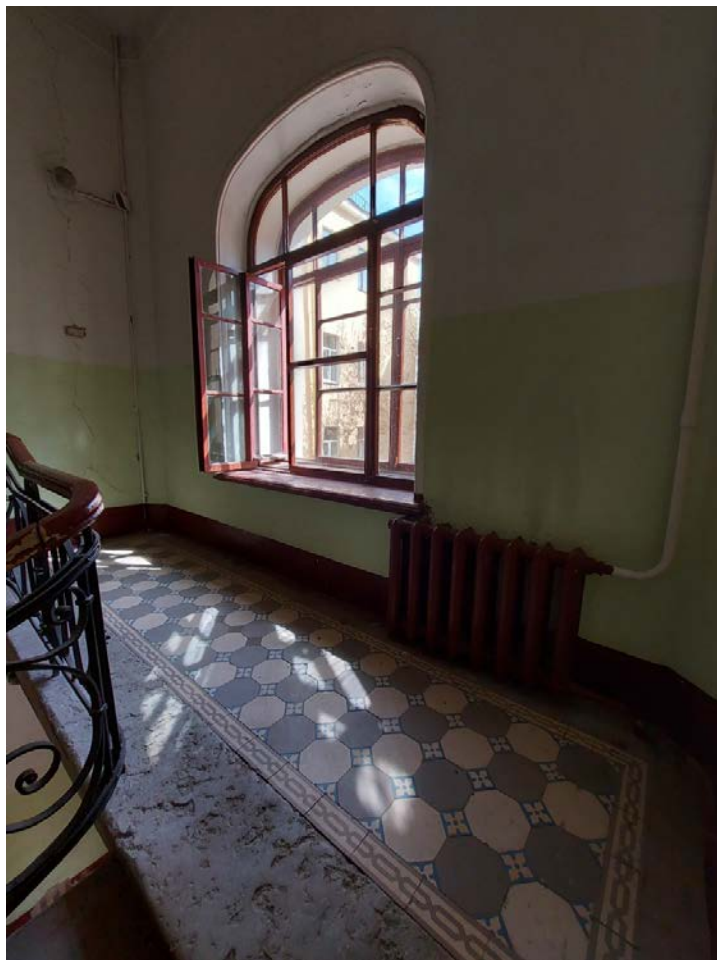
Фото 105. ЗЛК. Междуэтажная площадка.
