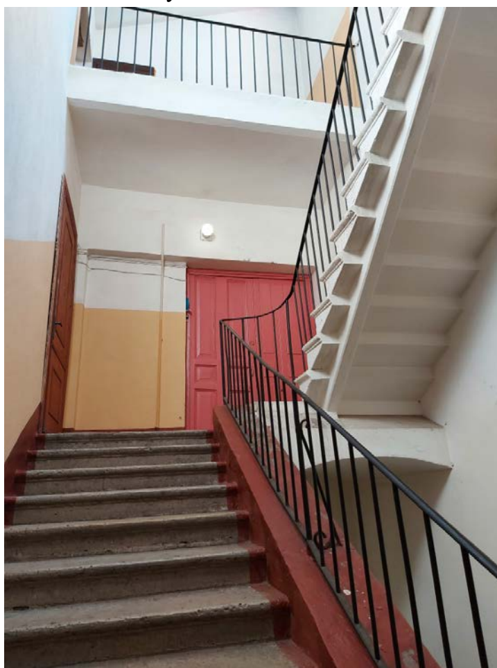
Фото 134. 4ЛК. Лестничный марш.
