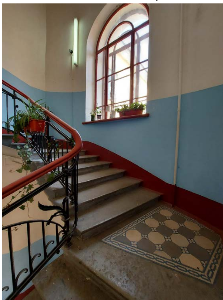
Фото 116. 1ЛК. Междуэтажные площадки.
