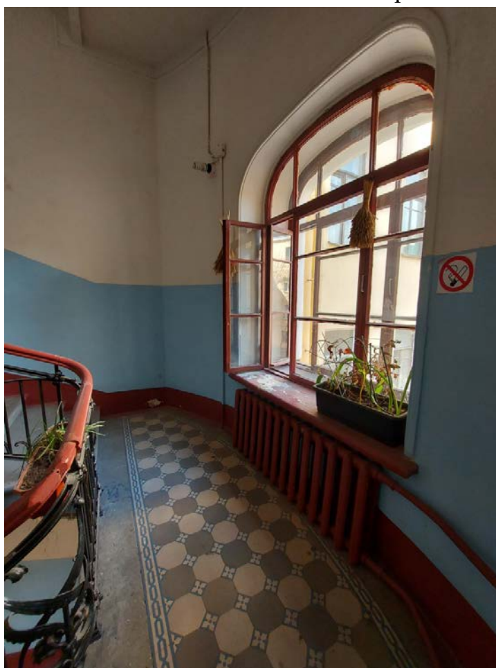
Фото 92. Междуетажная площадка 1ЛК.
