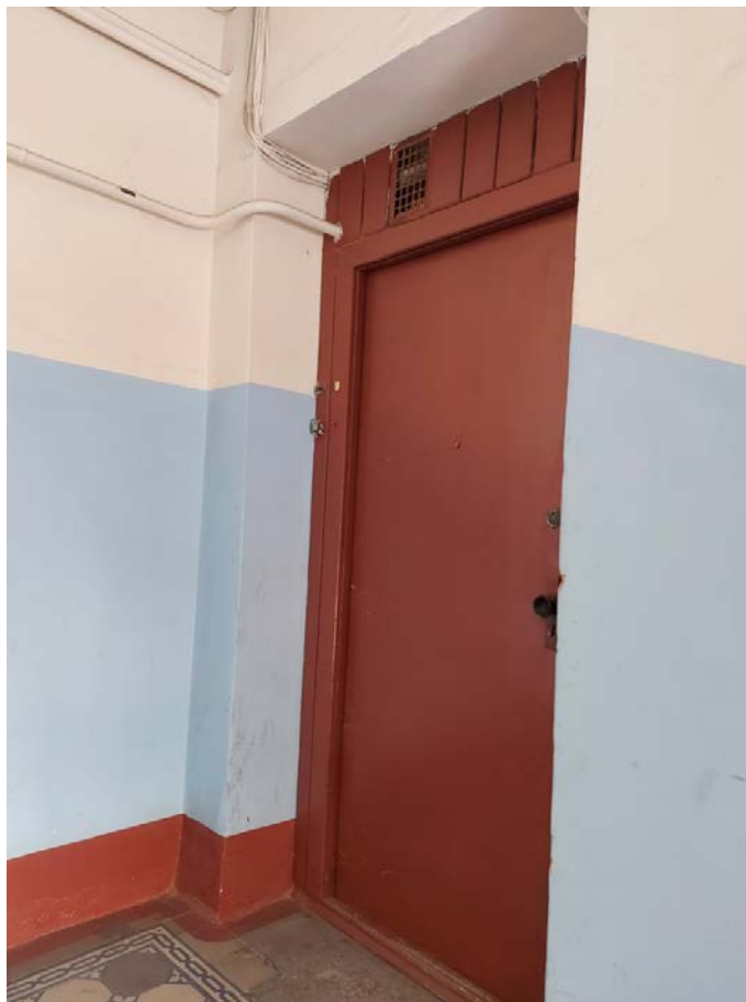
Фото 69. 1ЛК. Проем на площадке этажа.
