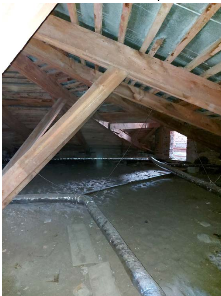
Фото 145. Вид на север чердака.
