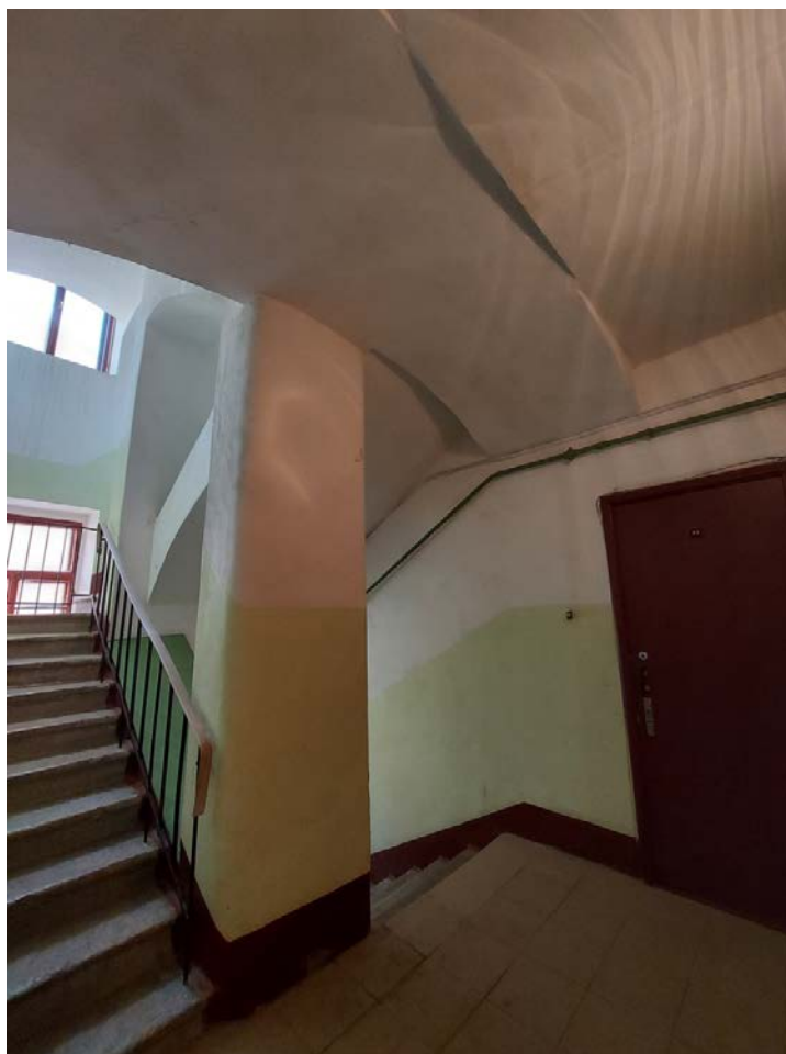
Фото 76. 2ЛК. Площадка этажа и лестница на 3 этаж.
