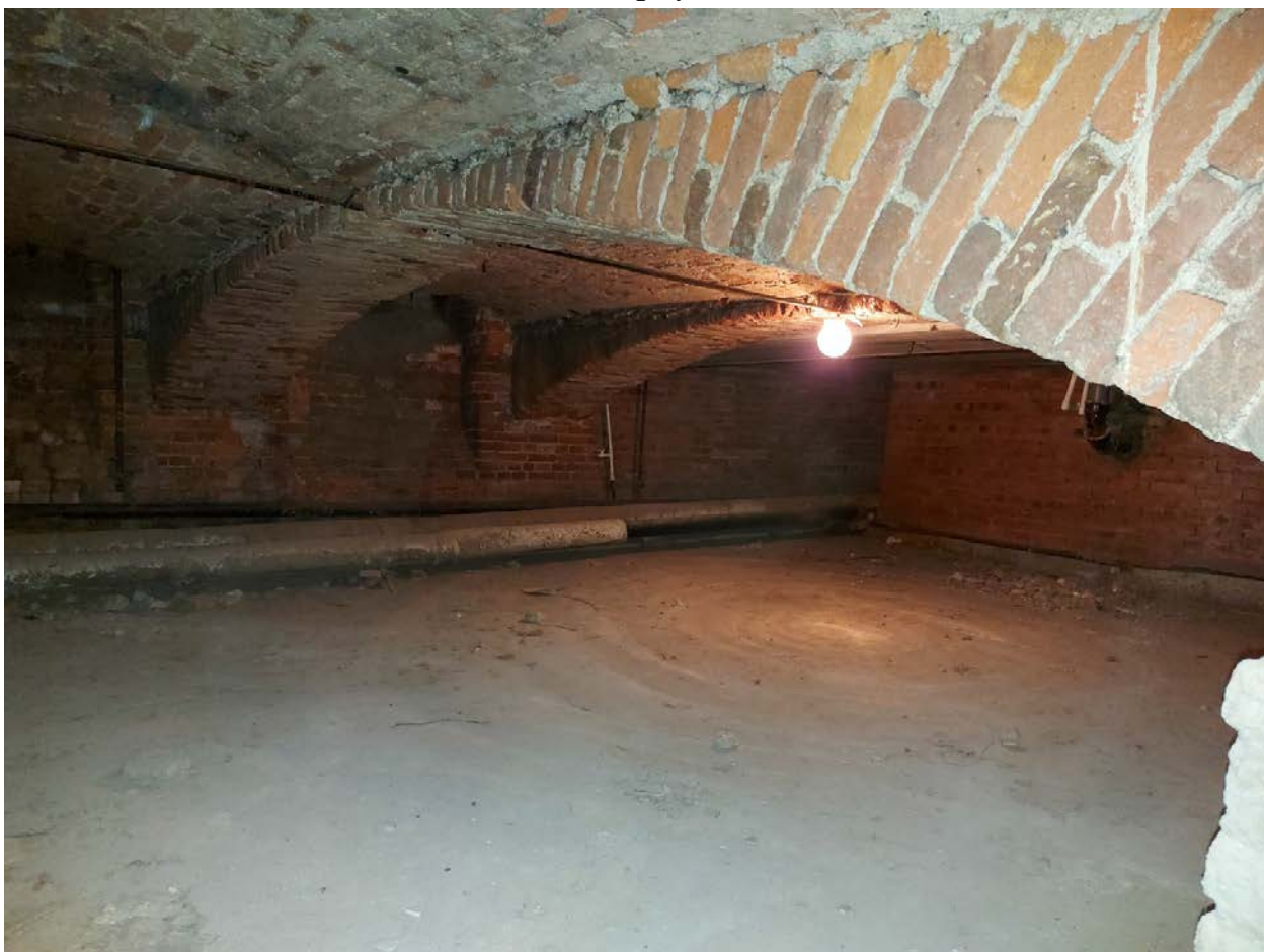
Фото 34. Перекрытие северной части подвала.
