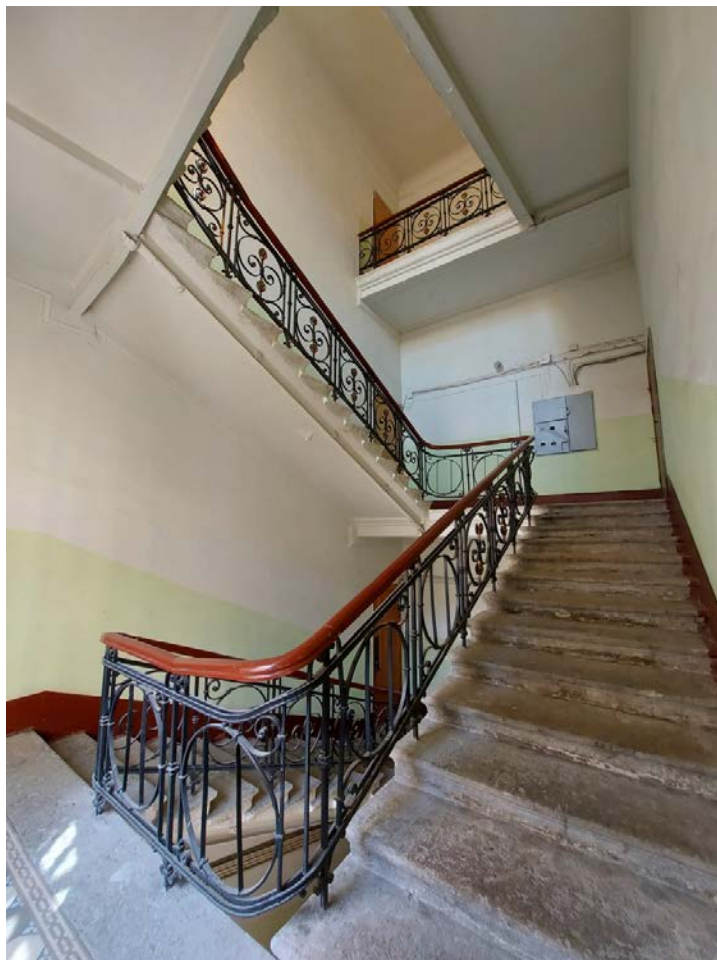
Фото 107. ЗЛК. Общий вид.
