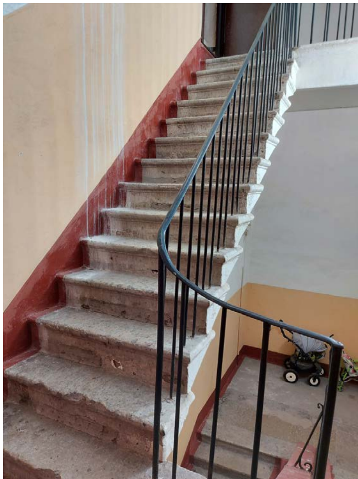
Фото 139. 4ЛК. Марш на чердак.
