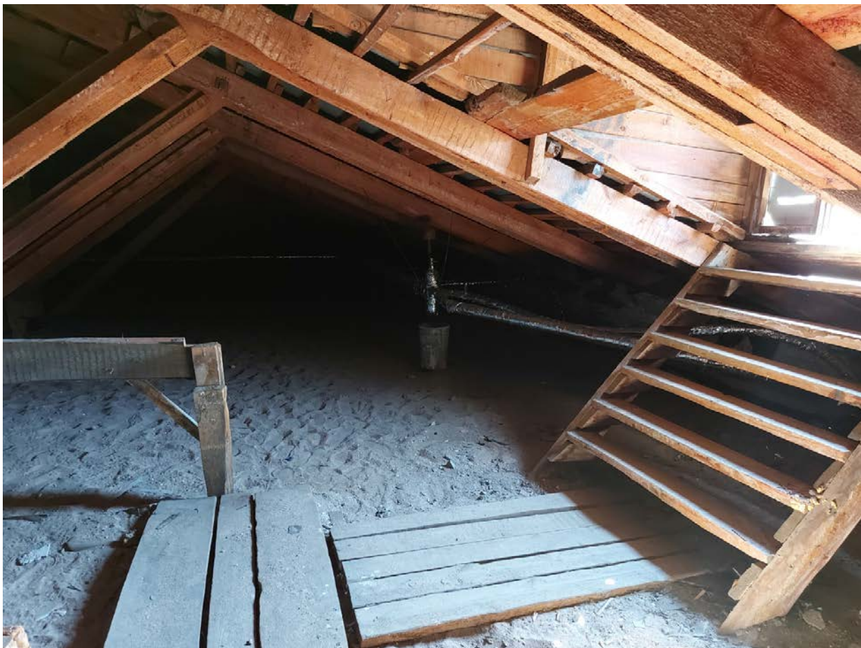
Фото 152. Выход на крышу в западной стены.
