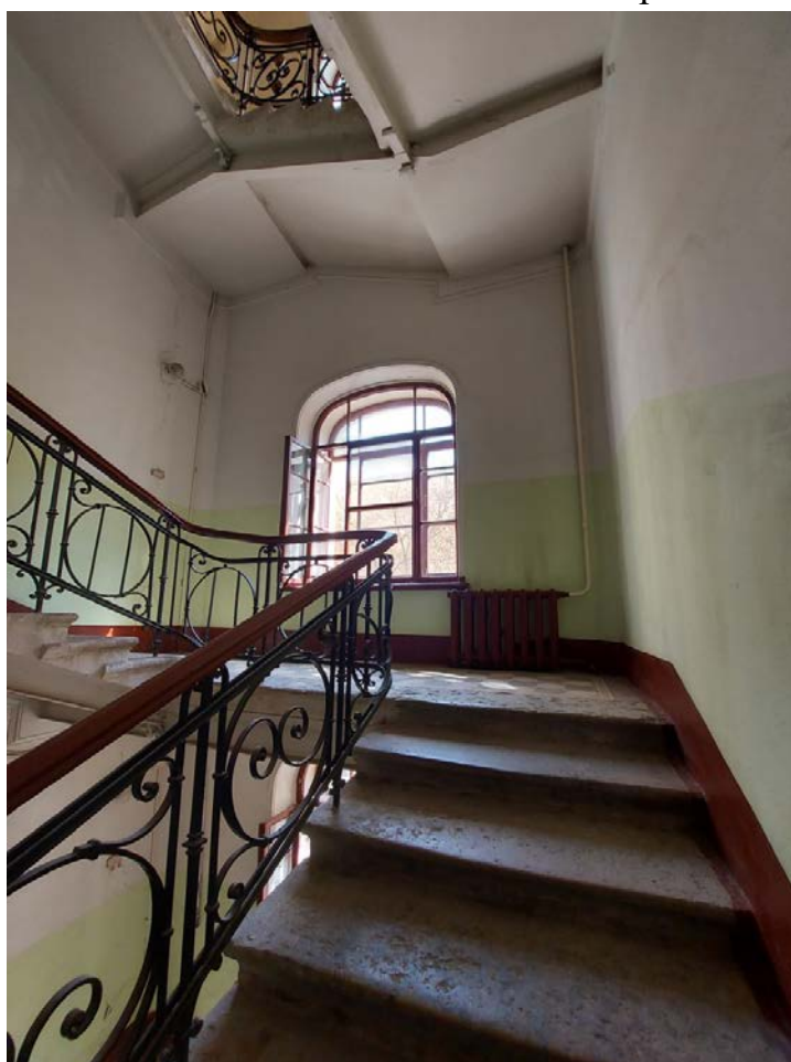
Фото 104. 3ЛК. Лестничный марш.
