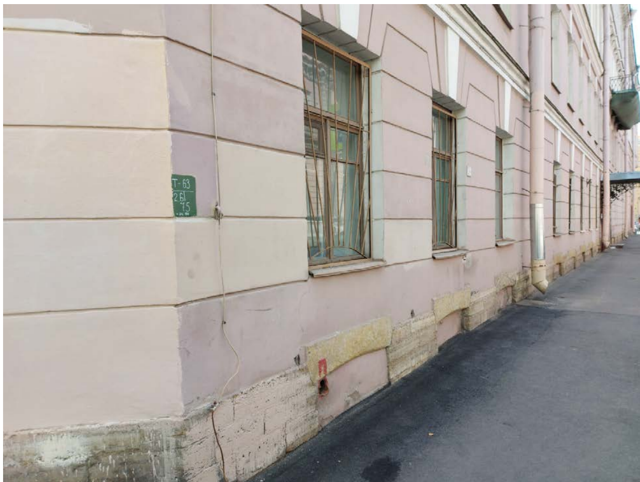
Фото 13. Фрагмент северного фасада восточная часть.
