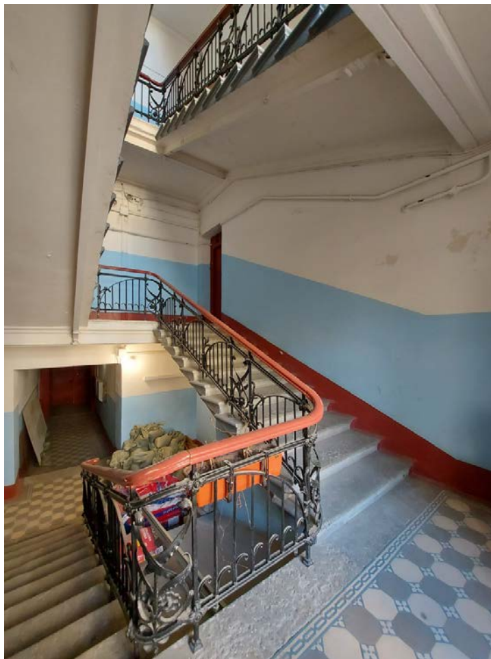
Фото 67. Вид лестницы 1ЛК.
