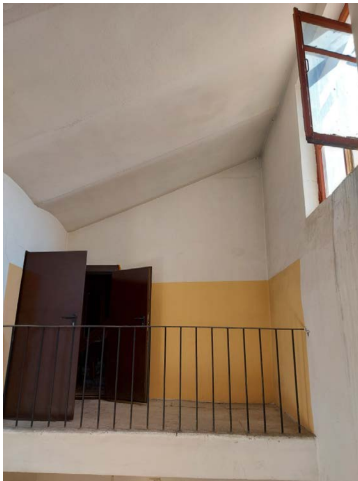
Фото 142. Вид на балкон в 4ЛК.
