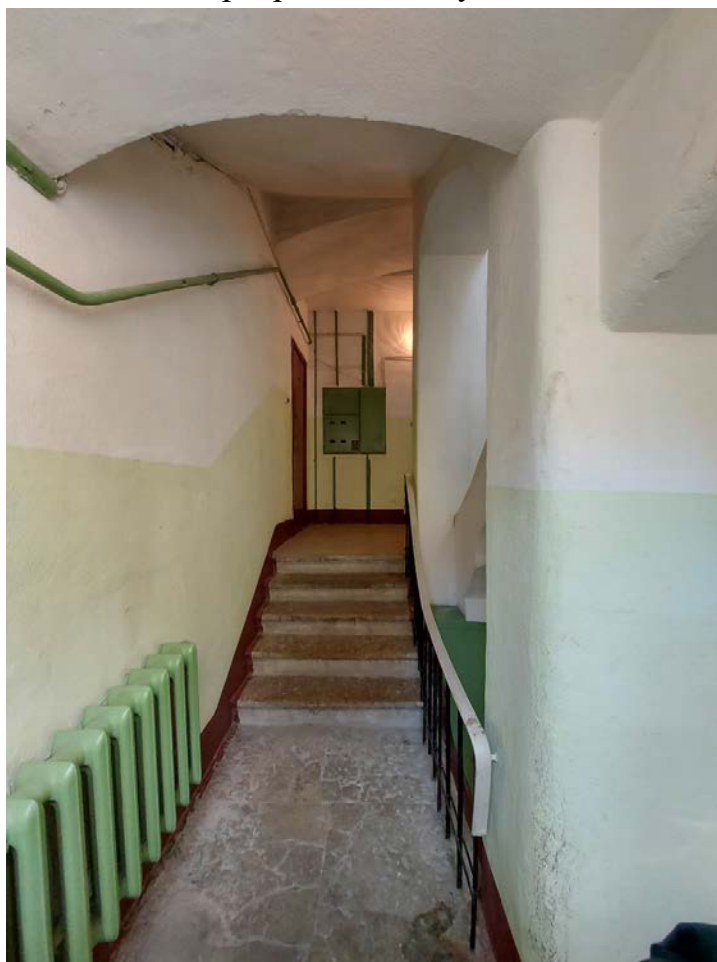
Фото 74. 2ЛК. Лестничный марш.
