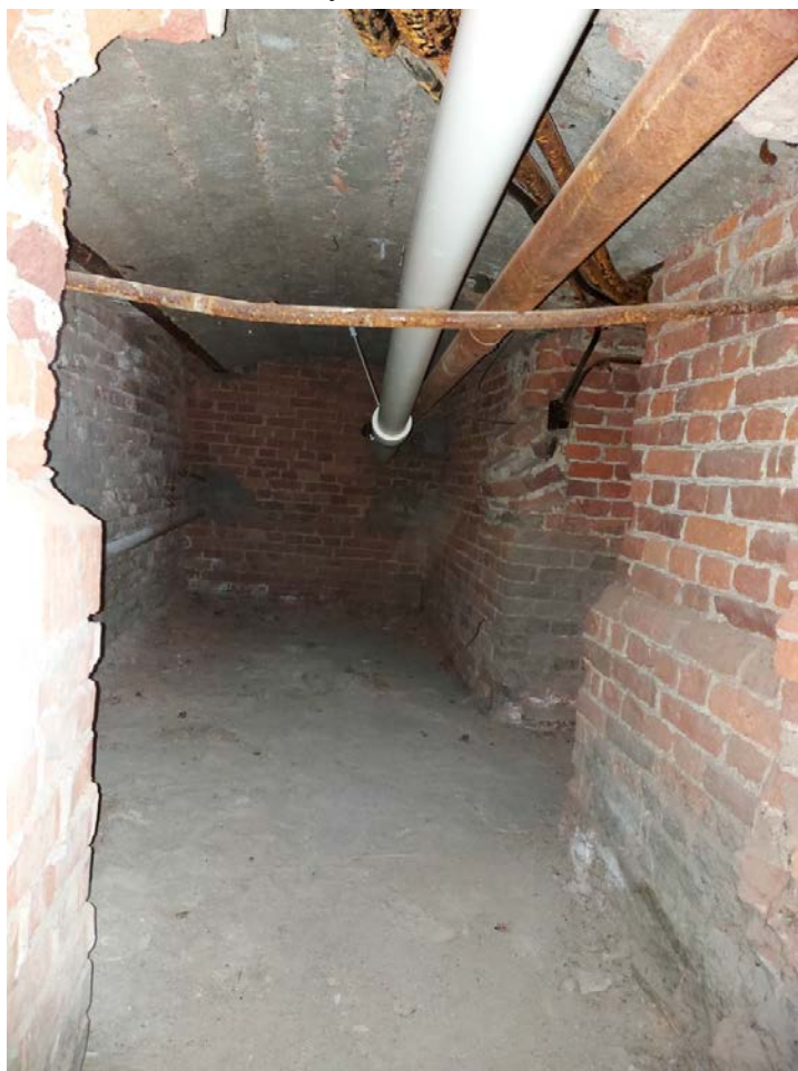
Фото 32. Помещение в подвале.
