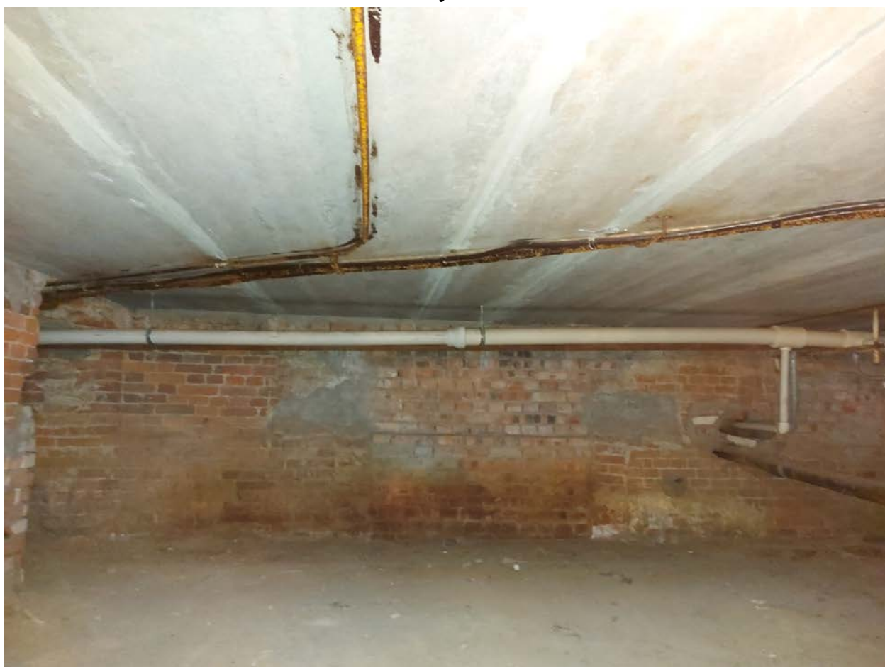
Фото 30. Продольная стена подвала.
