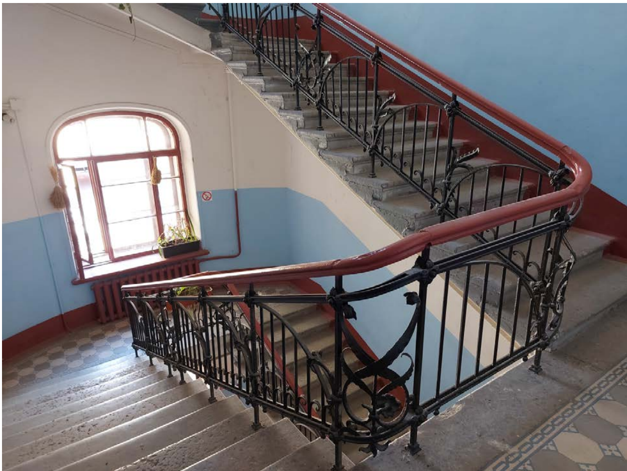
Фото 97. Общий вид 1ЛК.
