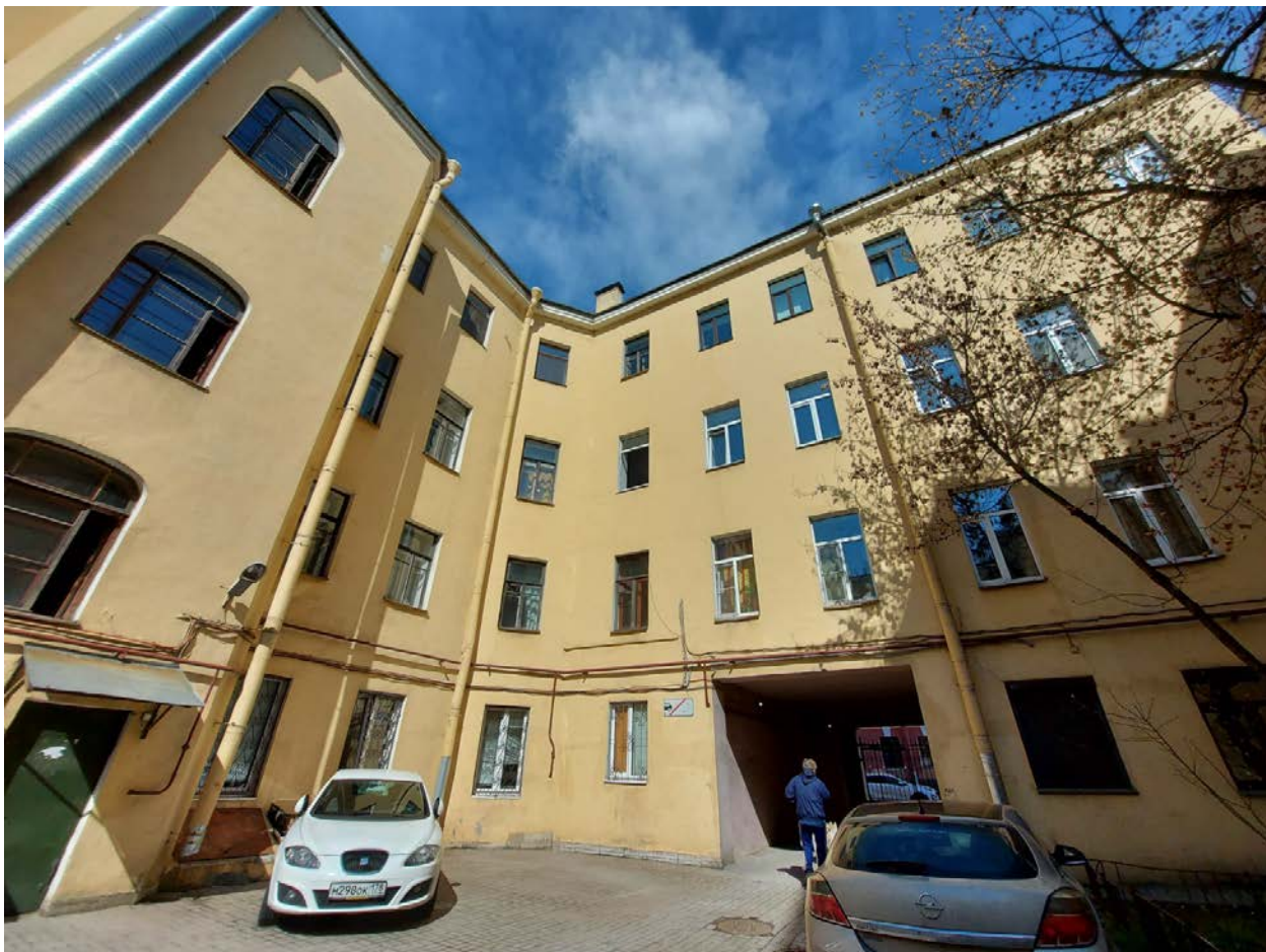
Фото 21. Вид дворовых фасадов с юго-запада.
