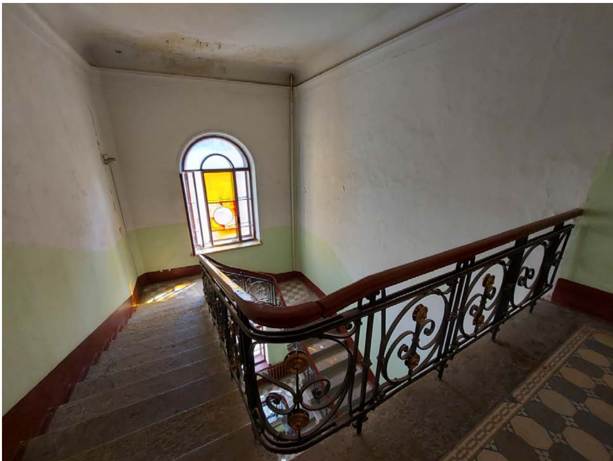
Фото 131. ЗЛК. Общий вид лестничной клетки.
