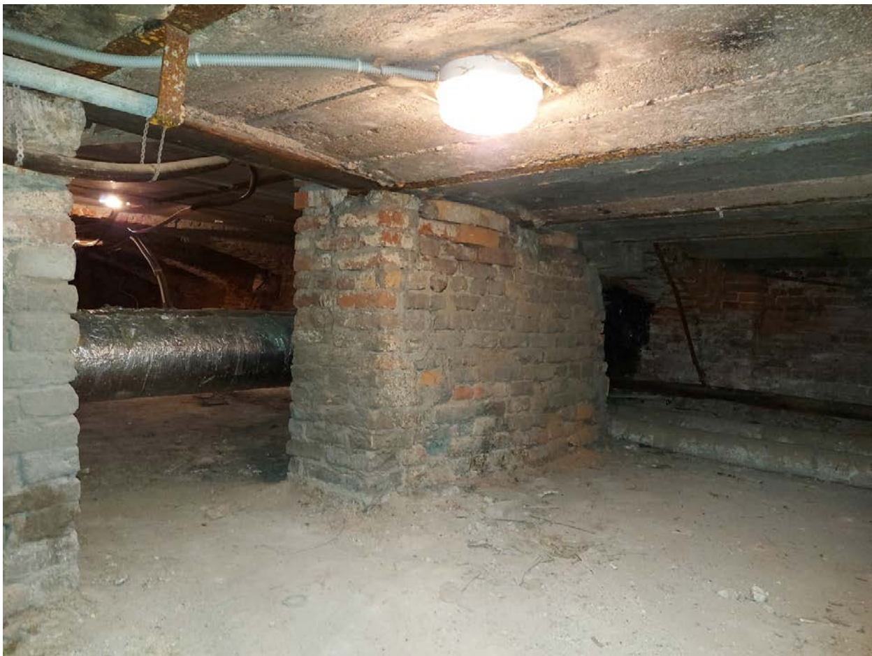
Фото 35. Фрагмент колонн подвала.
