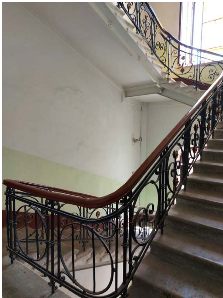
Фото 109. 3ЛК. Ограждение маршей и площадок.
