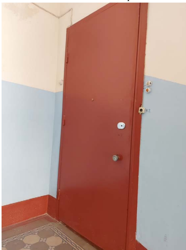
Фото 96. 1ЛК. Проем на площадке этажа.
