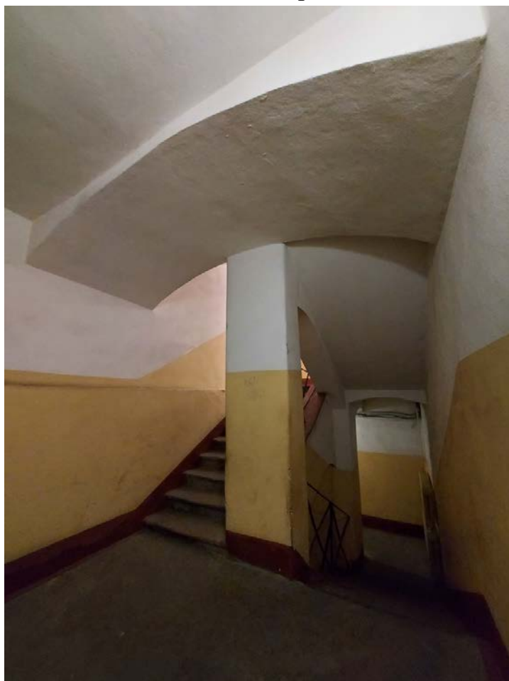
Фото 64. 4ЛК. Вид междуэтажной площадки.
