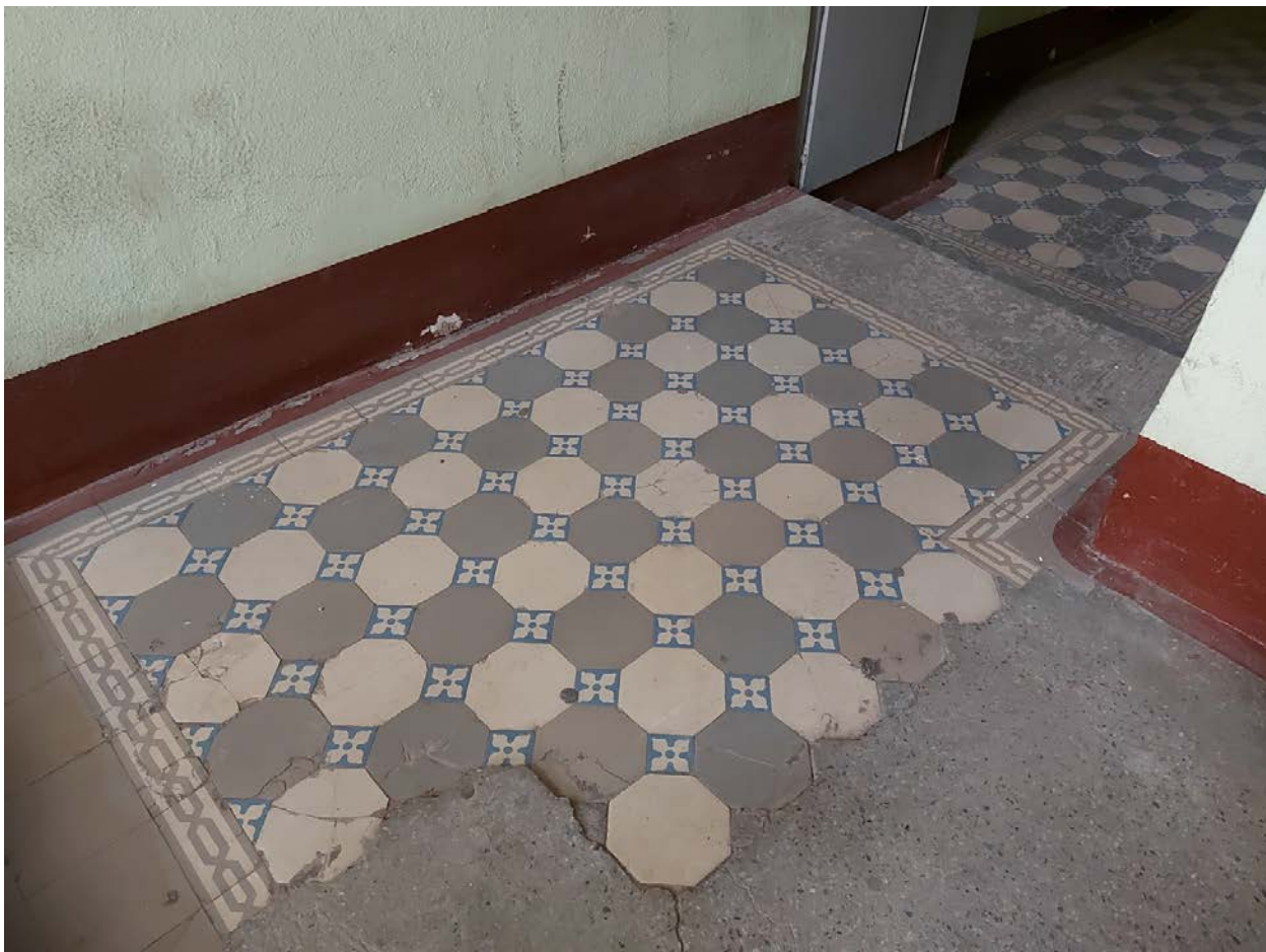
Фото 55. ЗЛК. Покрытие пола лестницы.
