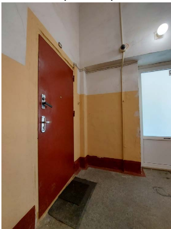
Фото 110. 4ЛК. Проем на этаже.
