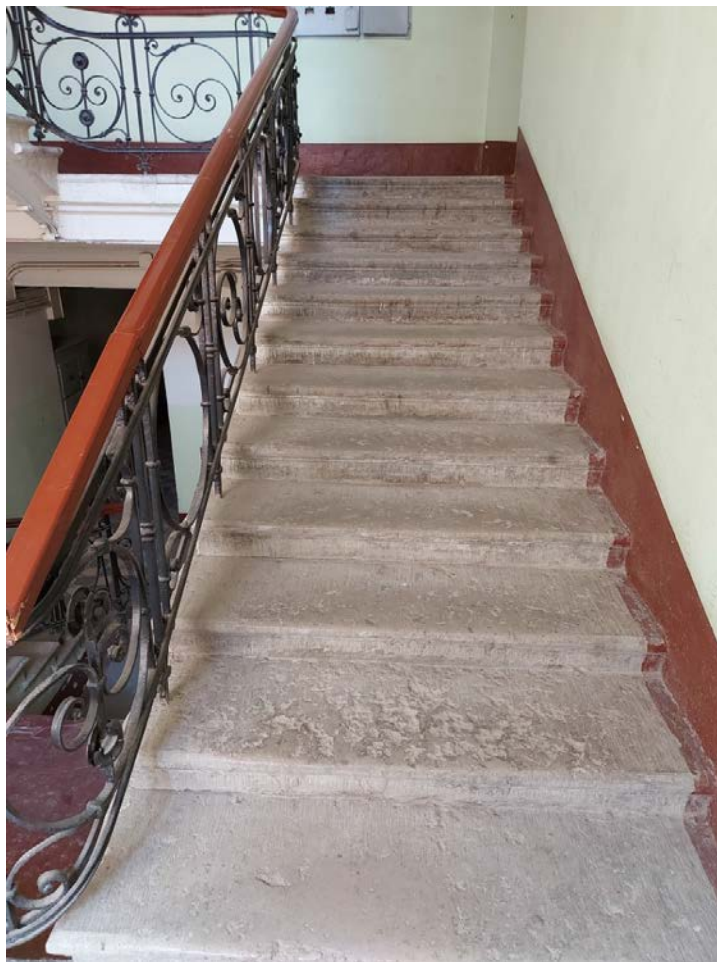
Фото 81. ЗЛК. Лестничный марш на этаж.
