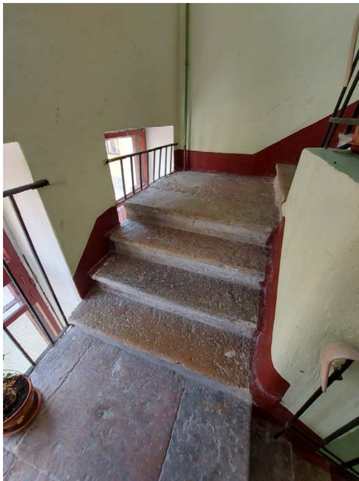
Фото 123. 2ЛК. Междуэтажная площадка.
