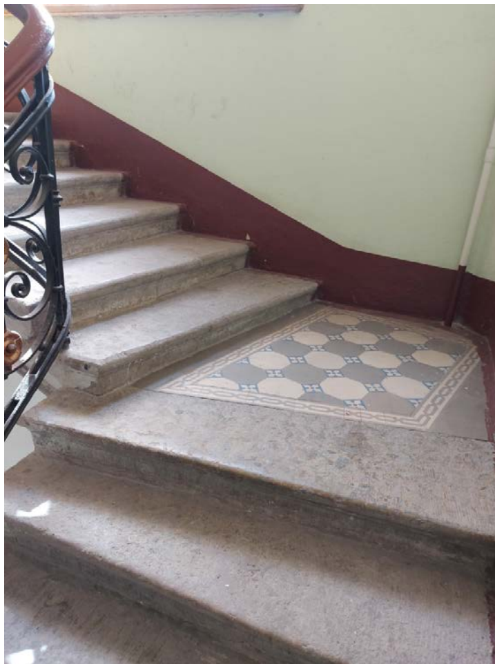
Фото 129. ЗЛК. Междуетажные площадки и марши.
