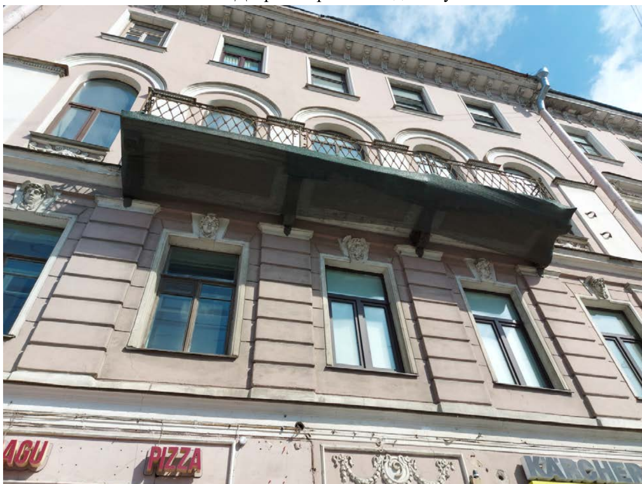
Фото 16. Балкон юго-западного фасада.
