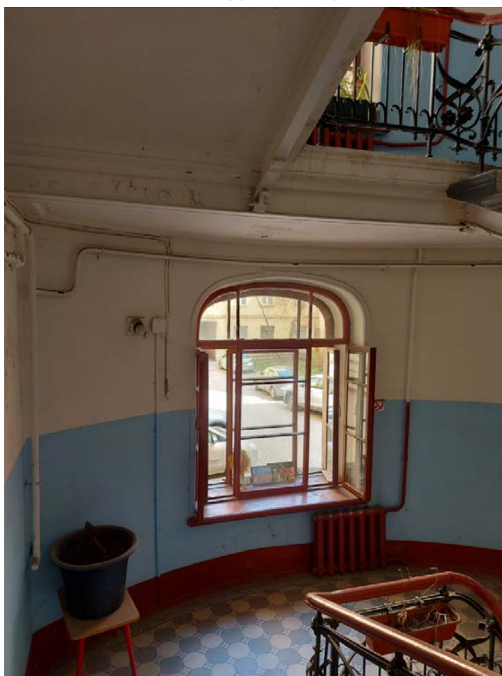
Фото 68. Междуэтажная площадка 1ЛК.
