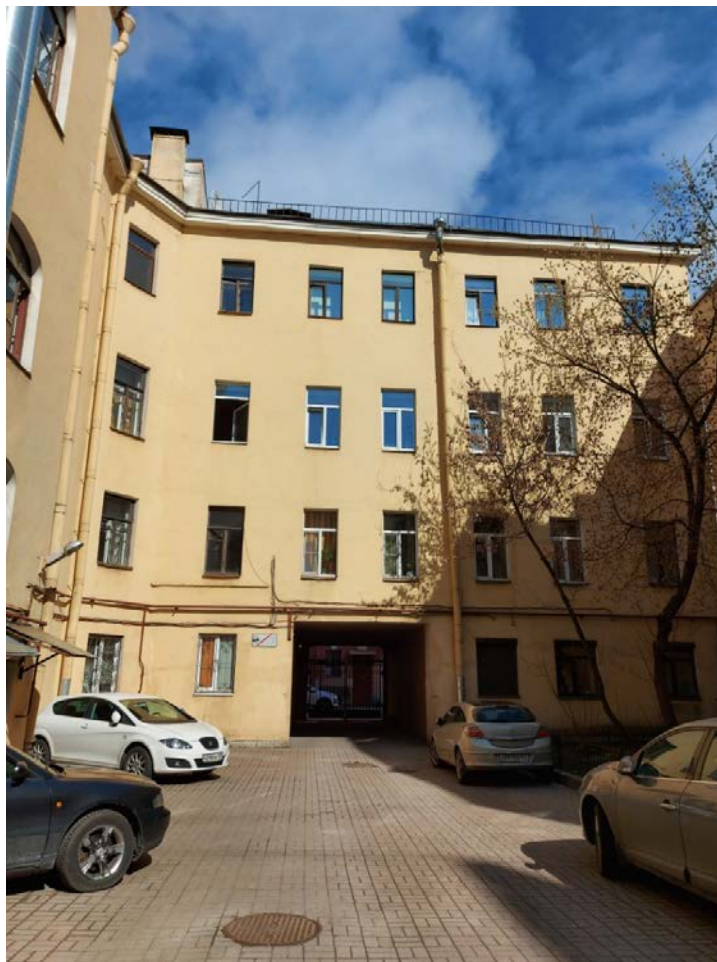
Фото 27. Дворовой юго-западный фасад
