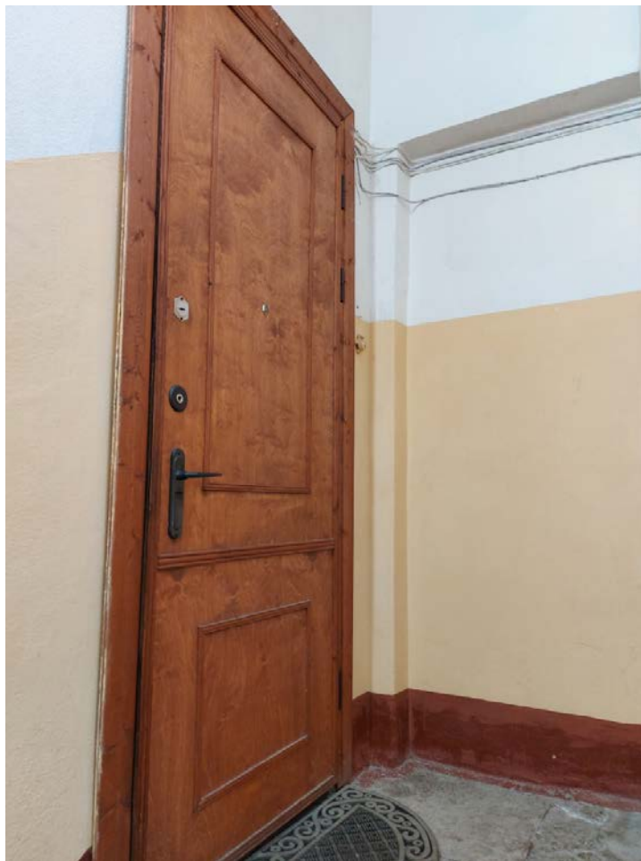
Фото 135. 4ЛК. Проем на площадке этажа
