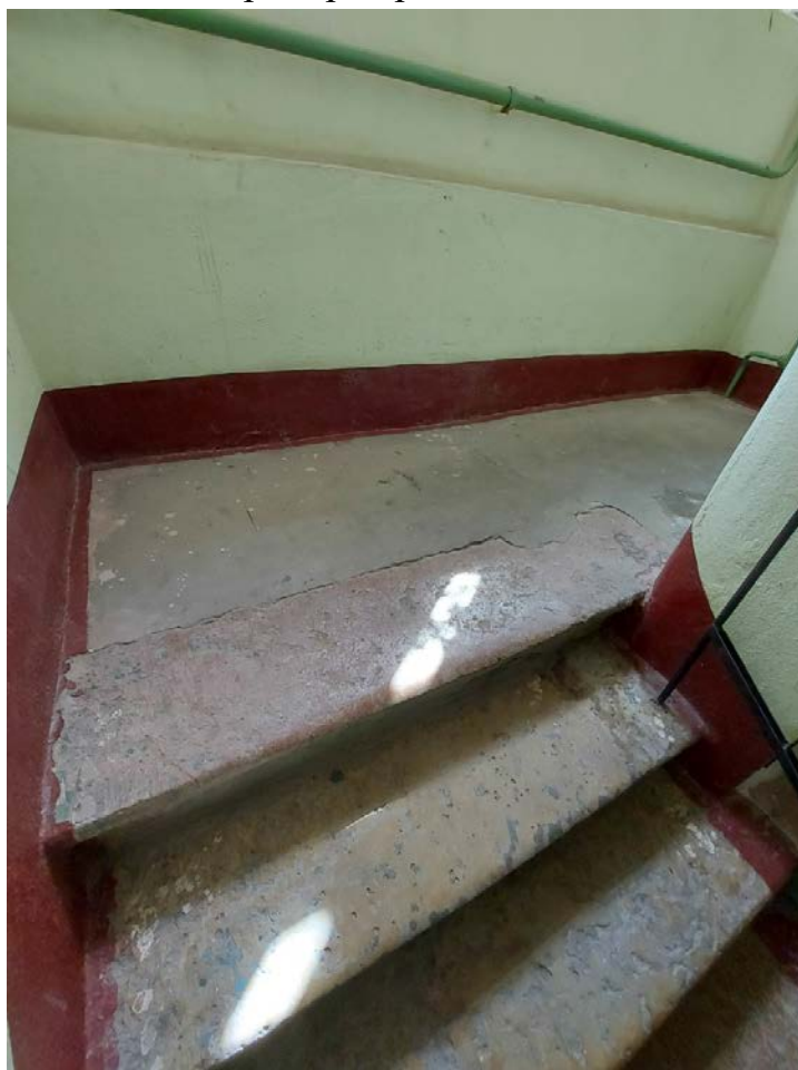
Фото 72. 2ЛК. Междуетажная площадка.
