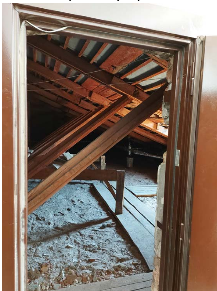
Фото 151. Вход на чердак, юго-восточная часть.
