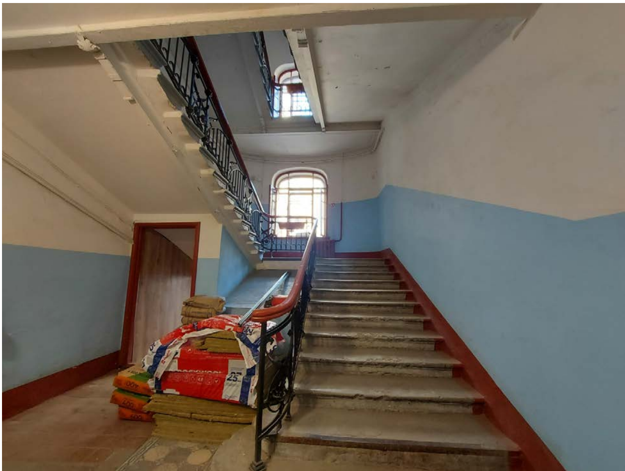
Фото 41. Общий вид 1ЛК.
