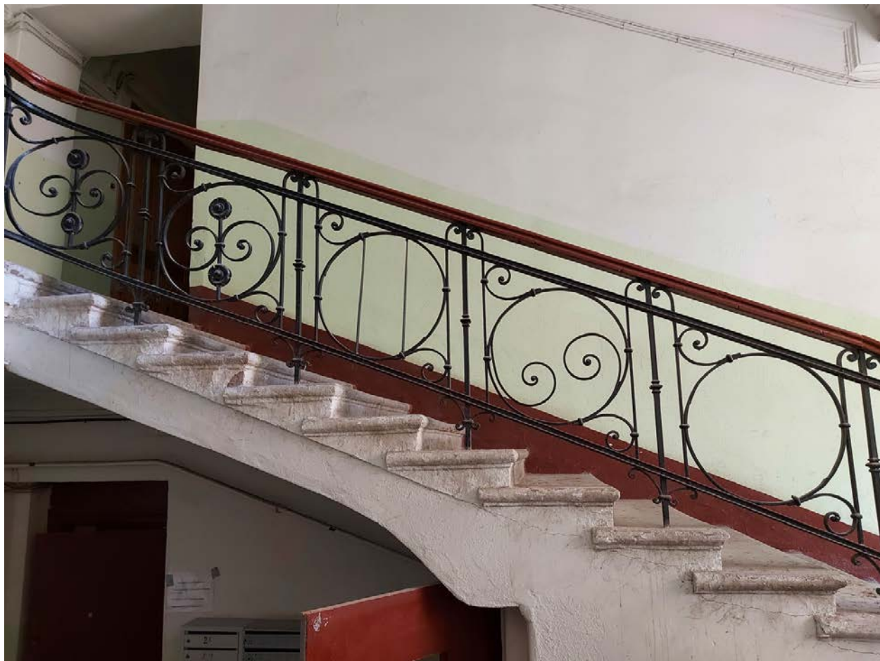
Фото 77. ЗЛК. Фрагмент ограждения марша.
