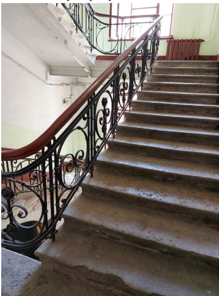
Фото 84. ЗЛК. Лестничный марш.
