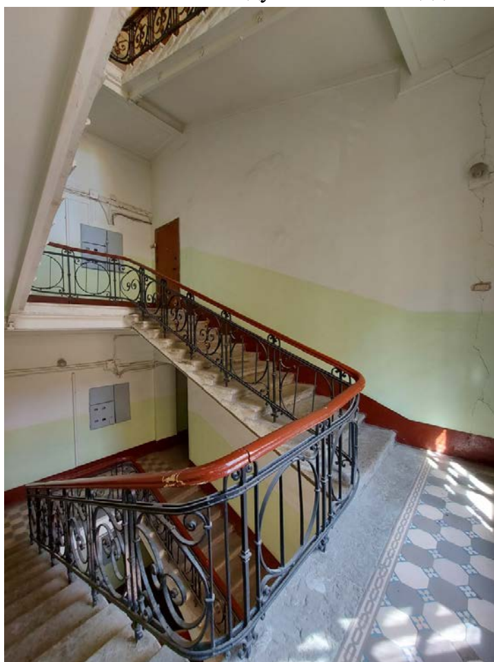
Фото 106. ЗЛК. Вид лестницы с ограждением.
