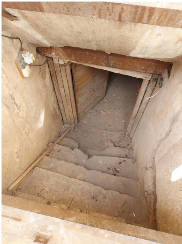
Фото 29. Спуск в подвал.
