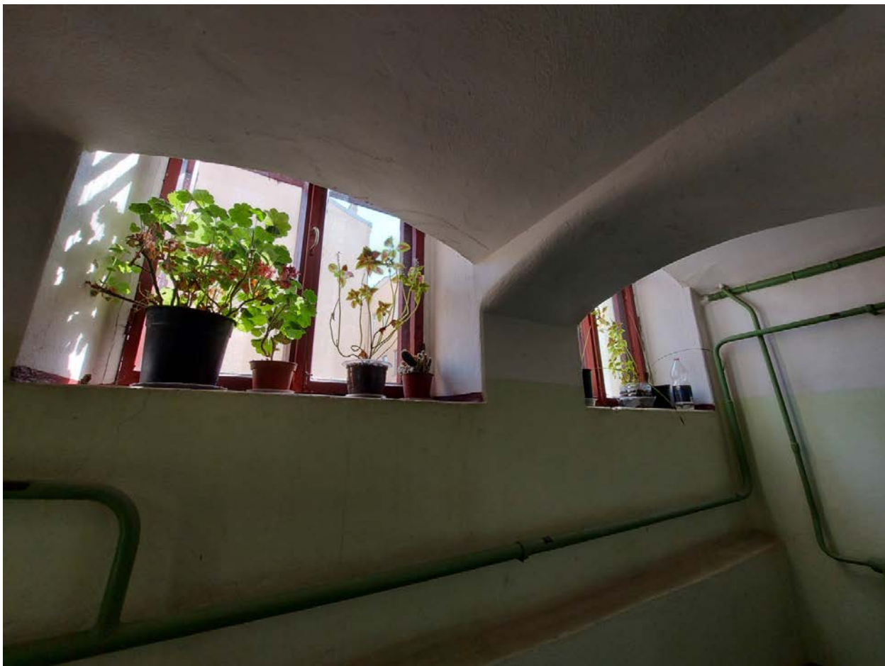
Фото 73. 2ЛК. Перекрытие междуэтажной площадки.
