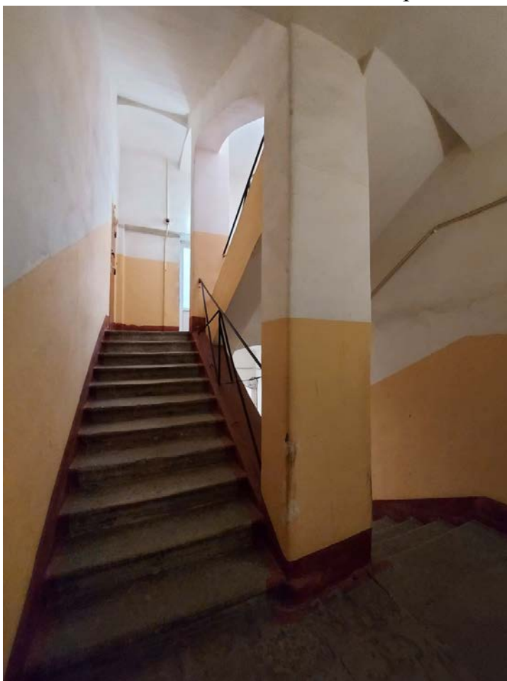
Фото 90. 4ЛК. Междуэтажная площадка
