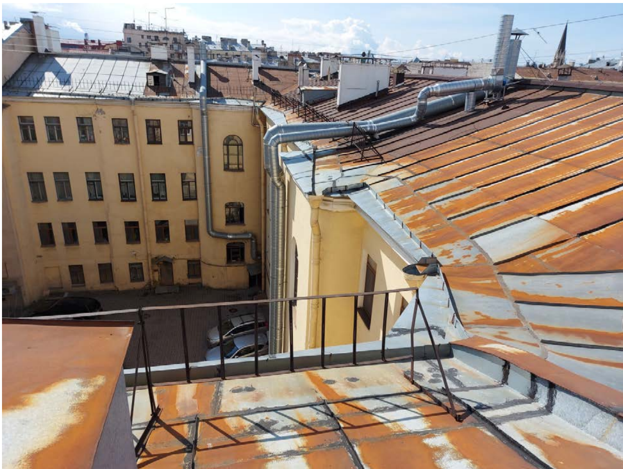
Фото 154к. Общий вид крыши.
