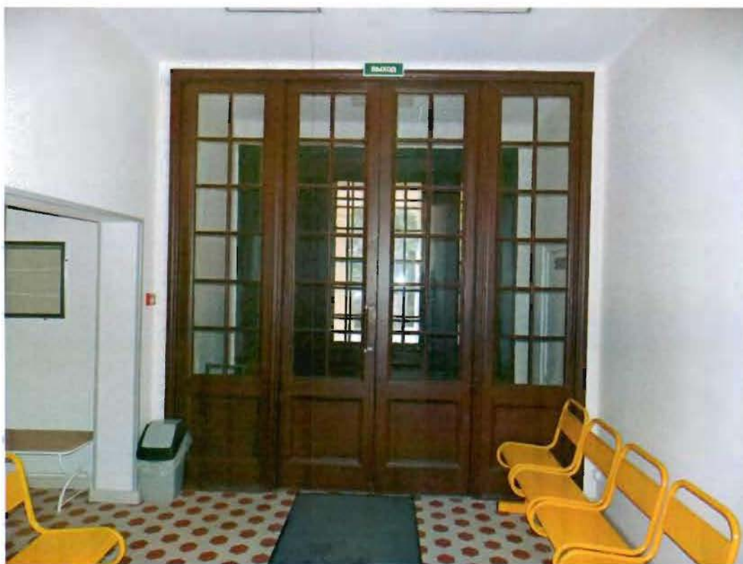
7. Тамбур парадного входа.
