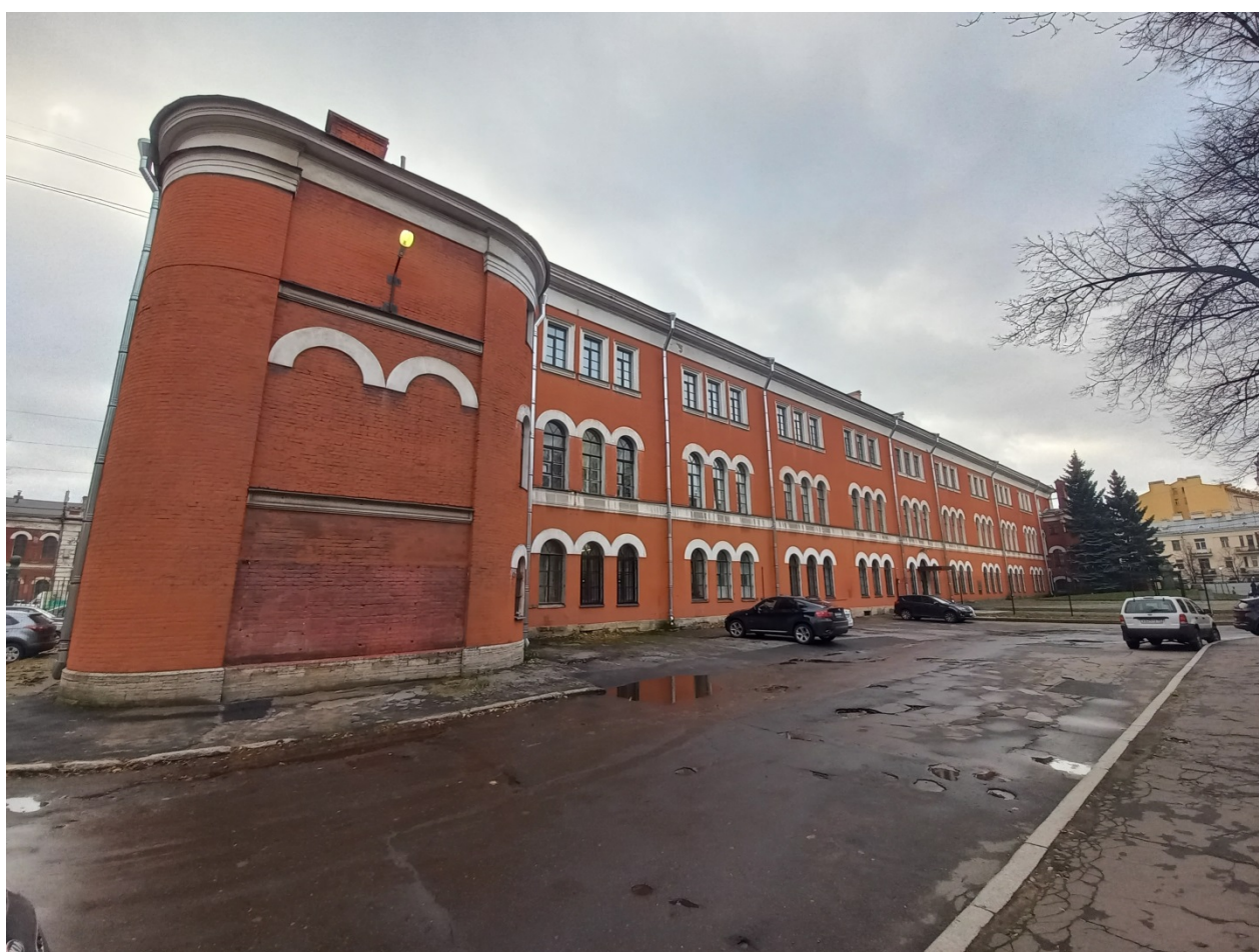
Фото 1. Дворовый фасад. Направление съемки – юго-запад.
