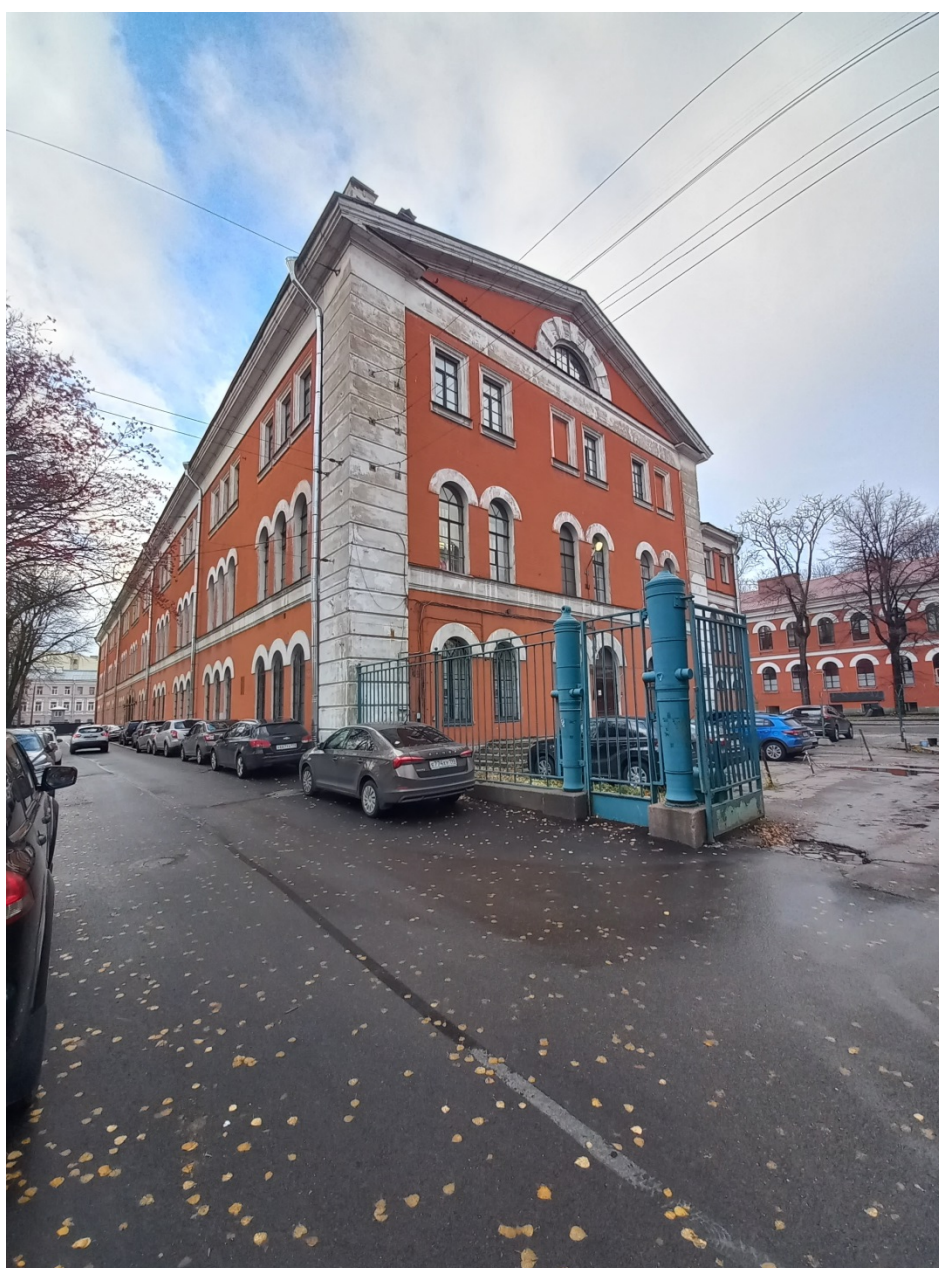
Фото 7. Торцевой фасад. Фасад по ул. Комсомола. Направление съемки – северо - запад.
