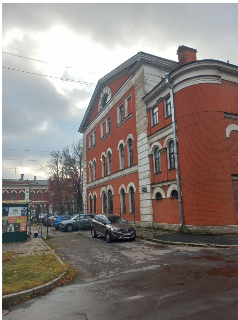
Фото 5. Дворовый и торцевой фасады. Направление съемки – юго-запад.
