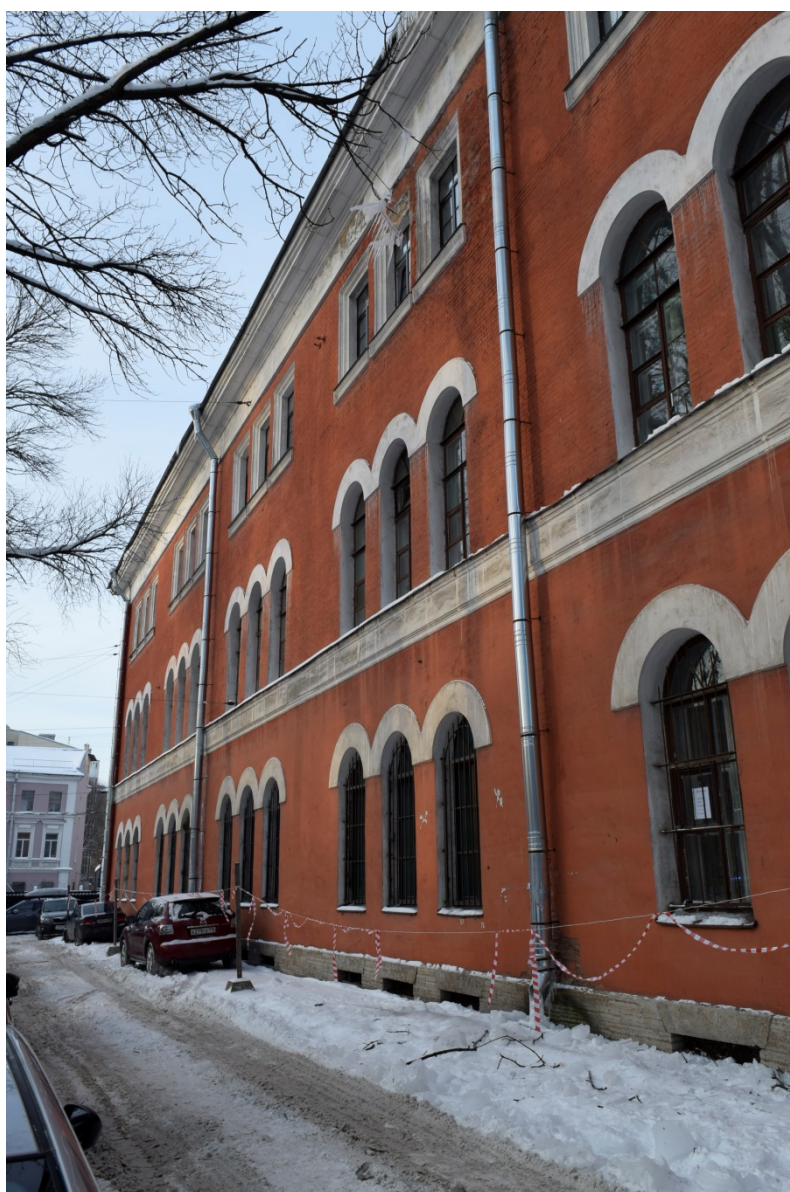
Фото 4*. Южный фасад (фрагмент). Направление съемки – запад.
