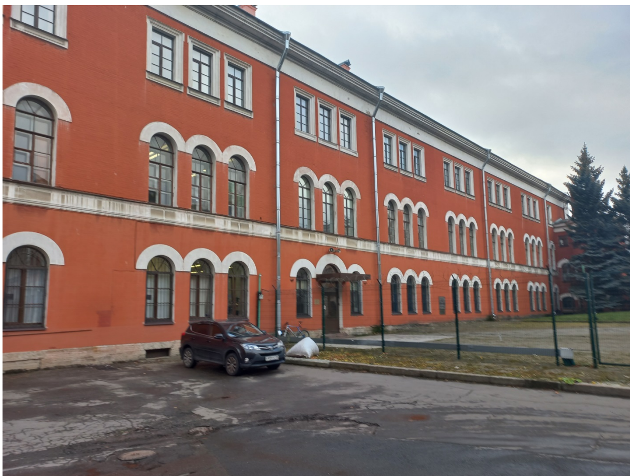
Фото 2. Дворовый фасад. Направление съемки – юго-запад.
