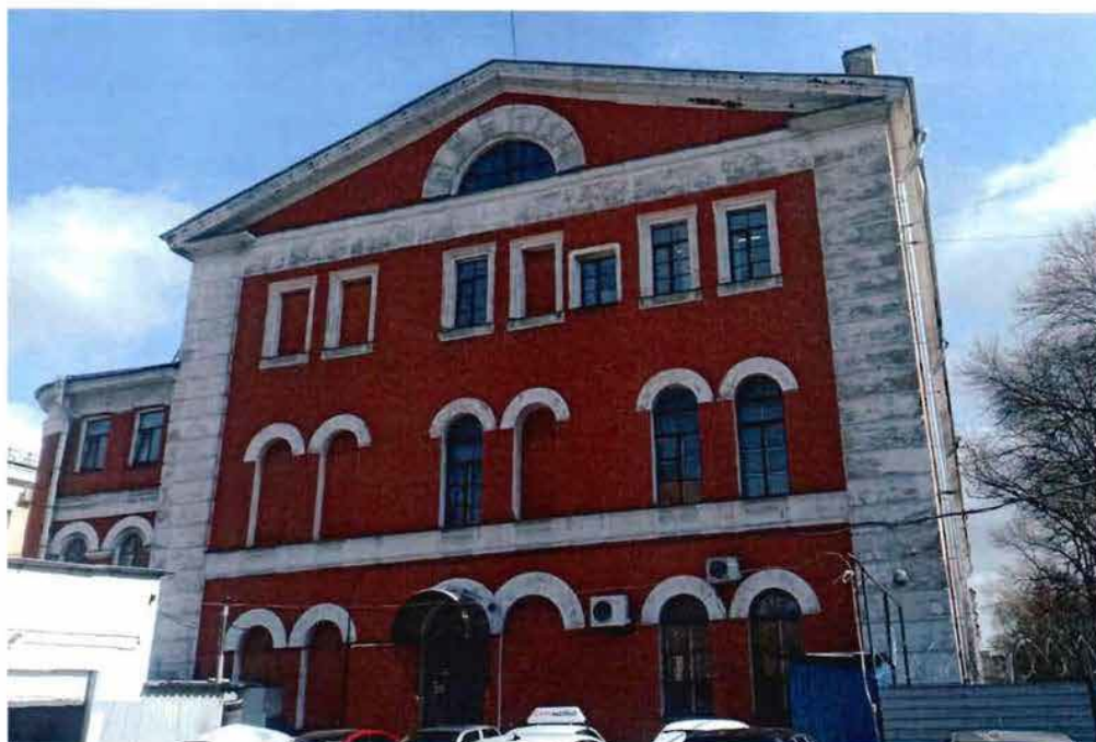
2. Вид на западный фасад объекта культурного наследия.
