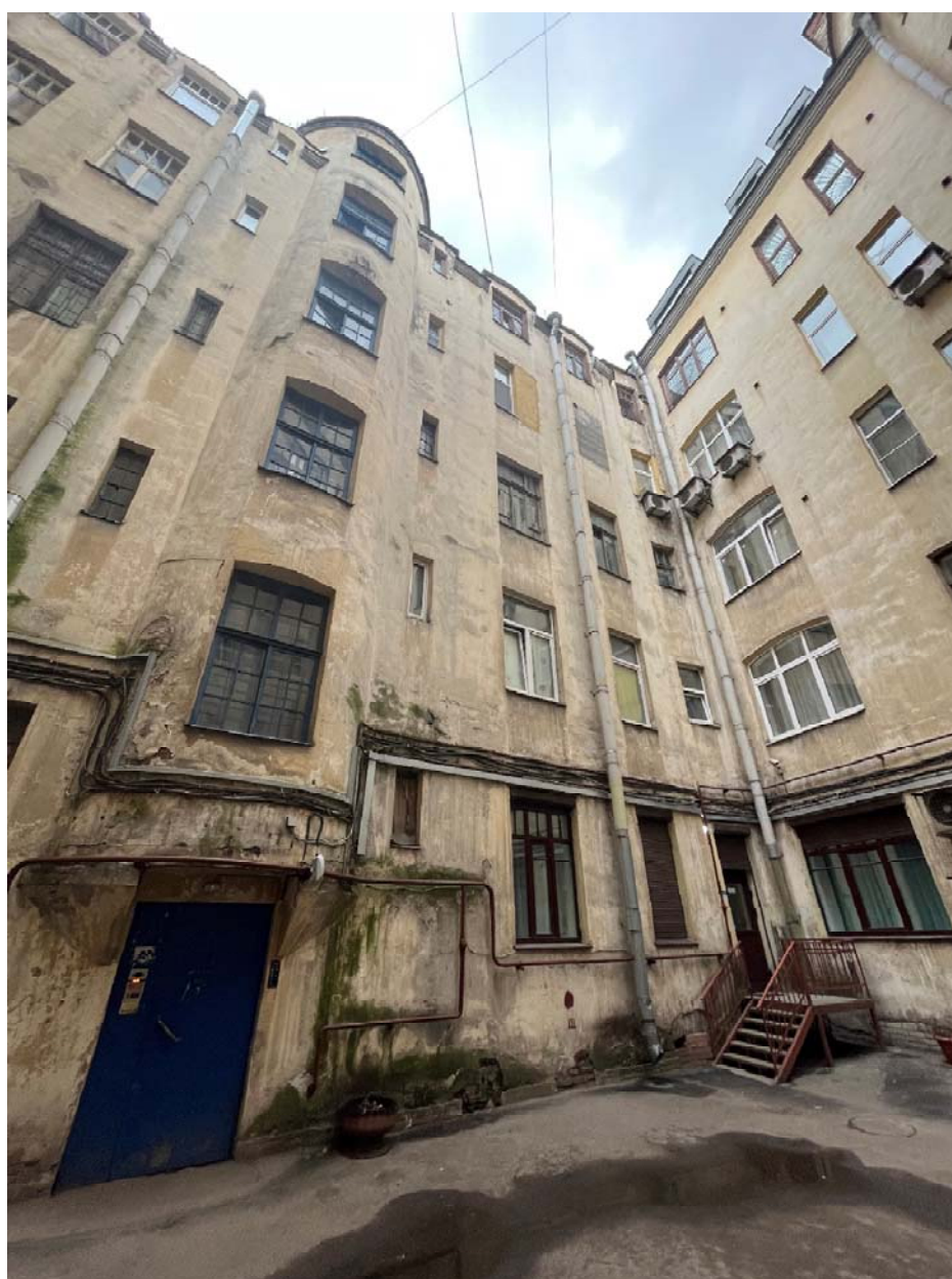
Фото №4. Фрагмент дворового фасада.
