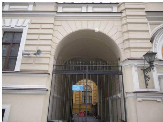
заполнение воротного проезда – материал (металл), конструкция (ворота двустворчатые), оформление (в виде вертикальных прутьев, завершенных пиками; сверху с фризом с мотивом «пояс меандра»);
