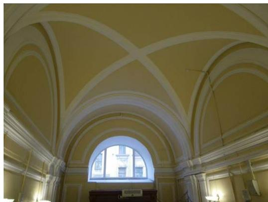
оформление стен – профилированные зеркала; пяты свода опираются на раскрепованные пилястры, каннелированные в верхней половине;
