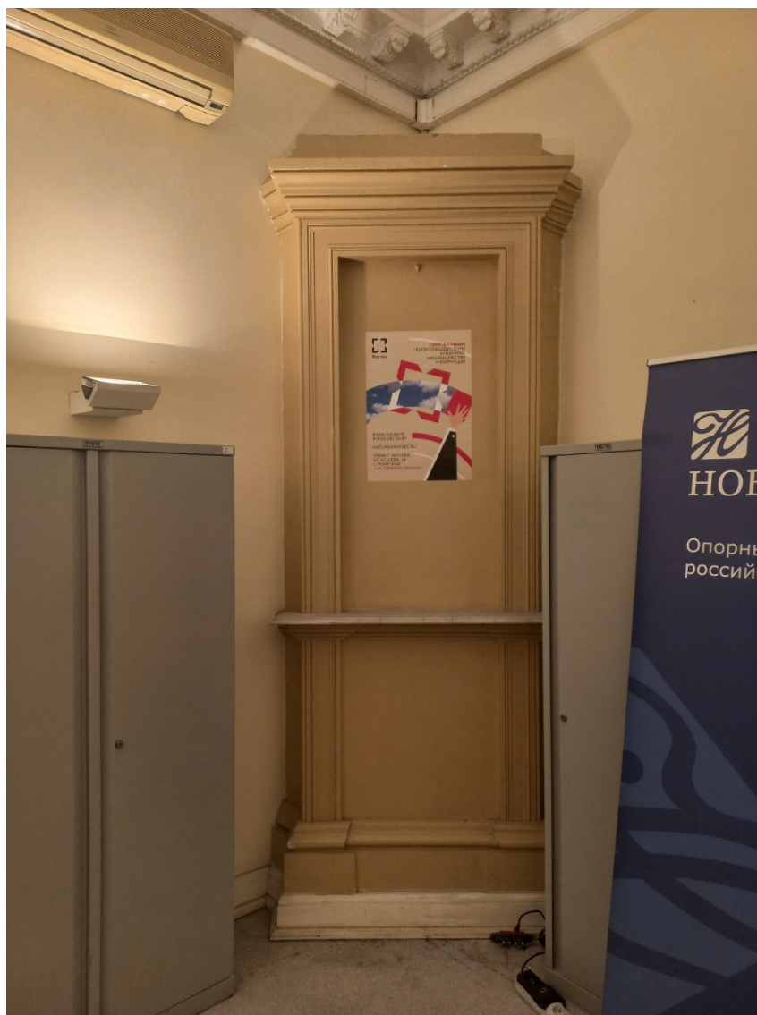
Фото 11. Помещение №15. Общий вид.
