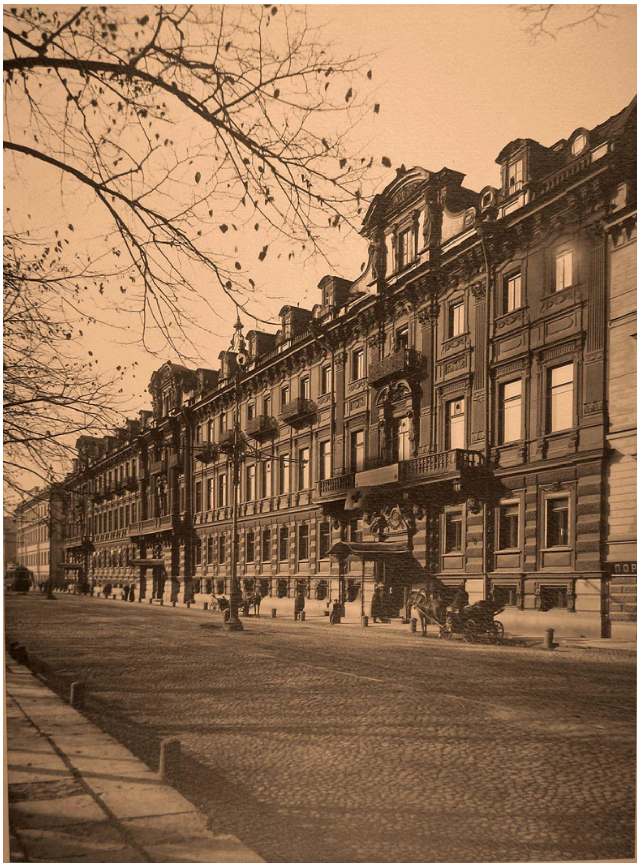
10. Конногвардейский бульвар, 17, фото 1915 г. , источник - https://pastvu.com/ .
