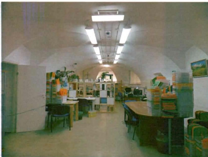
4. Помещение цокольного этажа (7-Н)
