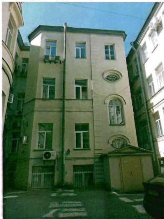
3. Западный дворовый фасад
