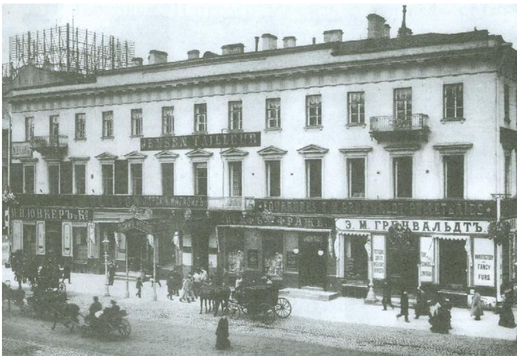
26. Фасад дома № 22 по Невскому проспекту. Фотография. Начало 1900-х гг.
