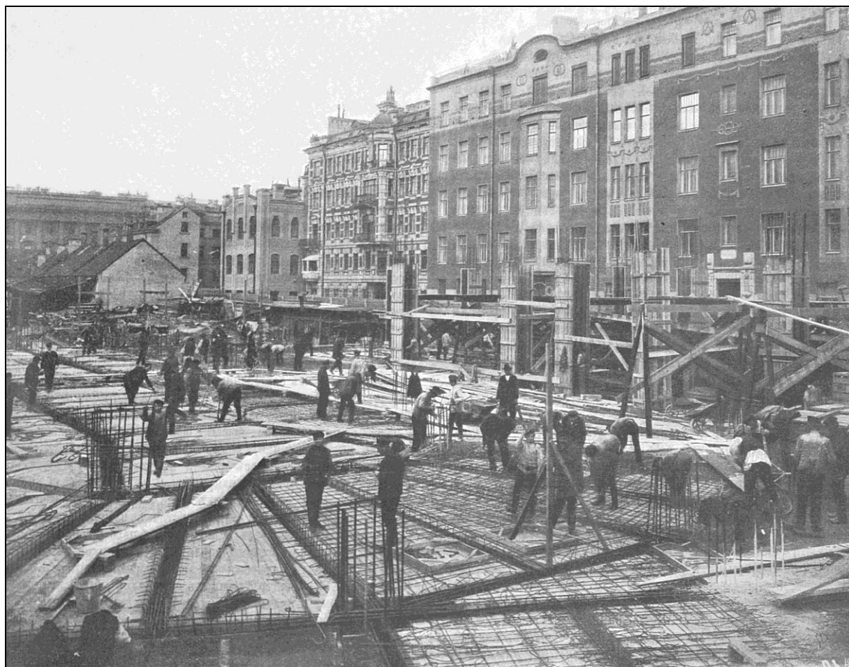
Илл. 24. Работы по устройству балок и перекрытия первого этажа здания Гвардейского экономического общества. На заднем плане – фрагмент лицевого фасада доходного дома по Волынскому переулку. Фотография. 1908 г.
