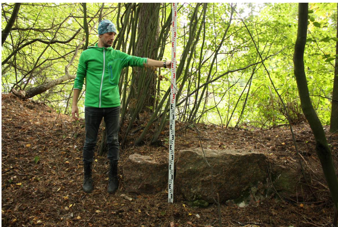
Рис. 15. Санкт-Петербург-2022. Сестрорецкий курзал. Точка фотофиксации 4. Участок кладки подпорной стены террасы. Вид с запада.
