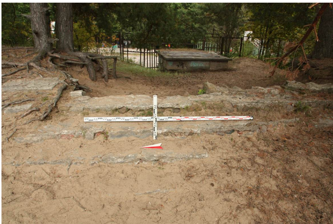
Рис. 29. Санкт-Петербург-2022. Сестрорецкий курзал. Основание ступеней центральной лестницы. Вид с запада.
