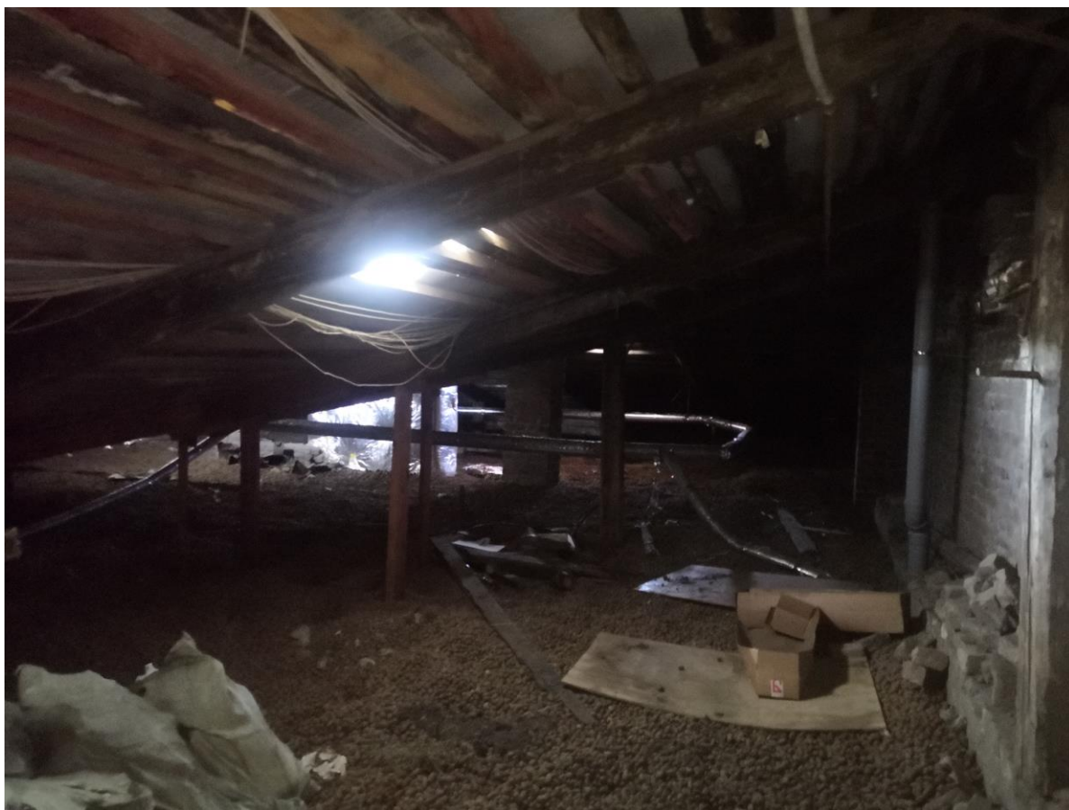
Фото.19. Общий вид на помещение чердака.
