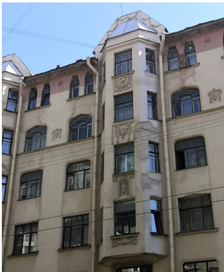
Фото.7. Вид на эркер лицевого западного фасада.
