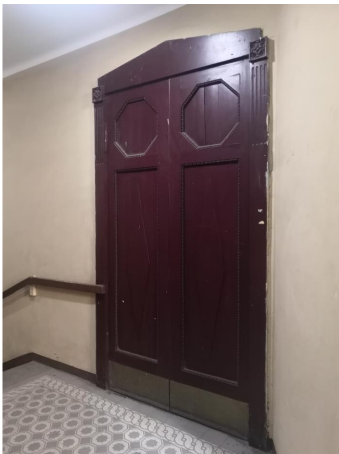
Фото.25. Историческое дверное заполнение лестничной клетки.
