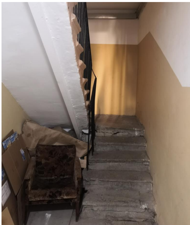
Фото.47. Вид на лестничную клетку. Первый этаж.
