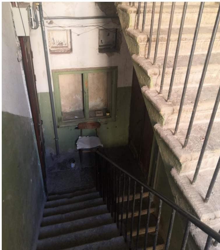
Фото.49. Вид на лестничную клетку. Типовой этаж.
