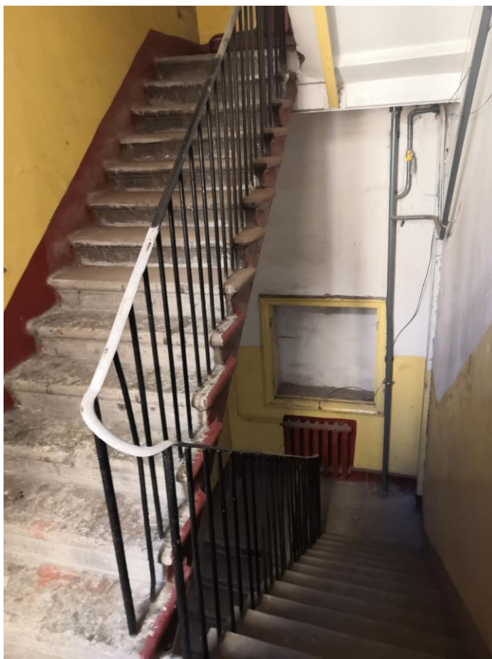
Фото.57. Вид на лестничную клетку. Типовой этаж.
