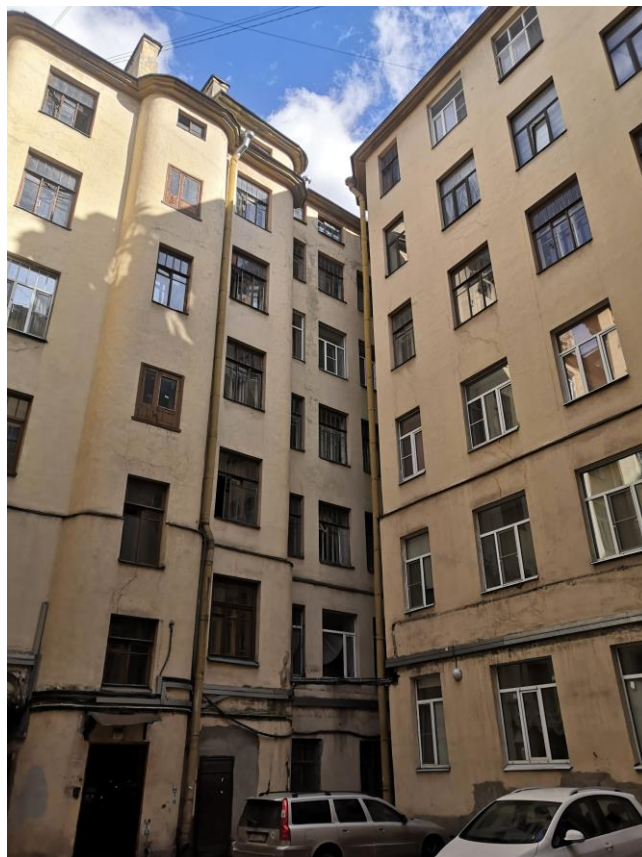
Фото.11. Вид на дворовой фасад.
