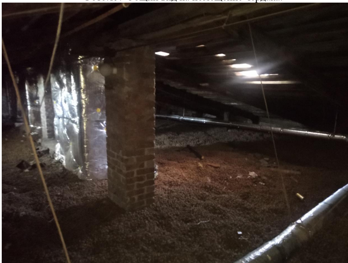
Фото.20. Общий вид на помещение чердака.
