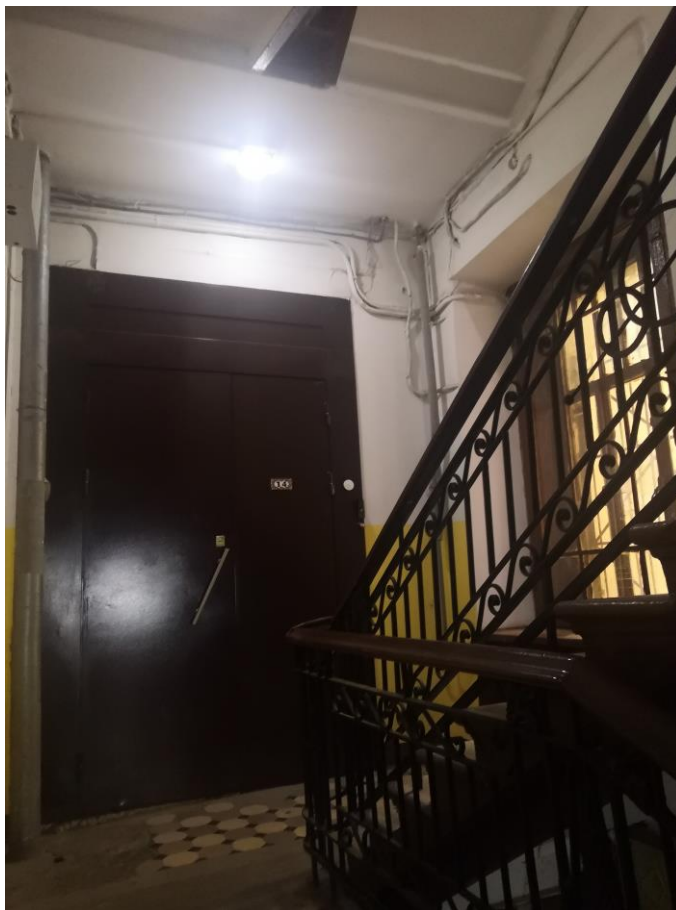
Фото.39. Вид на лестничную клетку. Типовой этаж.
