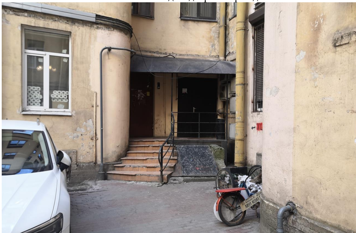
Фото.12. Вид на вход в южную черную лестницу западного корпуса.
