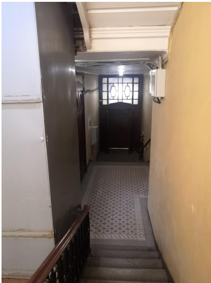
Фото.27. Вид на вестибюль и лестничную клетку. Первый этаж.
