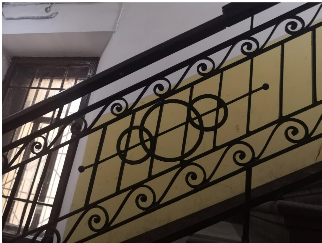
Фото.37. Вид на ограждение лестничной клетки.
