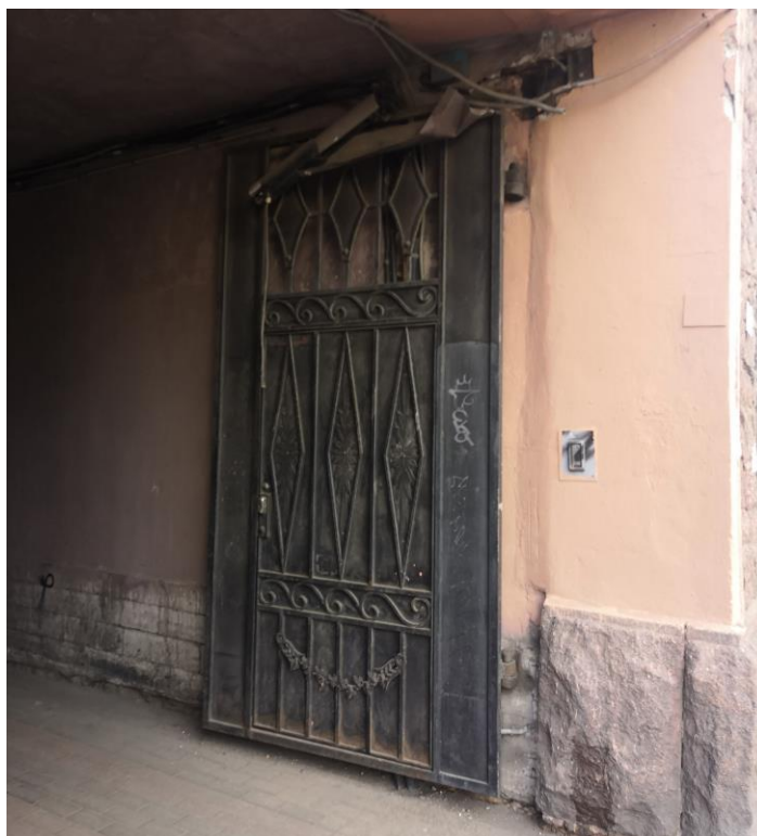
Фото.5. Вид на заполнение воротного проезда.
