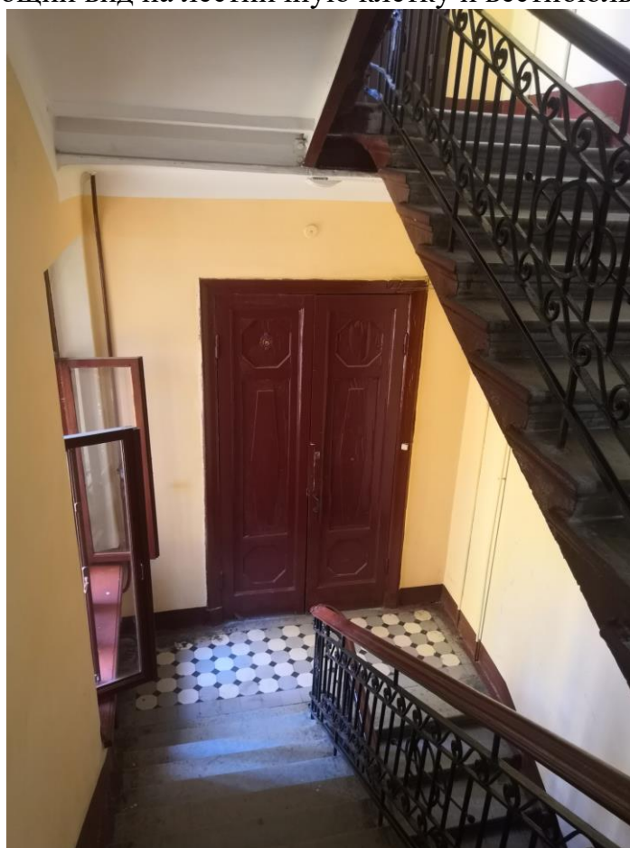
Фото.44. Общий вид на лестничную клетку. Типовой этаж.
