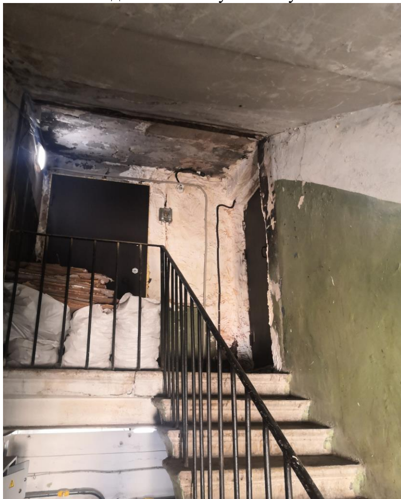
Фото.50. Вид на лестничную клетку. Шестой этаж.
