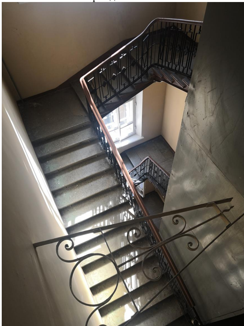
Фото.30. Общий вид на лестничную клетку. Шестой этаж.
