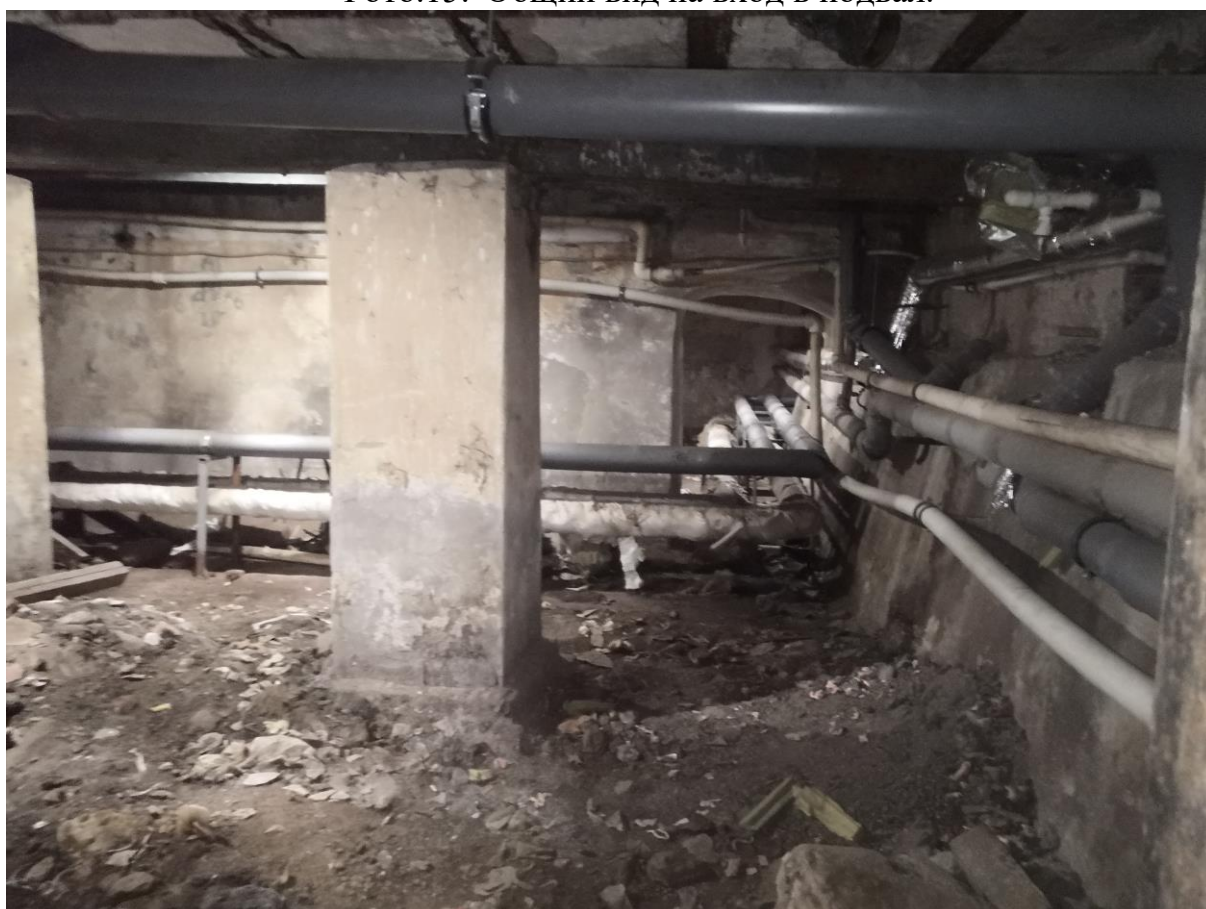
Фото.16. Общий вид на помещение подвала.
