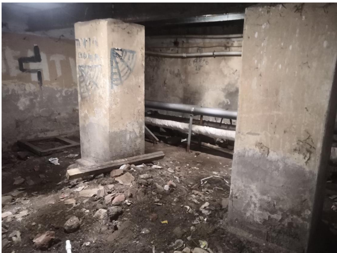
Фото.17. Общий вид на помещение подвала.
