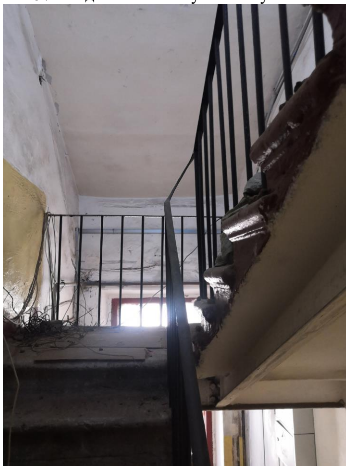
Фото.58. Вид на лестничную клетку. Шестой этаж.
