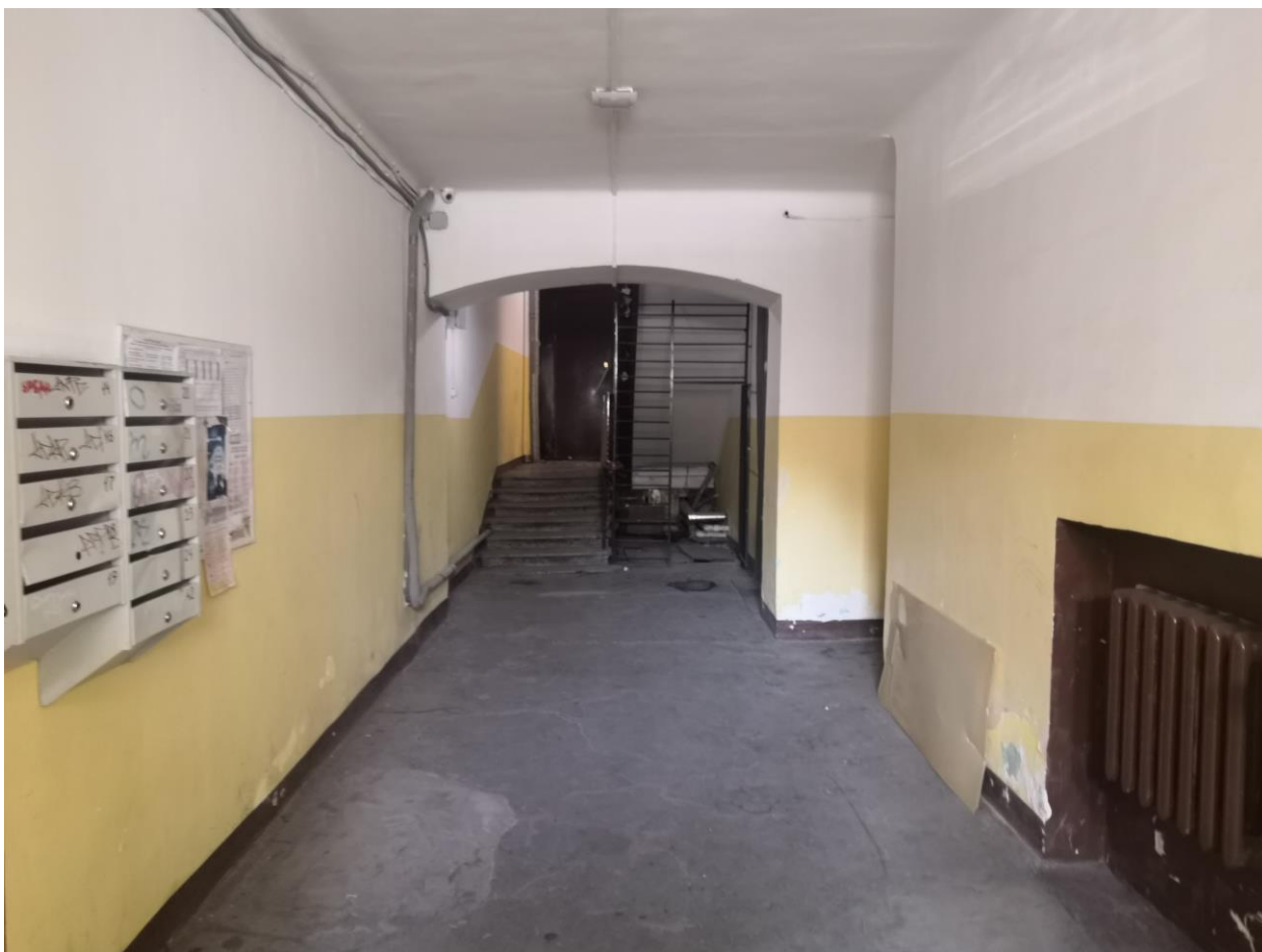
Фото.35. Общий вид вестибюль.
