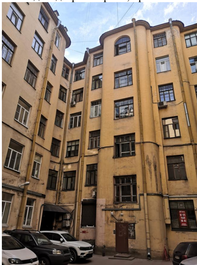
Фото.10. Вид на дворовой фасад.
