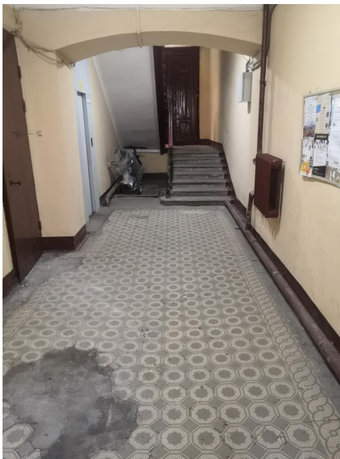
Фото.43. Общий вид на лестничную клетку и вестибюль. Первый этаж.
