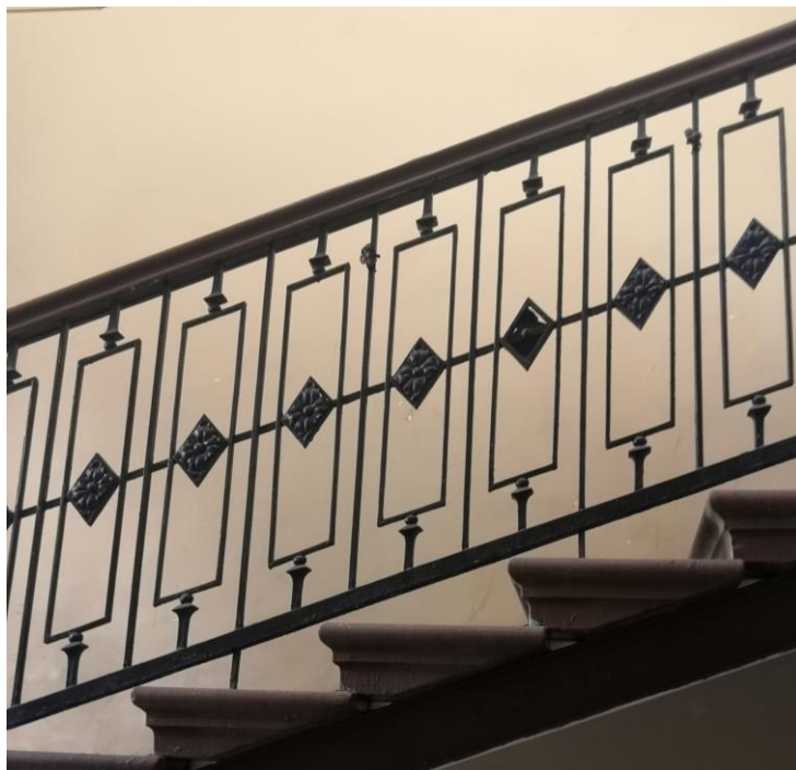
Фото.29. Ограждение лестничной клетки.
