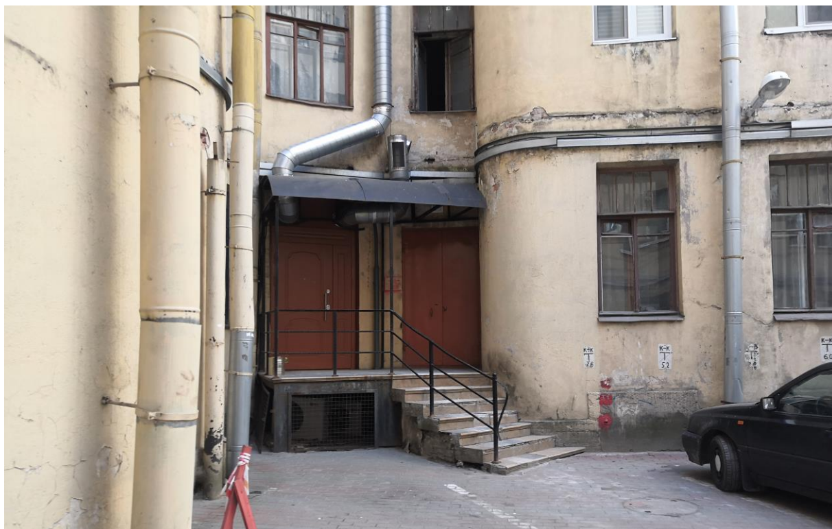
Фото.13. Вид на вход в северную черную лестницу западного корпуса.
