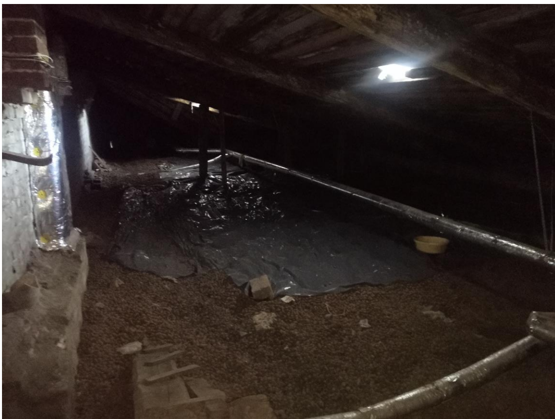
Фото.21. Общий вид на помещение чердака. Интерьеры. 1ЛК.
