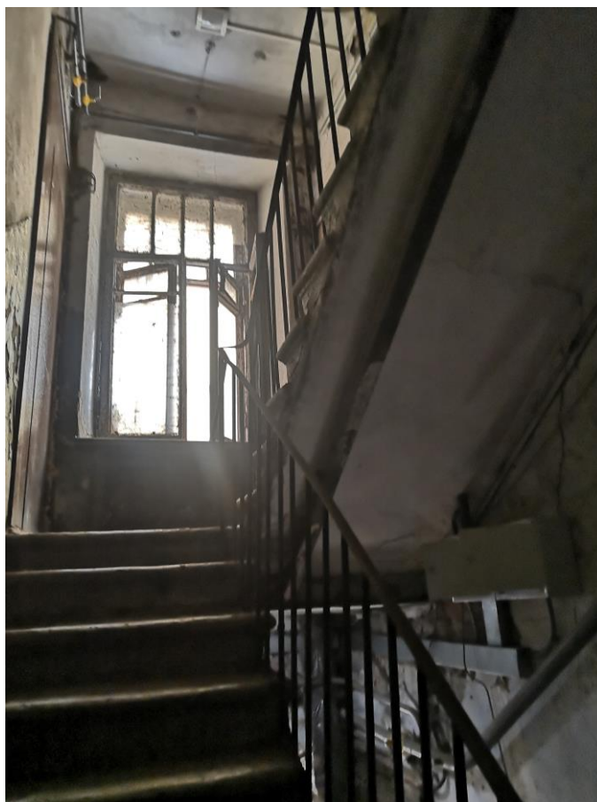
Фото.53. Вид на лестничную клетку. Типовой этаж.
