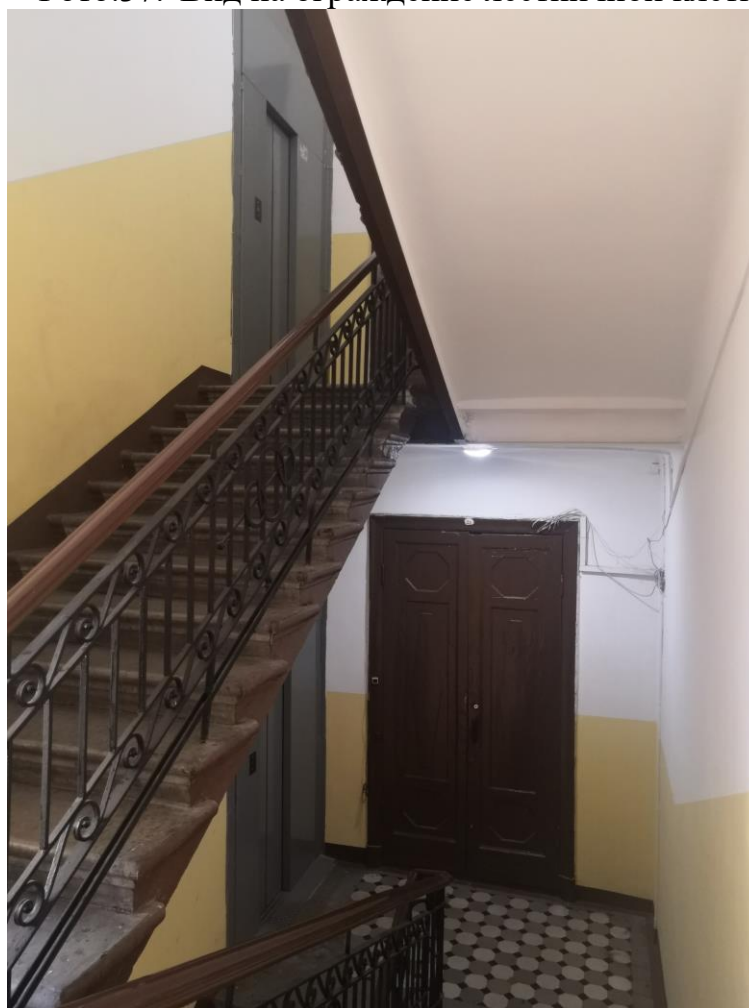
Фото.38. Вид на лестничную клетку. Типовой этаж.
