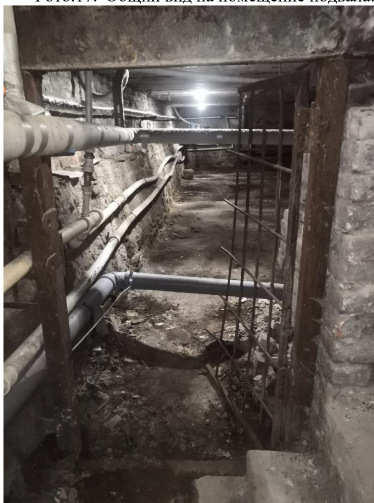
Фото.18. Общий вид на помещение подвала.
