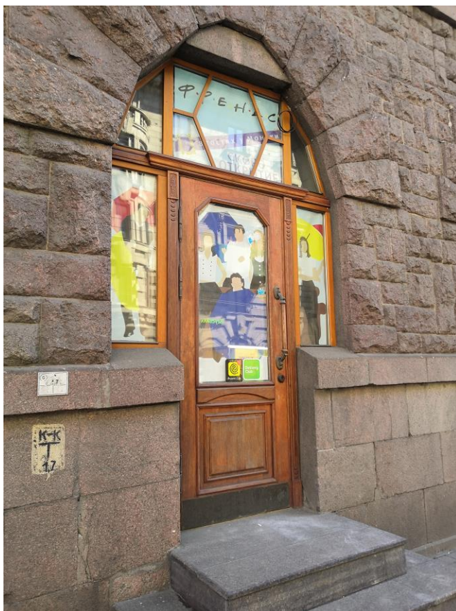
Фото.9. Вид на дверной проем, пробитый из оконного.
