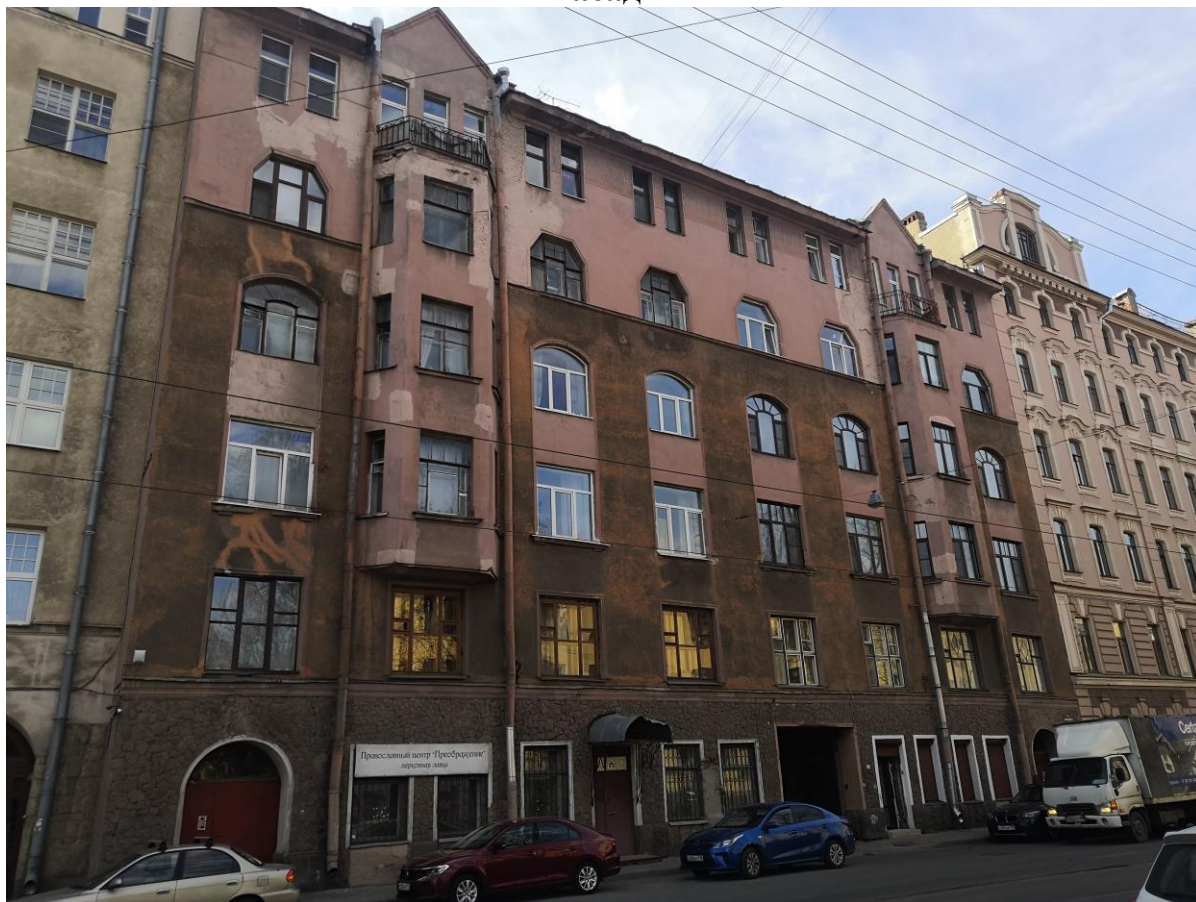
Фото.1. Общий вид на восточный лицевой фасад.
