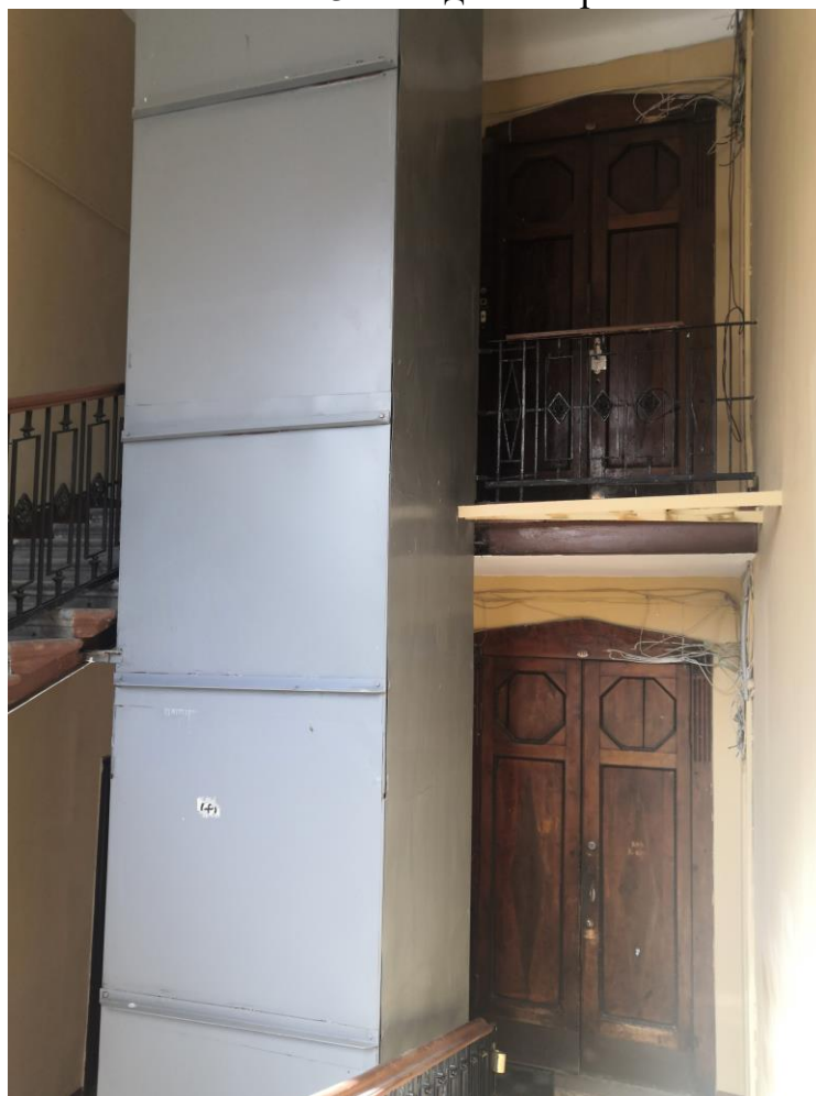
Фото.32. Общий вид на лестничную клетку. Шестой этаж.
