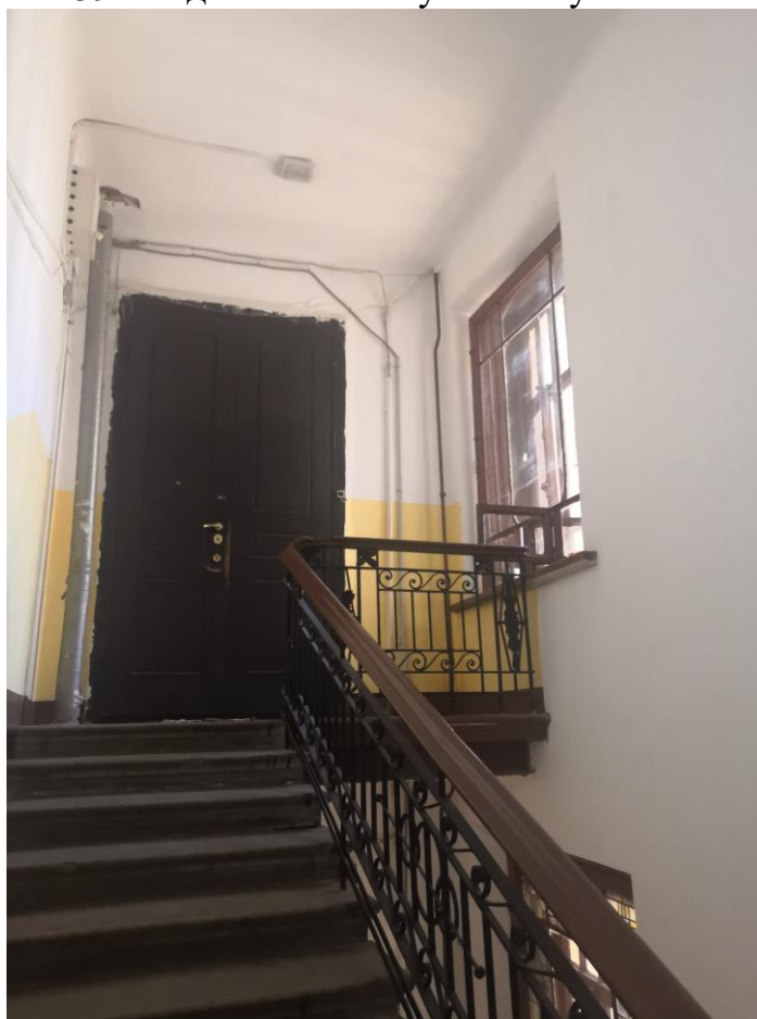
Фото.40. Вид на лестничную клетку. Шестой этаж.
