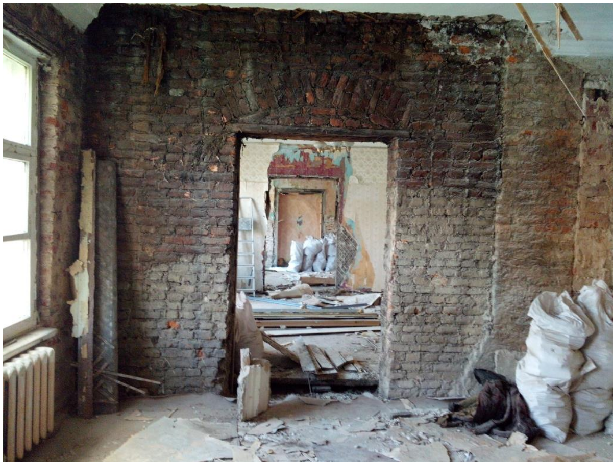
11. Выявленный объект культурного наследия «Дом Мичуриных», расположенный по адресу: Санкт-Петербург, 1-я линия В.О., дом 40, литера А. Квартира № 8. Помещение №№ 3, 5, 6, 7, 8 (в соответствии с планом ПИБ). 19.03.2021.
