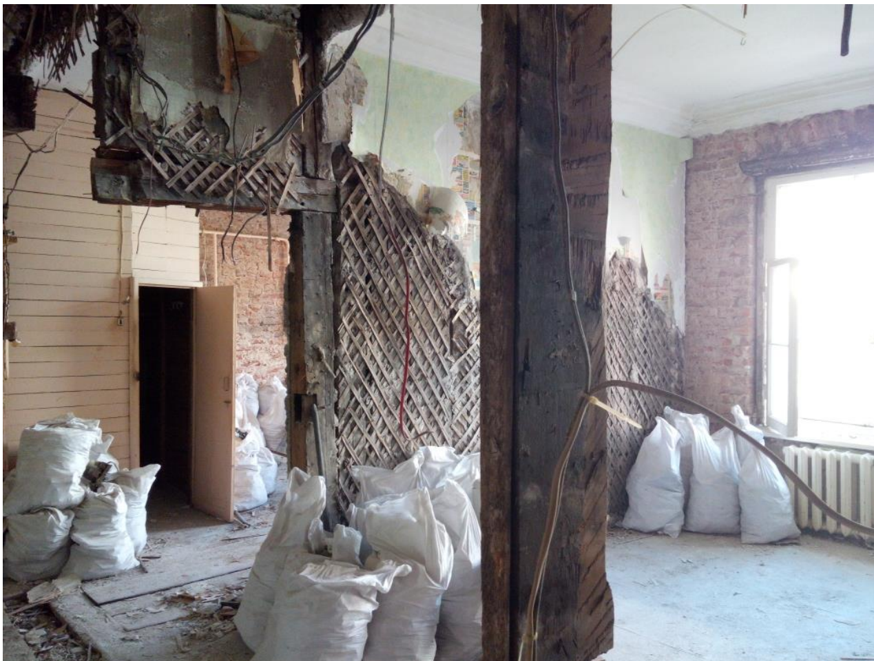
8. Выявленный объект культурного наследия «Дом Мичуриных», расположенный по адресу: Санкт-Петербург, 1-я линия В.О., дом 40, литера А. Квартира № 8. Помещение № 2 (в соответствии с планом ПИБ). 19.03.2021.
