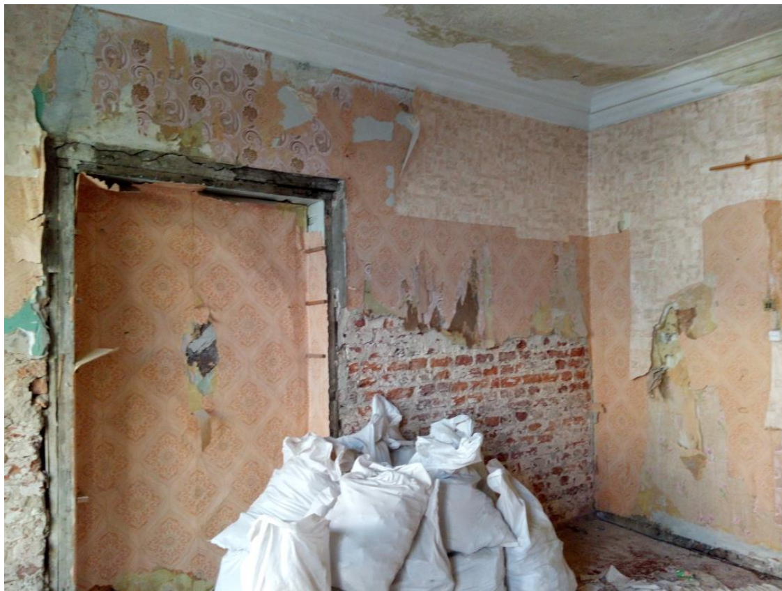
14. Выявленный объект культурного наследия «Дом Мичуриных», расположенный по адресу: Санкт-Петербург, 1-я линия В.О., дом 40, литера А. Квартира № 8. Помещение № 7 (в соответствии с планом ПИБ). 19.03.2021.
