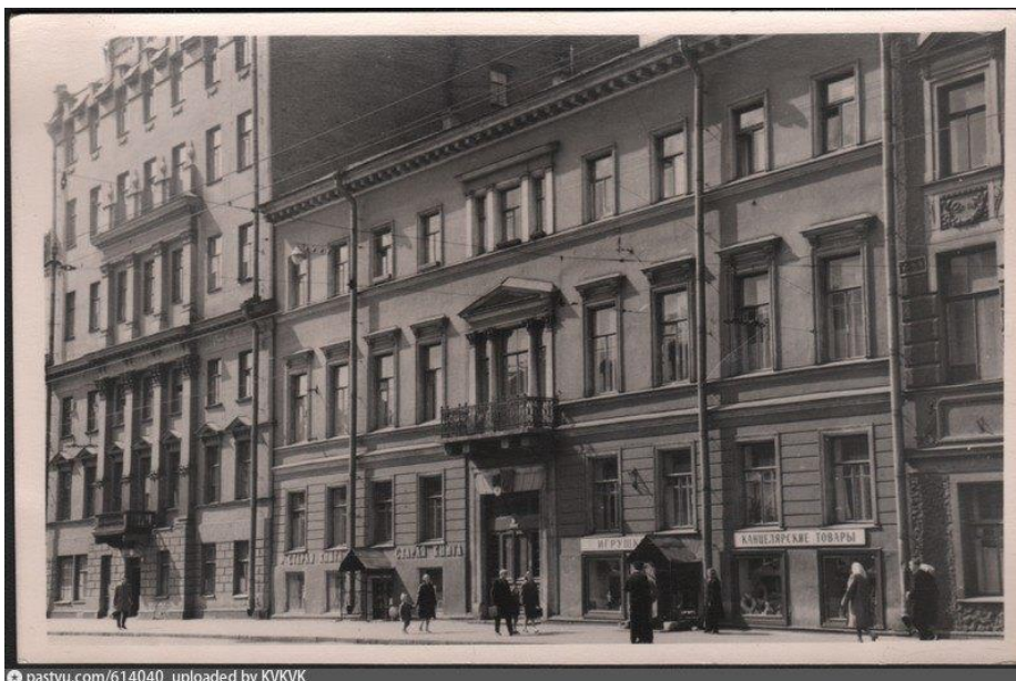
Илл. 18. 1-я линия, дом №40. Фасад. Вид с северо-запада. Фото 1950-1960-х гг. ГМИ СПб Инв.№-II-Б47776ф. Интернет-ресурс http://goskatalog.ru/portal/#/collections?id=7827382 .
