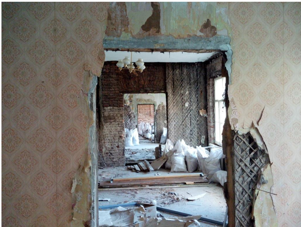
13. Выявленный объект культурного наследия «Дом Мичуриных», расположенный по адресу: Санкт-Петербург, 1-я линия В.О., дом 40, литера А. Квартира № 8. Помещения №№ 2,3,5,6, 7 (в соответствии с планом ПИБ). 19.03.2021.
