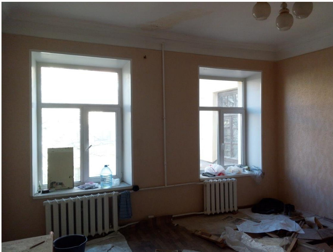
16. Выявленный объект культурного наследия «Дом Мичуриных», расположенный по адресу: Санкт-Петербург, 1-я линия В.О., дом 40, литера А. Квартира № 8. Помещение № 8 (в соответствии с планом ПИБ). 19.03.2021.
