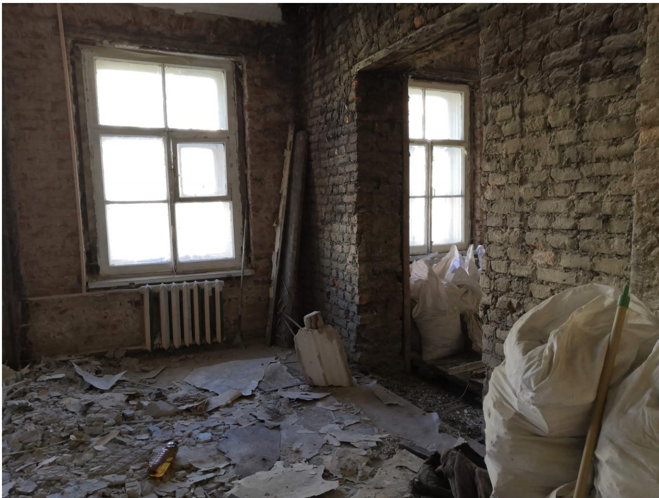
10. Выявленный объект культурного наследия «Дом Мичуриных», расположенный по адресу: Санкт-Петербург, 1-я линия В.О., дом 40, литера А. Квартира № 8. Помещения № 3 и № 5 (в соответствии с планом ПИБ). 19.03.2021.
