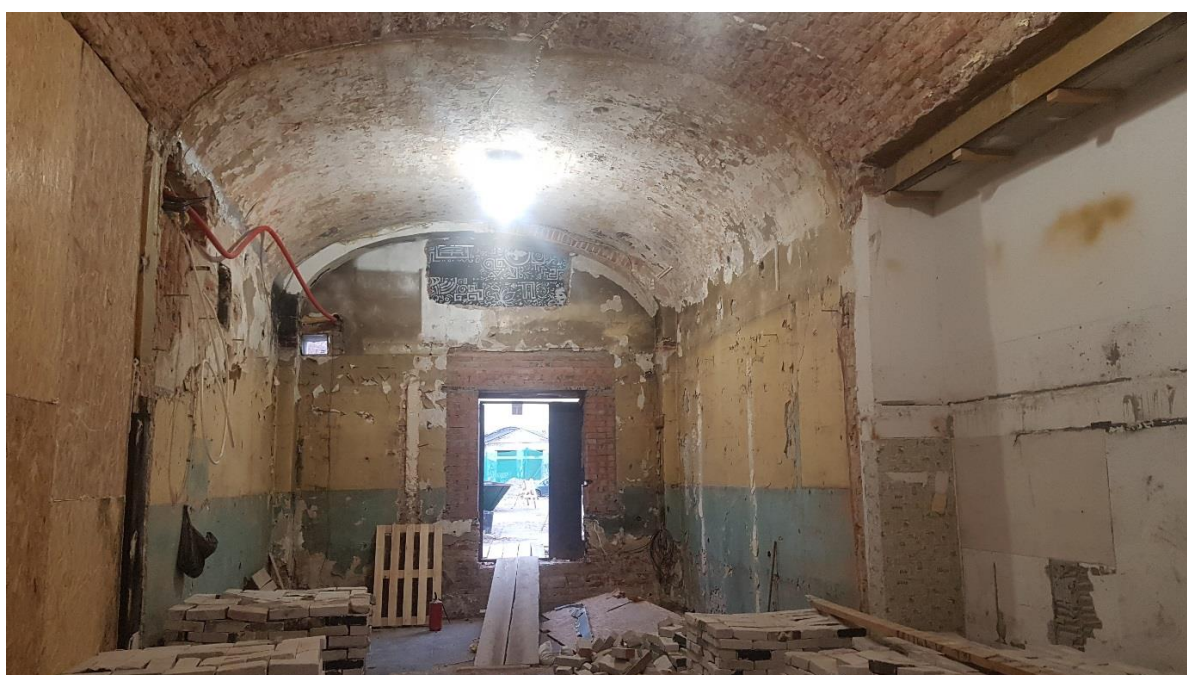
Фото 2. Арочный проем № 1. Помещение между арочными проемами.
