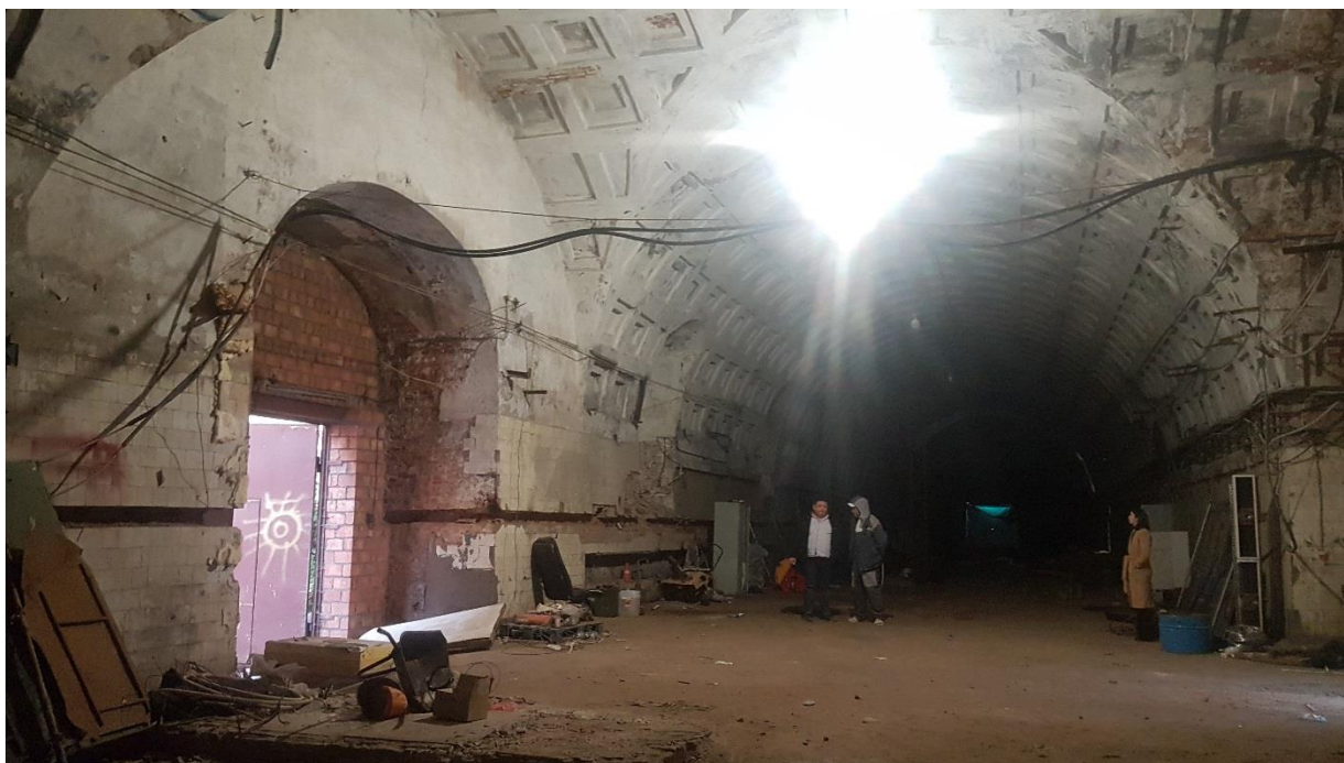
Фото 9. Арочный проем № 2. Помещение 2-Н.
