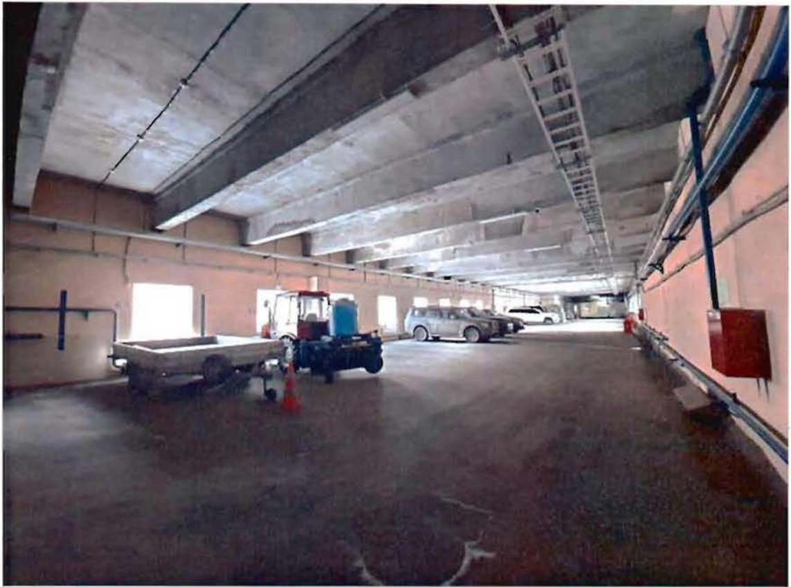
8. Интерьеры. 2 этаж. Дата фотофиксации: 12.03.2021
