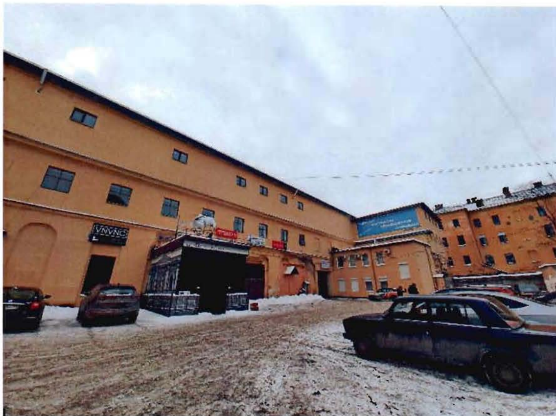
2. Фрагмент северного фасада объекта культурного наследия. Дата фотофиксации: 19.02.2021
