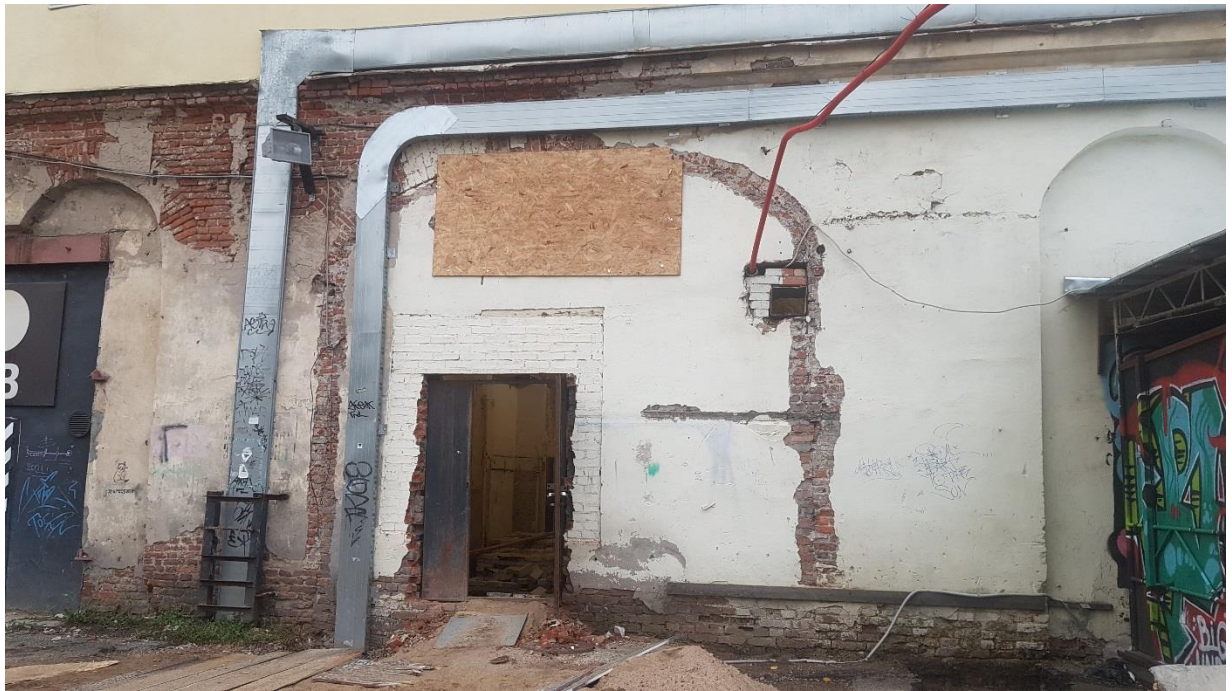
Фото 5. Арочный проем № 1. Вид со двора.
