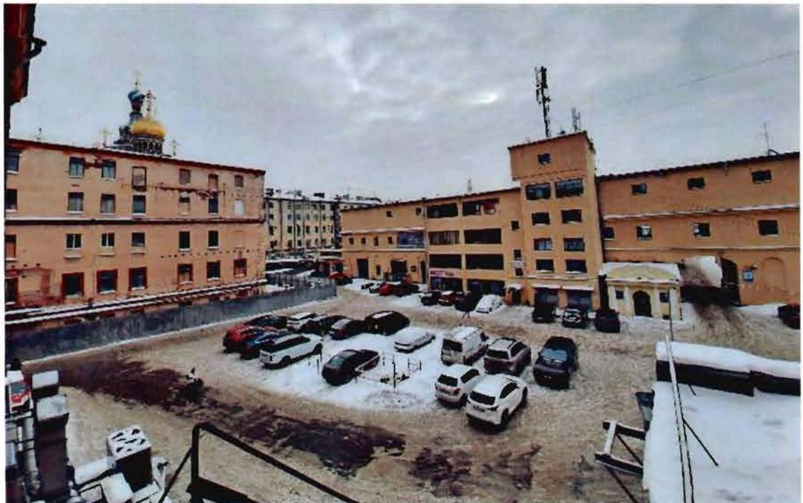
11. Территория объекта культурного наследия регионального значения «Конюшенный двор», вид с севера. Дата фотофиксации: 19.02.2021
