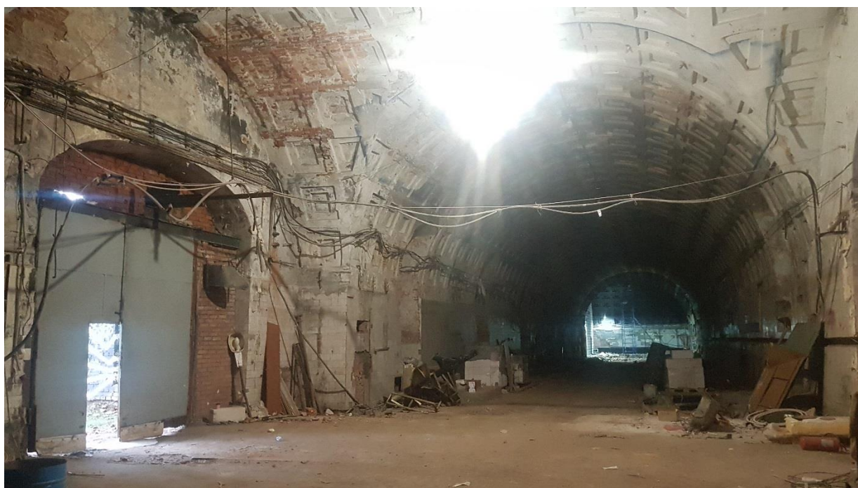
Фото 8. Арочный проем № 2. Помещение 2-Н.
