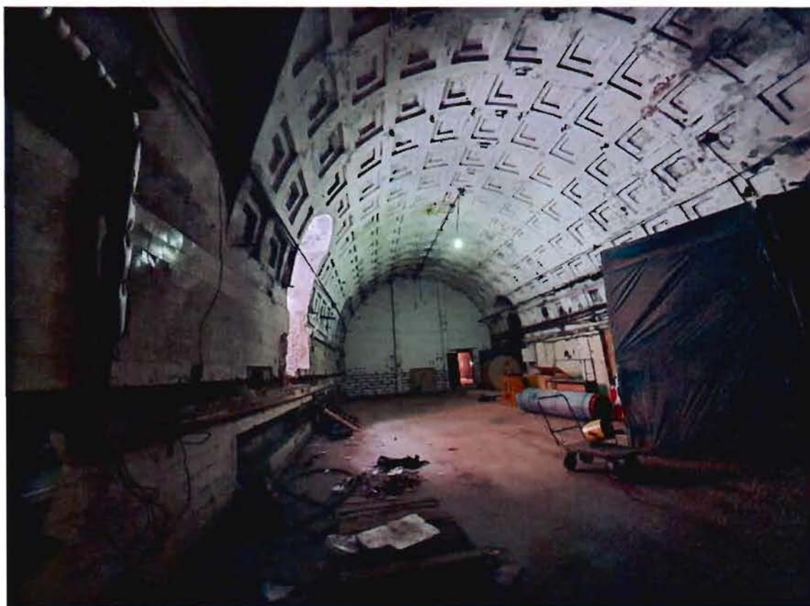
7. Интерьеры. 1 этаж. Дата фотофиксации: 19.02.2021
