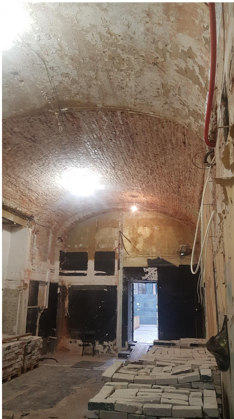
Фото 3. Арочный проем № 1. Помещение между арочными проемами.
