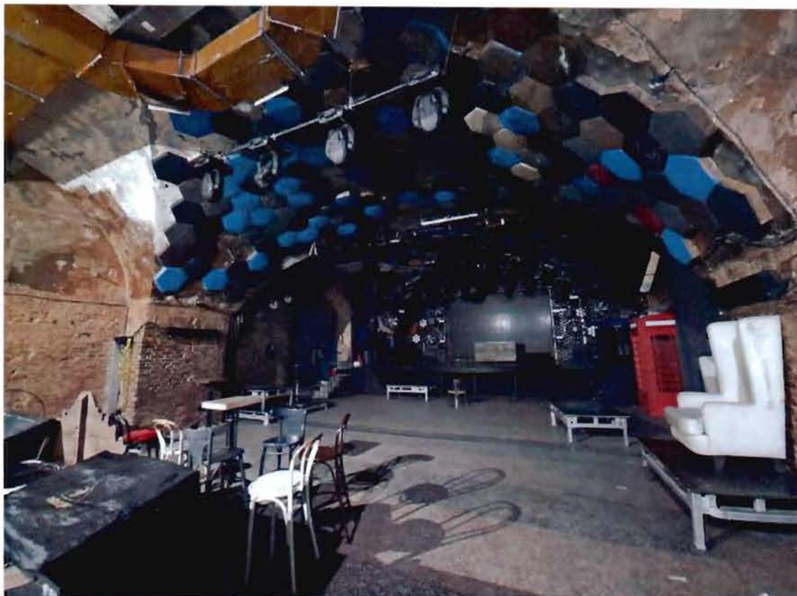
6. Интерьеры. 1 этаж. Дата фотофиксации: 19.02.2021
