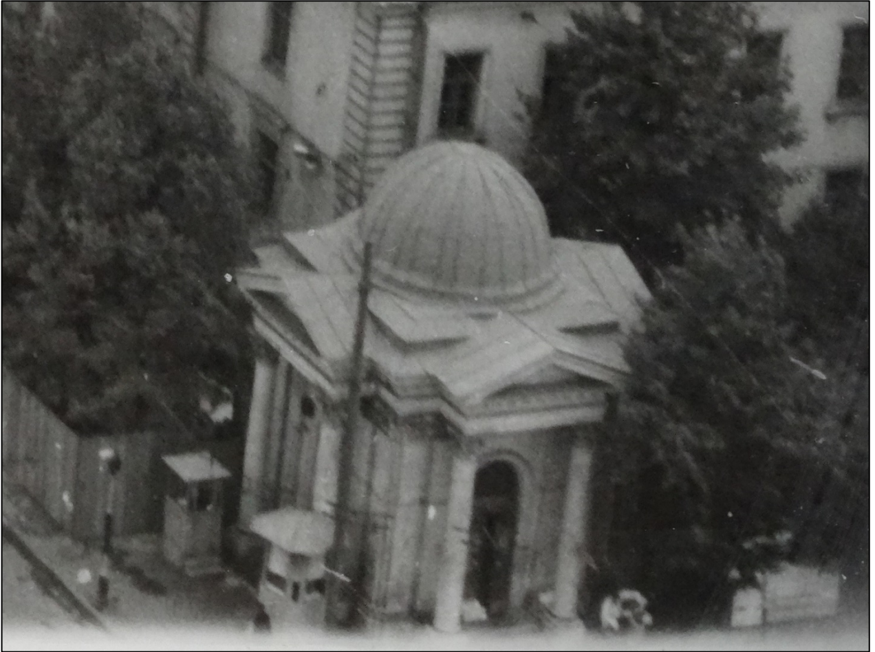
27. Вид на перспективу первой Красноармейской ул. в сторону Московского проспекта [с кровли Троицкого собора]. 1970г. / ЦГАКФФД, Ар 238491. Фрагмент фотографии.
