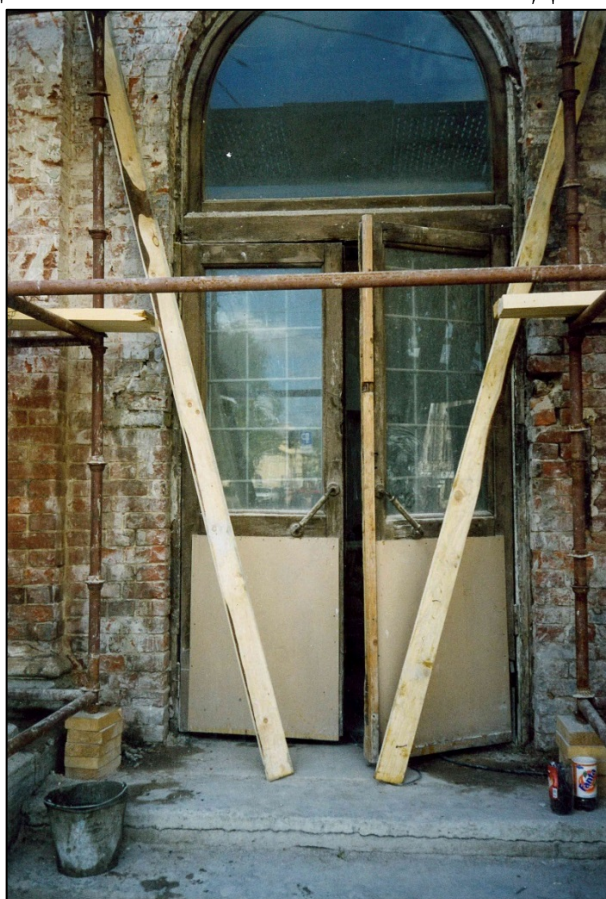
47. Часовня в ходе восстановления. Дверное заполнение. Вид снаружи. 1998 г. / Архив Троицкого собора.
