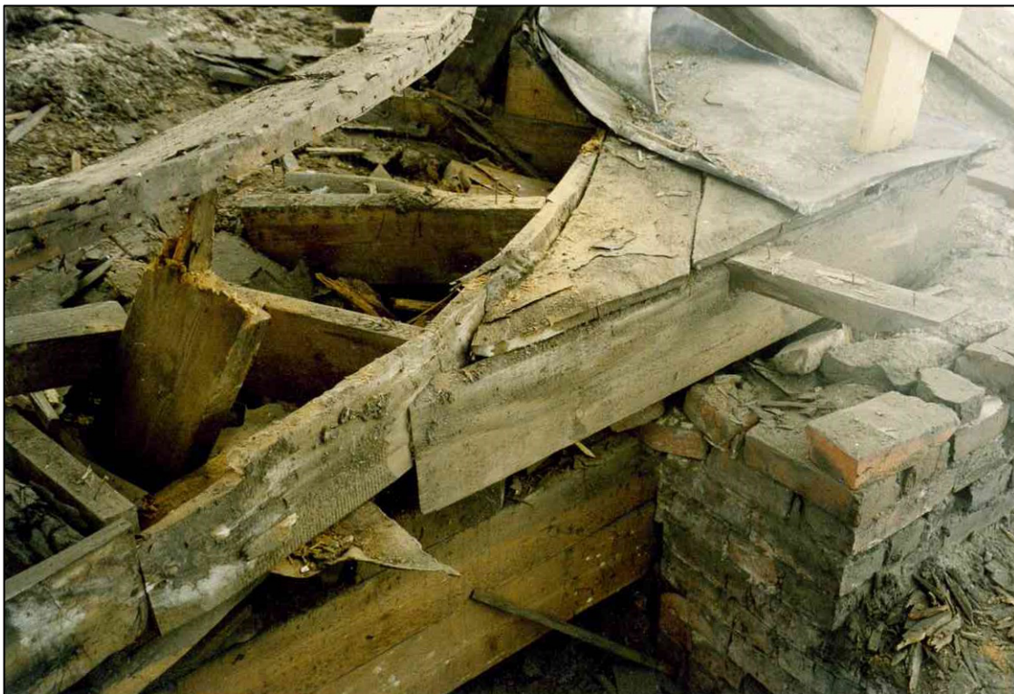
44. Часовня в ходе восстановления. Четверики в основании купола. / Заключение о техническом состоянии часовни собора Святой Животворящей Троицы Лейб-Гвардии Измайловского полка. ПК «СТРОЙДИАГНОЗ». - СПб, 1998.
