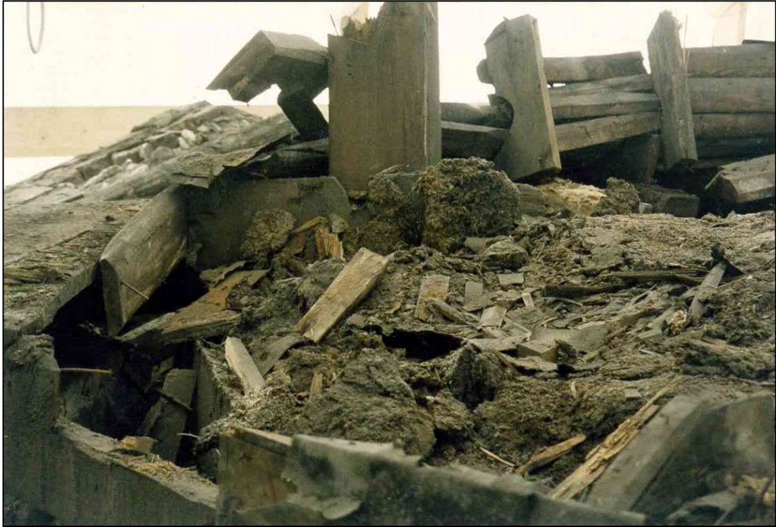
42. Часовня в ходе восстановления. Остатки каркаса профилированного пояса в основании купола. / Заключение о техническом состоянии часовни собора Святой Животворящей Троицы Лейб-Гвардии Измайловского полка. ПК «СТРОЙДИАГНОЗ». - СПб, 1998.
