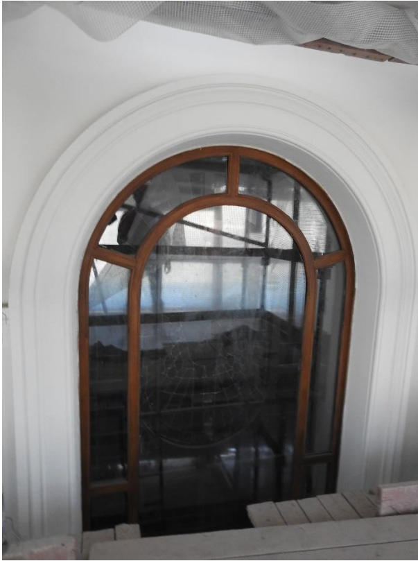
11. «Часовня, 1894 г., гражд. инж. Кондратьев С.П.», входящая в состав объекта культурного наследия федерального значения «Собор Троицкий (Измайловский)», Измайловский пр., д.4-а, лит. А, д.7-а, лит. А. Северный фасад. Фрагмент. Фото 26.04.2022г.
