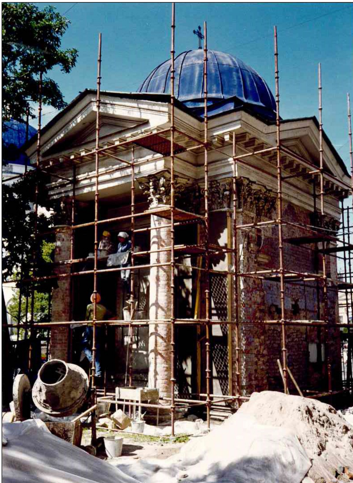
36. Часовня в ходе восстановления. Вид с юго-востока. / Заключение о техническом состоянии часовни собора Святой Животворящей Троицы Лейб-Гвардии Измайловского полка. ПК «СТРОЙДИАГНОЗ». - СПб, 1998.
