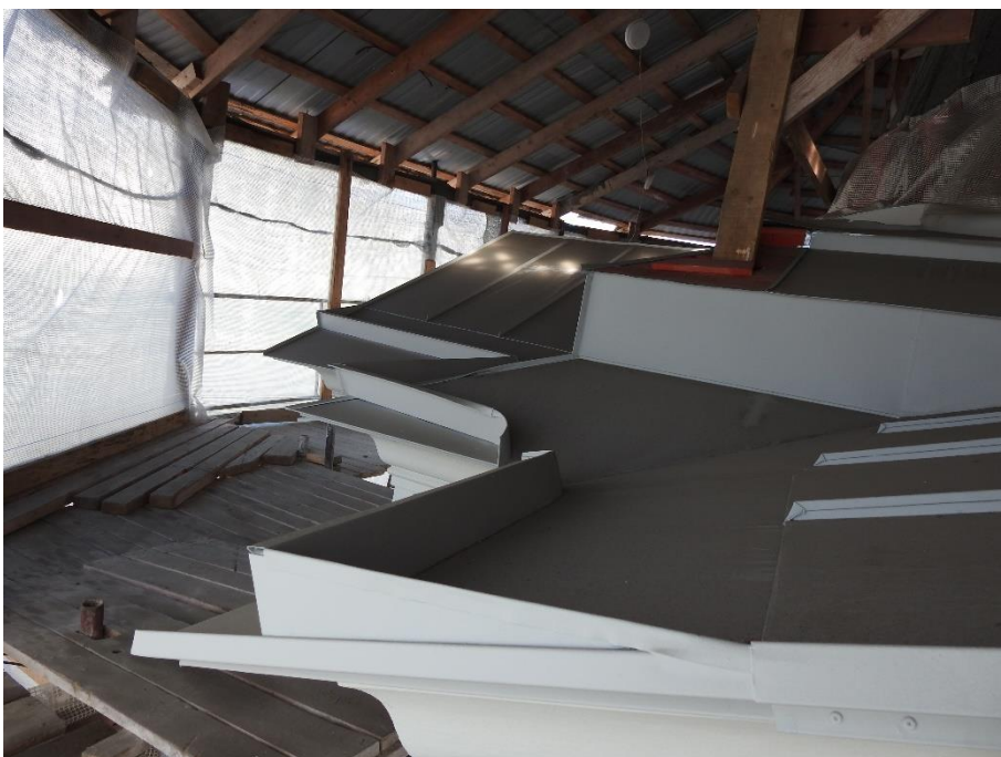
6. «Часовня,1894 г., гражд. инж. Кондратьев С.П.», входящая в состав объекта культурного наследия федерального значения «Собор Троицкий (Измайловский)», Измайловский пр., д.4-а, лит. А, д.7-а, лит. А. Кровля. Фрагмент. Фото 26.04.2022г.
