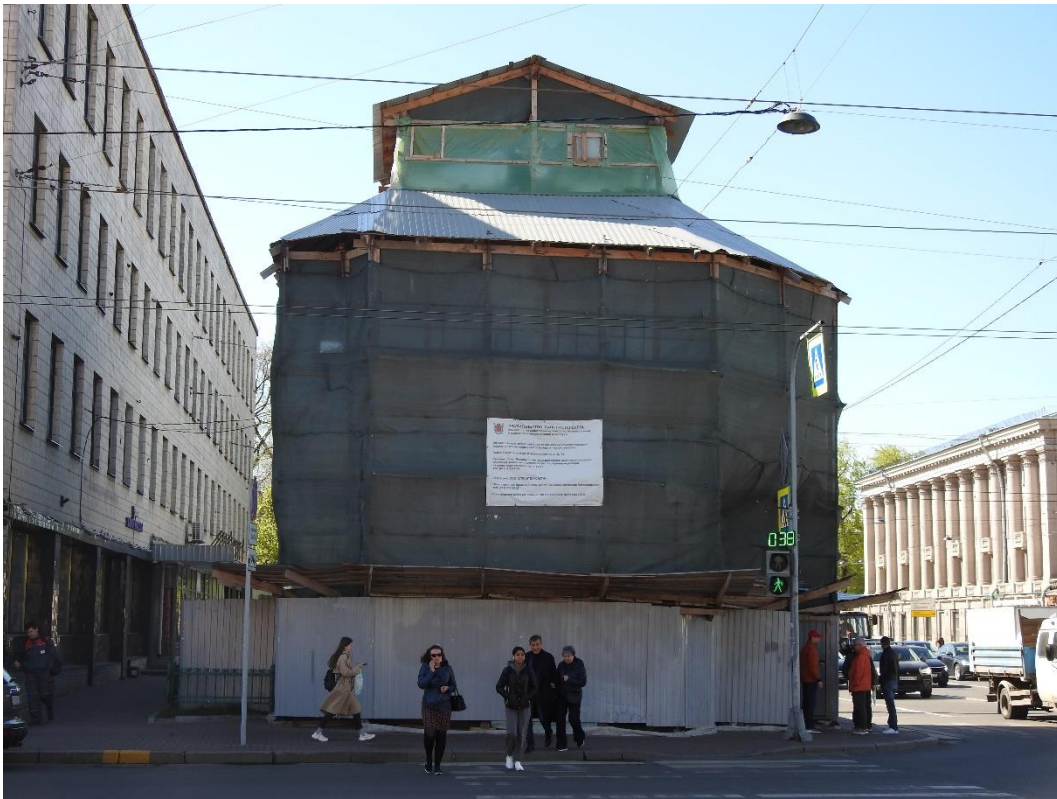
1. «Часовня,1894 г., гражд. инж. Кондратьев С.П.», входящая в состав объекта культурного наследия федерального значения «Собор Троицкий (Измайловский)», Измайловский пр., д.4-а, лит. А, д.7-а, лит. А. Северный фасад. Общий вид. Фото 26.04.2022г.
