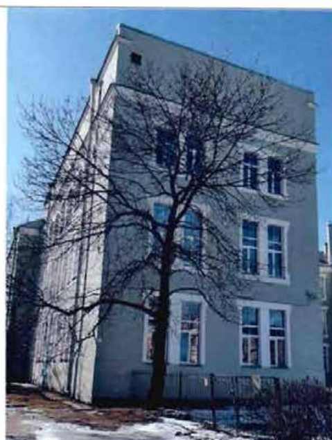
5. Фрагмент северо-восточного фасада
