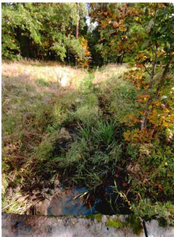
2. Русло надземной части объекта культурного наследия, вид с запада.
