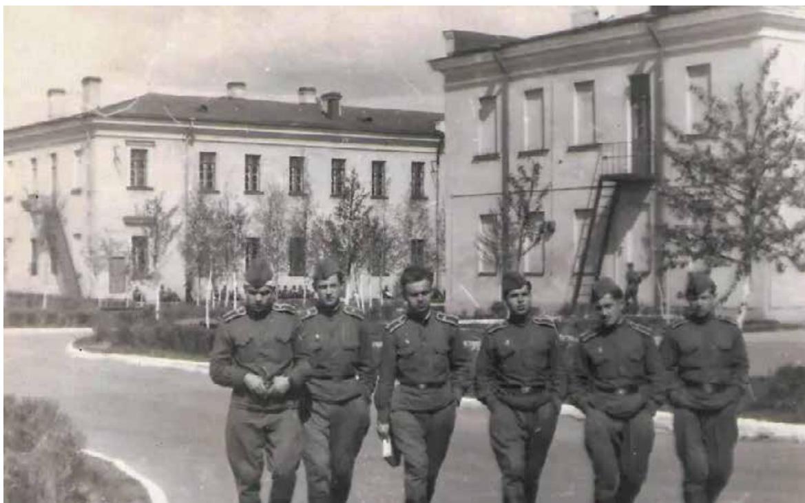
Илл. 13. ЛенВОКУ имени С.М.Кирова. Объект культурного наследия регионального значения «Казармы лейб-гвардии Уланского полка (с воротами, каменной оградой и территорией)». Фото в территории 1965 г. Retro View of Mankind's Habitat [Электронный ресурс]. Режим доступа: https://pastvu.com/ .
