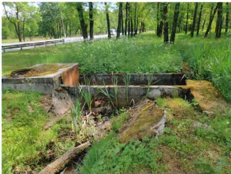
4. Мост-плотина, расположенный в северной части парка, у Санкт-Петербургского пр.
