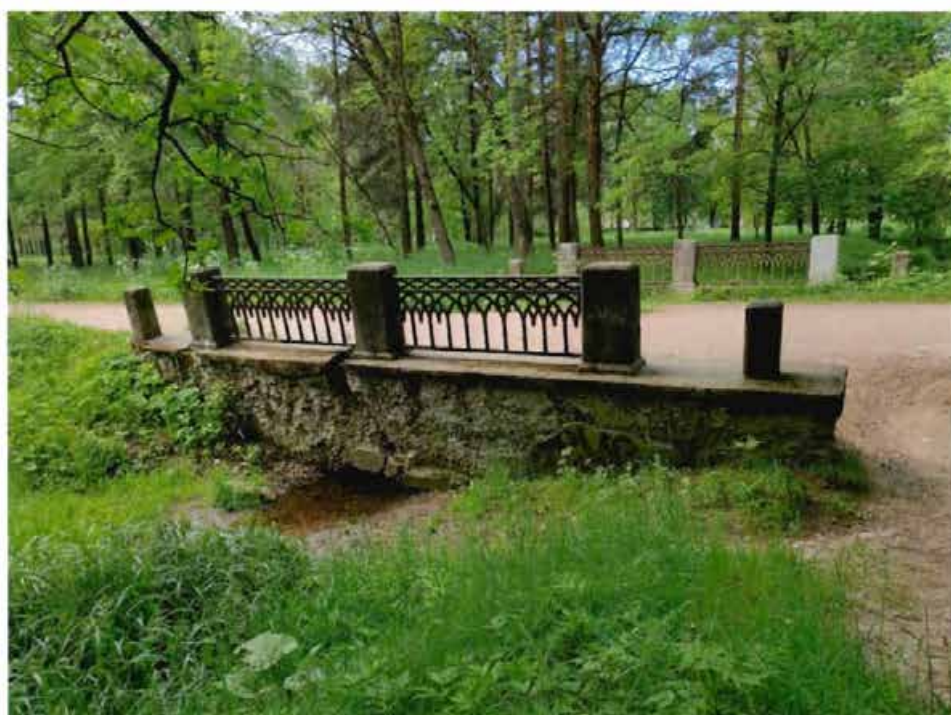
1. Мост-плотина, расположенный в юго-западной части парка, между прудом и объектом культурного наследия федерального значения «Водовод». Вид с северо-востока.
