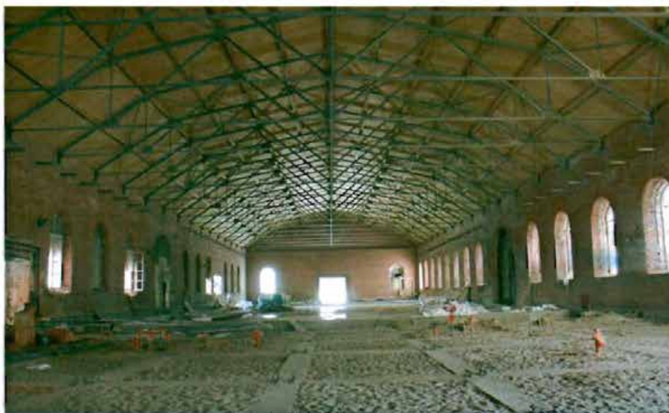
Фото №3. Помещение 1-го этажа.
