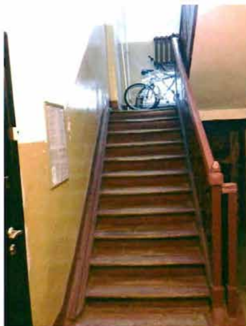
5. Лестничная клетка. Первый этаж
