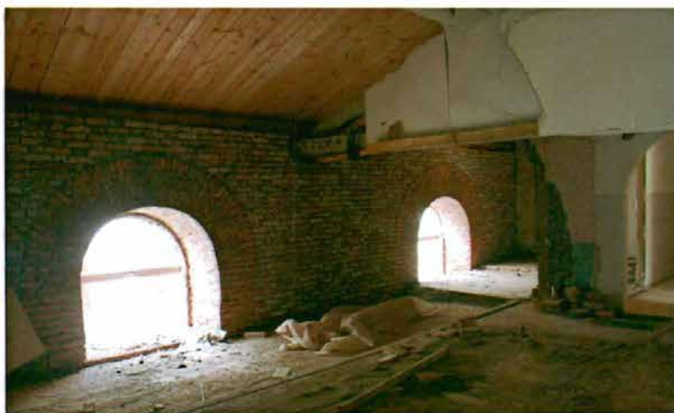
Фото №4. Помещение 2-го этажа.
