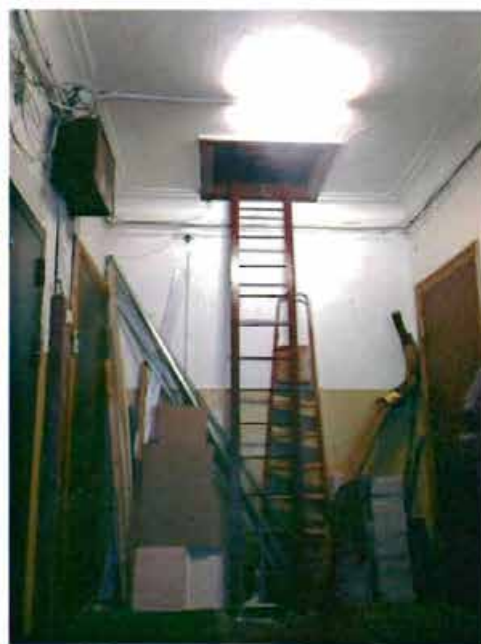
6. Лестничная клетка. Второй этаж
