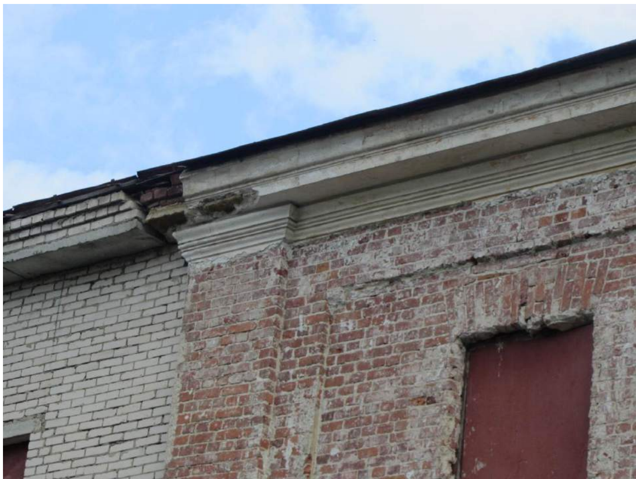
8. Казарма Офицерской стрелковой школы по адресу: г. Ломоносов, Владимирская ул., 10. Фрагмент западного лицевого фасада. Карнизная часть. Фото: 01.06.2022
