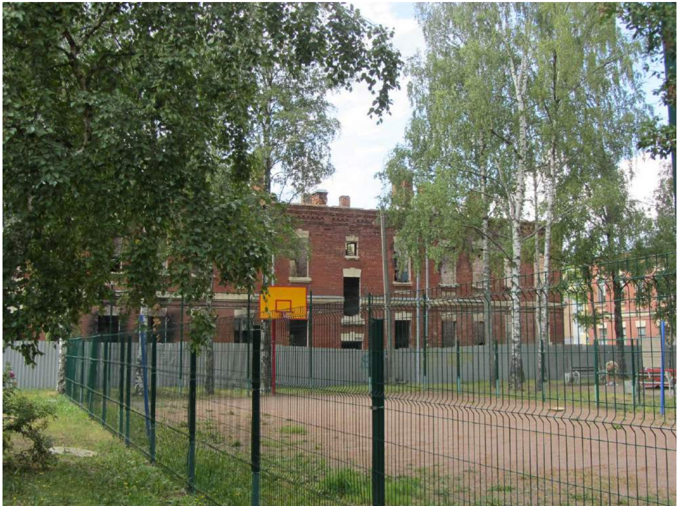
2. Казарма Офицерской стрелковой школы по адресу: г. Ломоносов, Владимирская ул., 16. Общий вид дворового восточного фасада. Вид с востока.
