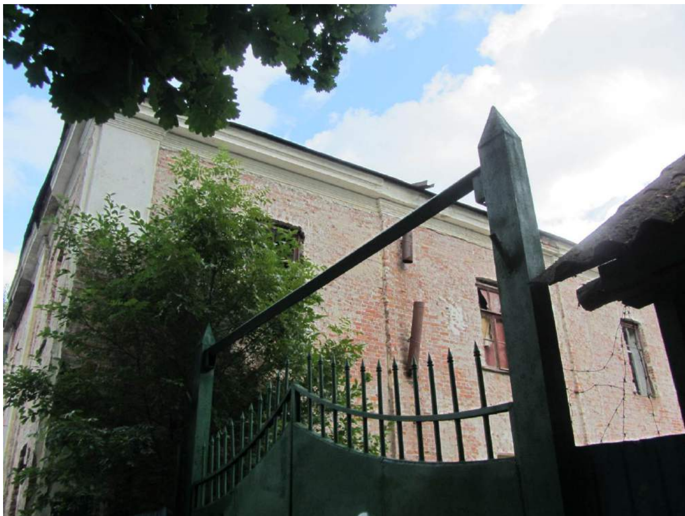
5. Казарма Офицерской стрелковой школы по адресу: г. Ломоносов, Владимирская ул., 10. Видимая с Владимирской улицы часть южного фасада здания. Фото: 01.06.2022
