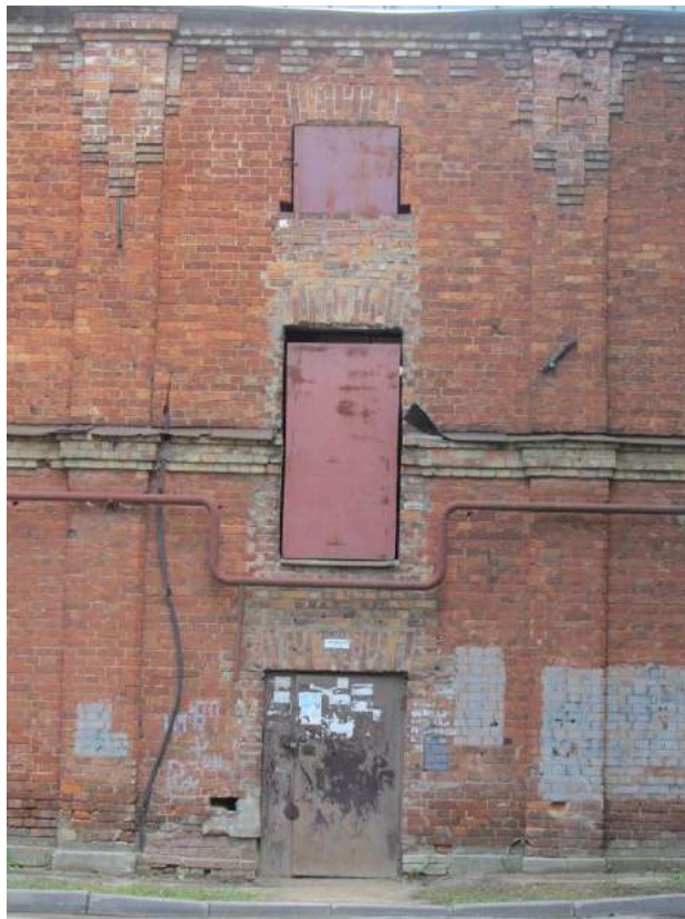
7. Казарма Офицерской стрелковой школы по адресу: г. Ломоносов, Владимирская ул., 15 Фрагменты дворового фасада здания. Фото: 01.06.2022.
