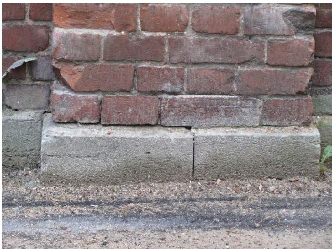
11. Казарма Офицерской стрелковой школы по адресу: г. Ломоносов, Владимирская ул., 15 Фрагменты торцевого фасада здания. Фото: 01.06.2022.
