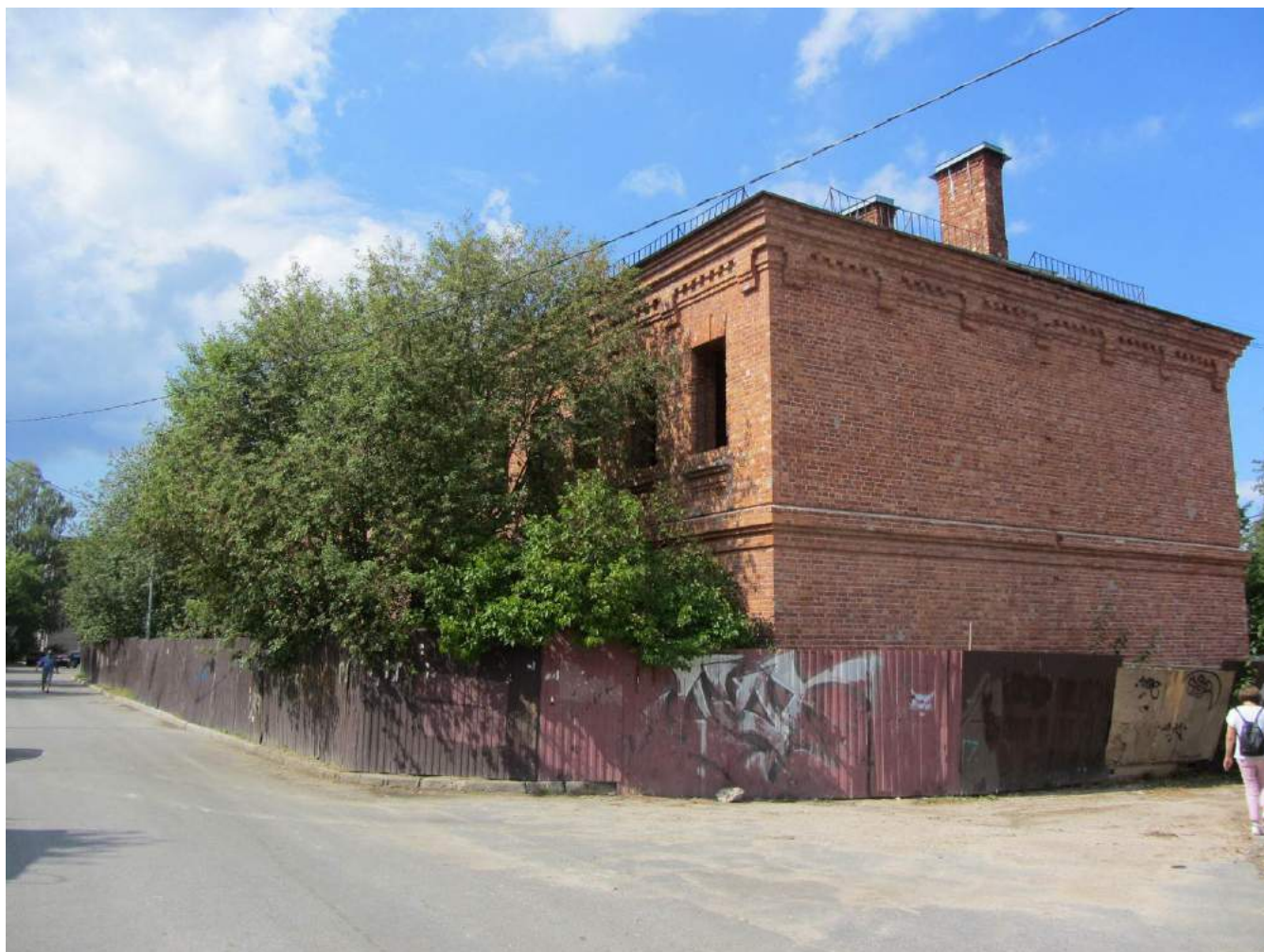
3. Казарма Офицерской стрелковой школы по адресу: г. Ломоносов, Владимирская ул., 16а. Торцевой восточный фасад. Вид с юго-востока. Фото: 01.06.2022.
