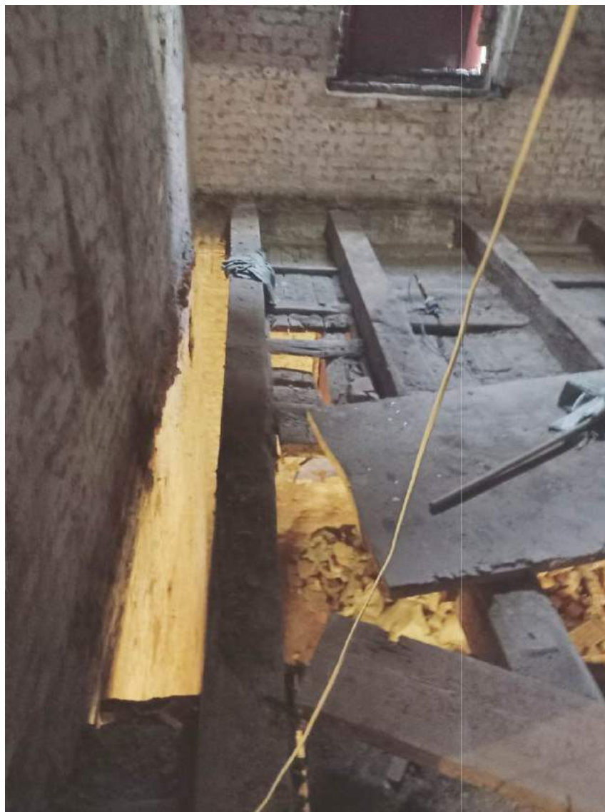
24. Казарма Офицерской стрелковой школы по адресу: г. Ломоносов, Владимирская ул., 15 Фрагмент интерьера 2-го этажа.
