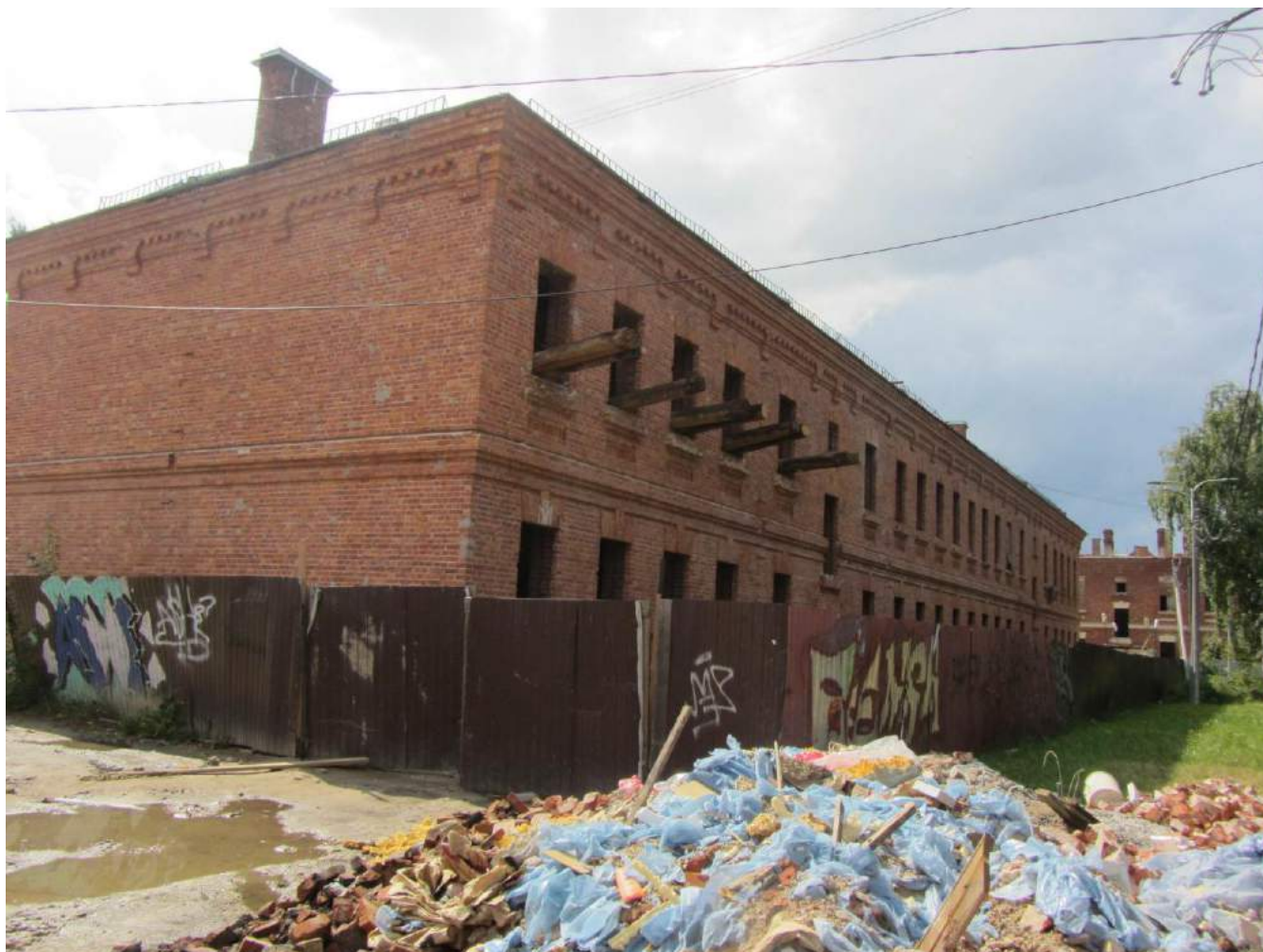
4. Казарма Офицерской стрелковой школы по адресу: г. Ломоносов, Владимирская ул., 16а. Общий вид северного фасада. Вид с северо-востока. Фото: 01.06.2022.
