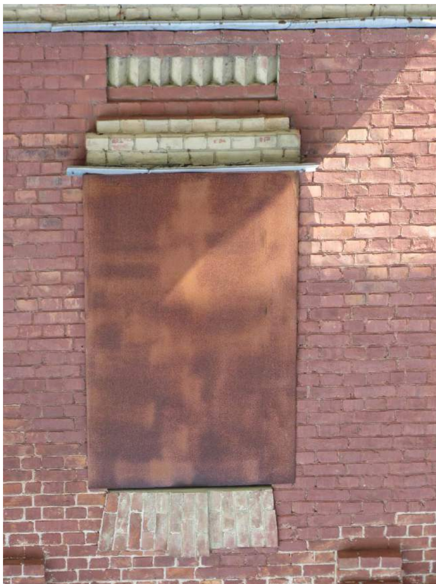
7. Казарма Офицерской стрелковой школы по адресу: г. Ломоносов, Владимирская ул., 12. Деталь лицевого фасада. Оконный проем второго этажа. Фото: 01.06.2022.
