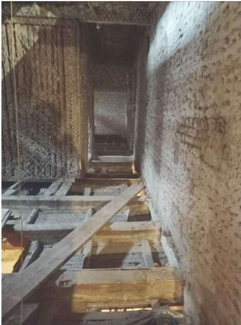
23. Казарма Офицерской стрелковой школы по адресу: г. Ломоносов, Владимирская ул., 15 Фрагмент интерьера 2-го этажа. Фото: 01.06.2022.
