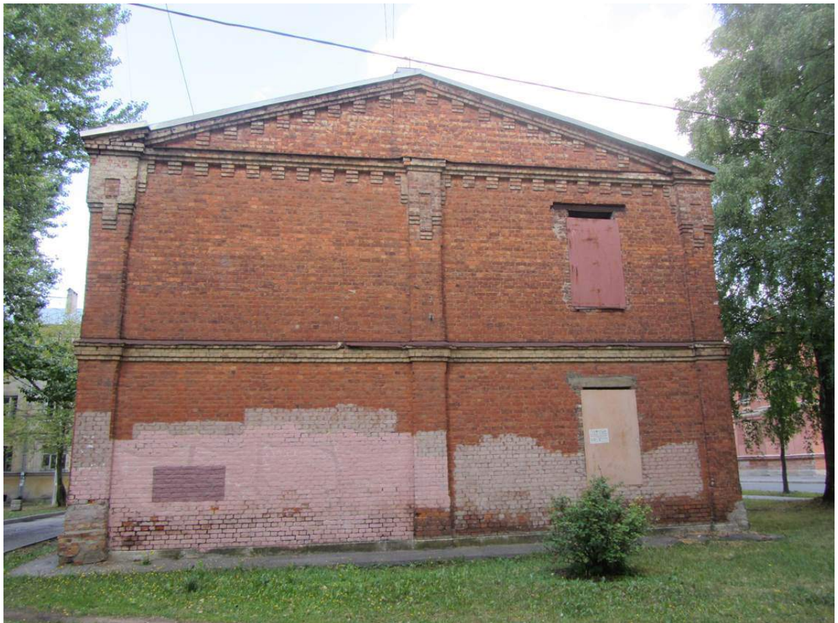
9. Казарма Офицерской стрелковой школы по адресу: г. Ломоносов, Владимирская ул., 15 Общий вид южного торцевого фасада здания. Фото: 01.06.2022.
