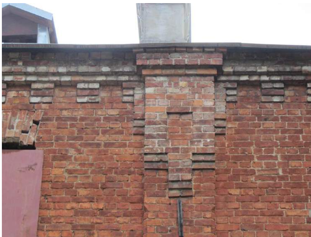
8. Казарма Офицерской стрелковой школы по адресу: г. Ломоносов, Владимирская ул., 15 Фрагменты дворового фасада здания. Фото: 01.06.2022.
