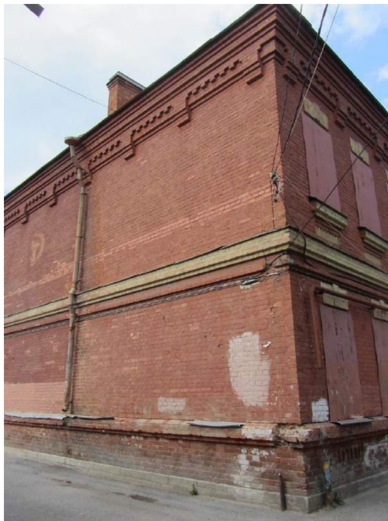
3. Казарма Офицерской стрелковой школы по адресу: г. Ломоносов, Владимирская ул., 12. Торцевой южный фасад. Вид с юго-востока. Фото: 01.06.2022.
