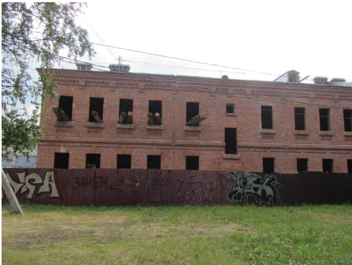
5. Казарма Офицерской стрелковой школы по адресу: г. Ломоносов, Владимирская ул., 16а. Восточная часть северного фасада. Фото: 01.06.2022.
