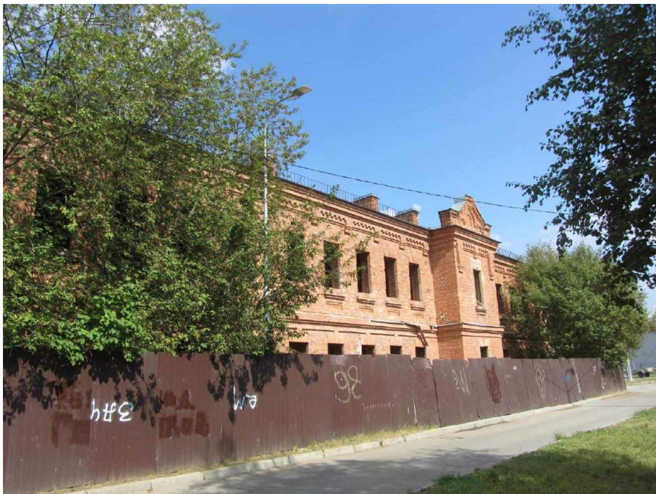
1. Казарма Офицерской стрелковой школы по адресу: г. Ломоносов, Владимирская ул., 16а. Общий вид южного фасада. Фото: 01.06.2022.
