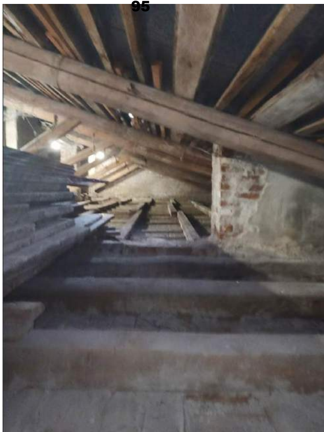
27. Казарма Офицерской стрелковой школы по адресу: г. Ломоносов, Владимирская ул., 15 Фрагменты интерьера чердака. Фото: 01.06.2022.
