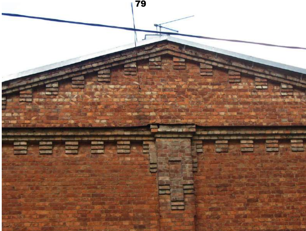
10. Казарма Офицерской стрелковой школы по адресу: г. Ломоносов, Владимирская ул., 15 Фрагменты торцевого фасада здания. Фото: 01.06.2022.
