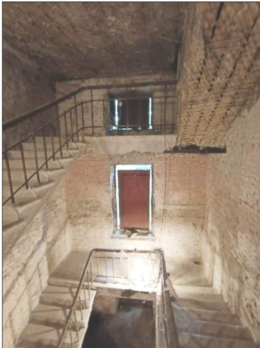
20. Казарма Офицерской стрелковой школы по адресу: г. Ломоносов, Владимирская ул., 15 Фрагмент интерьера. Общий вид лестницы. Фото: 01.06.2022.
