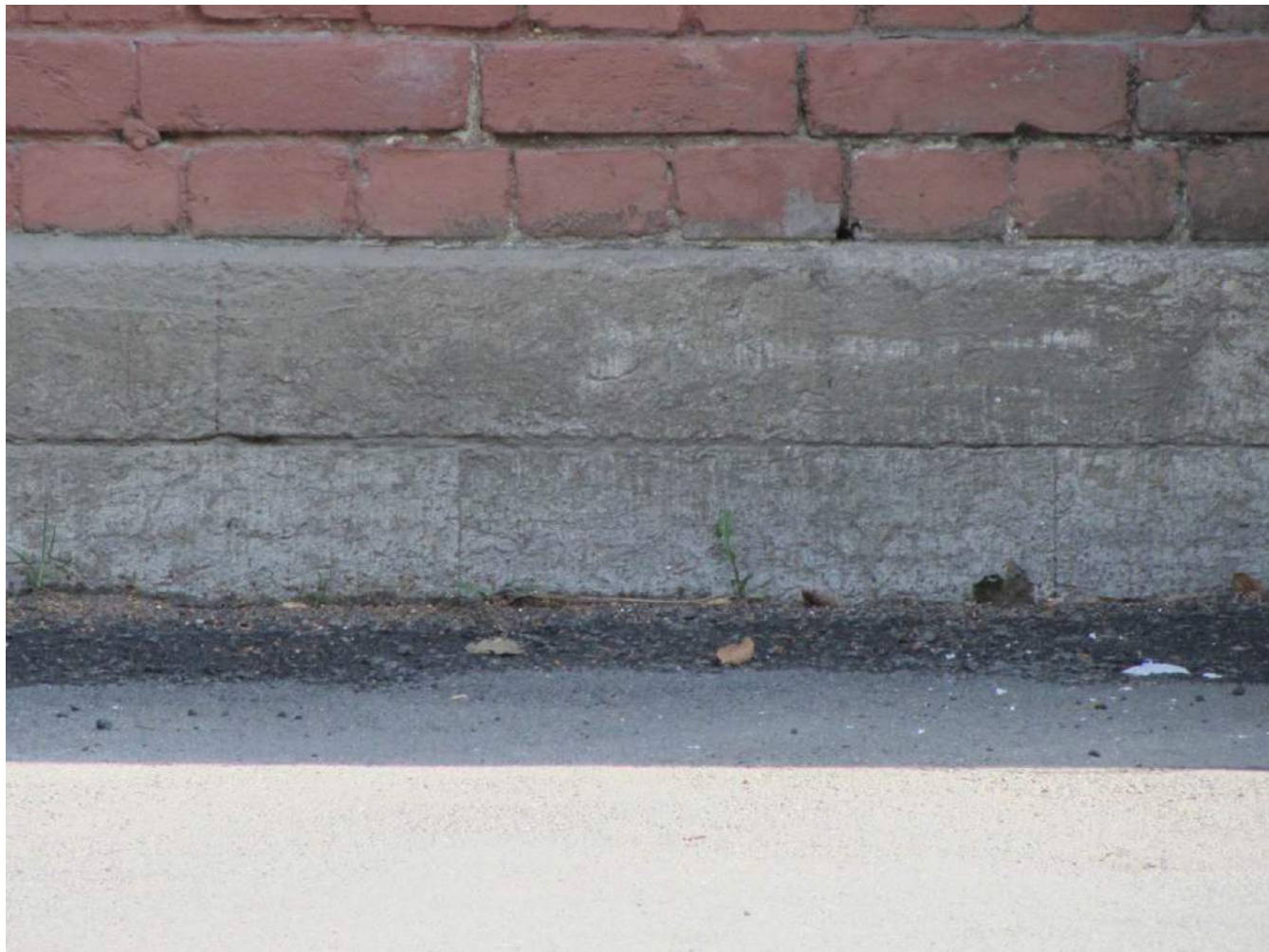
9. Казарма Офицерской стрелковой школы по адресу: г. Ломоносов, Владимирская ул., 12. Деталь цоколя. Фото: 01.06.2022.
