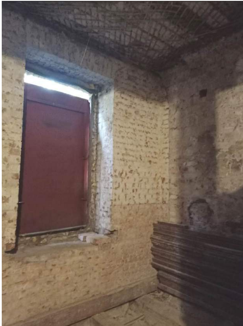
25. Казарма Офицерской стрелковой школы по адресу: г. Ломоносов, Владимирская ул., 15 Фрагмент интерьера 2-го этажа. Фото: 01.06.2022.
