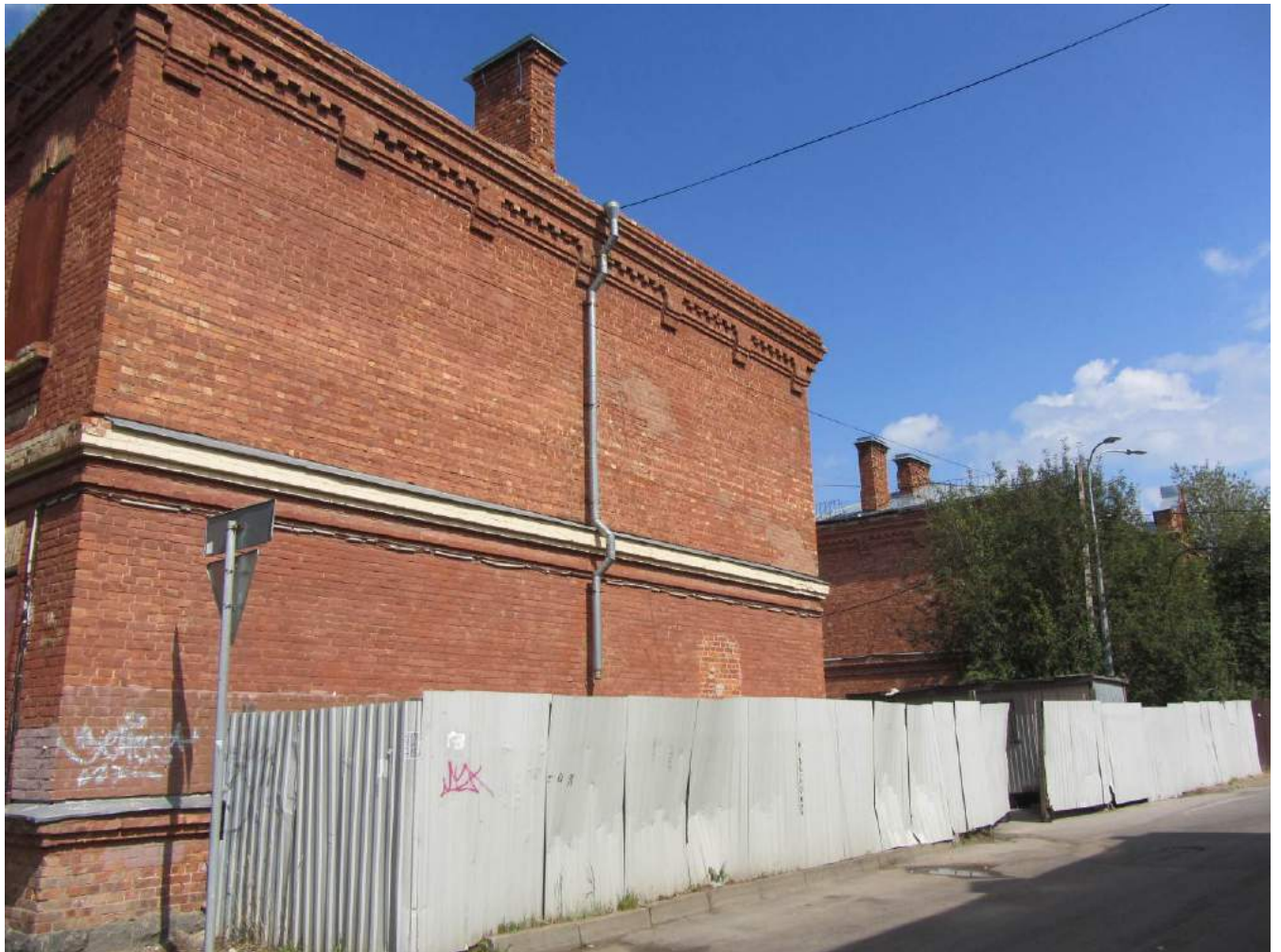
3. Казарма Офицерской стрелковой школы по адресу: г. Ломоносов, Владимирская ул., 16. Общий вид торцевого южного фасада. Фото: 01.06.2022.
