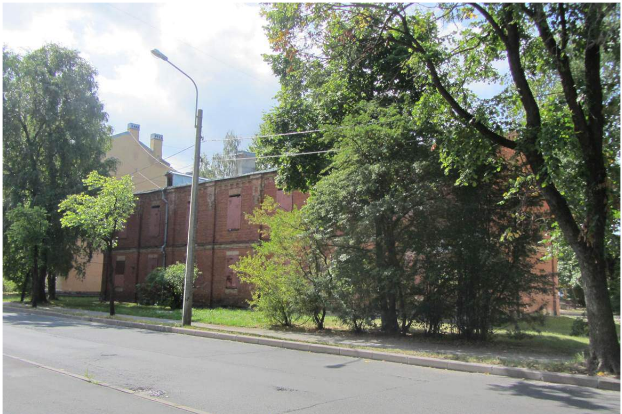
2. Казарма Офицерской стрелковой школы по адресу: г. Ломоносов, Владимирская ул., 15 Общий вид лицевого фасада здания. Вид с северо-востока.
