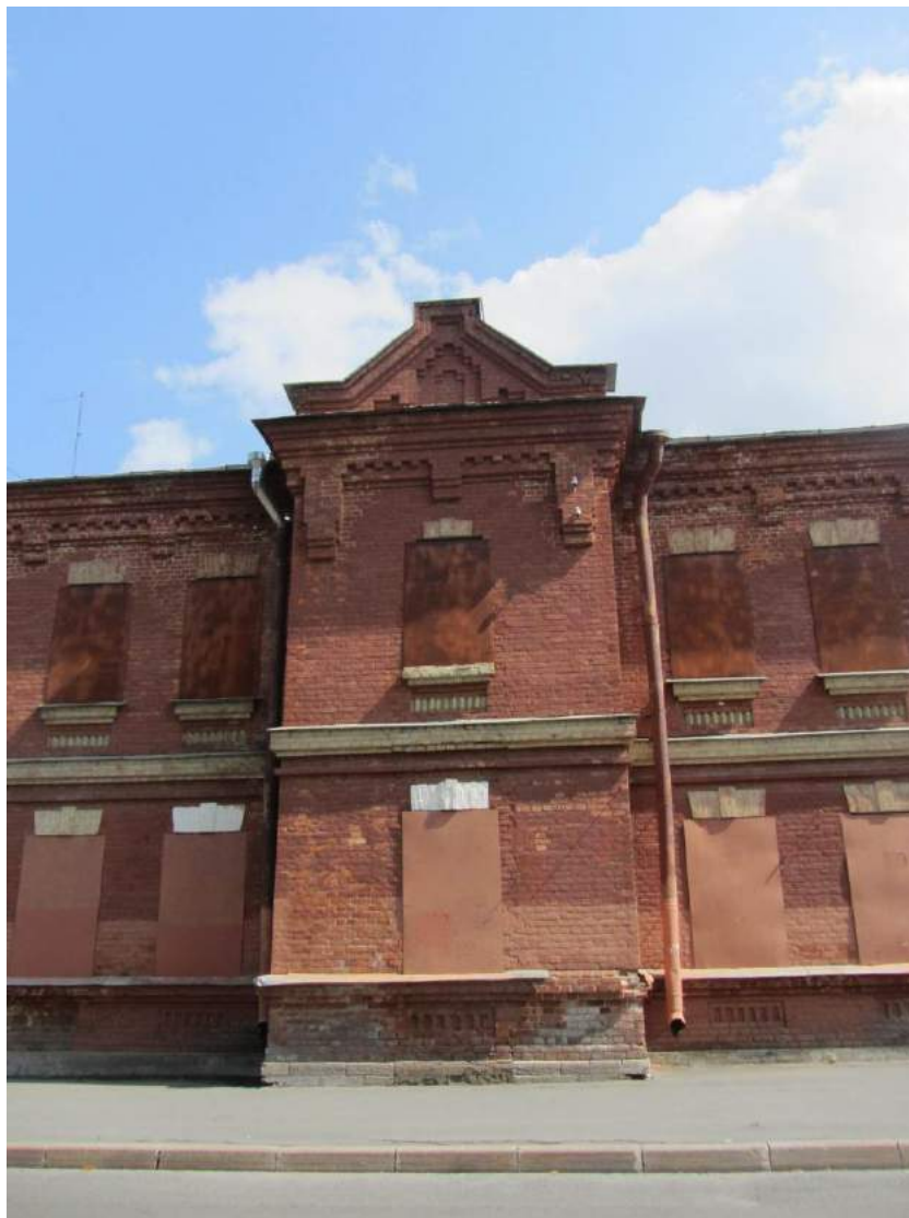
4. Казарма Офицерской стрелковой школы по адресу: г. Ломоносов, Владимирская ул., 12. Фрагмент лицевого фасада. Южный ризалит.
