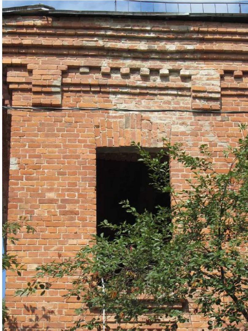
8. Казарма Офицерской стрелковой школы по адресу: г. Ломоносов, Владимирская ул., 16а. Деталь южного фасада. Венчающий карниз. Фото: 01.06.2022.
