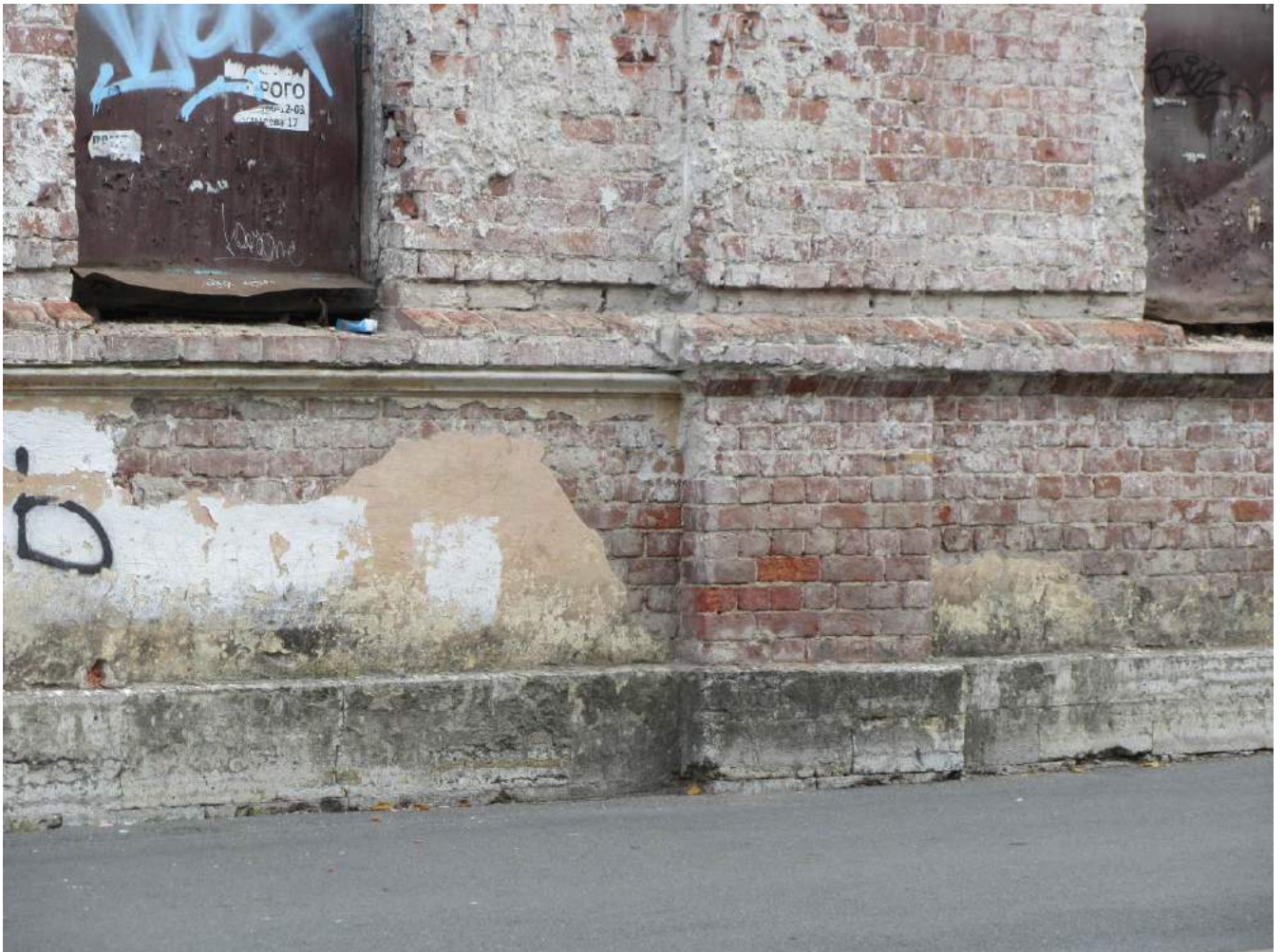
6. Казарма Офицерской стрелковой школы по адресу: г. Ломоносов, Владимирская ул., 10. Фрагмент западного лицевого фасада. Цокольная часть. Фото: 01.06.2022
