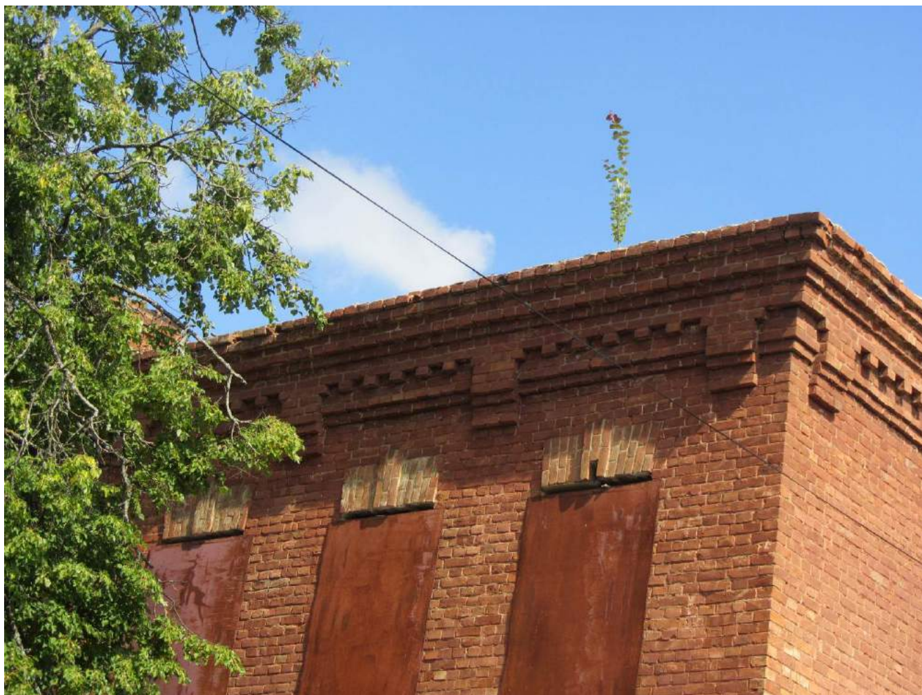
4. Казарма Офицерской стрелковой школы по адресу: г. Ломоносов, Владимирская ул., 16. Фрагмент лицевого фасада по Владимирской улице: венчающий карниз, оконные проемы 2-го этажа. Фото: 01.06.2022.
