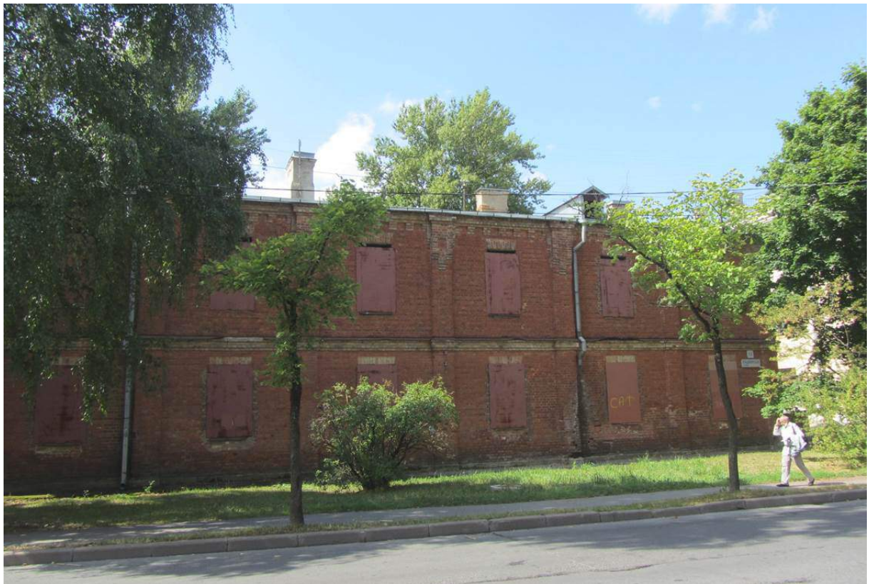
3. Казарма Офицерской стрелковой школы по адресу: г. Ломоносов, Владимирская ул., 15 Общий вид лицевого фасада здания. Вид с востока. Фото: 01.06.2022.
