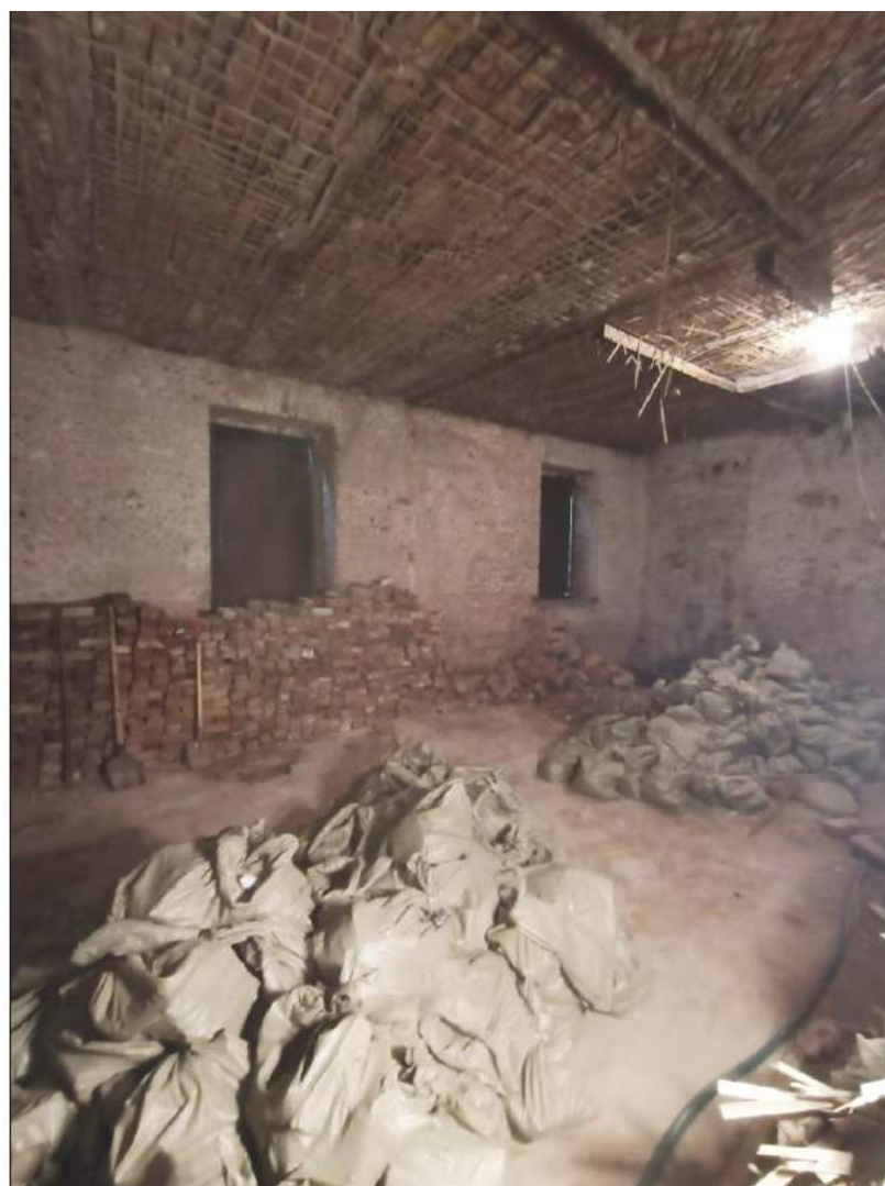
14. Казарма Офицерской стрелковой школы по адресу: г. Ломоносов, Владимирская ул., 15 Фрагмент интерьера 1-го этажа. Существующая кладка. Фото: 01.06.2022.
