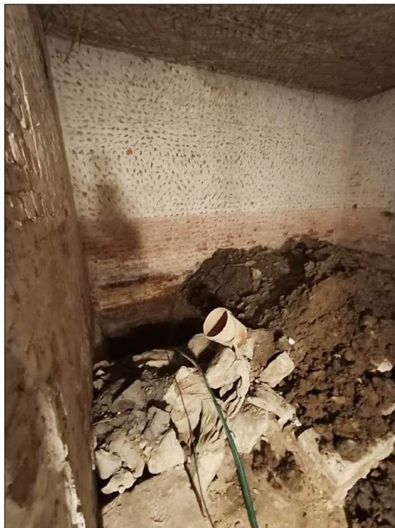
13. Казарма Офицерской стрелковой школы по адресу: г. Ломоносов, Владимирская ул., 15 Фрагмент интерьера 1-го этажа. Место устройства шурфа. Фото: 01.06.2022.
