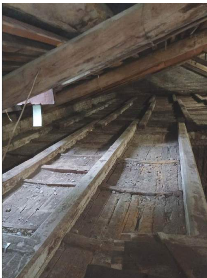
28. Казарма Офицерской стрелковой школы по адресу: г. Ломоносов, Владимирская ул., 15 Фрагменты интерьера чердака. Фото: 01.06.2022.
