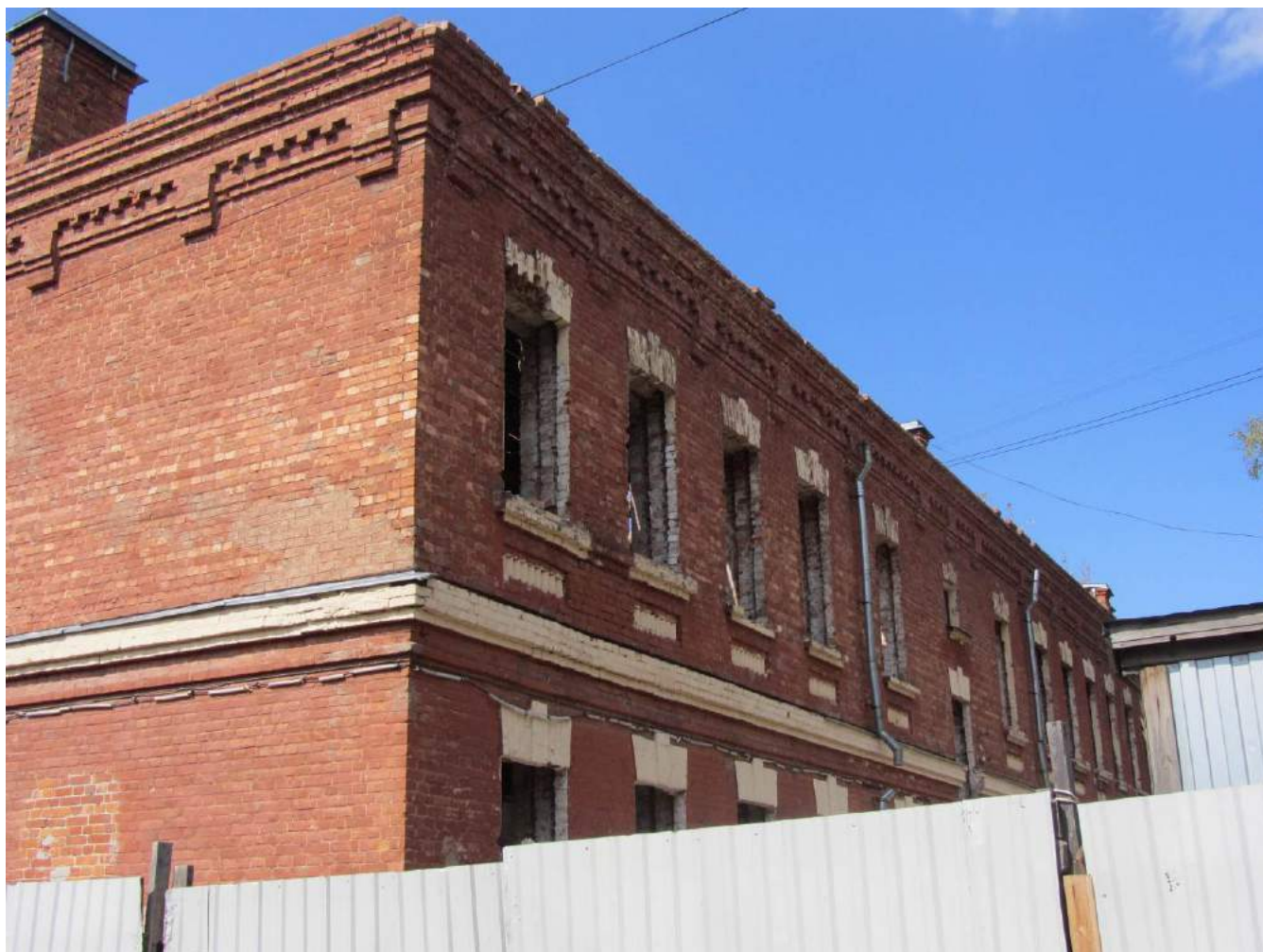
5. Казарма Офицерской стрелковой школы по адресу: г. Ломоносов, Владимирская ул., 16. Фрагмент торцевого и дворового фасадов казармы: венчающий карниз, оконные проемы 2-го этажа. Фото: 01.06.2022.
