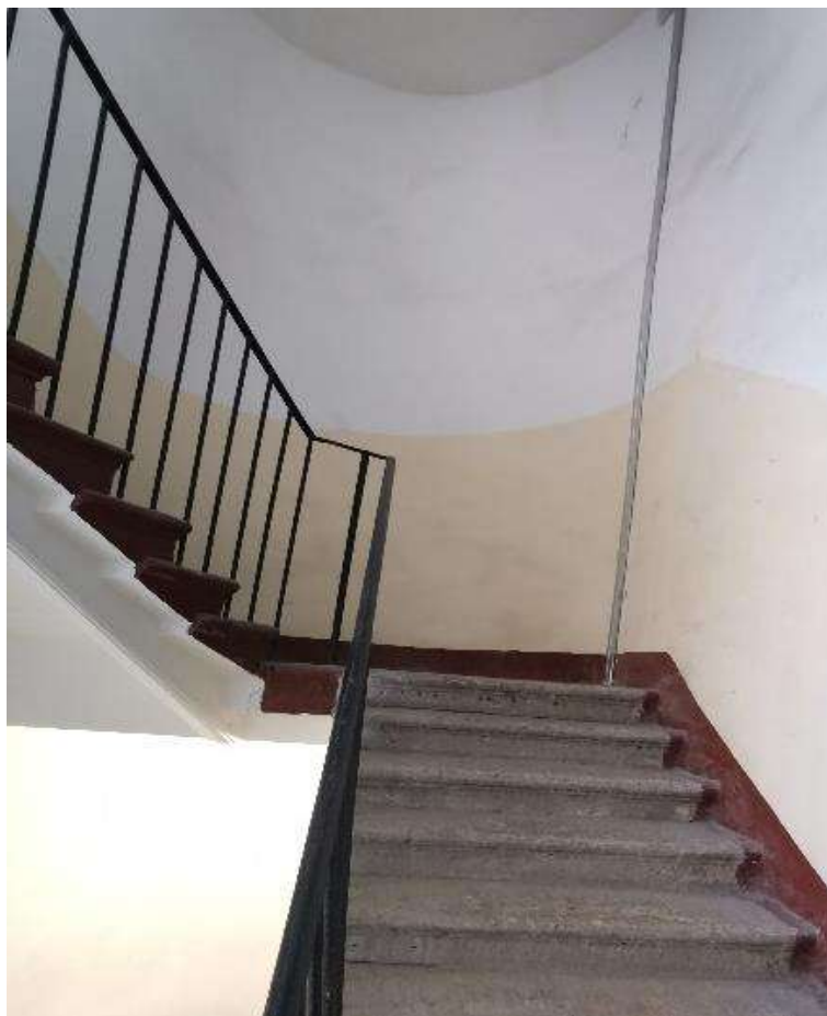
Фото №93. Парадная лестница №9. Лестничный марш, вид с площадки третьего этажа.
