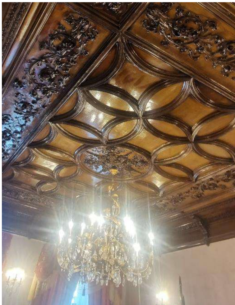
Фото №53. Помещение 1-Н. Комната 37.8 кв.м. Оформление потолка
