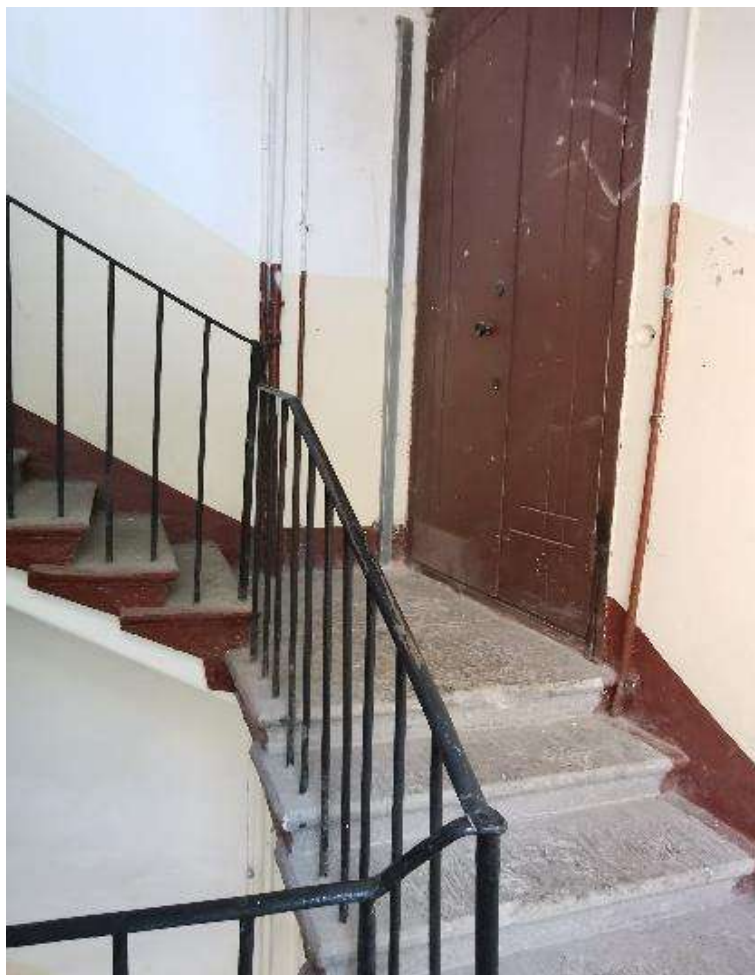
Фото №95. Парадная лестница №9. Площадка четвертого этажа.
