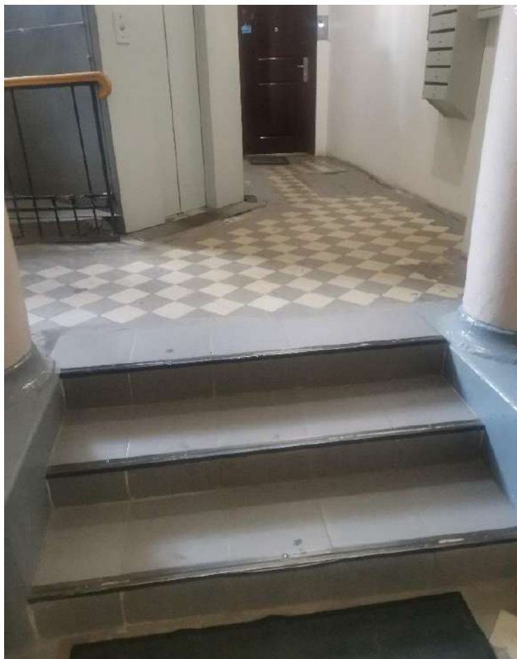
Фото №35. Парадная лестница №1. Лестница на первом этаже.
