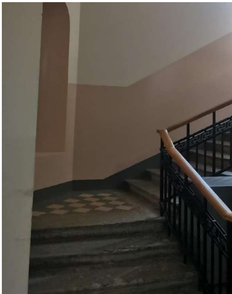
Фото №37. Парадная лестница №1. Лестничный марш, вид с первого этажа.
