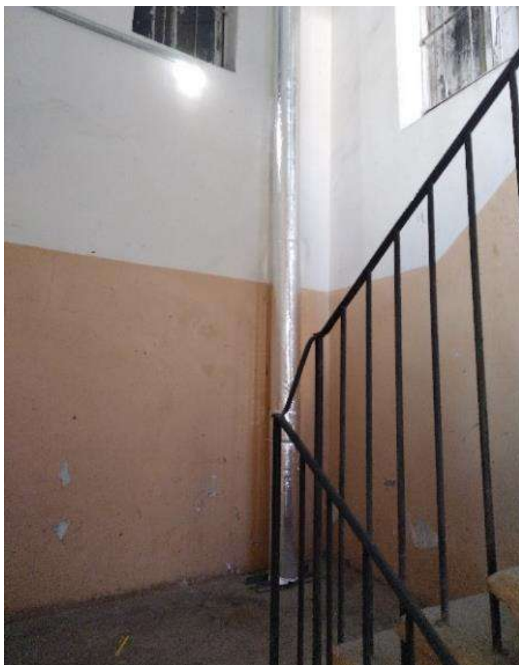
Фото №70. Парадная лестница №8. Междуетажная площадка между 2 и 3 этажами.
