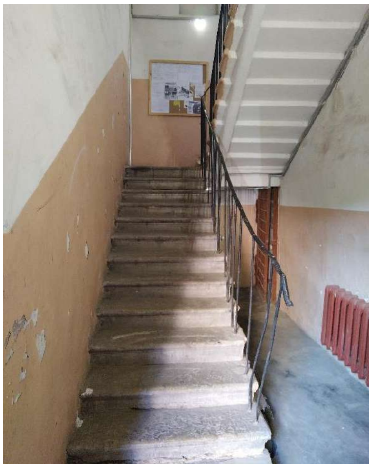
Фото №64. Парадная лестница №8. Вестибюль первого этажа, вид от входа.
