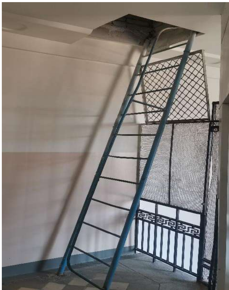
Фото №61. Парадная лестница №1. Лестница на чердак на площадке шестого этажа.
