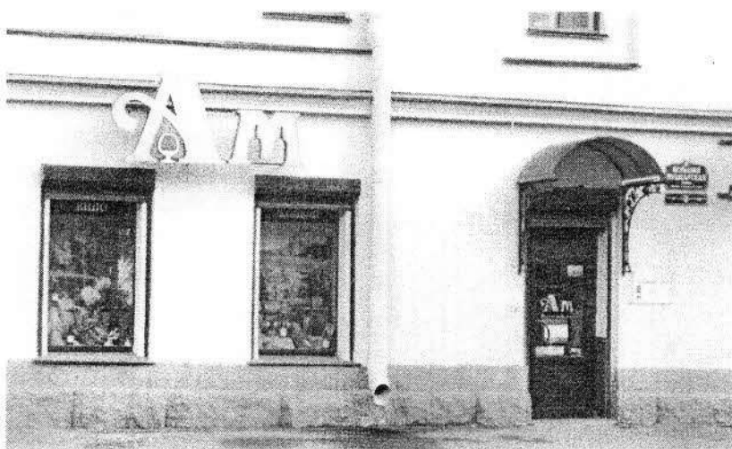
Лицевой северо-западный фасад. Фрагмент. Оконные проемы пом. 14-Н. Съёмка 15.01.2012, В.А. Матвеева.
