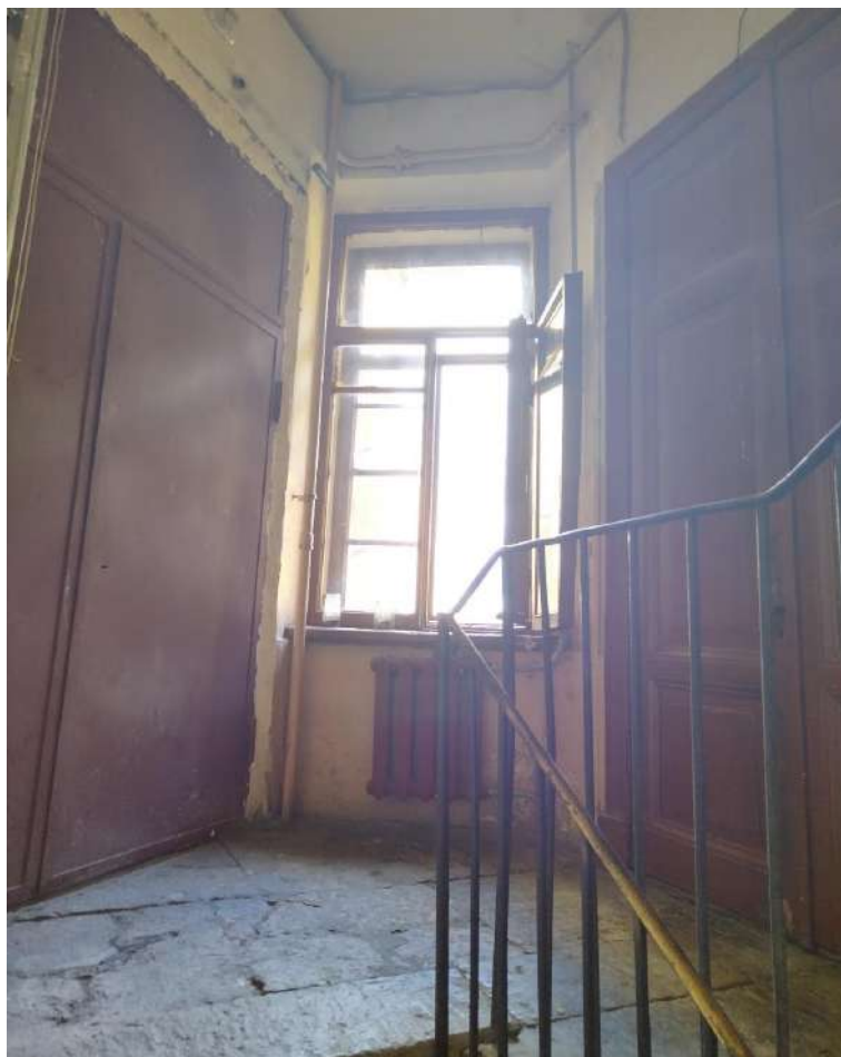
Фото №75. Парадная лестница №8. Площадка четвертого этажа.
