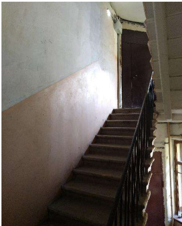
Фото №77. Парадная лестница №8. Вид на пятый этаж с междуэтажной площадки между 4 и 5 этажами.
