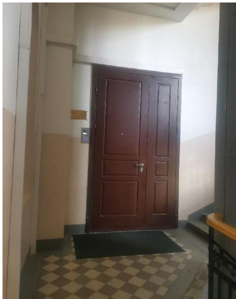
Фото №44. Парадная лестница №1. Площадка третьего этажа.
