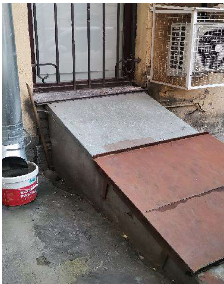
Фото №102. Вход в подвал со двора.
