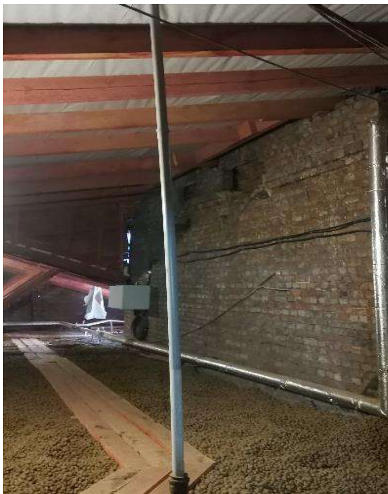
Фото №82. Парадная лестница №8. Чердак.
