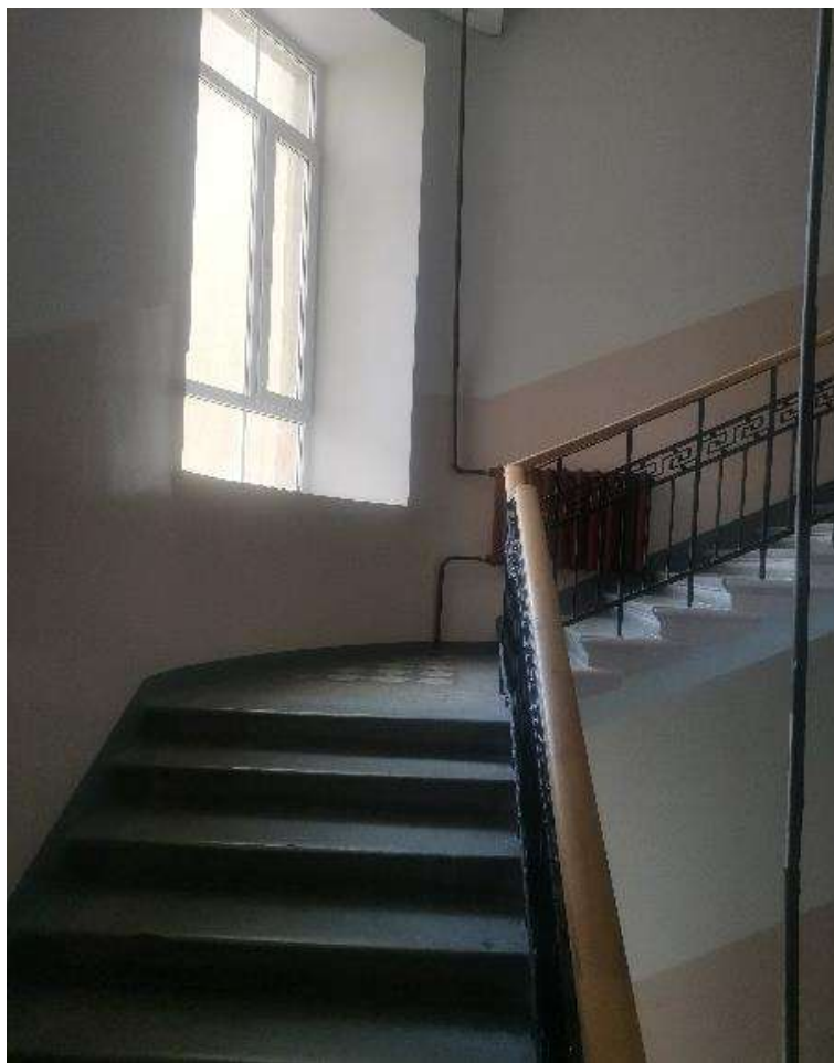
Фото №55. Парадная лестница №1. Лестничный марш, вид в сторону четвертого этажа.
