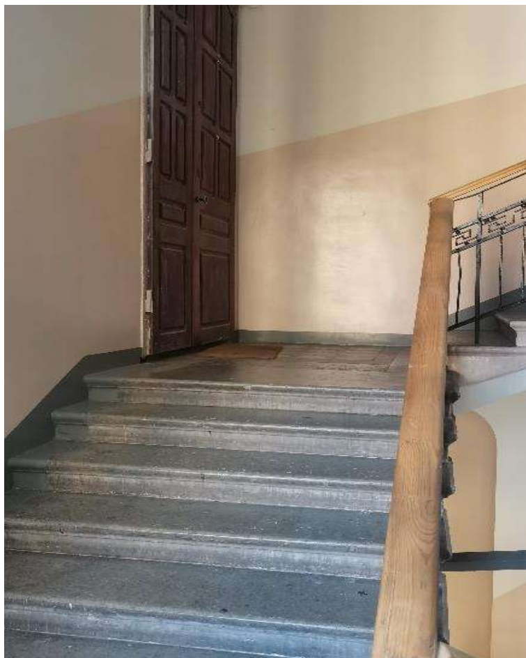
Фото №57. Парадная лестница №1. Лестничный марш, площадка четвертого этажа.
