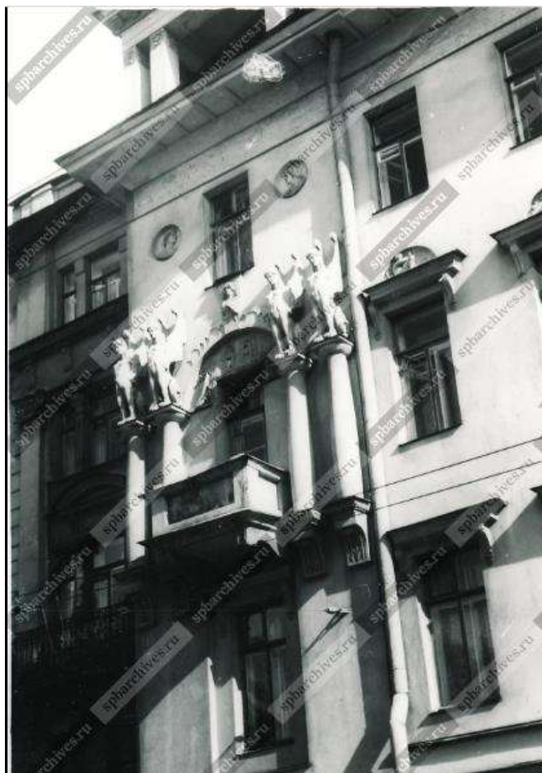
Илл.18. Вид части центрального фасада жилого дома №3 по Большой Пушкарской улице. 23 августа 1977г. (ЦГАКФФД СПб Фотодокумент Ар 242058)
