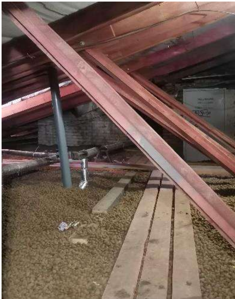
Фото №81. Парадная лестница №8. Чердак.
