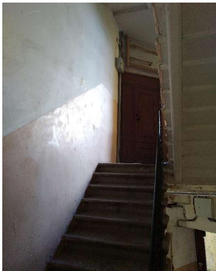
Фото №68. Парадная лестница №8. Лестничный марш, вид с междуэтажной площадки между 1 и 2 этажами.
