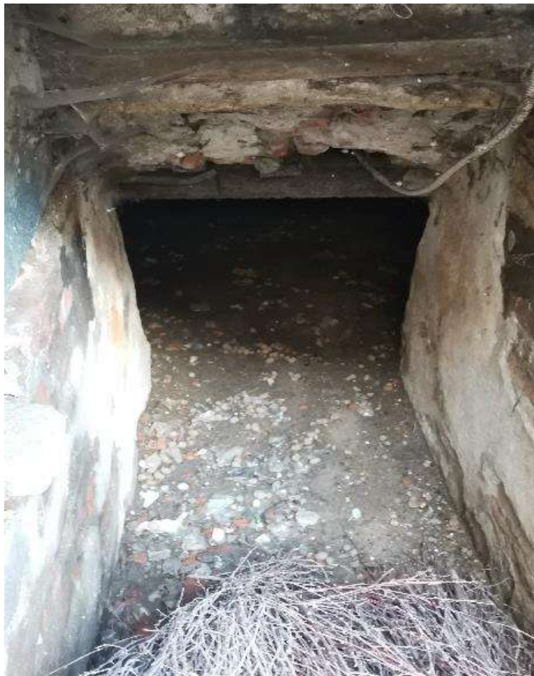
Фото №103. Вход в подвал со двора.
