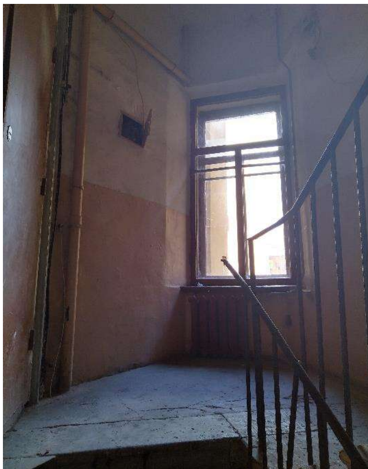
Фото №72. Парадная лестница №8. Площадка третьего этажа.
