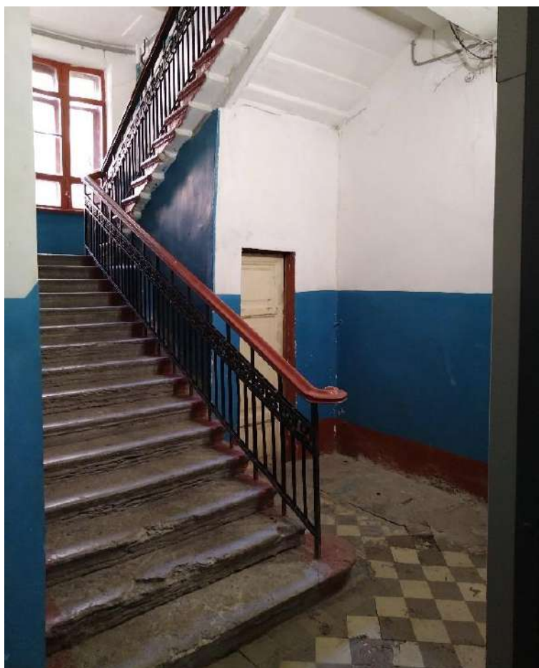
Фото №18. Парадная лестница №2. Лестничный марш и междуэтажная площадка, вид с первого этажа.
