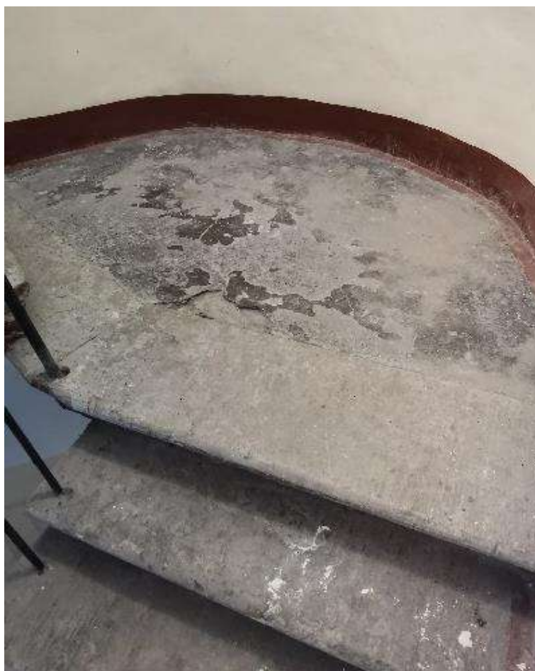
Фото №86. Парадная лестница №9. Оформление пола междуэтажных площадок.
