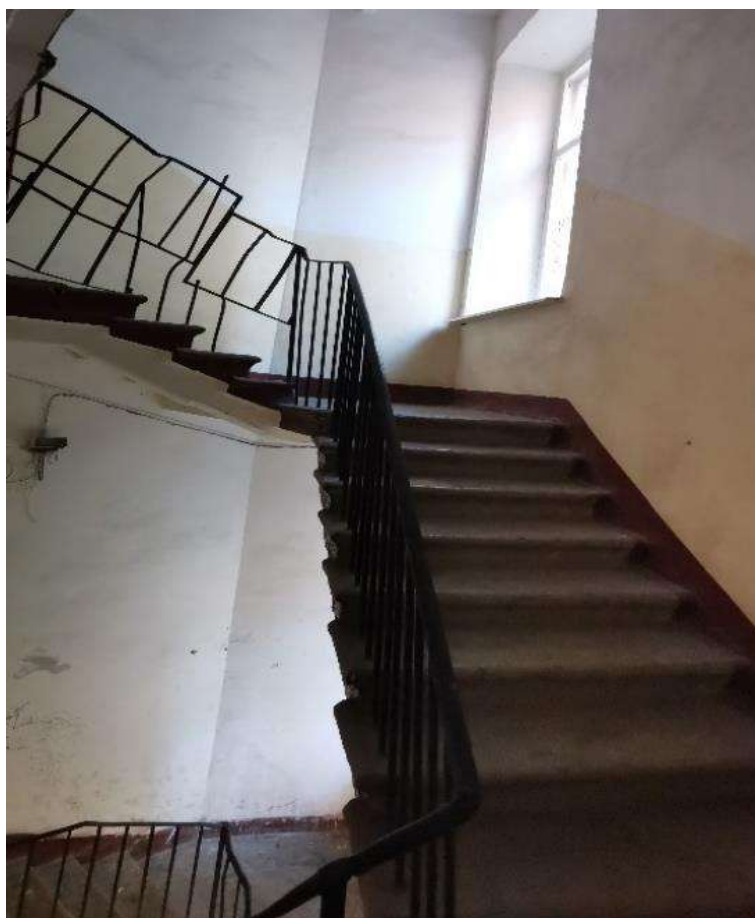
Фото №90. Парадная лестница №9. Междуэтажная площадка на уровне 3 этажа, лестничный марш.
