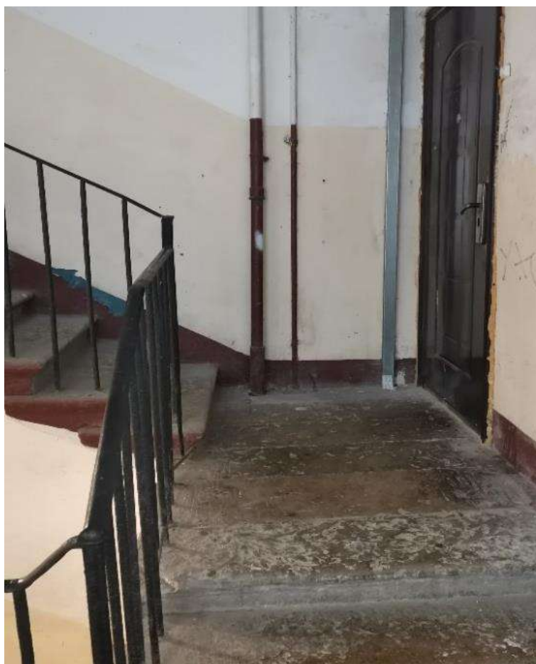
Фото №88. Парадная лестница №9. Междуэтажная площадка на уровне второго этажа, лестничный марш.
