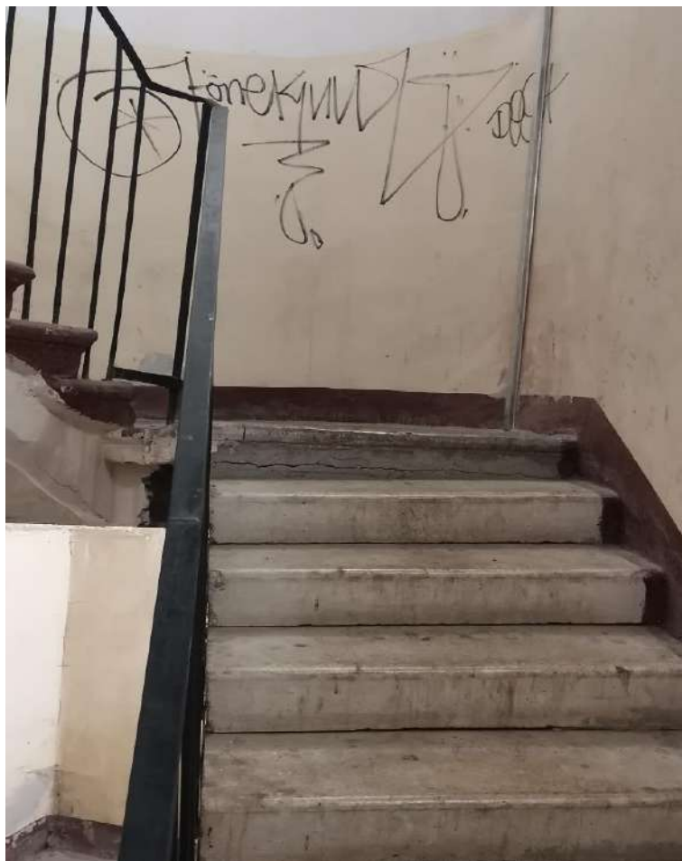
Фото №85. Парадная лестница №9. Лестничный марш, вид с первого этажа.
