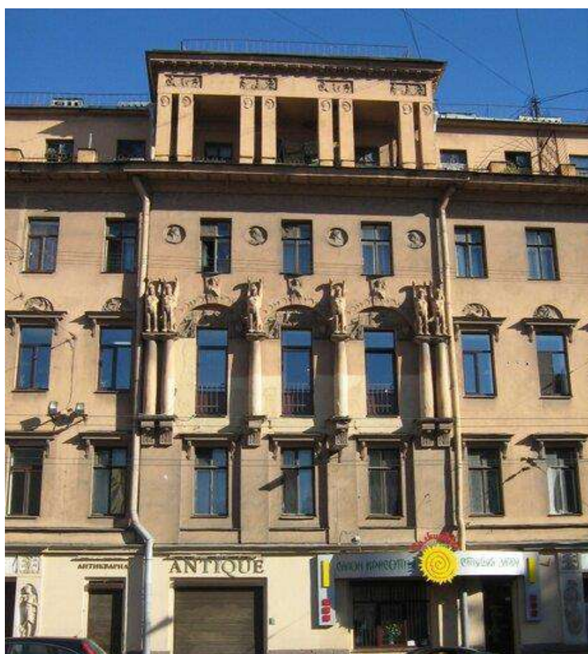
Илл.7. Фрагмент фасада дома № 3 по Большой Пушкарской улице без балконов. Фото до 2015г.
