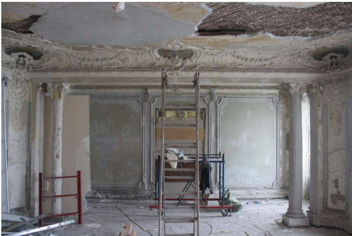
Илл.53. Левая парадная. Квартиры. Печь, декорированная вазочками с двух сторон, (женщина с детьми и животные на природе) в квартире на 5 этаже. Фото Олега Еверзова, 04.2017. (Источник: https://p3.citywalls.ru/photo_382-391171.jpg?mt=1555106164 )
