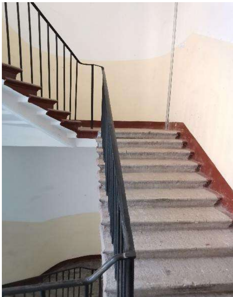
Фото №99. Парадная лестница №9. Междуэтажная площадка, вид с пятого этажа.
