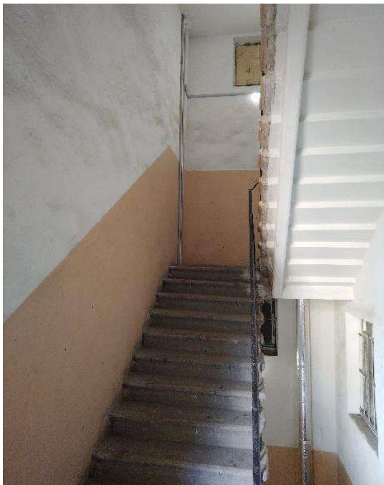
Фото №73. Парадная лестница №8. Лестничный марш, вид с площадки третьего этажа.
