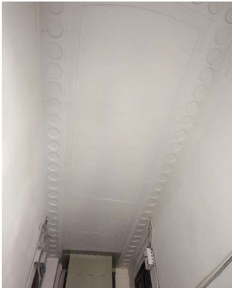
Фото №31. Парадная лестница №2. Оформление потолка на пятом этаже.
