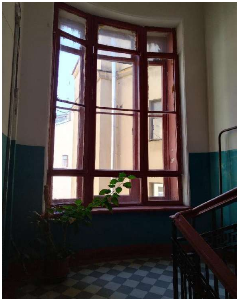
Фото №29. Парадная лестница №2. Междуэтажная площадка между четвертым и пятым этажами.
