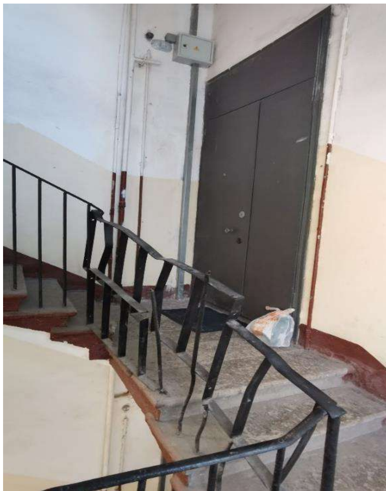
Фото №91. Парадная лестница №9. Площадка третьего этажа.
