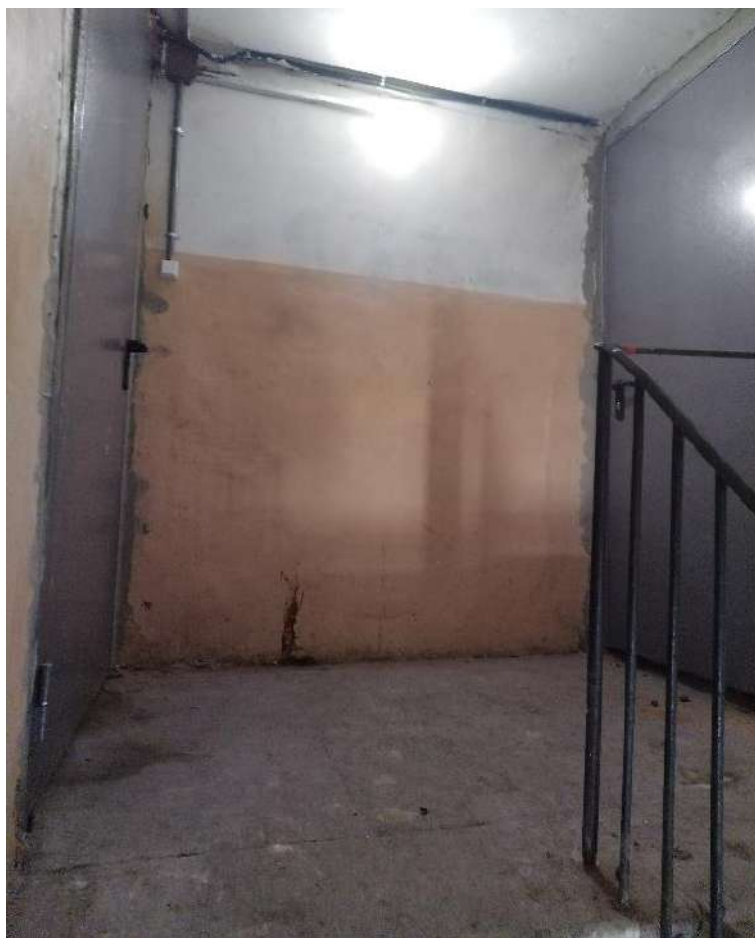
Фото №80. Парадная лестница №8. Выход на чердак.
