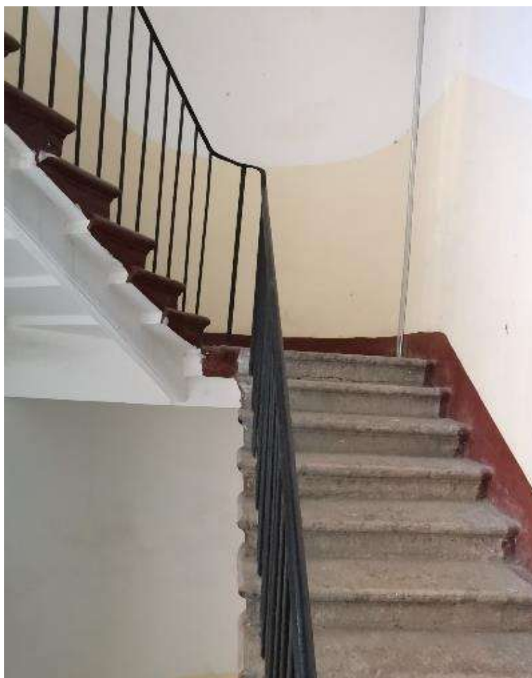
Фото №96. Парадная лестница №9. Междуэтажная площадка между 4 и 5 этажами.
