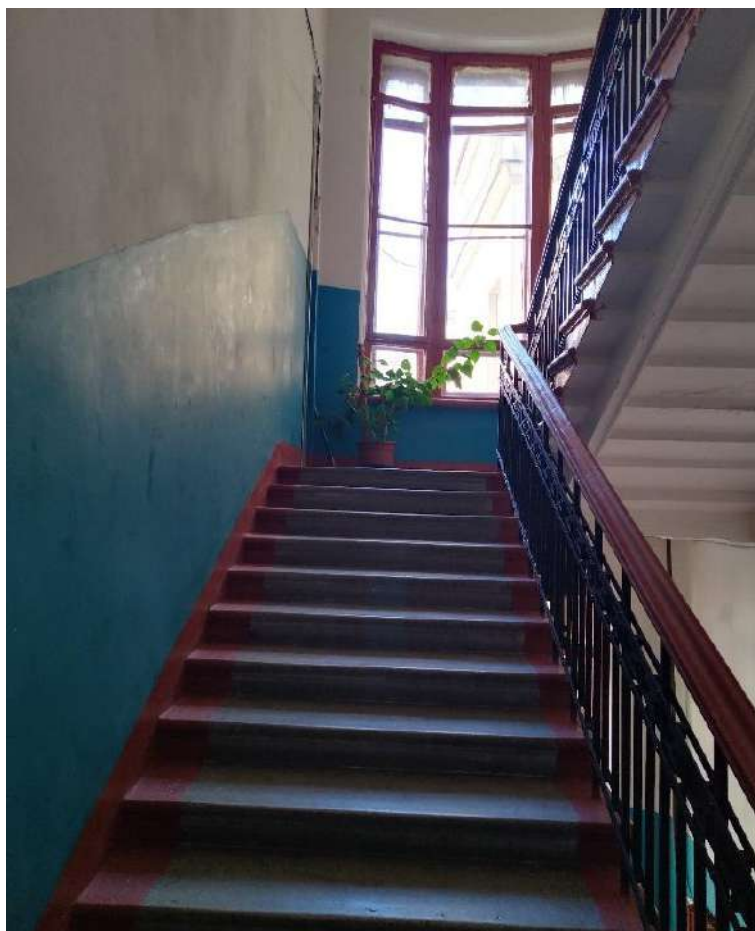
Фото №28. Парадная лестница №2. Лестничный марш, вид с четвертого этажа.
