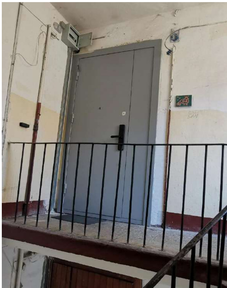
Фото №101. Парадная лестница №9. Площадка 6 этажа.
