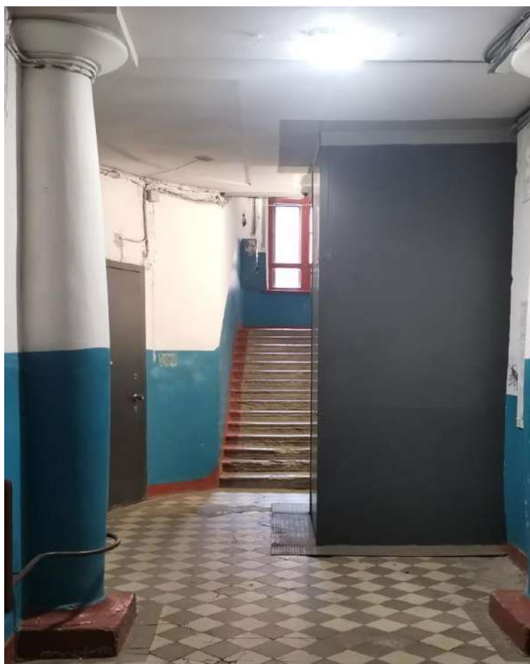
Фото №14. Парадная лестница №2. Вестибюль.
