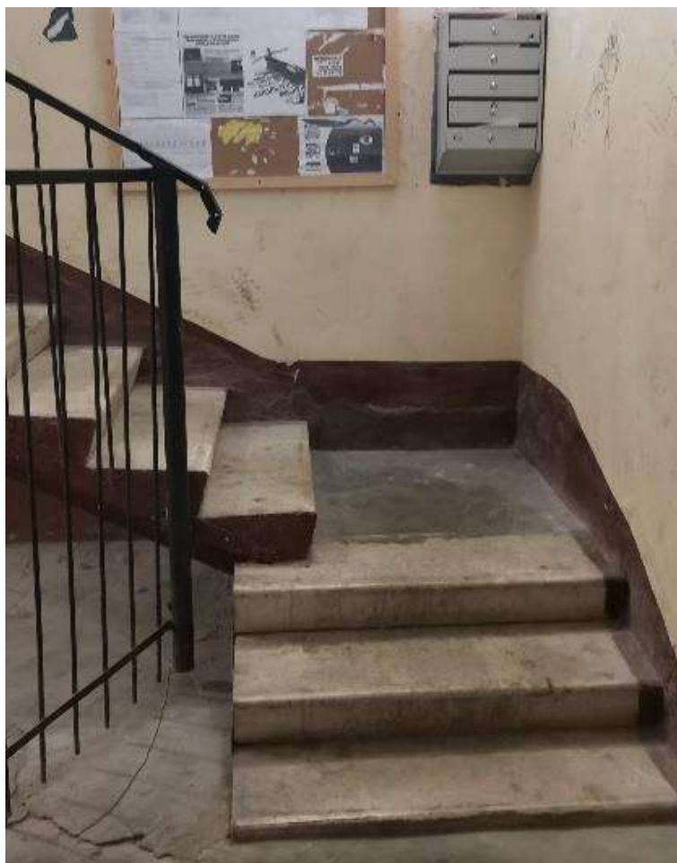
Фото №84. Парадная лестница №9. Лестница на первом этаже.
