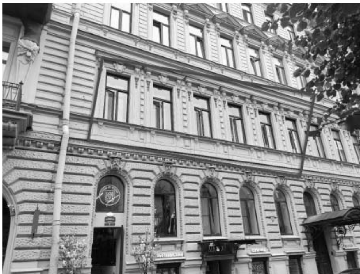
1. Общий вид на главный фасад здания и окна квартиры по проспекту Чернышевского;
