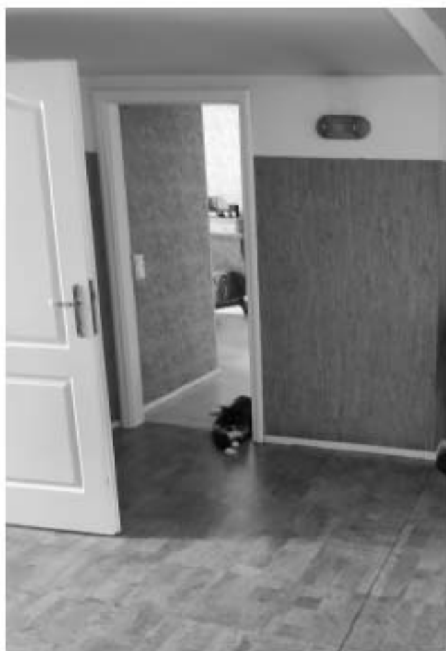
4. Фрагмент интерьера коридора (помещение №1);
