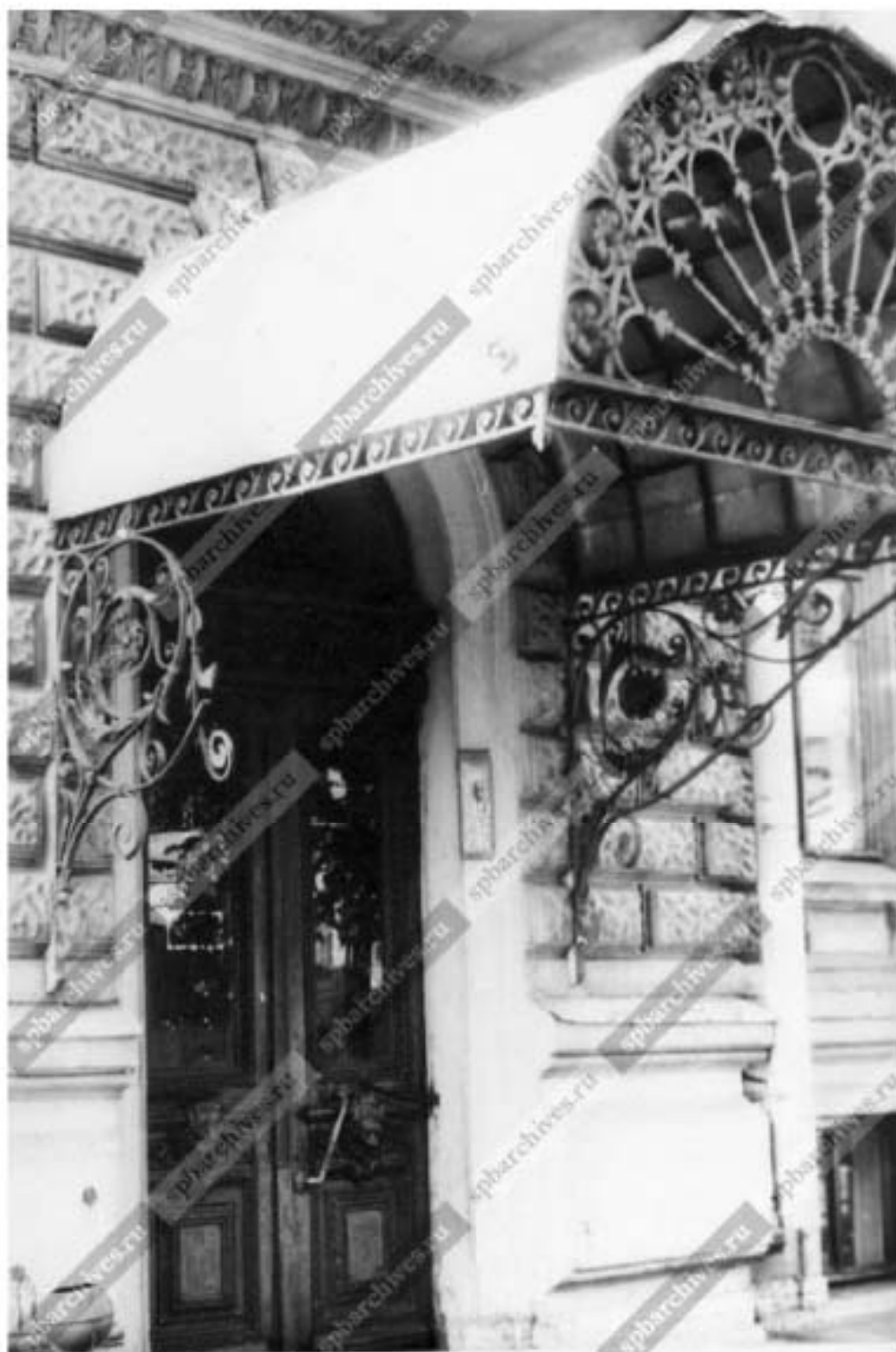
Илл. 43. Вид одного из кованых металлических козырьков, остекленных сверху, над входом южного фасада дома № 38/9 на улице Чайковского (бывший доходный дом П.П.Вейнера, архитектор Б.И.Гиршович, 1892-1896гг.). 18 июля 1983 г. ЦГАКФФД СПб Фотодокумент Ар 234059
