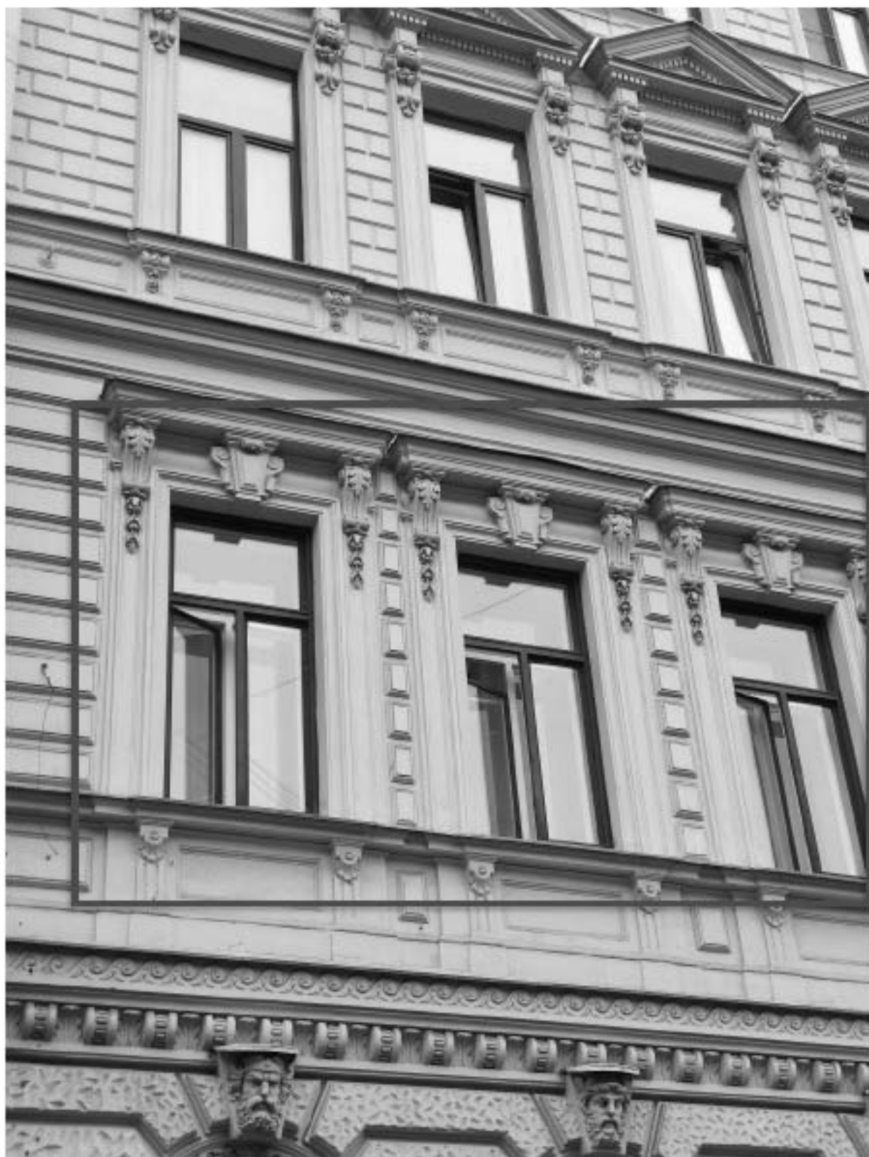
2. Вид на окна квартиры №19;
