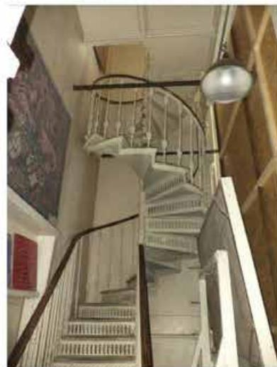
ограждения винтовой лестницы из литых чугунных стоек с фигурными орнаментированными накладками;
