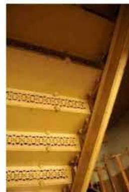
материал ограждения (чугун), техника исполнения (литье), рисунок (вертикальные прутья со стилизованным растительным орнаментом); поручни – материал (дерево), конфигурация (профилированные);
