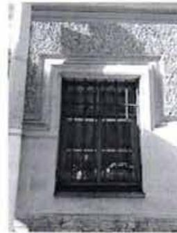
оконные проемы 1-го этажа - кованые решетки из вертикальных прутьев, с копьевидными завершениями;
