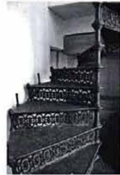
тип (распашная), конструкция (в нижней части - средиетенная, состоящая из двух маршей разной ширины, в верхней части - распашная), с дубовой подшивкой маршей, с деревянными ступенями, покрытыми дубовым паркетом;
