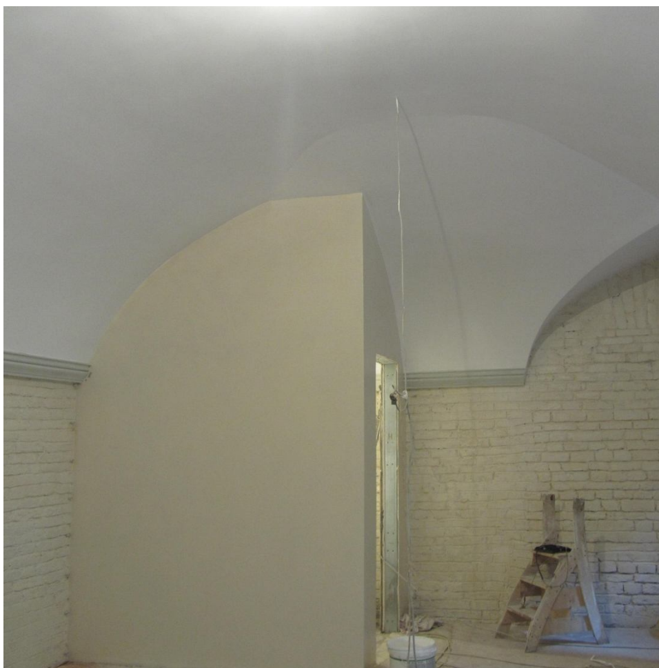
22. Вид в интерьере квартиры №19.
