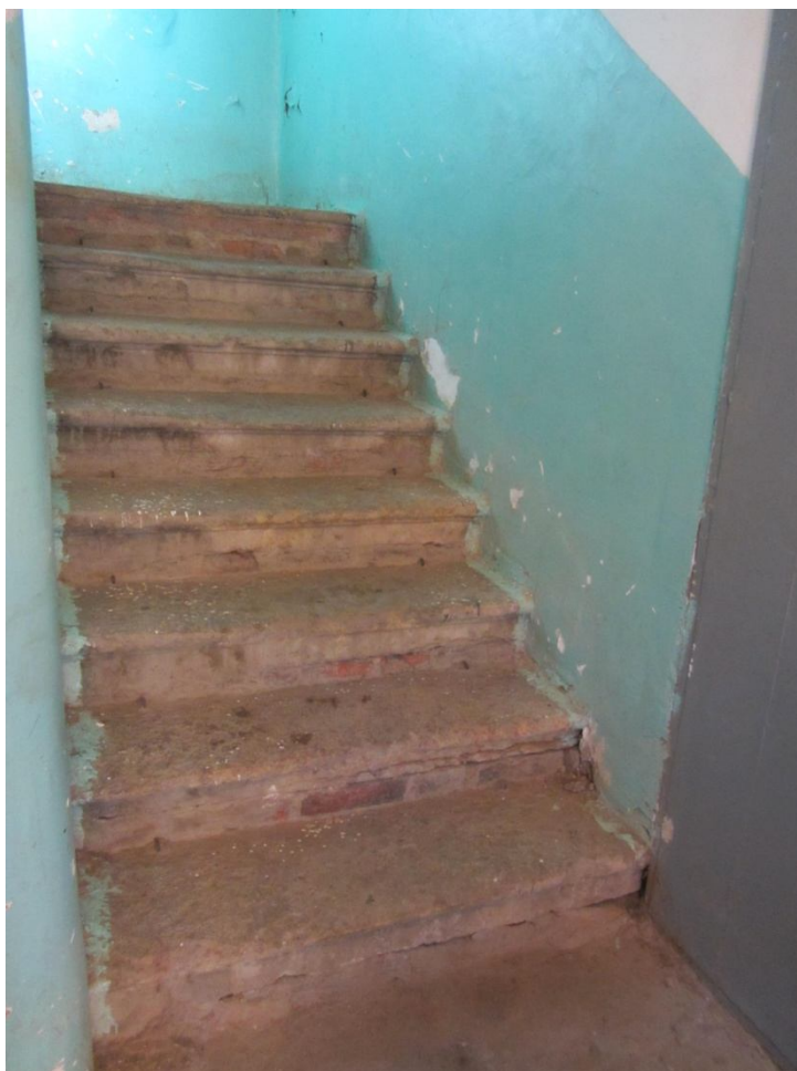
13. Вид на лестничной клетке жилой части восточного флигеля.
