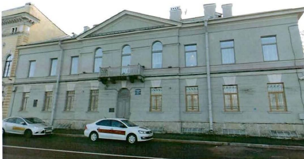
2. Фасад по Английской набережной
