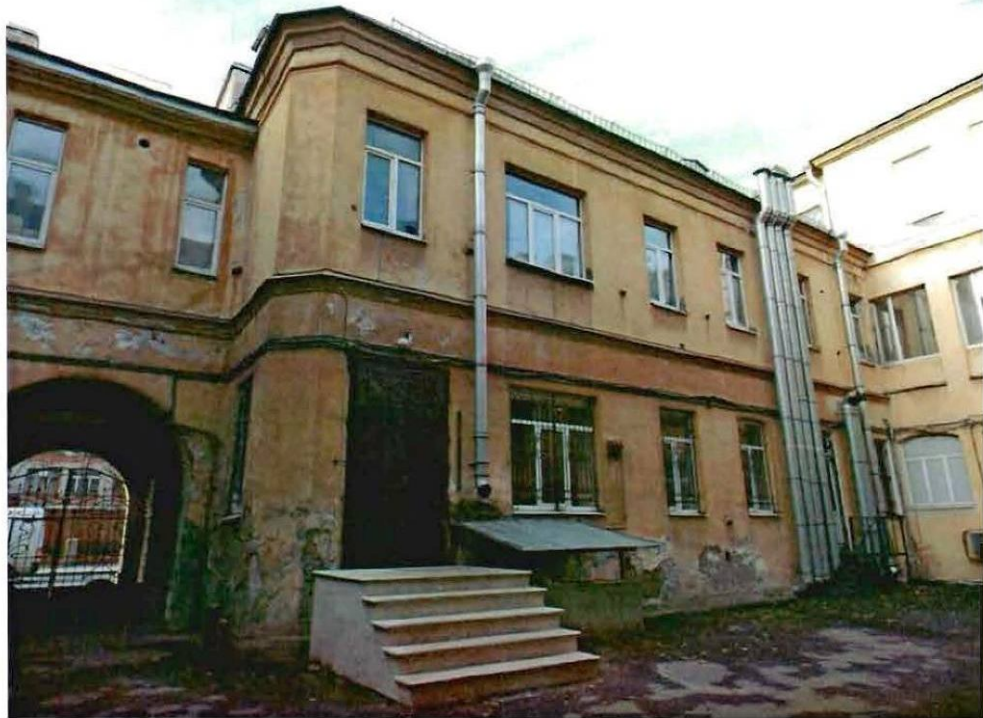
4. Западный дворовый фасад
