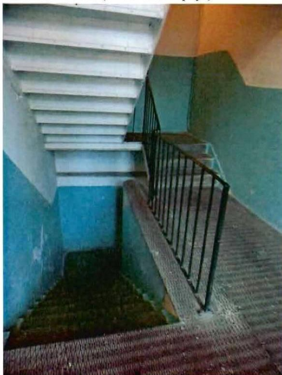
12. Лестница Л-3 (восточный корпус)
