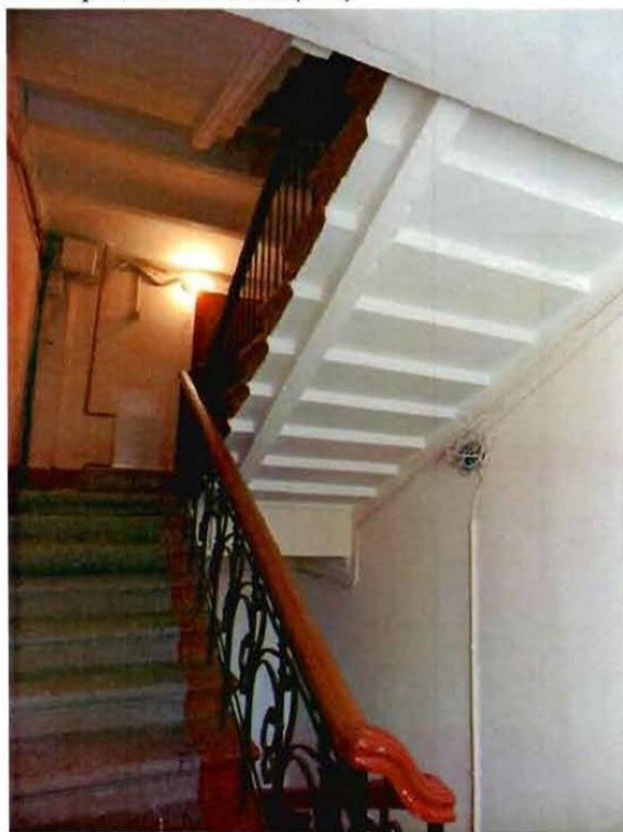
10. Лестница Л-2 (западный корпус)
