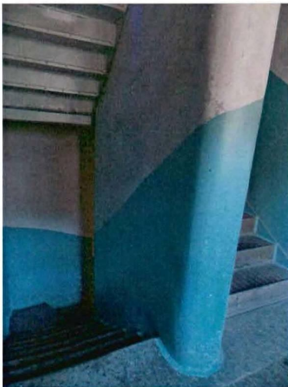
11. Лестница Л-3 (восточный корпус)
