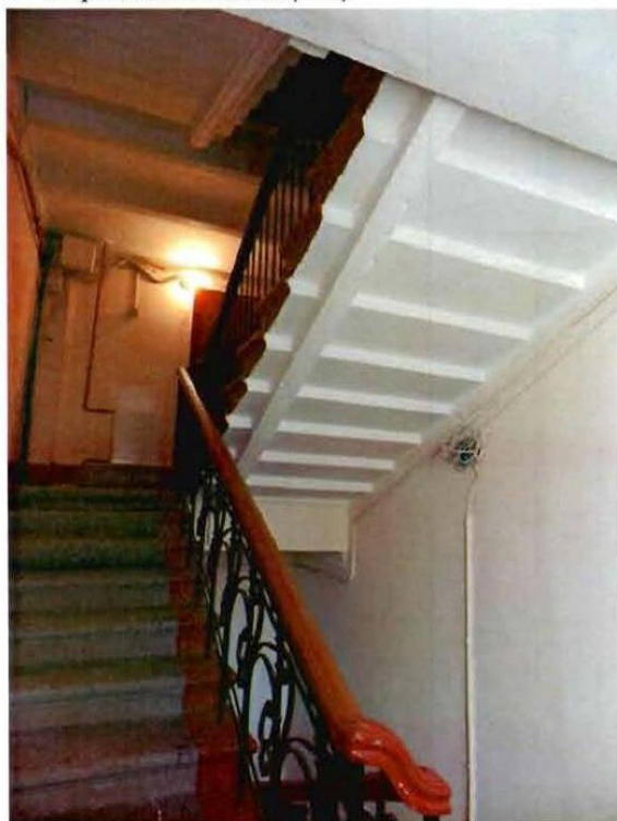
10. Лестница Л-2 (западный корпус)
