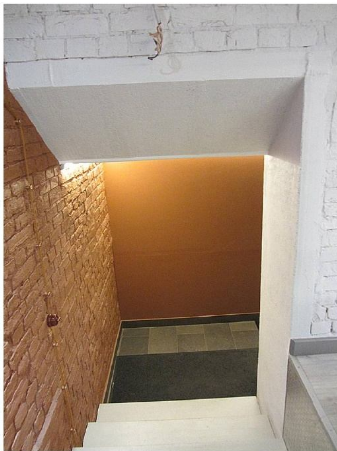
29. Вид на вход в помещение 7-Н (бывшая кв.7).
