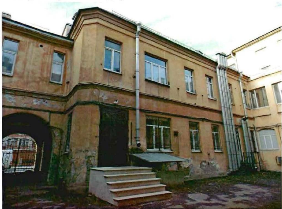
4. Западный дворовый фасад
