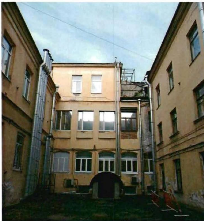
7. Северный дворовый фасад
