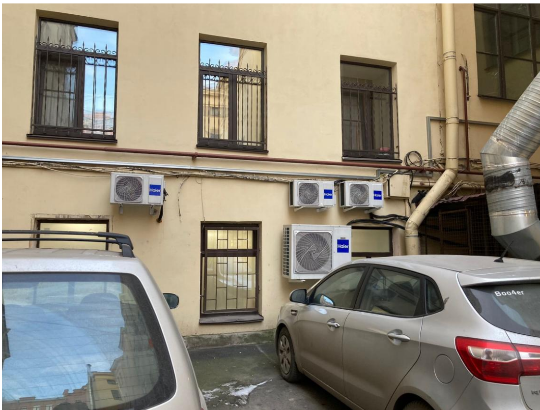
Фото 7. Фрагмент дворового фасада выявленного объекта культурного наследия «Дом К.И. Путилова»
