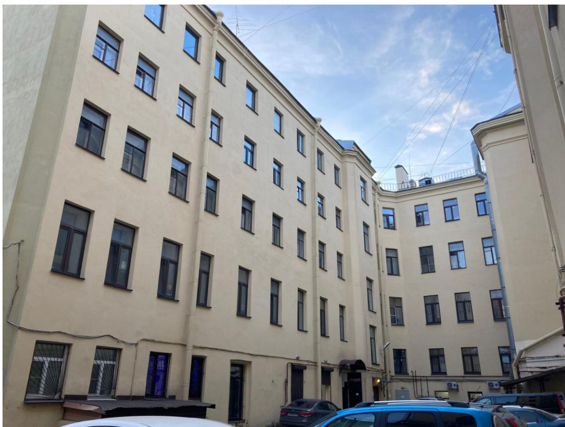
Фото 6. Фрагмент дворового фасада выявленного объекта культурного наследия «Дом К.И. Путилова»
