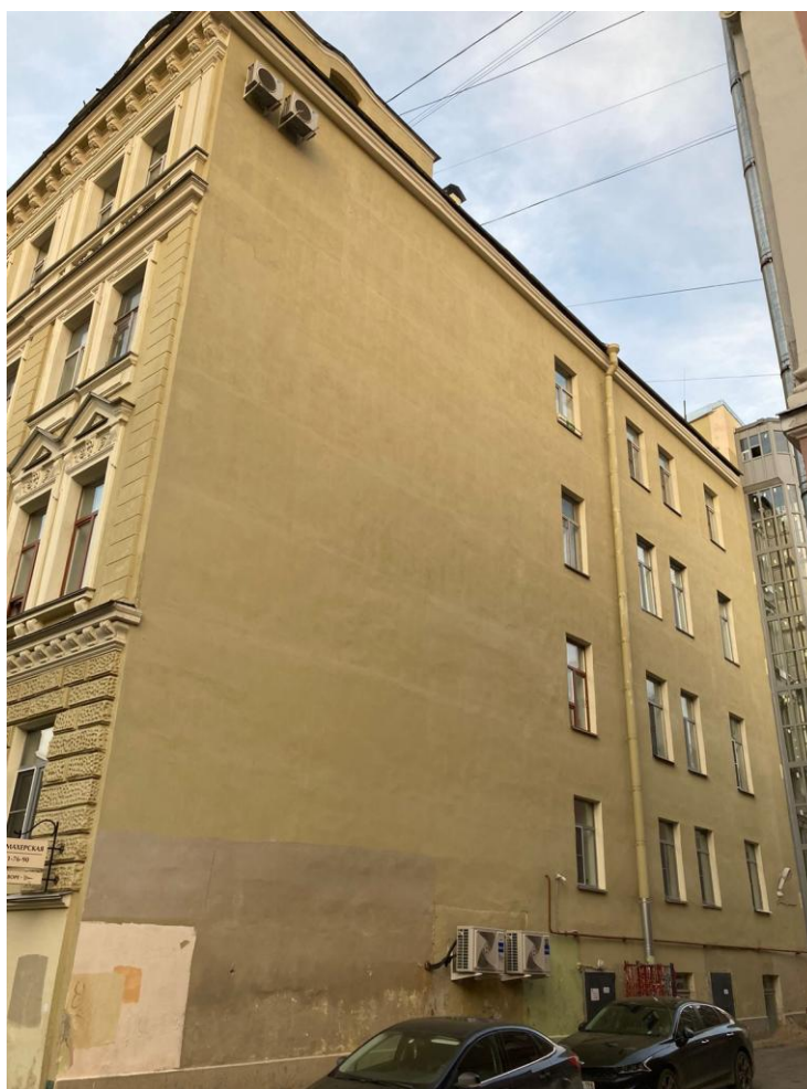
Фото 4. Фрагмент дворового фасада выявленного объекта культурного наследия «Дом К.И. Путилова»
