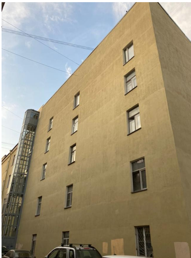
Фото 5. Фрагмент дворового фасада выявленного объекта культурного наследия «Дом К.И. Путилова»
